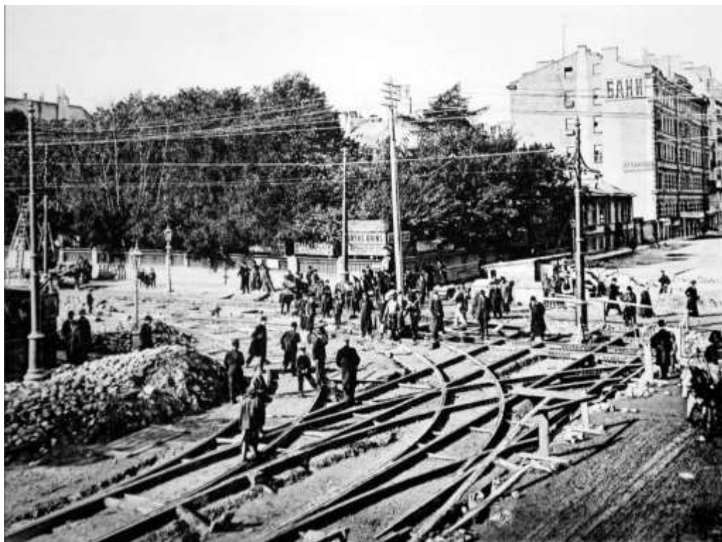
53. Укладка рельсов на перекрёстке Большого проспекта и 8-9 линии Васильевского острова. 1907
