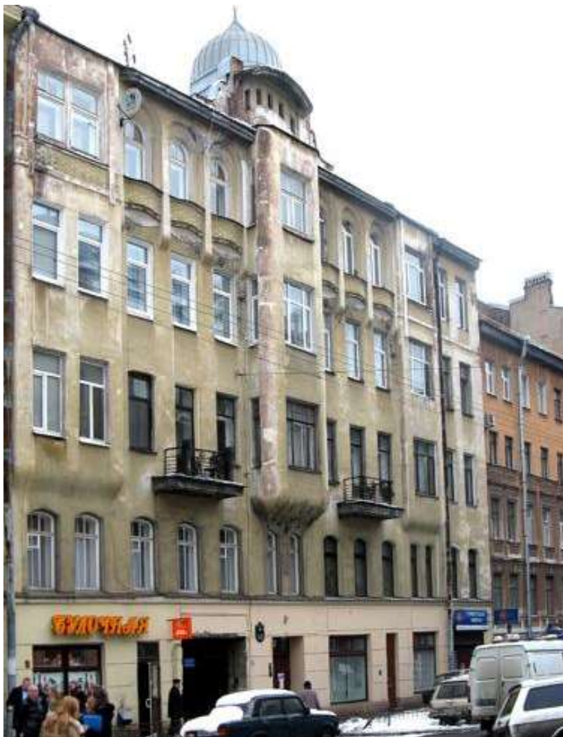
42. Дом Н.А. Пундика. Кавалергардская ул., дом 8
