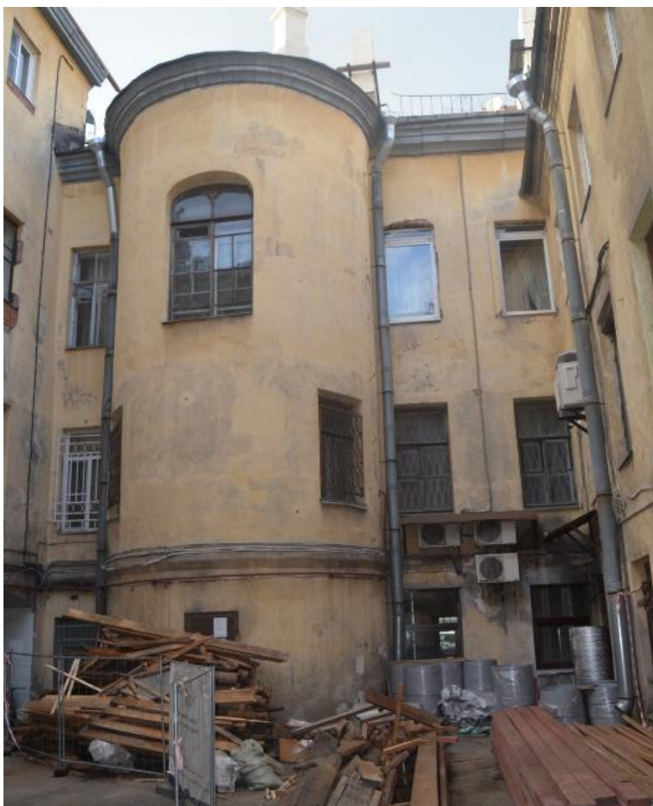
18. Выявленный объект культурного наследия «Особняк Е.А. Александровской (здание нефтепромышленного торгового общества "Мазут")». Дворовый (южный) фасад лицевого дома с ризалитом парадной лестницы. Вид с юго-востока. Съемка 26.04.2021
