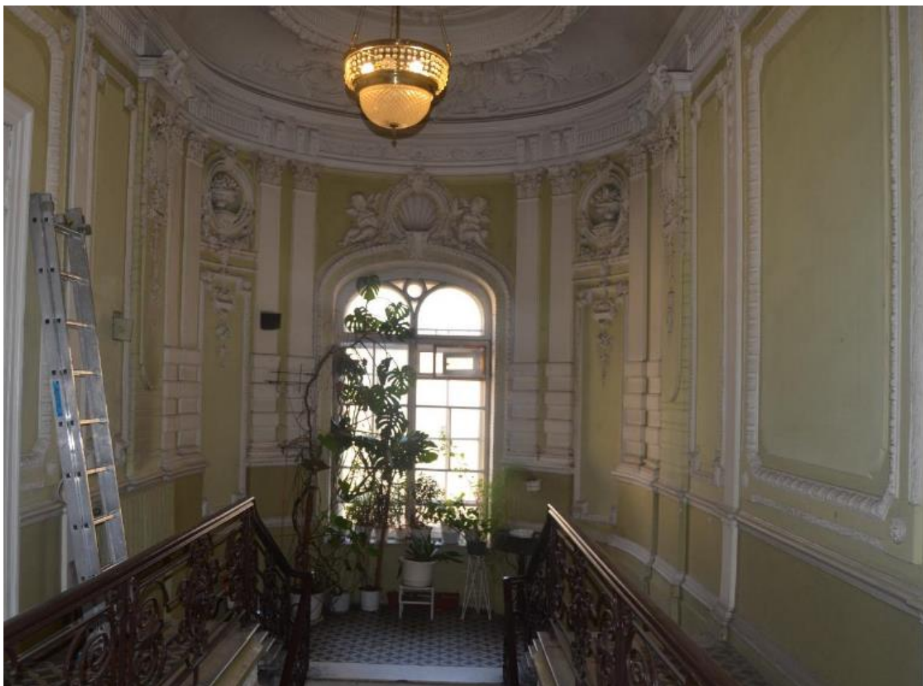
37. Выявленный объект культурного наследия «Особняк Е.А. Александровской (здание нефтепромышленного торгового общества "Мазут")». Парадная лестница (Л 2). Оформление лестничной площадки третьего этажа в объеме ризалита. Вид с севера. Съемка 26.04.2021
