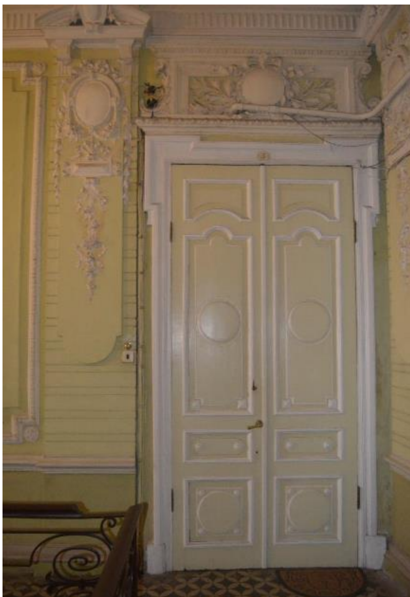
38. Выявленный объект культурного наследия «Особняк Е.А. Александровской (здание нефтепромышленного торгового общества "Мазут")». Парадная лестница (Л 2). Историческое дверное заполнение и оформление дверных проемов в уровне третьего этажа. Вид с востока. Съемка 26.04.2021
