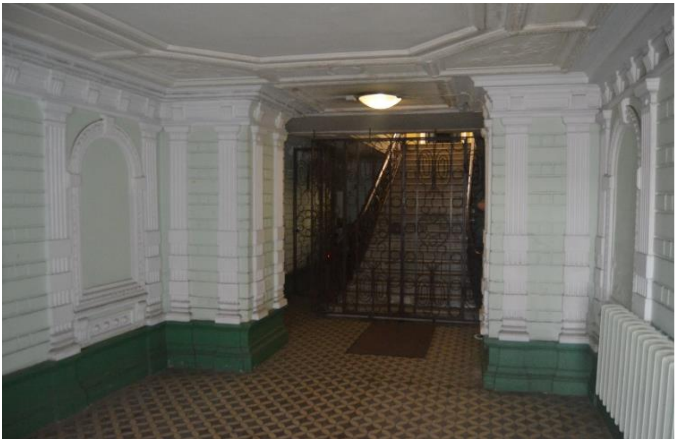
20. Выявленный объект культурного наследия «Особняк Е.А. Александровской (здание нефтепромышленного торгового общества "Мазут")». Парадная лестница (Л 2). Общий вид вестибюля. Вид с севера. Съемка 26.04.2021
