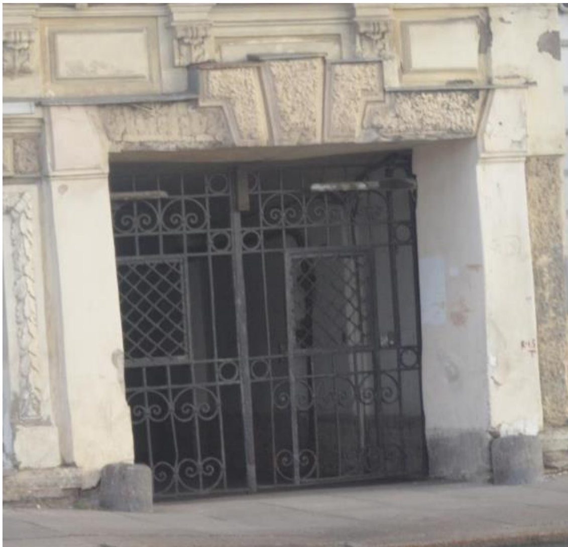
11. Выявленный объект культурного наследия «Особняк Е.А. Александровской (здание нефтепромышленного торгового общества "Мазут")». Оформление воротного проезда со стороны лицевого фасада. Вид с севера. Съемка 26.04.2021
