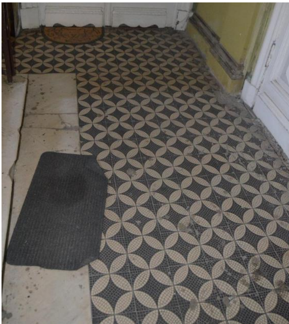
32. Выявленный объект культурного наследия «Особняк Е.А. Александровской (здание нефтепромышленного торгового общества "Мазут")».Парадная лестница (Л 2). Оформление пола лестничных площадок в уровне второго этажа. Вид с востока.. Съемка 26.04.2021
