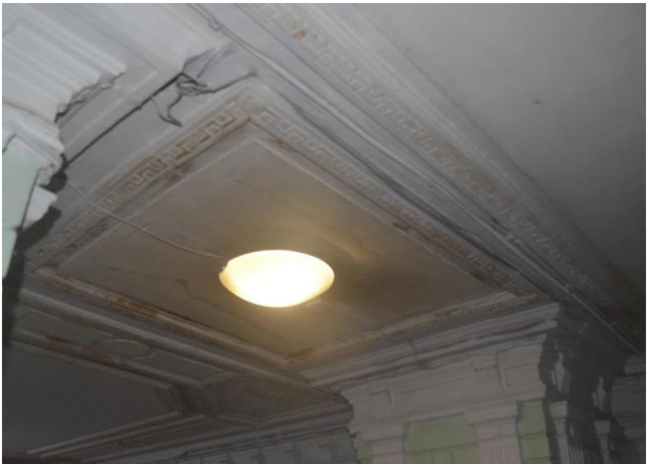
25. Выявленный объект культурного наследия «Особняк Е.А. Александровской (здание нефтепромышленного торгового общества "Мазут")». Парадная лестница (Л 2). Оформление потолка проема между вестибюлем и лестничной клеткой. Вид с юга. Съемка 26.04.2021
