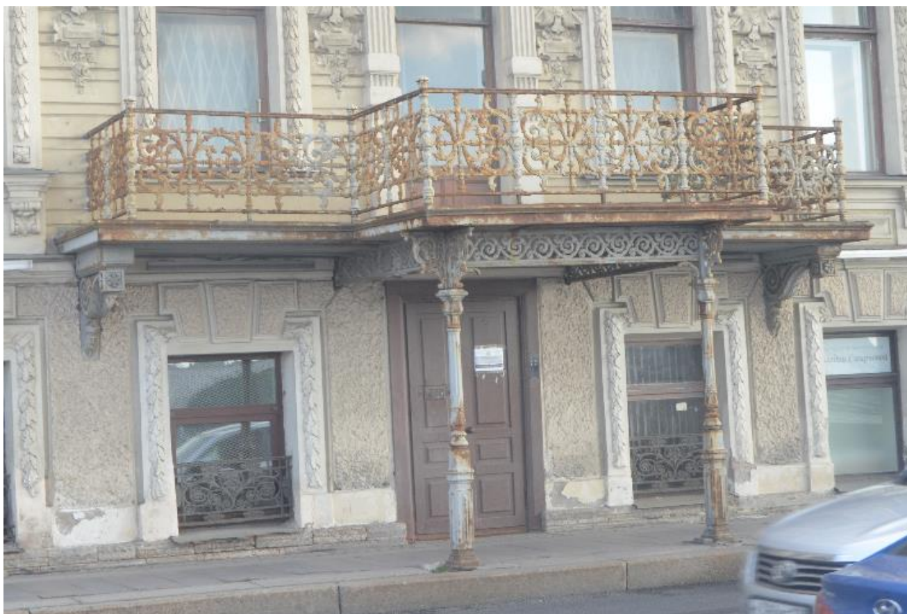
3. Выявленный объект культурного наследия «Особняк Е.А. Александровской (здание нефтепромышленного торгового общества "Мазут")». Выносной балкон по центральным осям лицевого фасада. Вид с севера. Съемка 26.04.2021
