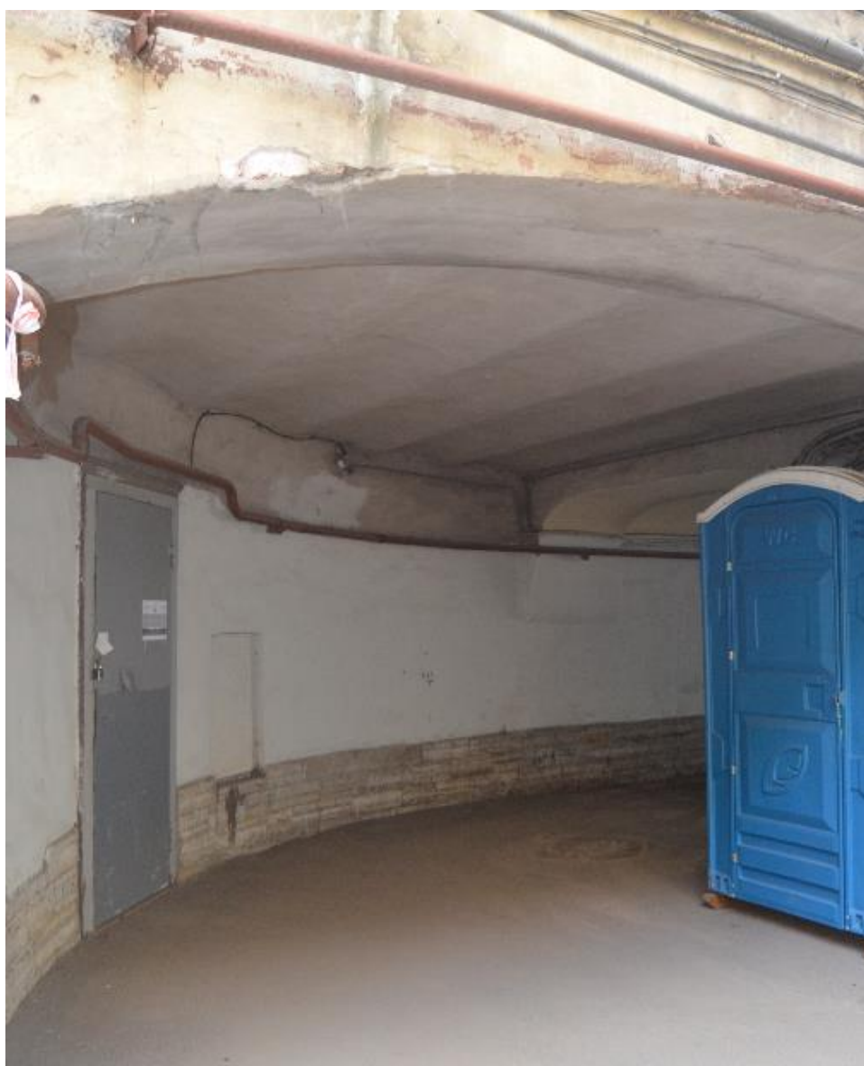
13. Выявленный объект культурного наследия «Особняк Е.А. Александровской (здание нефтепромышленного торгового общества "Мазут")». Конструкция воротного проезда. Вид с востока. Съемка 26.04.2021
