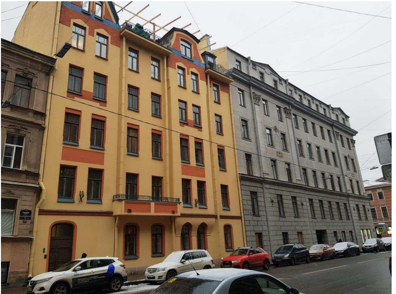
1. Выявленный объект культурного наследия «Доходный дом страхового общества «Россия»», общий вид северного фасада (по Баскову пер.)
