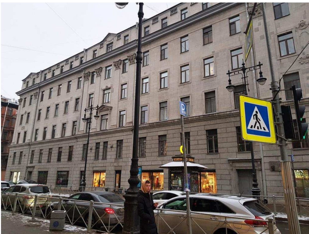
2. Выявленный объект культурного наследия «Доходный дом страхового общества «Россия»», общий вид западного фасада (по ул. Маяковского).
