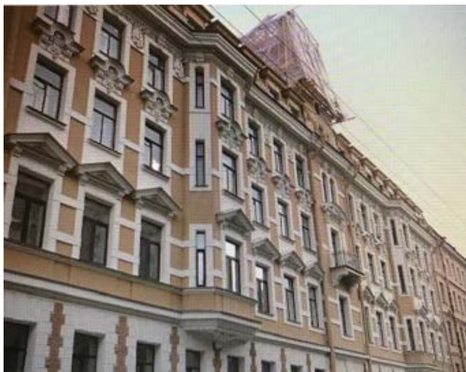
Саперный переулок, дом 10. Окончание реставрации фасада.2012г.
