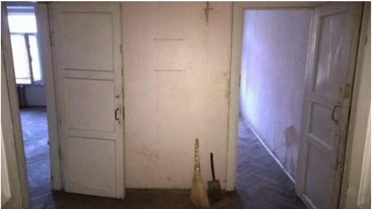
Фото 3. Саперный пер, д.10, кв.14: Тамбур перед Комнатой 1 и Комнатой 2
