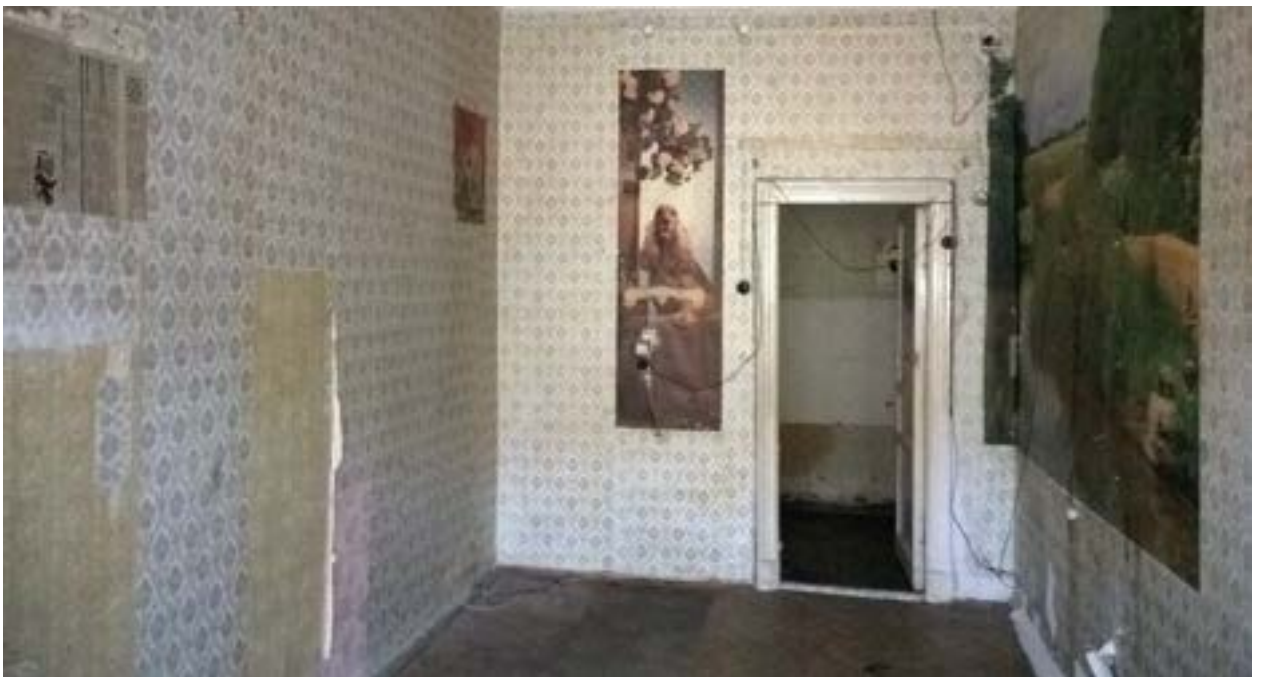
Фото 9. Саперный пер, д.10, кв.14: Комната 5
