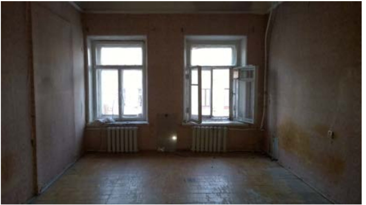
Фото 13. Саперный пер, д.10, кв.14: Комната 7
