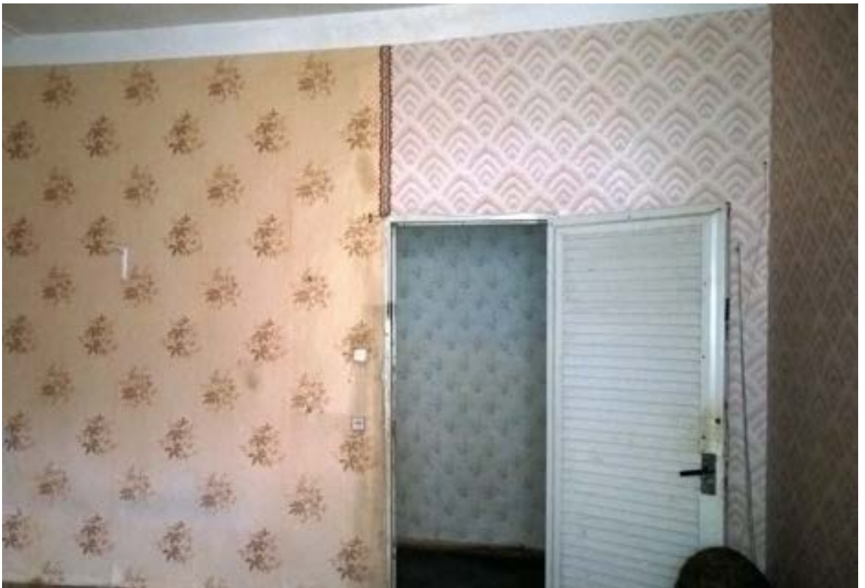
Фото 7. Саперный пер, д.10, кв.14: Комната 4
