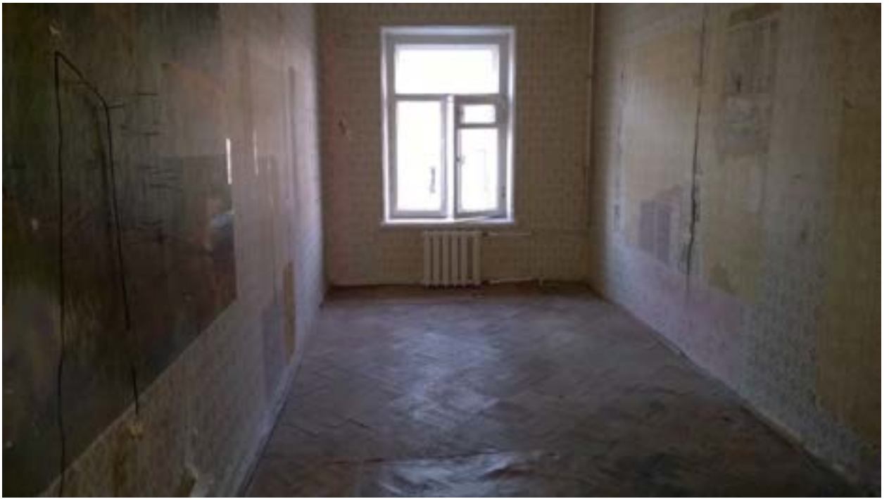
Фото 8. Саперный пер, д.10, кв.14: Комната 5
