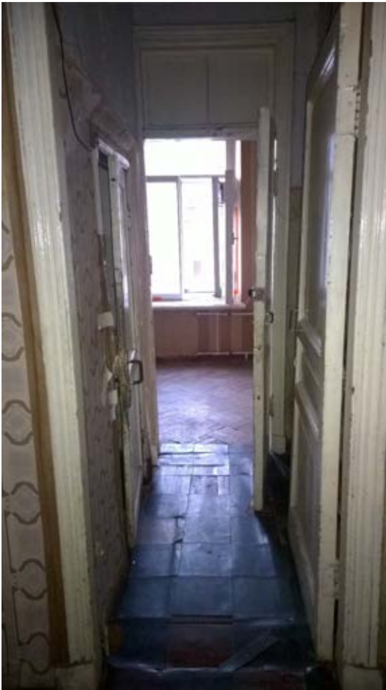
Фото 14. Саперный пер, д.10, кв.14: Комната 8
