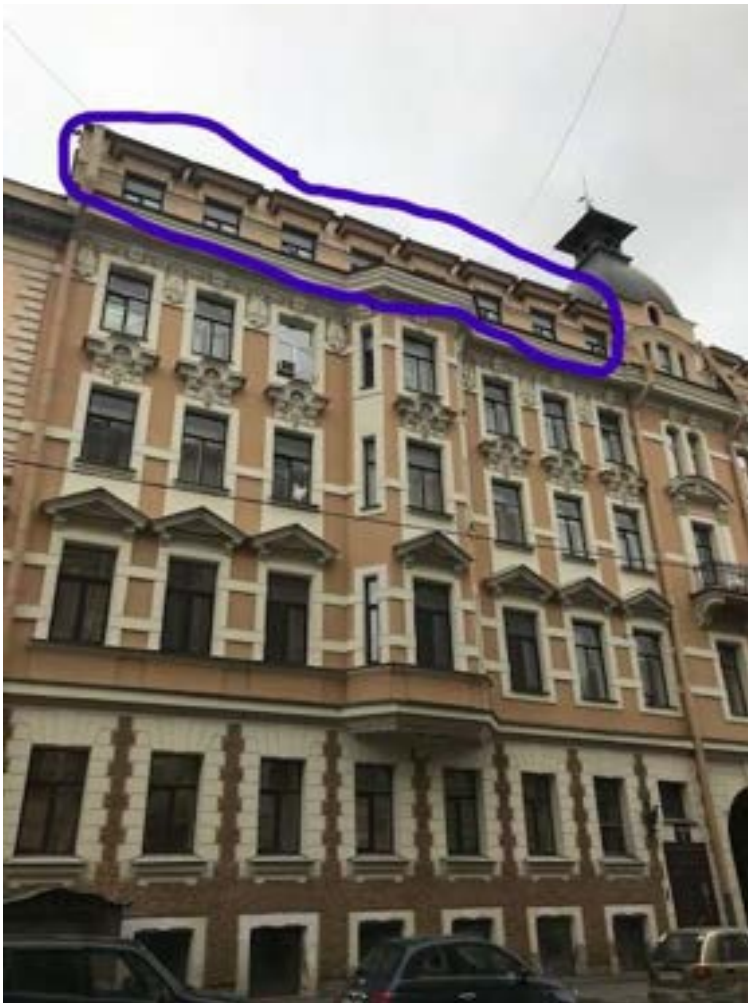
Фото здания 2. Саперный пер, д.10: Окна квартиры №14
