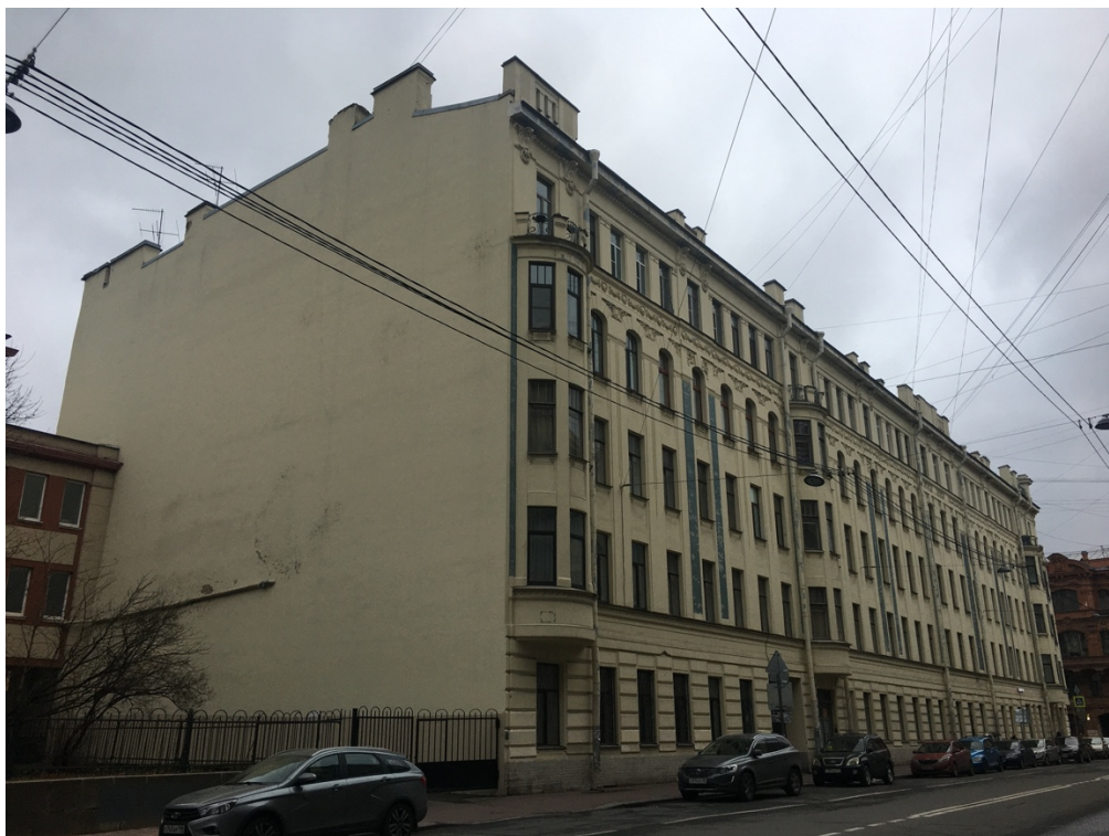
4. Выявленный объект культурного наследия «Дом Санкт-Петербургского мещанского общества», расположенный по адресу: г. Санкт-Петербург, Центральный район, Загородный пр-т, д. 31 (Бородинская ул., д. 12). Вид лицевого фасада с ул. Бородинской в направлении пр. Загородного. Фото 10.11.2020
