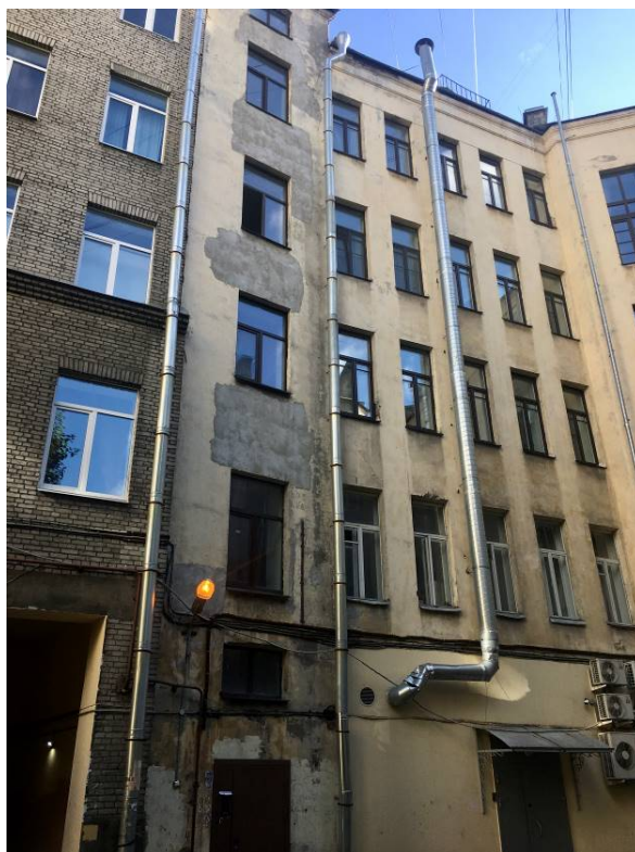
7. Выявленный объект культурного наследия «Дом Санкт-Петербургского мещанского общества», расположенный по адресу: г. Санкт-Петербург, Центральный район, Загородный пр-т, д. 31 (Бородинская ул., д. 12). Вид дворового фасада. Направление съемки юго-запад. Фото 12.08.2020
