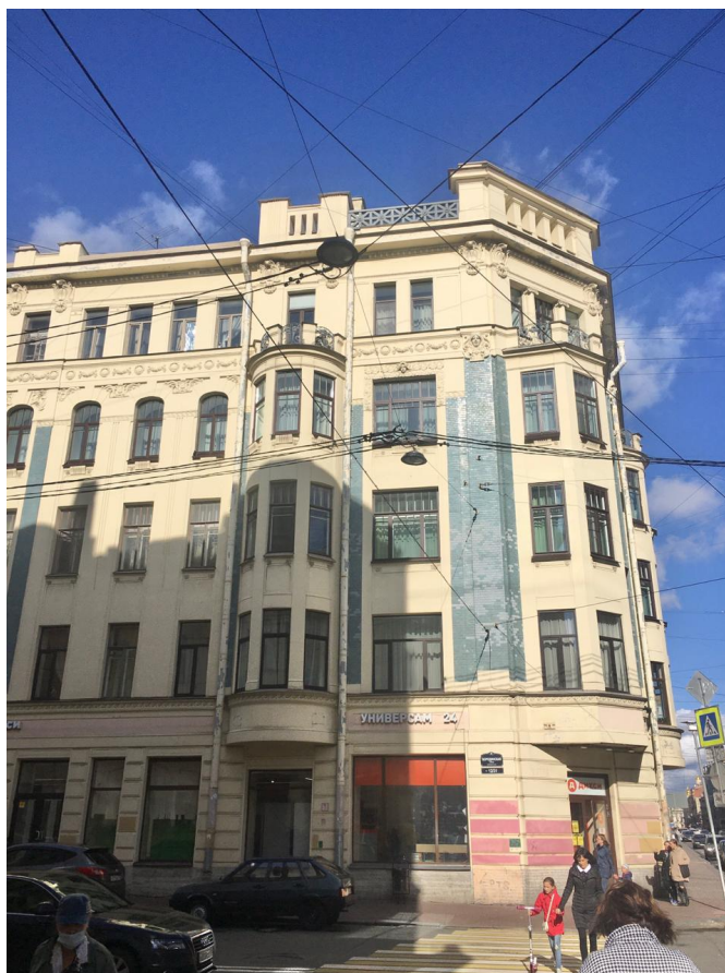
5. Выявленный объект культурного наследия «Дом Санкт-Петербургского мещанского общества», расположенный по адресу: г. Санкт-Петербург, Центральный район, Загородный пр-т, д. 31 (Бородинская ул., д. 12). Вид лицевого фасада с перекрестка пр. Загородного и ул. Бородинской. Фото 12.08.2020
