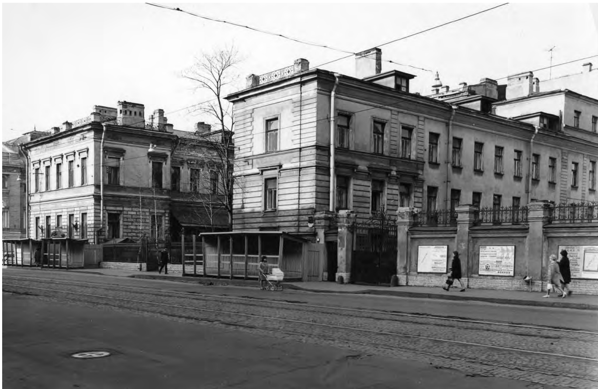
108. Ул. Глинки д. 4. Фото нач. 1970-х гг. КГИОП. №113532/4
