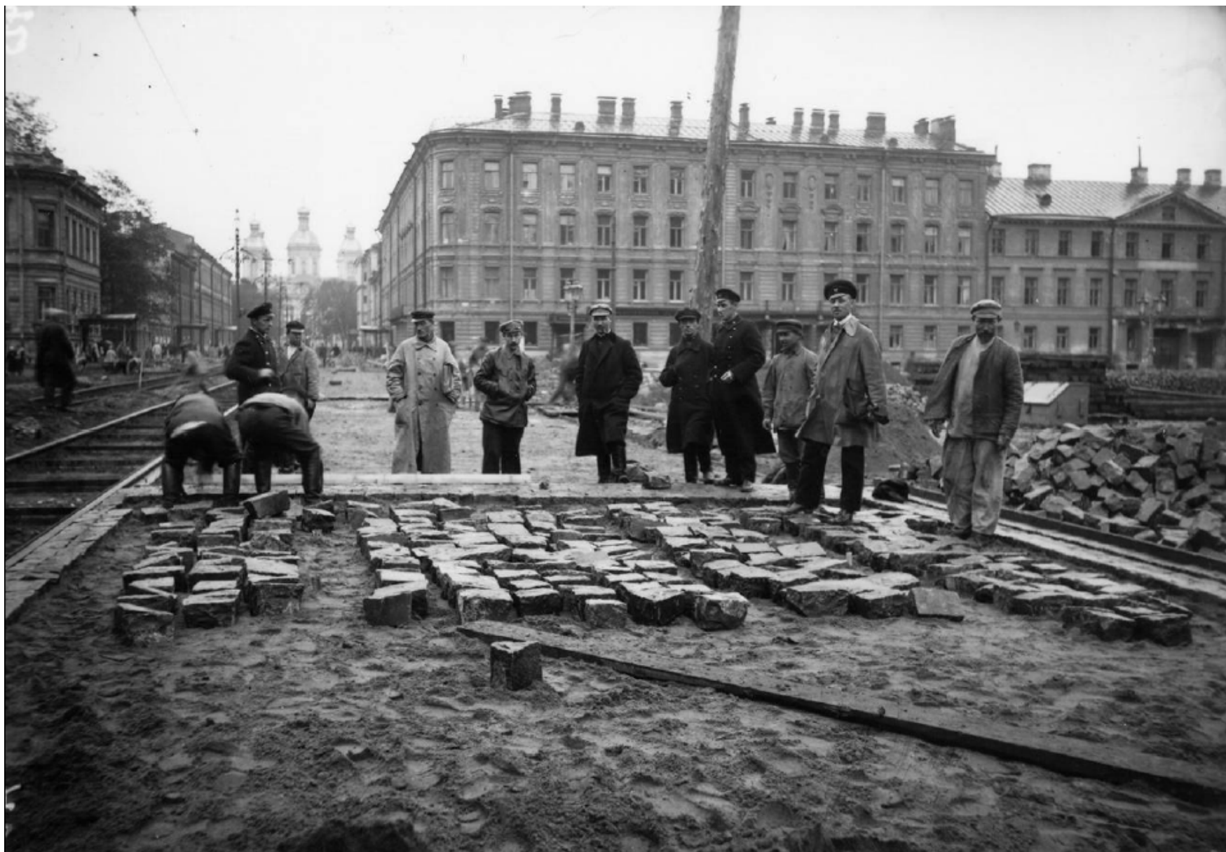
96. Дорожные работы на Театральной площади. После 1925 г. ЦГАКФФД. Гр 82997.
