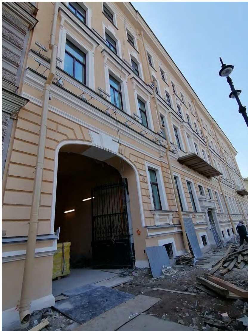
11. Объект культурного наследия регионального значения «Дом Мордвиновых» входящий в состав ансамбля «Дом Мордвиновых (с фонтаном "Девушка с кувшином и путти" и оградой курдонера)» по адресу: г. Санкт-Петербург, улица Глинки, дом 4, литера А Вид с северо-востока Дата съемки: 28 апреля 2021 г.
