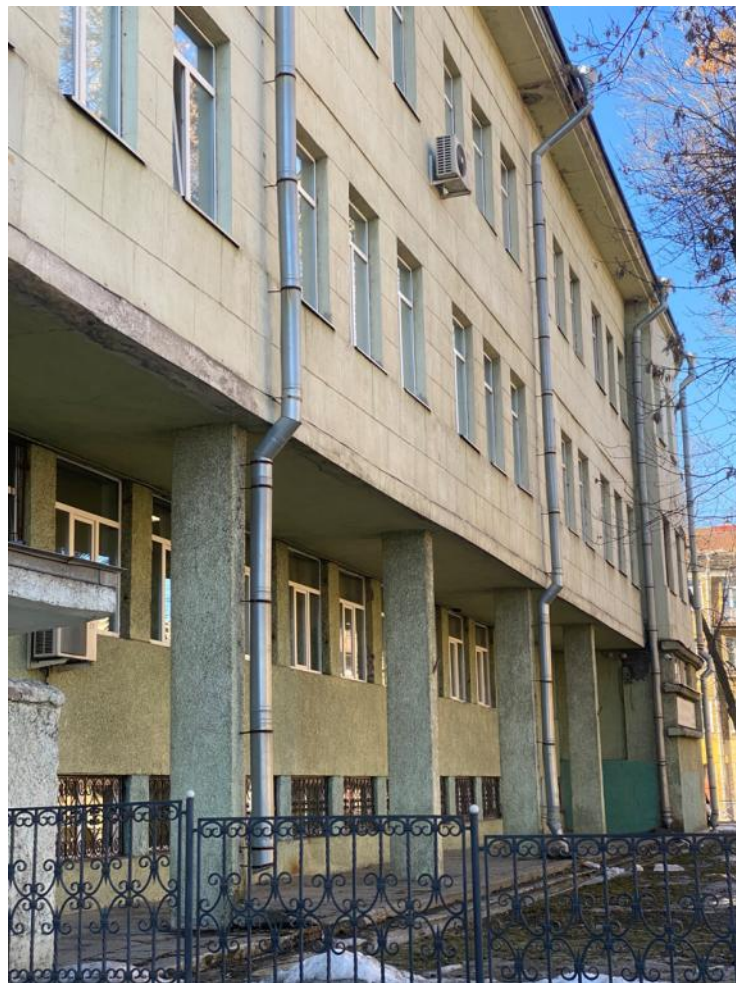
Фото 4. Выявленный ОКН «Здание школы». Фрагмент восточного фасада.
