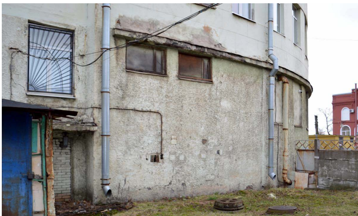
Фото 11. Выявленный ОКН «Здание школы». Фрагмент западного фасада.
