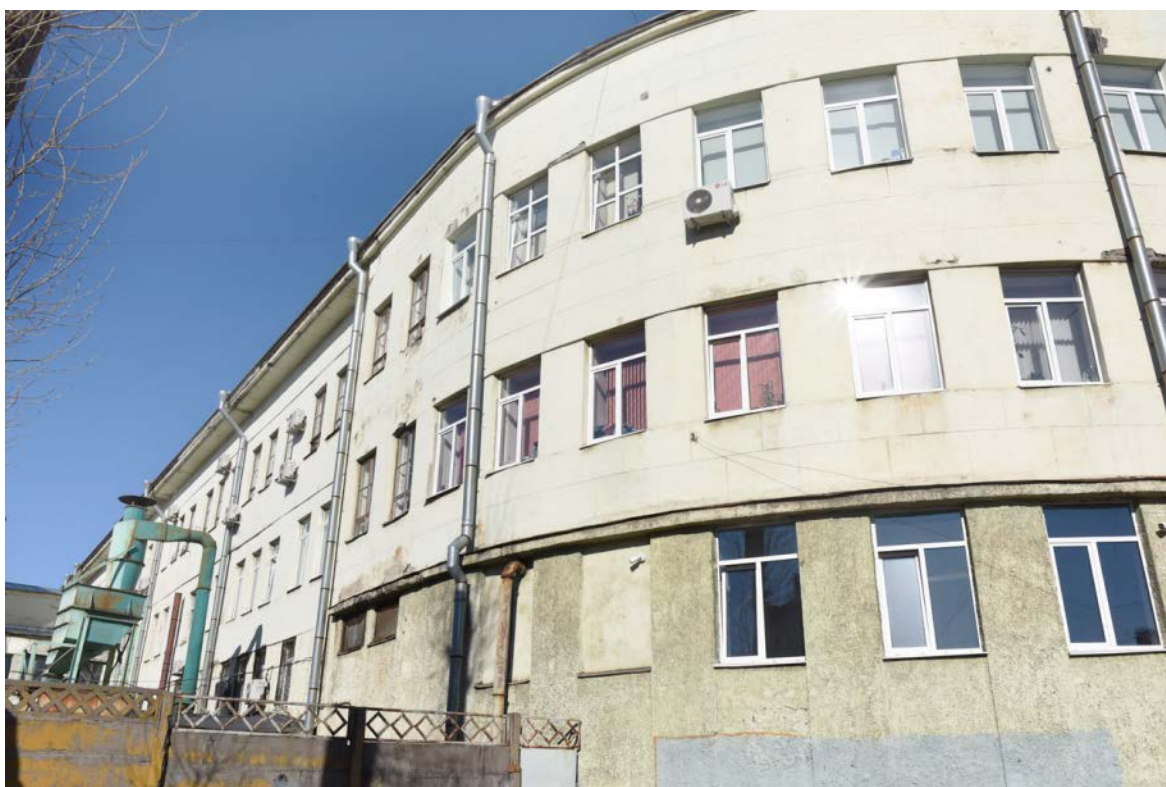
Фото 8. Выявленный ОКН «Здание школы». Общий вид западного фасада. Вид с юга.
