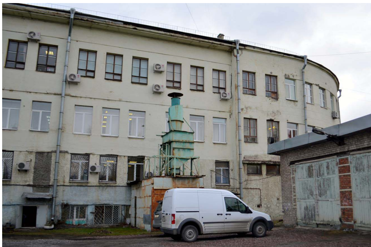
Фото 10. Выявленный ОКН «Здание школы». Фрагмент западного фасада.
