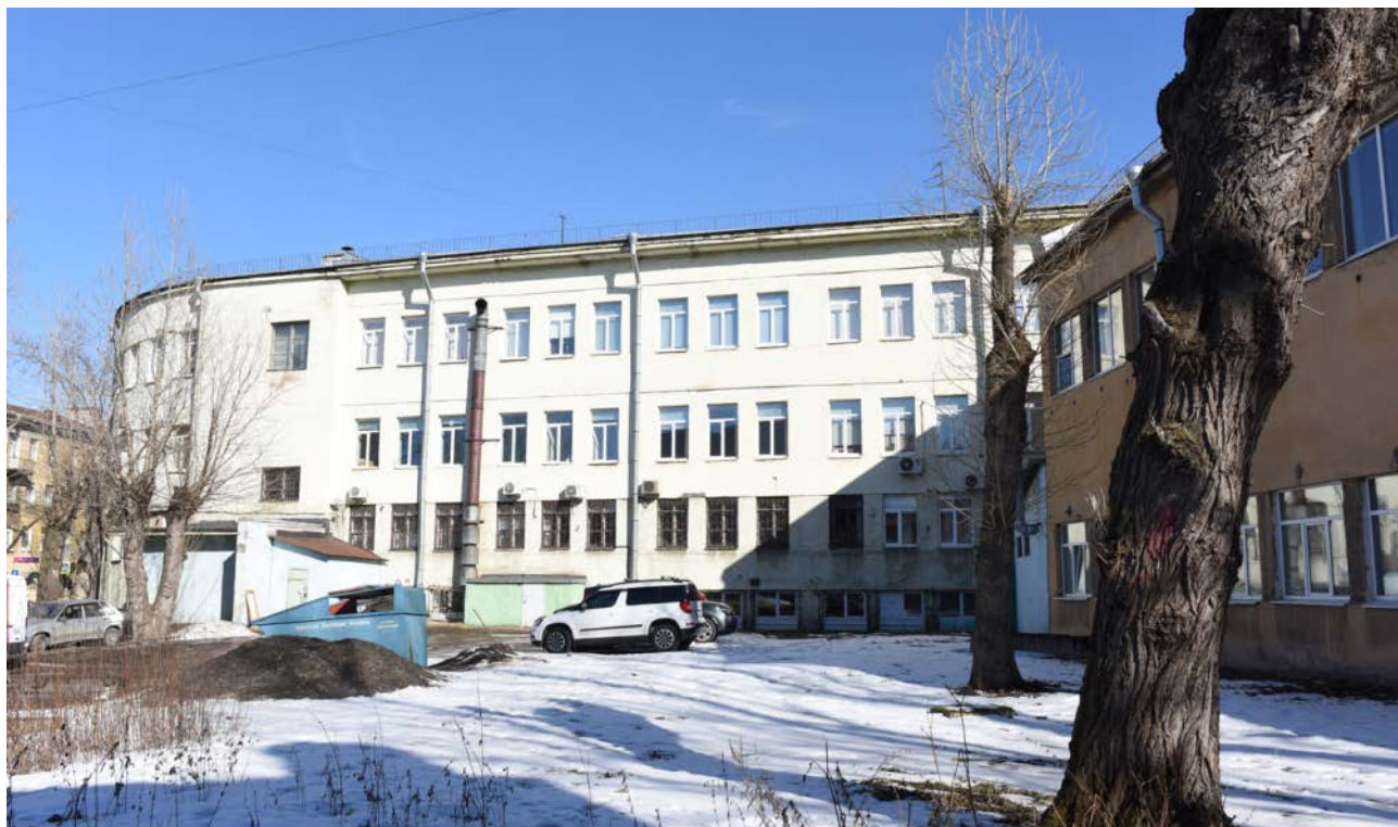
Фото 16. Выявленный ОКН «Здание школы». Фрагмент западного фасада.
