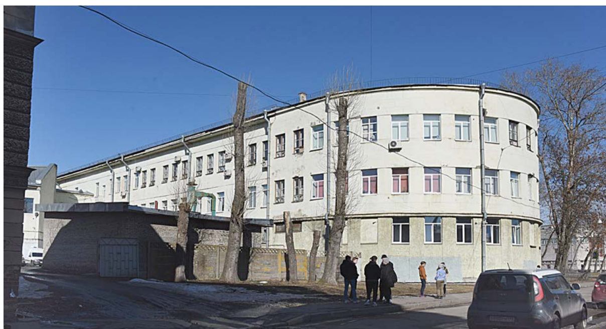
Фото 9. Выявленный ОКН «Здание школы». Общий вид западного фасада. Вид с пер. Урюпина.
