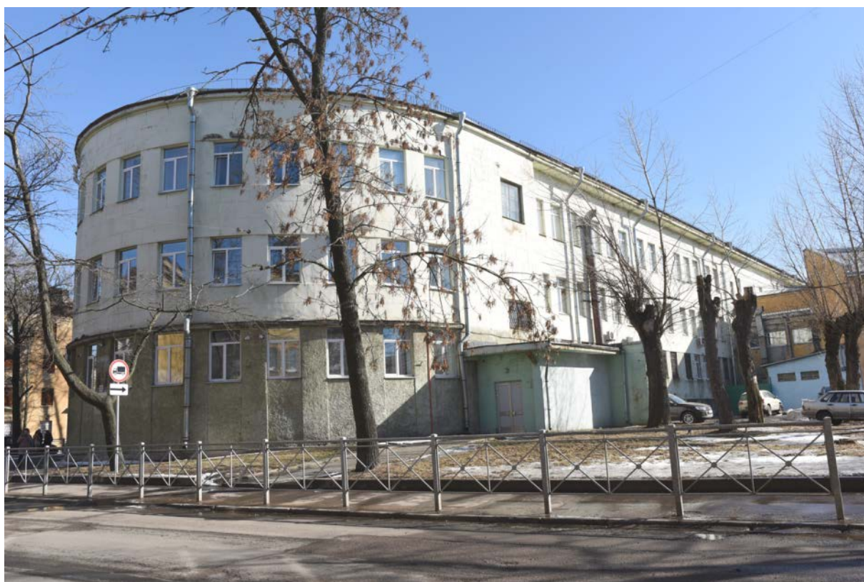
Фото 15. Выявленный ОКН «Здание школы». Общий вид западного фасада. Вид с северо-запада..
