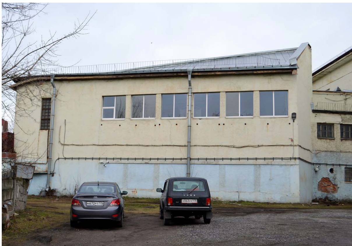
Фото 13. Выявленный ОКН «Здание школы». Фрагмент южного фасада.
