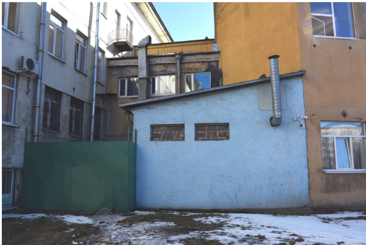
Фото 18. Выявленный ОКН «Здание школы». Фрагмент северного фасада.
