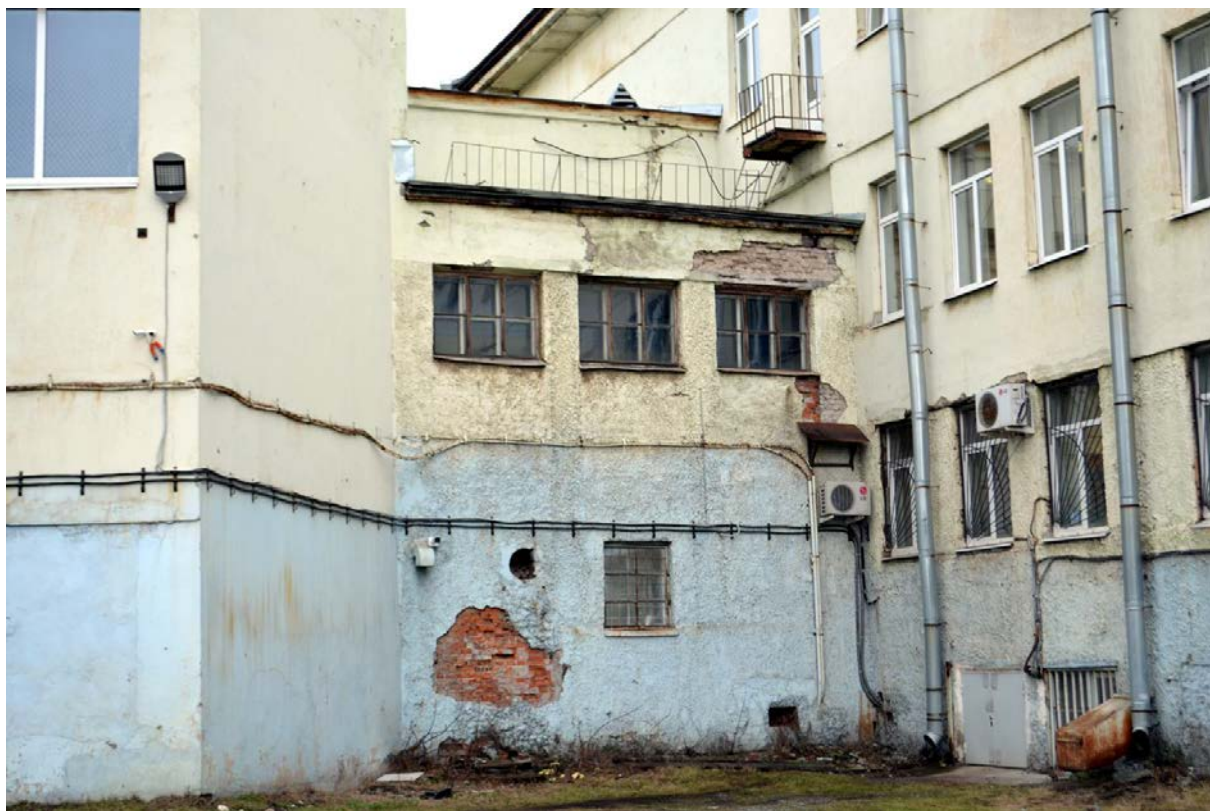
Фото 12. Выявленный ОКН «Здание школы». Фрагмент южного фасада.
