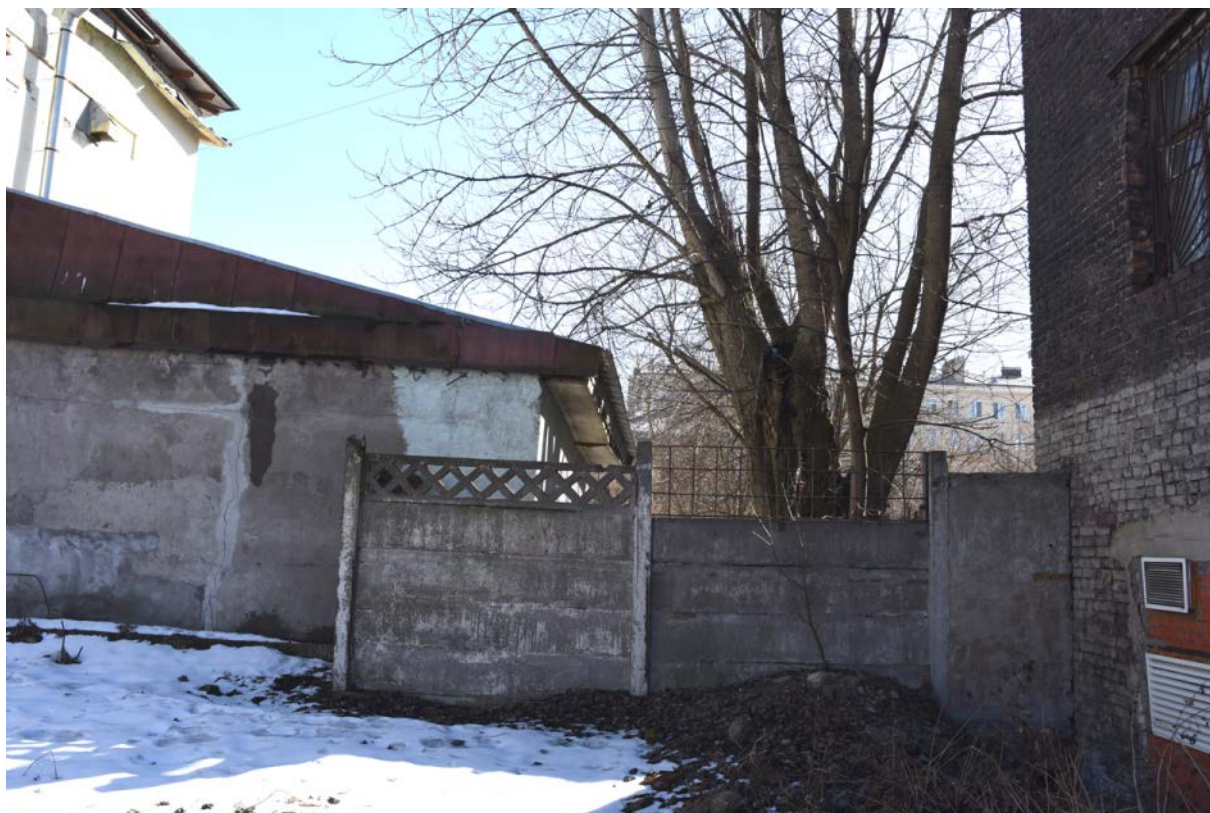
Фото 20. Выявленный ОКН «Здание школы». Фрагмент северного фасада.
