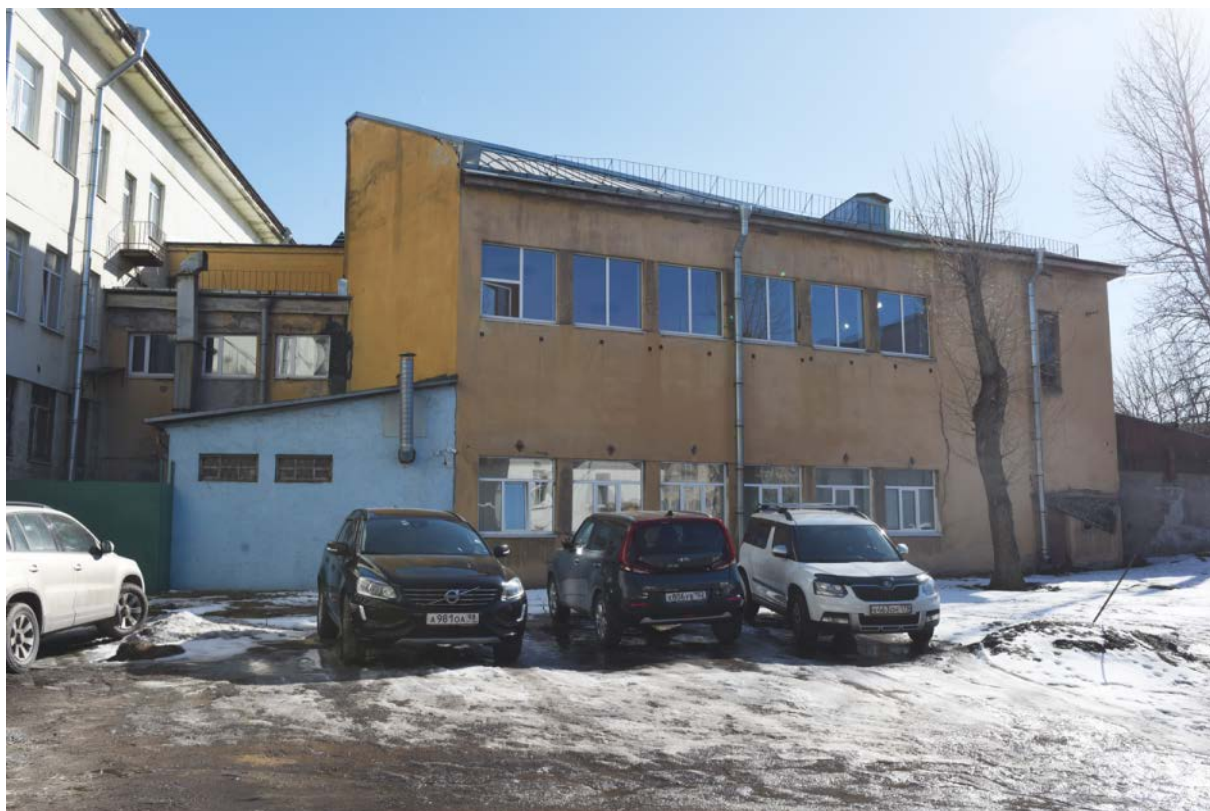
Фото 17. Выявленный ОКН «Здание школы». Фрагмент северного фасада.
