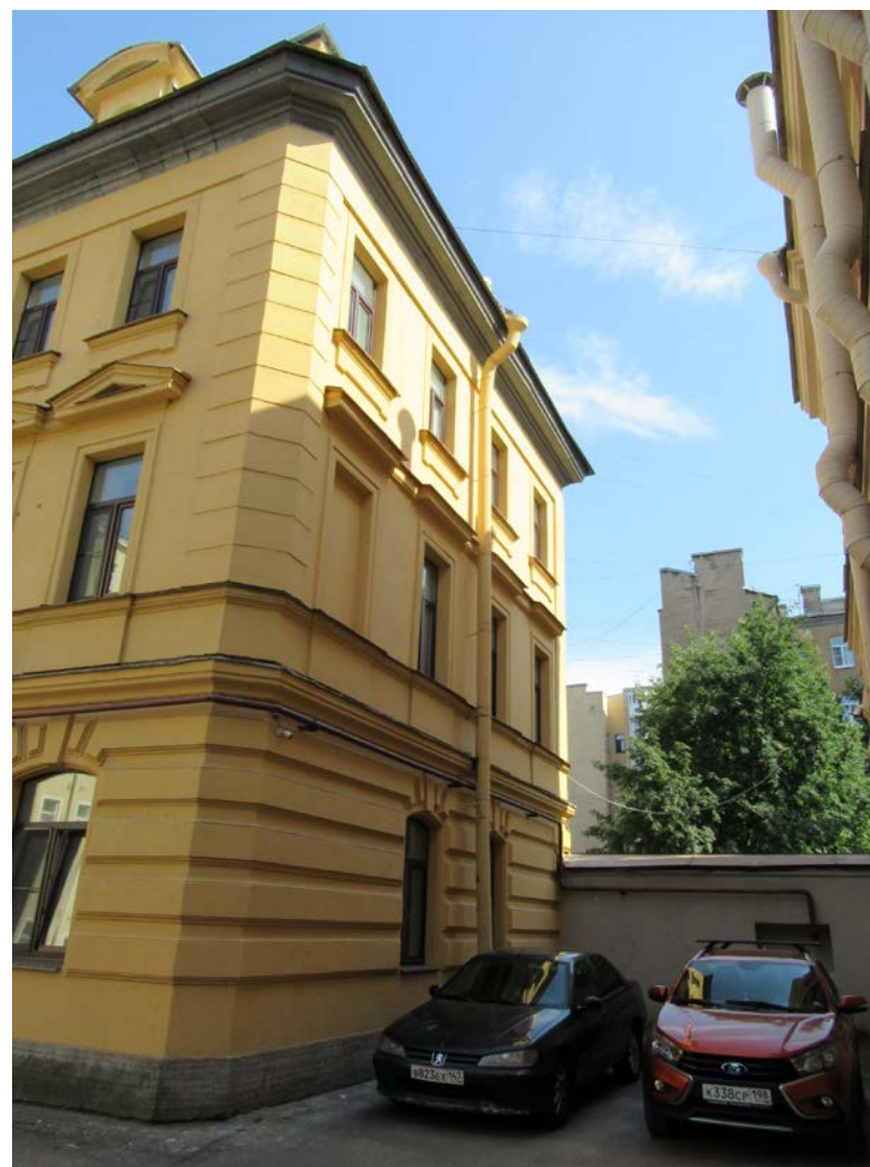
23. 12-я линия В.О., 25; Средний пр. В.О., 48, лит.Б. Флигель, входящий в состав ОКН «Дома В.Н. фон Дервиз». Общий вид на юго-западный фасад с северо-запада.
