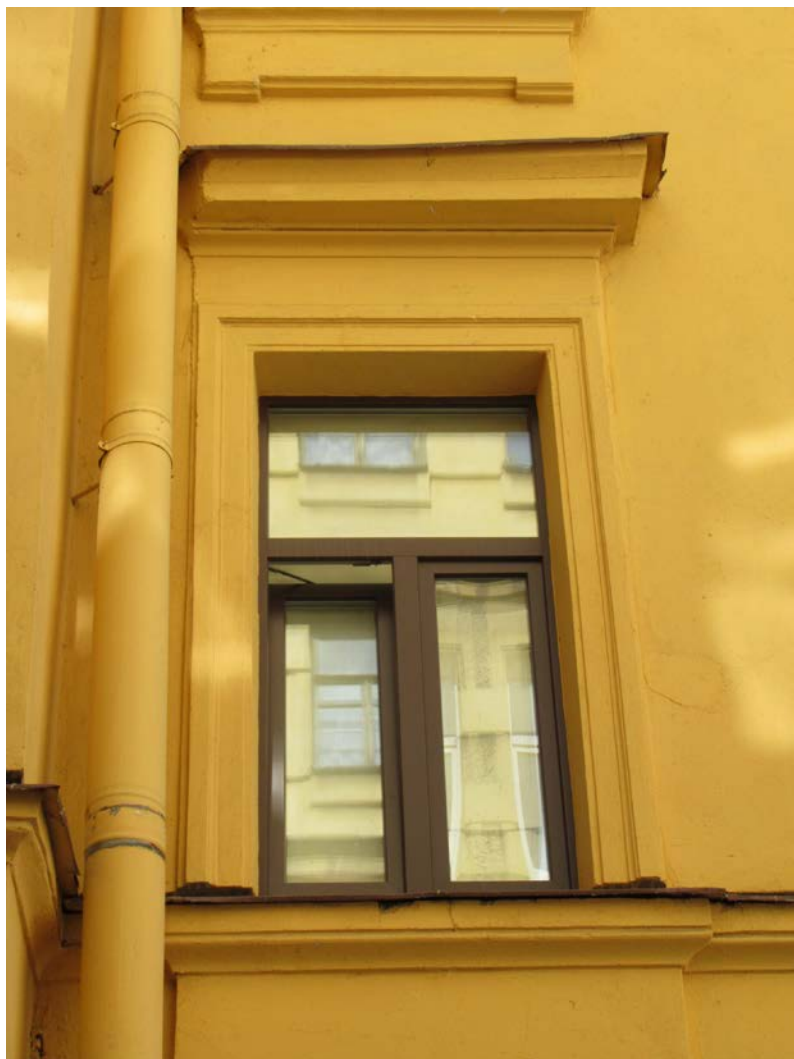
22. 12-я линия В.О., 25; Средний пр. В.О., 48, лит.Б. Флигель, входящий в состав ОКН «Дома В.Н. фон Дервиз». Северо-восточный фасад, оконный проем лестницы между 1-м и 2-м этажами.
