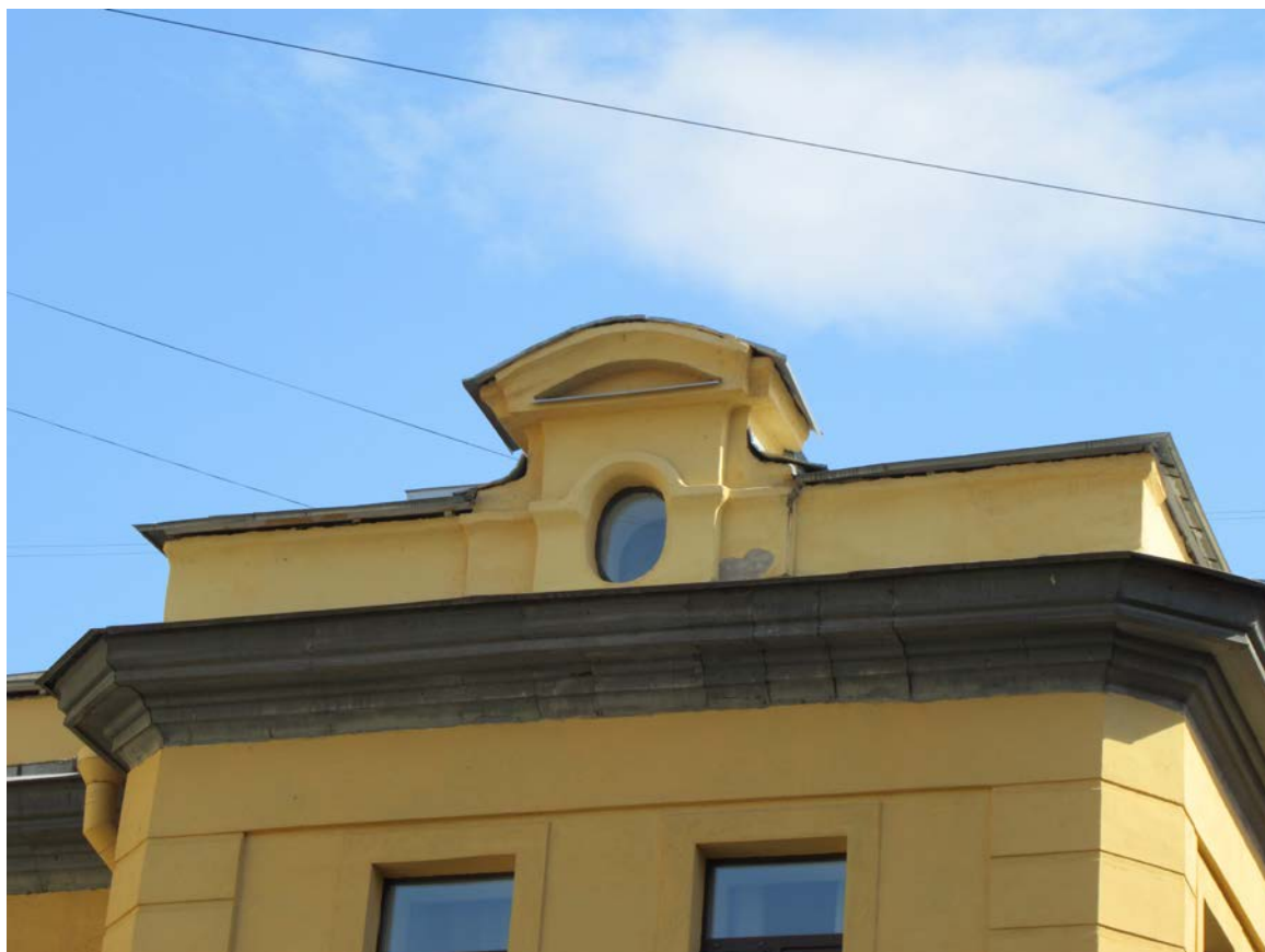
7. 12-я линия В.О., 25; Средний пр. В.О., 48, лит.Б. Флигель, входящий в состав ОКН «Дома В.Н. фон Дервиз». Фронтон западного ризалита лицевого фасада.
