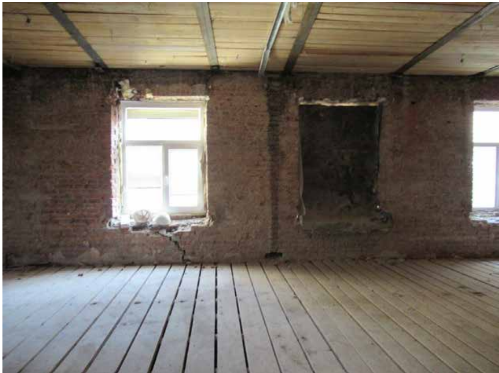
Илл. 57. 4-й этаж. Помещение 86. Съемка 02.04.2021 г. Трушковский В. Э.
