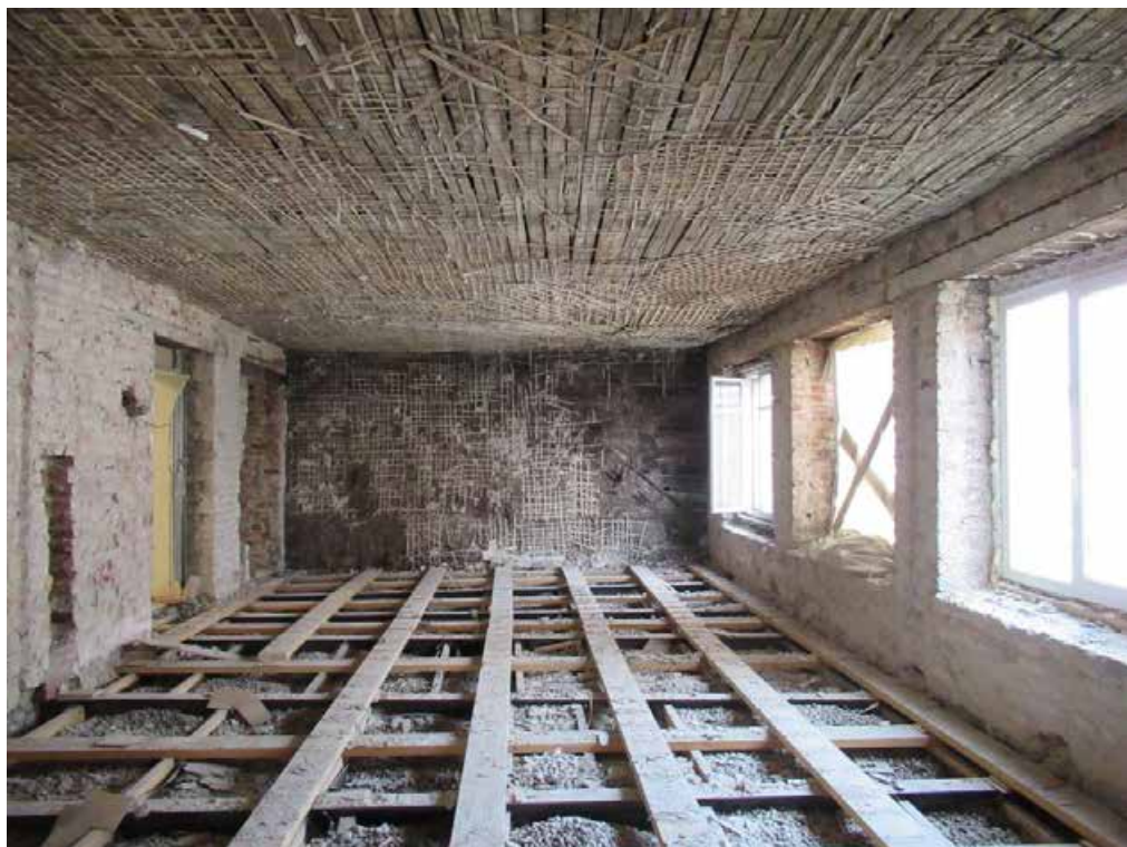
Илл. 68. 5-й этаж. Помещение 109; 110; 111. Съемка 02.04.2021 г. Трушковский В. Э.
