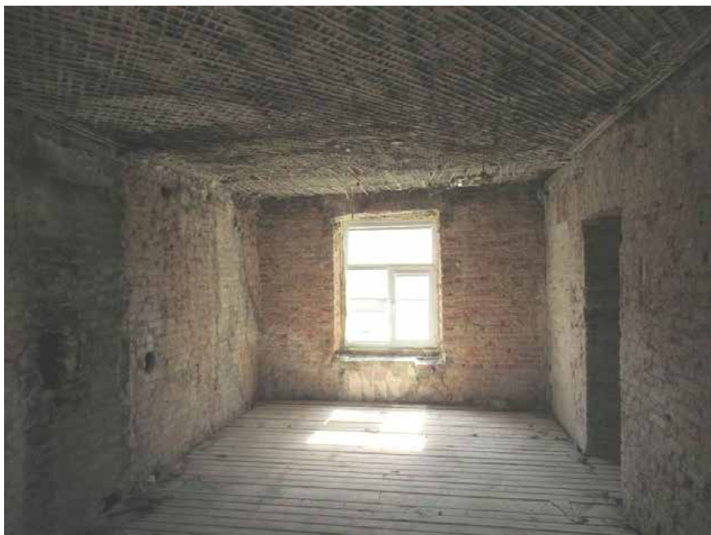
Илл. 60. 4-й этаж. Помещение 85; 82. Съемка 02.04.2021 г. Трушковский В. Э.
