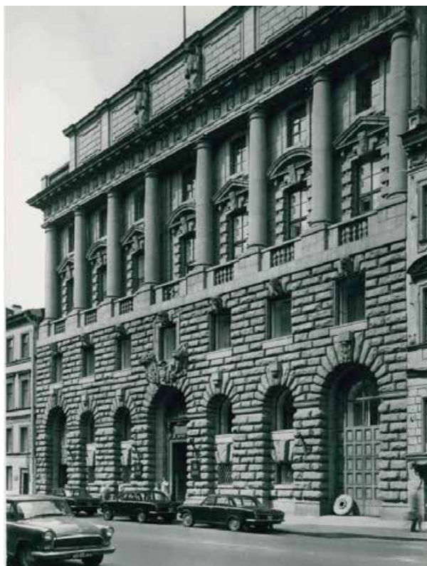
Илл. 39. Фасад дома № 15 по ул. Герцена (Б. Морской). КГИОП. 1974. нег 46080.
