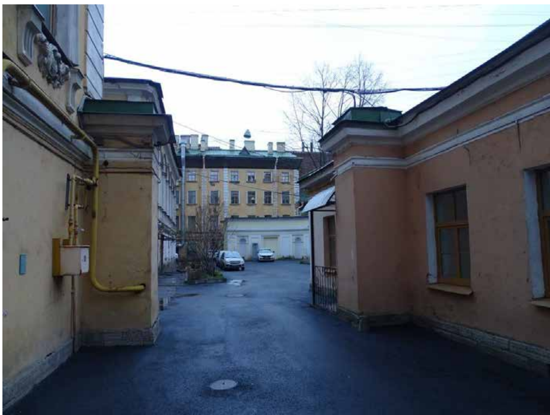
Илл. 04. Здание по адресу: по адресу: г. Санкт-Петербург, Малая Морская улица, дом 10, литера А. Территория внутреннего двора. Съемка 02.04.2021 г. Трушковский В. Э.
