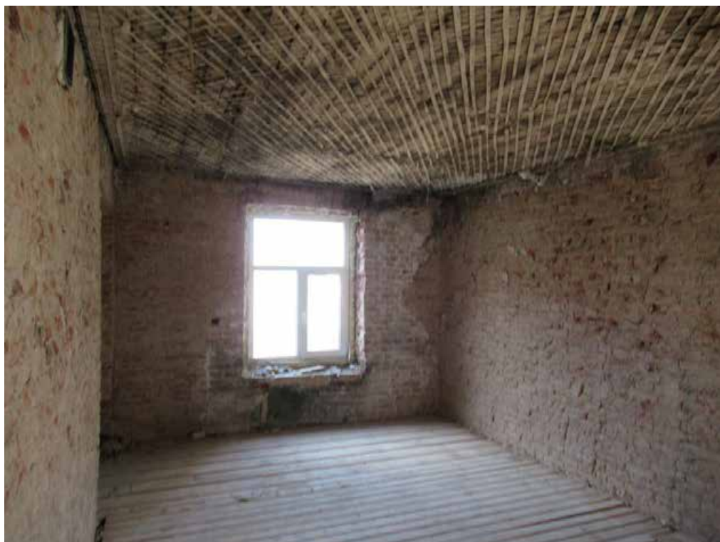
Илл. 59. 4-й этаж. Помещение 85; 82. Съемка 02.04.2021 г. Трушковский В. Э.
