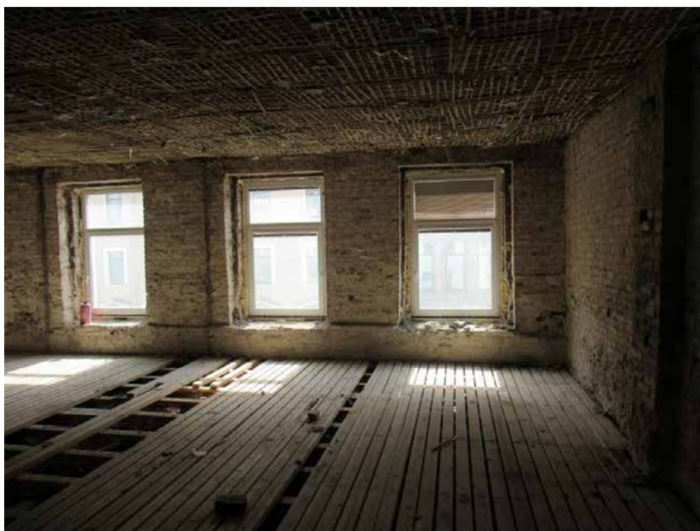
Илл. 63. 4-й этаж. Помещение 90; 91; 89; 88. Съемка 02.04.2021 г. Трушковский В. Э.
