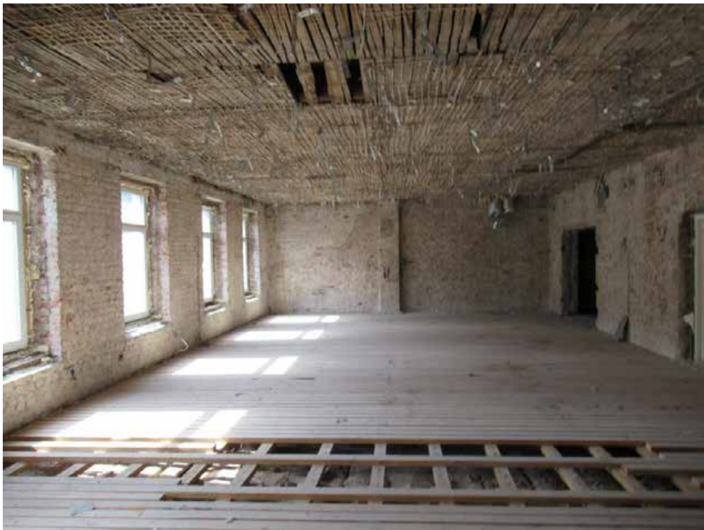
Илл. 71. 5-й этаж. Помещение 113. Съемка 02.04.2021 г. Трушковский В. Э.
