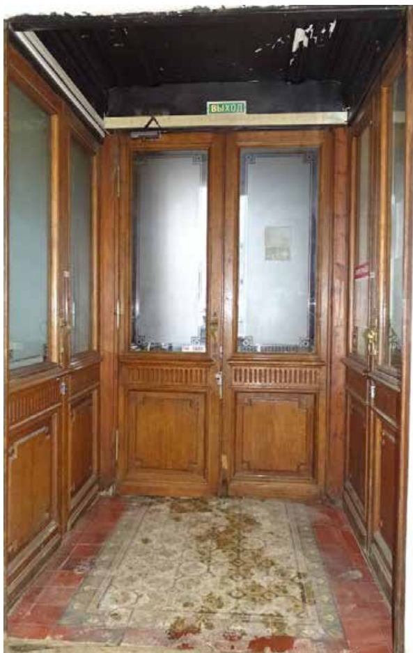
Илл. 01. 1-й этаж. Помещение тамбура и вестибюля. Съемка 02.04.2021 г. Трушковский В. Э.
