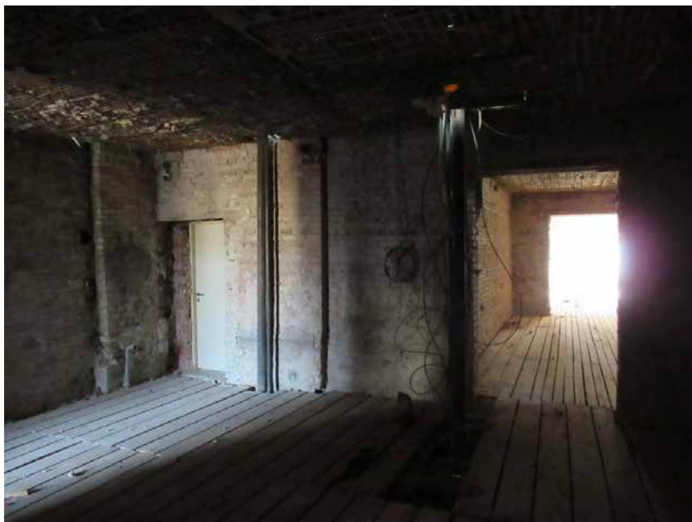
Илл. 61. 4-й этаж. Помещение 98. Съемка 02.04.2021 г. Трушковский В. Э.
