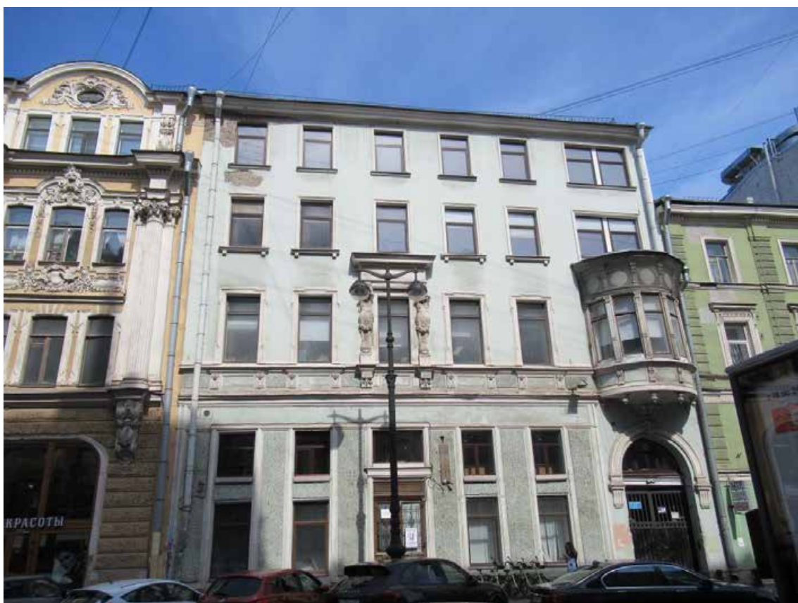
Илл. 02. Здание по адресу: г. Санкт-Петербург, ул. Большая Морская д. 19, литера А. Лицевой фасад. Съемка 02.04.2021 г. Трушковский В. Э.
