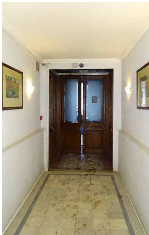
Илл. 02. 1-й этаж. Помещение тамбура и вестибюля. Съемка 02.04.2021 г. Трушковский В. Э.
