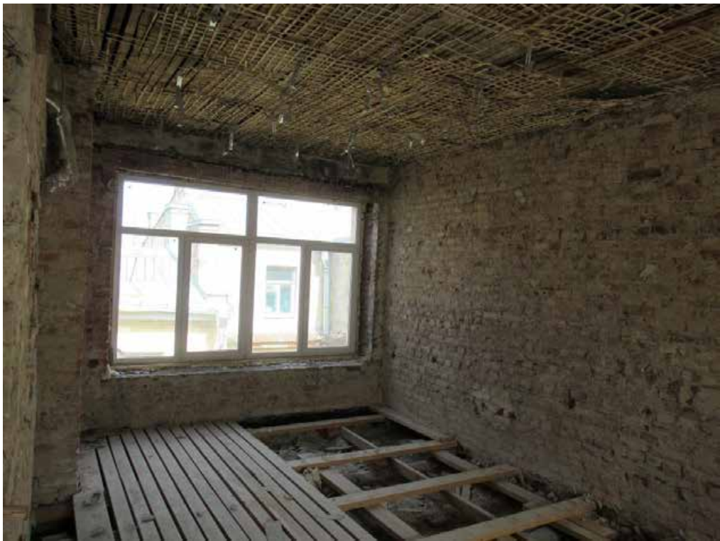
Илл. 70. 5-й этаж. Помещение 112. Съемка 02.04.2021 г. Трушковский В. Э.
