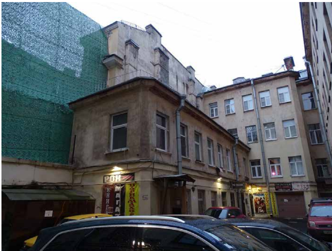
Илл. 03. Здание по адресу: по адресу: г. Санкт-Петербург, Большая Морская улица, дом 21, литера А. Внутренний двор. Съемка 02.04.2021 г. Трушковский В. Э.
