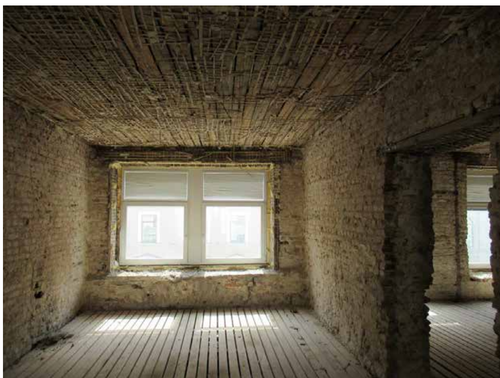
Илл. 66. 4-й этаж. Помещение 87. Съемка 02.04.2021 г. Трушковский В. Э.
