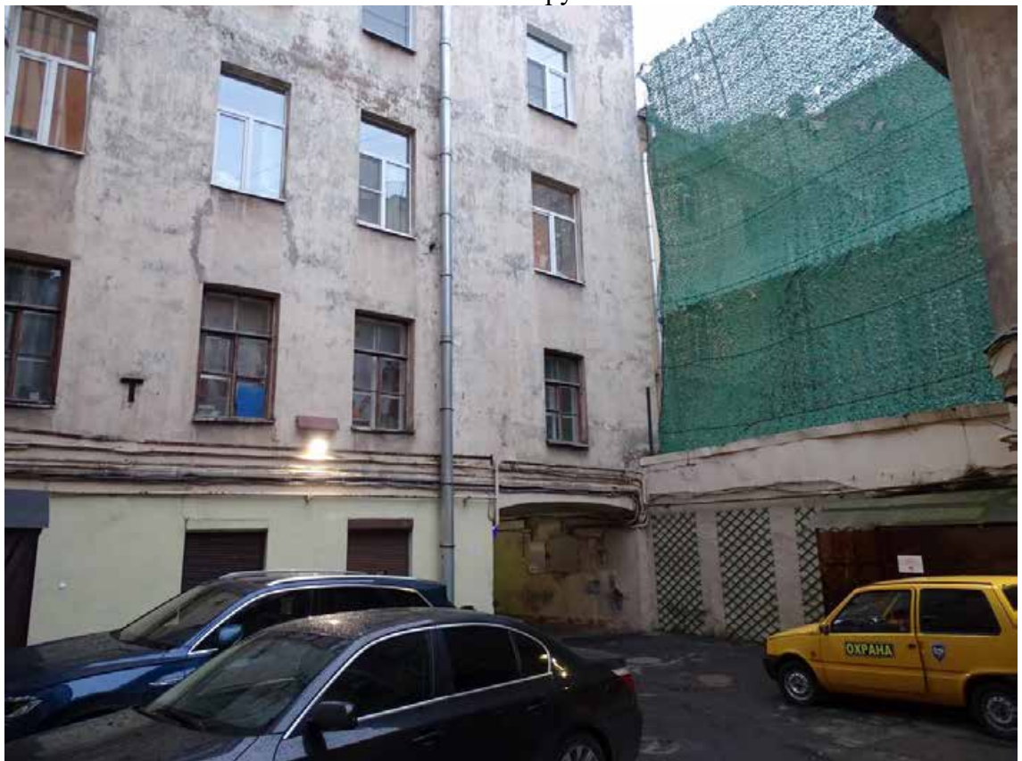
Илл. 02. Здание по адресу: по адресу: г. Санкт-Петербург, Большая Морская улица, дом 21, литера А. Лицевой корпус. Вид со стороны внутреннего двора. Съемка 02.04.2021 г. Трушковский В. Э.
