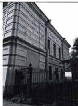
вентиляционные отверстия с металлическими козырьками в уровне 1-ого этажа (вентиляция помещений с печами для смальтоварения);
