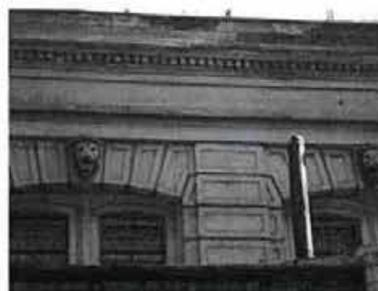
профилированная тяга в уровне 1-го этажа, обводящая верхнюю часть оконных проемов наподобие наличников;
