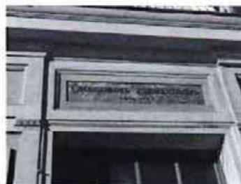
дверное заполнение главного входа – материал (дуб), рисунок (двустворчатое, полусветлое с четырехчастной остекленной фрамугой, створки – филёнчатые, правая створка имеет малую одностворчатую дверь; сандрик дубовый резной, с ложчатым орнаментом и карнизом с пояском остролиста; над дверью фрамуга на четыре стекла);
