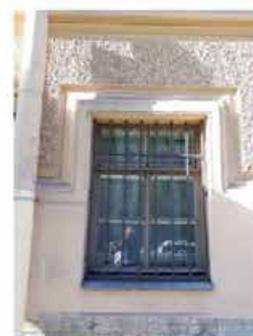
оконные проемы 1-го этажа - кованые решетки из вертикальных прутьев, с копьевидными завершениями;
