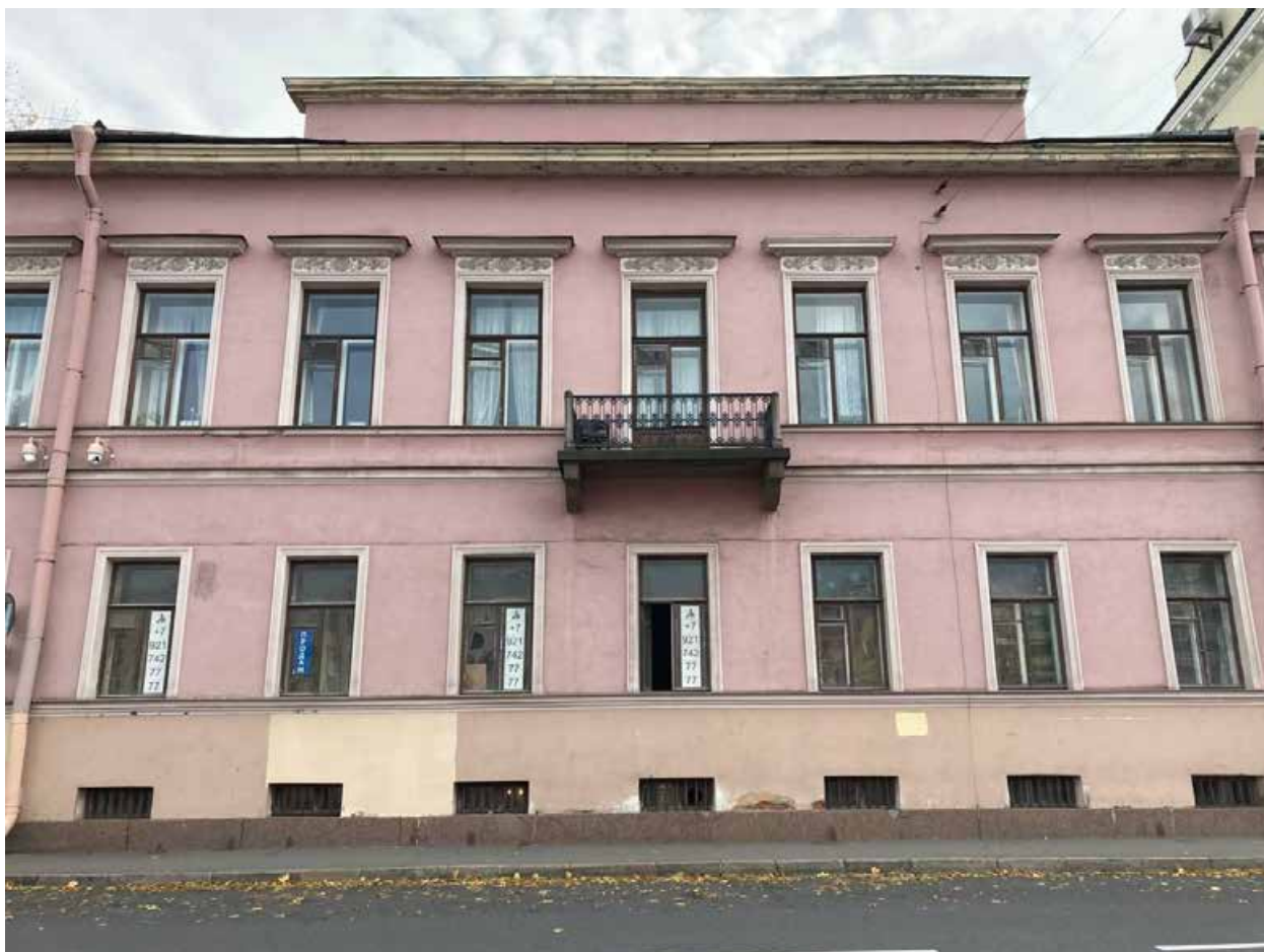
Фото 01. Вид на северный фасад лицевого корпуса с четной стороны наб. р. Фонтанки (Санкт-Петербург, набережная реки Фонтанки, дом 130). Съемка: Богомаз К.М.
