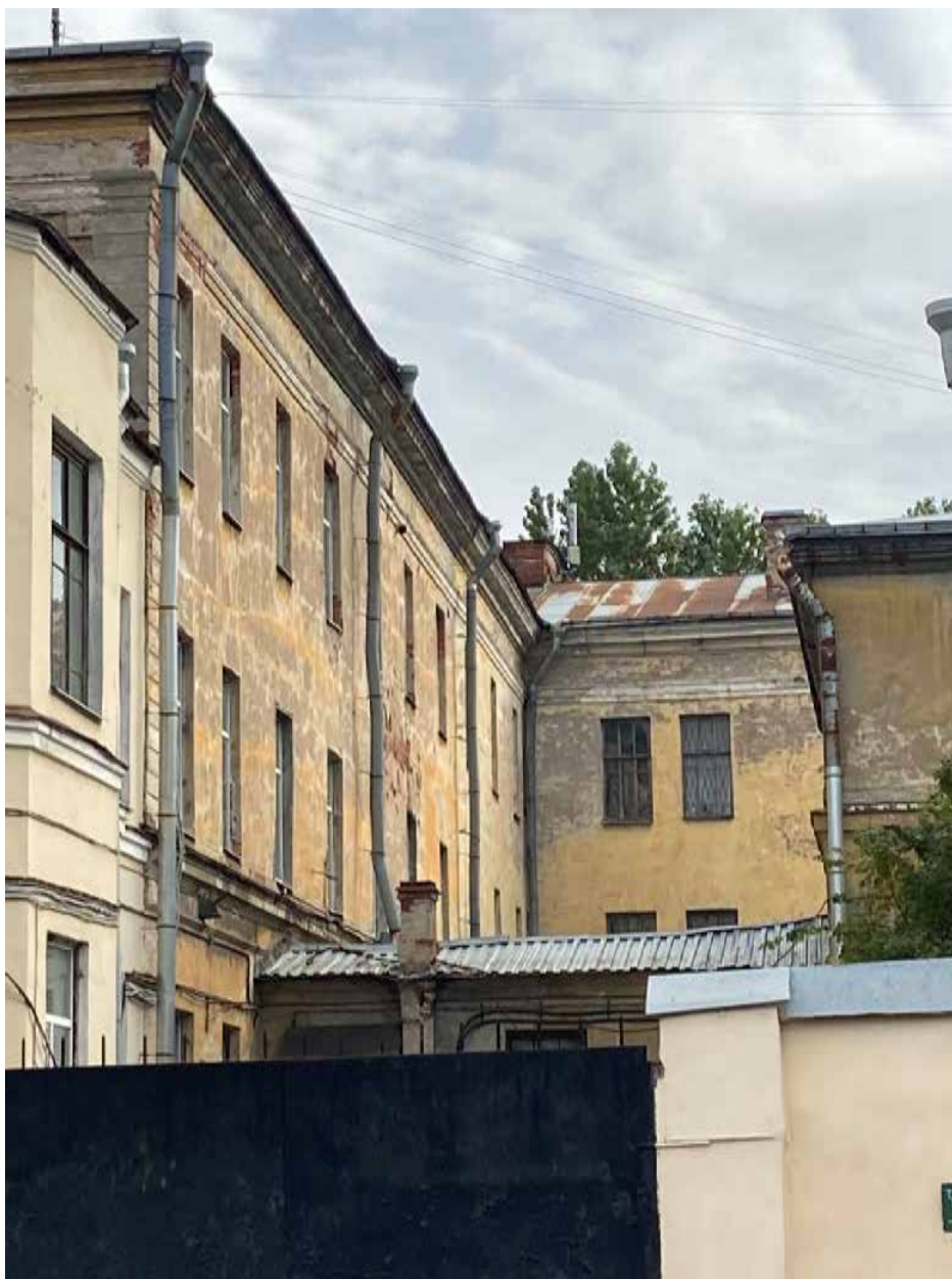
Фото 15. Вид на западный фасад главного корпуса с четной стороны наб. р. Фонтанки. (Санкт-Петербург, Троицкий пр., 1-3; Фонтанки р. наб., 132). Съемка: Богомаз К.М.
