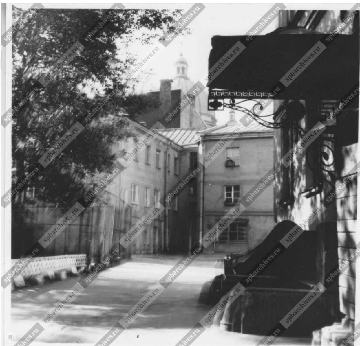
27. Двор дома № 130 по набережной Фонтанки (двор особняка П.А. Поповой, архитектор А.И. Мельников, 1822 -1825 гг.). Июль 1970 г. ЦГАКФФД СПб Шифр: Бр 72987.
