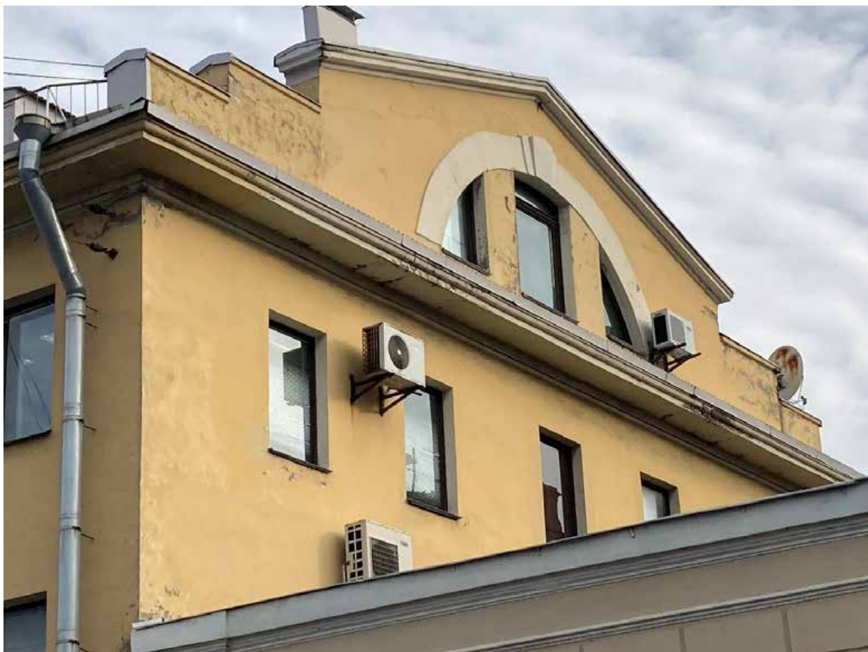
Фото 05. Вид на западный фасад. (Санкт-Петербург, набережная реки Фонтанки, дом 132, литера 3). Съемка: Богомаз К.М.
