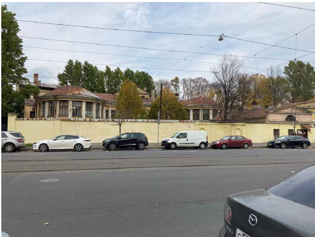
Фото 20. Вид на ограду и «Здание аптеки и первого больничного здания по пр. Москвиной» с нечетной стороны Троицкого пр. (Санкт-Петербург, Фонтанки р. наб., 132Б). Съемка: Богомаз К.М.
