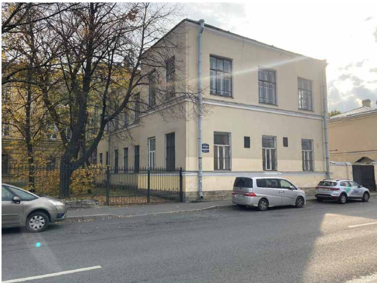
Фото 12. Вид на лицевой (северный) фасад флигеля, примыкающего справа к главному корпусу с четной стороны наб. р. Фонтанки. (Санкт-Петербург, Троицкий пр., 1-3; Фонтанки р. наб., 132). Съемка: Богомаз К.М.
