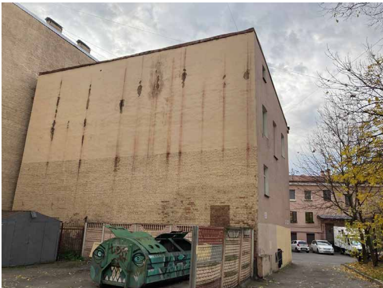
Фото 20. Вид на бранмауэр флигеля, расположенного в восточной границе участка. (Санкт-Петербург, набережная реки Фонтанки, дом 130). Съемка: Богомаз К.М.
