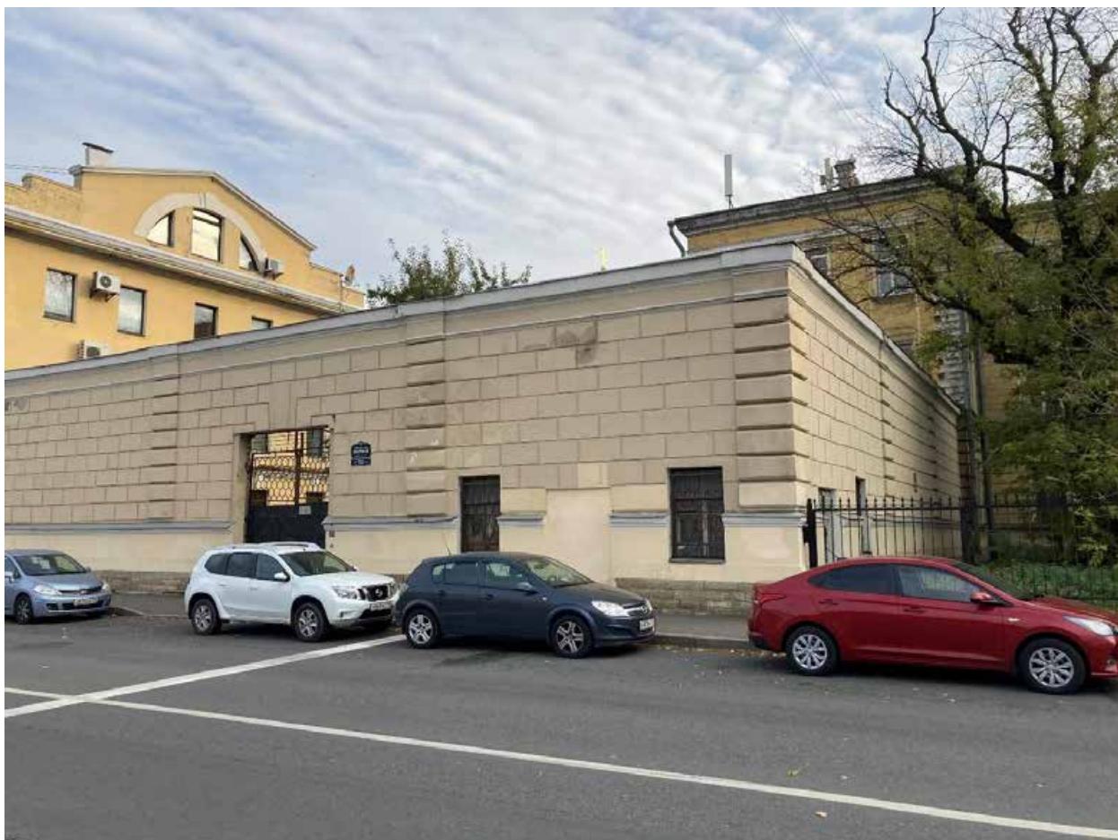
Фото 06. Вид на западный фасад. (Санкт-Петербург, набережная реки Фонтанки, дом 132, литера 3). Съемка: Богомаз К.М.
