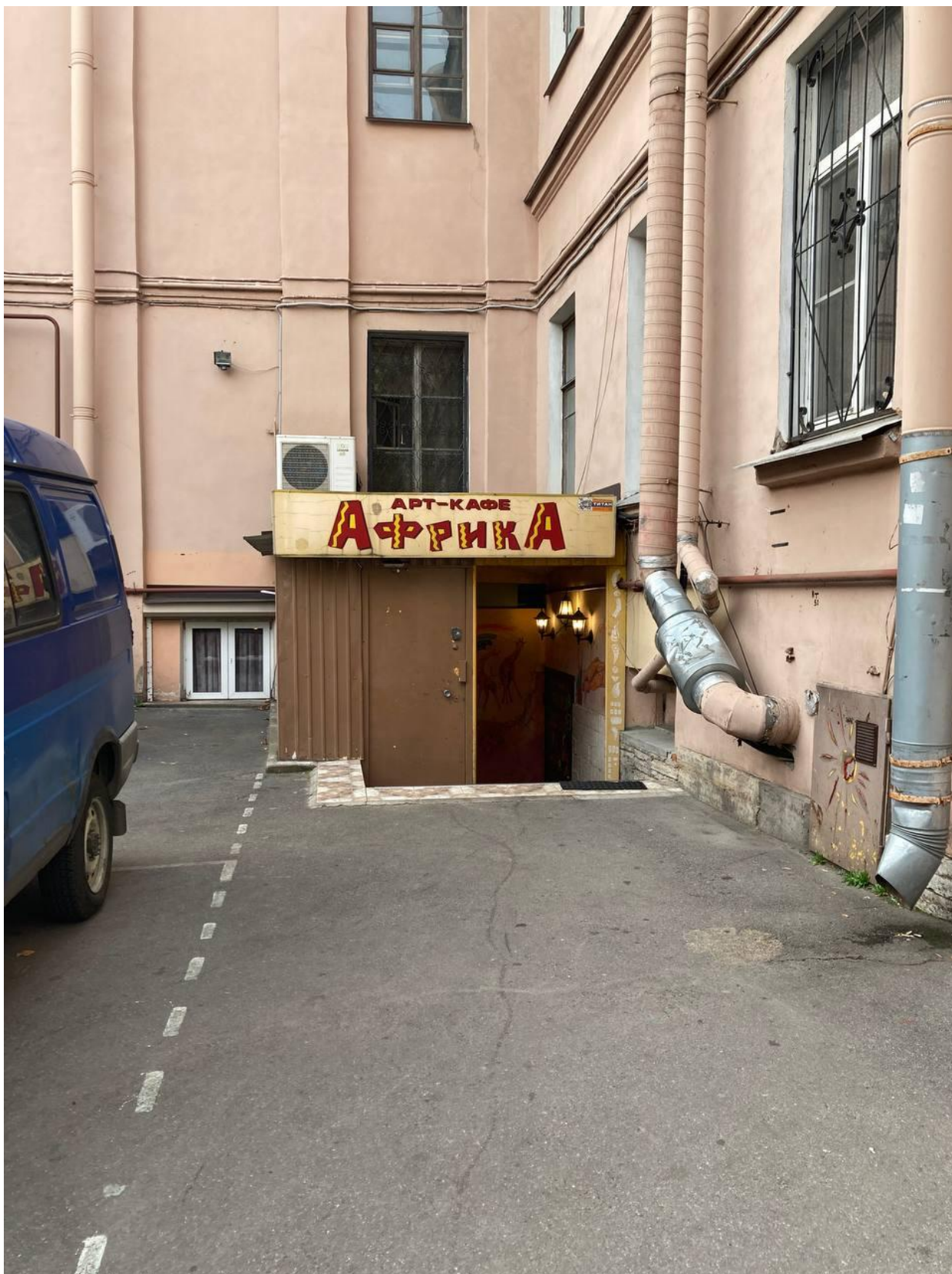
Фото 11. Вид со двора на пристройку к флигелю, расположенному в западной границе участка. (Санкт-Петербург, набережная реки Фонтанки, дом 130). Съемка: Богомаз К.М.
