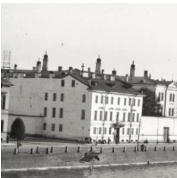
Фрагмент с домом Яковлевой.
