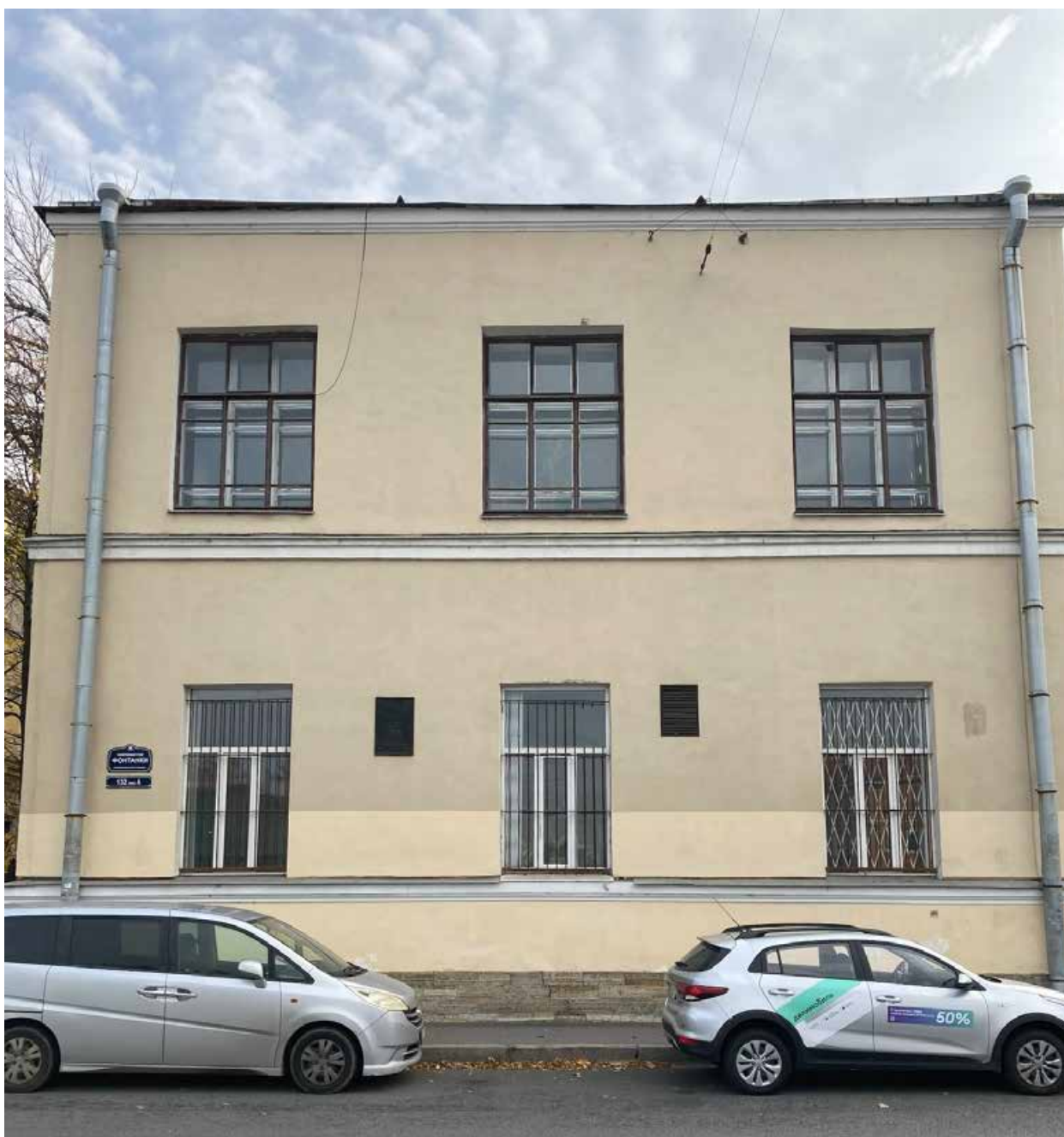
Фото 13. Вид на лицевой (северный) фасад флигеля, примыкающего справа к главному корпусу с четной стороны наб. р. Фонтанки. (Санкт-Петербург, Троицкий пр., 1-3; Фонтанки р. наб., 132). Съемка: Богомаз К.М.
