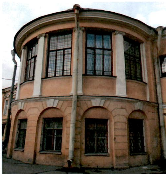
9. Фрагмент южного лицевого фасада здания.
