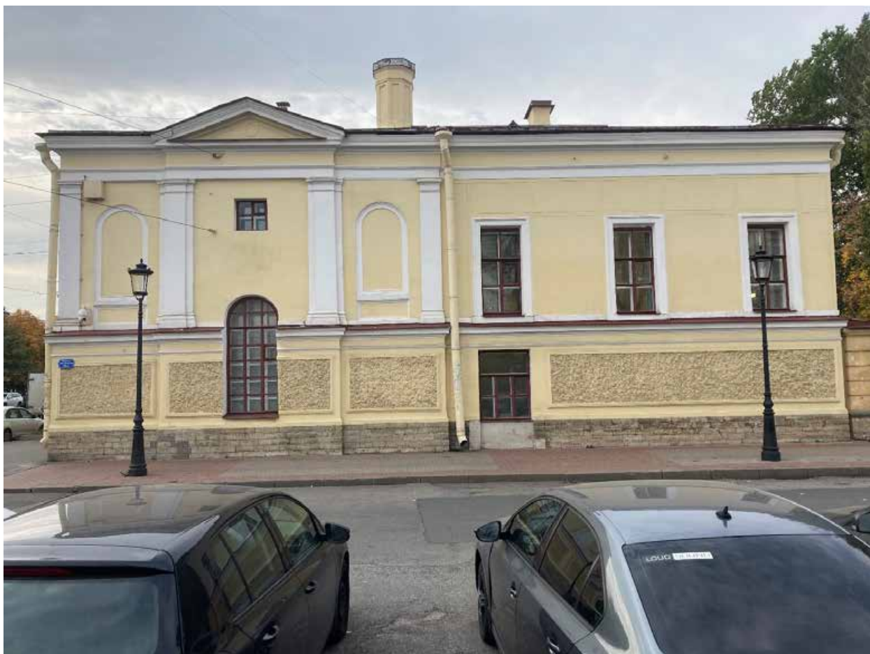
Фото 32. Вид на юго-восточный фасад «Часовни у Троицкого собора» с нечетной стороны Троицкого пр. (Фонтанки р. наб., 132Д). Съемка: Богомаз К.М.
