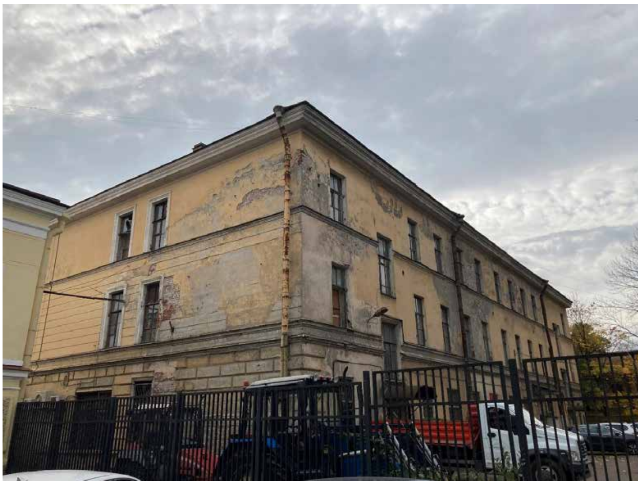
Фото 36. Вид на северный фасад флигеля с нечетной стороны Троицкого пр. (Фонтанки р. наб., 132Г). Съемка: Богомаз К.М.
