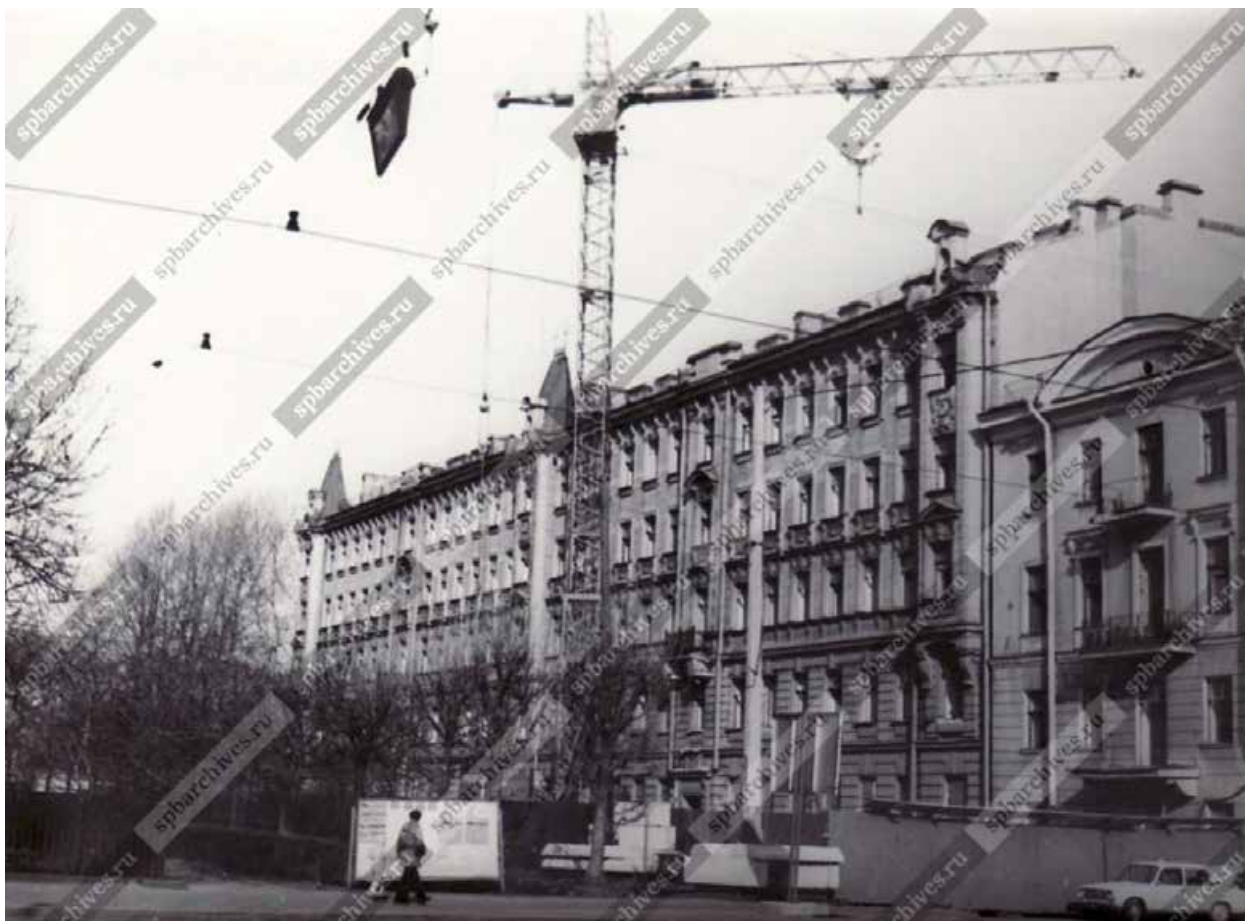
14. Вид фасада дома № 7 по Измайловскому проспекту во время реставрации (архитекторы М.Ф. Петерсон, 1876 -1877 гг. и А.С. Пронин, 1901-1902 гг.). 17 апреля 1983 г. ЦГАКФФД СПб. Шифр: Ар 217712.
