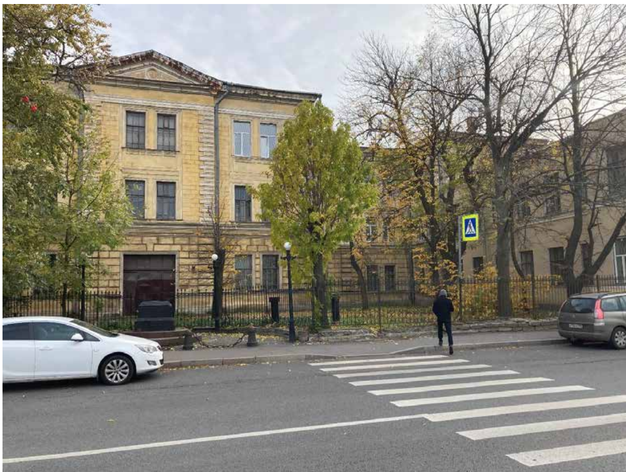
Фото 10. Вид на (северный) фасад главного корпуса с четной стороны наб. р. Фонтанки. (Санкт-Петербург, Троицкий пр., 1-3; Фонтанки р. наб., 132). Съемка: Богомаз К.М.
