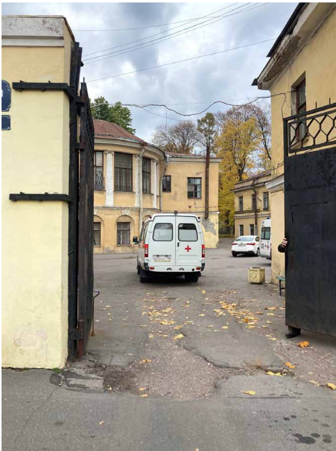
Фото 25. Вид на лицевой фасад «Здания аптеки и первого больничного здания по пр. Москвиной» с нечетной стороны Троицкого пр., (Санкт-Петербург, Фонтанки р. наб., 132Б). Съемка: Богомаз К.М.
