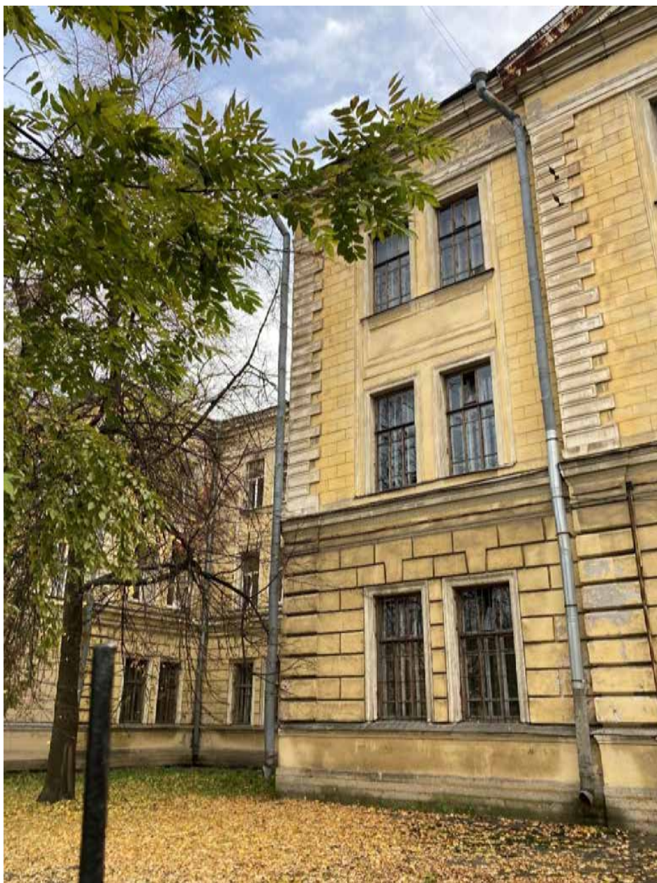
Фото 07. Вид на (северный) фасад главного корпуса с четной стороны наб. р. Фонтанки. (Санкт-Петербург, Троицкий пр., 1-3; Фонтанки р. наб., 132). Съемка: Богомаз К.М.
