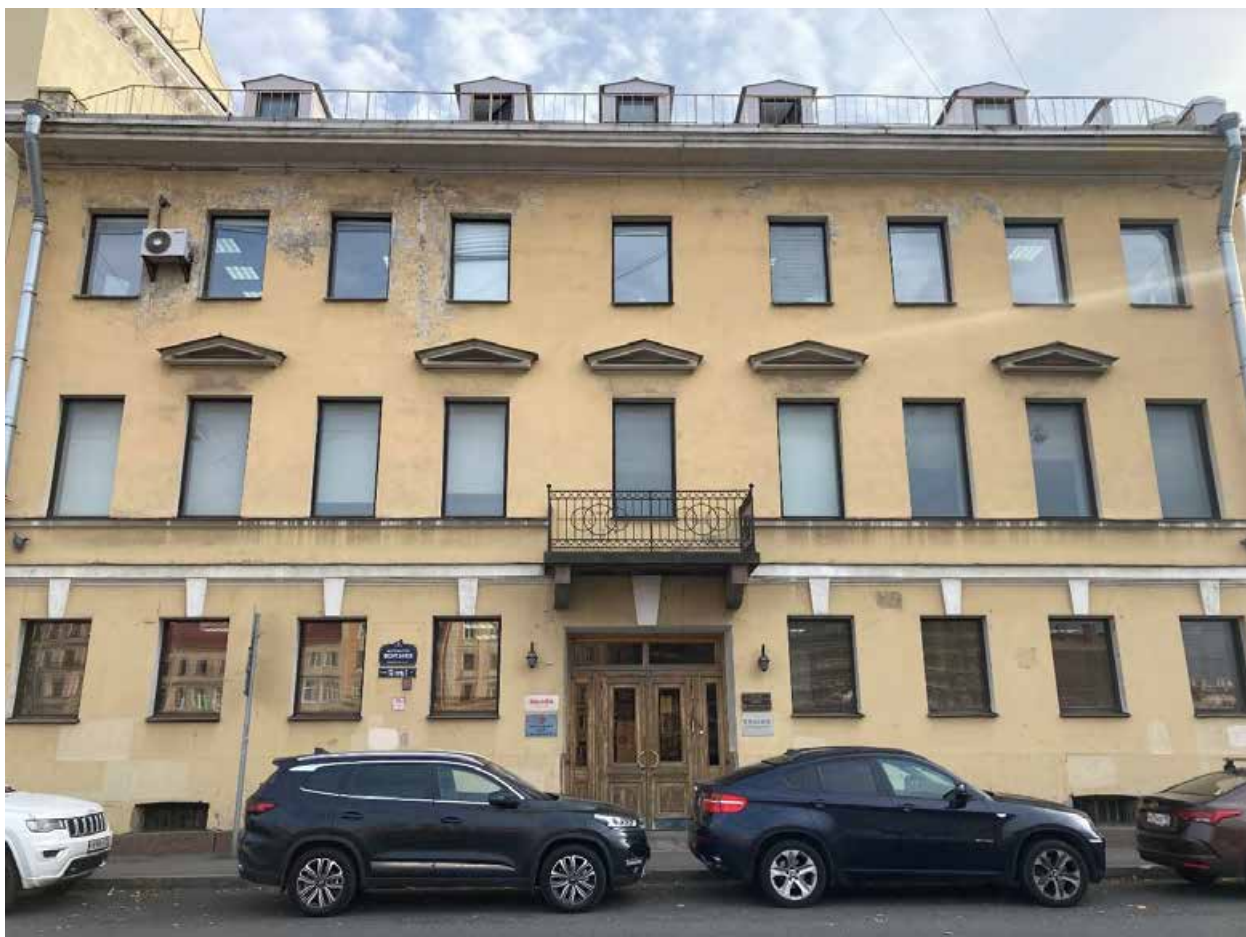
Фото 02. Вид на лицевой (северный) фасад с четной стороны наб. р. Фонтанки. (Санкт-Петербург, набережная реки Фонтанки, дом 132, литера З). Съемка: Богомаз К.М.
