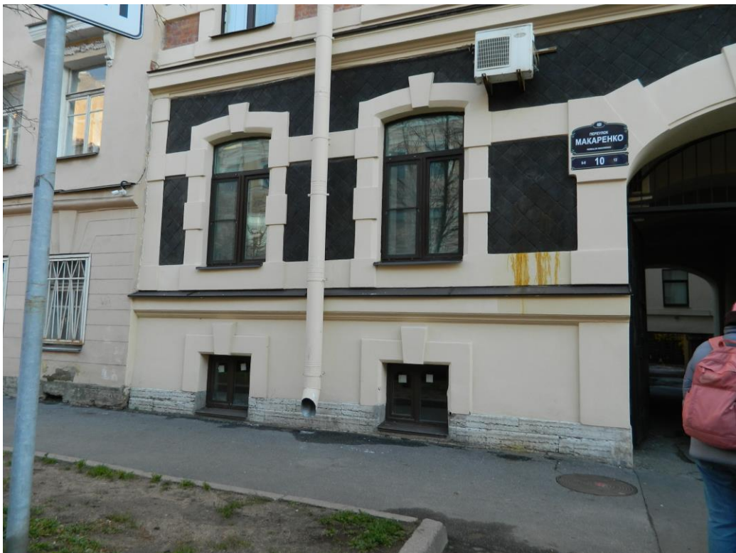
15, 16. Объект культурного наследия регионального значения «Дом А.Н. Бебутовой», расположенный по адресу: г. Санкт-Петербург, наб. Крюкова канала, д. 27, литера А, пер. Макаренко, д. 10, литера А. Лицевой западный корпус (пер. Макаренко, д. 10, литера А). Лицевой фасад. Фрагмент.
