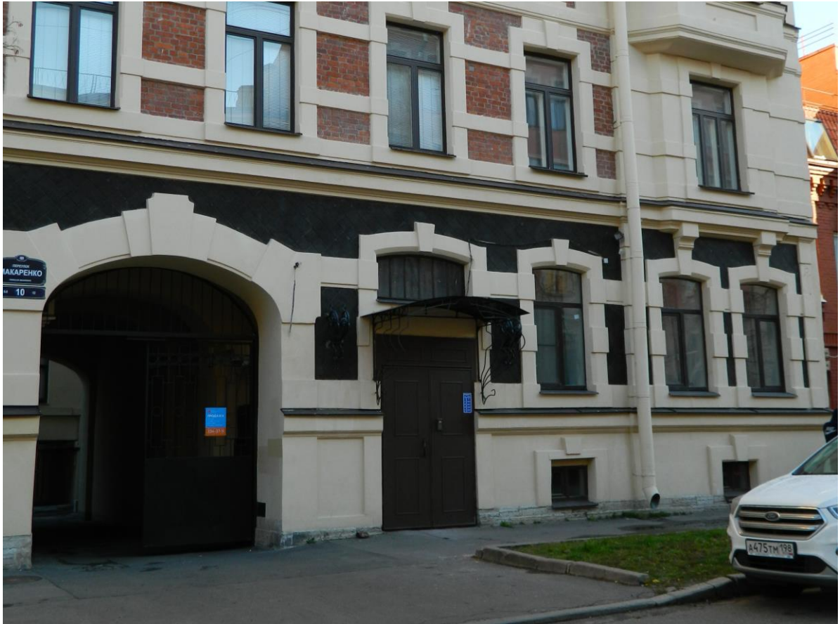
17. Объект культурного наследия регионального значения «Дом А.Н. Бебутовой», расположенный по адресу: г. Санкт-Петербург, наб. Крюкова канала, д. 27, литера А, пер. Макаренко, д. 10, литера А. Лицевой западный корпус (пер. Макаренко, д. 10, литера А). Лицевой фасад. Фрагмент. Арочный проезд и дверной проем с современным заполнением.
