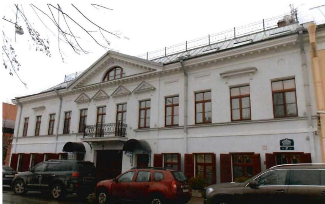
10. Фасад со стороны Крюкова канала 27.
