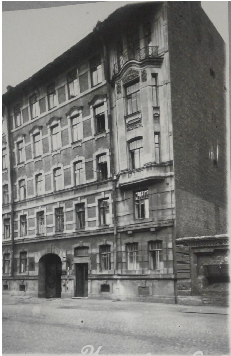
8. Усачев переулок (в наши дни переулок Макаренко). Фасад дома №10. Фотография. 1949 г. ЦГА КФФД СПб. Гр-71596.
