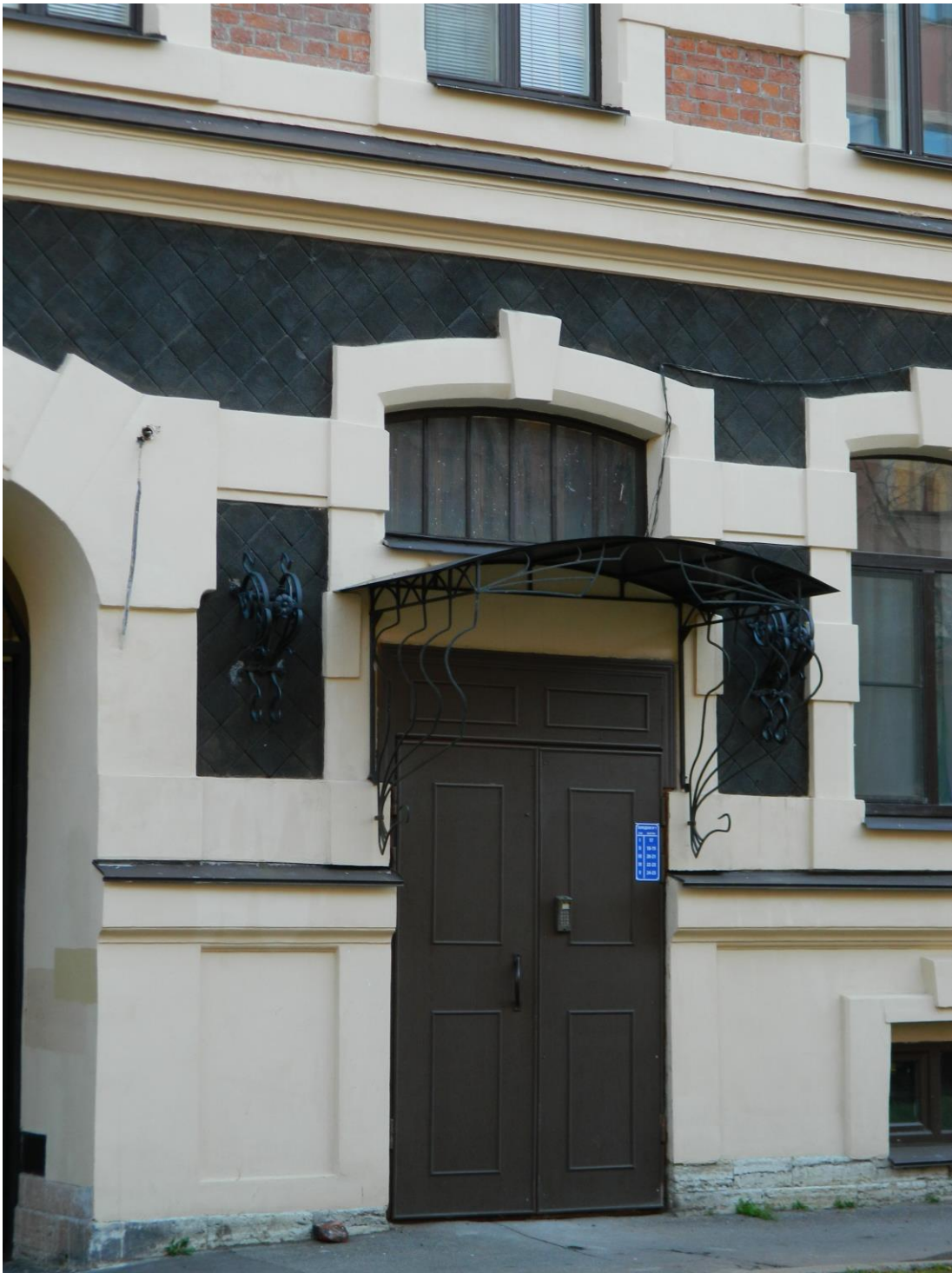
18. Объект культурного наследия регионального значения «Дом А.Н. Бебутовой», расположенный по адресу: г. Санкт-Петербург, наб. Крюкова канала, д. 27, литера А, пер. Макаренко, д. 10, литера А. Лицевой западный корпус (пер. Макаренко, д. 10, литера А). Лицевой фасад. Фрагмент. Дверной проем.
