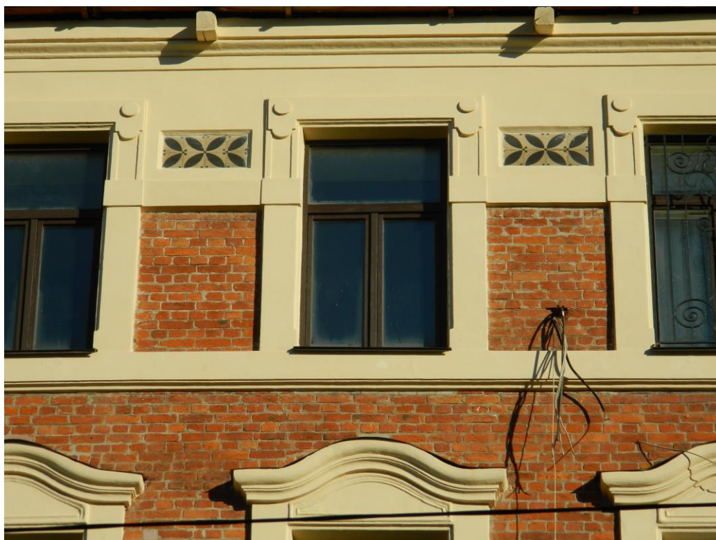
13. Объект культурного наследия регионального значения «Дом А.Н. Бебутовой», расположенный по адресу: г. Санкт-Петербург, наб. Крюкова канала, д. 27, литера А, пер. Макаренко, д. 10, литера А. Западный лицевой фасад (пер. Макаренко, д. 10, литера А). Фрагмент. Элементы декора –глазурованная плитка с монохромным рисунком в уровне 5-го этажа, в оконных простенках; оформление оконных проемов в уровне 5-го эт.
