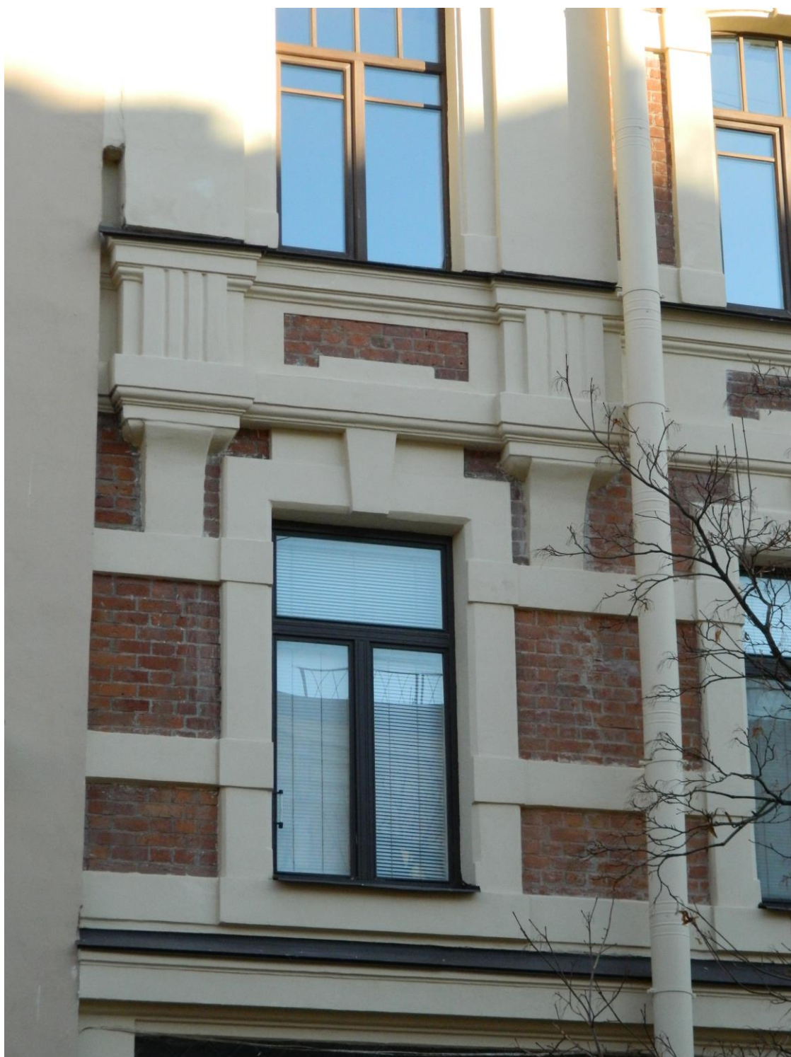
9. Объект культурного наследия регионального значения «Дом А.Н. Бебутовой», расположенный по адресу: г. Санкт-Петербург, наб. Крюкова канала, д. 27, литера А, пер. Макаренко, д. 10, литера А. Западный лицевой фасад (пер. Макаренко, д. 10, литера А). Фрагмент. Оформление фасада по 1-ой световой оси в уровне 2-го – 3-го эт.
