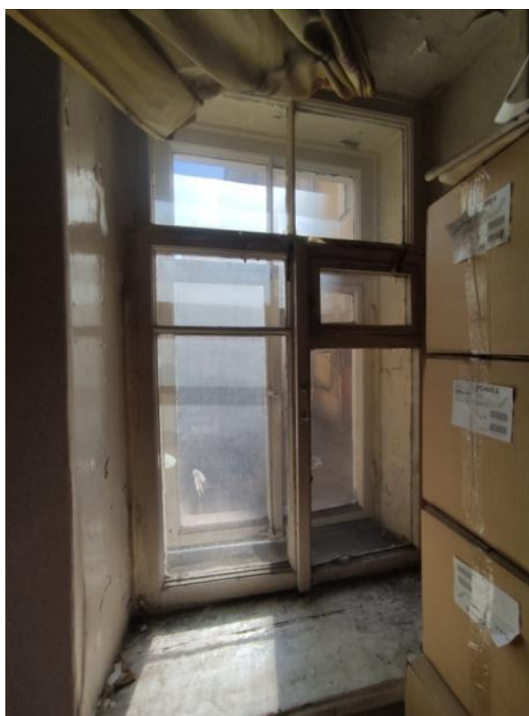
Фото 43. Оконное заполнение помещения №9 (кв.№22)
