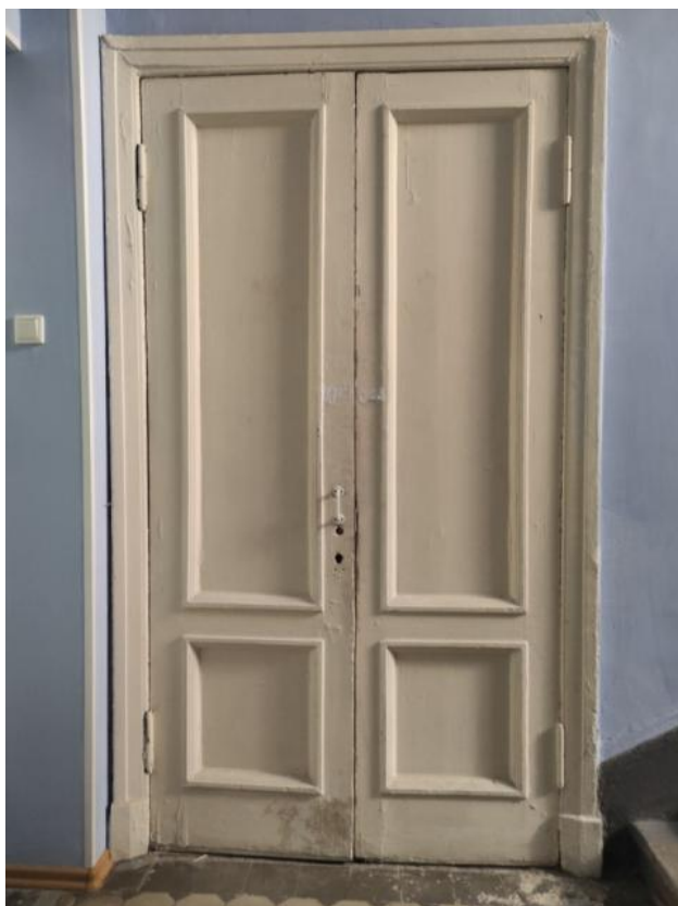
Фото 15. Дверное заполнение со стороны лестничной клетки (пом.17-Н)
