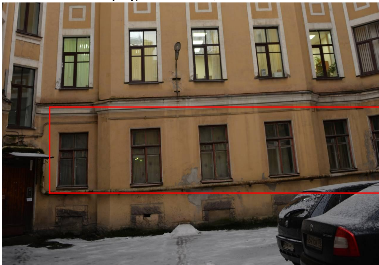
Фото 14. Оконные заполнения квартиры №22 дворового фасада выявленного объекта культурного наследия «Доходный дом»
