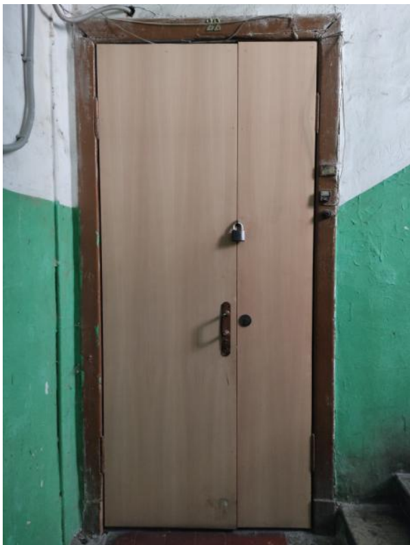
Фото 28. Дверное заполнение кв. № 22, вид с лестничной клетки
