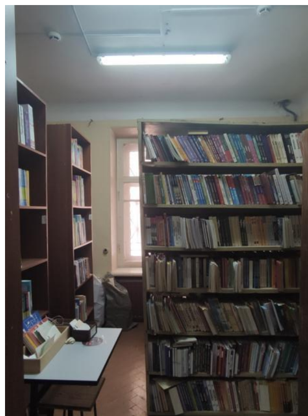
Фото 22. Интерьер ч.п.№3. Вид на оконный проем (пом.17-Н)
