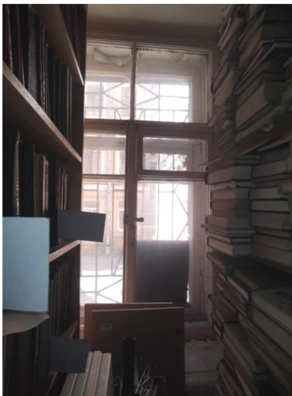
Фото 38. Оконное заполнение помещения № 6 (кв.№22)
