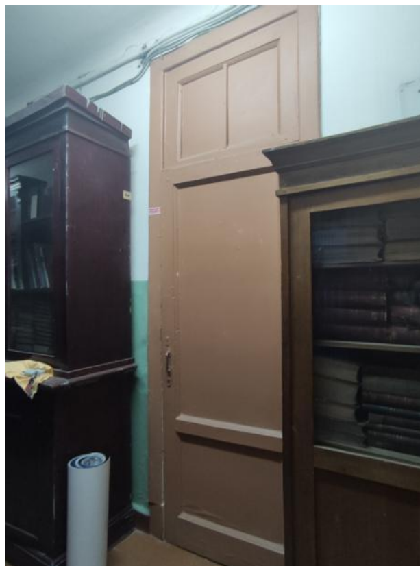
Фото 17. Дверное заполнение помещения 4 со стороны коридора ч.п. №1 (пом.17-Н)
