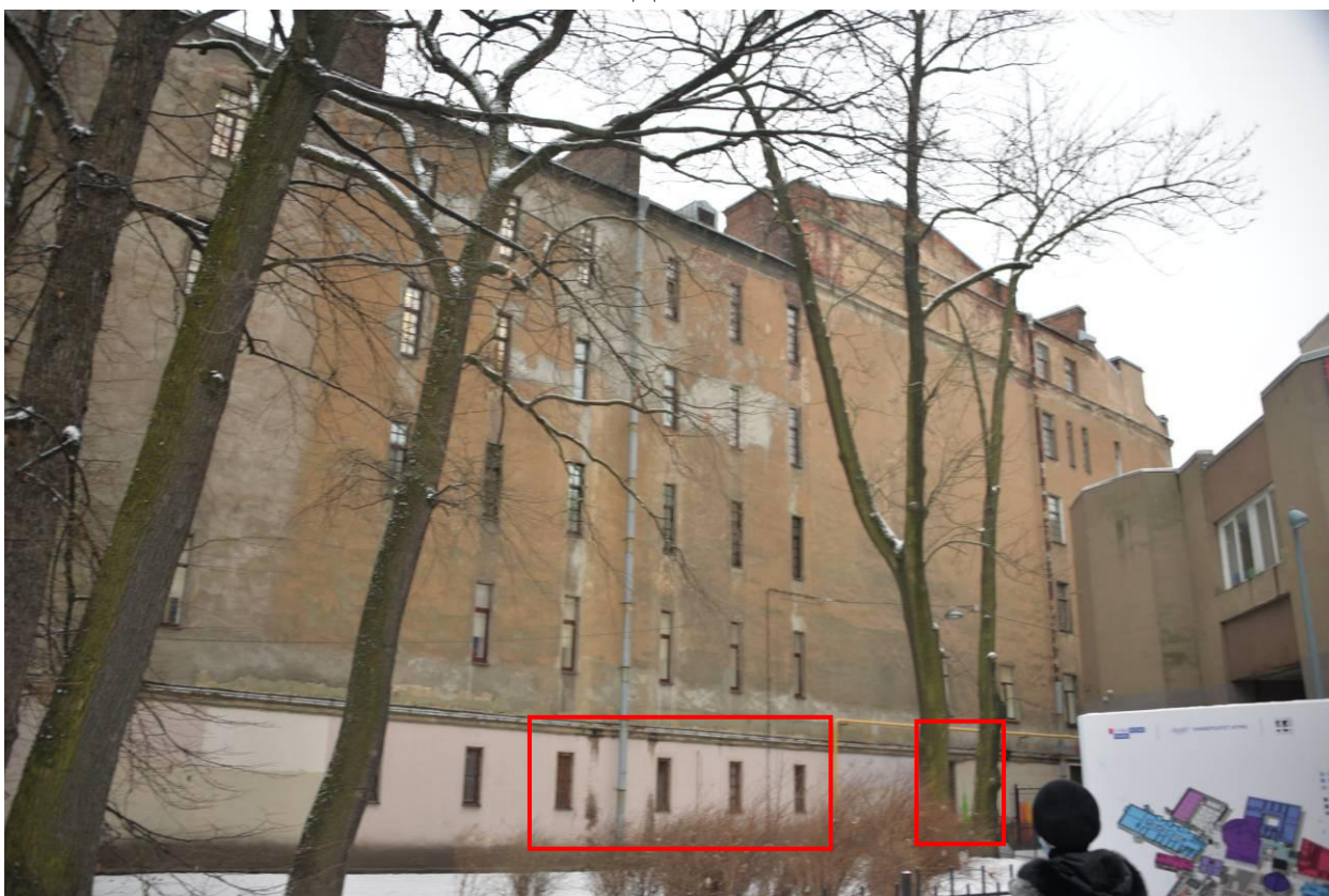
Фото 8. Фрагмент торцевого (западного) фасада выявленного объекта культурного наследия «Доходный дом»
