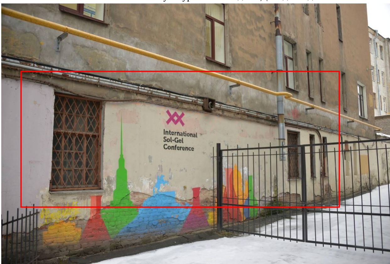
Фото 10. Оконные заполнения квартиры №22 торцевого (западного) фасада выявленного объекта культурного наследия «Доходный дом»
