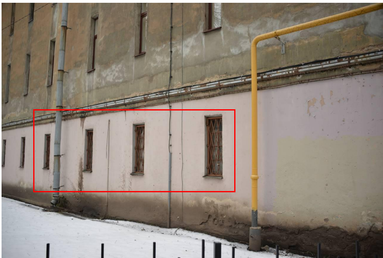
Фото 9. Оконные заполнения квартиры №22 торцевого (западного) фасада выявленного объекта культурного наследия «Доходный дом»
