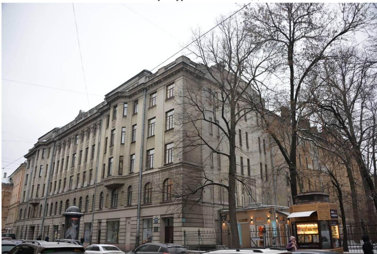
Фото 4. Фрагмент лицевого фасада выявленного объекта культурного наследия «Доходный дом» вдоль улицы Ломоносова
