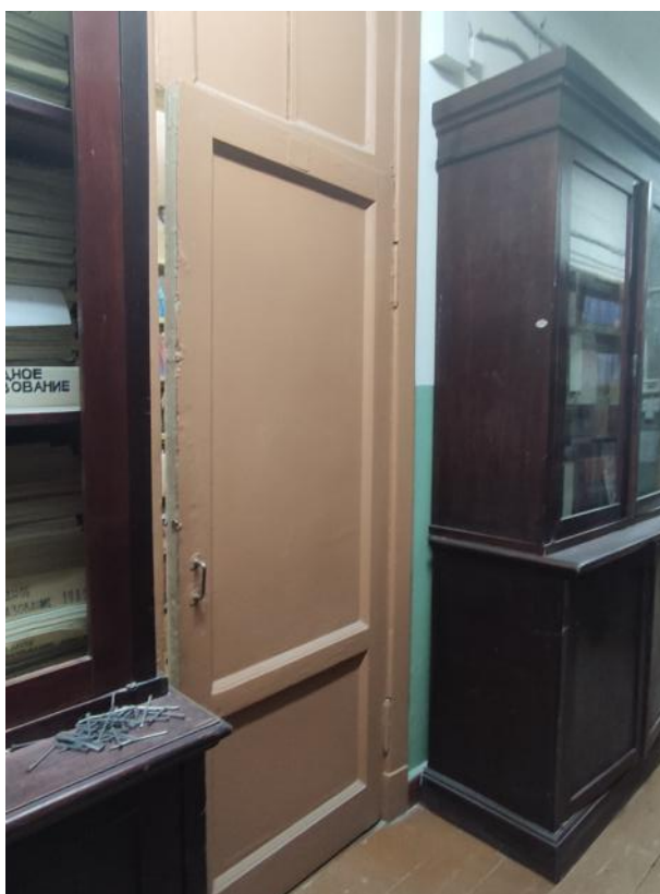
Фото 21. Дверное заполнение помещения № 3 со стороны коридора ч.п. №1 (пом.17-Н)
