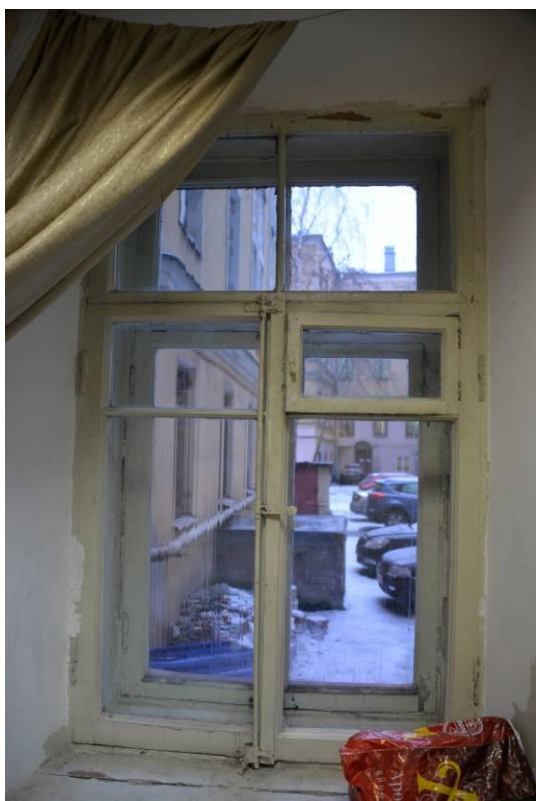
Фото 42. Оконное заполнение помещения №8 (кв.№22)
