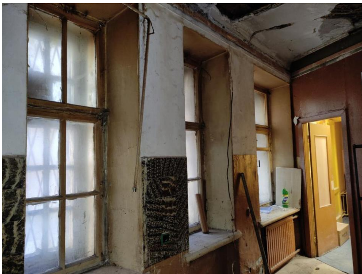
Фото 33. Оконные заполнения помещения № 2 (кв. №22)
