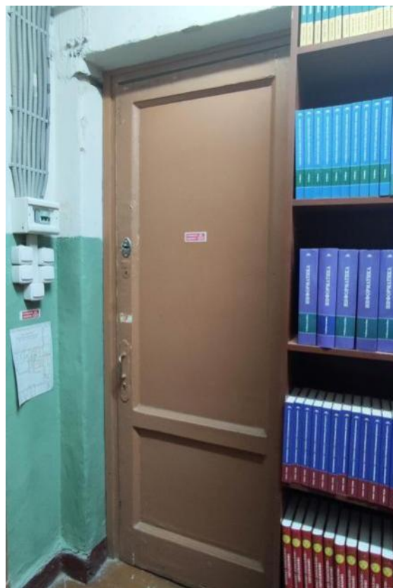
Фото 24. Дверное заполнение помещения №5, вид из ч.п. №5 (пом.17-Н)
