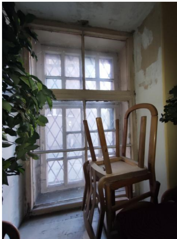
Фото 35. Оконное заполнение помещения №3 (кв.№22)
