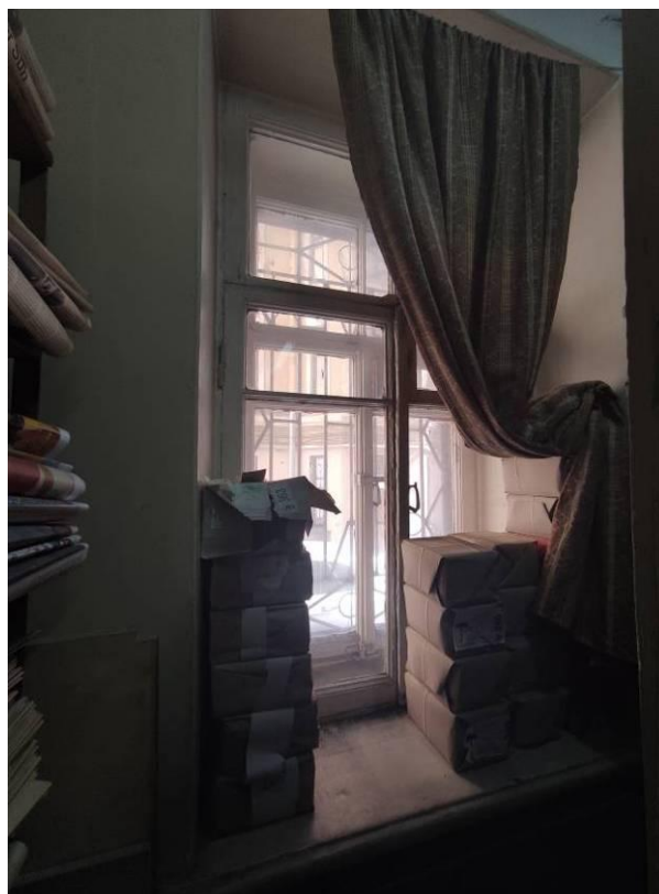
Фото 20. Оконное заполнение помещения №4 (пом.17-Н)
