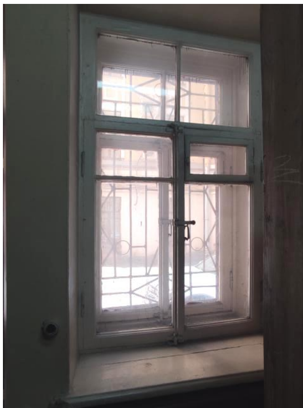
Фото 23. Оконное заполнение помещения №3 (пом.17-Н)
