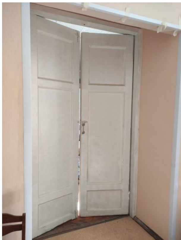
Фото 39. Дверное заполнение помещения № 7, вид из ч.п. № 8 (кв.№22)
