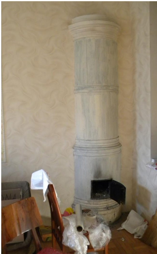
22. Объект культурного наследия «Дом Х.Г. Борхова» по адресу: г. Санкт-Петербург, Большой пр. В.О., д. 56, литера А. Квартира 34. Кухня. Круглая печь «голландка».
