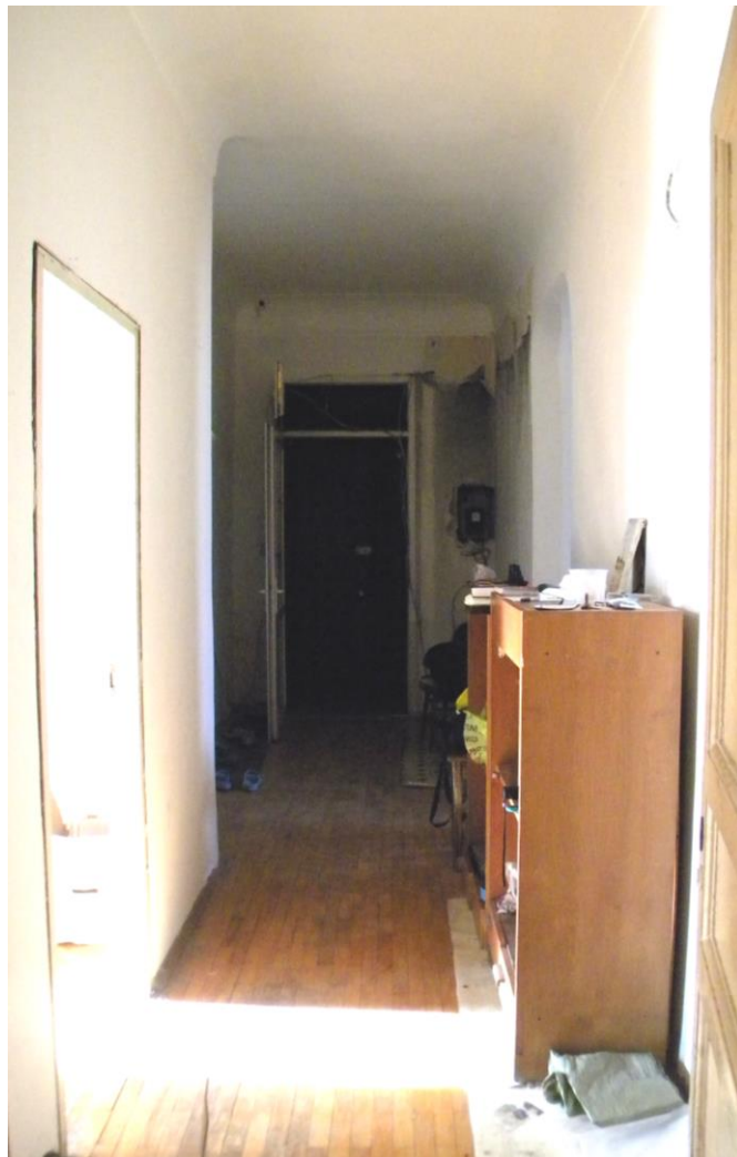
10. Выявленный объект культурного наследия «Дом Х.Г. Борхова» по адресу: г. Санкт-Петербург, Большой пр. В.О., д. 56, литера А. Квартира 34. Коридор. Общий вид.
