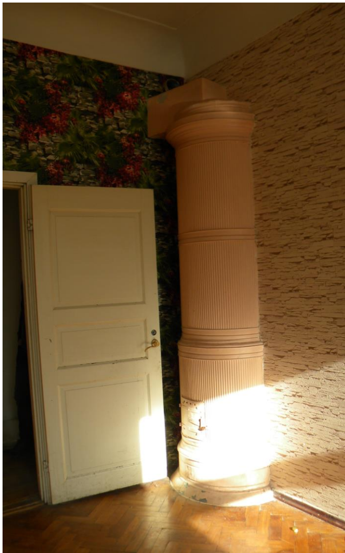
14. Выявленный объект культурного наследия «Дом Х.Г. Борхова» по адресу: г. Санкт-Петербург, Большой пр. В.О., д. 56, литера А. Квартира 34. Жилая комната. Круглая печь «голландка».
