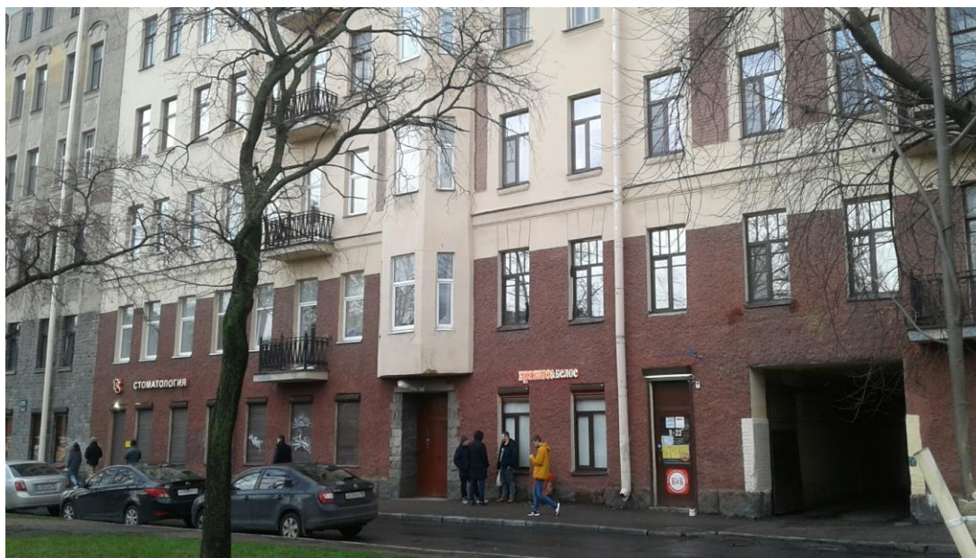
4. Выявленный объект культурного наследия «Дом Х.Г. Борхова» по адресу: г. Санкт-Петербург, Большой пр. В.О., д. 56, литера А. Главный (лицевой) фасад. Фрагмент.
