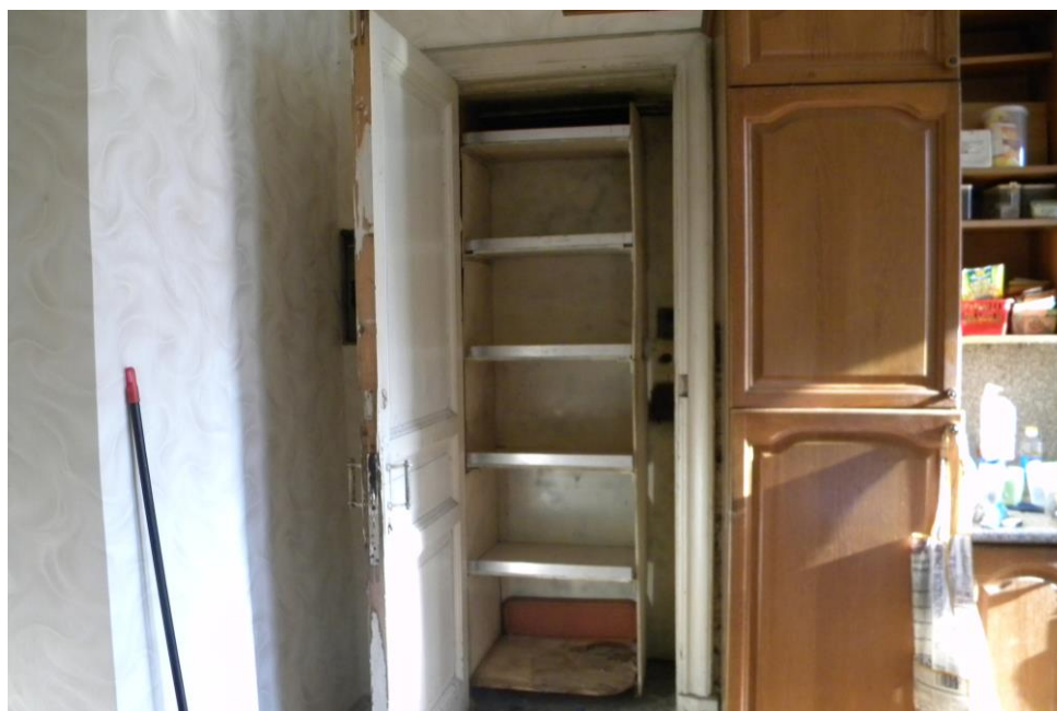
21. Объект культурного наследия «Дом Х.Г. Борхова» по адресу: г. Санкт-Петербург, Большой пр. В.О., д. 56, литера А. Квартира 34. Кухня. Выход на черную лестницу.
