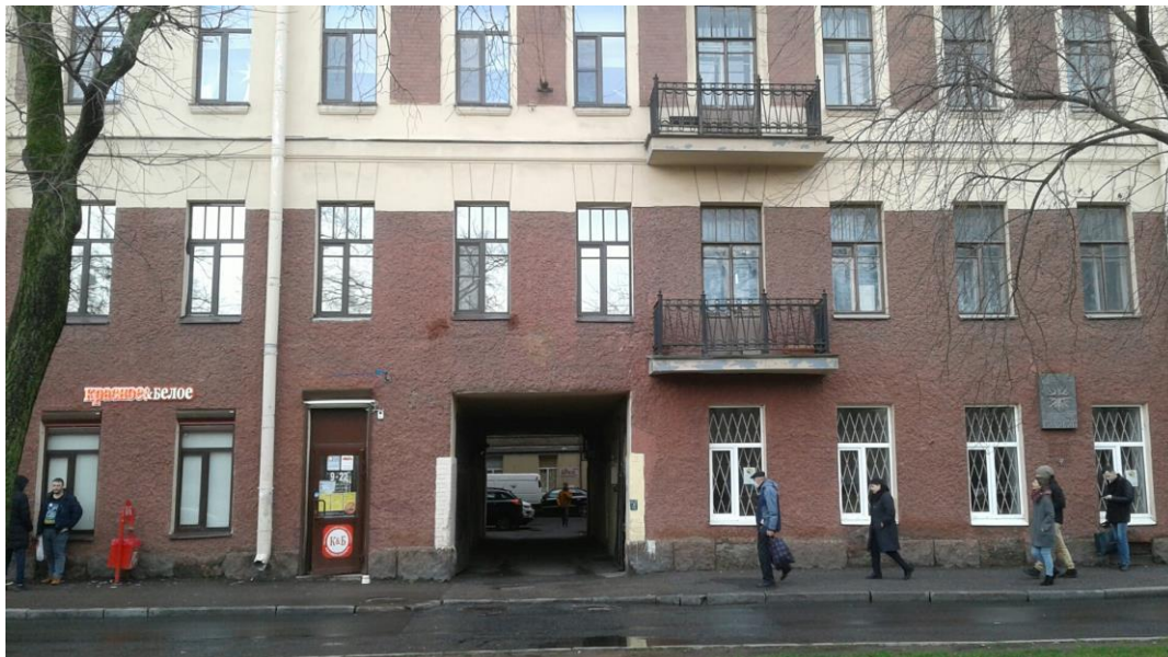
3. Выявленный объект культурного наследия «Дом Х.Г. Борхова» по адресу: г. Санкт-Петербург, Большой пр. В.О., д. 56, литера А. Главный (лицевой) фасад. Фрагмент.
