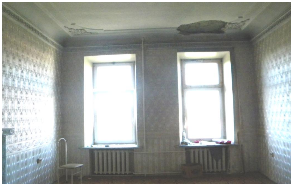
17. Выявленный объект культурного наследия «Дом Х.Г. Борхова» по адресу: г. Санкт-Петербург, Большой пр. В.О., д. 56, литера А. Квартира 34. Жилая комната с камином.
