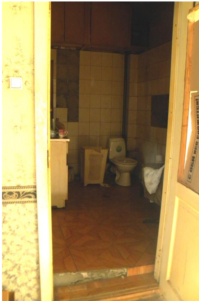
23. Объект культурного наследия «Дом Х.Г. Борхова» по адресу: г. Санкт-Петербург, Большой пр. В.О., д. 56, литера А. Квартира 34. Санузел. Общий вид. Подъем уровня пола санузда.
