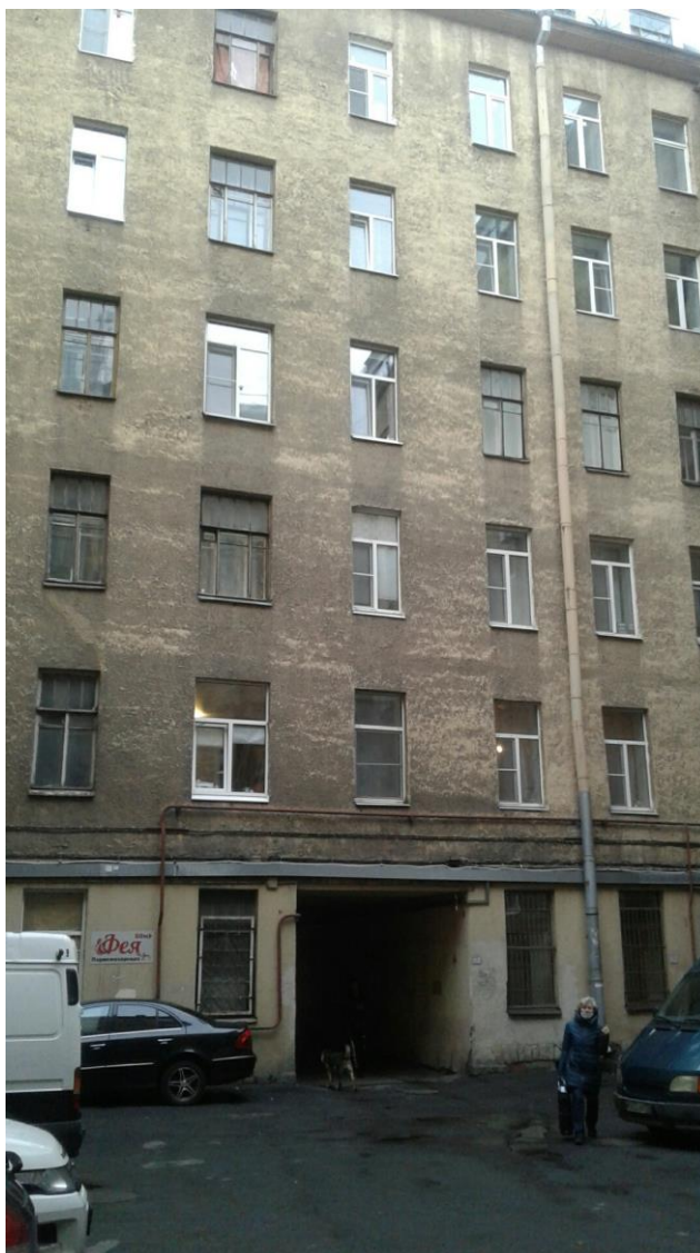
6. Выявленный объект культурного наследия «Дом Х.Г. Борхова» по адресу: г. Санкт-Петербург, Большой пр. В.О., д. 56, литера А. Дворовый фасад.
