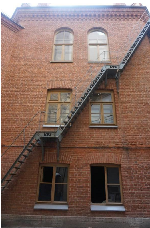
Фото 15. Фрагмент дворового фасада объекта культурного наследия федерального значения «Банк для внешней торговли Русский с флигелями», наружная лестница с кронштейнами
