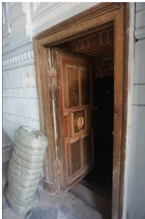
Фото 18. Интерьер объекта культурного наследия федерального значения «Банк для внешней торговли Русский с флигелями», ч.п.111, дверное заполнение
