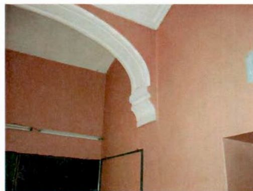
помещение № 6, площадью 25,1 кв.м. трехцентровой арочный проем, декорированный филенками;
