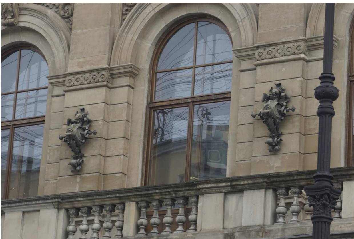
Фото 3. Фрагмент лицевого фасада объекта культурного наследия федерального значения «Банк для внешней торговли Русский с флигелями», флагодержатели
