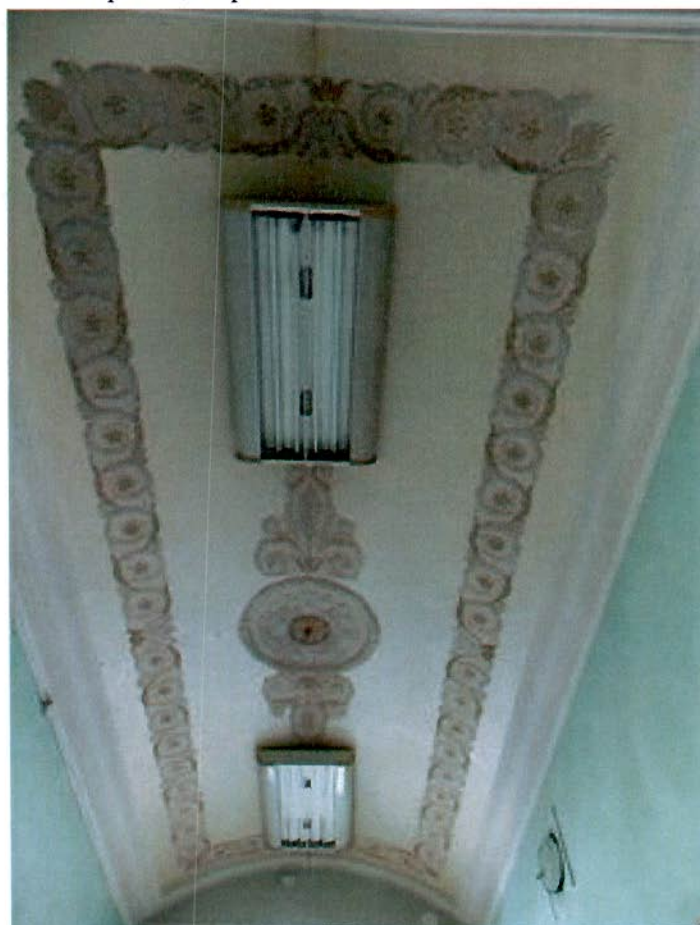
9. Помещение № 5. Первый этаж.
