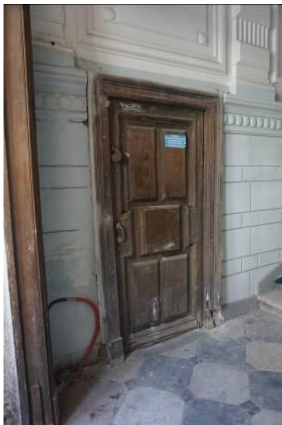
Фото 17. Интерьер объекта культурного наследия федерального значения «Банк для внешней торговли Русский с флигелями», ч.п.111, дверное заполнение
