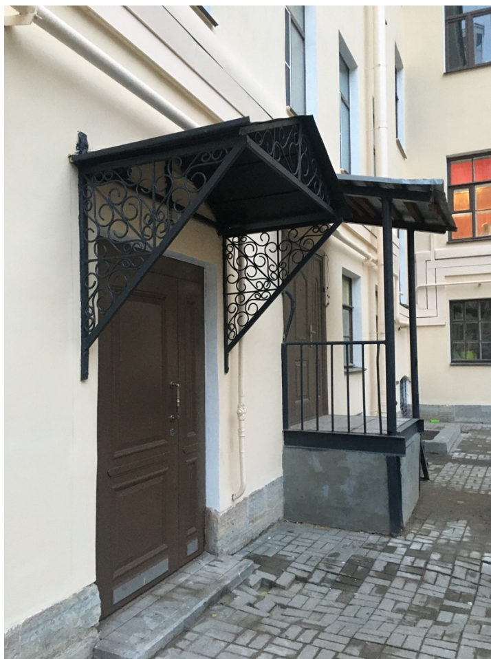
12. Выявленный объект культурного наследия «Дом С.Д. Шереметьева», г. Санкт-Петербург, пр. Литейный, дом № 51, лит. А. Вид дворового фасада.
