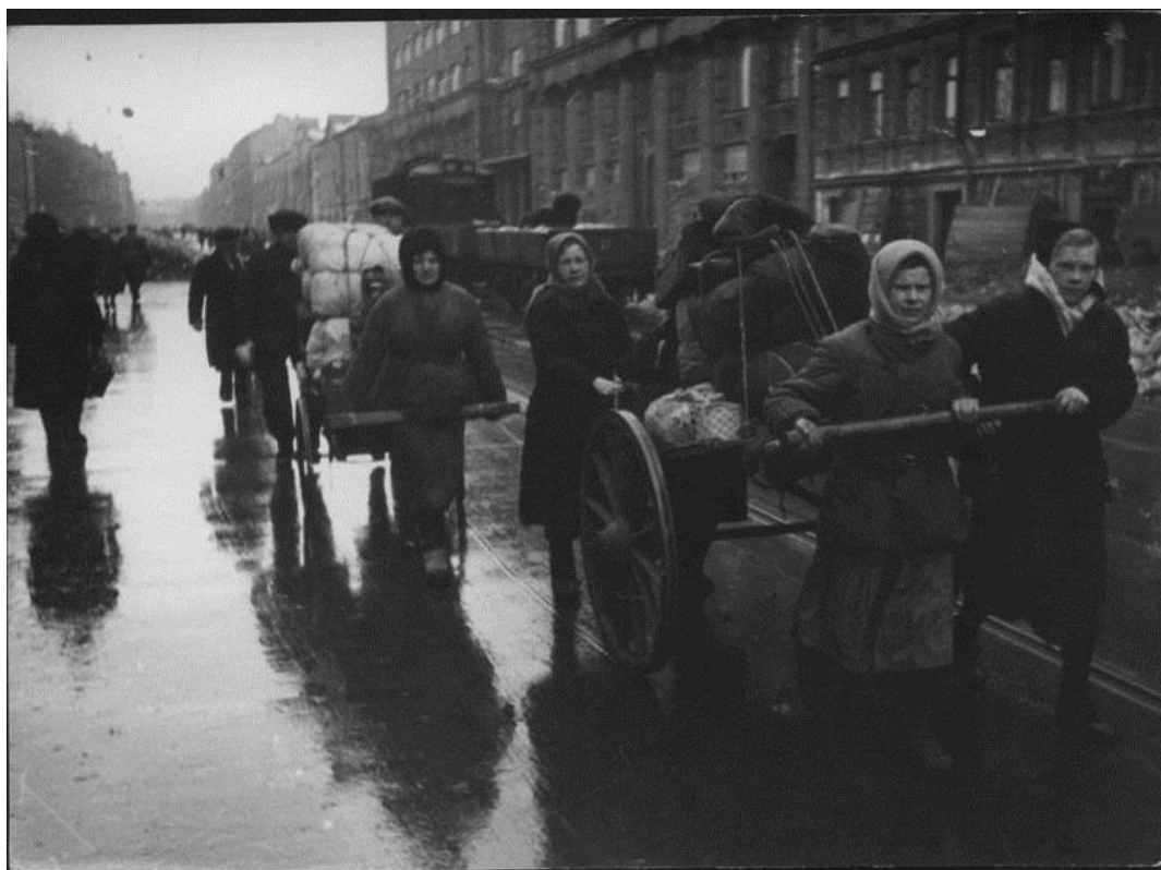
21. Эвакуация ленинградцев. Проспект Володарский. Дата съемки: 1941г. Направление съемки: юг. // https://goskatalog.ru/portal/#/collections?id=4585376
