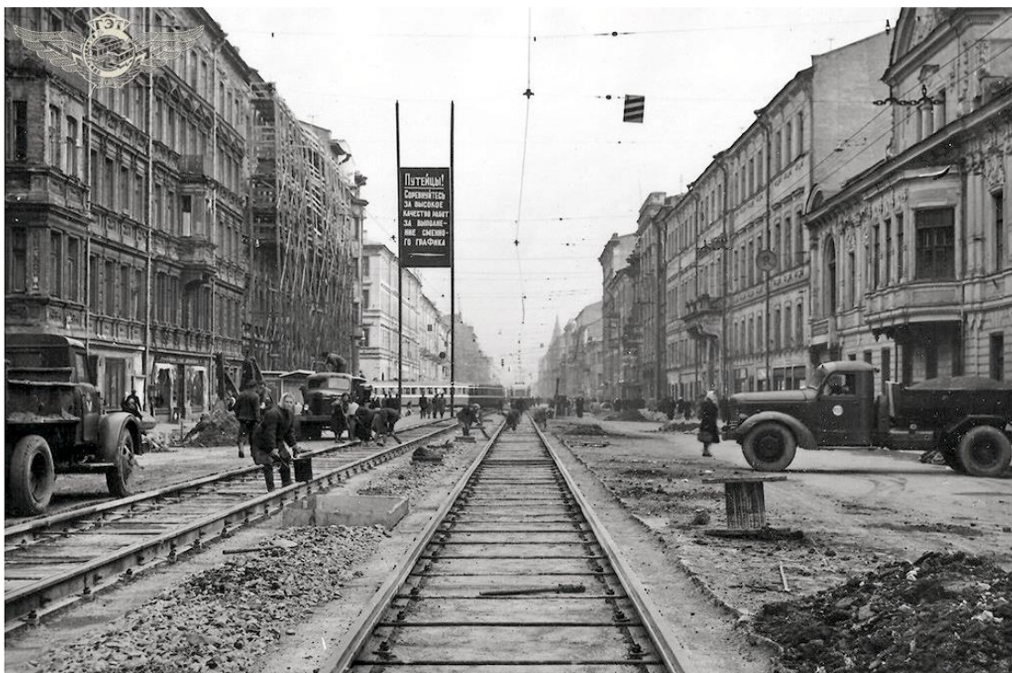
24. Трамвай на Литейном. Большой ремонт путей. Дата съёмки: 1952-1953 гг. Автор съёмки неизвестен. Направление съёмки: север. // https://pastvu.com/p/735834
