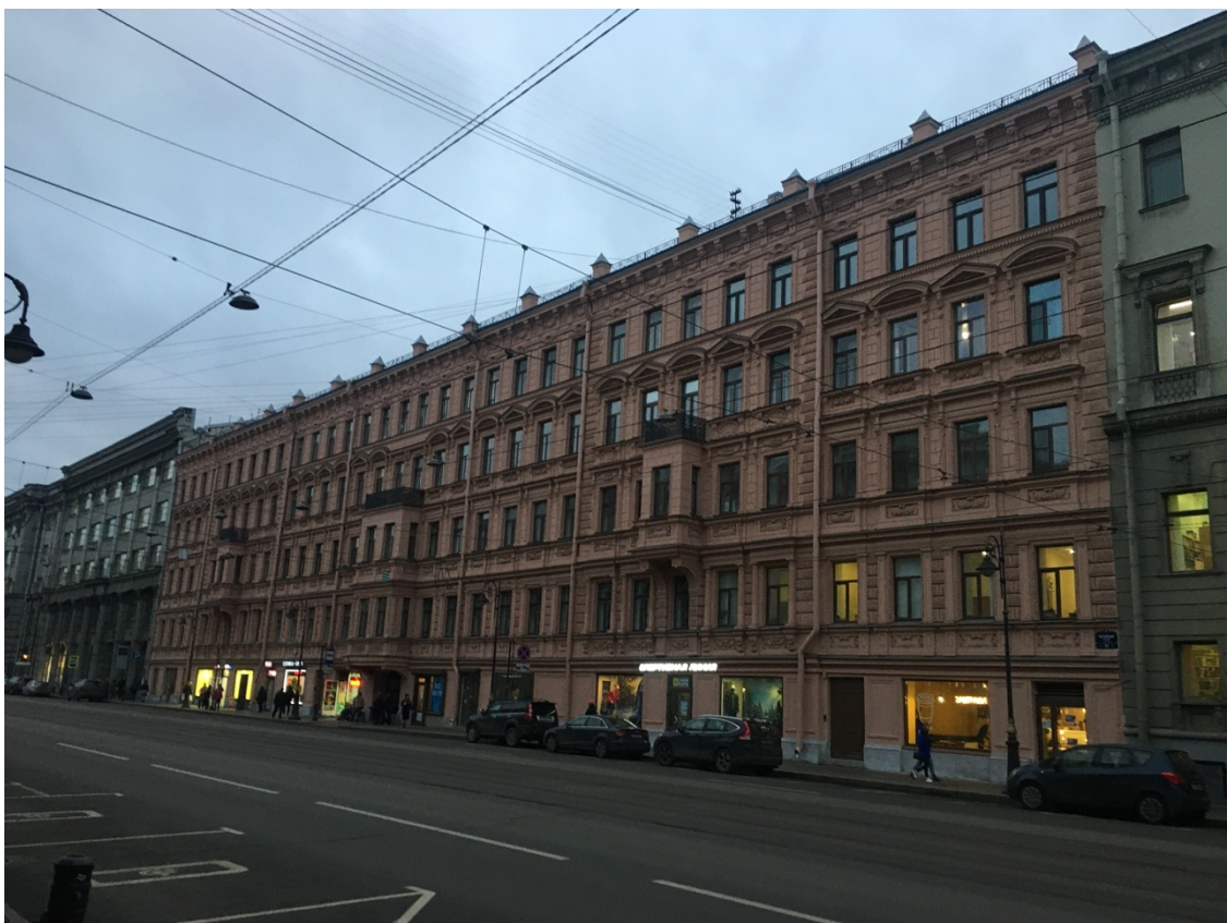
1. Выявленный объект культурного наследия «Дом С.Д. Шереметьева», г. Санкт-Петербург, пр. Литейный, дом № 51, лит. А. Вид лицевого фасада.
