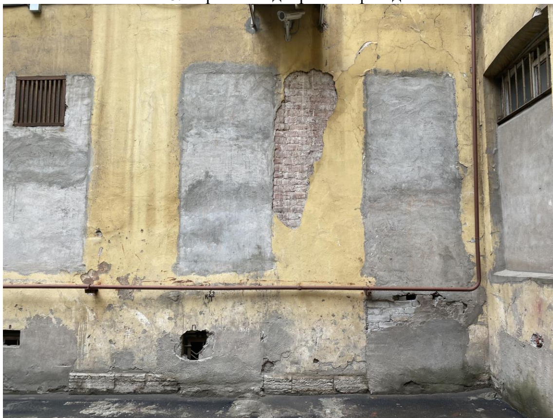
9. Фрагмент дворового фасада.
