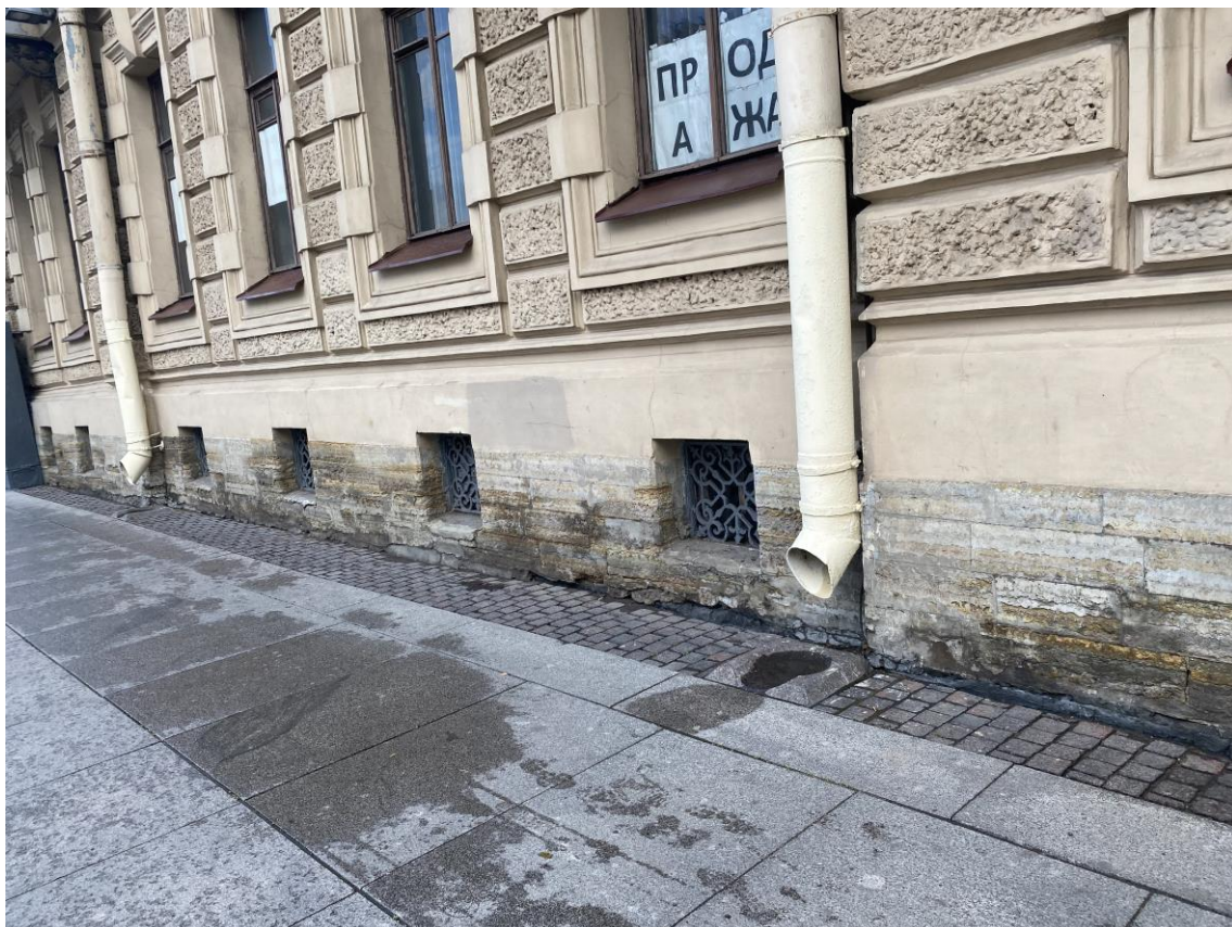
3. Фрагмент подвального этажа.
