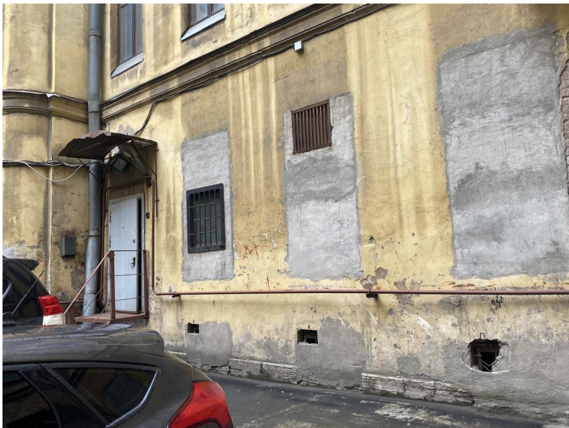
10. Фрагмент дворового фасада.
