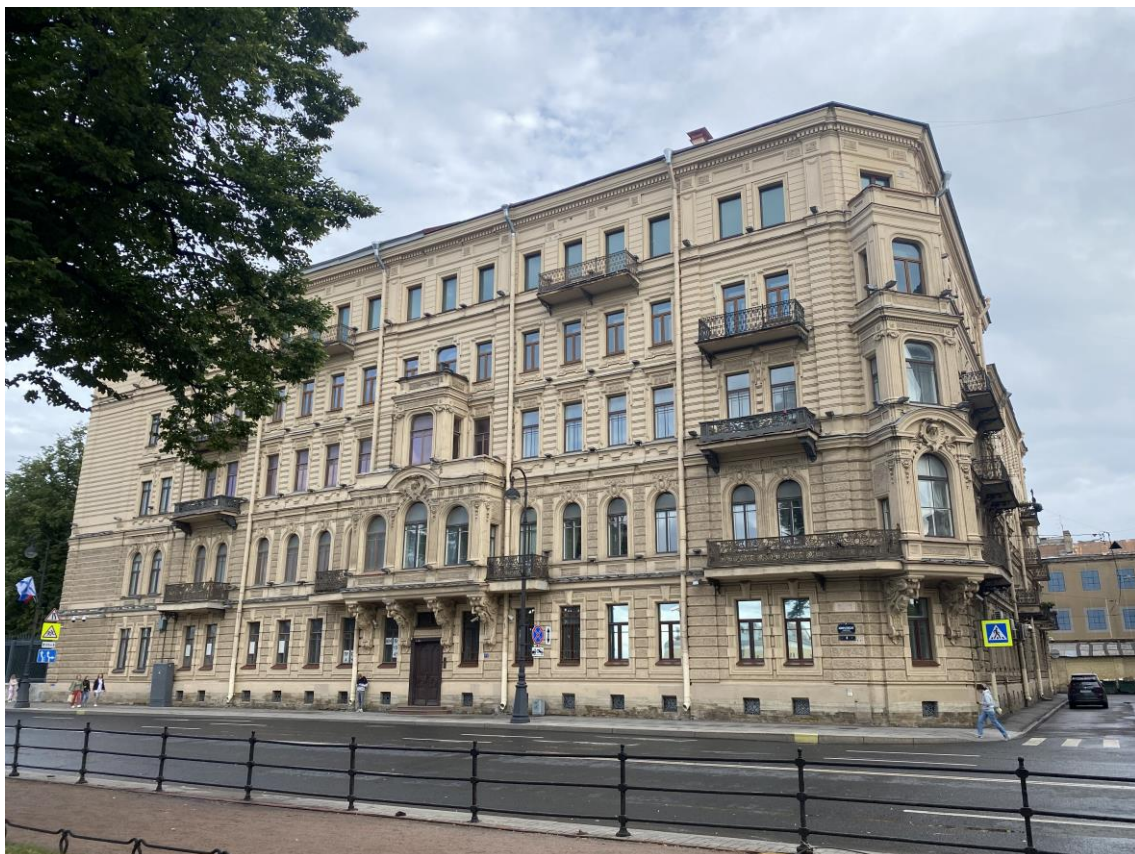
1. Лицевой фасад на Адмиралтейской набережной.
