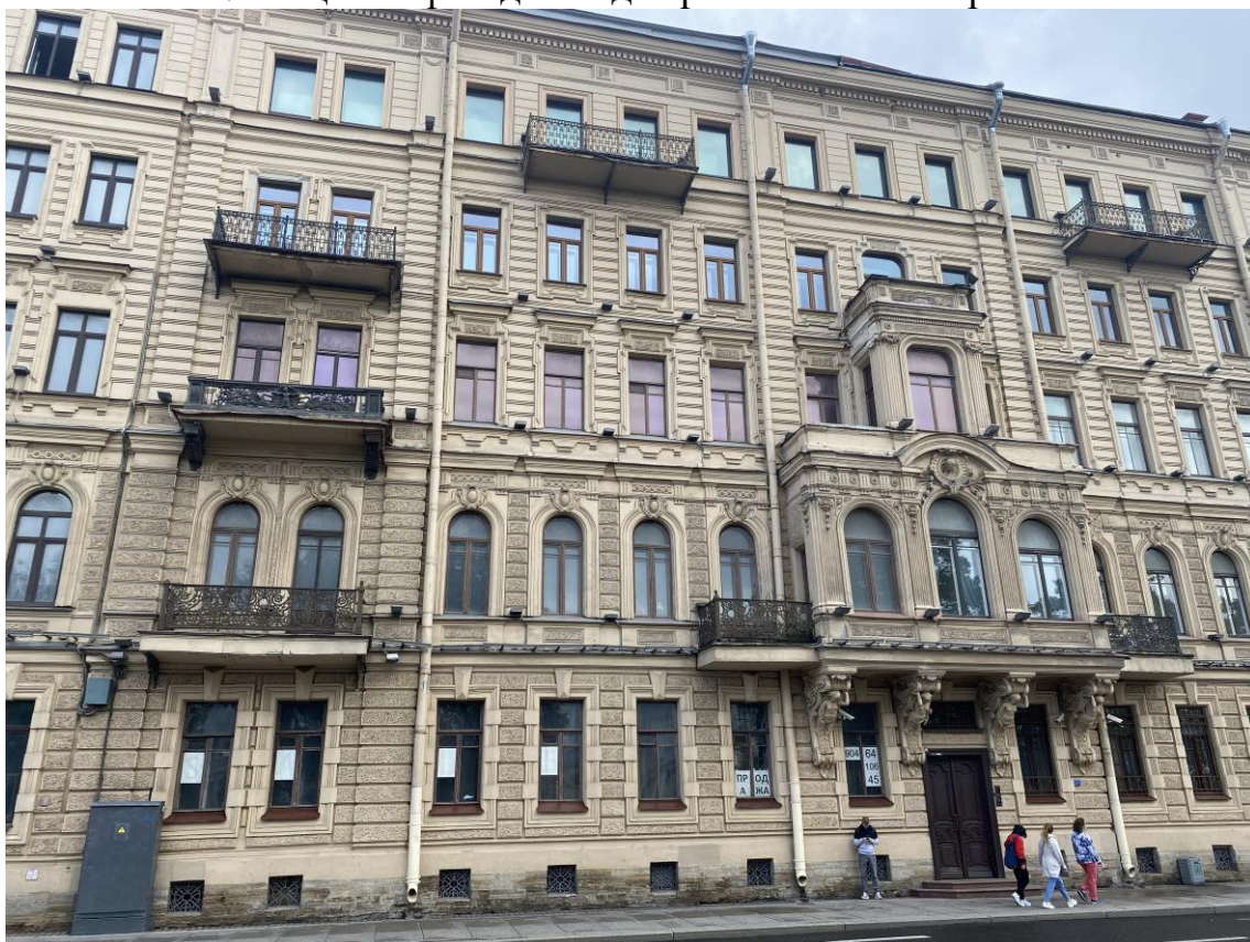
2. Лицевой фасад на Адмиралтейской набережной.
