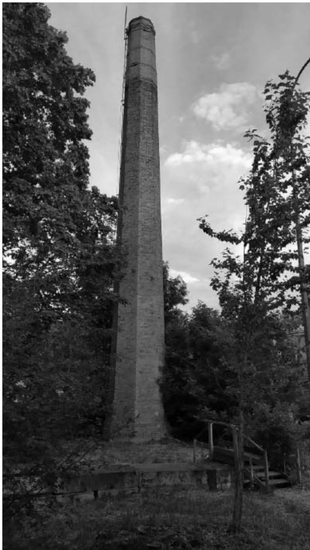
фото 59. Промышленная дымовая труба отремонтирована в 2017 году.
