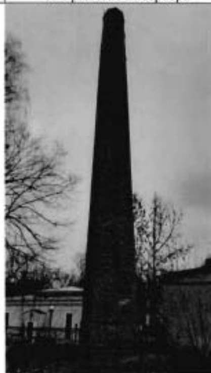
10. Историческая дымовая труба
