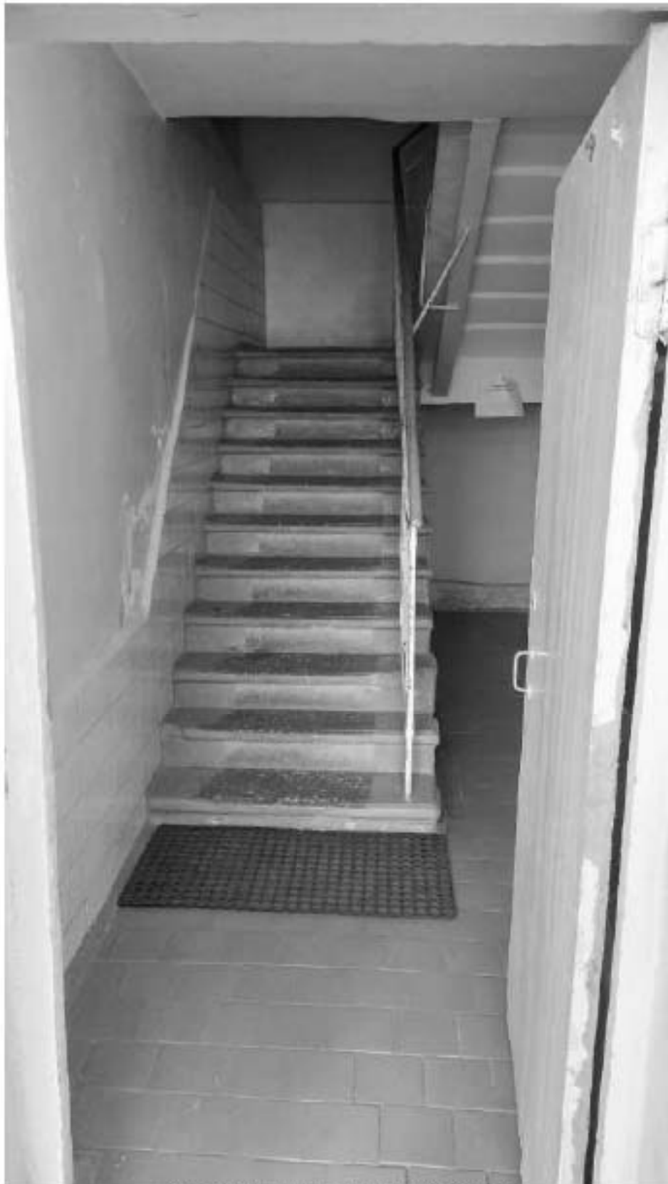
фото 13 Лестнич без повреждений. Блок 1.
