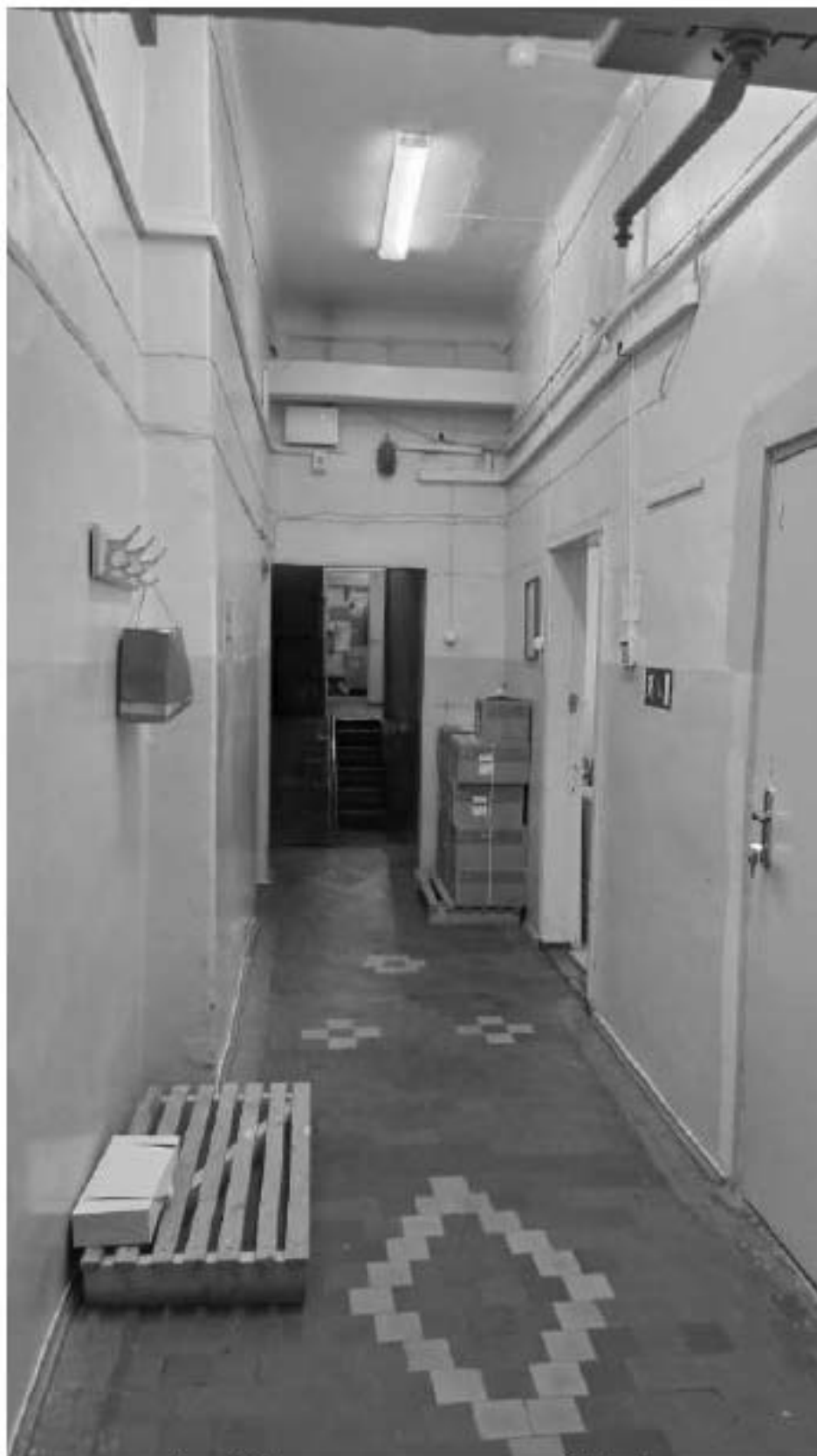
фото 15. Полы в помещениях прачечной. Блок 1.
