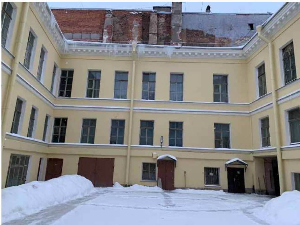
Фото 6. Дворовой фасад. Оконные заполнения получили естественный физический износ, наблюдаются следы биоповреждений, деструкция древесины, поздние вставки и замены. Двери поздние, утилитарные, часть металлические
