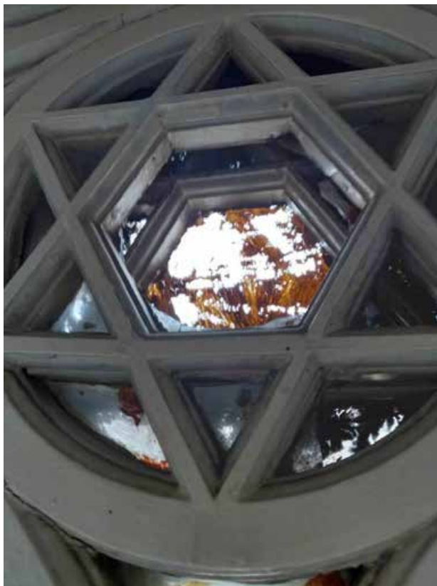
Фото 29. Фрагмент оконного заполнения, парадная лестница, 3 этаж.
