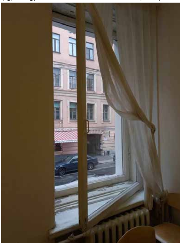
Фото 16. Оконное заполнение лицевого фасада, вид из помещения. Наблюдаются многочисленные следы поздней покраски, расхождение узловых соединений, перекос створок
