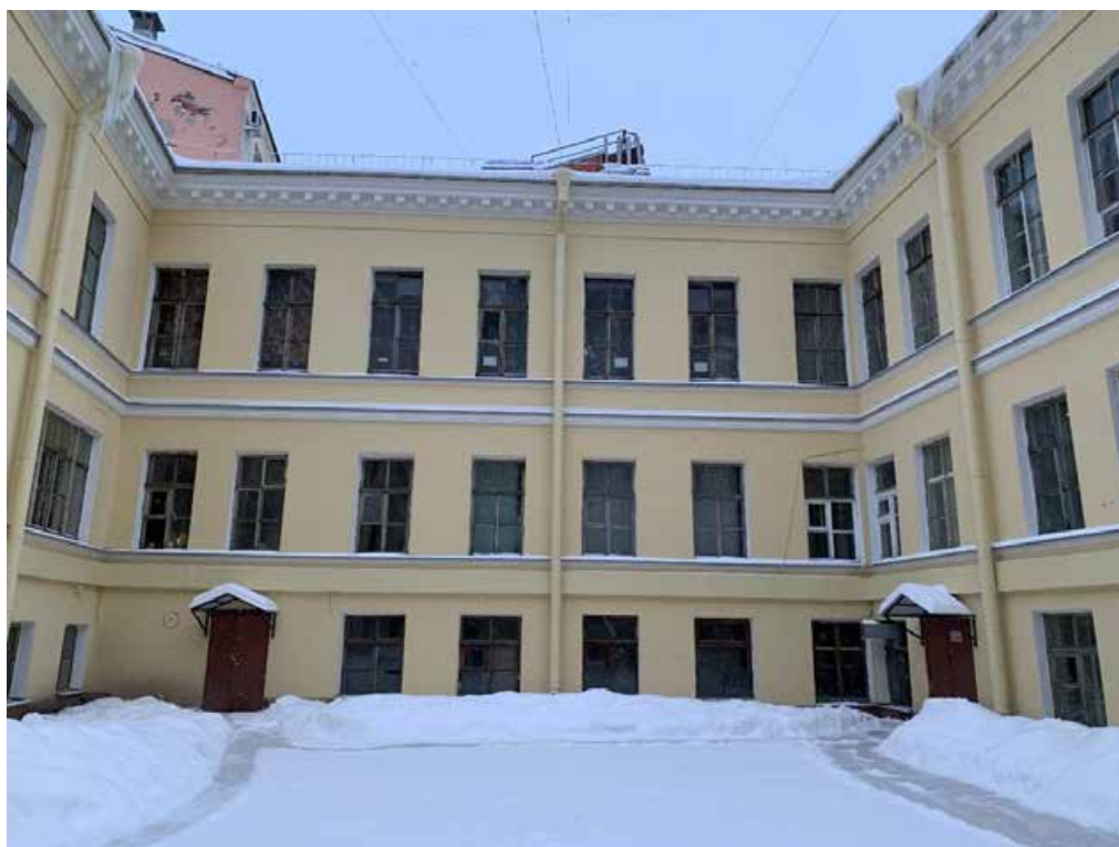
Фото 4. Дворовой фасад. Оконные заполнения за годы эксплуатации получили естественный физический износ, наблюдаются следы биоповреждений, деструкция древесины, поздние вставки и замены. Двери поздние, утилитарные, часть металлические
