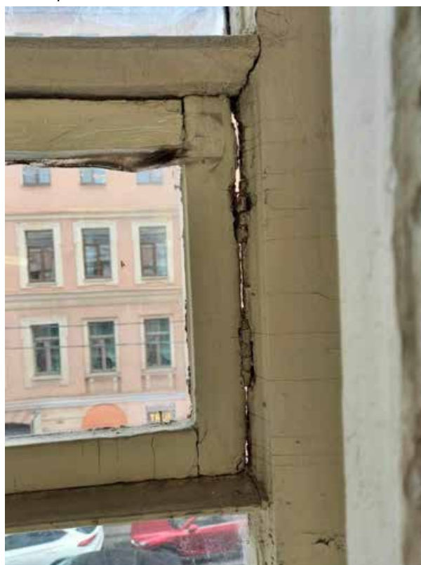
Фото 22. Оконное заполнение 3 этаж, лицевой фасад, вид из помещения. Наблюдаются поздние вставки, многочисленные следы поздней покраски, расхождение узловых соединений, сквозные щели между элементами
