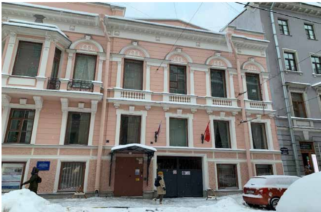
Фото 1. Общий вид. На фасаде наблюдаются оконные заполнения позднего периода с изменением расстекловки. Дверь заменена на утилитарную металлическую. Въездные ворота металлические с решеткой из арматуры.
