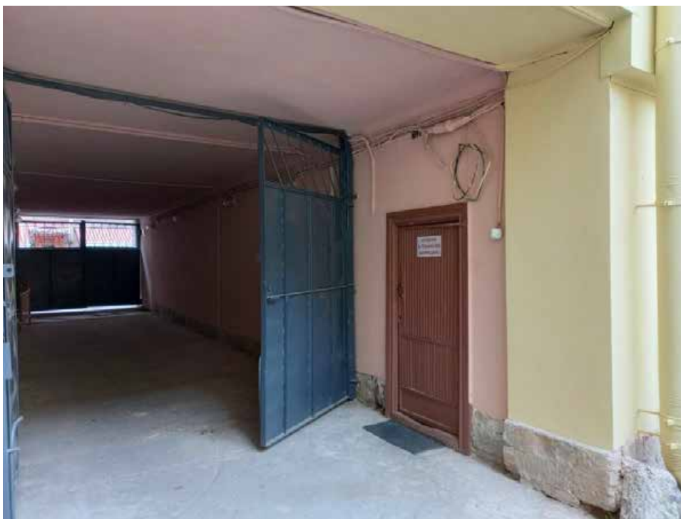
Фото 9. Стена арочного проезда. Поздние металлические ворота, утилитарное дверное заполнение входа в здание
