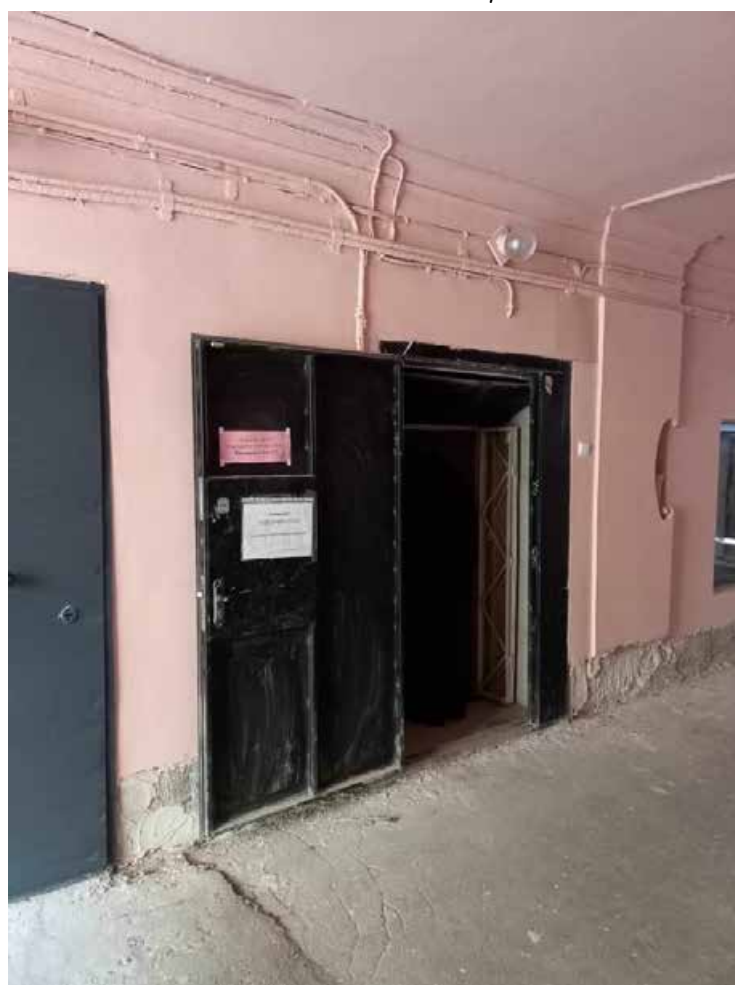
Фото 8. Стена арочного проезда. Поздние металлические двери
