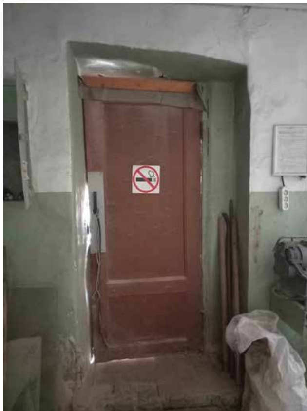
Фото 39. Дверное заполнение, 1 этаж, вид из помещения.
