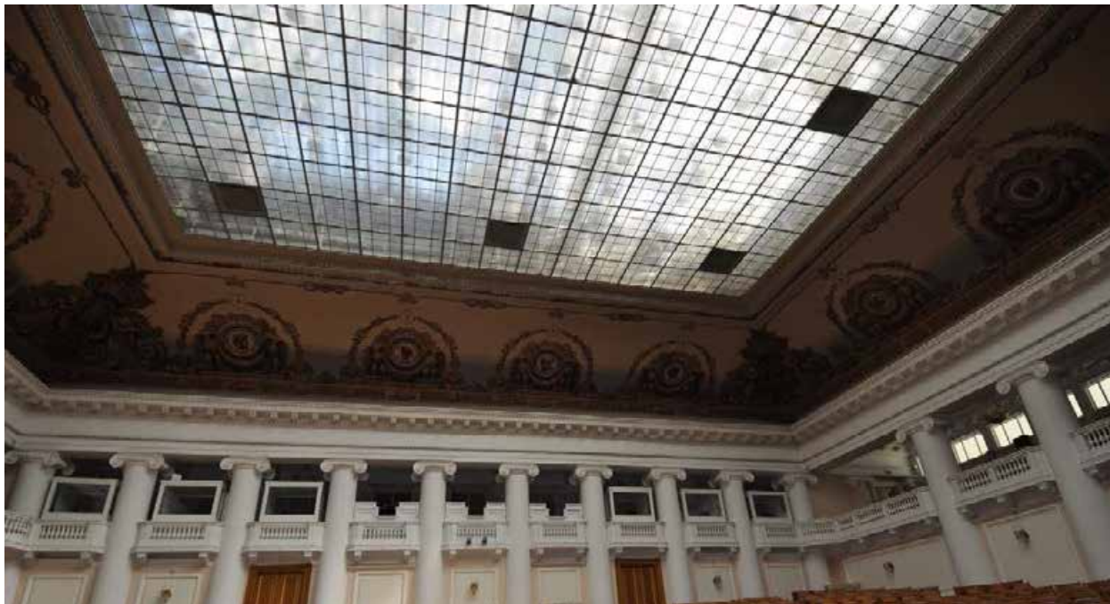
1. Думский зал объекта культурного наследия федерального значения «Дворец Таврический. Дворец», расположенного по адресу: г. Санкт-Петербург, ул. Шпалерная, д. 47, лит. А. 15.10.2021
