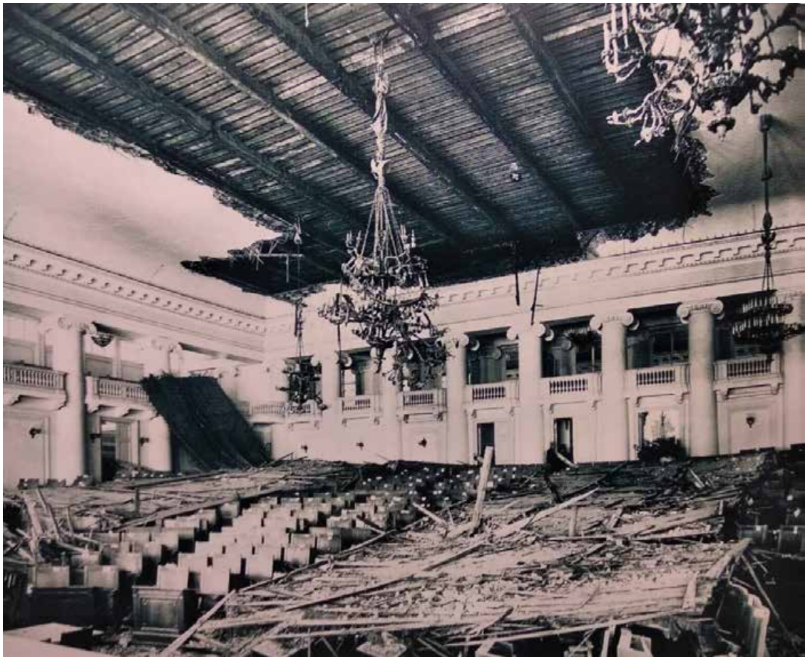
24. Обрушение потолка в зале заседаний 2 марта 1907 г. // ЦГА КФФД СПб Гр541226
