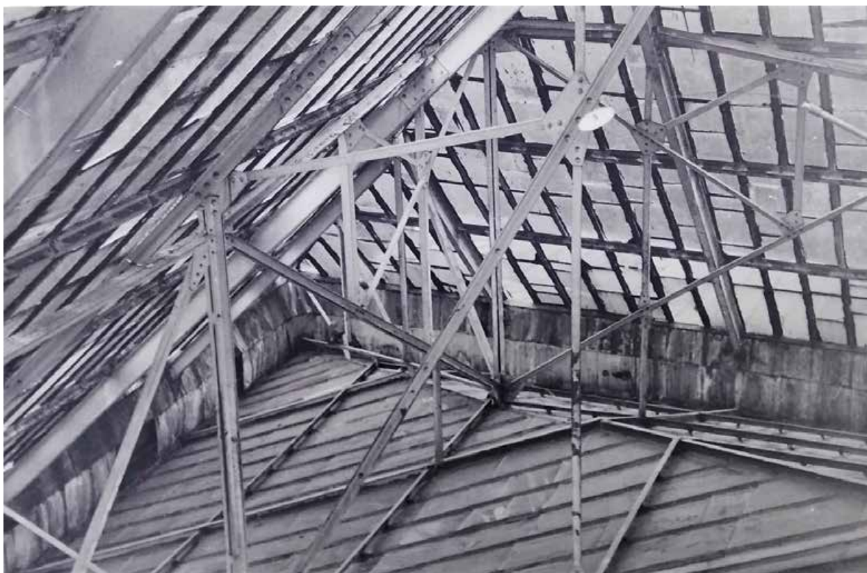
62. Покрытие над залом заседаний Общий вид пространства между первым и вторым ярусом остекления Фото 1983 г. // ГПИ Ленпроектстальконструкция. Шифр 8209 МО. Л. 3
