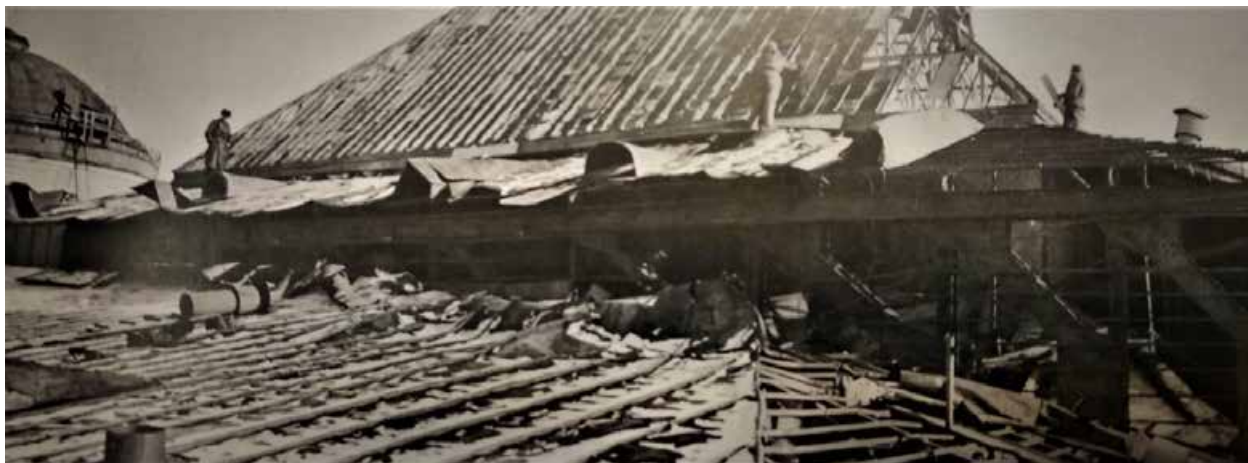
59. Разрушение части крыши и светового фонаря над Колонным залом и Залом заседаний 23 февраля 1942 г. // КГИОП
