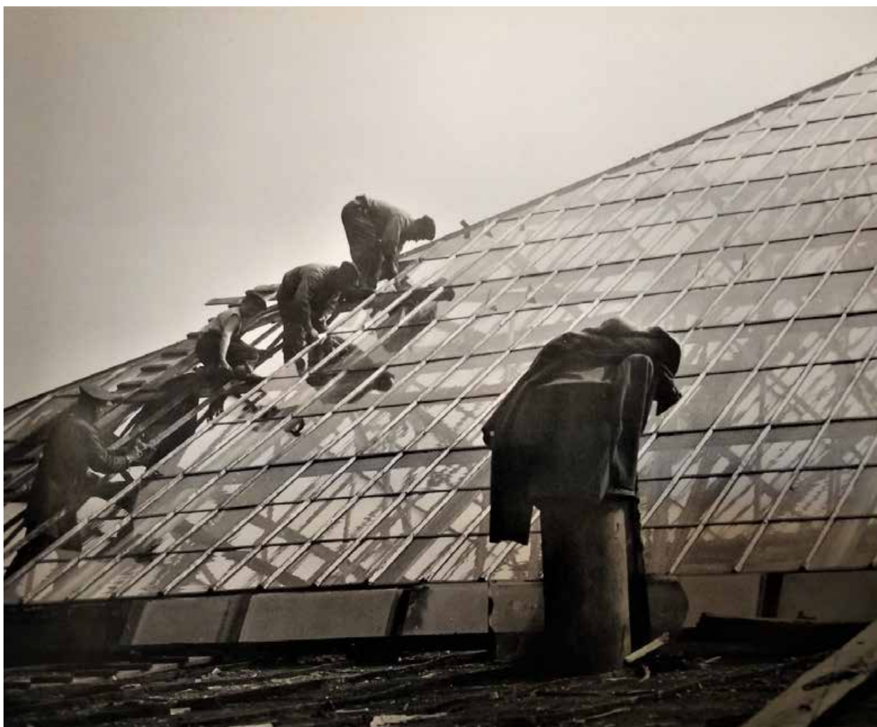
60. Ремонт фонаря крыши над Залом заседаний Фото 1946 г. // КГИОП
