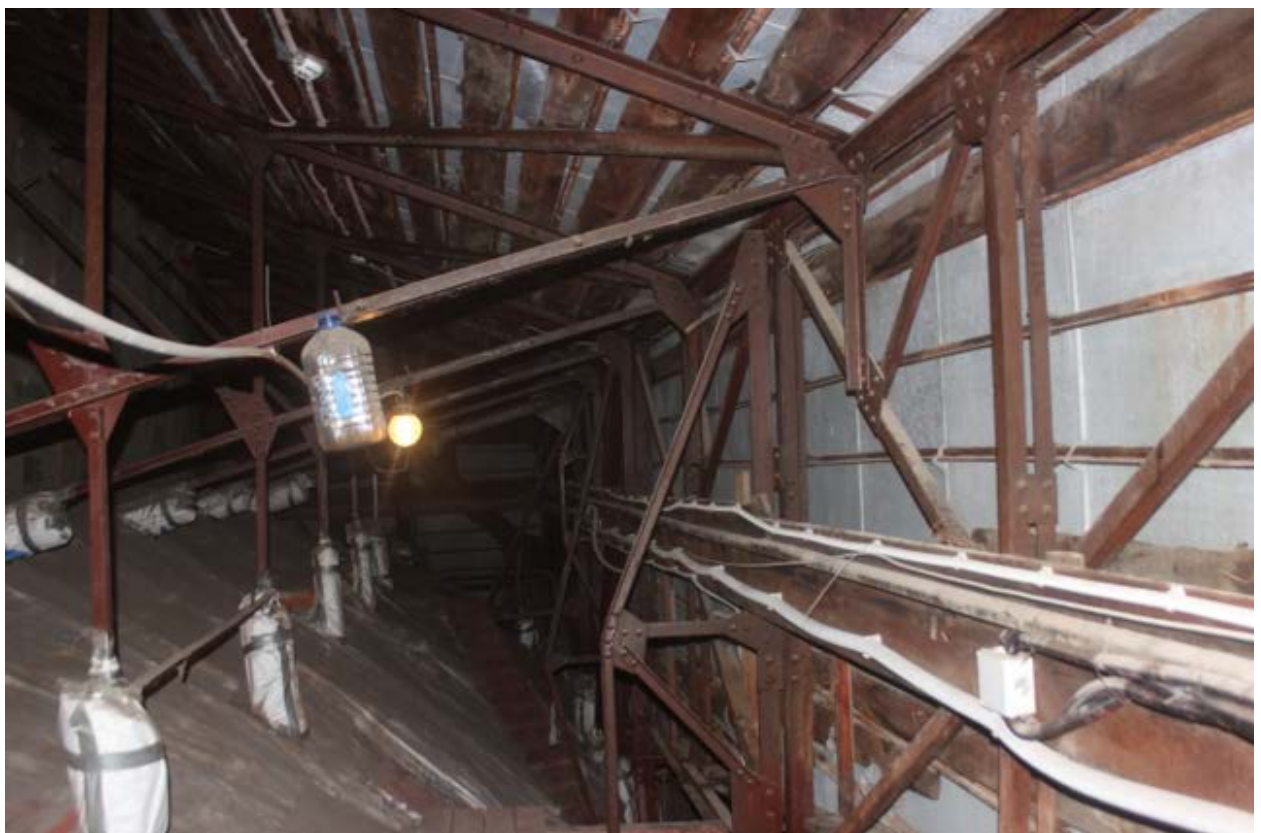
5. Фермы фонаря Думского зала объекта культурного наследия федерального значения «Дворец Таврический. Дворец», расположенного по адресу: г. Санкт-Петербург, ул. Шпалерная, д. 47, лит. А. 15.10.2021
