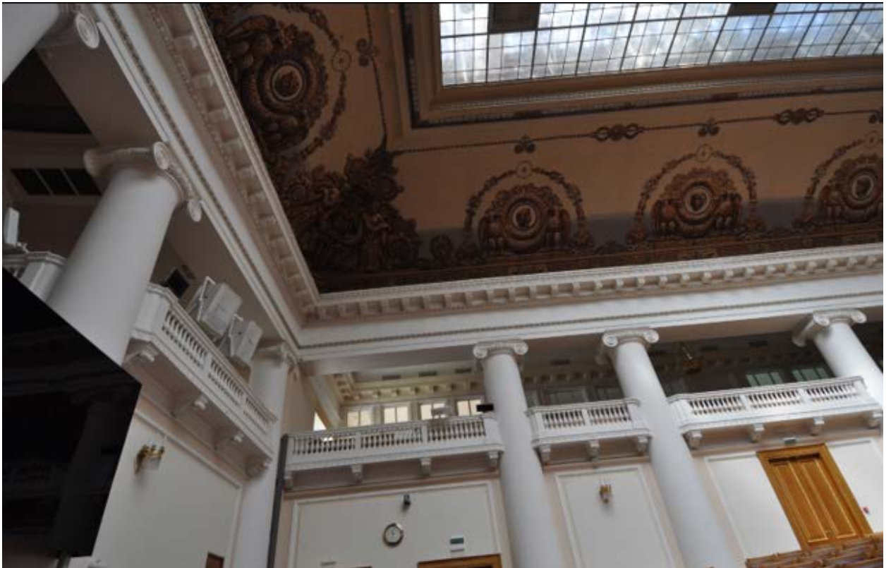
3. Думский зал объекта культурного наследия федерального значения «Дворец Таврический. Дворец», расположенного по адресу: г. Санкт-Петербург, ул. Шпалерная, д. 47, лит. А. 15.10.2021
