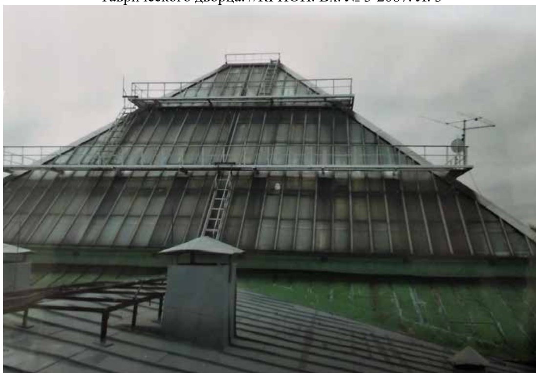
67. Общий вид светового фонаря над залом заседаний. Фото 2009 г. // КГИОП
