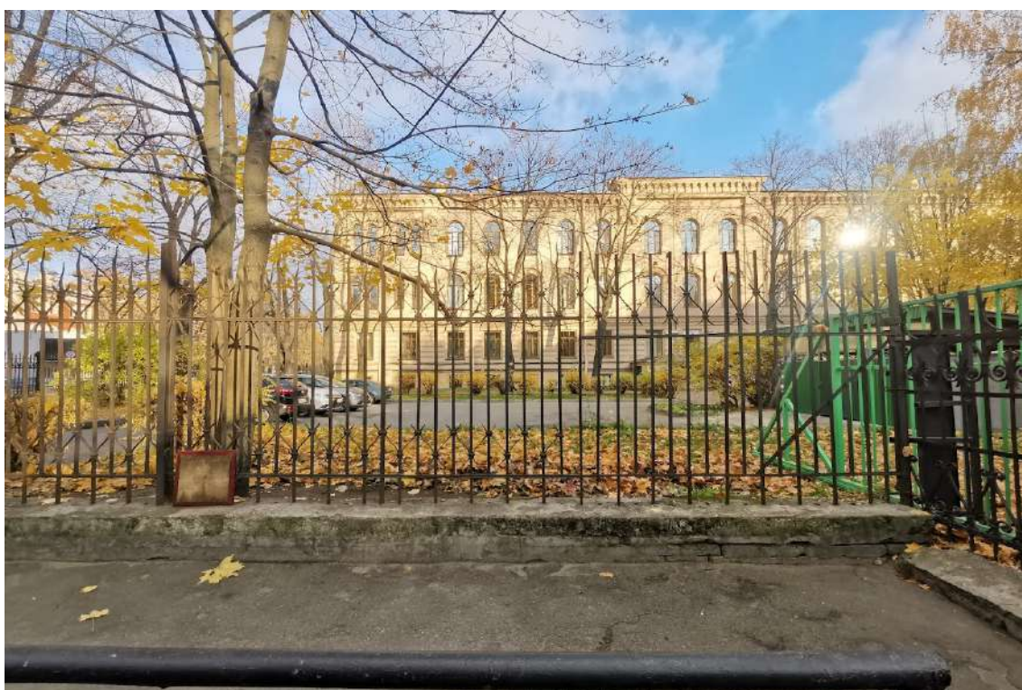
Фото №18. Вид секцию внутренней ограды. Утрата нижних декоративных элементов, отсутствие промежуточной стойки
