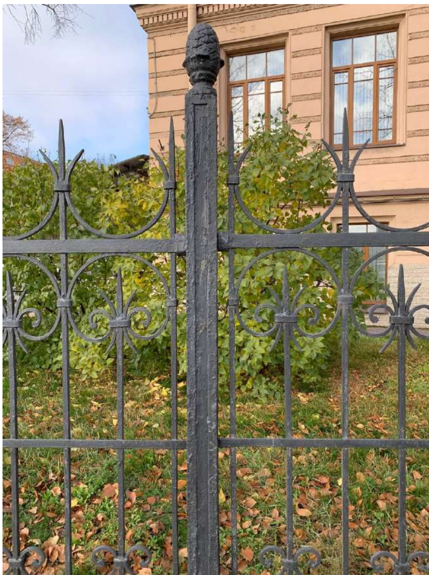
Фото №5. Поздняя стойка взамен утраченной исторической
