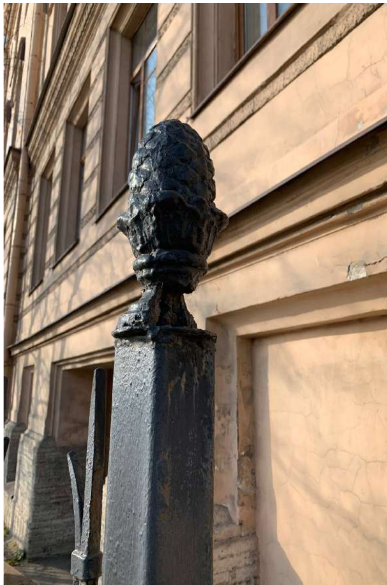
Фото №4. Частичная утрата декоративного элемента «шишка».
