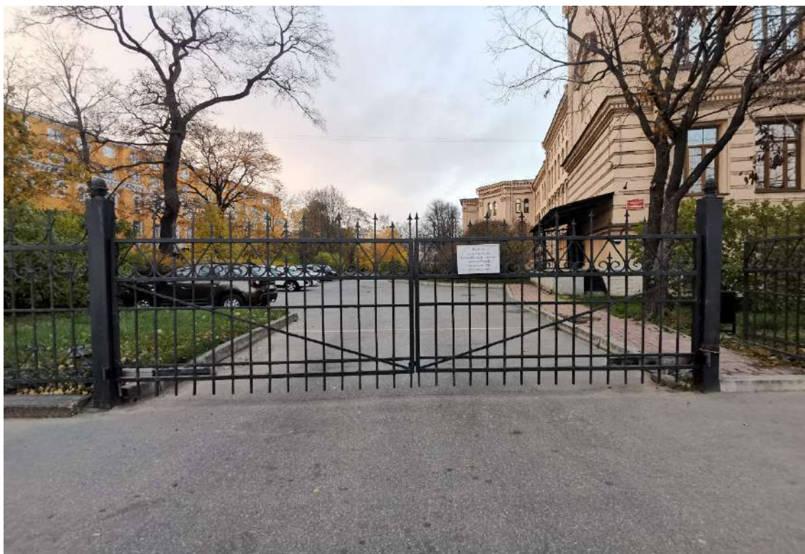
Фото №6. Вид на ворота и калитку со стороны Арсенальной набережной.
