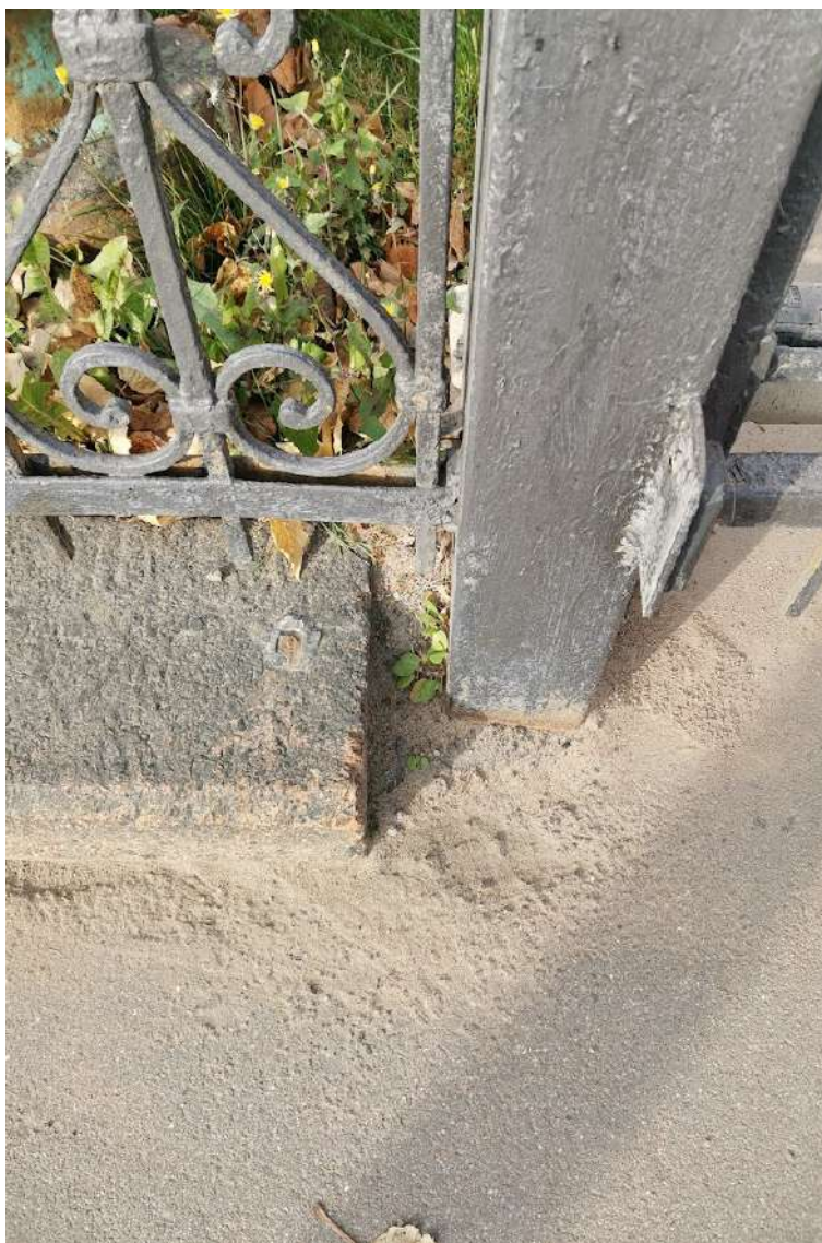
Фото №10. Позднее отверстие замастикованное цементно-песчаным раствором на гранитном цоколе, а так же сколы и проседание цоколя.
