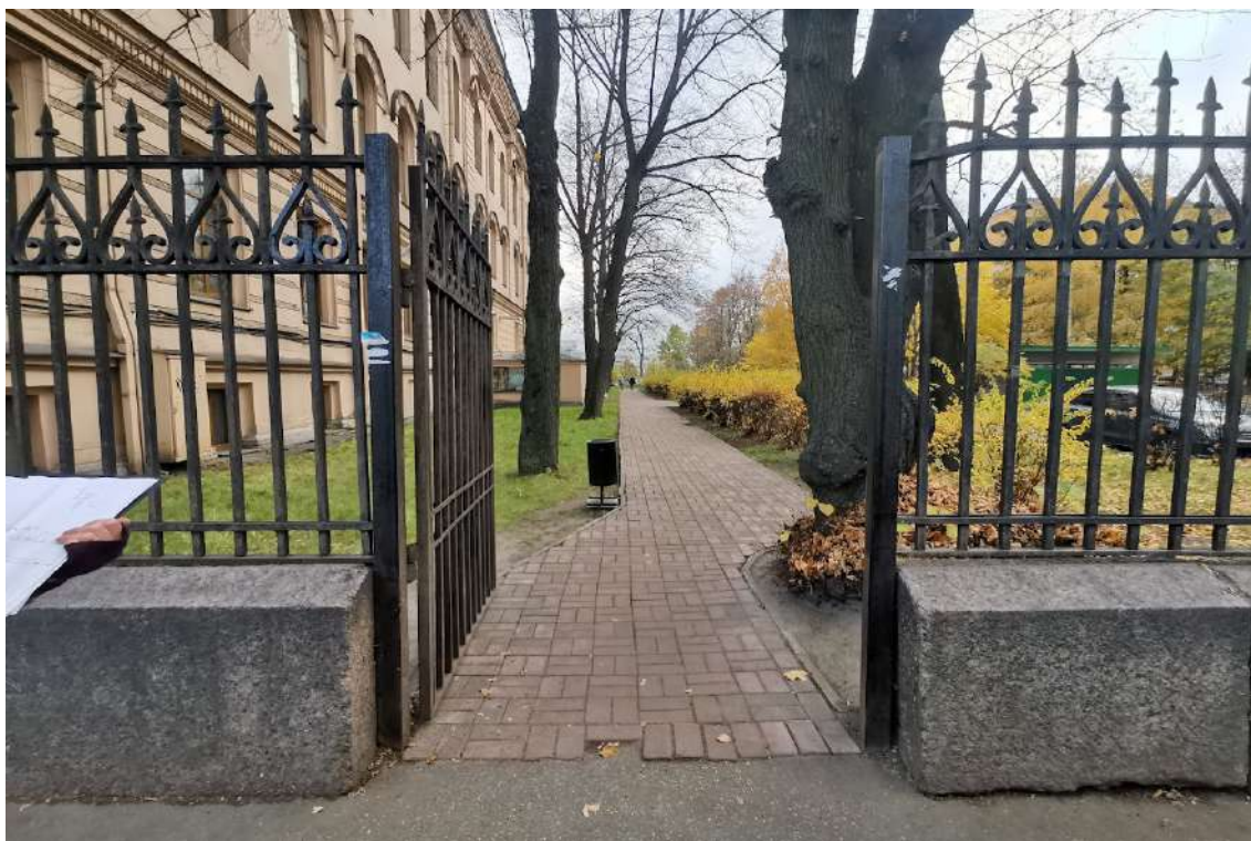
Фото №22. Вид на калитку со стороны ул. Комсомола. Установлены поздние стойки взамен утраченных.
