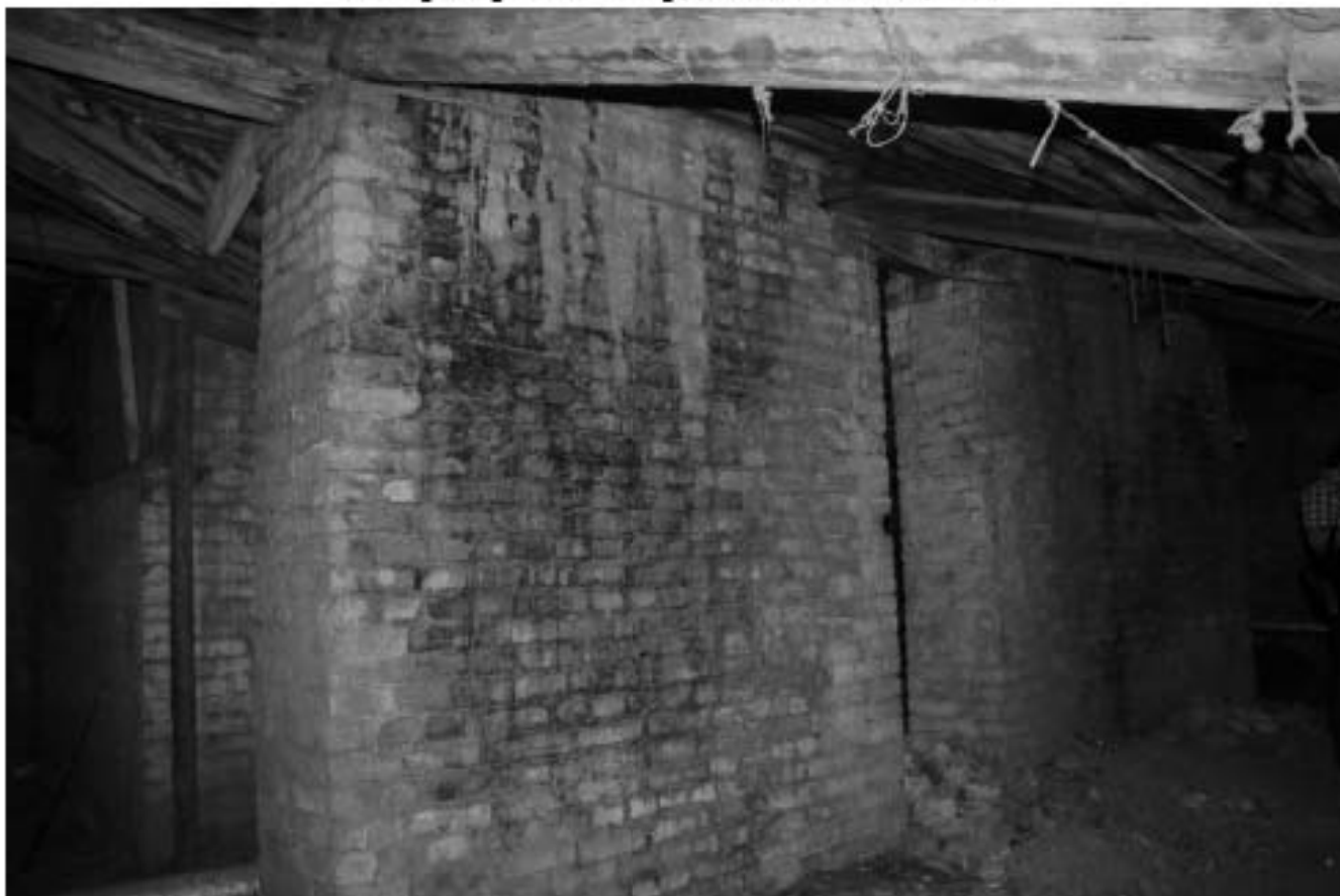
56. Пространство чердачного помещения
