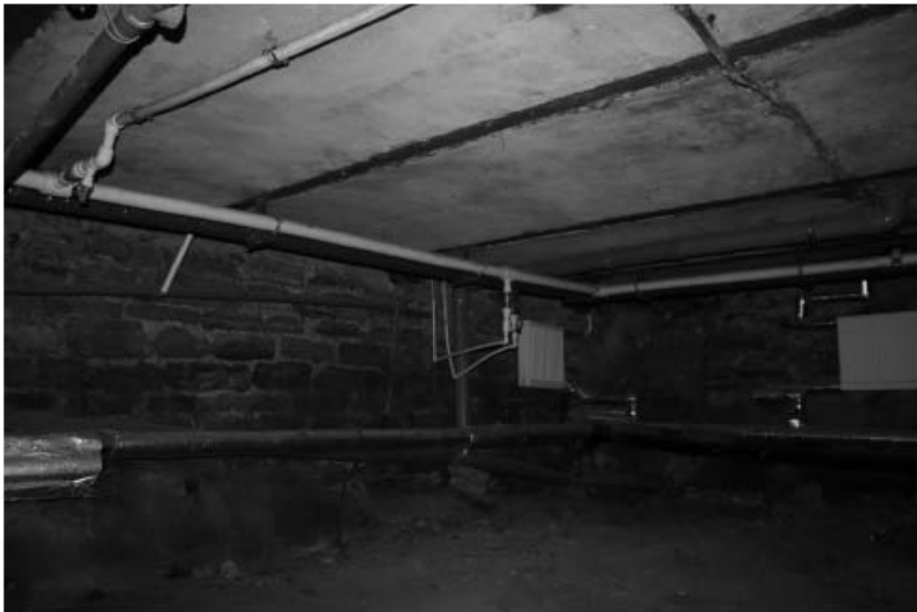
21. Фрагмент подвального помещения
