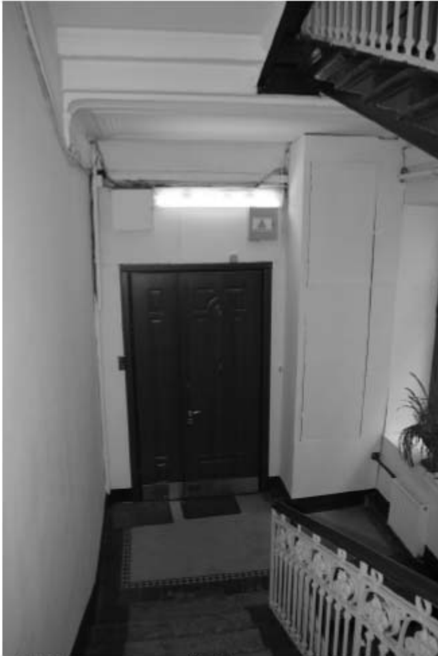
33. Интерьер парадной. Дверь жилого помещения.
