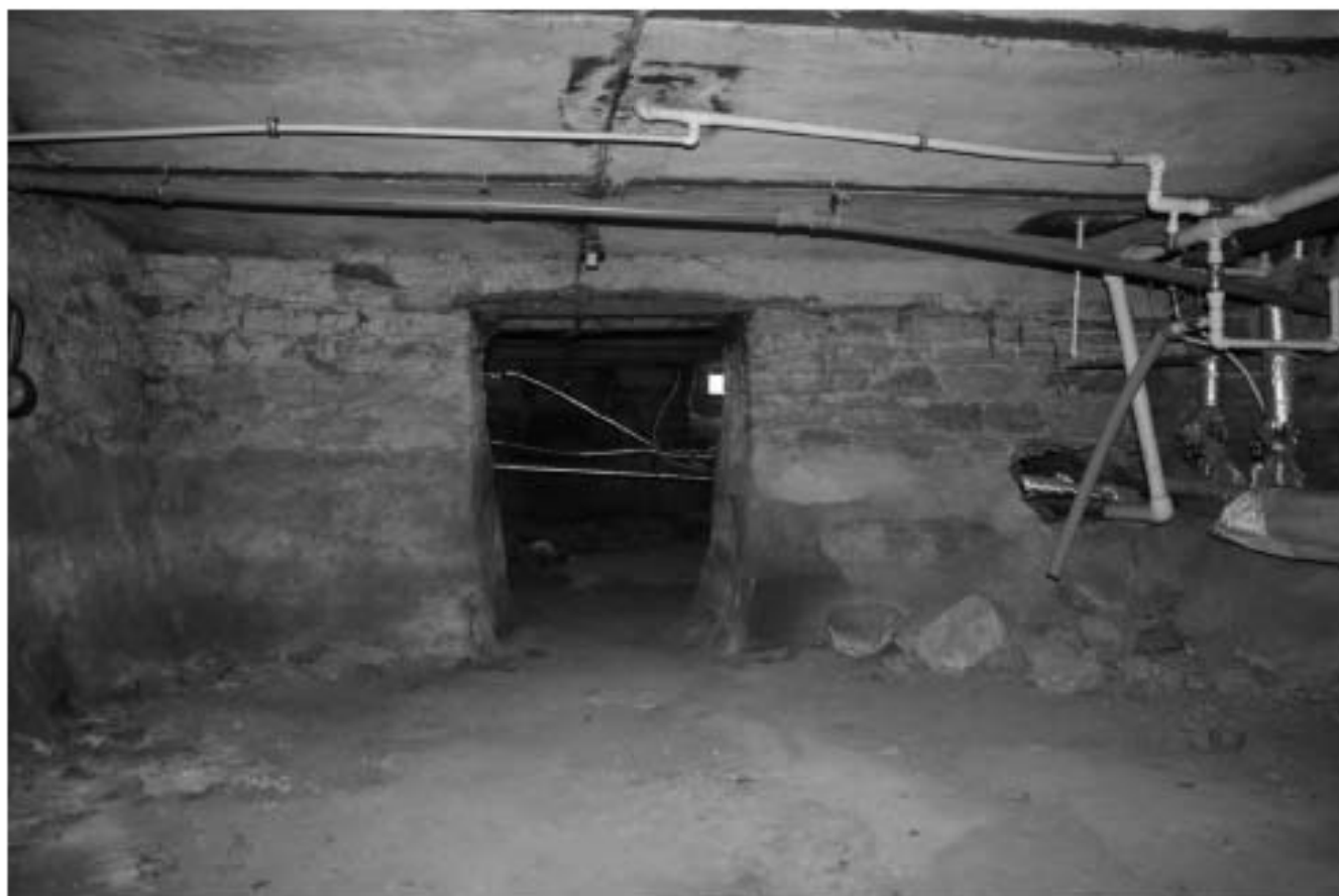
20. Фрагмент подвального помещения
