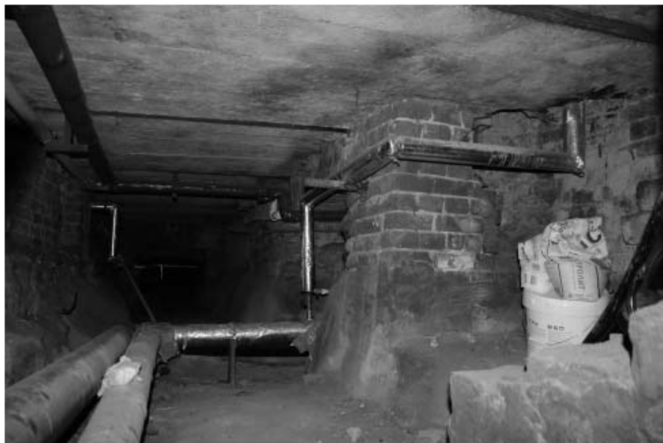
17. Фрагмент подвального помещения
