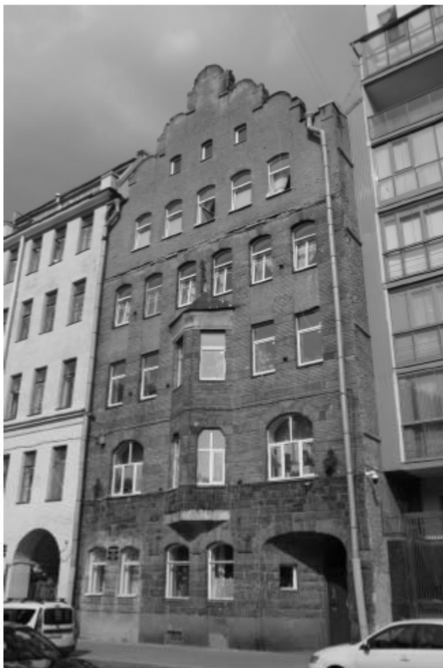
1. Общий вид главного фасада с Таврической улицы. Вид с юго-запада
