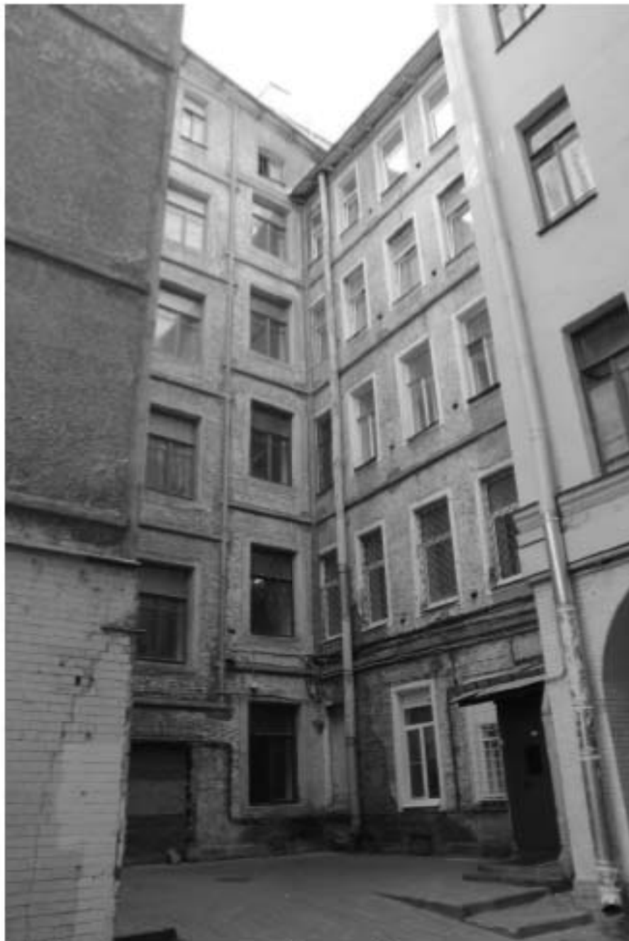
5. Фрагмент дворового фасада. Вид с северо-востока.
