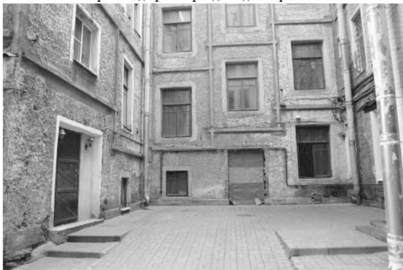
13. Фрагмент дворового фасада. Вид с севера.
