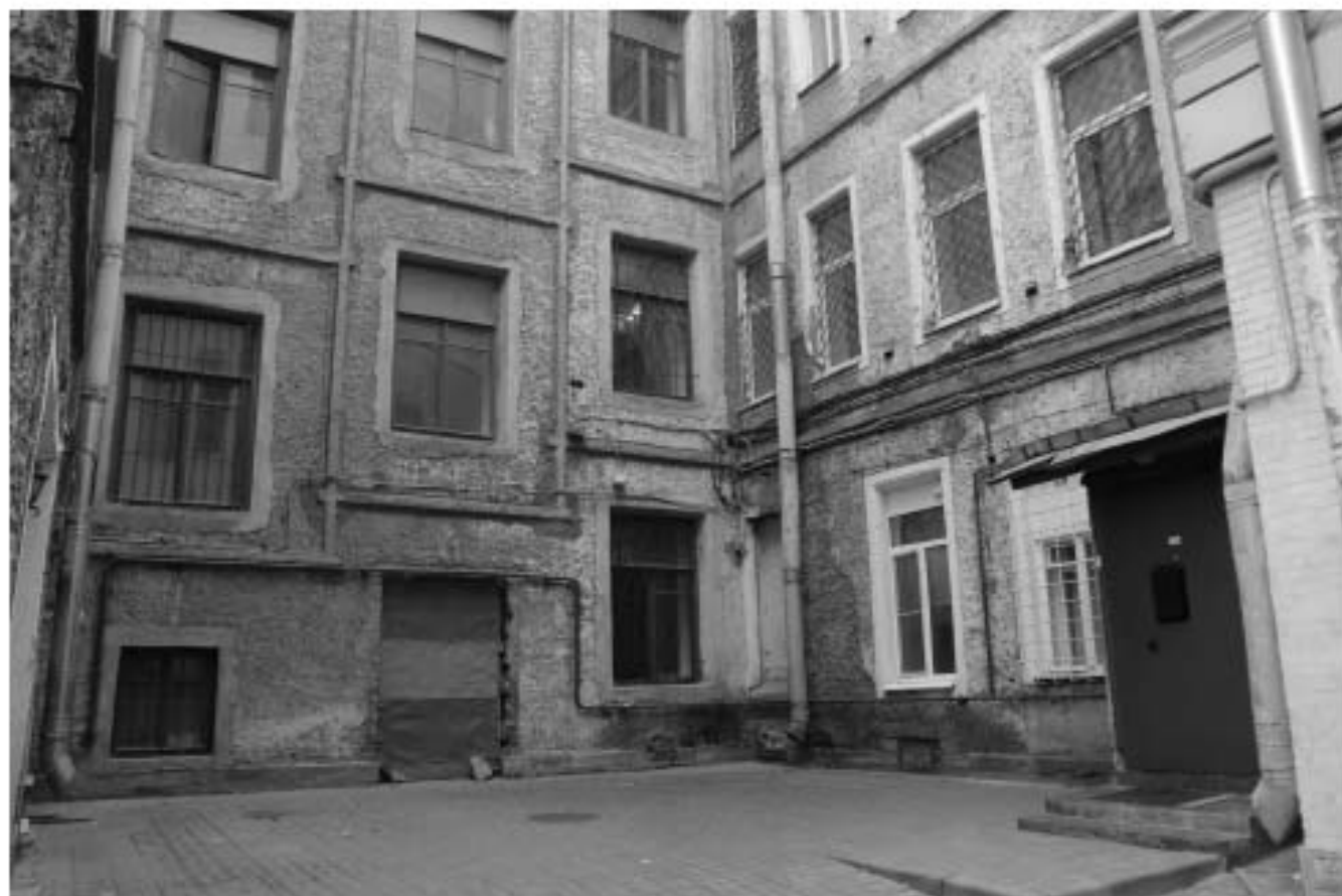
12. Фрагмент дворового фасада. Вид с северо-востока
