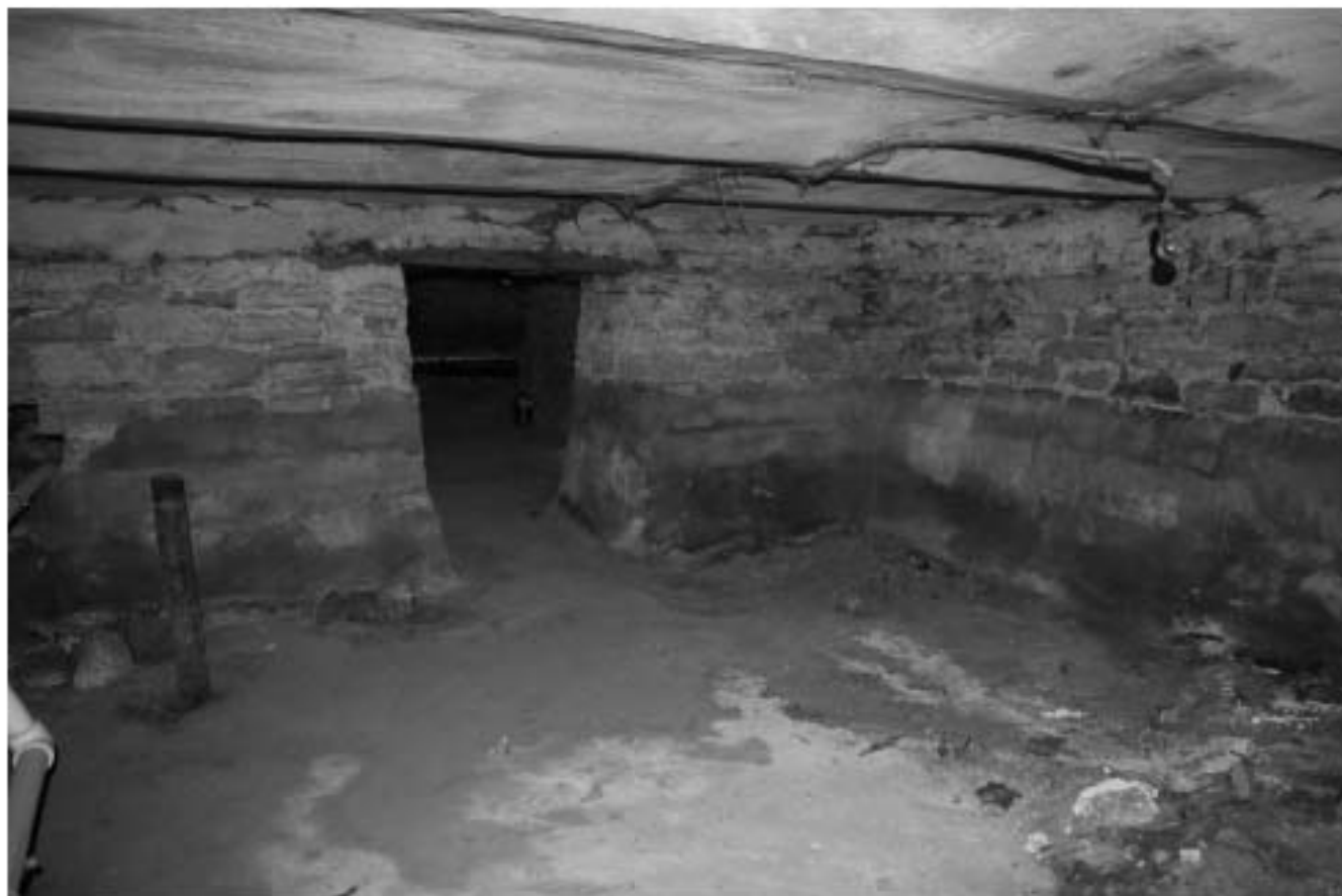
23. Фрагмент подвального помещения
