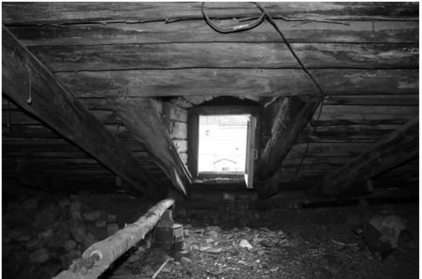
58. Пространство чердачного помещения. Чердачное окно.
