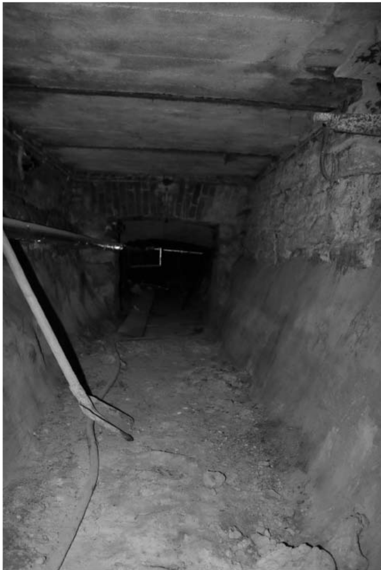
18. Фрагмент подвального помещения
