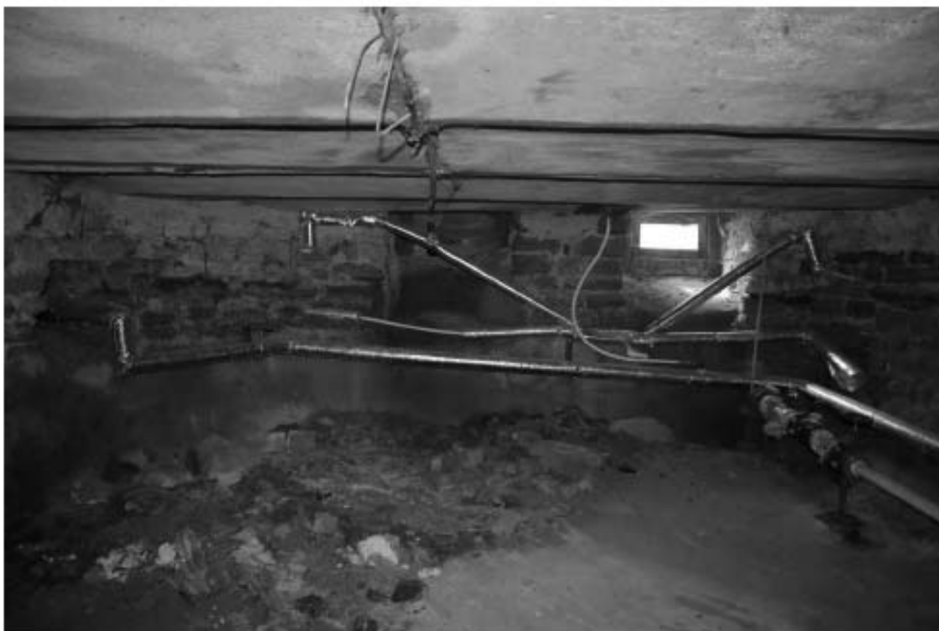
22. Фрагмент подвального помещения
