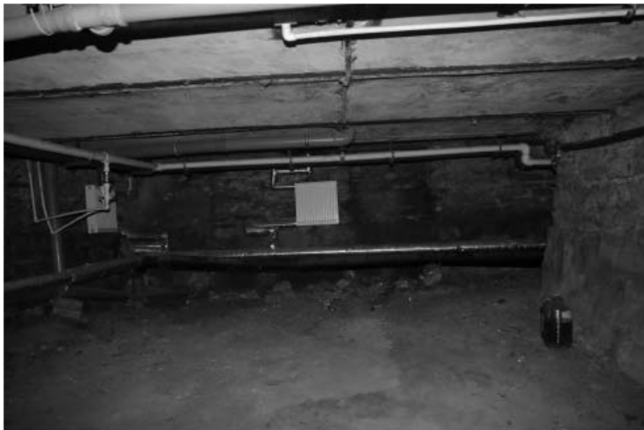
25. Фрагмент подвального помещения
