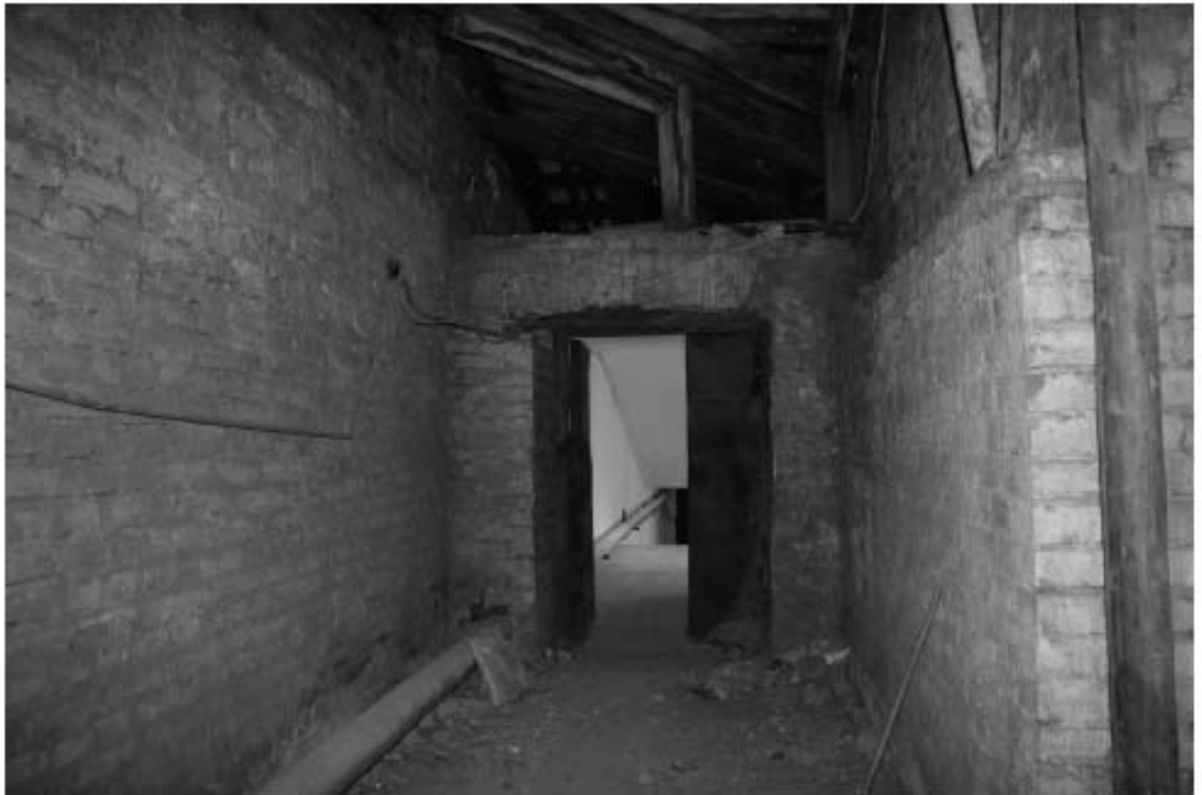
51. Пространство чердачного помещения. Дверь входа на чердак.
