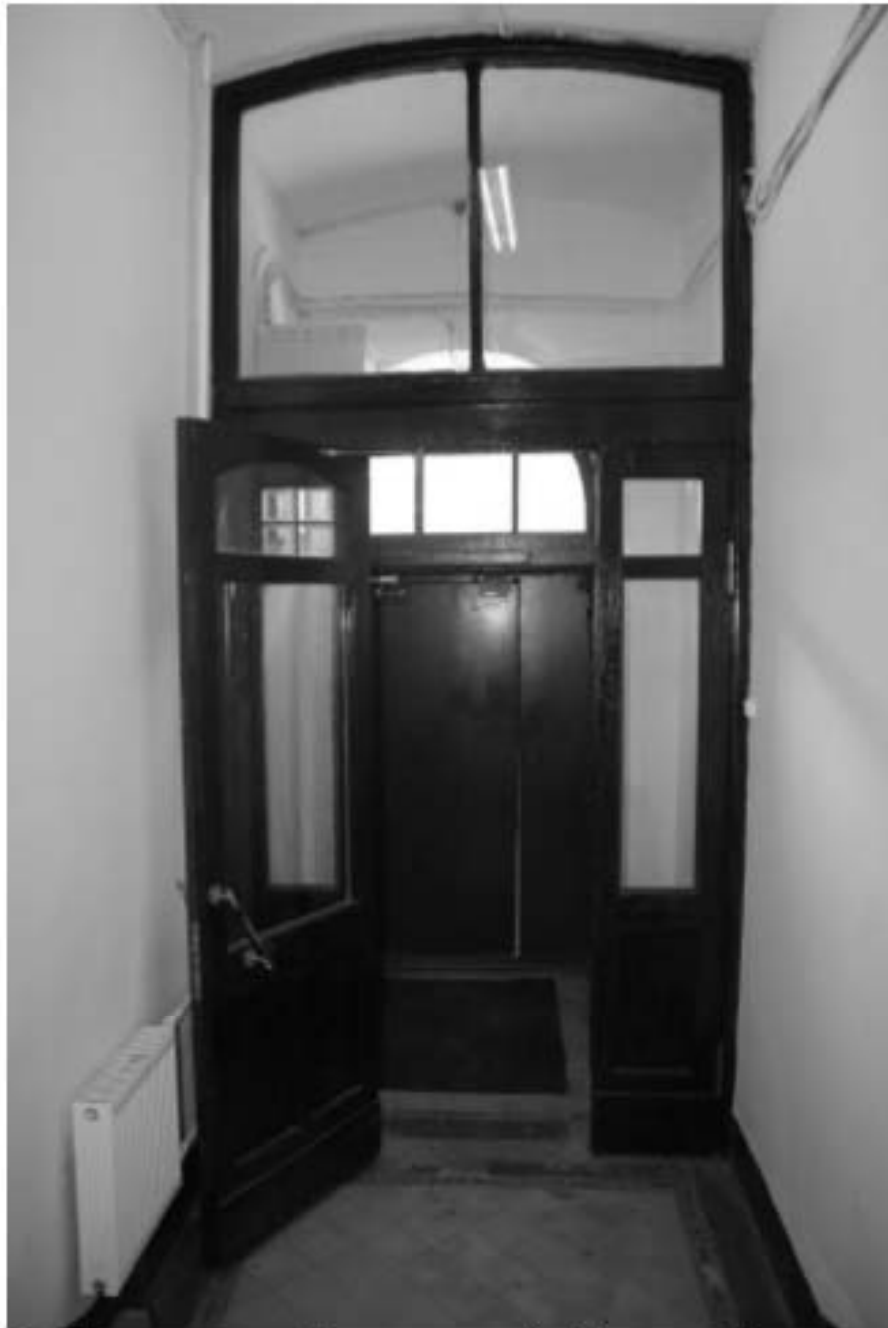
30. Интерьер вестибюля парадной. Двери тамбура входа
