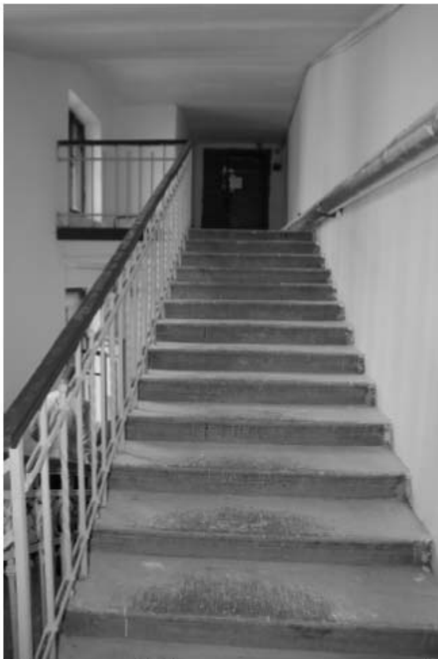
48. Интерьер парадной. Фрагмент лестницы на чердачный этаж
