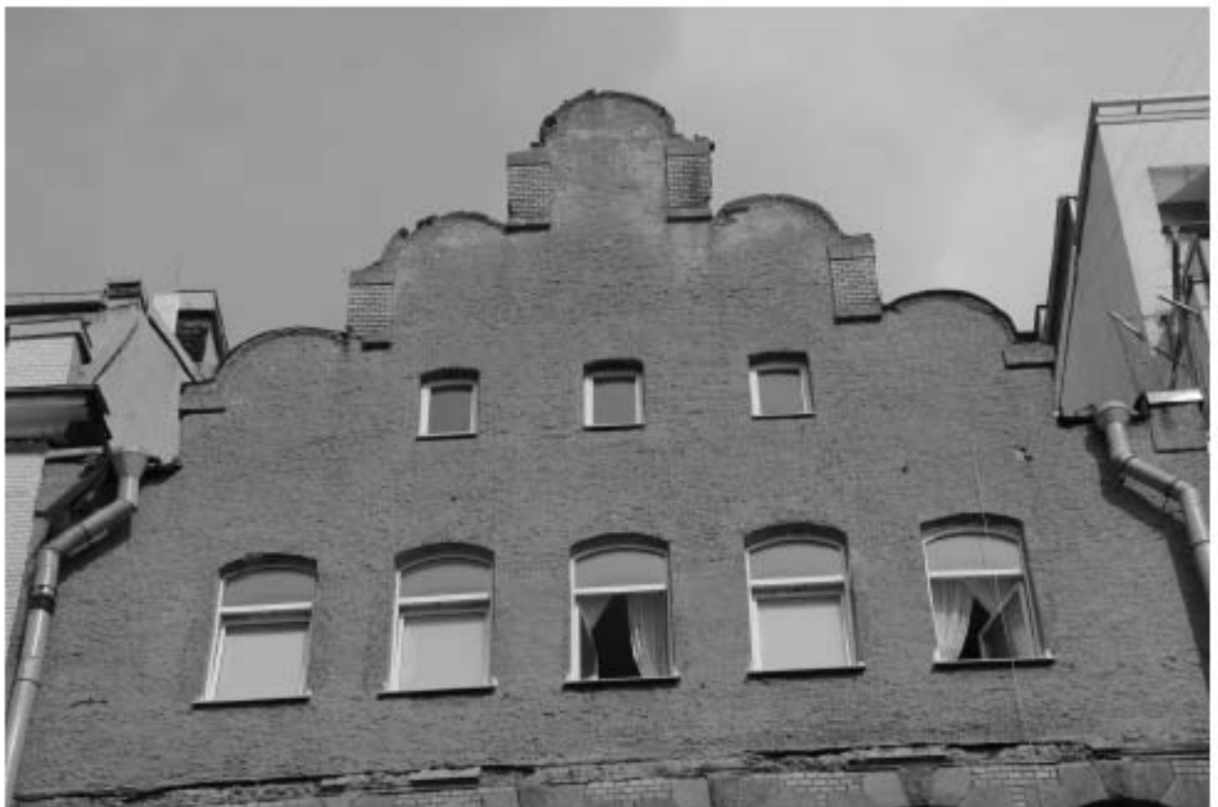
11. Фрагмент главного фасада. Вид с запада.
