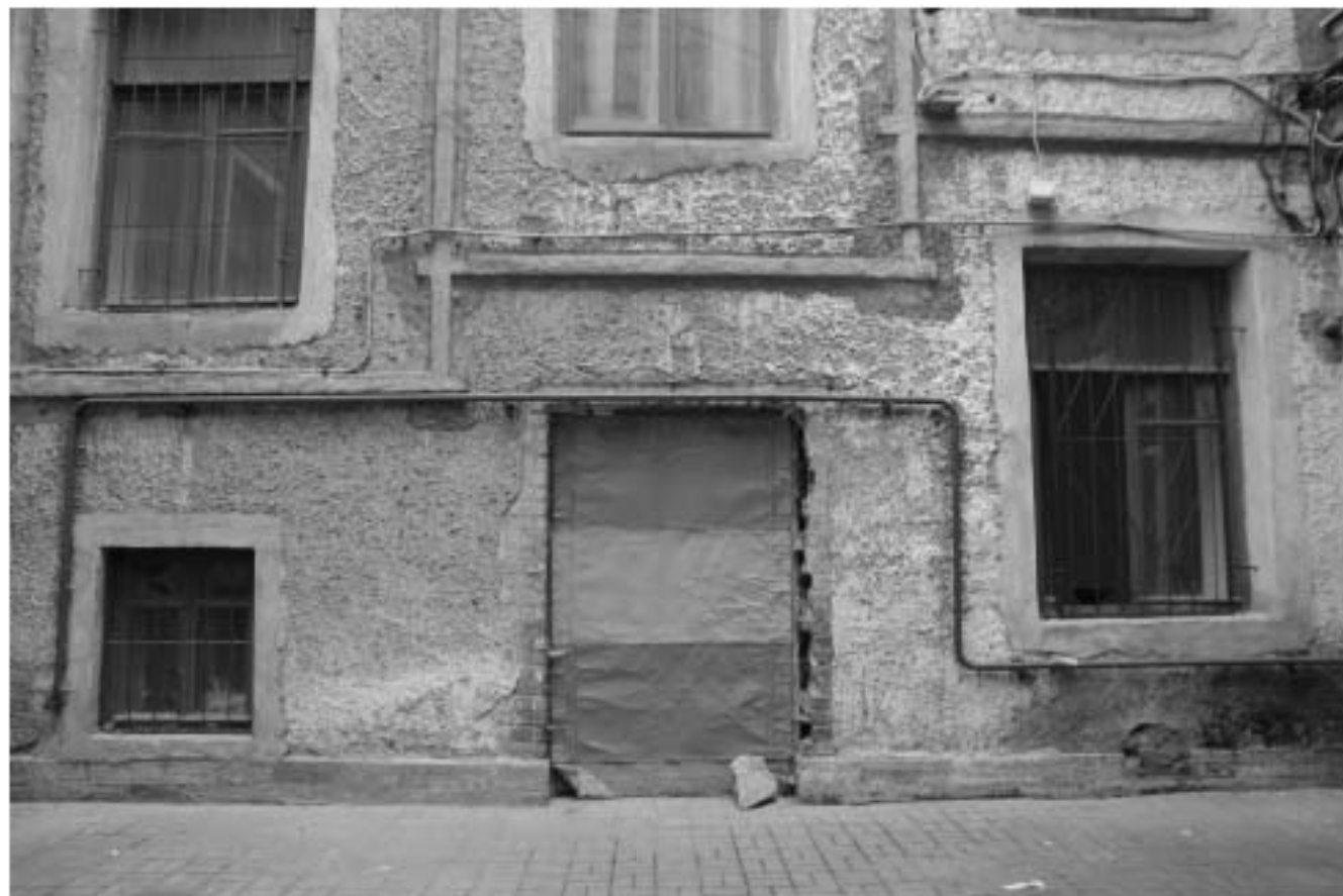
14. Фрагмент дворового фасада. Вид с севера.
