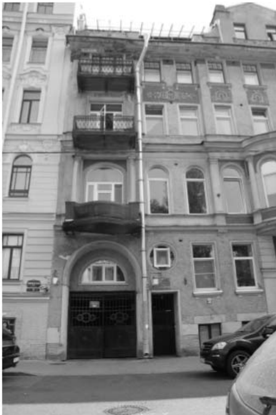
7. Фрагмент главного фасада по улице Таврическая. Воротный проезд и ворота входа. Вид с запада
