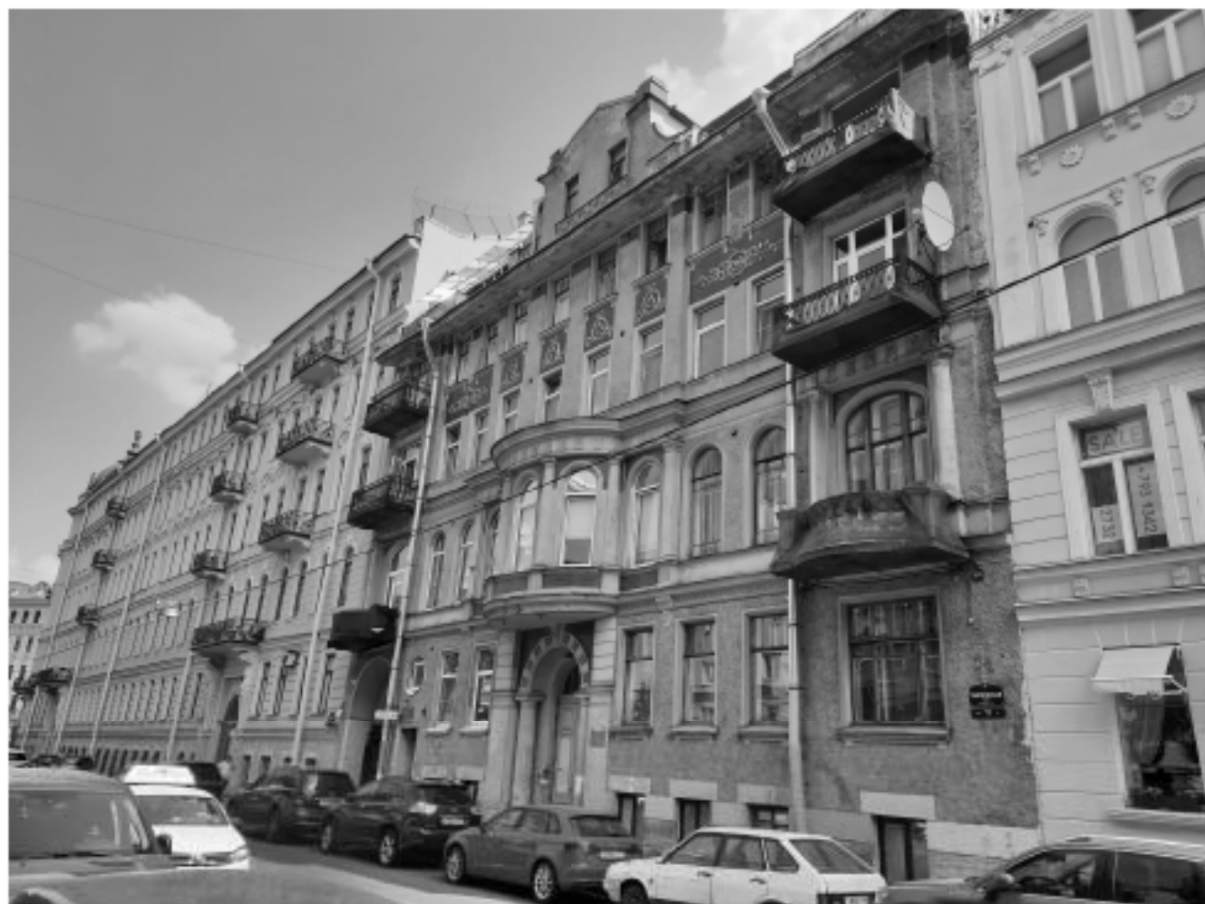
1. Главный фасад по улице Таврическая. Вид с юго-запада
