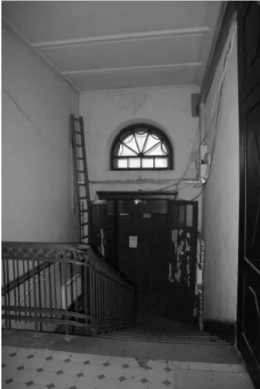
57. Интерьер вестибюля дворовой парадной. Двери тамбура входа
