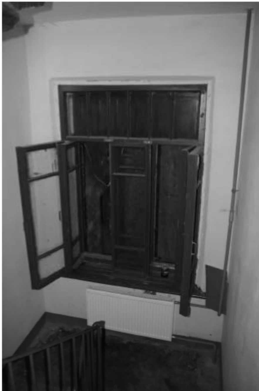
75. Интерьер дворовой парадной в проездной арке. Оформление оконного проема межэтажной лестничной площадки
