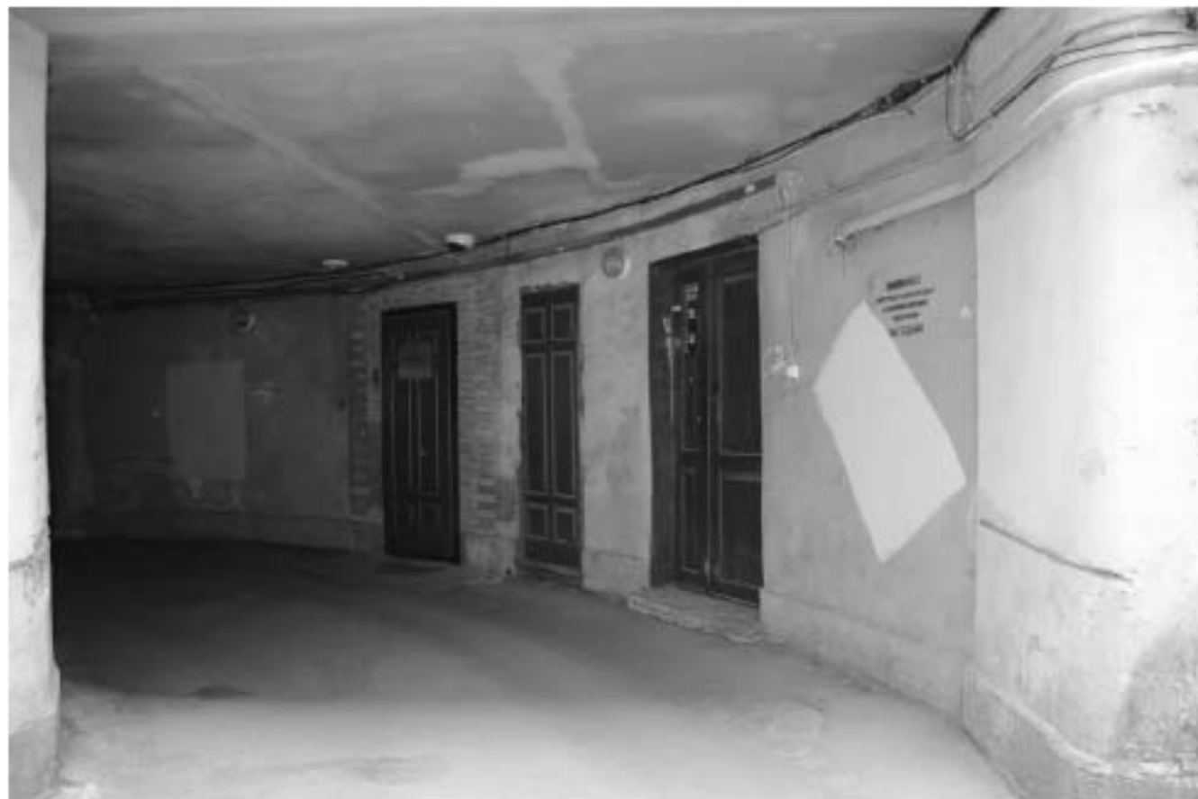
27. Дверные проемы в проездной арке
