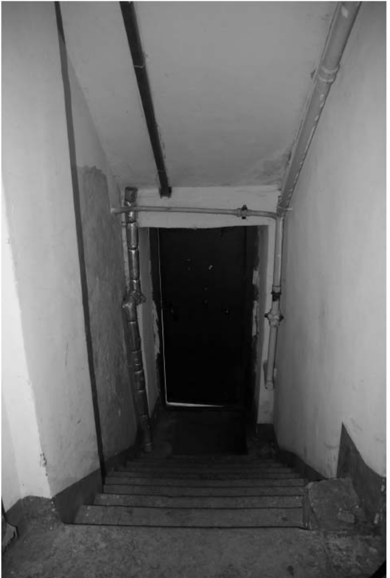
72. Интерьер первого этажа дворовой парадной в проездной арке. Дверь входа
