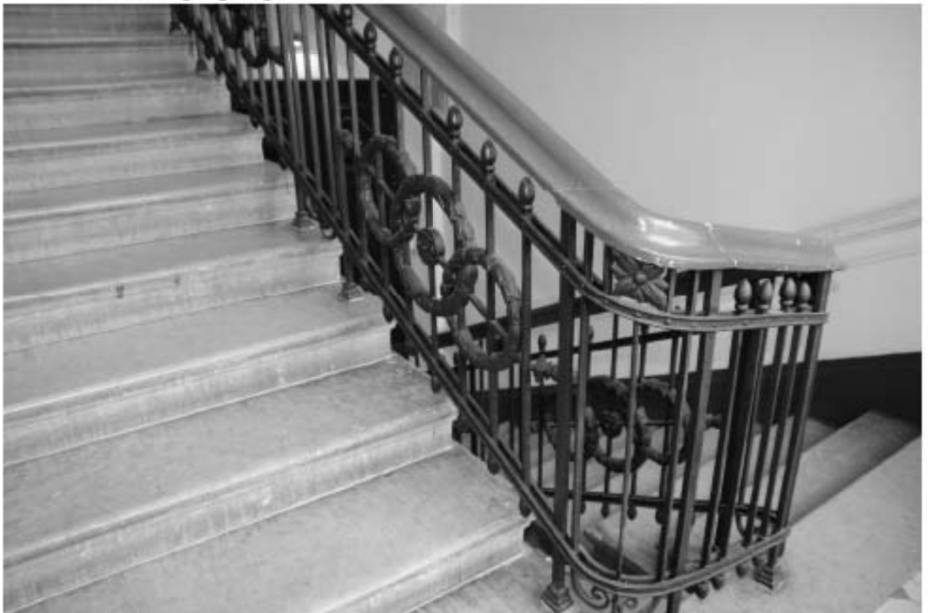
54. Интерьер парадного входа. Фрагмент лестничного ограждения
