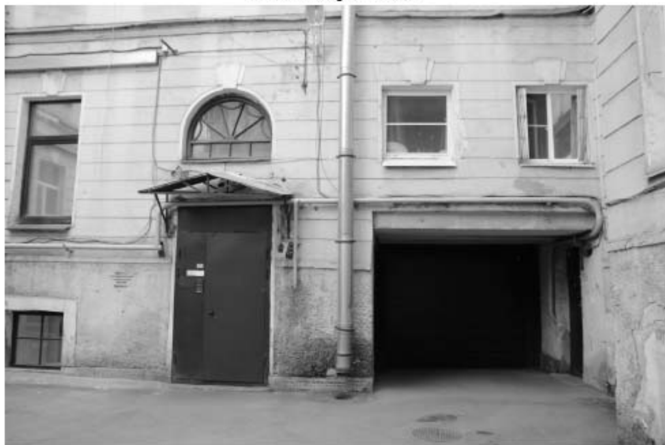
36. Фрагмент дворового фасада. Дверь входа в дворовую парадную с навесным металлическим козырьком. Оформление оконных проемов над проездной аркой. Вид с запада
