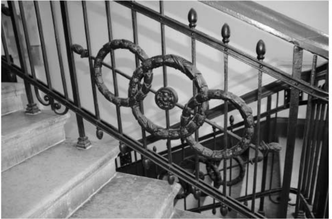
55. Интерьер парадного входа. Фрагмент лестничного ограждения
