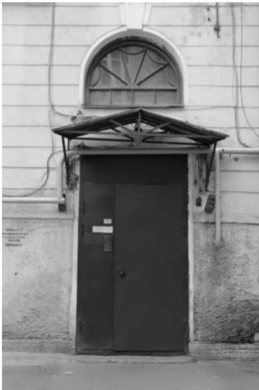
37. Фрагмент дворового фасада. Дверь входа в дворовую парадную с навесным металлическим козырьком. Вид с запада
