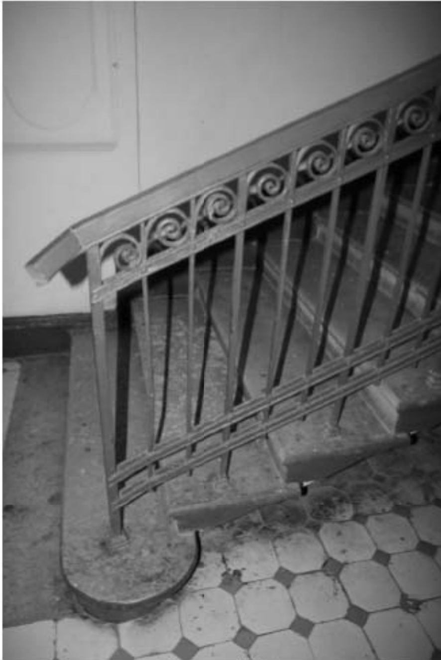
60. Интерьер вестибюля дворовой парадной. Фрагмент лестничного ограждения
