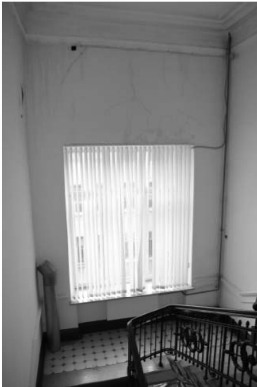
52. Интерьер парадного входа. Оформление оконного проема межэтажной лестничной площадки
