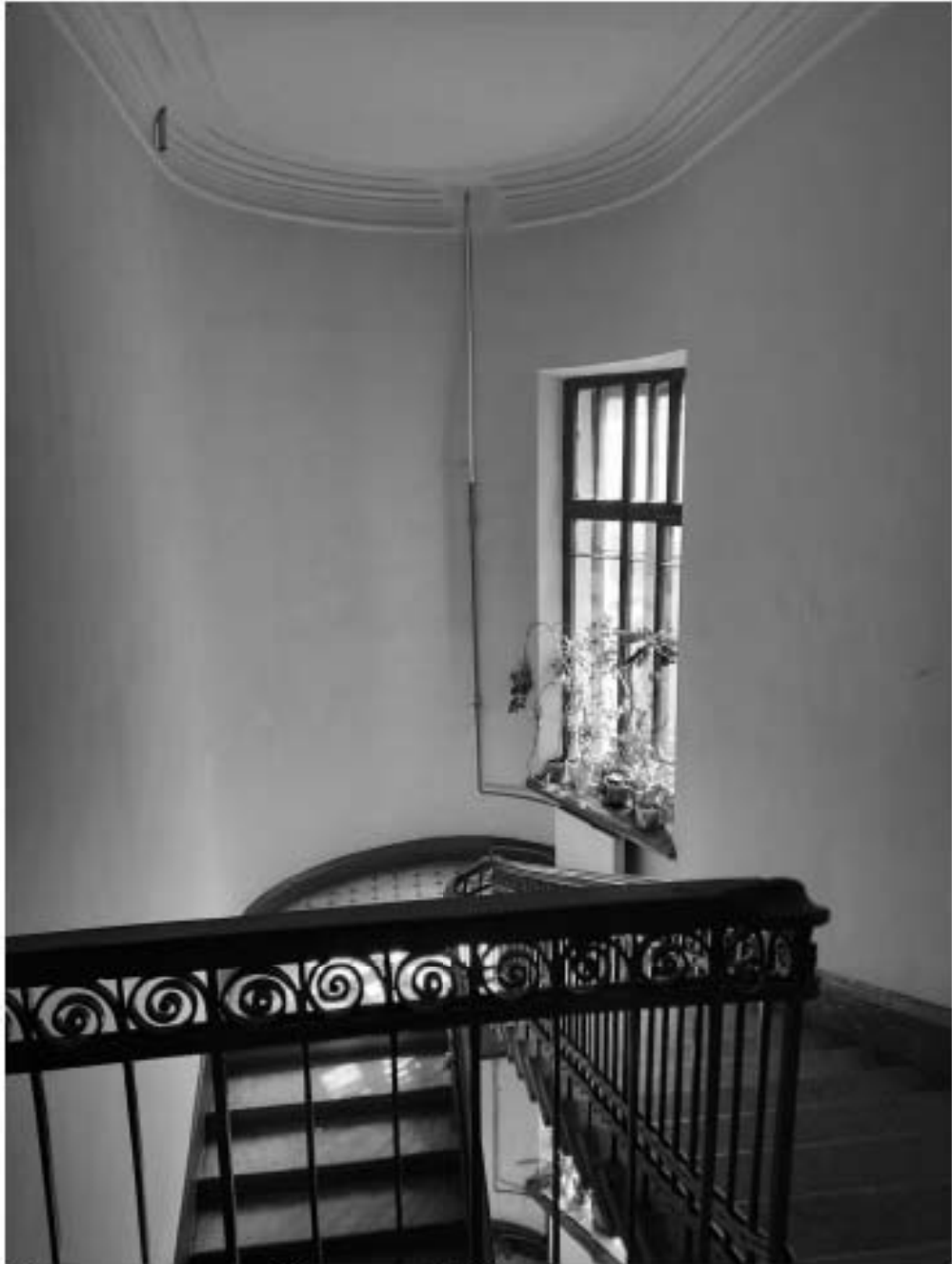
65. Интерьер дворовой парадной. Лестничная площадка пятого этажа
