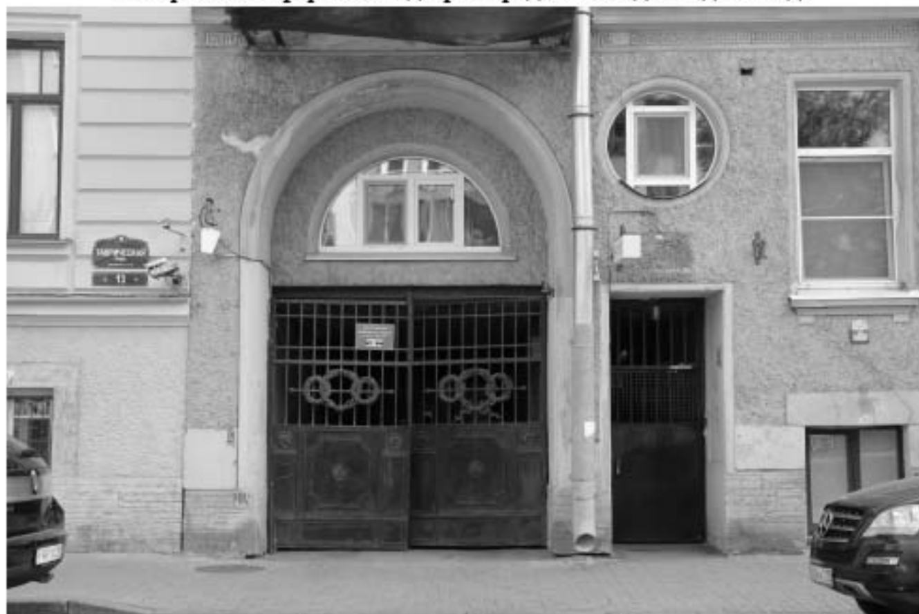
12. Фрагмент главного фасада по улице Таврической. Ворота проездной арки, ворота входа. Вид с запада
