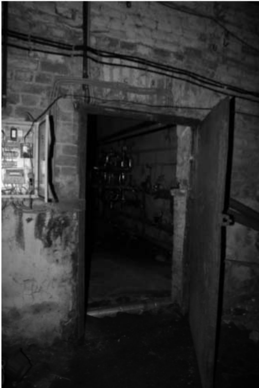
33. Фрагмент интерьера подвального помещения. Дверь прохода между подвальными помещениями
