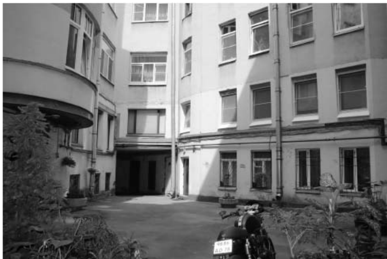
22. Фрагмент дворового фасада. Вид с юга
