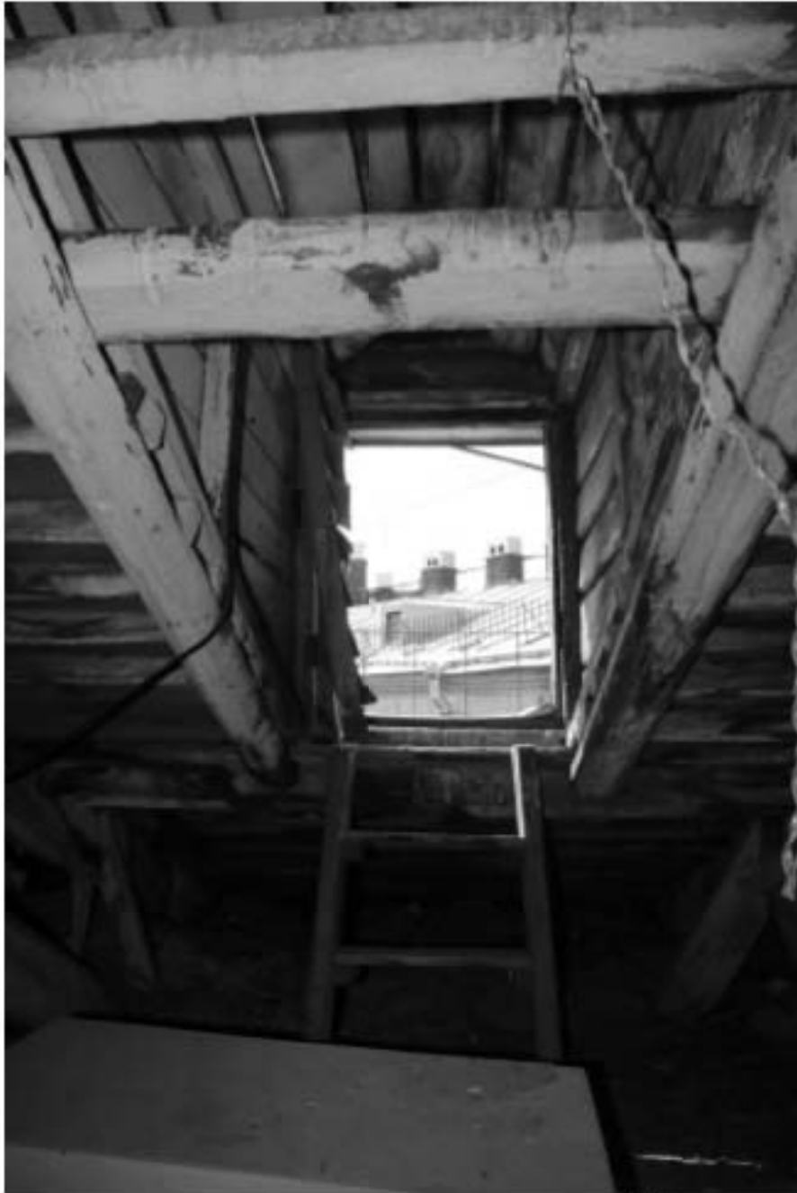
62. Фрагмент интерьера чердачного помещения. Чердачное окно
