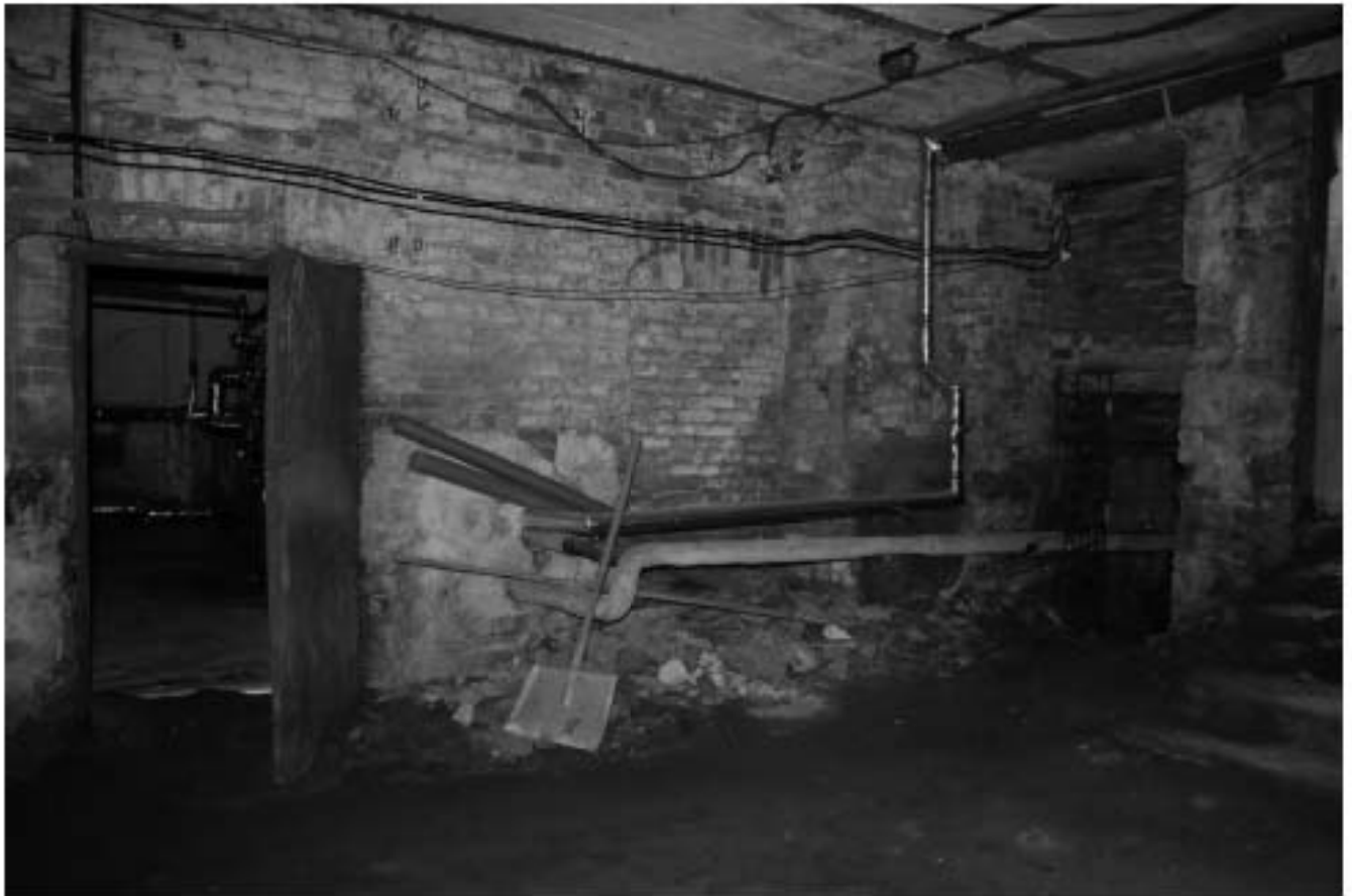
32. Фрагмент интерьера подвального помещения. Проход между подвальными помещениями
