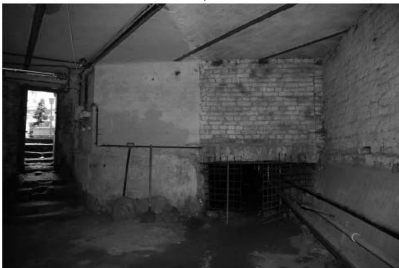
31. Фрагмент интерьера подвального помещения. Дверь входа в подвальное помещение
