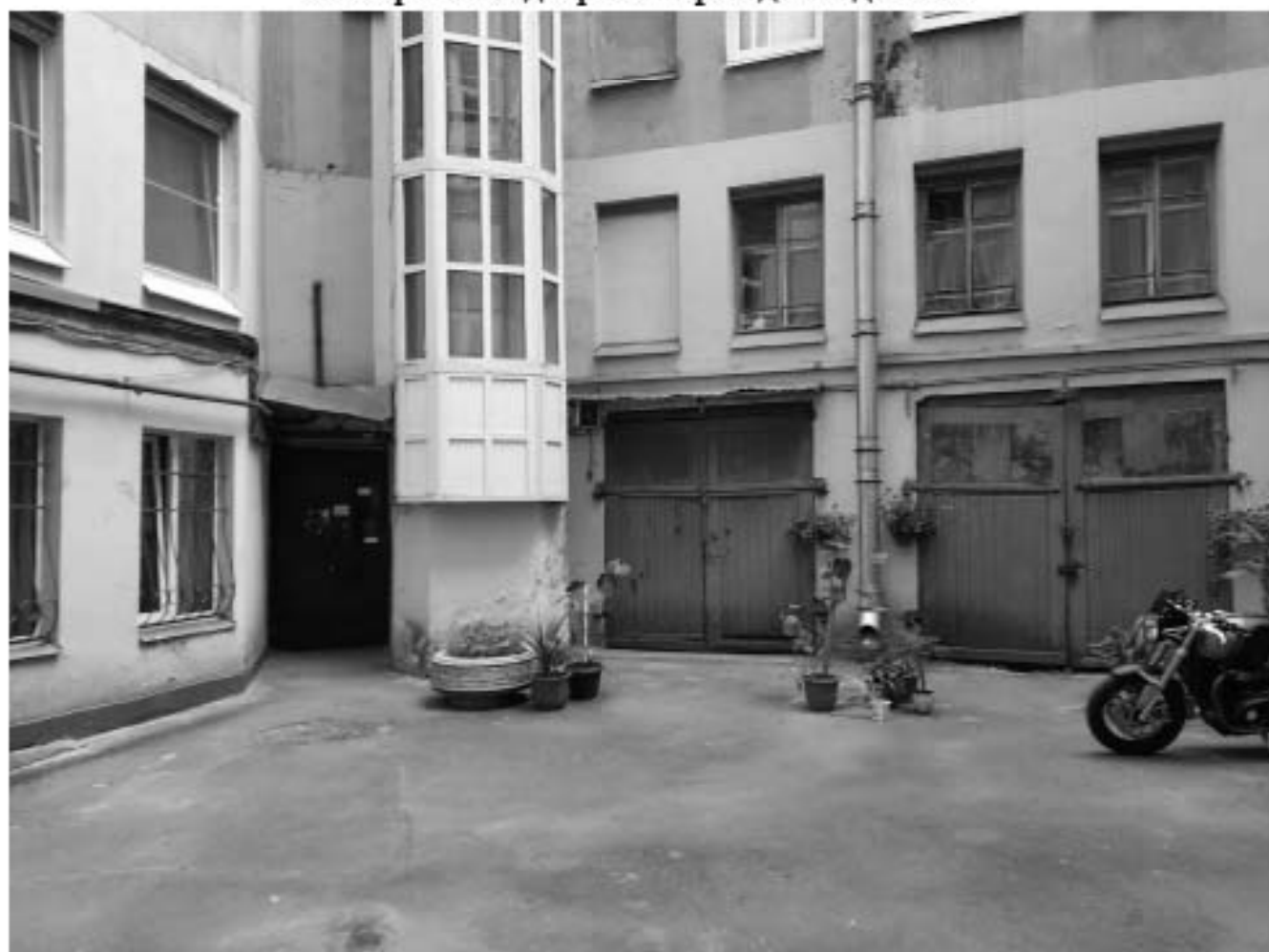
23. Фрагмент дворового фасада. Левее шахты лифта дверь входа в дворовую парадную. Вид с юго-запада
