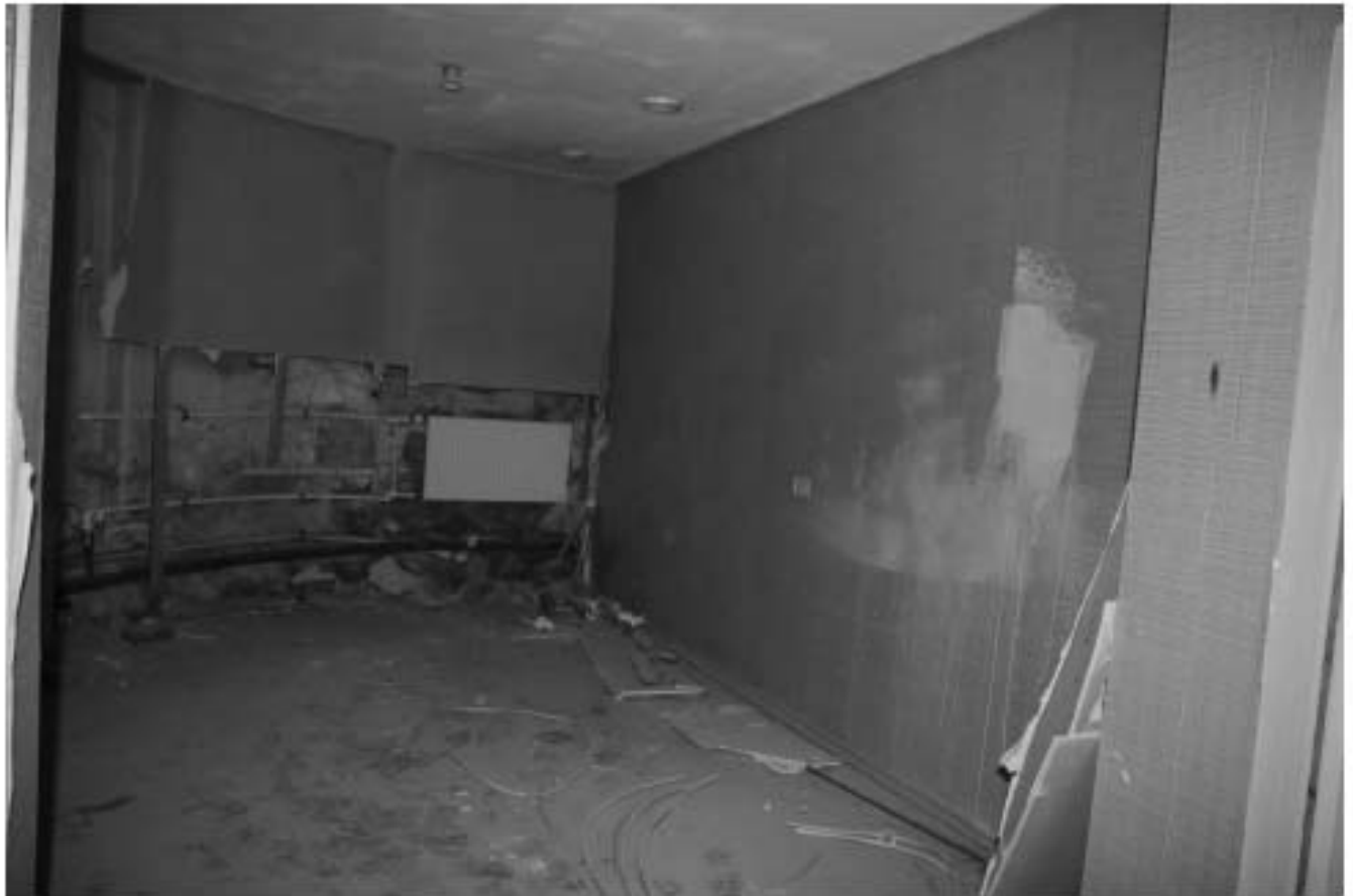
41. Фрагмент интерьера подвального помещения парадной
