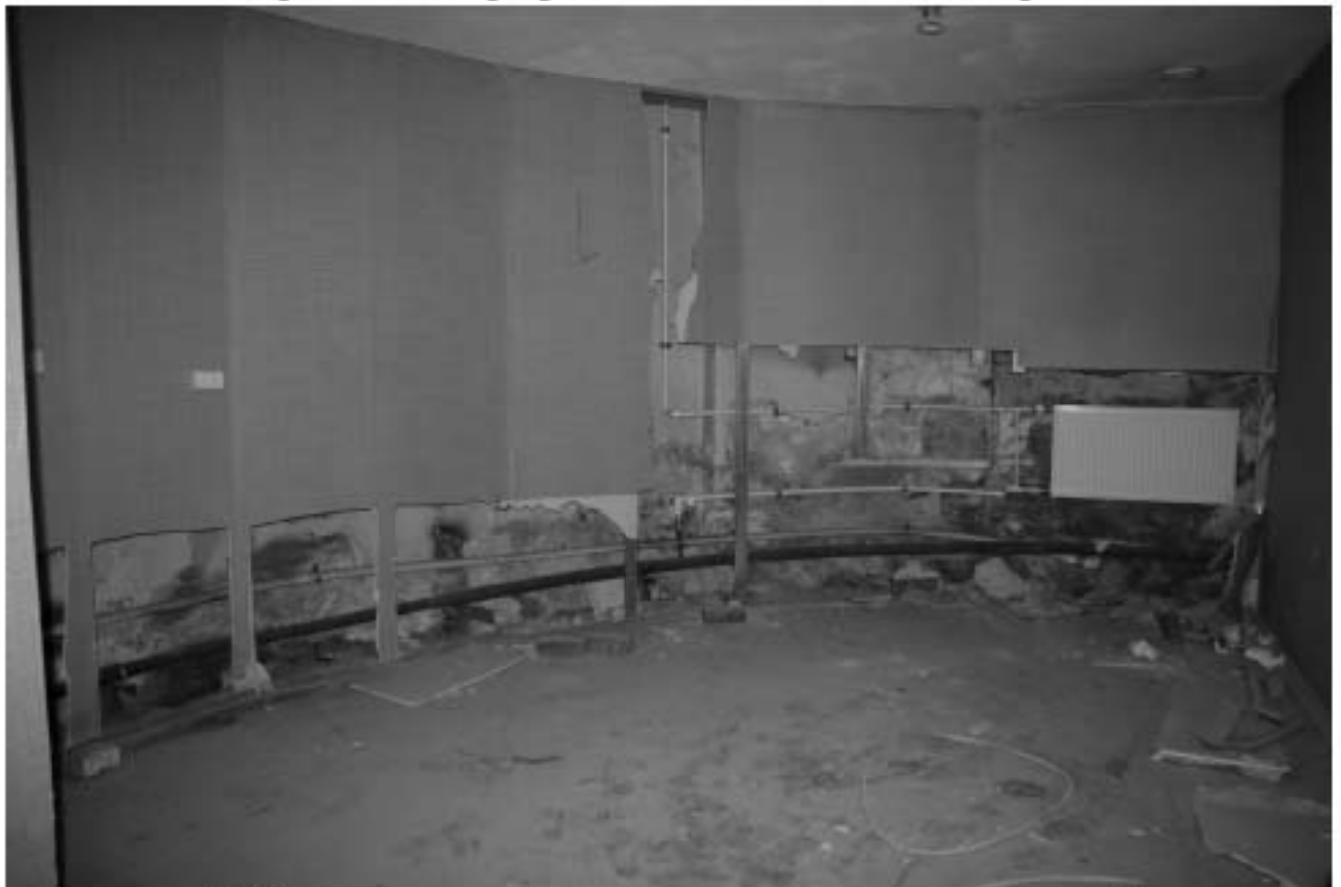
42. Фрагмент интерьера подвального помещения парадной
