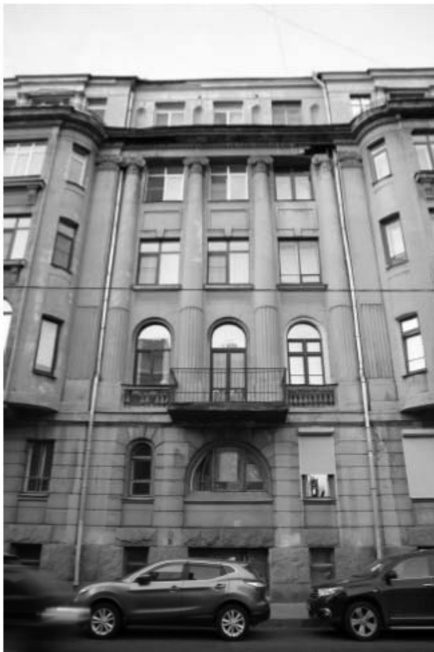
4. Центральная часть главного фасада по улице Таврическая. Оформление оконных проемов. Вид с запада
