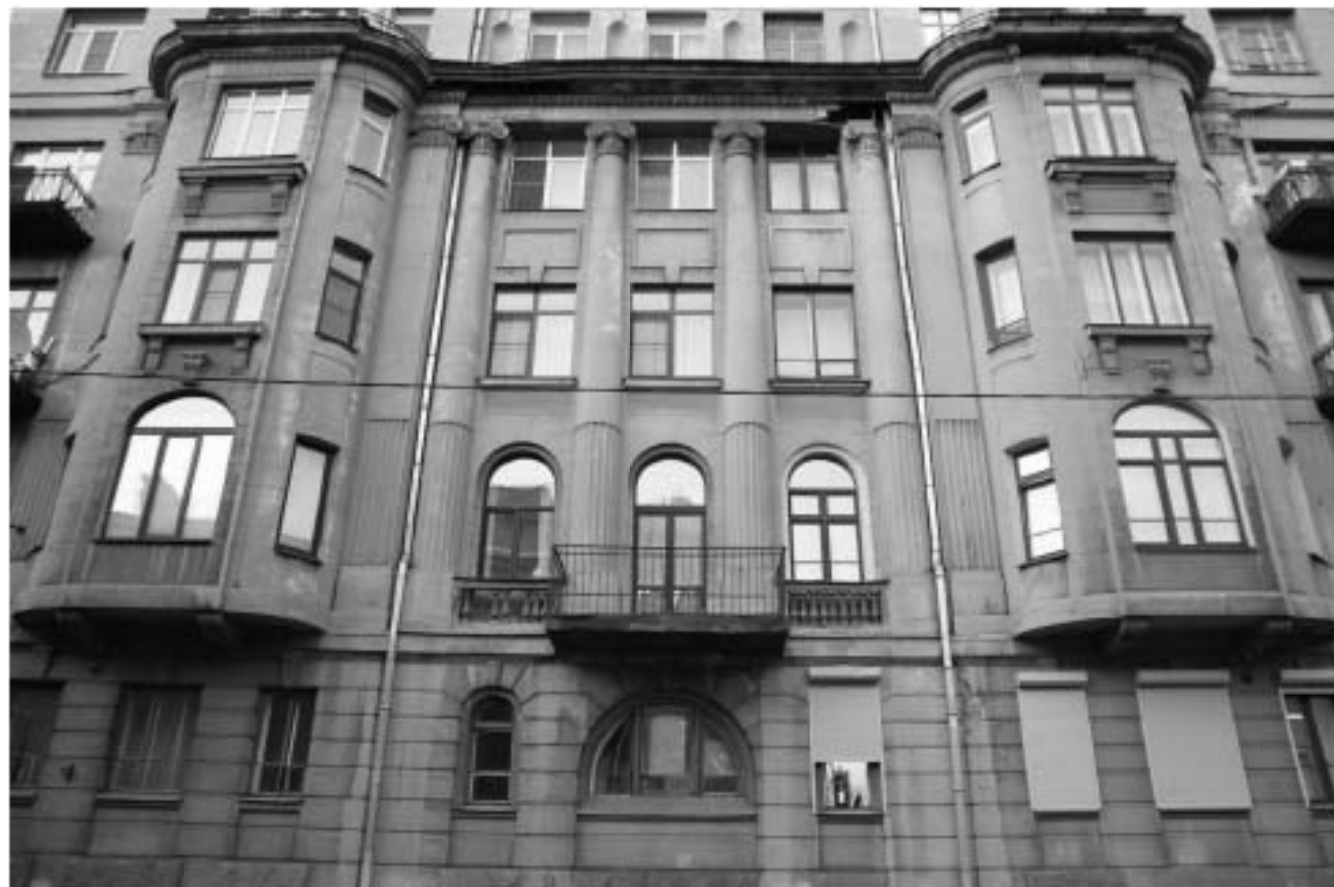
3. Центральная часть главного фасада по улице Таврическая. Вид с запада
