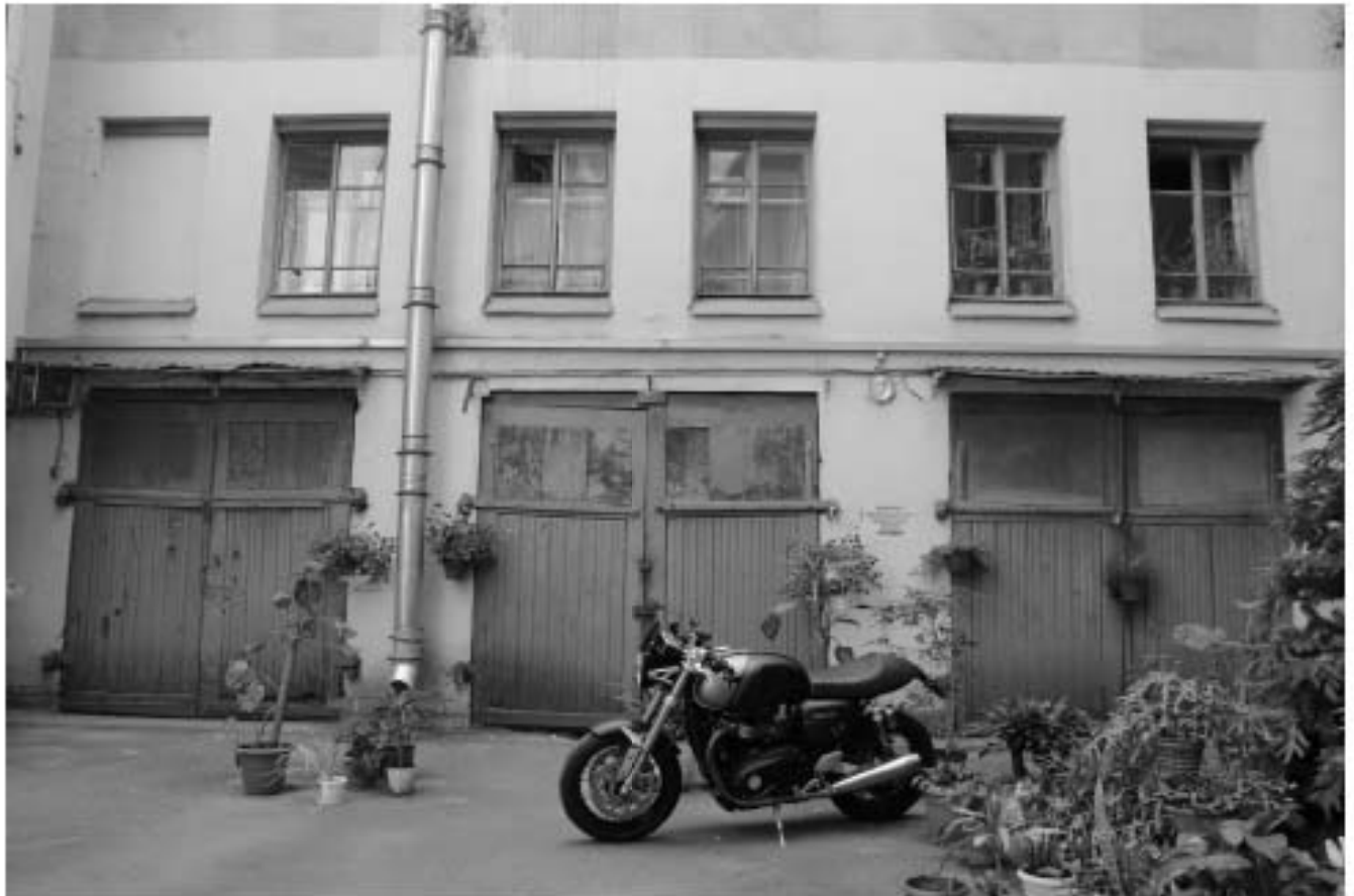
26. Фрагмент дворового фасада. Вид с северо-запада
