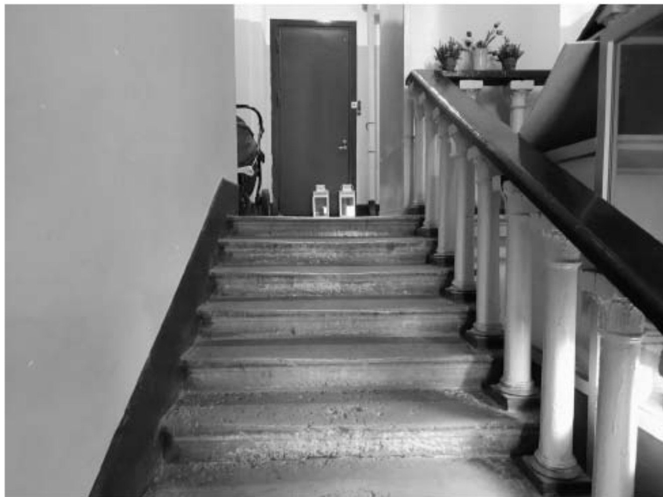
37. Лестница прохода в подвальное помещение парадной. Фрагмент лестничного ограждения
