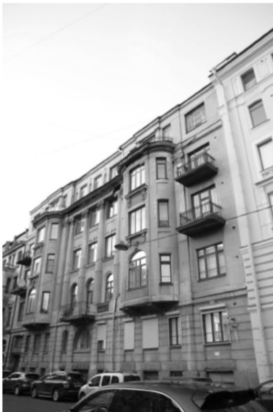
1. Главный фасад по улице Таврическая. Вид с юго-запада
