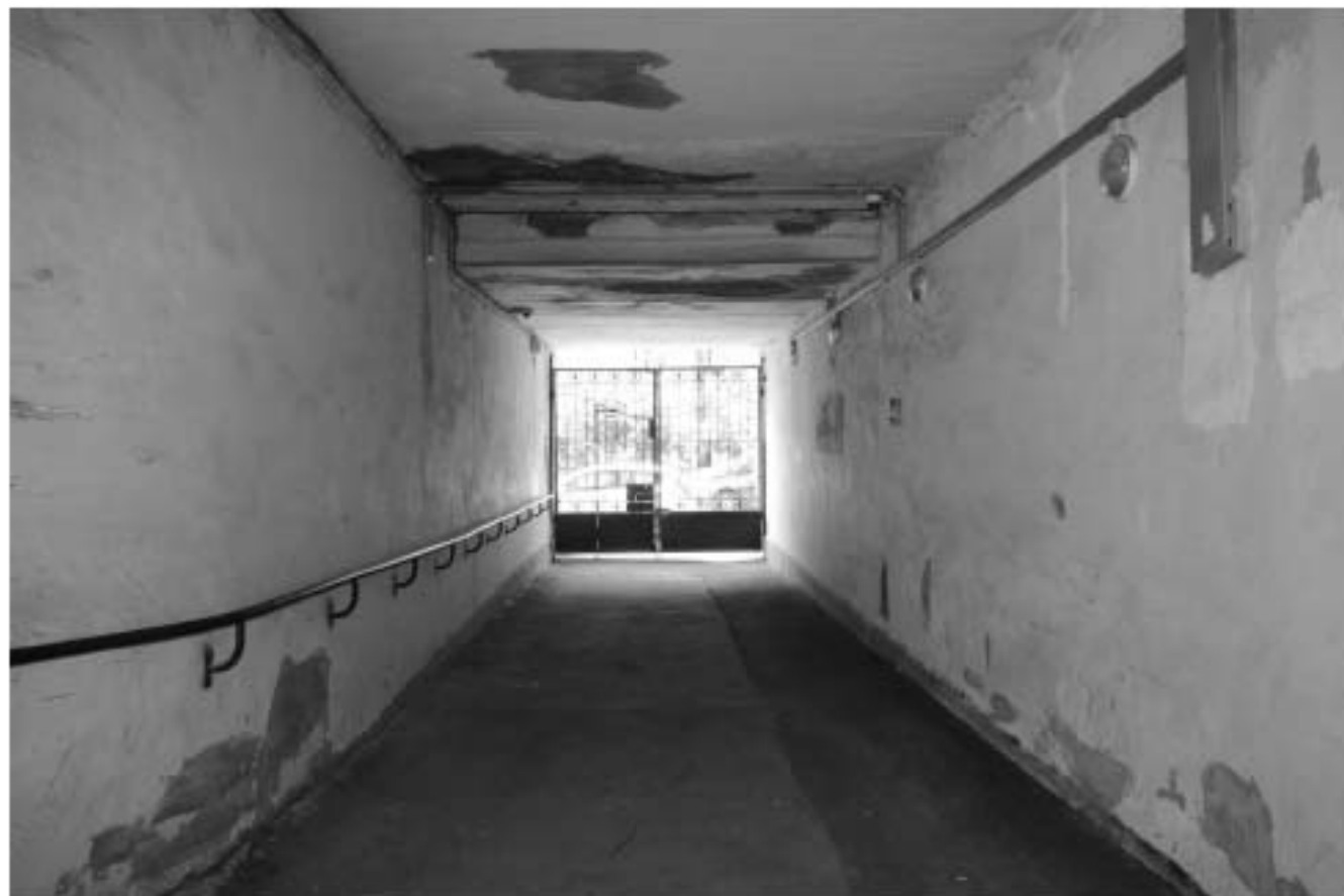
13. Проездная арка. Вид со стороны внутреннего двора на улицу Таврическая
