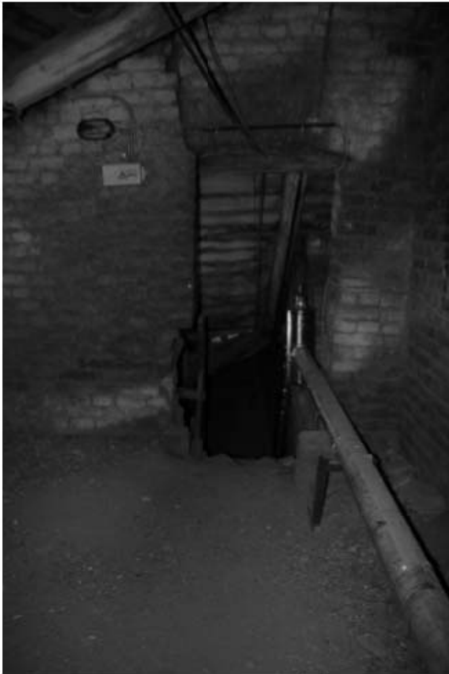
75. Фрагмент интерьера чердачного помещения. Проход между помещениями чердака
