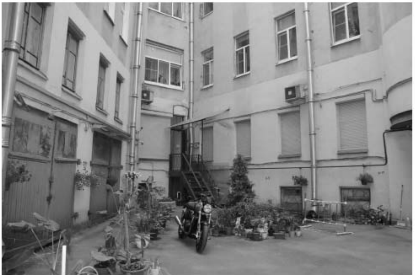
25. Фрагмент дворового фасада. Вид с северо-востока
