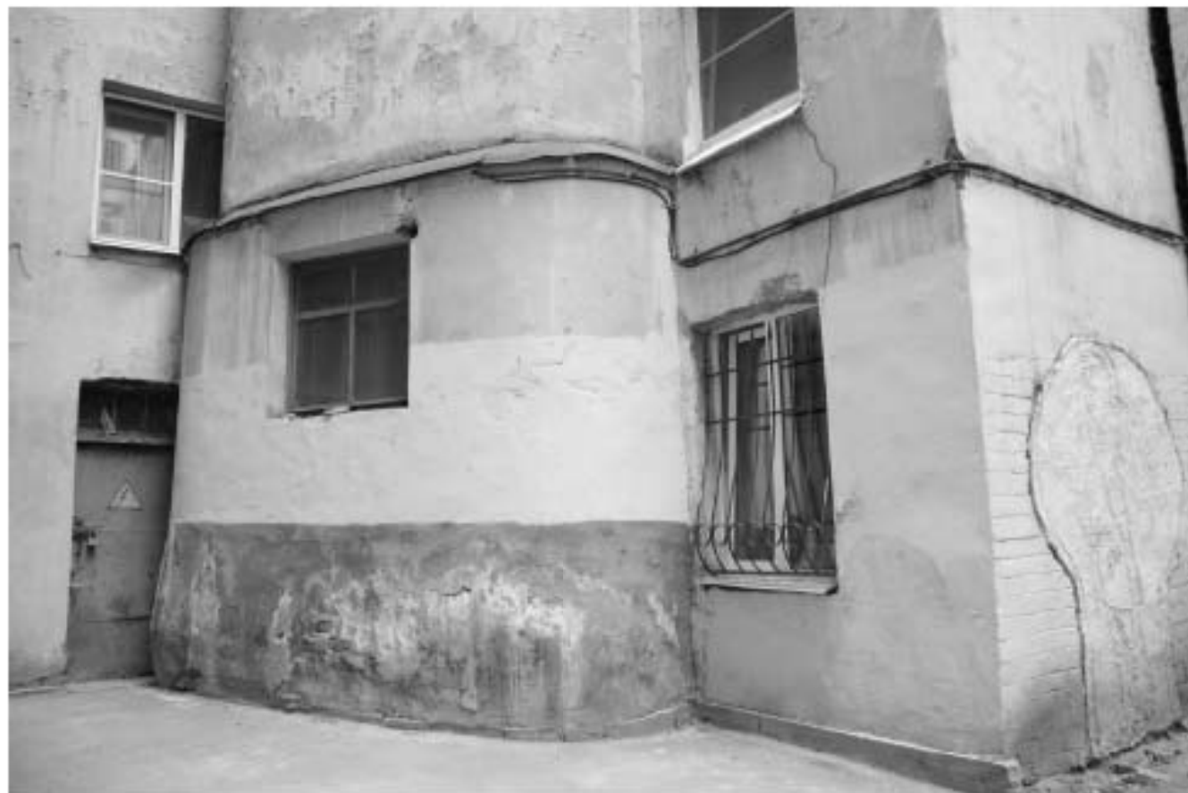
16. Фрагмент дворового фасада, примыкающего к стене дома № 5 по улице Таврическая и стене дома № 36 по Суворовскому проспекту. Вид с востока
