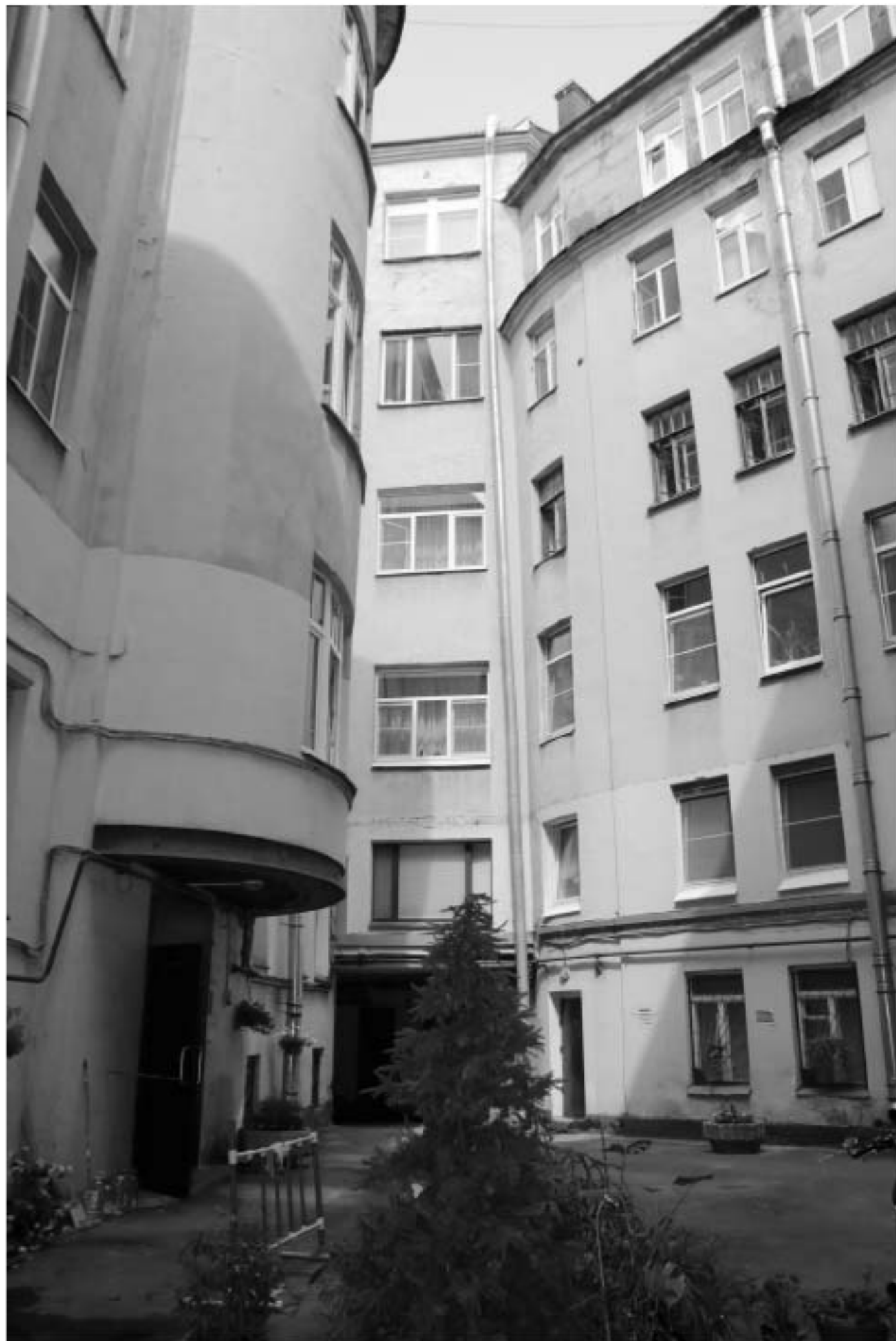
20. Фрагмент дворового фасада. Вид с юга
