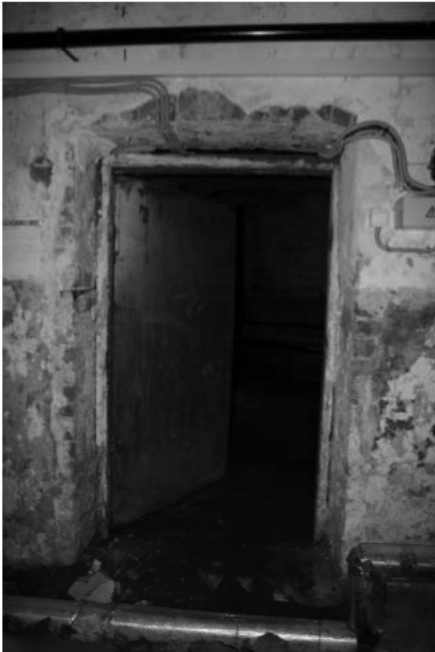
34. Фрагмент интерьера подвального помещения. Дверь прохода между подвальными помещениями
