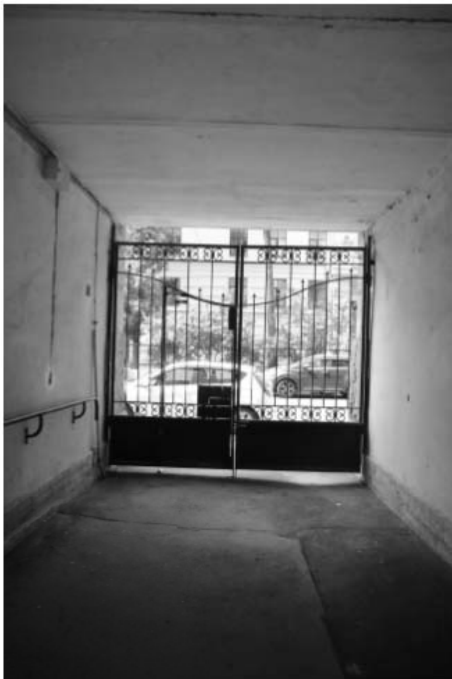
12. Фрагмент проездной арки. Вид со стороны внутреннего двора на улицу Таврическая
