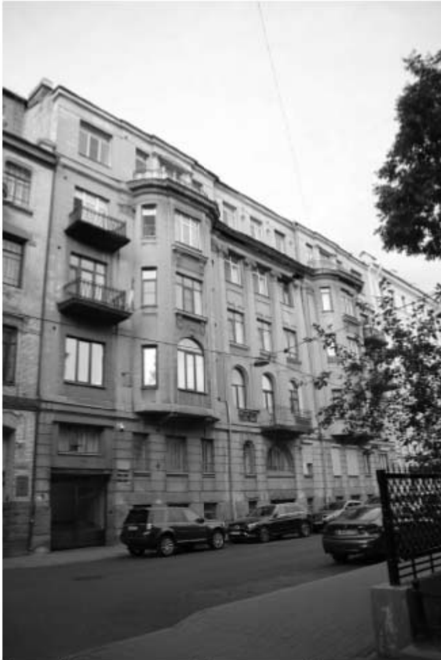
2. Главный фасад по улице Таврическая. Вид с северо-запада
