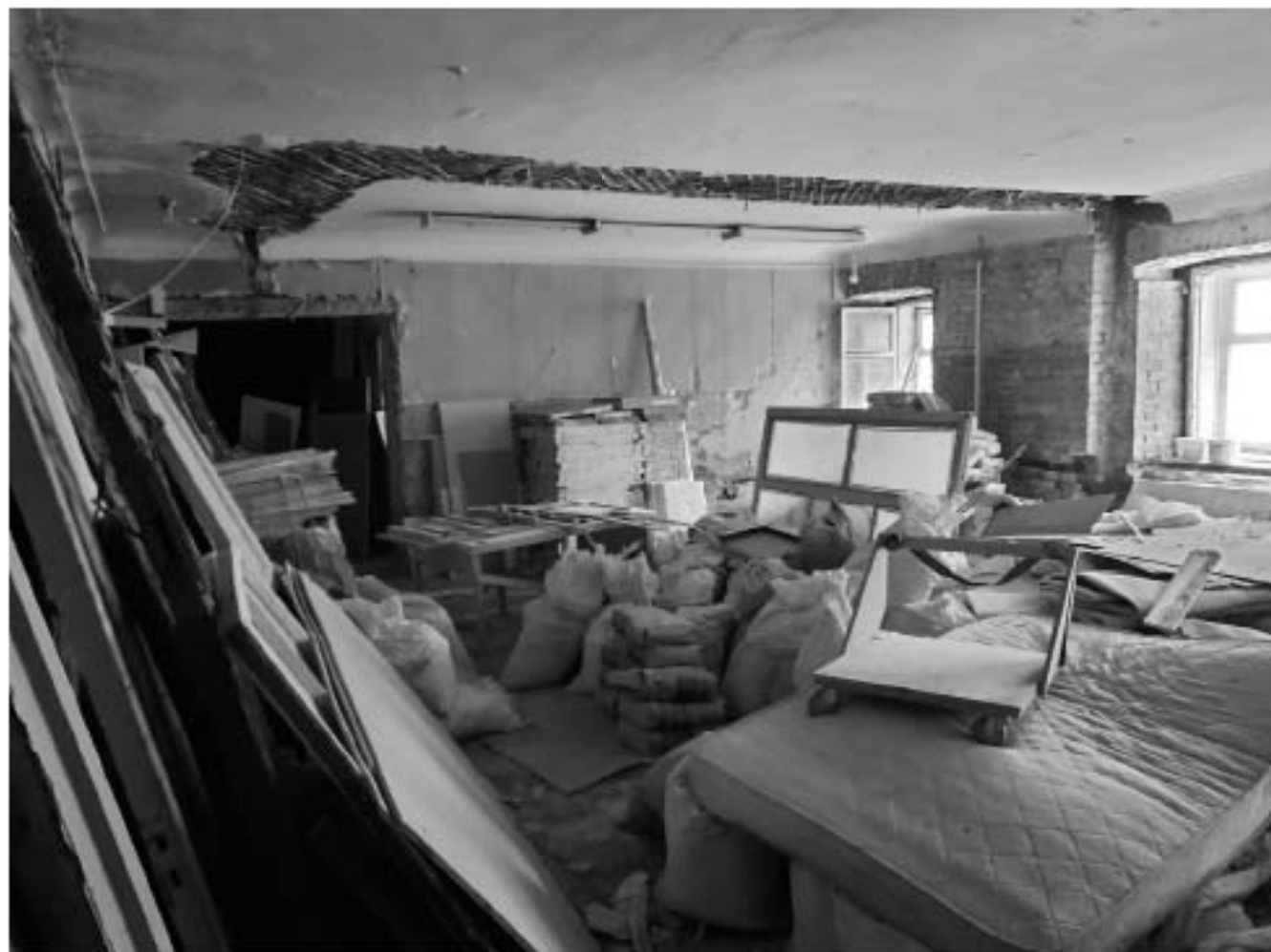
43. Фрагмент интерьера подвального помещения парадной
