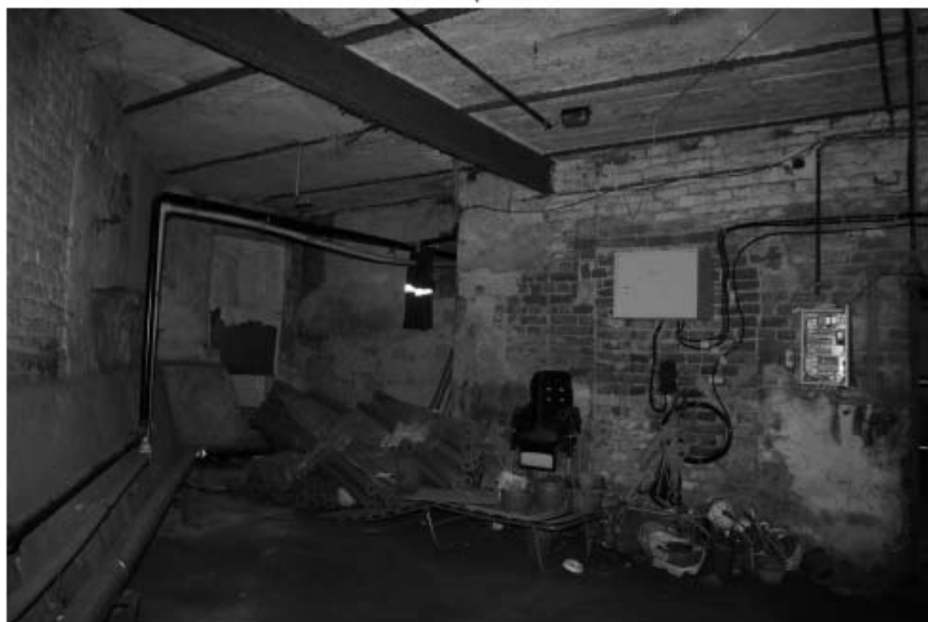
29. Фрагмент интерьера подвального помещения. Вид от входа в подвальное помещение
