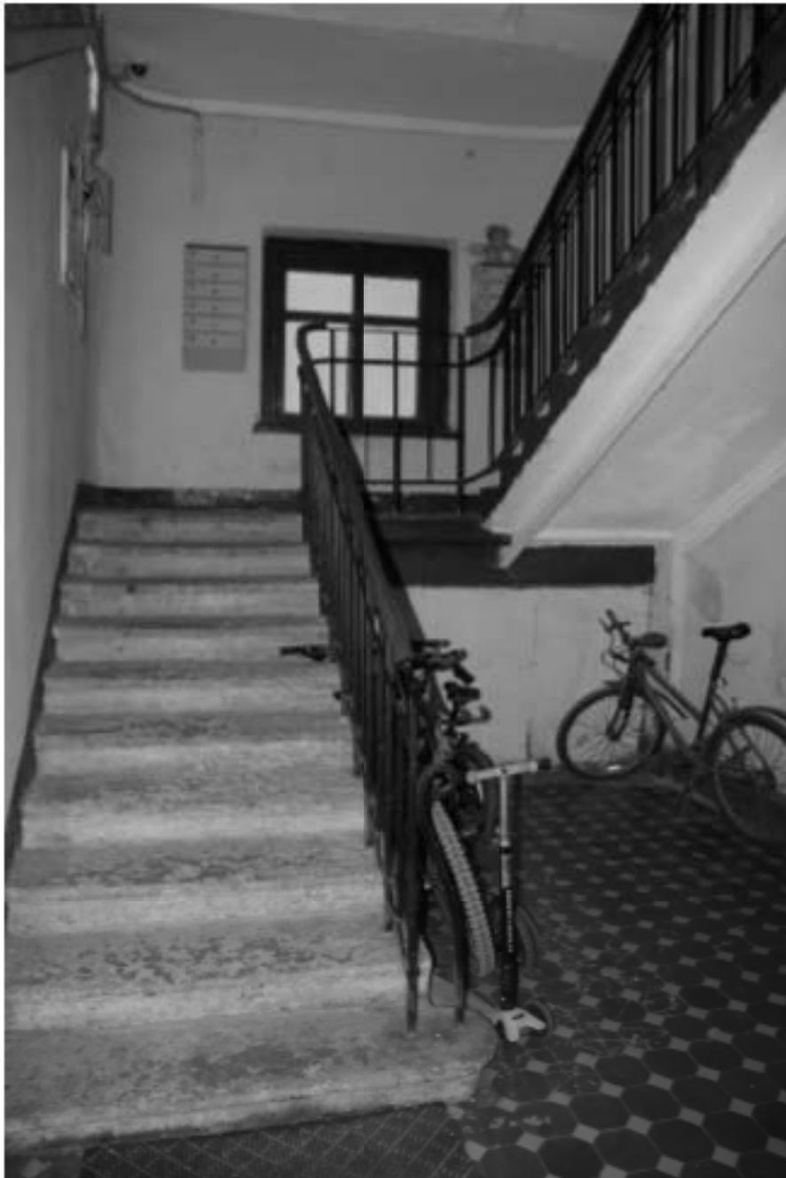
52. Фрагмент интерьера первого этажа дворовой парадной. Лестница на второй этаж. Оформление оконного проема лестничной площадки
