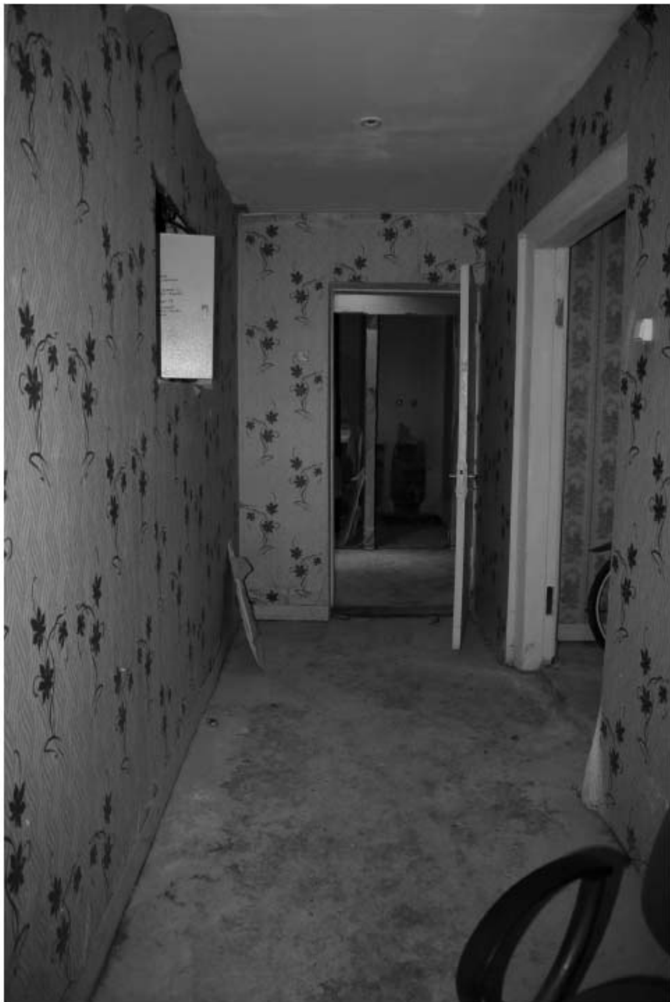
38. Интерьер подвального помещения парадной. Проходы между подвальными помещениями
