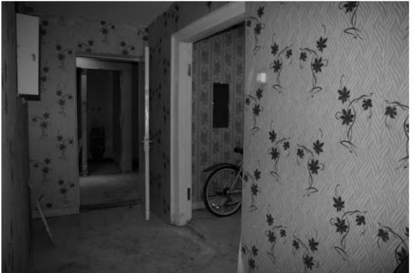
39. Интерьер подвального помещения парадной. Проходы между подвальными помещениями
