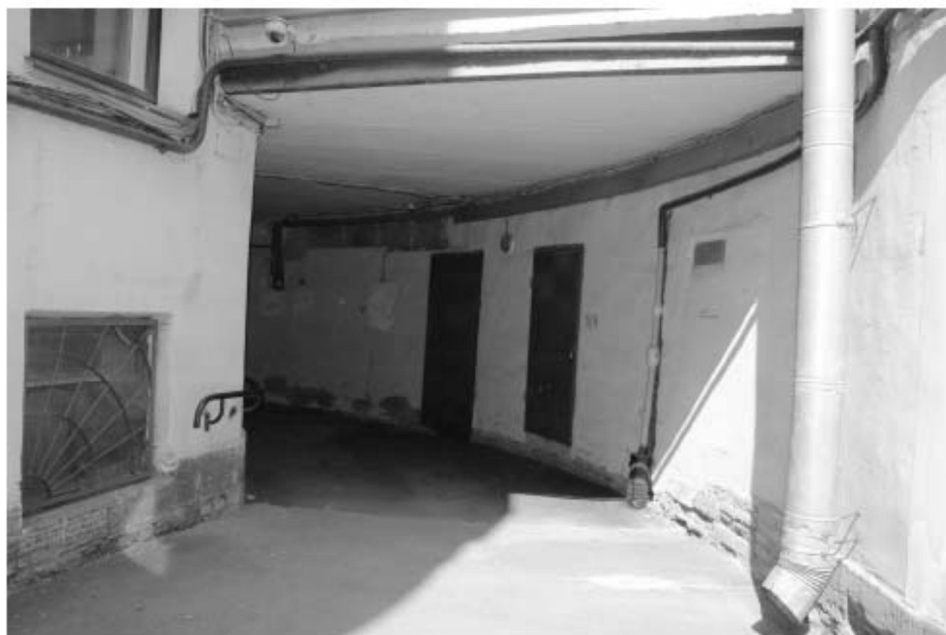
14. Фрагмент проездной арки. Дверные проемы в стене проездной арки. Вид с внутреннего двора
