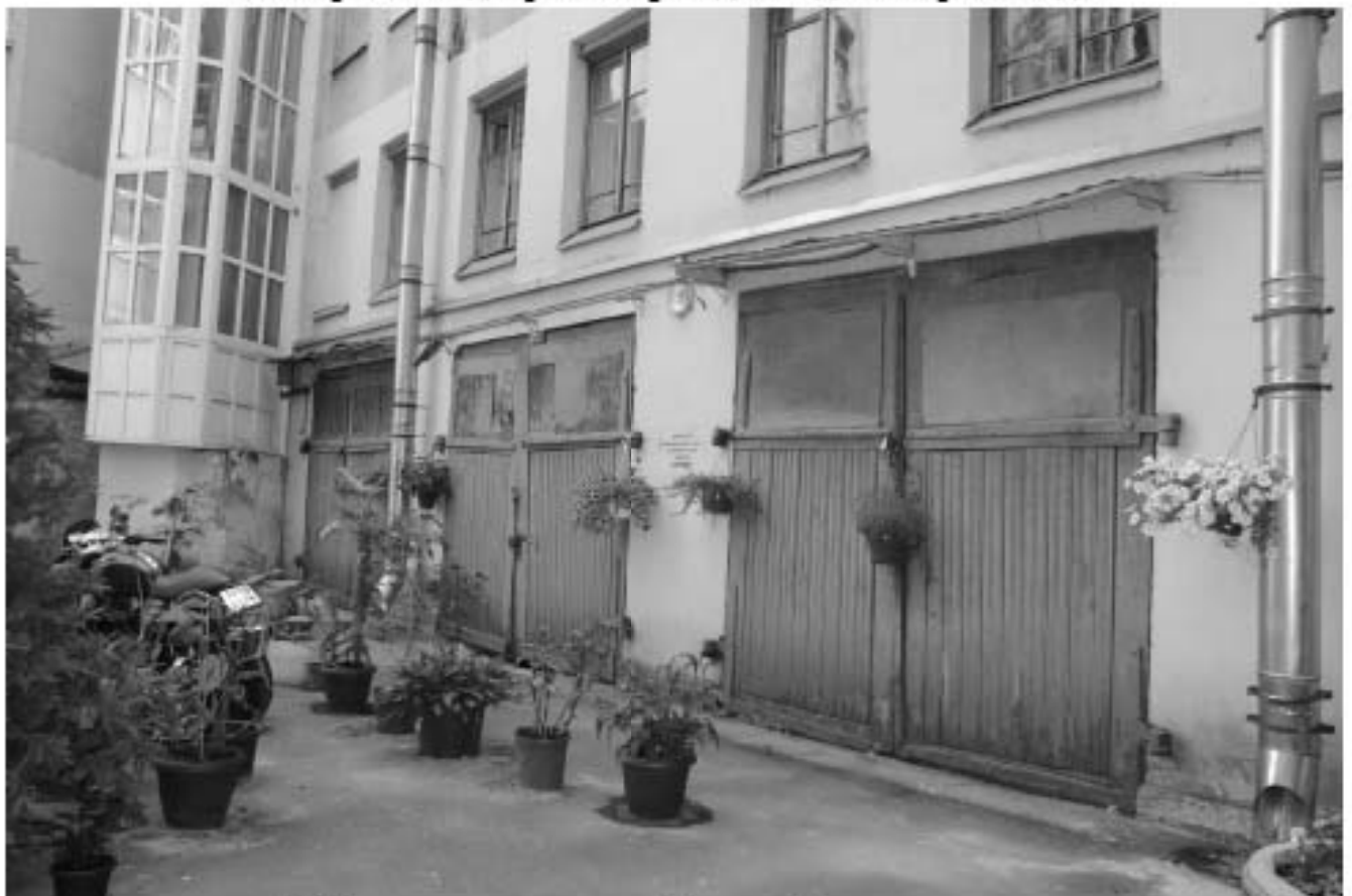
27. Фрагмент дворового фасада. Вид с юго-запада
