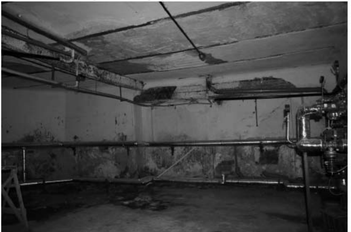
36. Фрагмент интерьера подвального помещения
