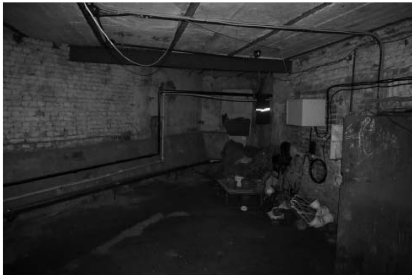
28. Фрагмент интерьера подвального помещения. Вид от входа в подвальное помещение
