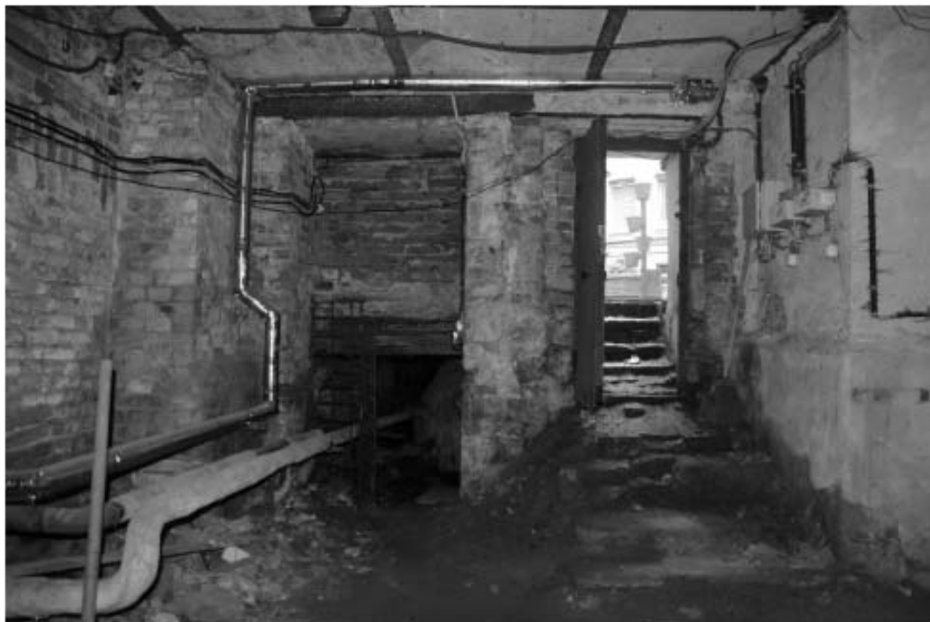
30. Фрагмент интерьера подвального помещения. Дверь входа в подвальное помещение
