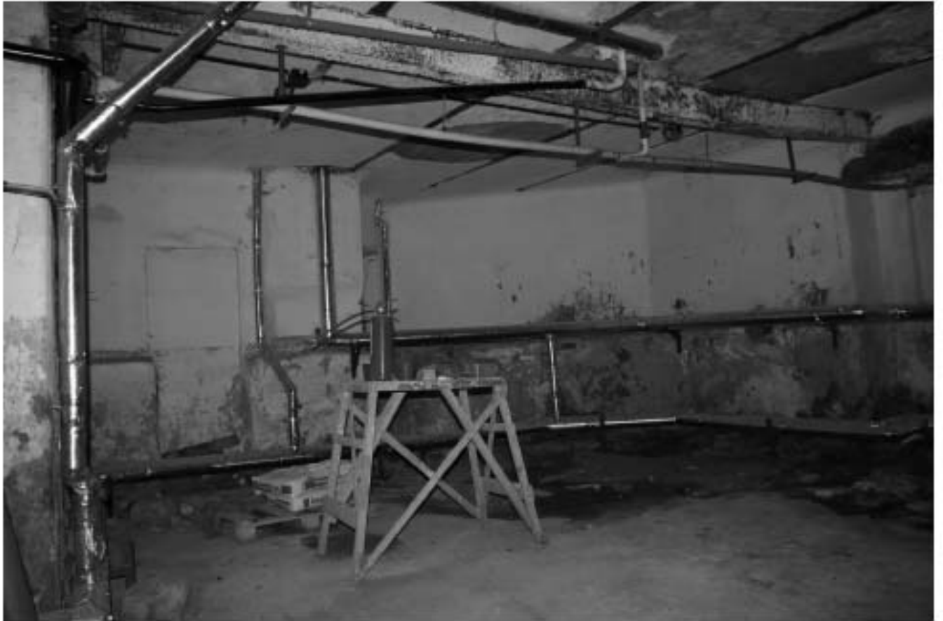
35. Фрагмент интерьера подвального помещения
