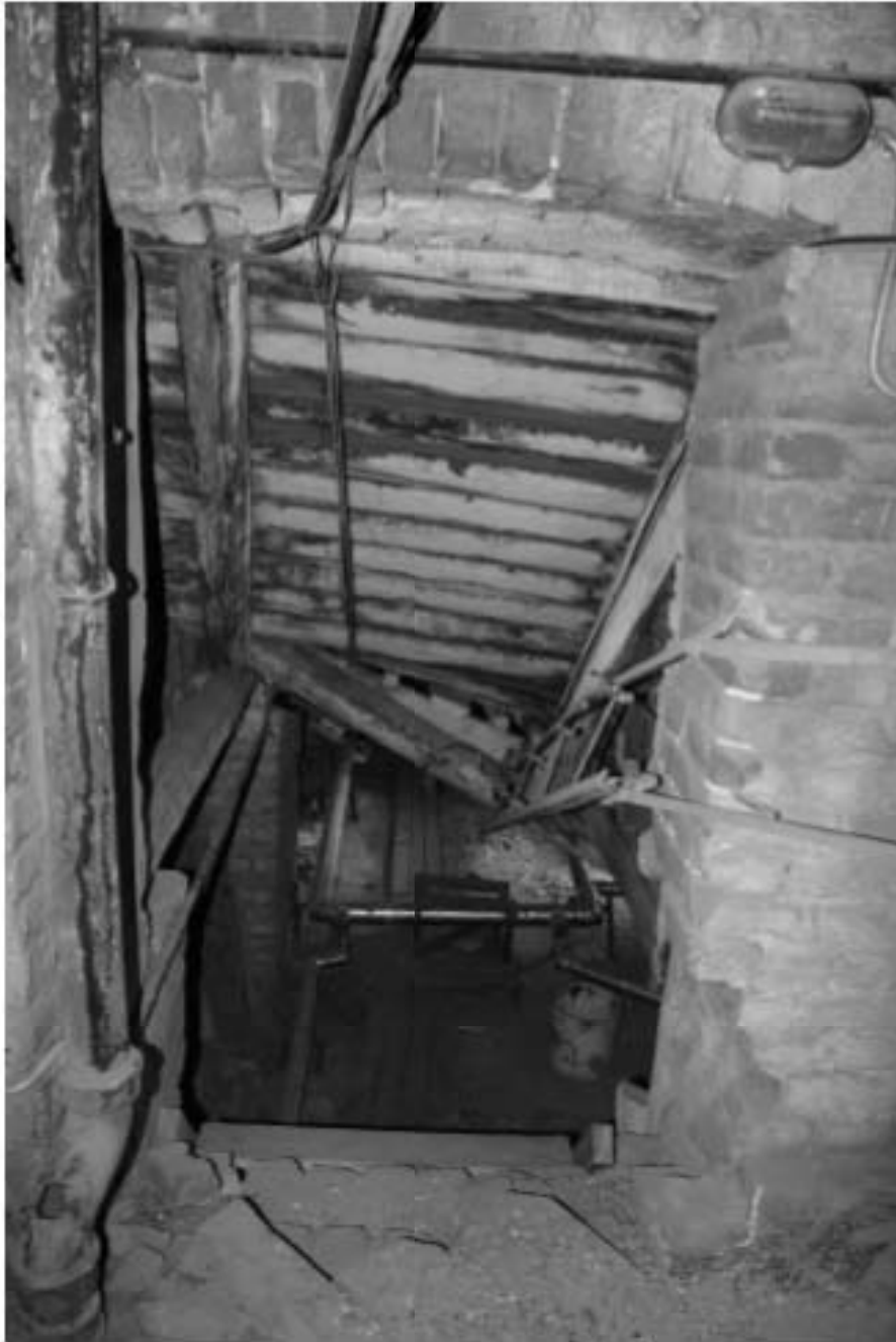
65. Фрагмент интерьера чердачного помещения. Проход между помещениями чердака
