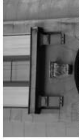
подоконный карниз на кронштейнах
