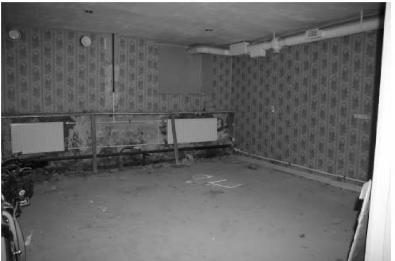
40. Фрагмент интерьера подвального помещения парадной
