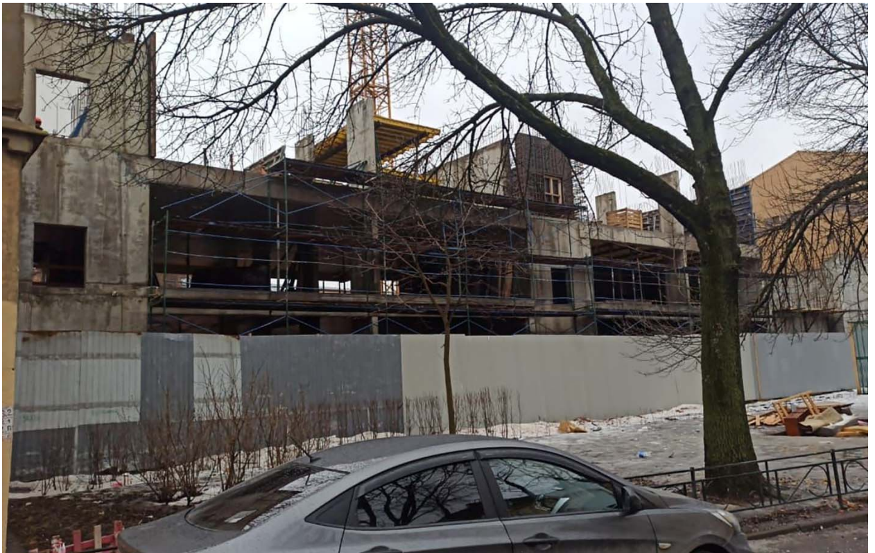
Санкт-Петербург, Васильевский остров, 15-я линия. Дом д. 84, корп.2, лит. Б. Современное состояние участка. Общий вид с северо-востока. 16.03.2021 г.
