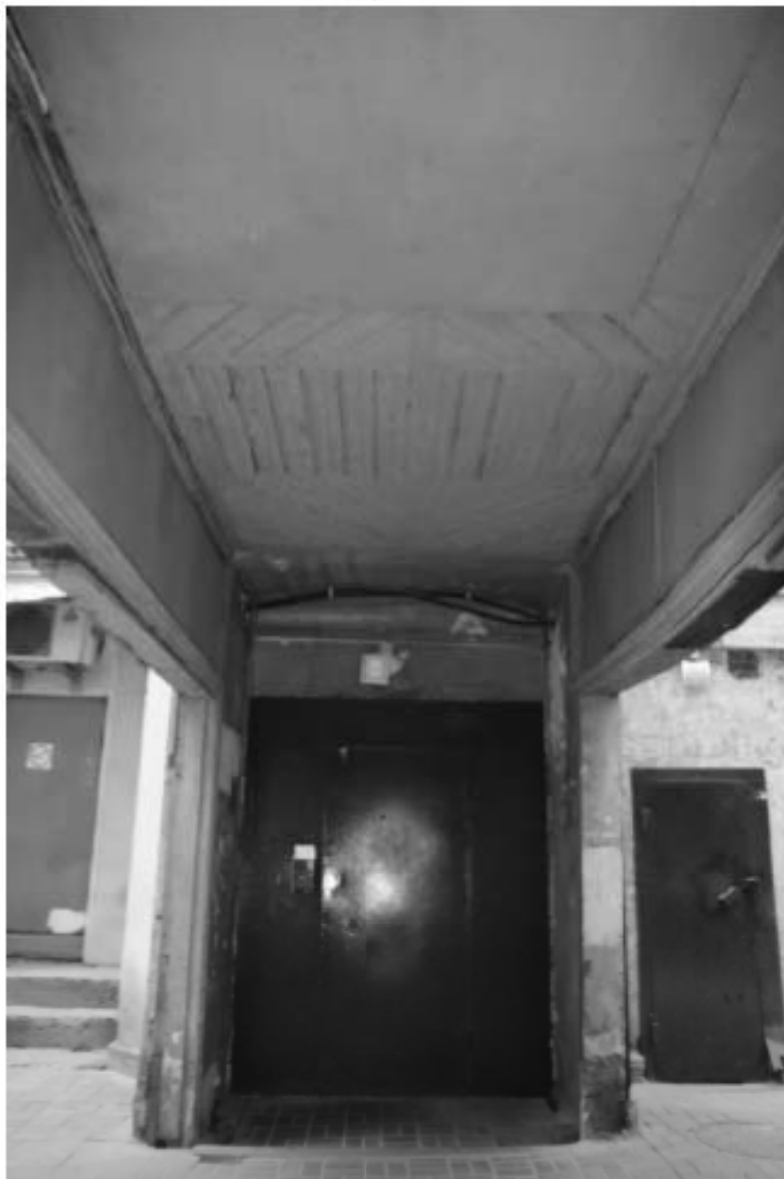
10. Фрагмент фасада внутреннего двора здания. Сторона арки, соединяющей литеру А и литеру Б, с дверью входа в парадную литеры Б. Вид с юго-востока
