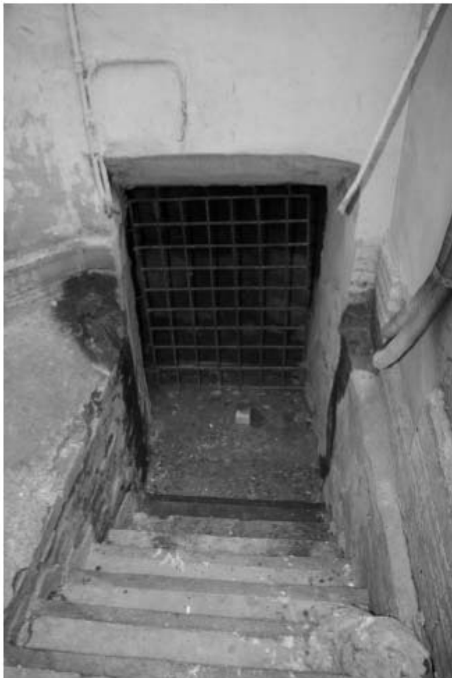
11. Вход в подвал
