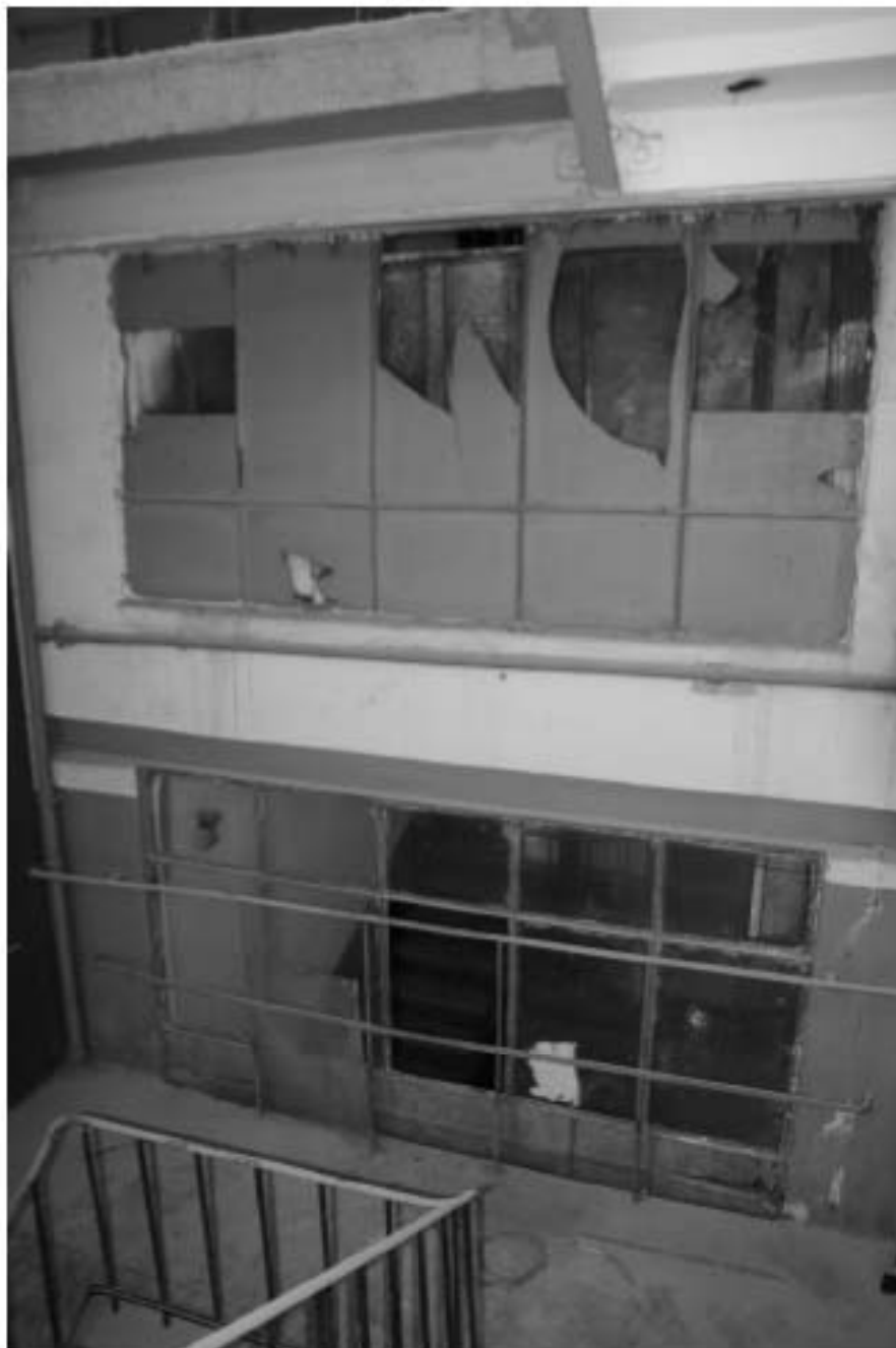
37. Перегородка между парадной и «черной» лестницами
