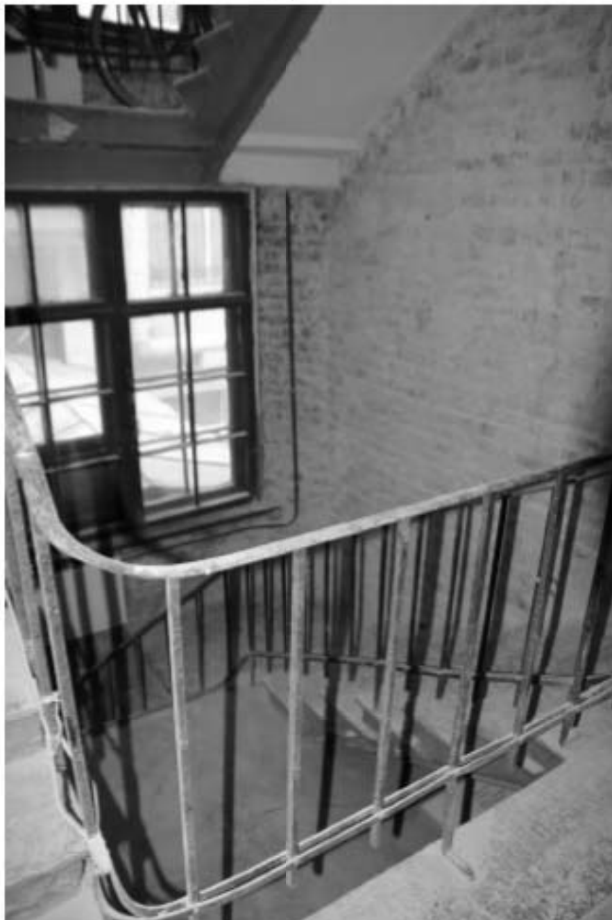
34. «Черная» лестница. Фрагмент оформления лестничного ограждения
