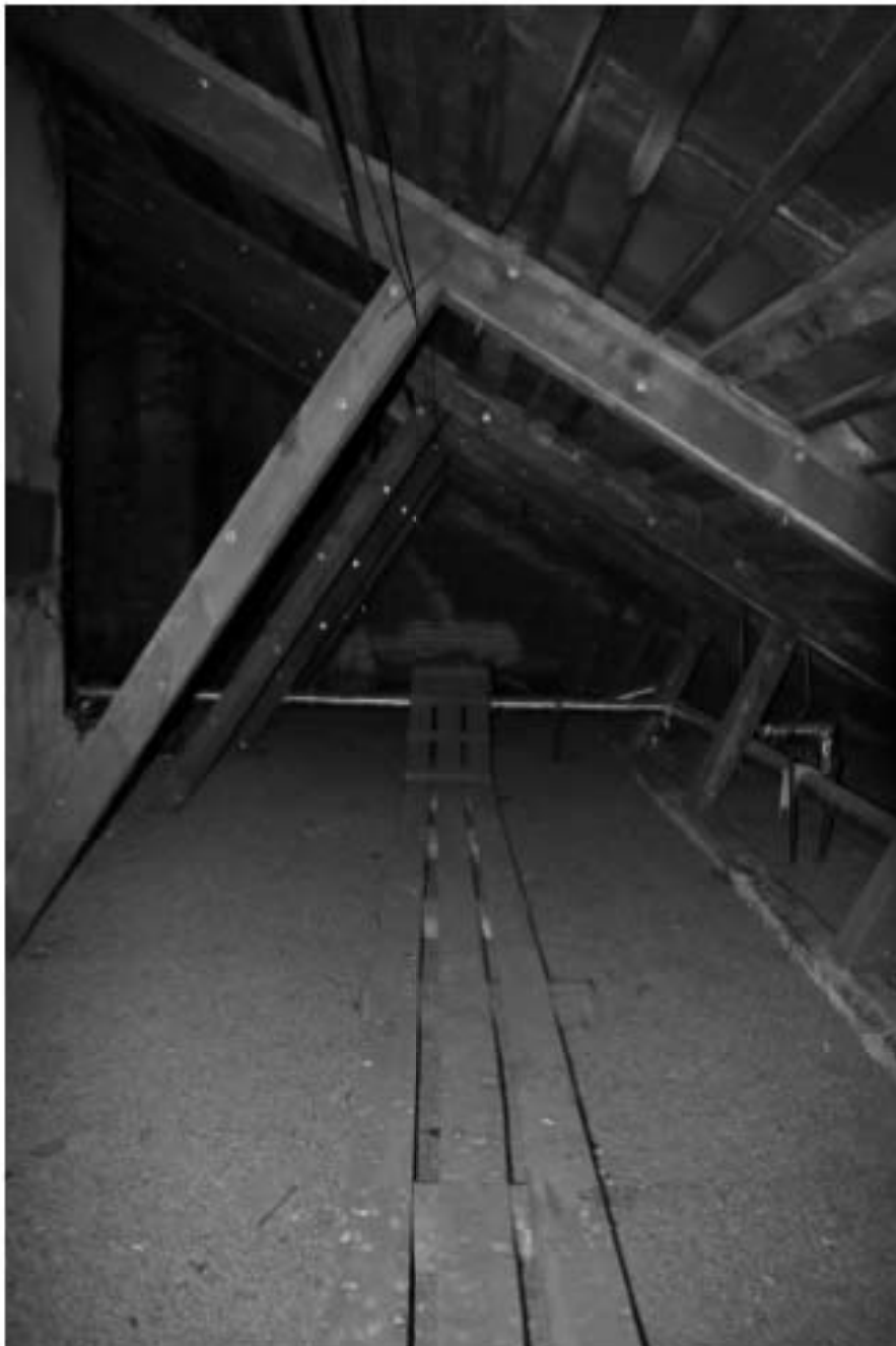
37. Фрагмент чердачного помещения
