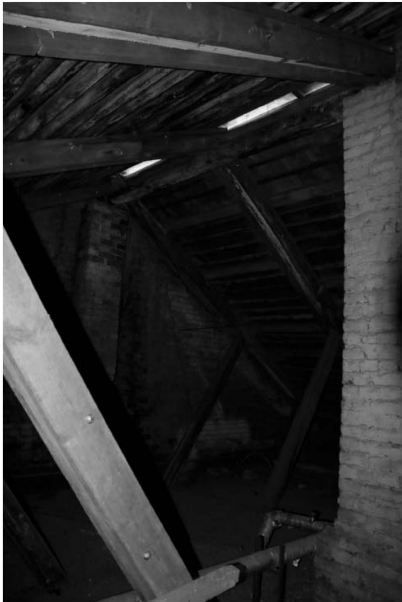
39. Фрагмент чердачного помещения
