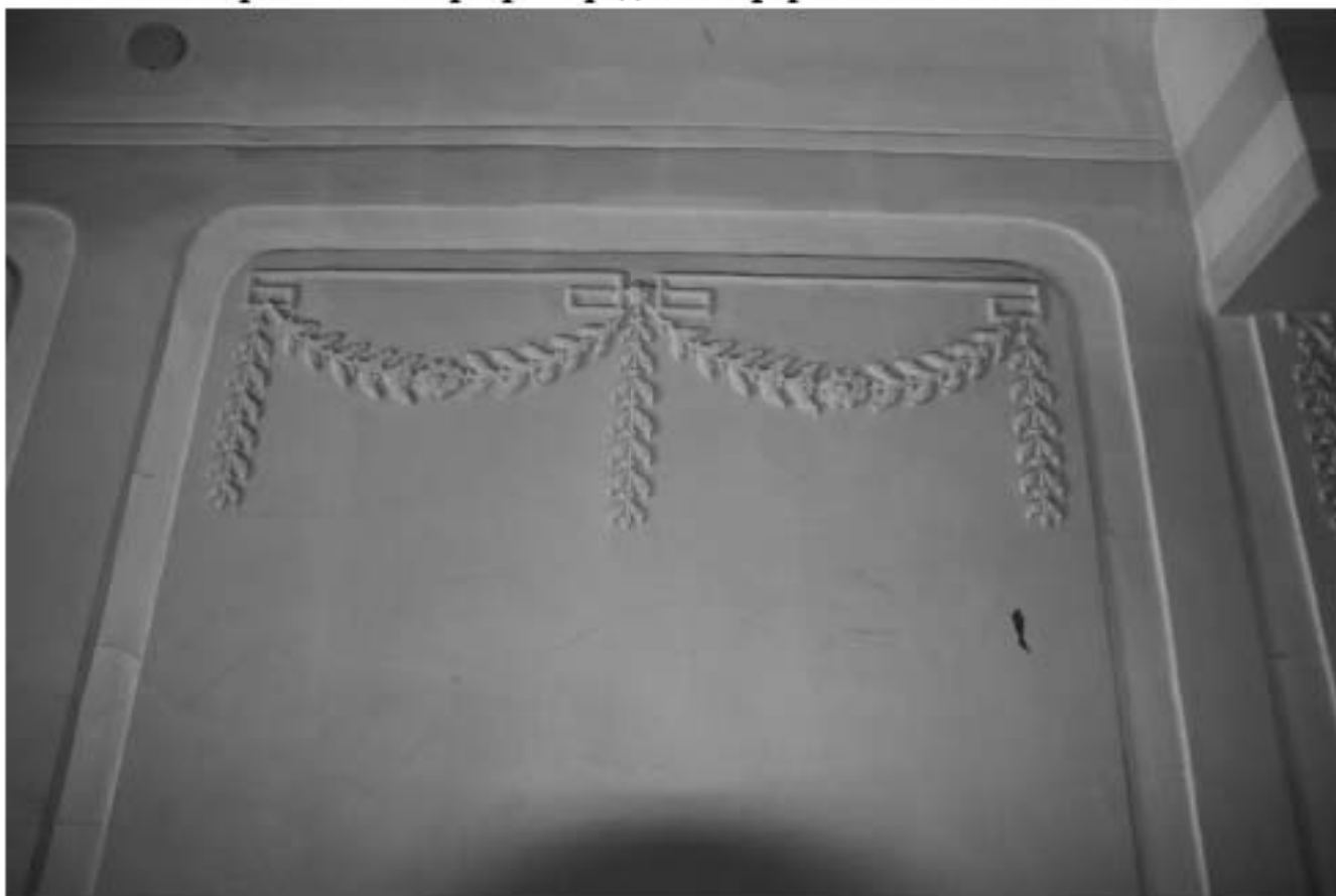
27. Фрагмент интерьера парадной. Оформление стен вестибюля
