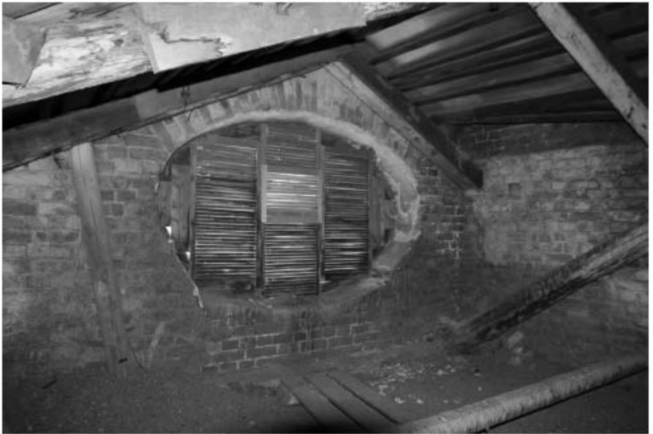
41. Фрагмент чердачного помещения
