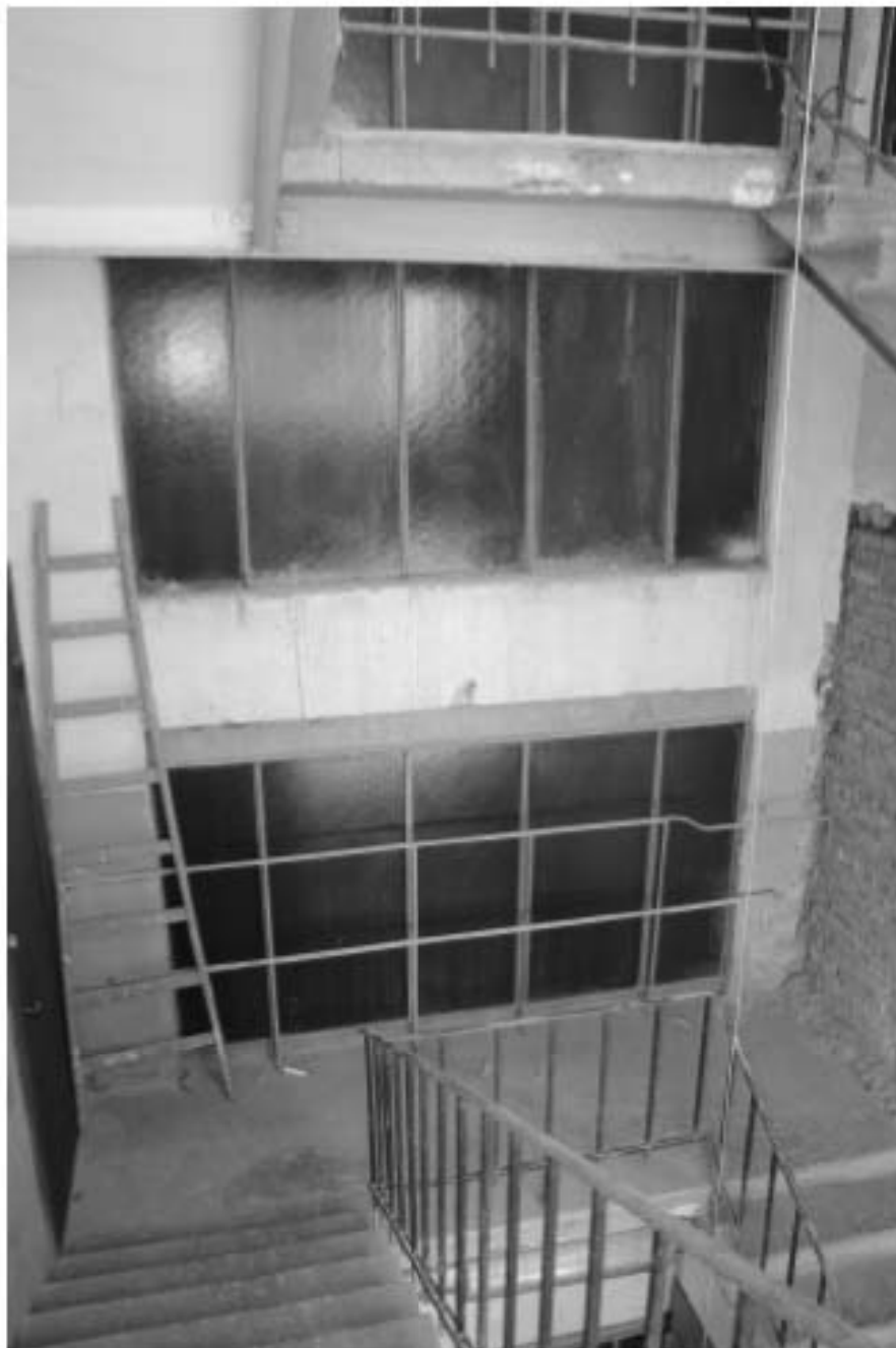
36. «Черная» лестница. Перегородка между парадной и «черной» лестницами
