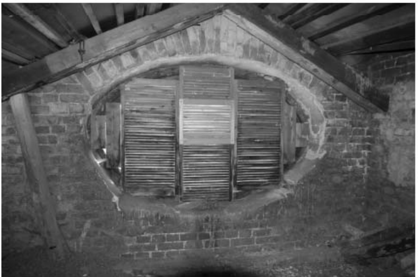
42. Фрагмент чердачного помещения
