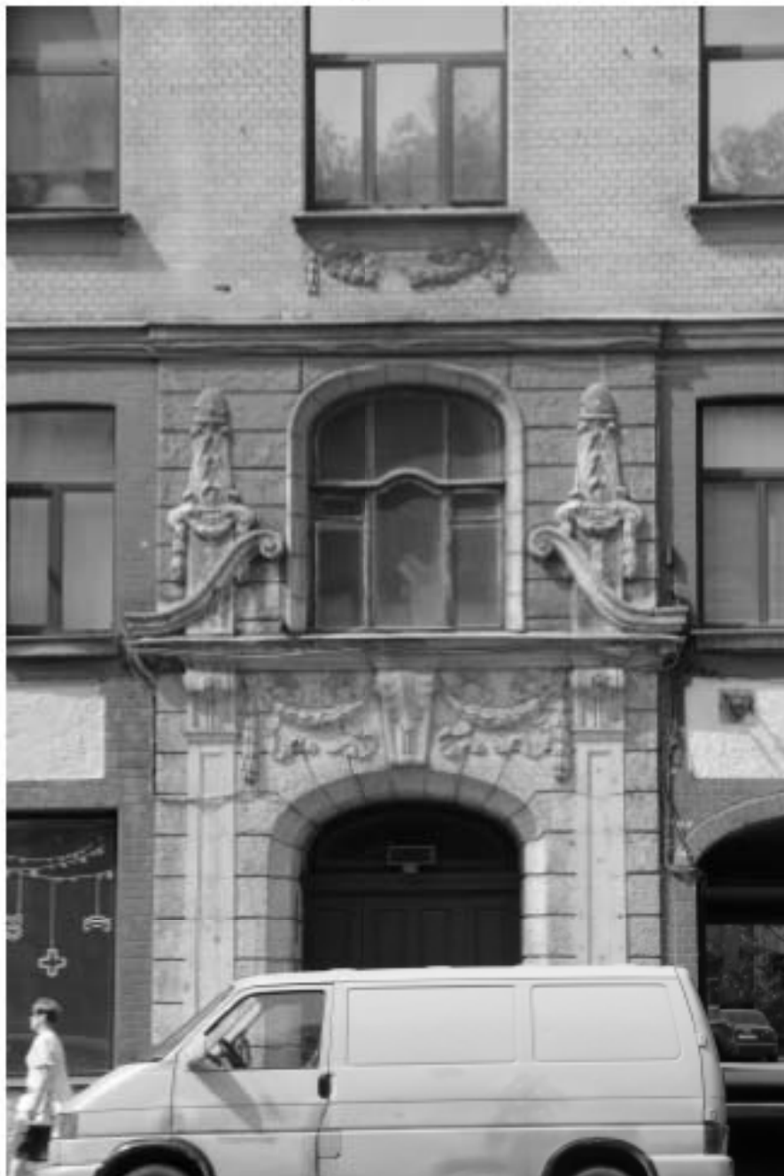
10. Фрагмент главного фасада по Суворовскому проспекту. Портал парадного входа. Вид с юго-востока
