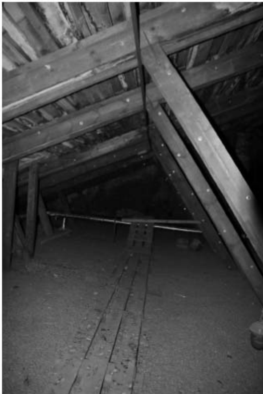
38. Фрагмент чердачного помещения
