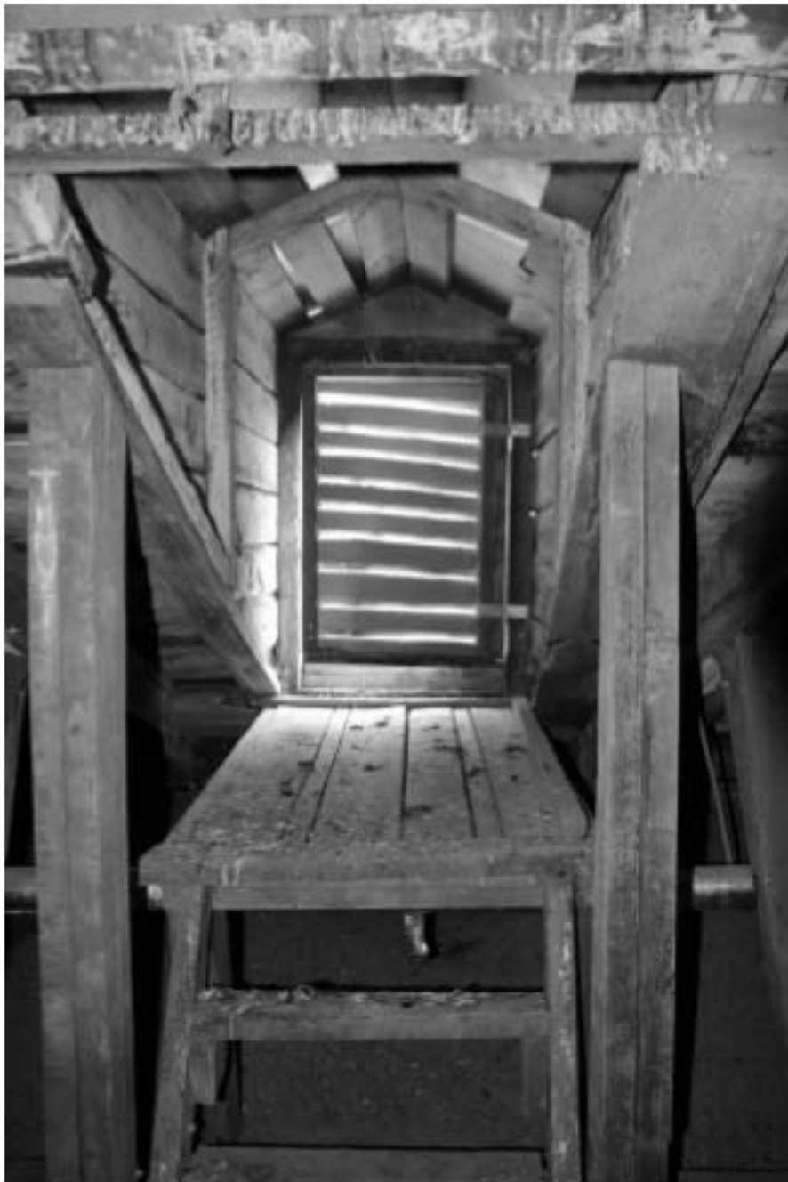
40. Фрагмент чердачного помещения. Чердачное окно
