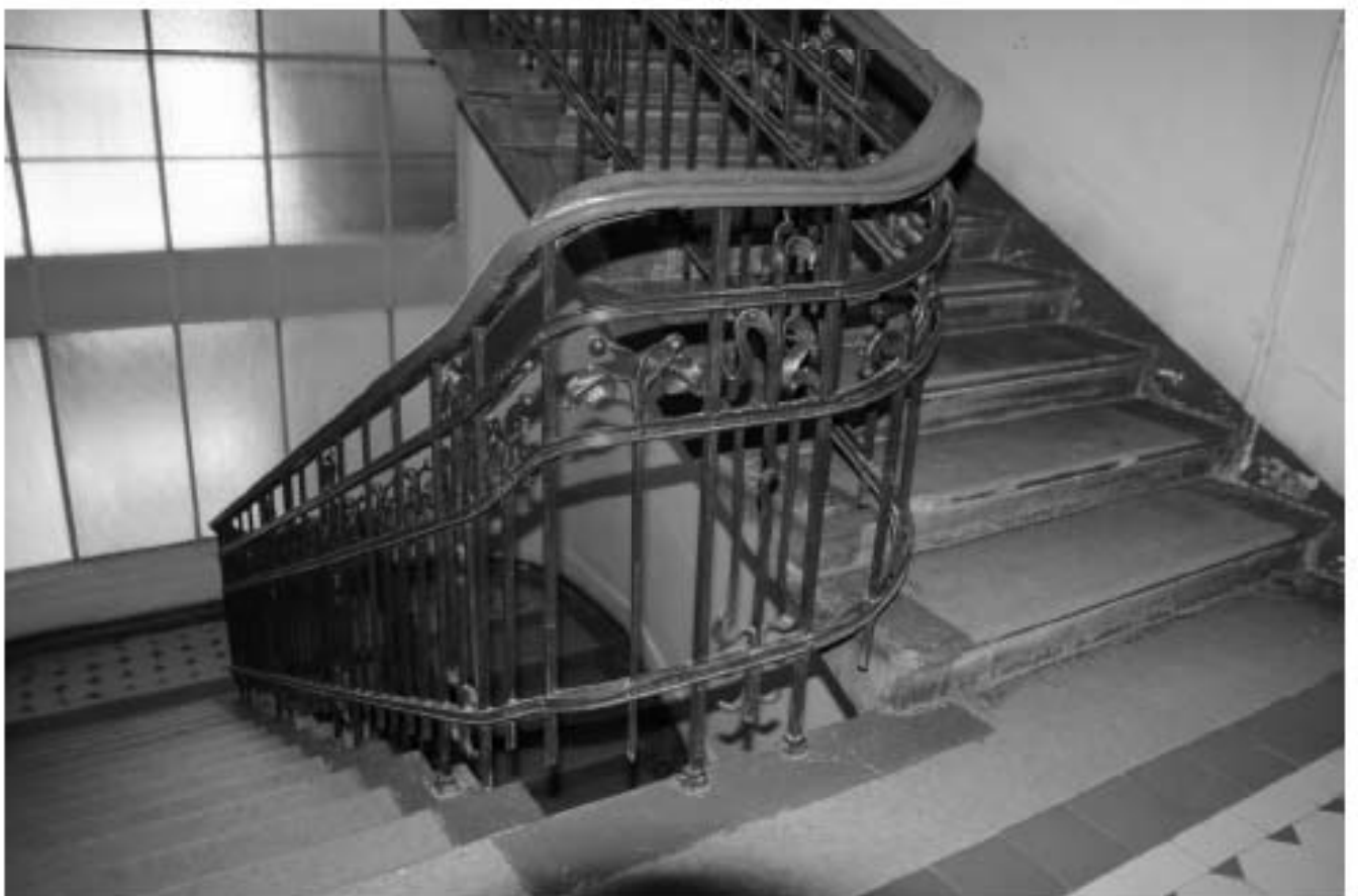
31. Фрагмент интерьера парадной. Фигурное металлическое ограждение парадной лестницы
