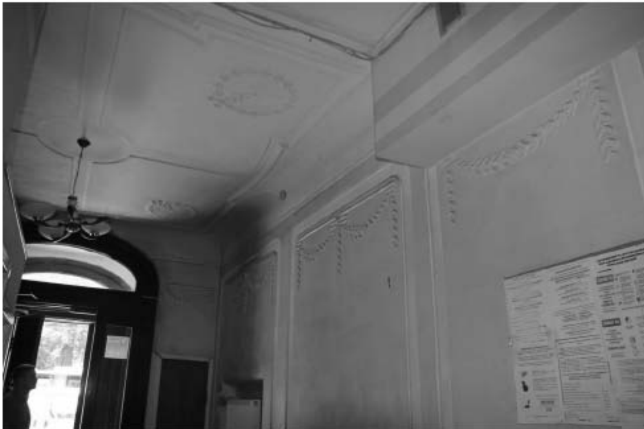
26. Фрагмент интерьера парадной. Оформление стен вестибюля
