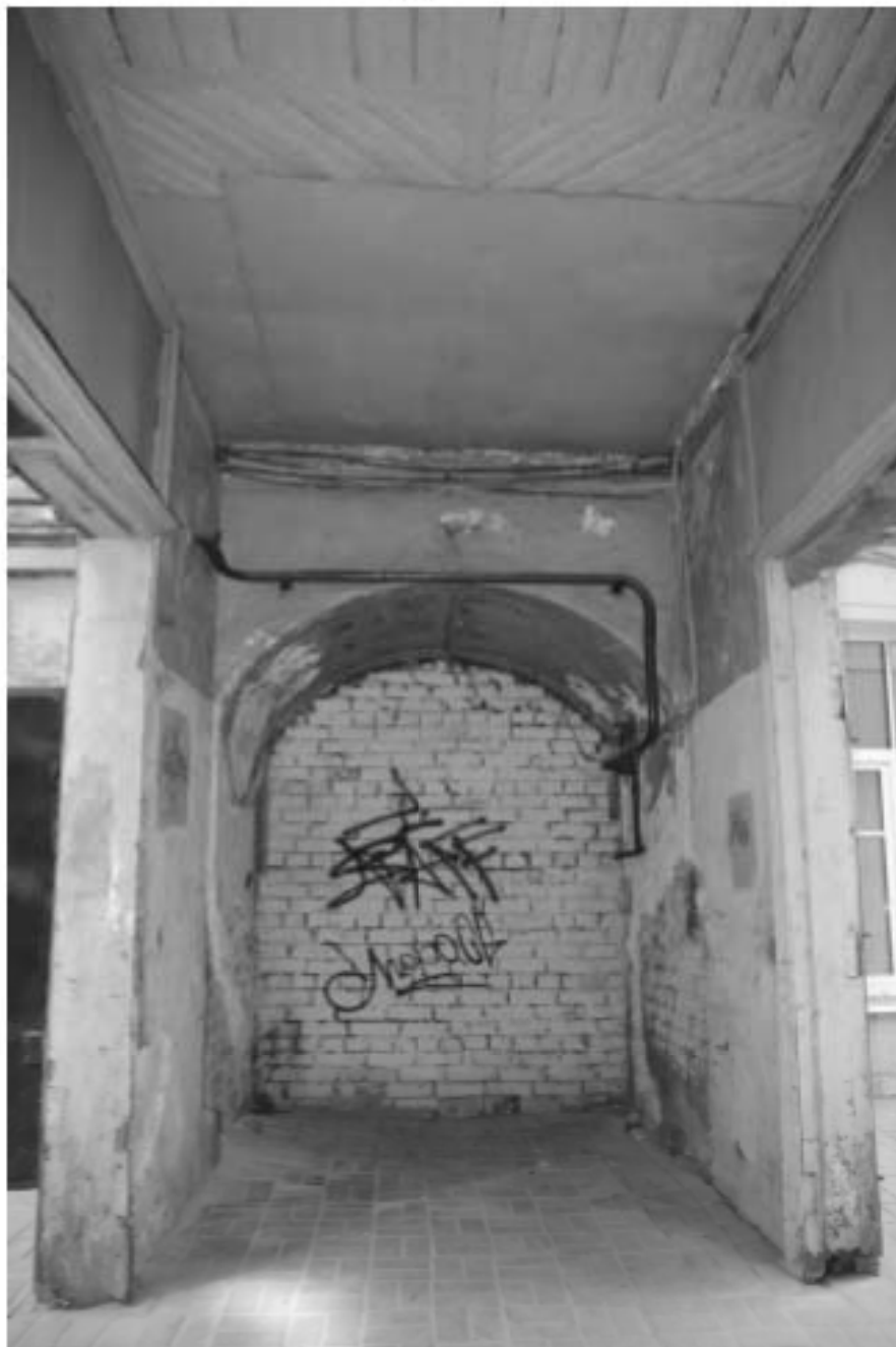
18. Фрагмент фасада внутреннего двора здания. Сторона арки, соединяющей литеру А и литеру Б, примыкающая к стене фасада литеры А. Вид с северо-запада
