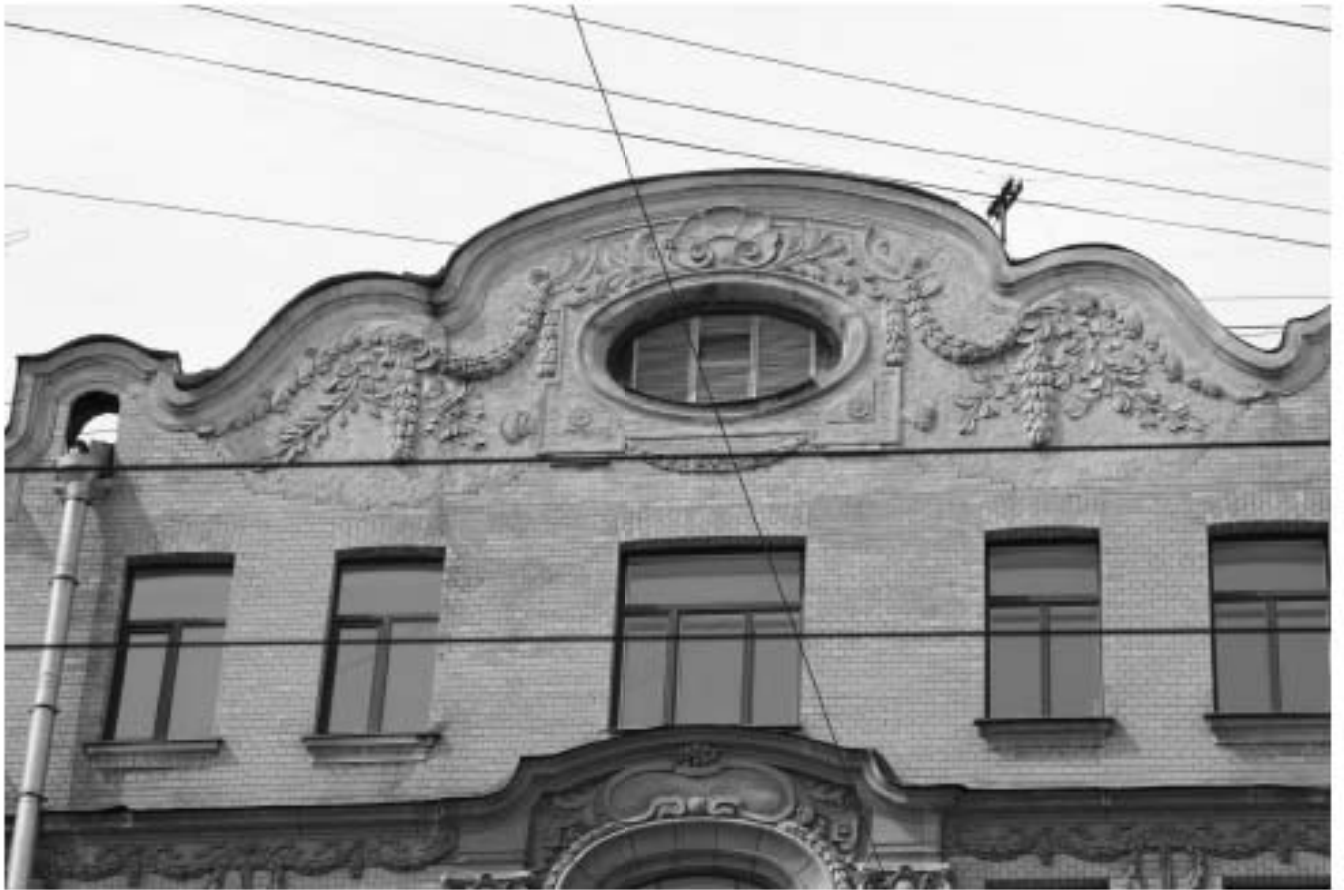
6. Фрагмент главного фасада по Суворовскому проспекту. Центральная часть аттика с окном типа «бычий глаз». Вид с юго-востока
