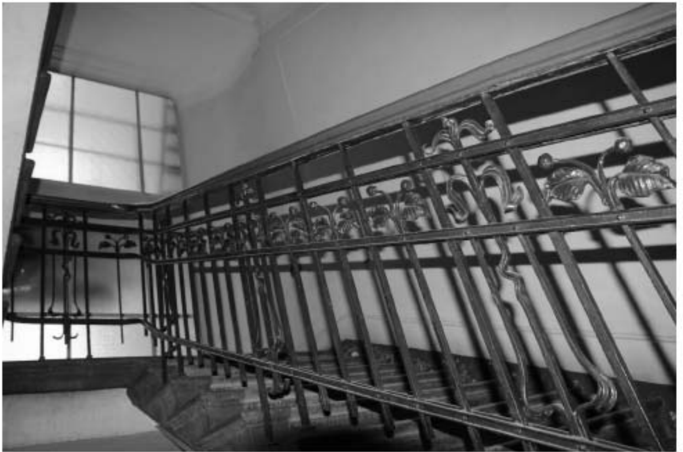
30. Фрагмент интерьера парадной. Фигурное металлическое ограждение парадной лестницы
