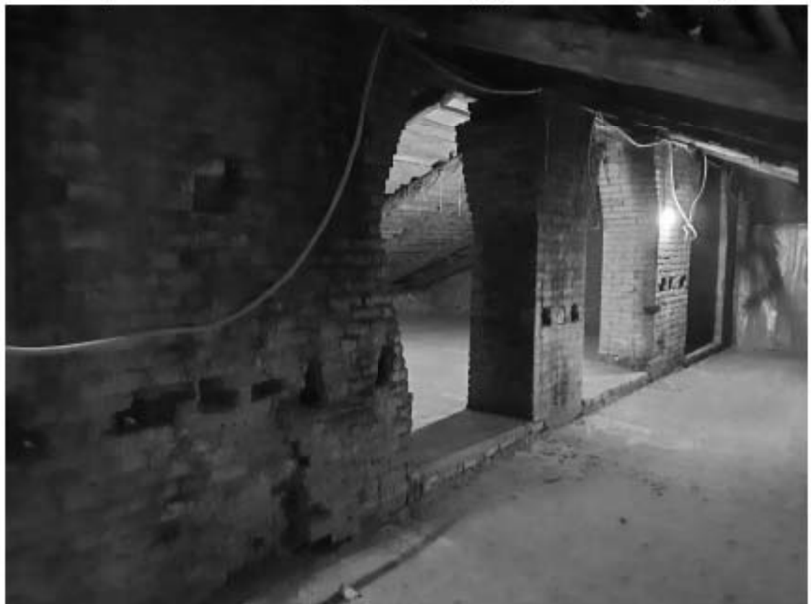
23. Фрагмент интерьера чердачного помещения
