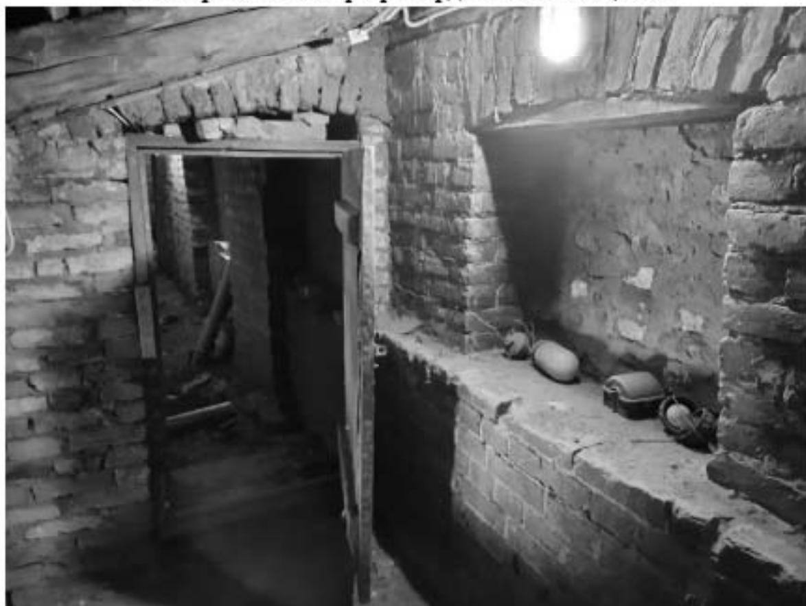
25. Фрагмент интерьера чердачного помещения
