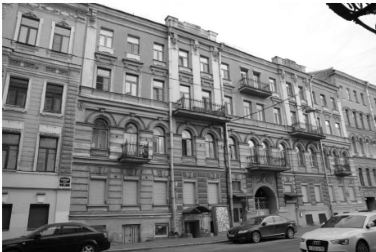
1. Общий вид главного фасада по Саперному переулку. Вид с северо-востока
