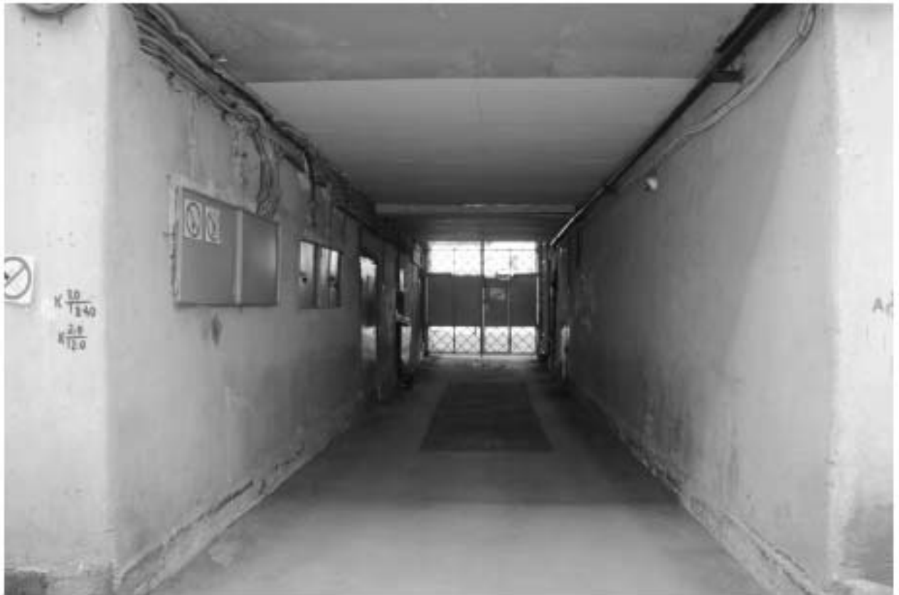
7. Проездная арка со стороны внутреннего двора. Вид с юга
