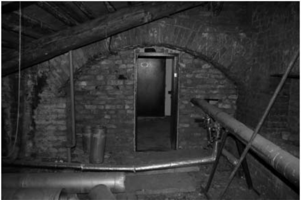
22. Чердачное помещение. Фрагмент оформления входа на чердак
