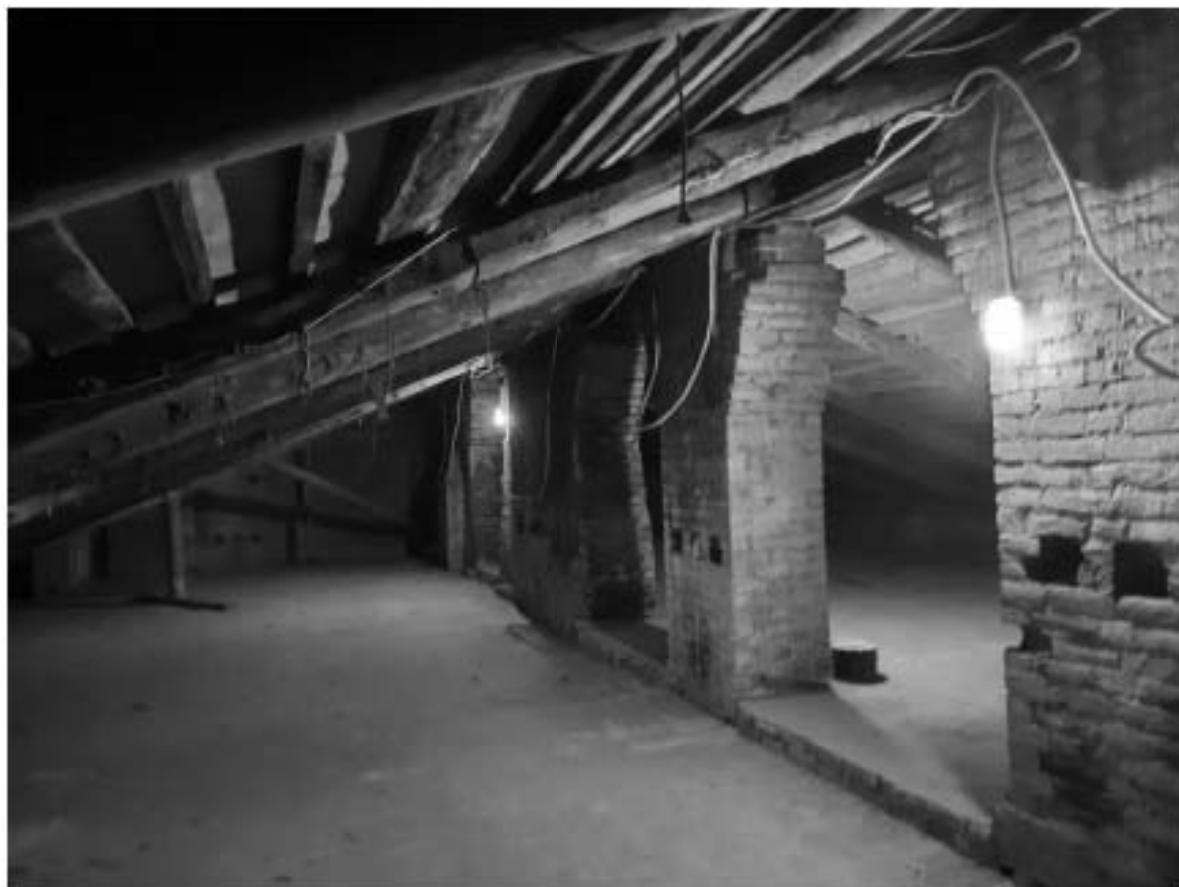
24. Фрагмент интерьера чердачного помещения
