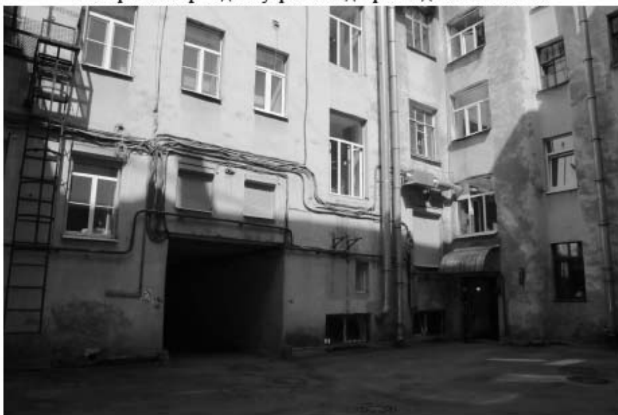
11. Фрагмент фасада внутреннего двора. Вид с юго-запада
