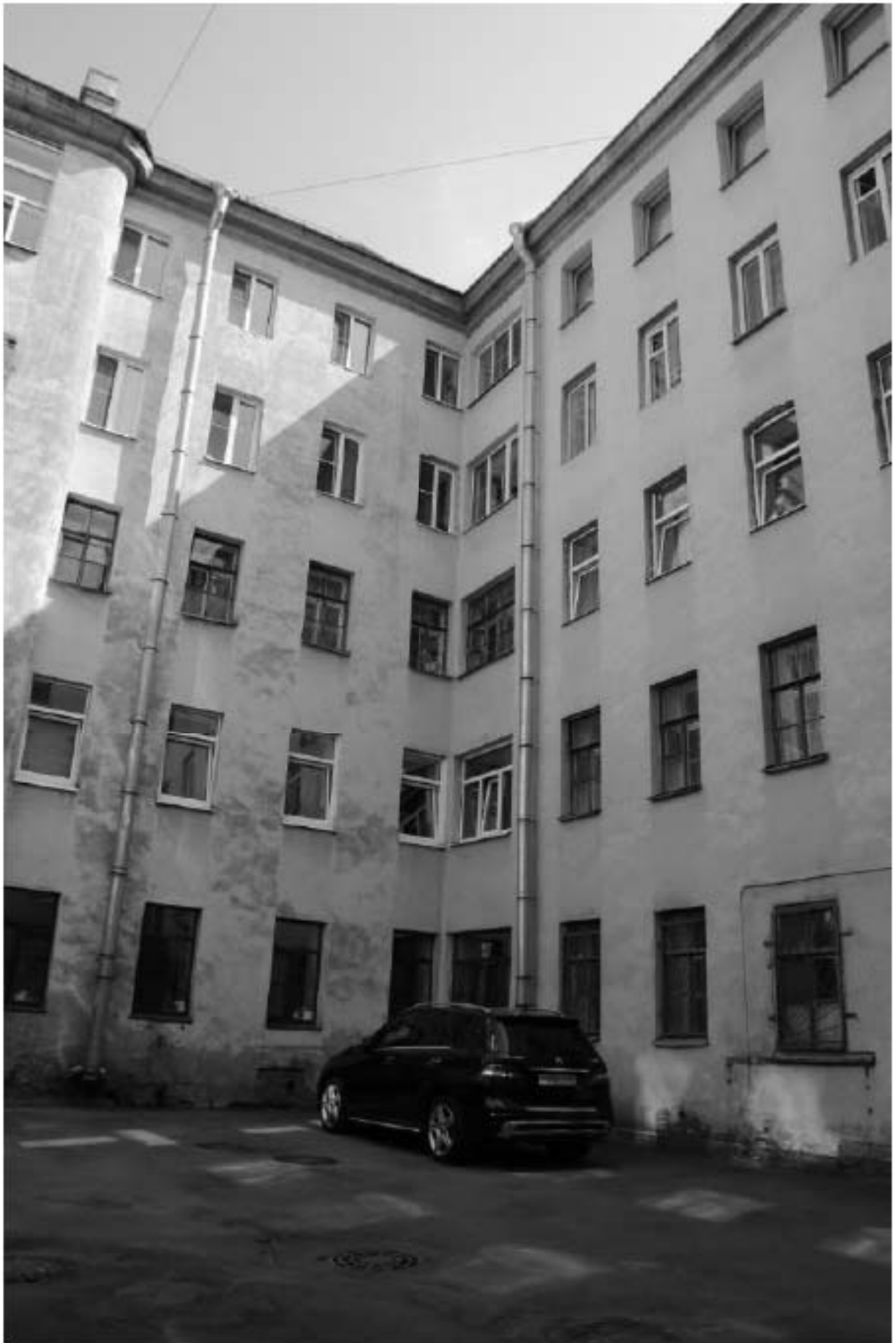
9. Фрагмент фасадов внутреннего двора. Вид с северо-запада
