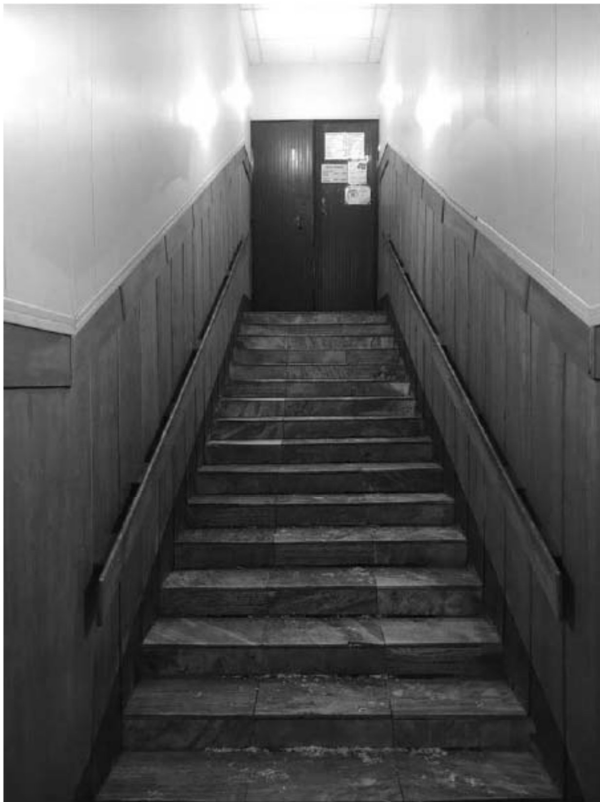
10 Парадный вестибюль (Л-2).
