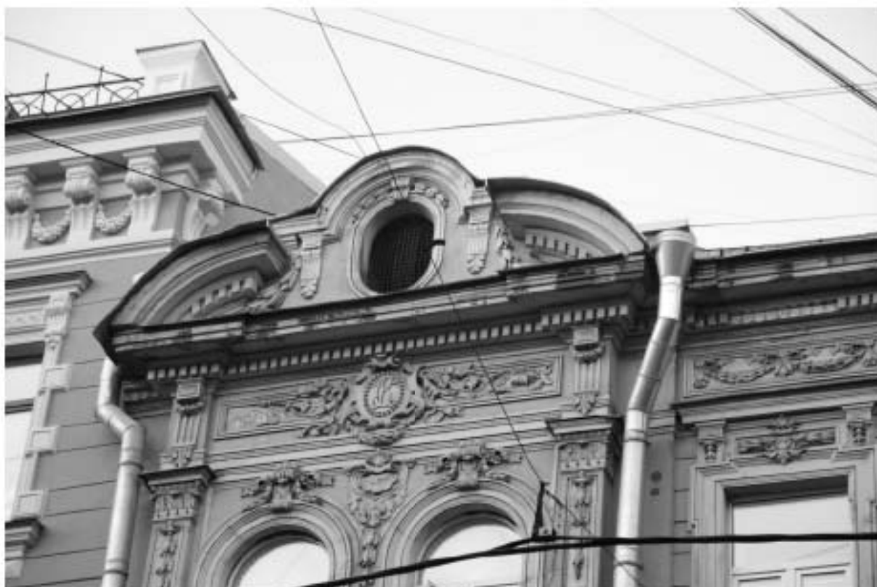
3. Фрагмент главного фасада. Вид с запада
