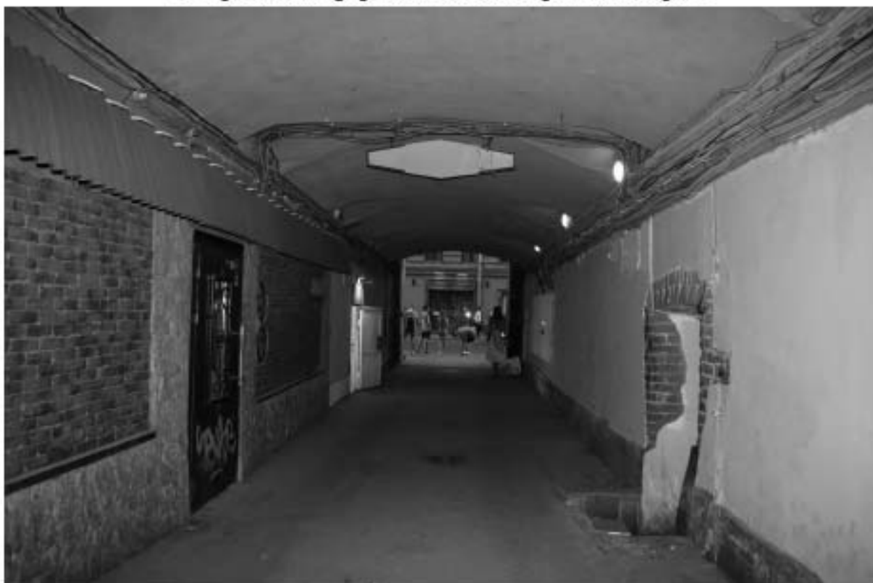
9. Проездная арка. Вид с востока
