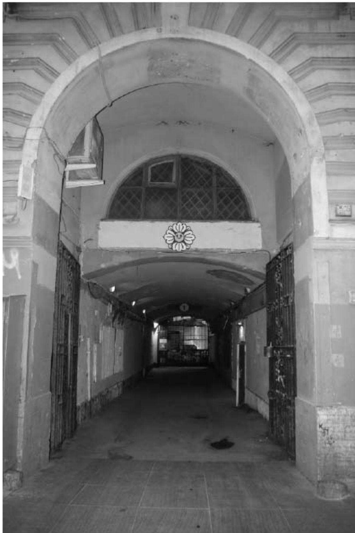
7. Проездная арка. Оформление оконного проема над сводом. Вид с запада
