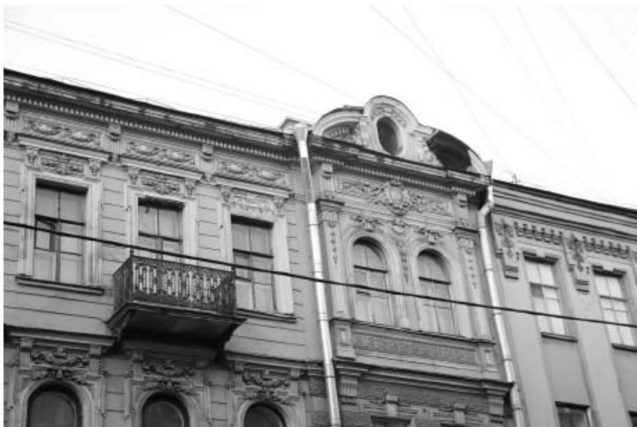
5. Фрагмент главного фасада. Вид с северо-запада
