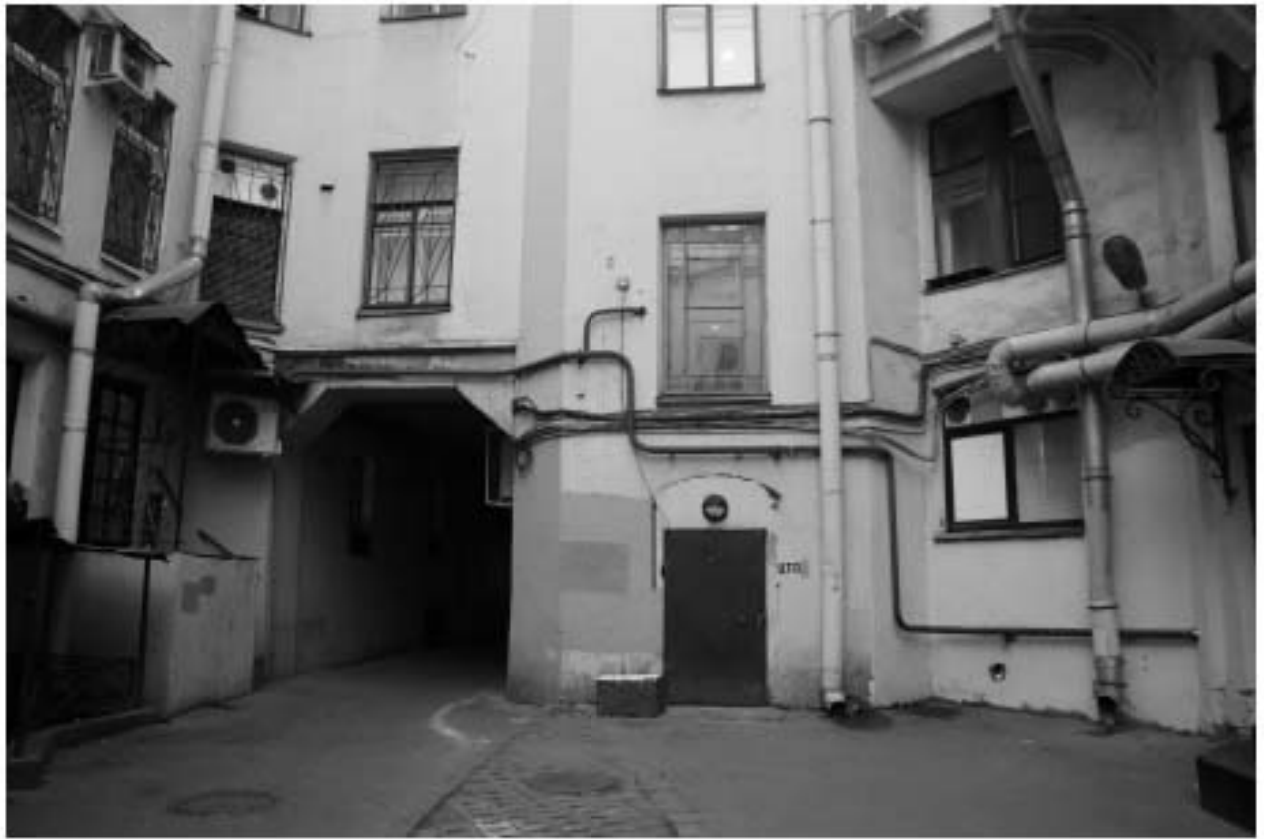
8. Фрагмент фасада внутреннего двора. Проездная арка
