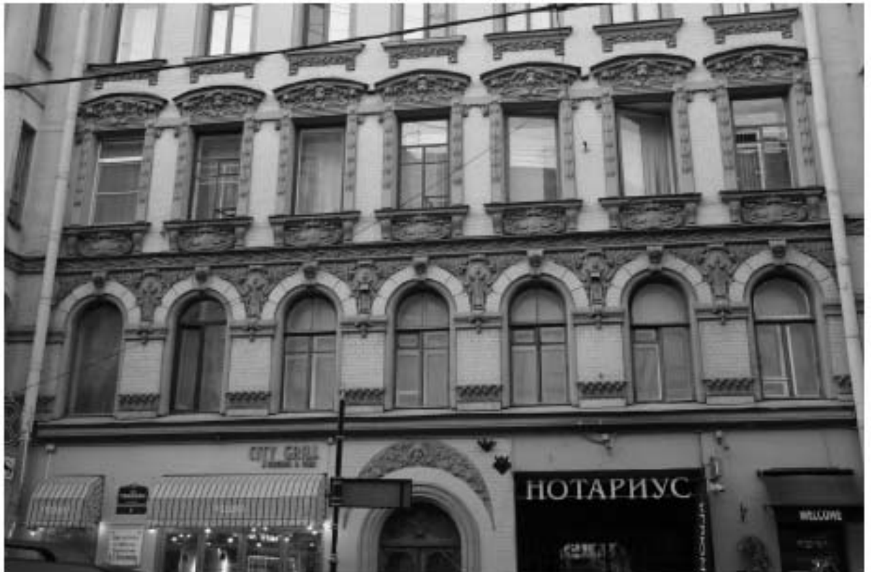
2. Фрагмент главного фасада. Оформление оконных проемов второго и третьего этажа
