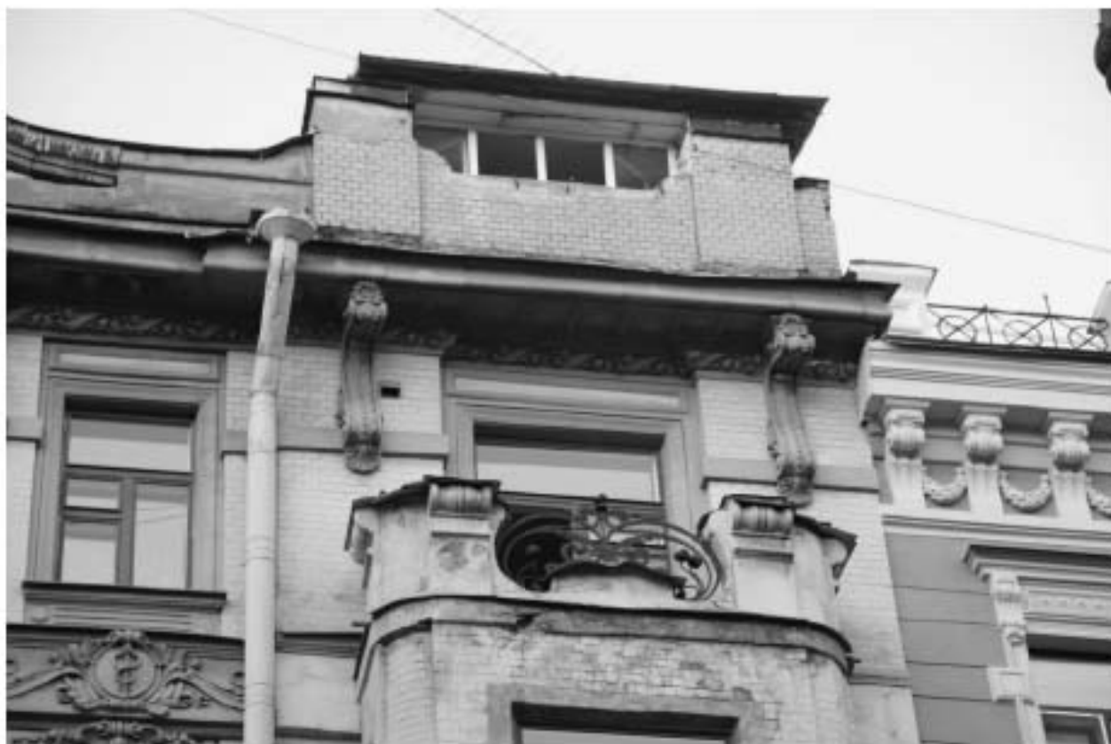
4. Фрагмент главного фасада. Вид с запада
