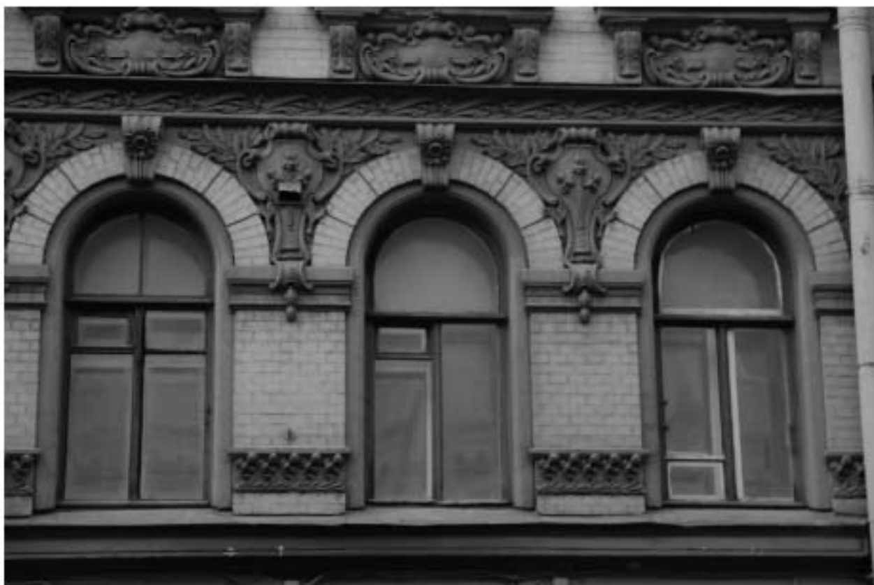
6. Фрагмент главного фасада. Оформление окон второго этажа
