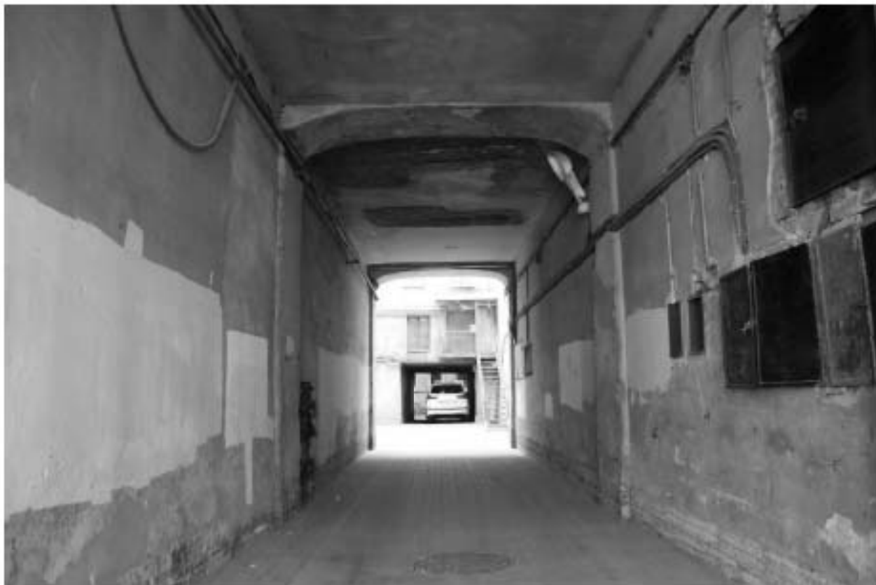
5. Проездная арка во внутренний двор с Виленского переуллка. Вид с севера
