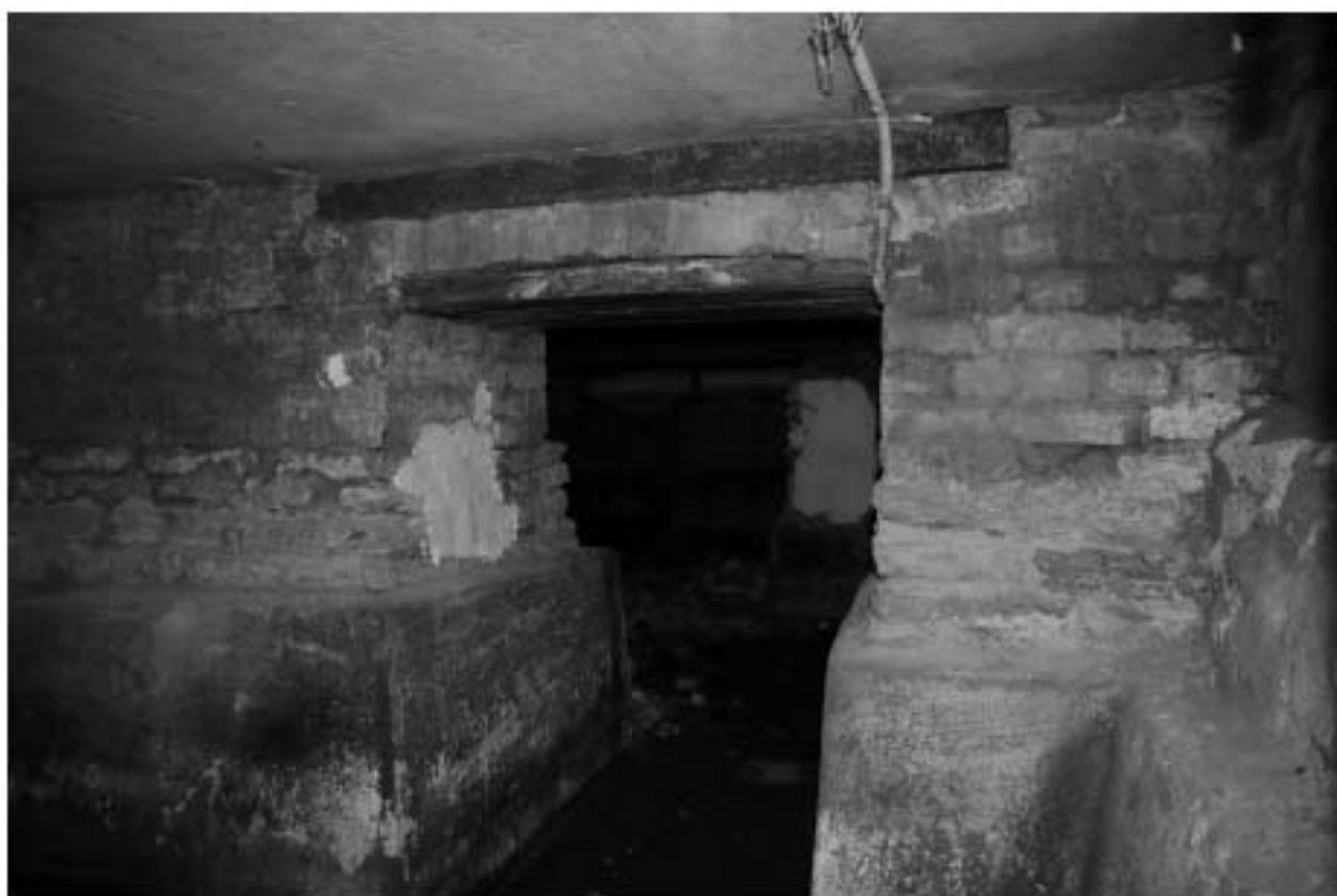
17. Фрагмент интерьера подвального помещения
