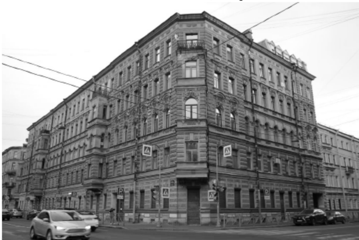
1. Общий вид здания с северо-востока
