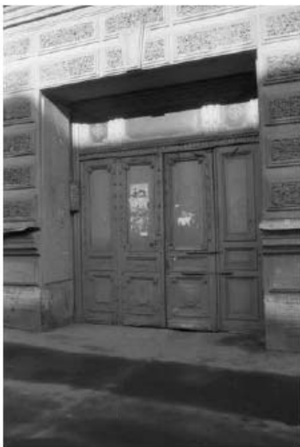
37. 1999 г. Двери парадного входа в здание. Источник – www.pastvu.com .
