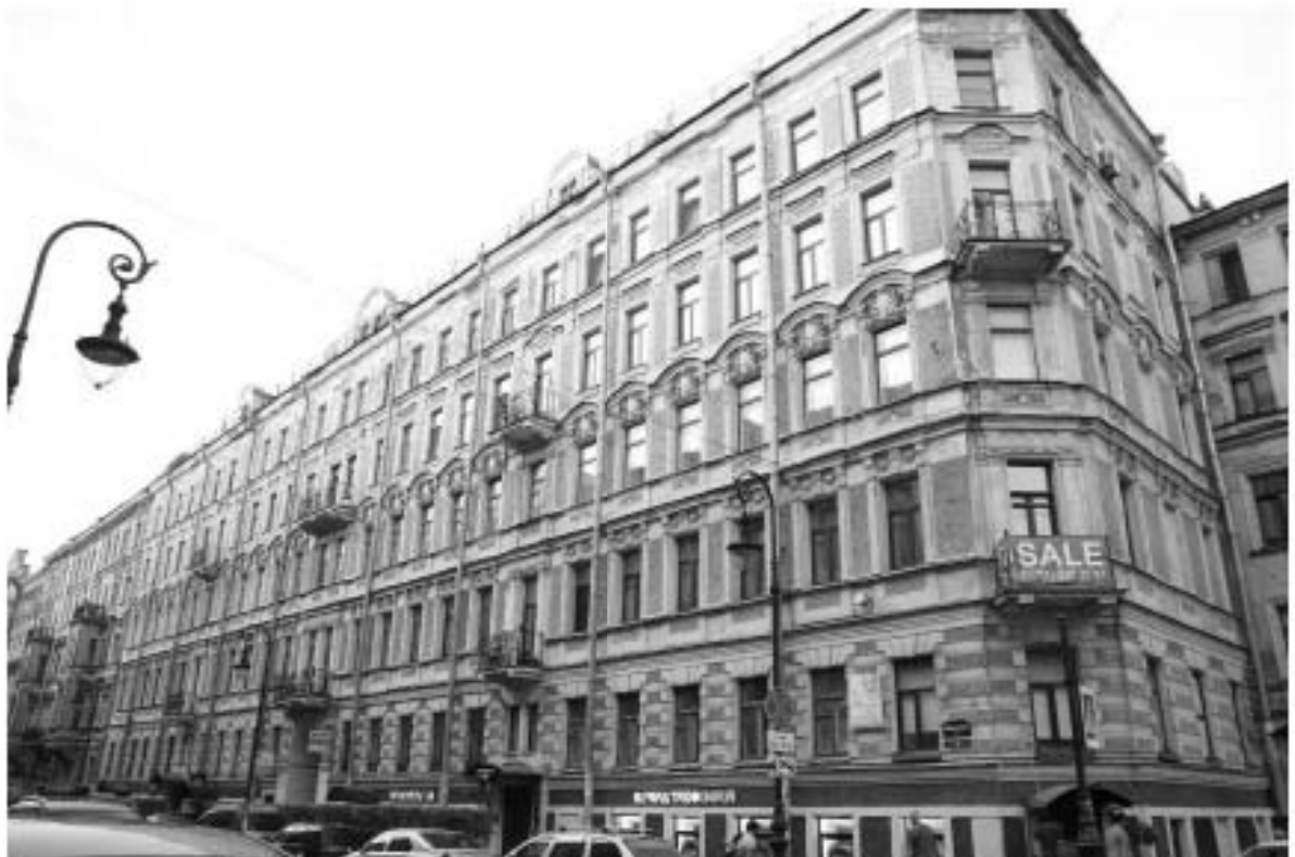
2. Фасад здания по ул. Пушкинская. Вид с запада
