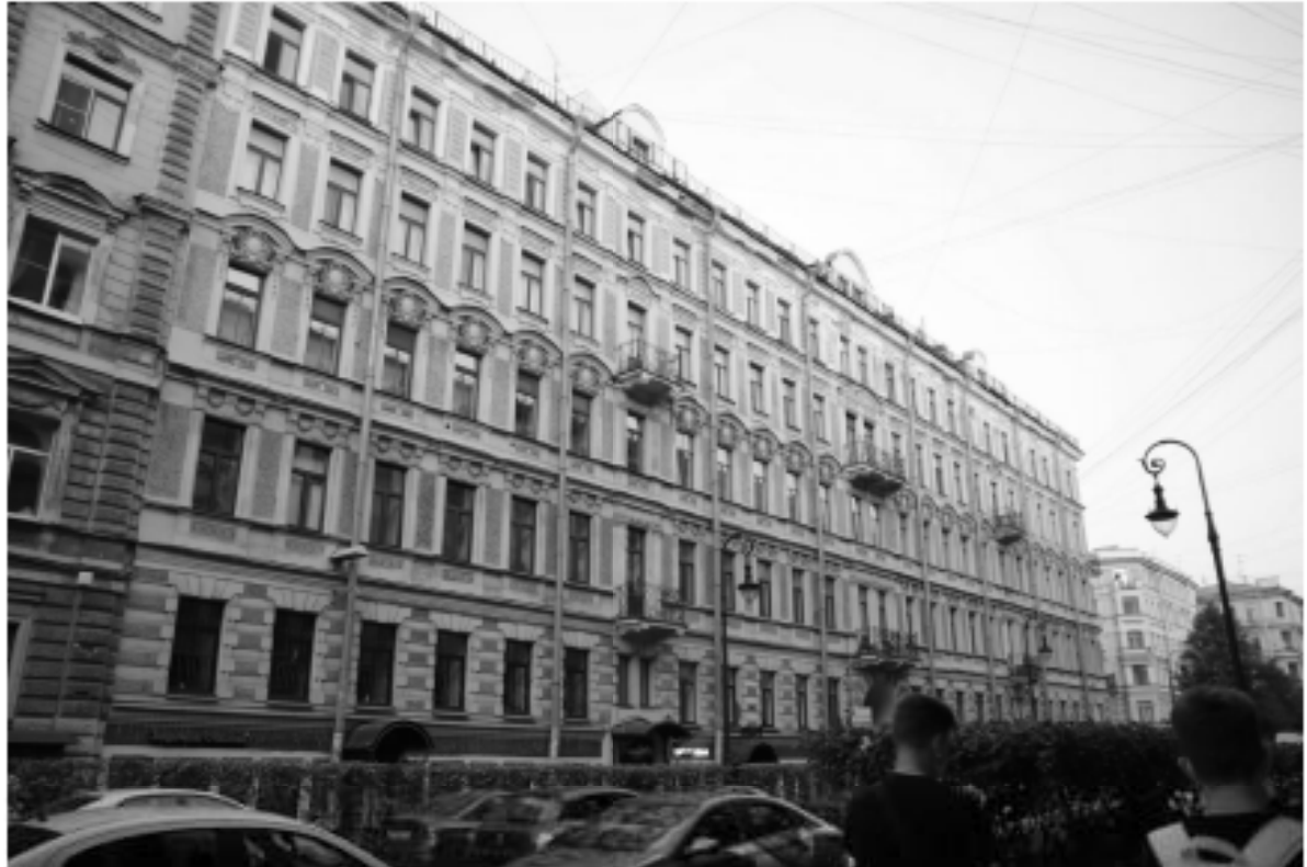
1. Фасад здания по ул. Пушкинская. Вид с севера
