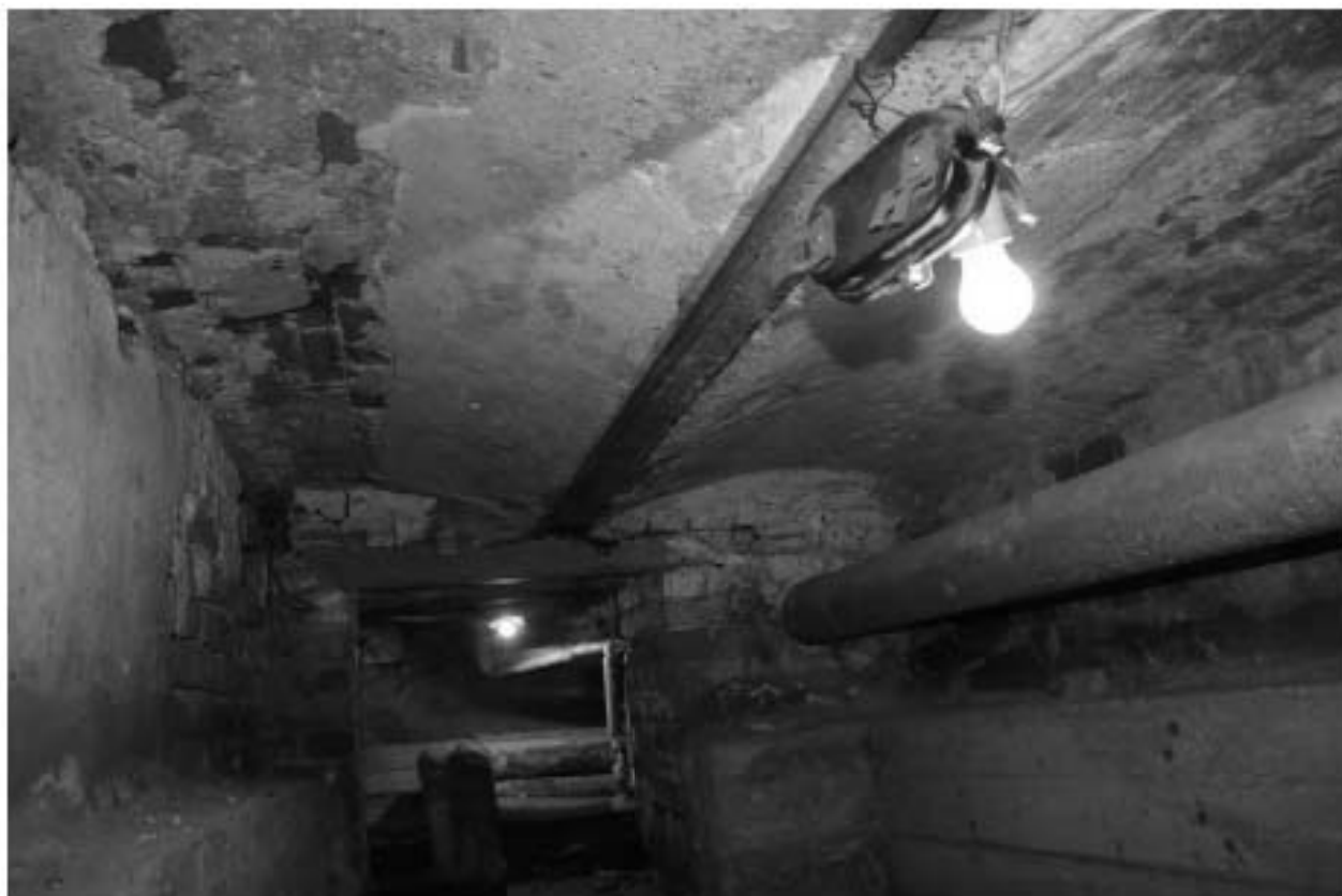
17. Фрагмент оформления потолка подвального помещения
