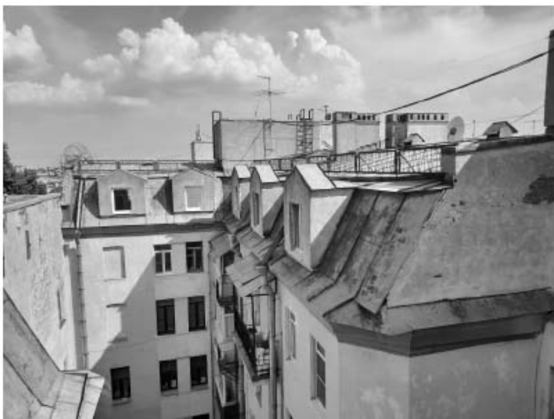
12. Вид на мансарду с крыши здания. Вид с юга
