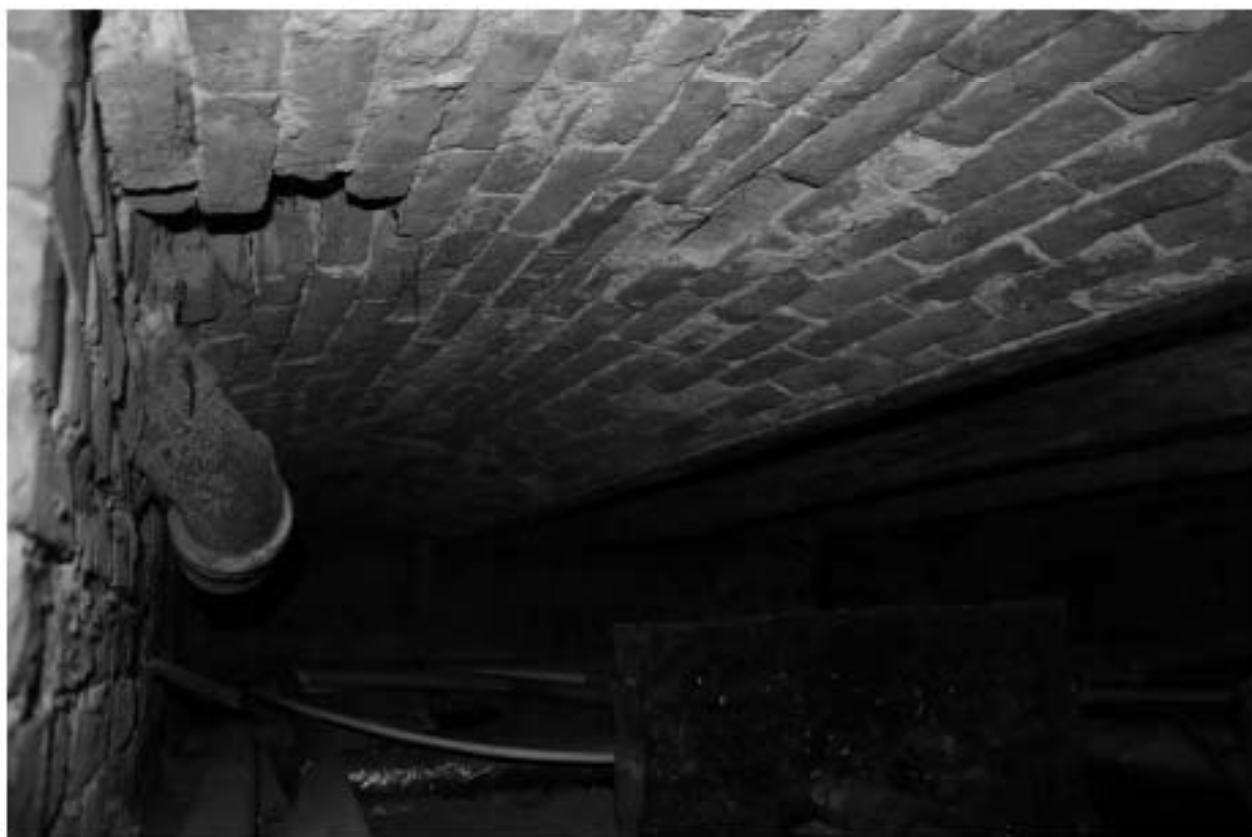
18. Фрагмент оформления потолка подвального помещения
