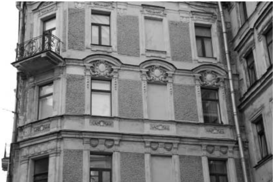
4. Фрагмент фасада. Вид с юго-запада
