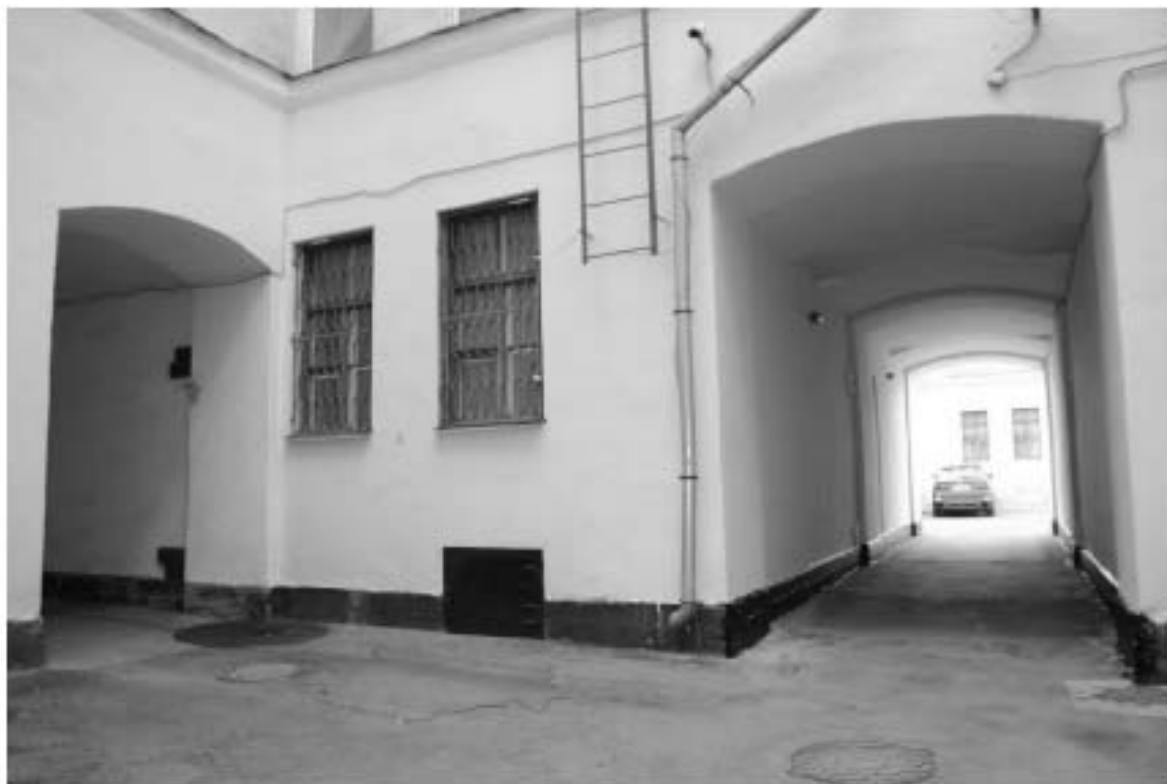
9. Фрагмент фасада. Вид с юго-запада
