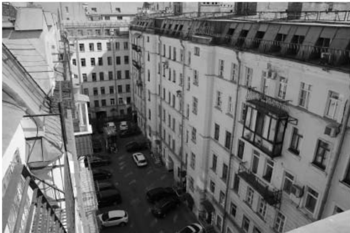
7. Вид на внутренний двор с крыши здания. Вид с севера
