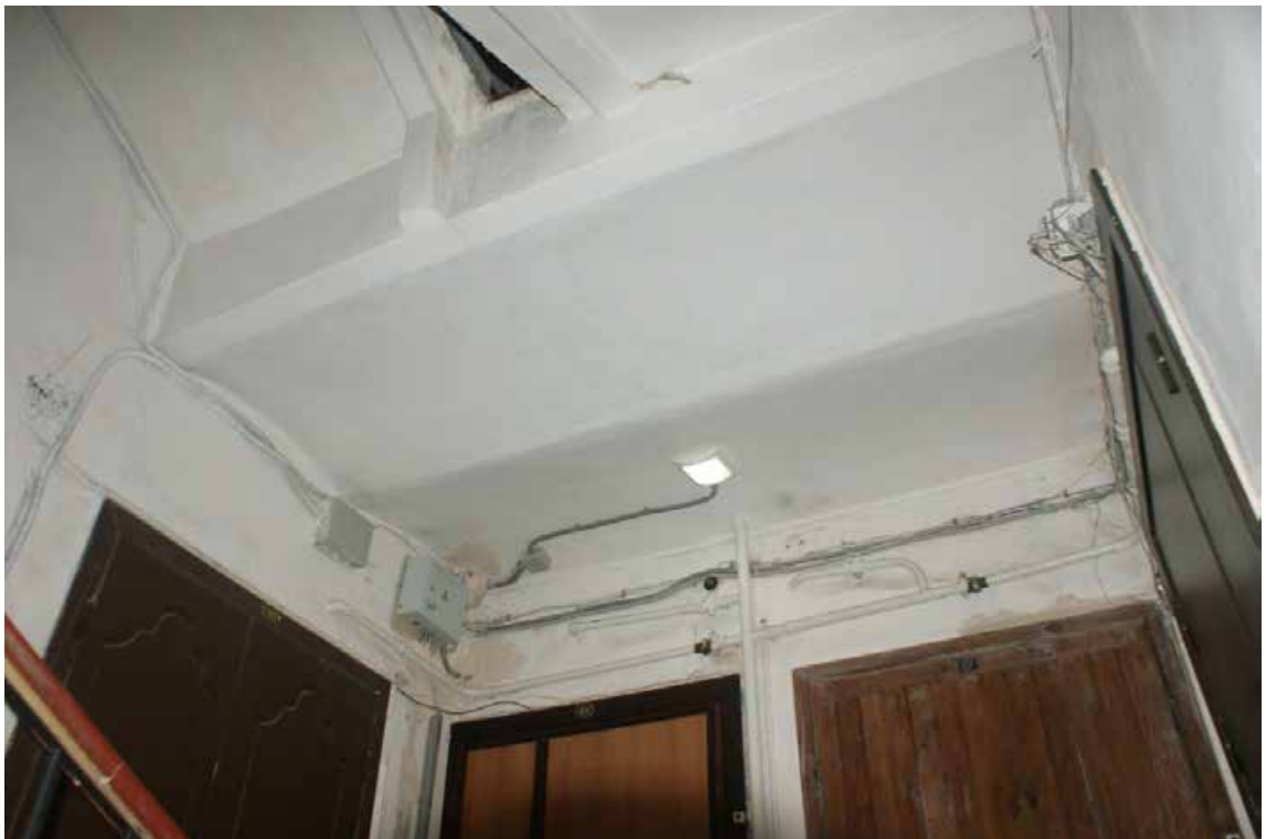
Фото 16. Лестница 1ЛК. 2-й этаж. Своды. Съемка 19.04.2021 г. Штиглиц М. С.
