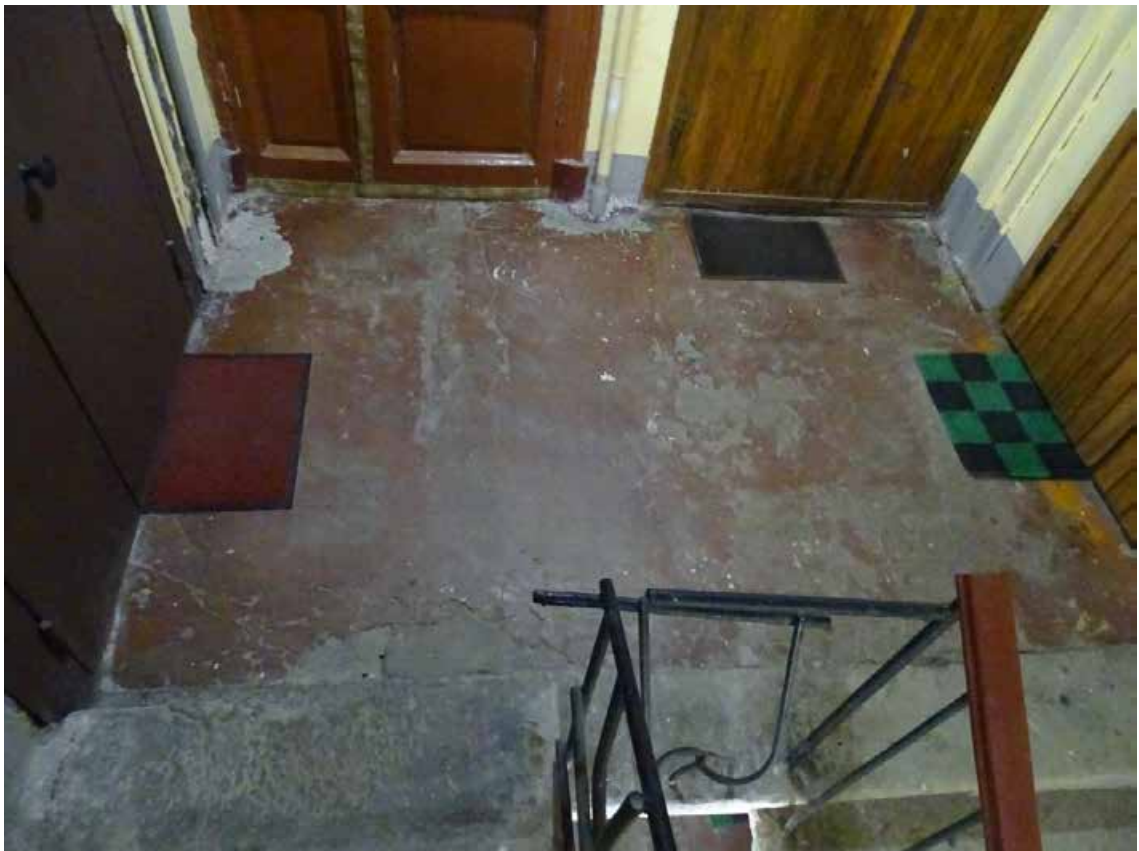
Фото 28. Лестница 1ЛК. 5-й этаж. Покрытие пола. Съёмка 19.04.2021 г. Штиглиц М. С.
