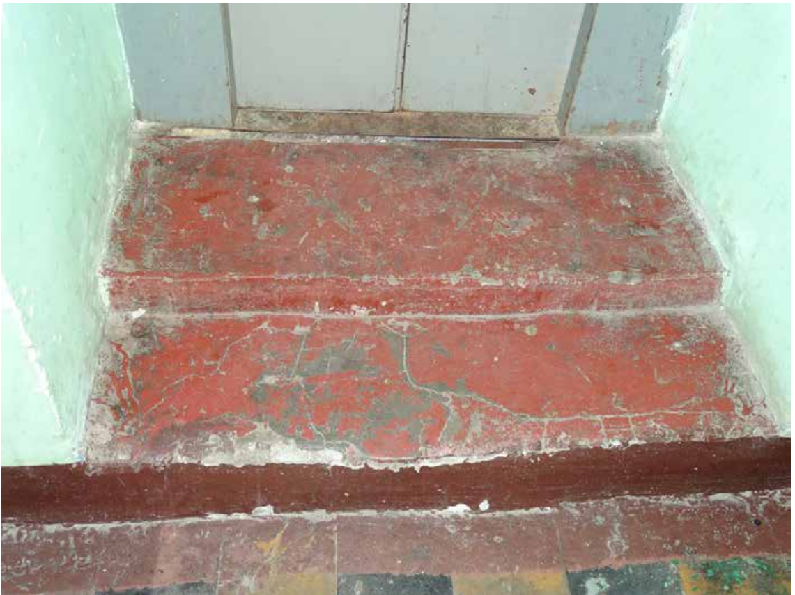
Фото 94. Лестница 3ЛК. Площадка между 1-м и 2-м этажом. Ступени к лифту. Съемка 19.04.2021 г. Штиглиц М. С.
