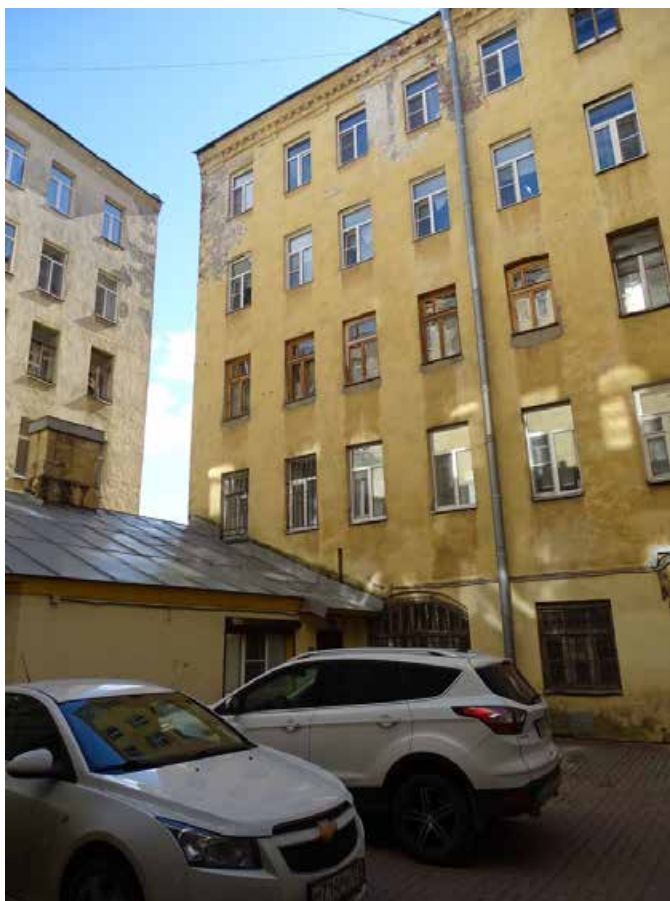
Фото 19. Здание по адресу: г. Санкт-Петербург, Большая Зеленина ул., дом 29, литера Б. Фрагмент дворового фасада. Съемка 19.04.2021 г. Штиглиц М. С.
