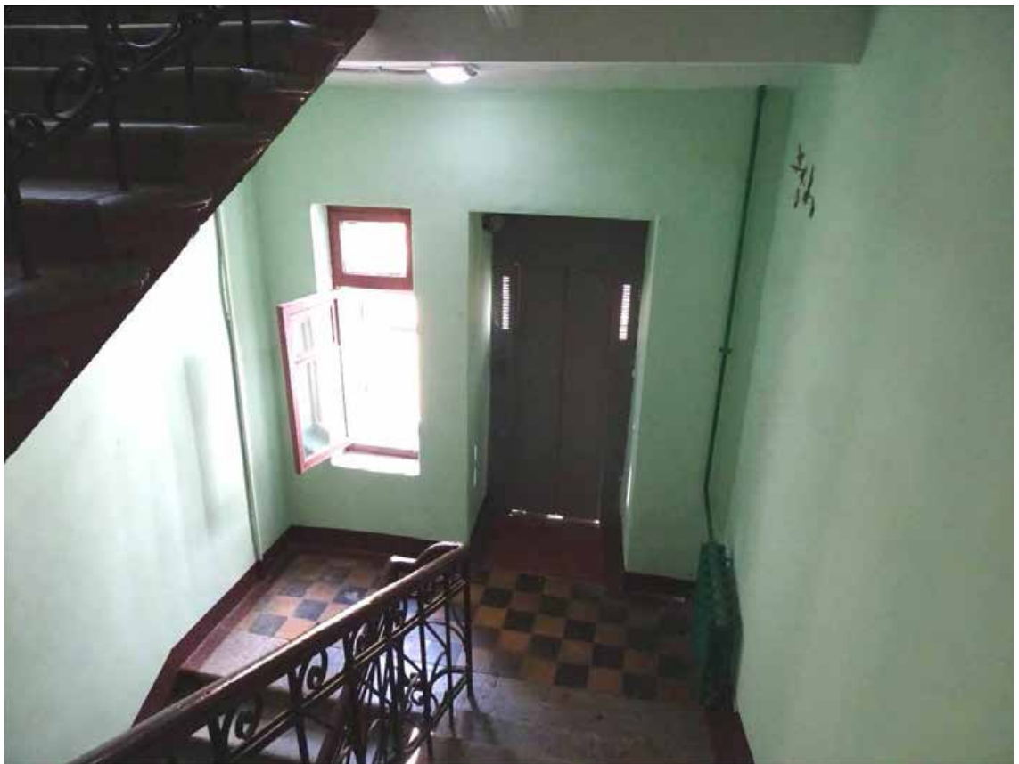
Фото 101. Лестница ЗЛК. Площадка между 3-м и 4-м этажом. Съемка 19.04.2021 г. Штиглиц М. С.
