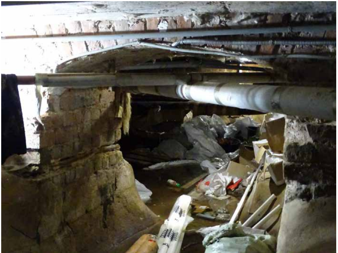
Фото 44. Лестница 2ЛК. Подвал. Съемка 19.04.2021 г. Штиглиц М. С.
