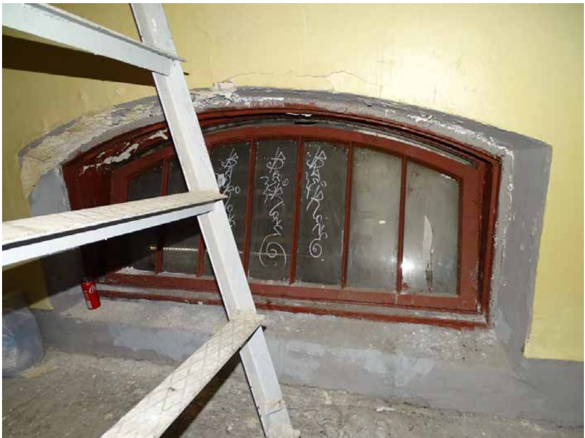
Фото 30. Лестница 1ЛК. Площадка между 5-м и чердачным этажом. Съемка 19.04.2021 г. Штиглиц М. С.
