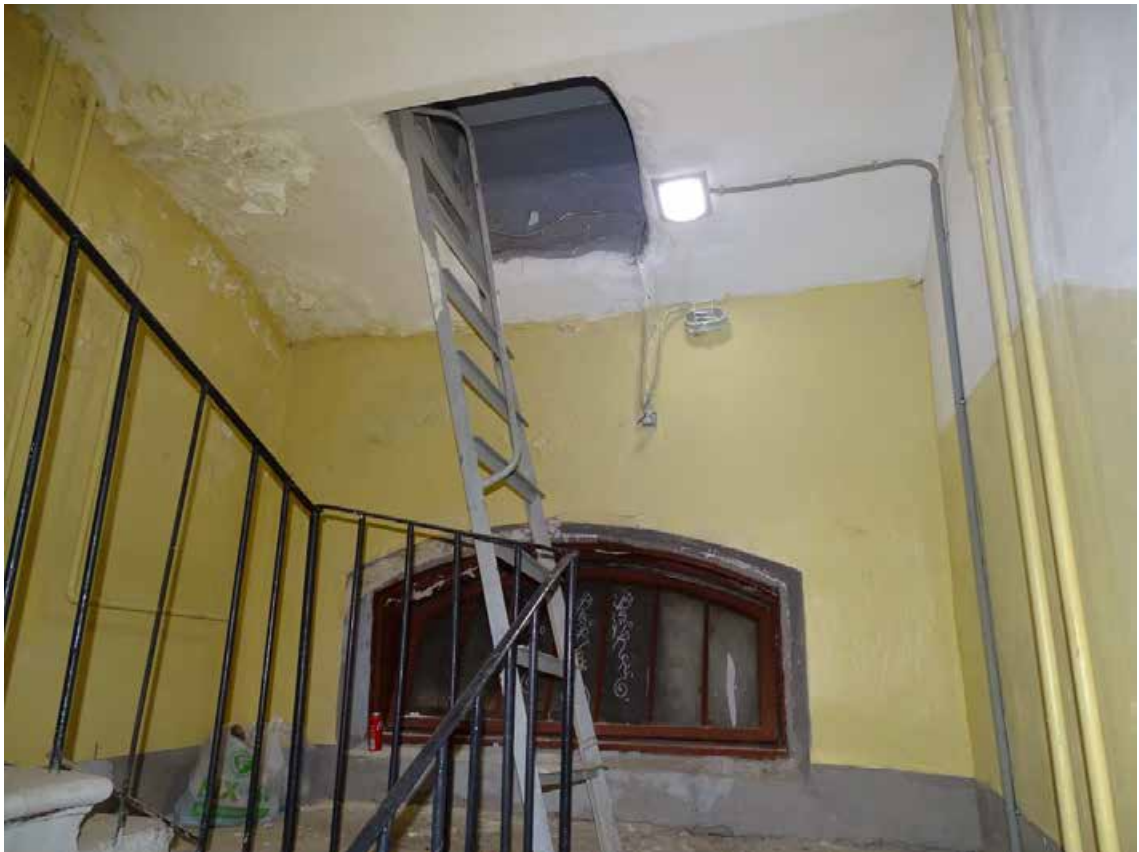
Фото 29. Лестница 1ЛК. Площадка между 5-м и чердачным этажом. Съемка 19.04.2021 г. Штиглиц М. С.
