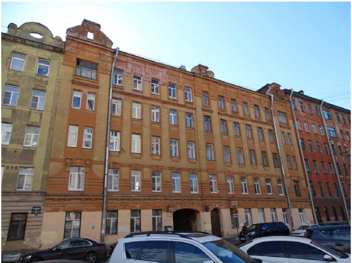
Фото 4. Здание по адресу: г. Санкт-Петербург, Большая Зеленина ул., дом 29, литера Б. Фрагмент лицевого фасада по ул. Петрозаводской. Съемка 19.04.2021 г. Штиглиц М. С.
