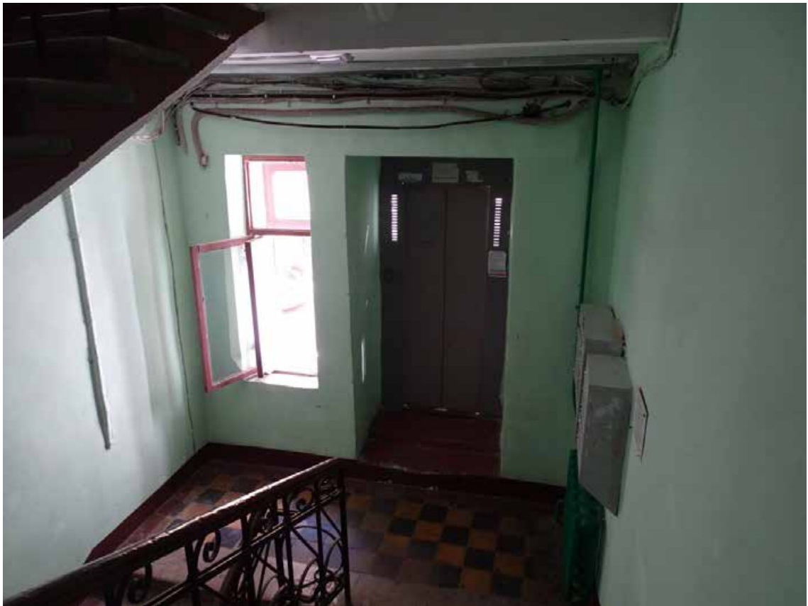
Фото 92. Лестница ЗЛК. Площадка между 1-м и 2-м этажом. Съемка 19.04.2021 г. Штиглиц М. С.
