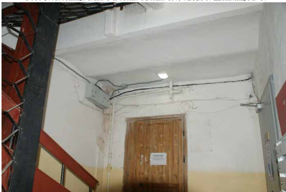
Фото 6. Лестница 1ЛК. 1-й этаж. Своды. Съемка 19.04.2021 г. Штиглиц М. С.
