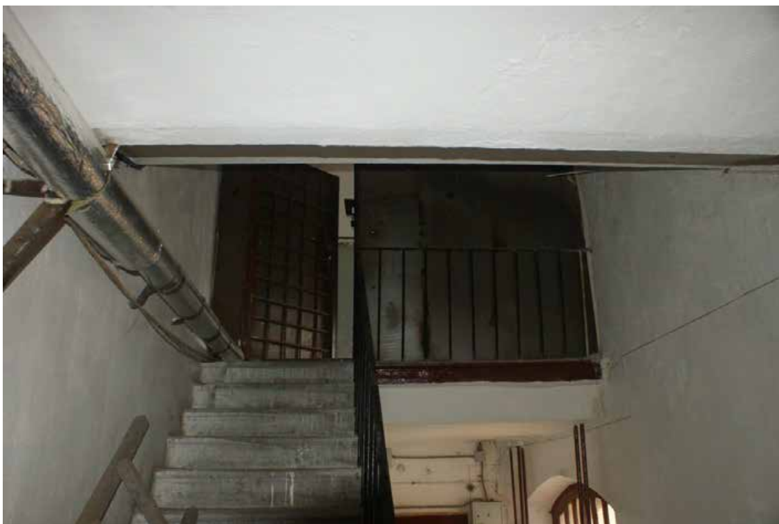
Фото 78. Лестница 2ЛК. Выход на технический этаж. Съёмка 19.04.2021 г. Штиглиц М. С.
