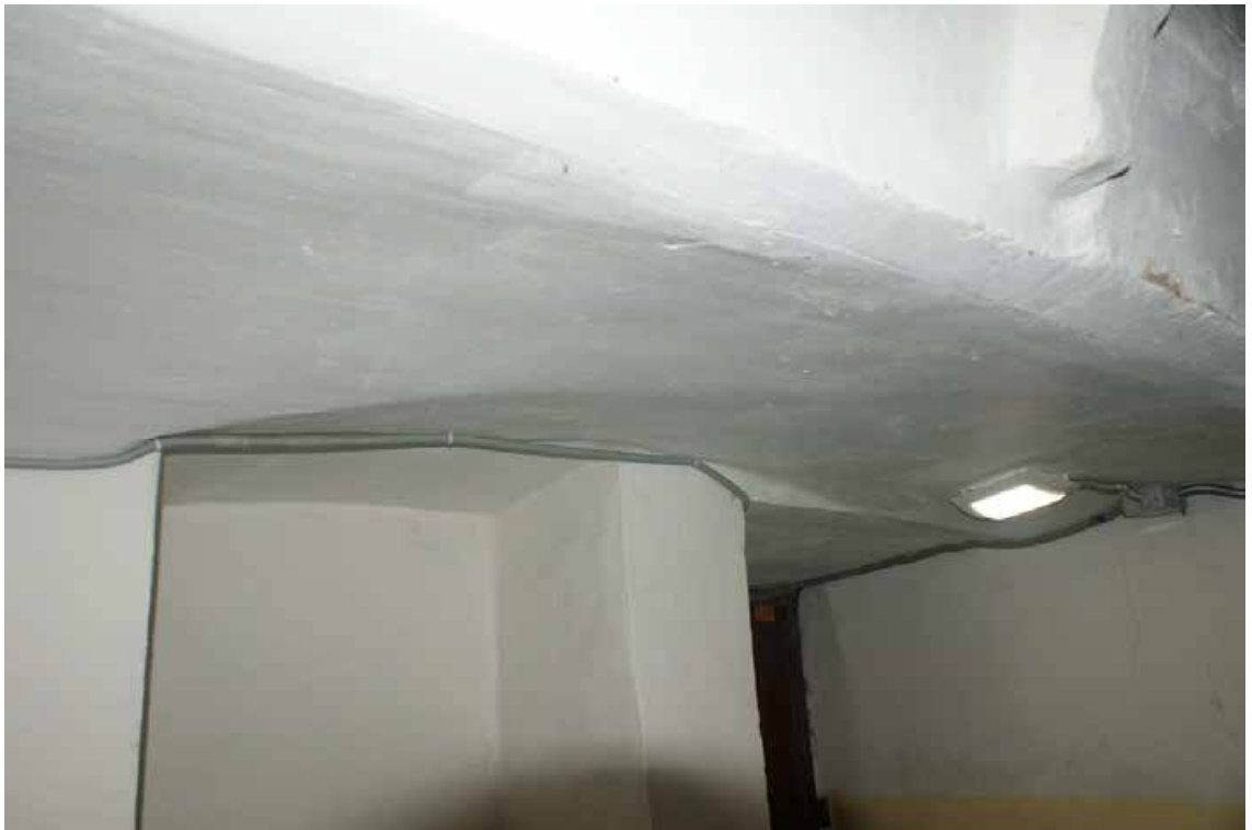
Фото 3. Лестница 1ЛК. 1-й этаж. Перекрытие. Съемка 19.04.2021 г. Штиглиц М. С.
