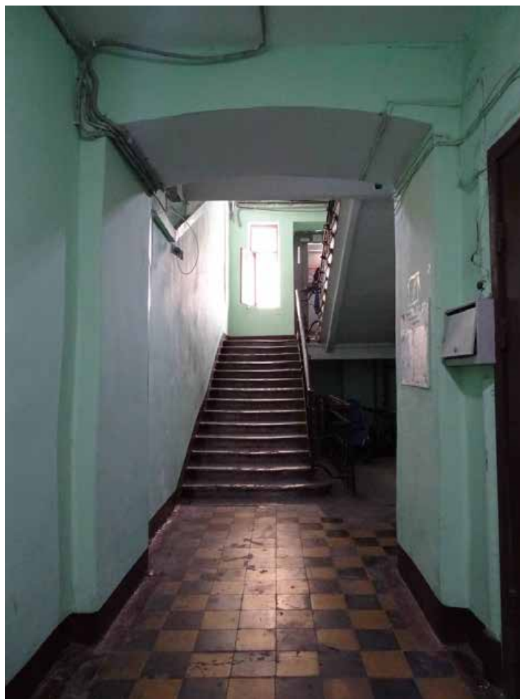
Фото 88. Лестница ЗЛК. 1-й этаж. Вестибюль. Съемка 19.04.2021 г. Штиглиц М. С.
