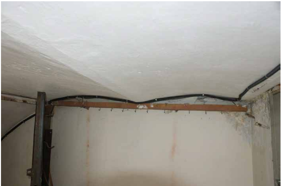
Фото 83. Лестница 2ЛК. Технический этаж. Своды. Съёмка 19.04.2021 г. Штиглиц М. С.
