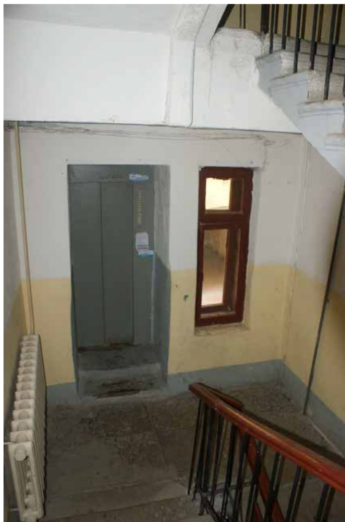
Фото 13. Лестница 1ЛК. Площадка между 1-м и 2-м этажом. Съемка 19.04.2021 г. Штиглиц М. С.
