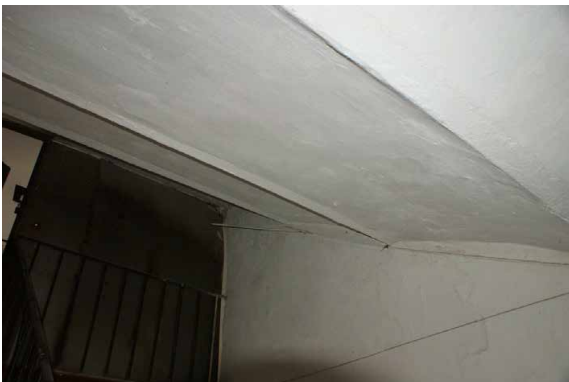
Фото 77. Лестница 2ЛК. Выход на технический этаж. Своды. Съемка 19.04.2021 г. Штиглиц М. С.
