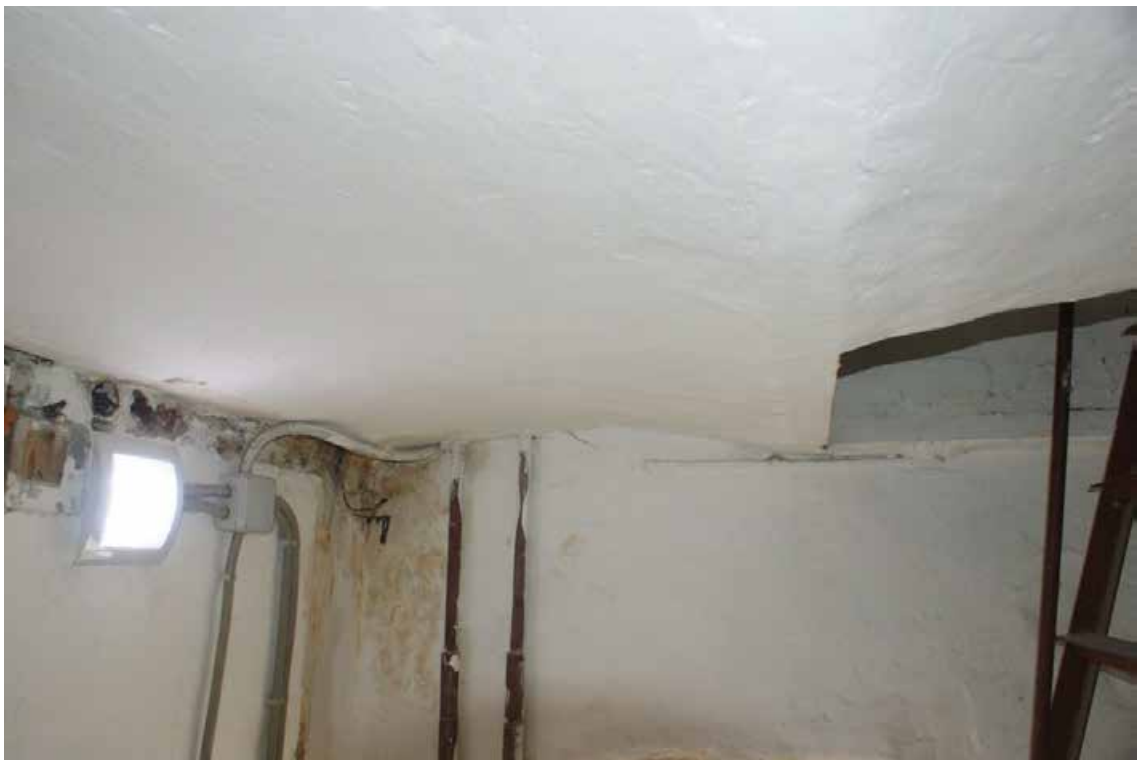
Фото 80. Лестница 2ЛК. Технический этаж. Своды. Съёмка 19.04.2021 г. Штиглиц М. С.
