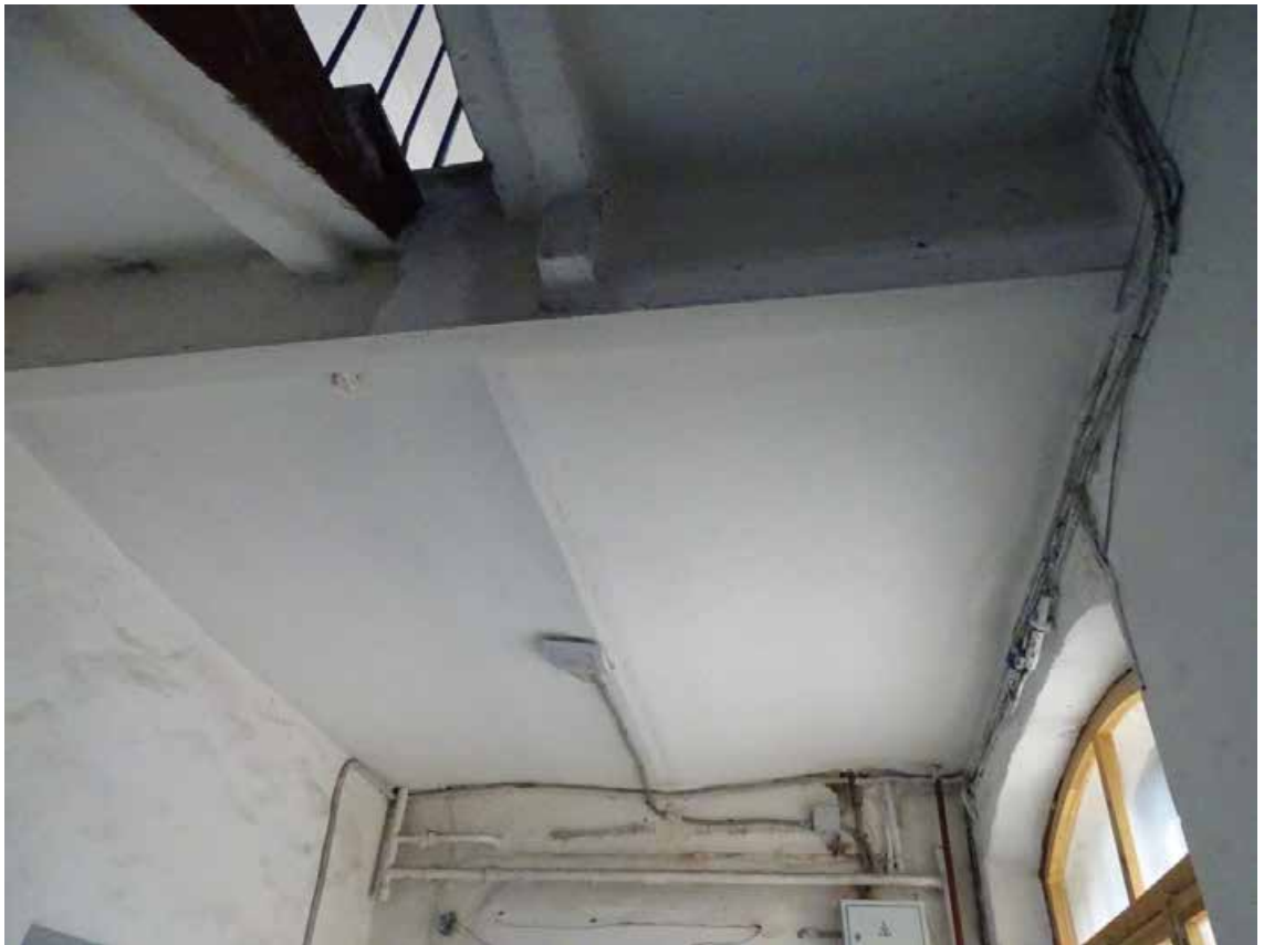
Фото 52. Лестница 2ЛК. 1-й этаж. Своды. Съемка 19.04.2021 г. Штиглиц М. С.
