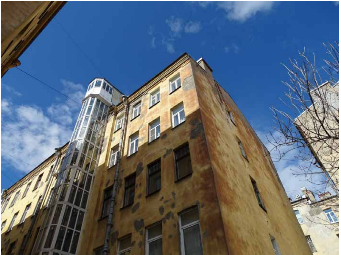
Фото 31. Здание по адресу: г. Санкт-Петербург, Большая Зеленина ул., дом 29, литера Б. Фрагмент северо-восточного фасада 5-ти этажного корпуса. Съемка 19.04.2021 г. Штиглиц М. С.
