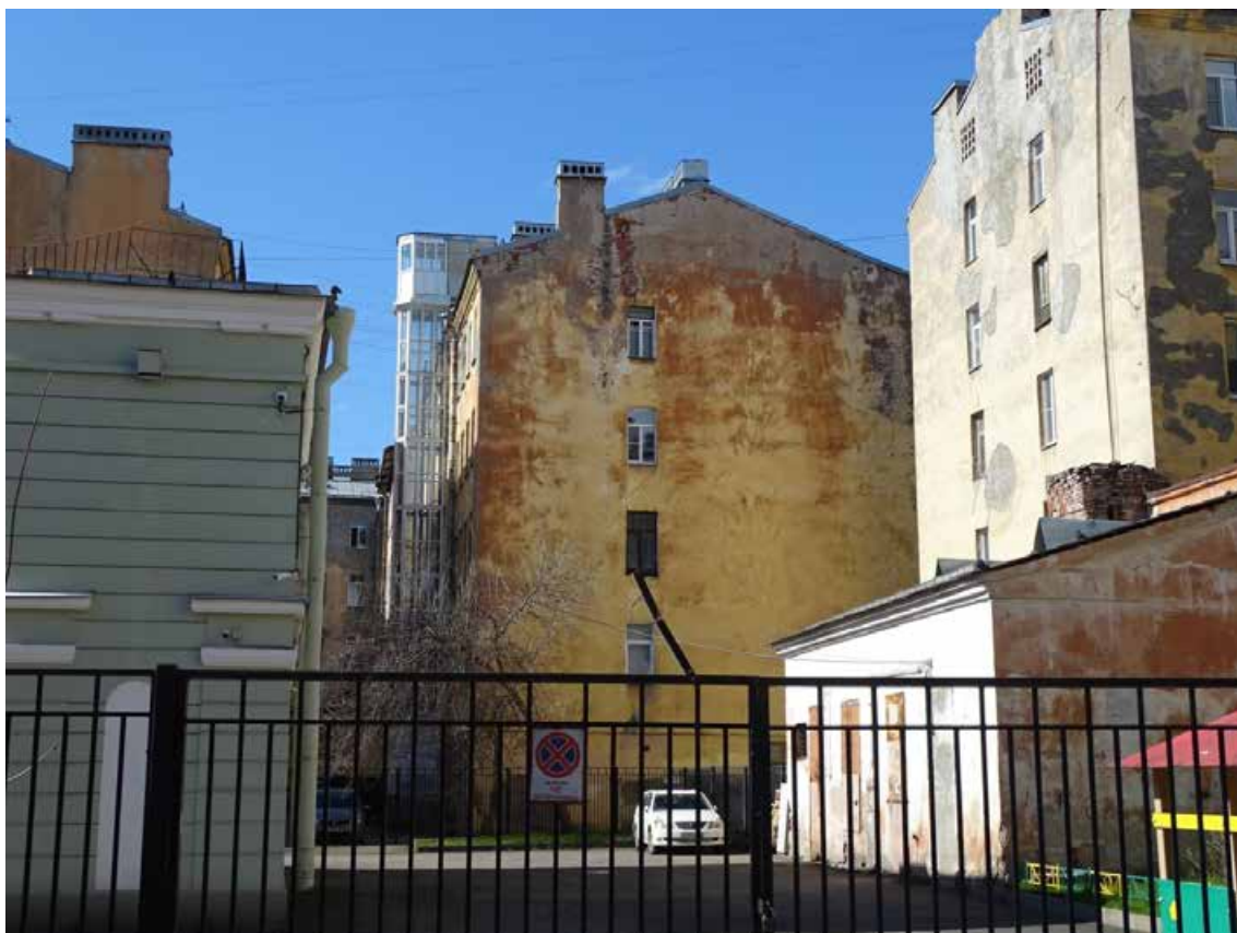
Фото 29. Здание по адресу: г. Санкт-Петербург, Большая Зеленина ул., дом 29, литера Б. Брандмауэр. Съемка 19.04.2021 г. Штиглиц М. С.
