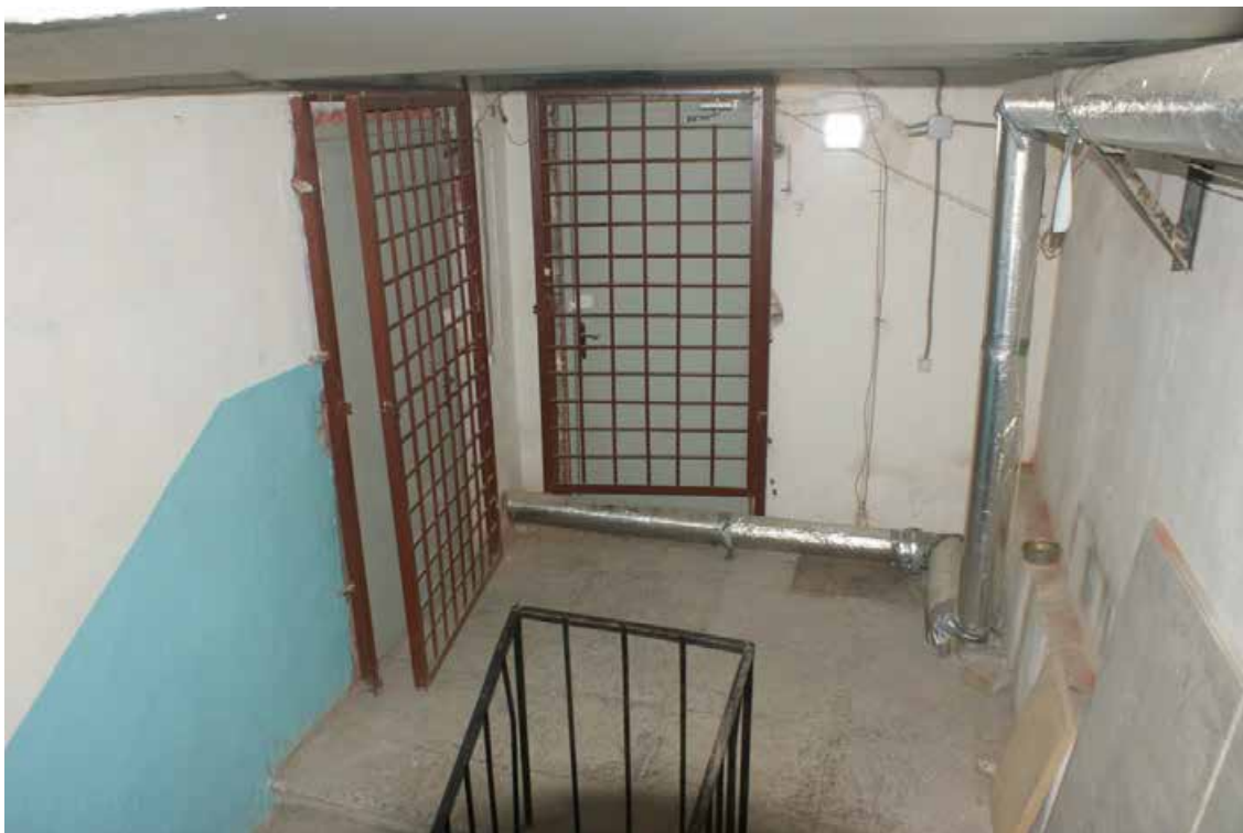
Фото 74. Лестница 2ЛК. Выход на технический этаж. Съёмка 19.04.2021 г. Штиглиц М. С.
