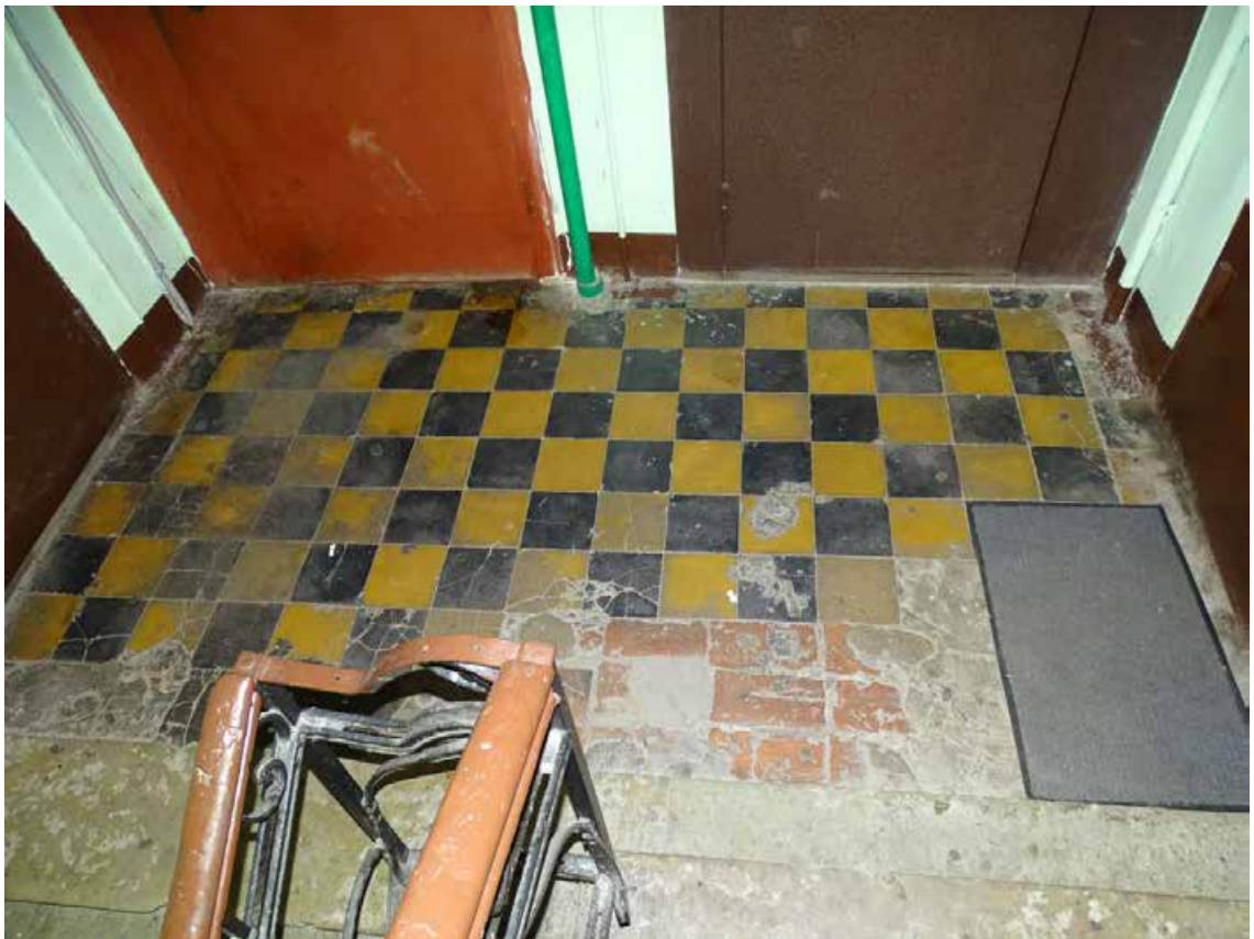
Фото 97. Лестница ЗЛК. 2-й этаж. Покрытие пола. Съемка 19.04.2021 г. Штиглиц М. С.
