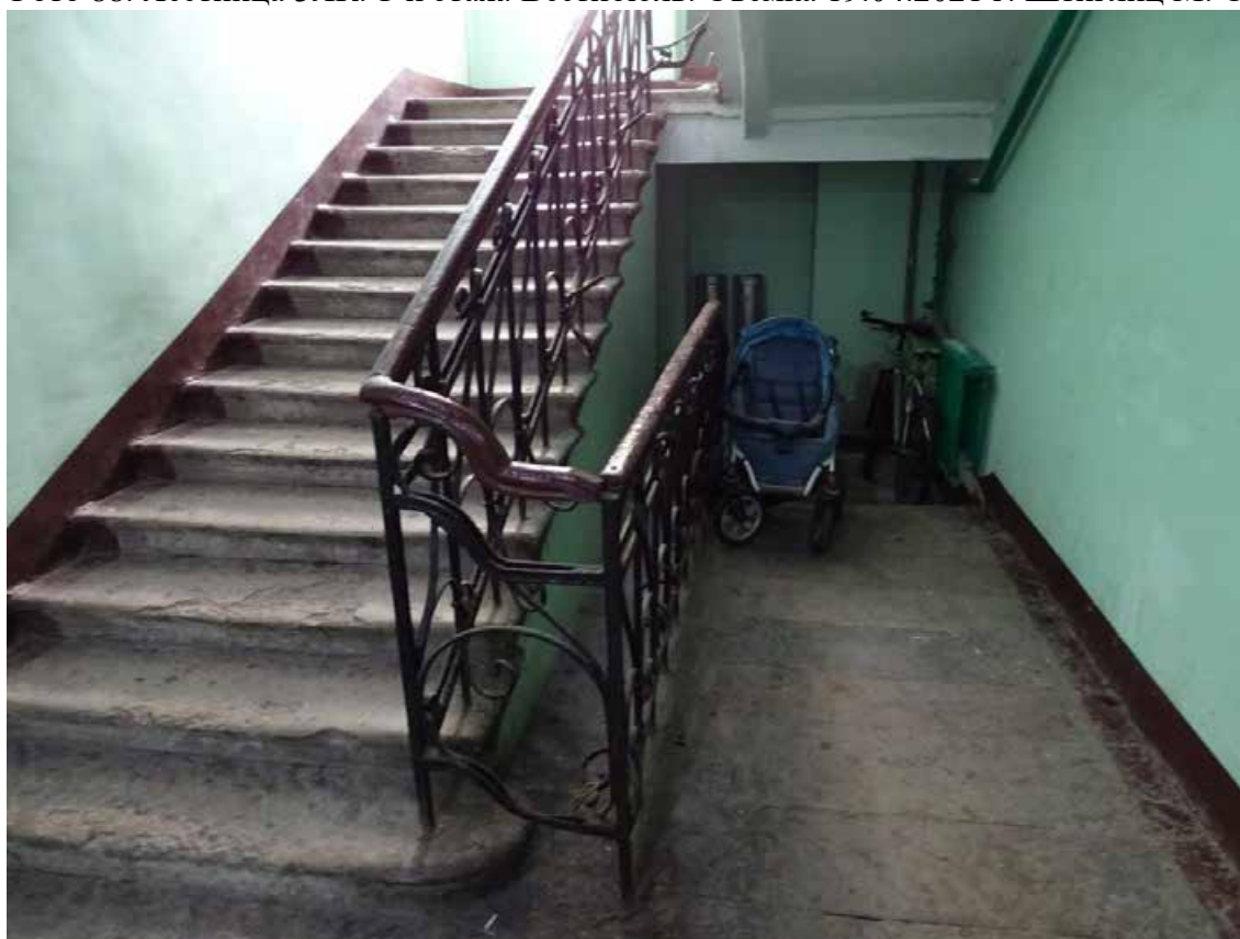
Фото 89. Лестница ЗЛК. 1-й этаж. Вестибюль. Съемка 19.04.2021 г. Штиглиц М. С.
