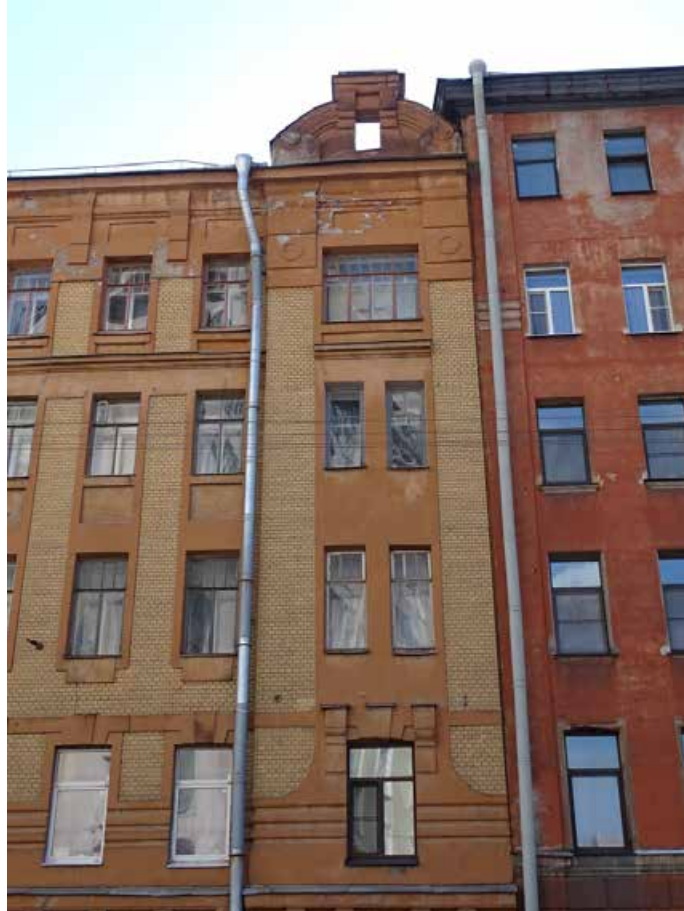
Фото 2. Здание по адресу: г. Санкт-Петербург, Большая Зеленина ул., дом 29, литера Б. Фрагмент лицевого фасада по ул. Петрозаводской. Съемка 19.04.2021 г. Штиглиц М. С.
