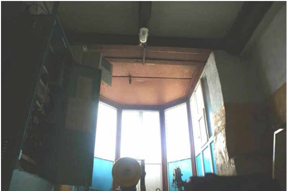
Фото 82. Лестница 2ЛК. Технический этаж. Съёмка 19.04.2021 г. Штиглиц М. С.
