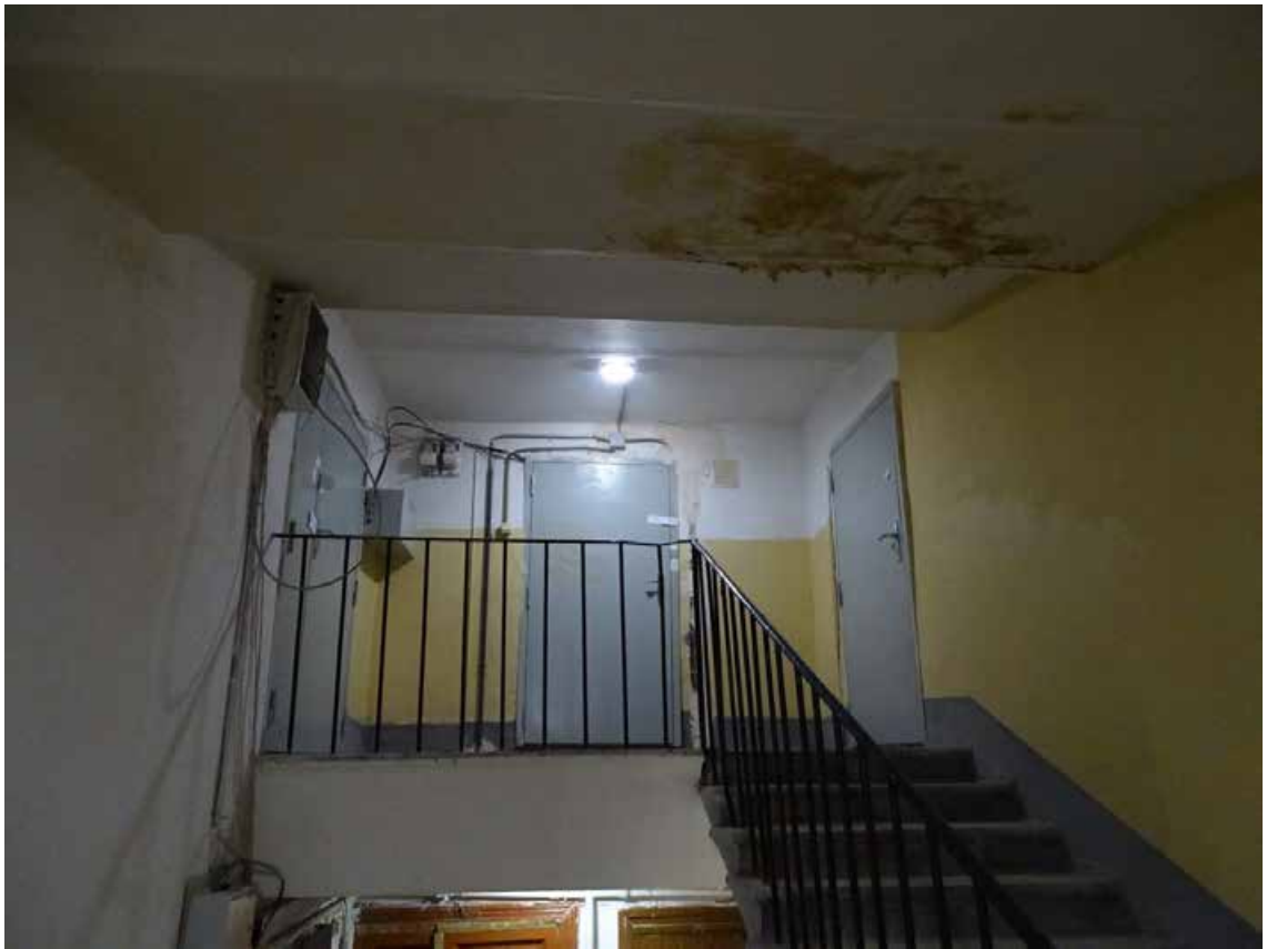
Фото 33. Лестница 1ЛК. Чердачный этаж. Съемка 19.04.2021 г. Штиглиц М. С.
