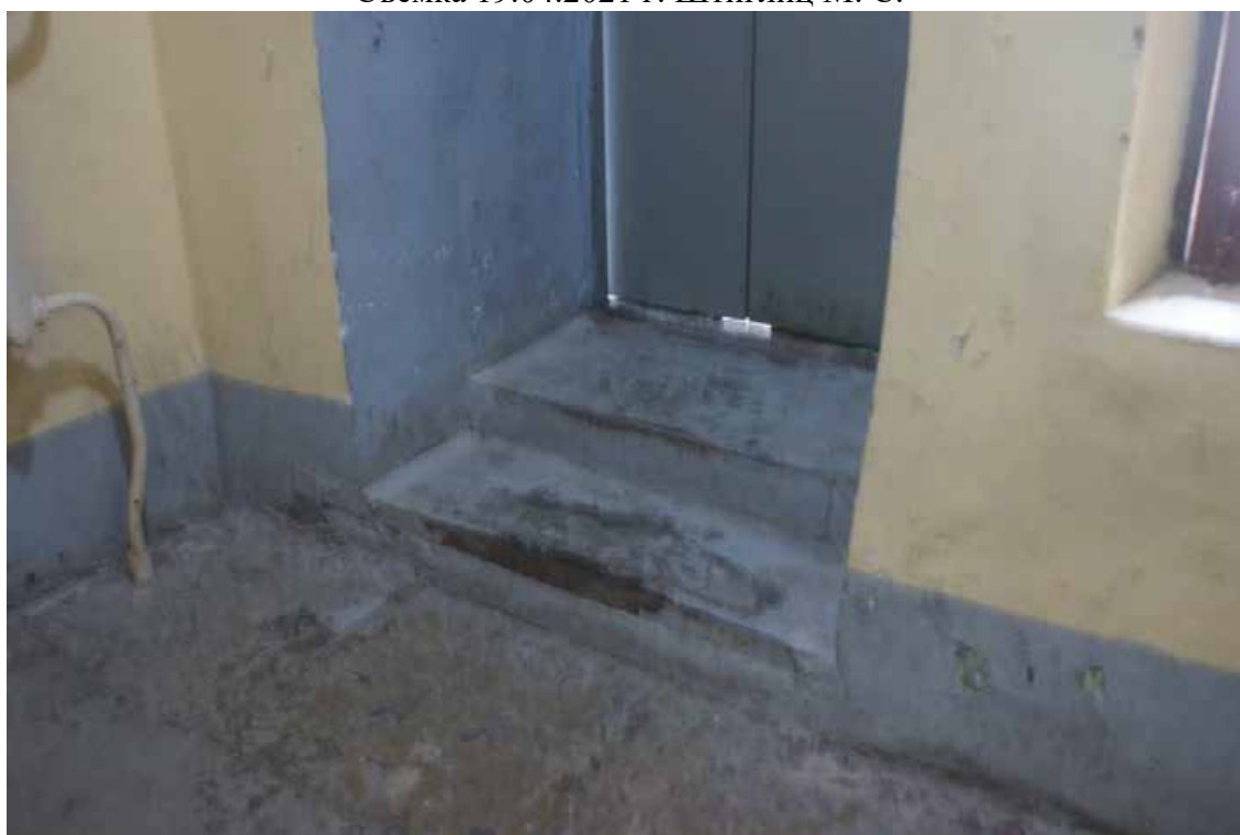
Фото 14. Лестница 1ЛК. Площадка между 1-м и 2-м этажом. Съемка 19.04.2021 г. Штиглиц М. С.
