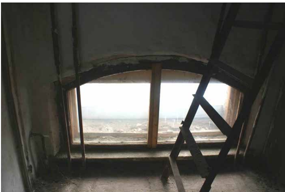
Фото 79. Лестница 2ЛК. Технический этаж. Съёмка 19.04.2021 г. Штиглиц М. С.
