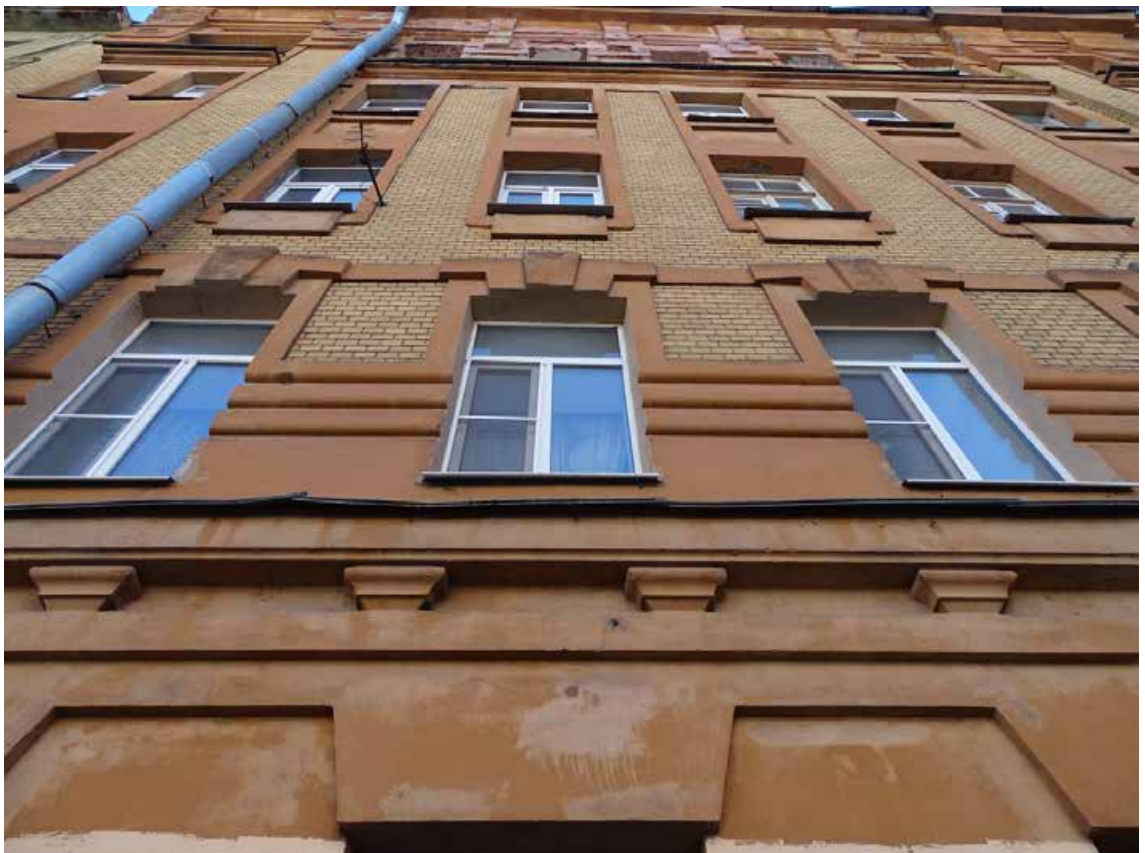
Фото 8. Здание по адресу: г. Санкт-Петербург, Большая Зеленина ул., дом 29, литера Б. Фрагмент лицевого фасада по ул. Петрозаводской. Съемка 19.04.2021 г. Штиглиц М. С.
