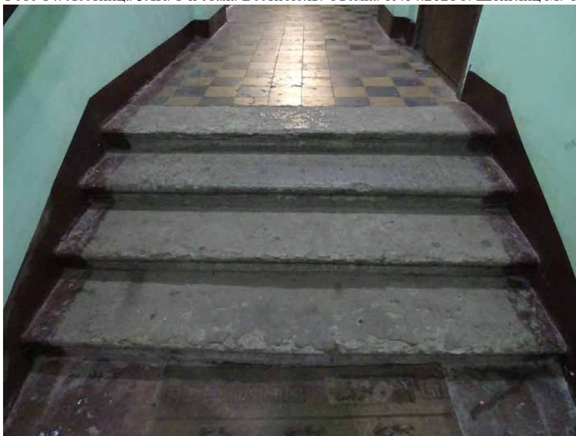
Фото 85. Лестница ЗЛК. 1-й этаж. Вестибюль. Ступени. Съёмка 19.04.2021 г. Штиглиц М. С.
