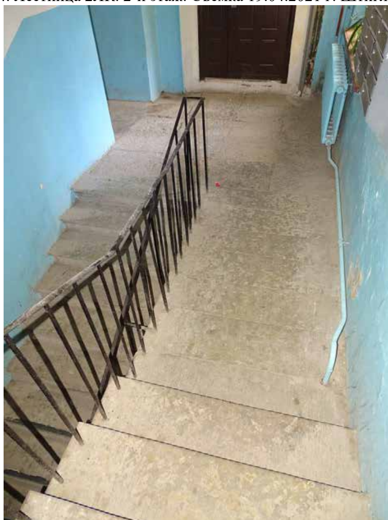
Фото 55. Лестница 2ЛК. Площадка 2-го этажа. Съемка 19.04.2021 г. Штиглиц М. С.
