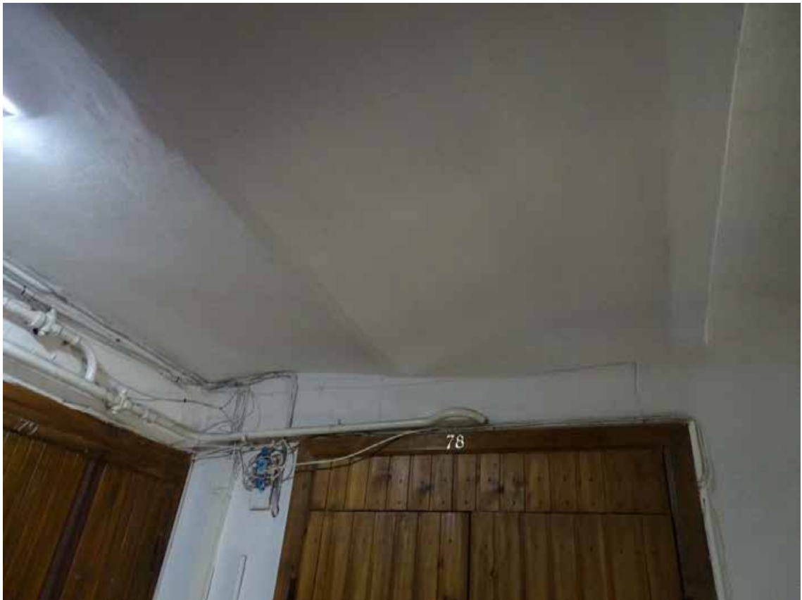
Фото 27. Лестница 1ЛК. 5-й этаж. Своды. Съёмка 19.04.2021 г. Штиглиц М. С.
