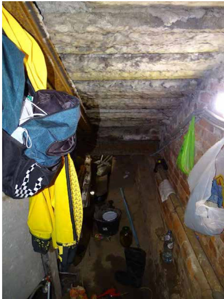
Фото 43. Лестница 2ЛК. 1-й этаж. Подвал. Съемка 19.04.2021 г. Штиглиц М. С.
