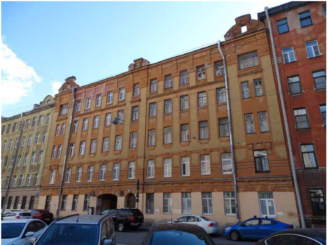
Фото 1. Здание по адресу: г. Санкт-Петербург, Большая Зеленина ул., дом 29, литера Б. Лицевой фасад по ул. Петрозаводской. Съемка 19.04.2021 г. Штиглиц М. С.
