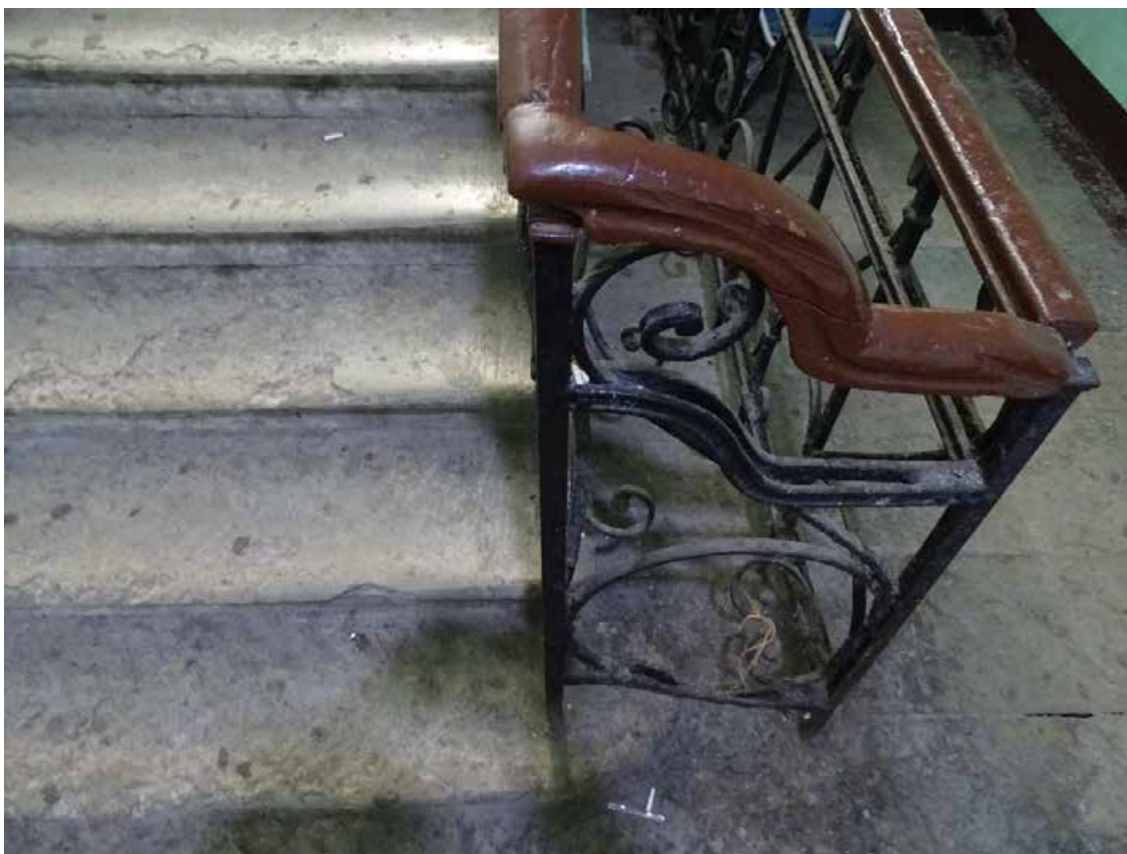
Фото 90. Лестница ЗЛК. 1-й этаж. Вестибюль. Ступени лестничного марша. Съемка 19.04.2021 г. Штиглиц М. С.
