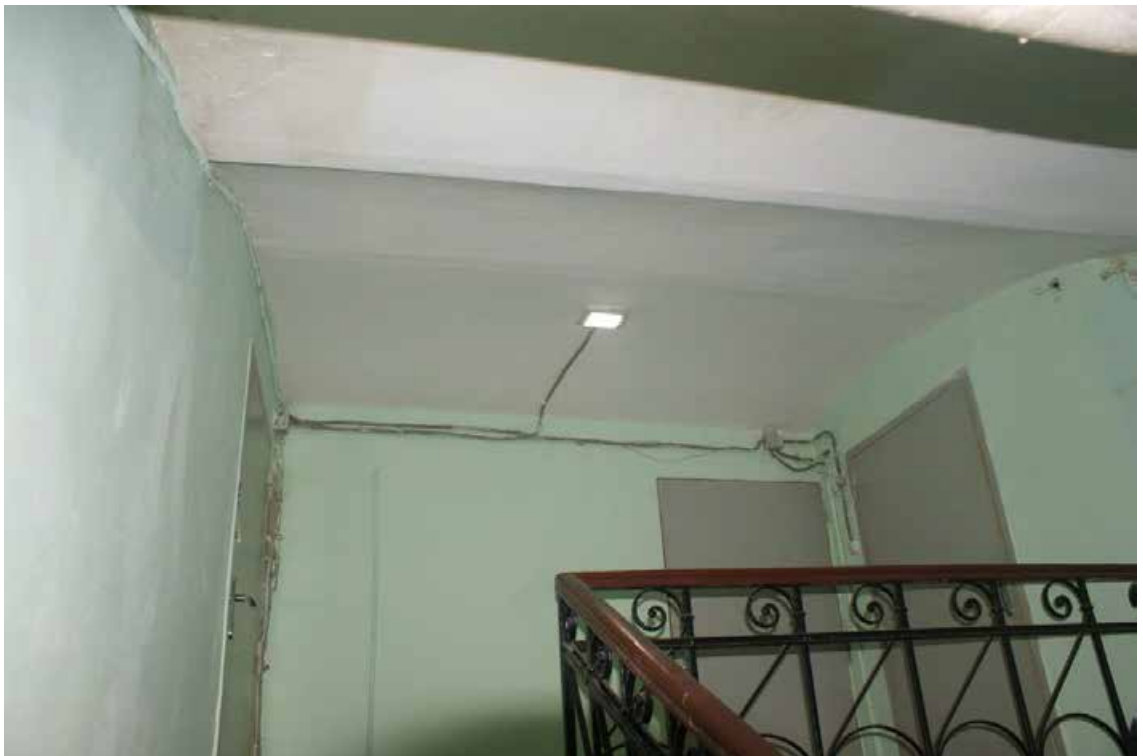
Фото 115. Лестница ЗЛК. Чердачный этаж. Своды. Съемка 19.04.2021 г. Штиглиц М. С.
