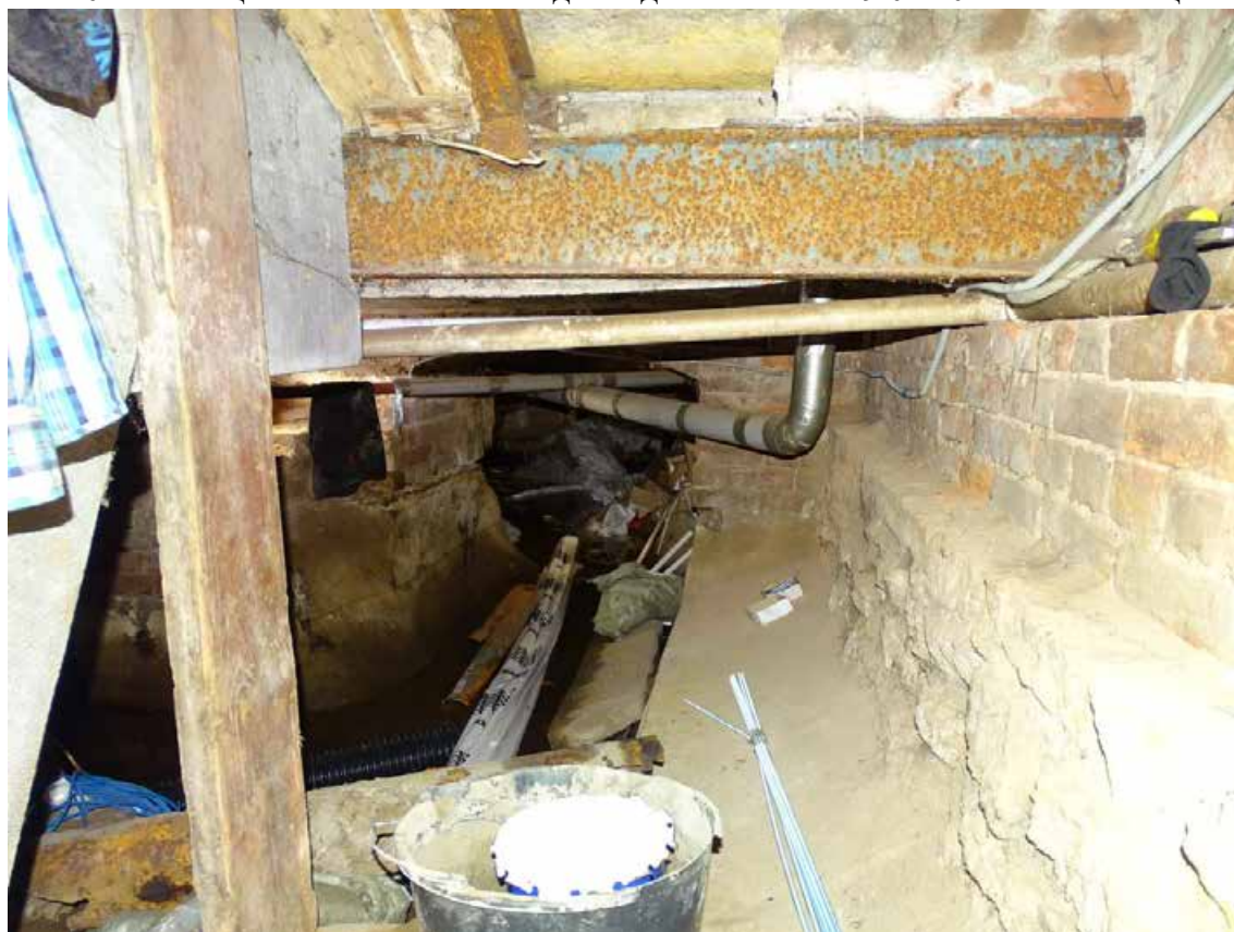
Фото 41. Лестница 2ЛК. Подвал. Съемка 19.04.2021 г. Штиглиц М. С.
