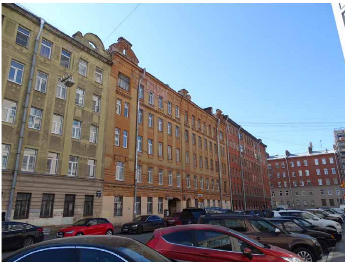
Фото 10. Здание по адресу: г. Санкт-Петербург, Большая Зеленина ул., дом 29, литера Б. Лицевой фасад по ул. Петрозаводской. Съемка 19.04.2021 г. Штиглиц М. С.
