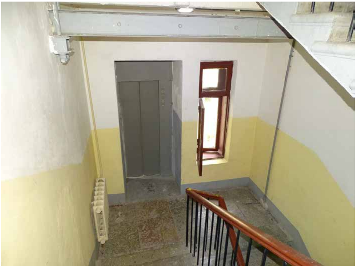
Фото 20. Лестница 1ЛК. Площадка между 3-м и 4-м этажом. Съемка 19.04.2021 г. Штиглиц М. С.
