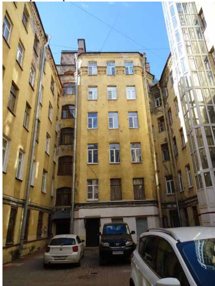
Фото 24. Здание по адресу: г. Санкт-Петербург, Большая Зеленина ул., дом 29, литера Б. Фрагмент дворового фасада. Съемка 19.04.2021 г. Штиглиц М. С.
