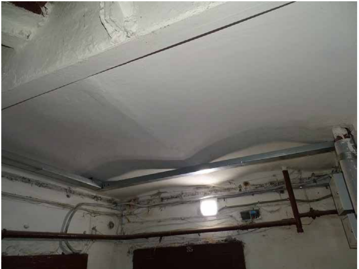
Фото 48. Лестница 2ЛК. 1-й этаж. Своды. Съемка 19.04.2021 г. Штиглиц М. С.
