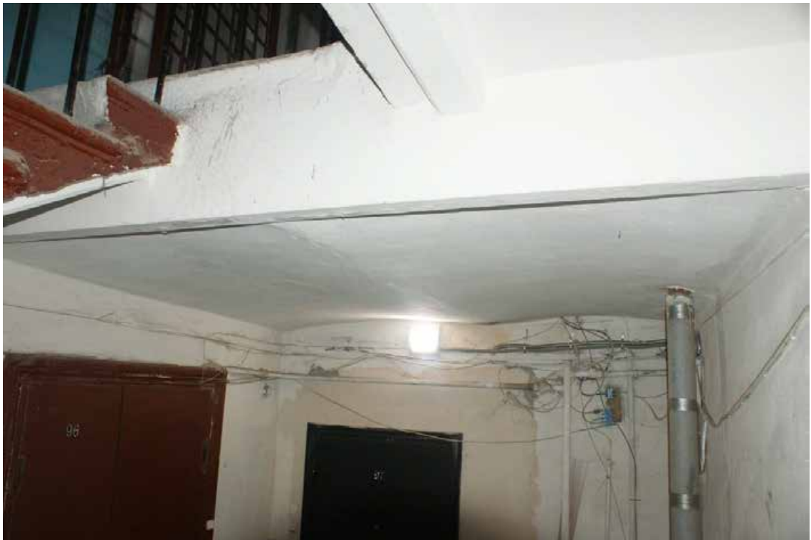
Фото 68. Лестница 2ЛК. 5-й этаж. Своды. Съемка 19.04.2021 г. Штиглиц М. С.
