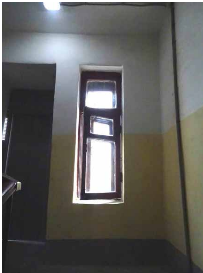
Фото 23. Лестница 1ЛК. Площадка между 4-м и 5-м этажом. Съемка 19.04.2021 г. Штиглиц М. С.
