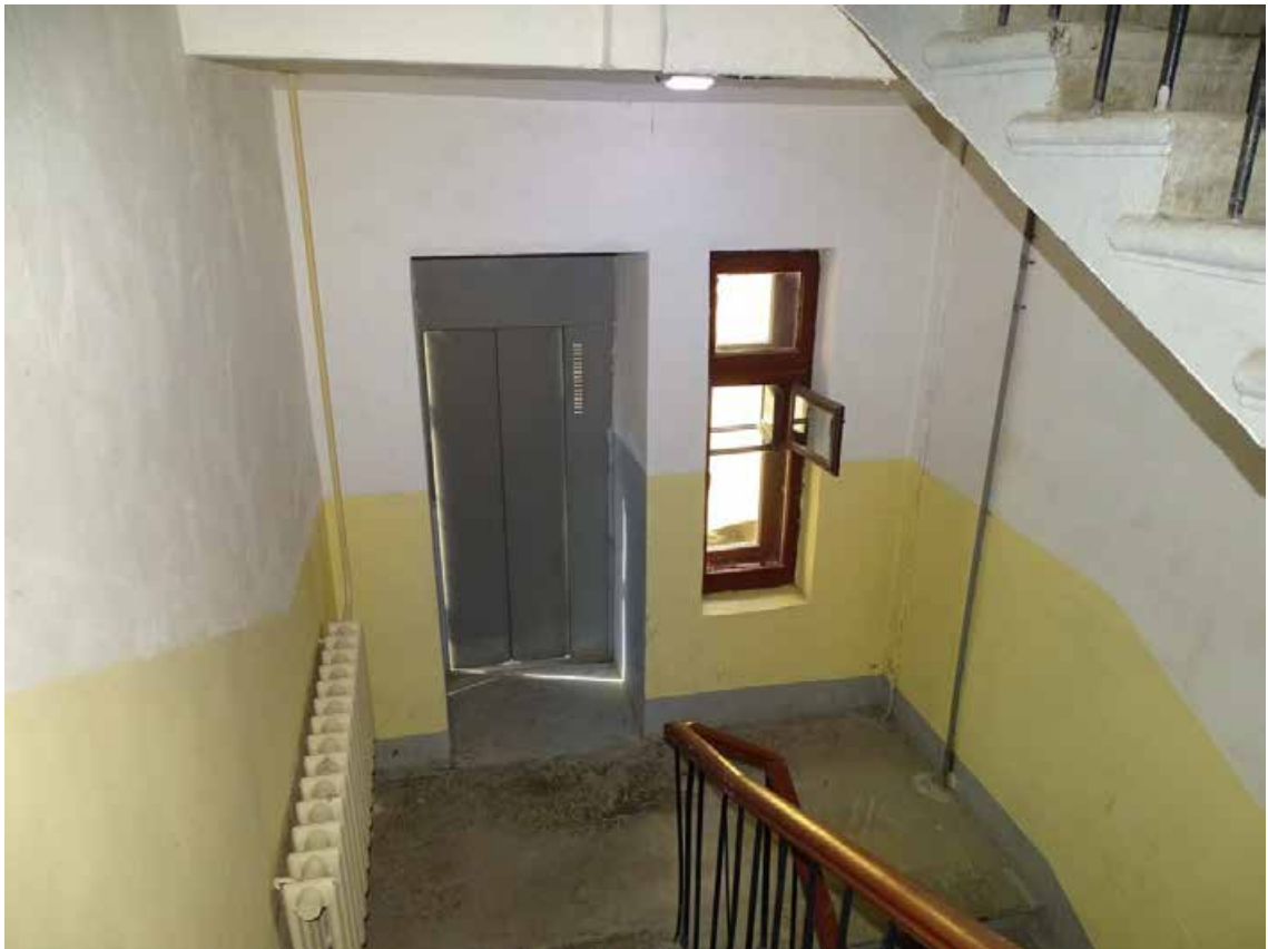
Фото 17. Лестница 1ЛК. Площадка между 2-м и 3-м этажом. Съемка 19.04.2021 г. Штиглиц М. С.
