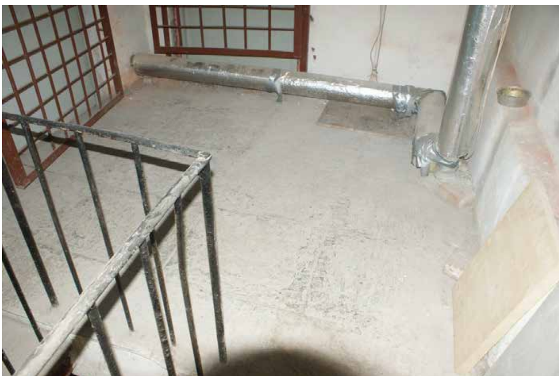
Фото 75. Лестница 2ЛК. Выход на технический этаж. Съёмка 19.04.2021 г. Штиглиц М. С.
