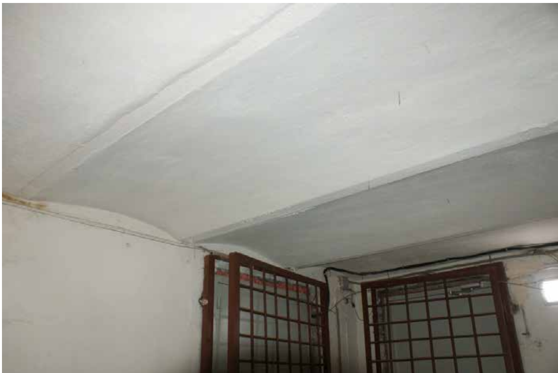
Фото 76. Лестница 2ЛК. Выход на технический этаж. Своды. Съемка 19.04.2021 г. Штиглиц М. С.
