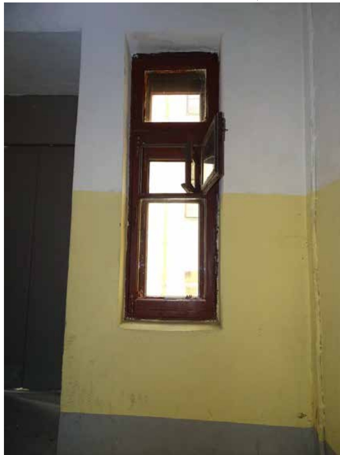
Фото 18. Лестница 1ЛК. Площадка между 2-м и 3-м этажом. Съемка 19.04.2021 г. Штиглиц М. С.
