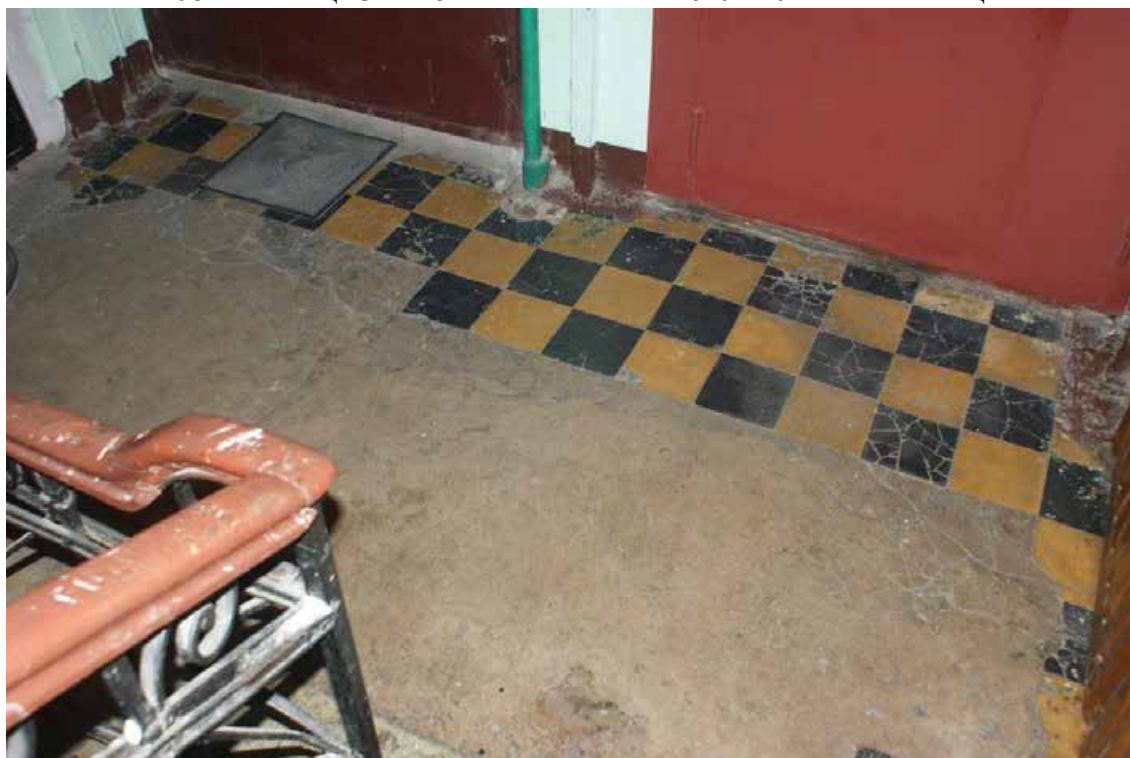
Фото 109. Лестница ЗЛК. 5-й этаж. Покрытие пола. Съемка 19.04.2021 г. Штиглиц М. С.
