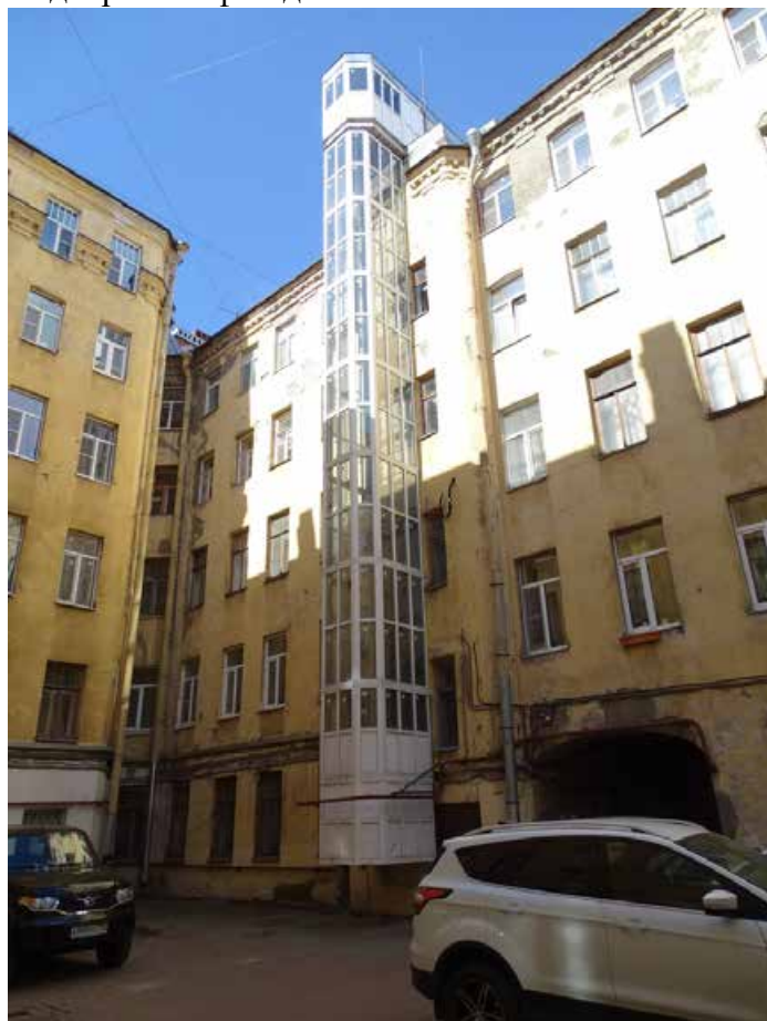
Фото 26. Здание по адресу: г. Санкт-Петербург, Большая Зеленина ул., дом 29, литера Б. Фрагмент дворового фасада. Лицевой корпус. Съемка 19.04.2021 г. Штиглиц М. С.
