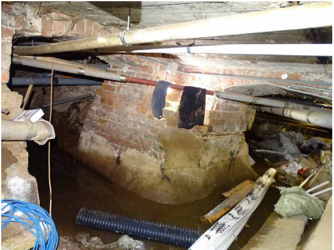
Фото 42. Лестница 2ЛК. Подвал. Съемка 19.04.2021 г. Штиглиц М. С.
