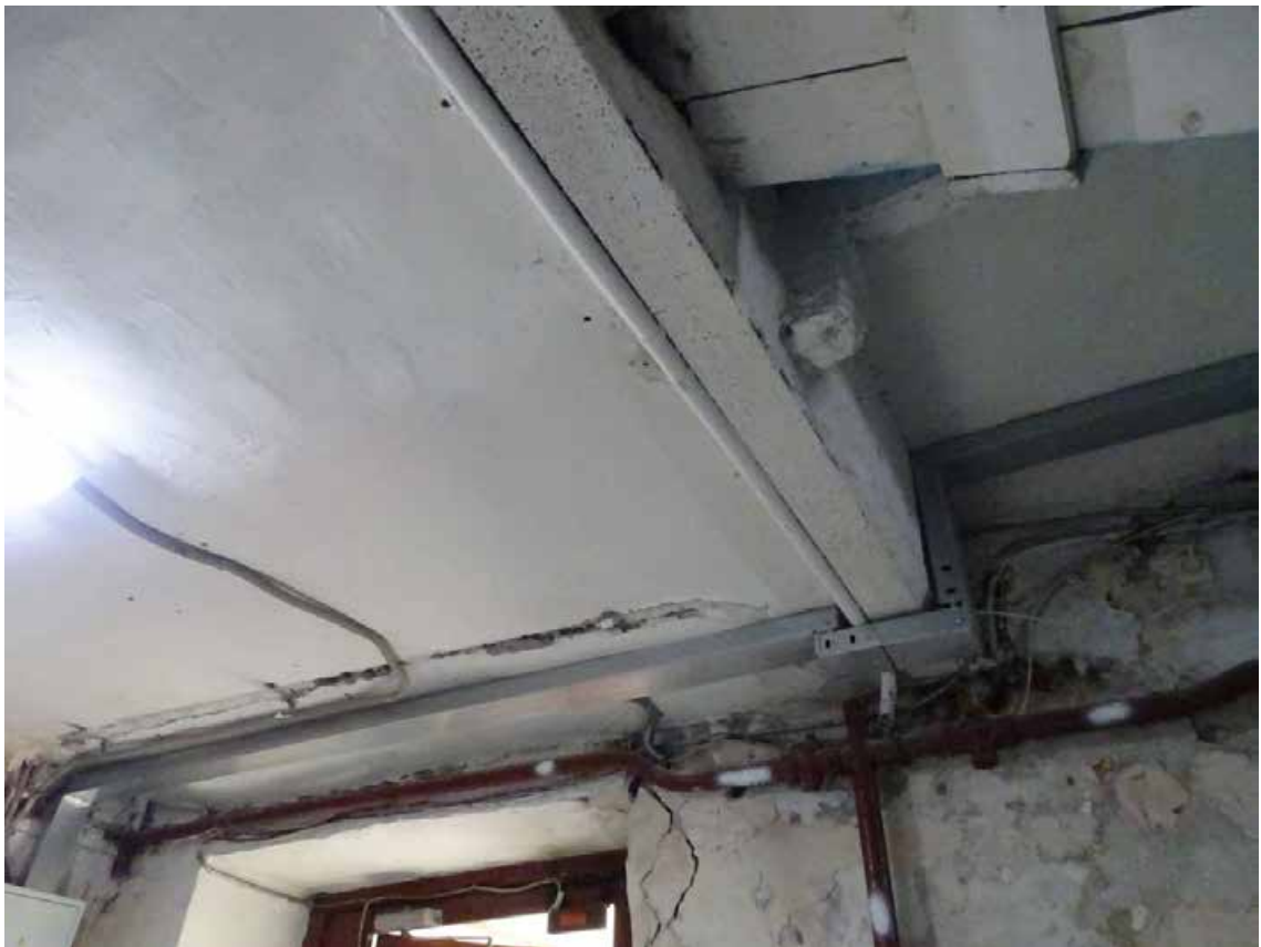
Фото 37. Лестница 2ЛК. 1-й этаж. Перекрытие. Съемка 19.04.2021 г. Штиглиц М. С.
