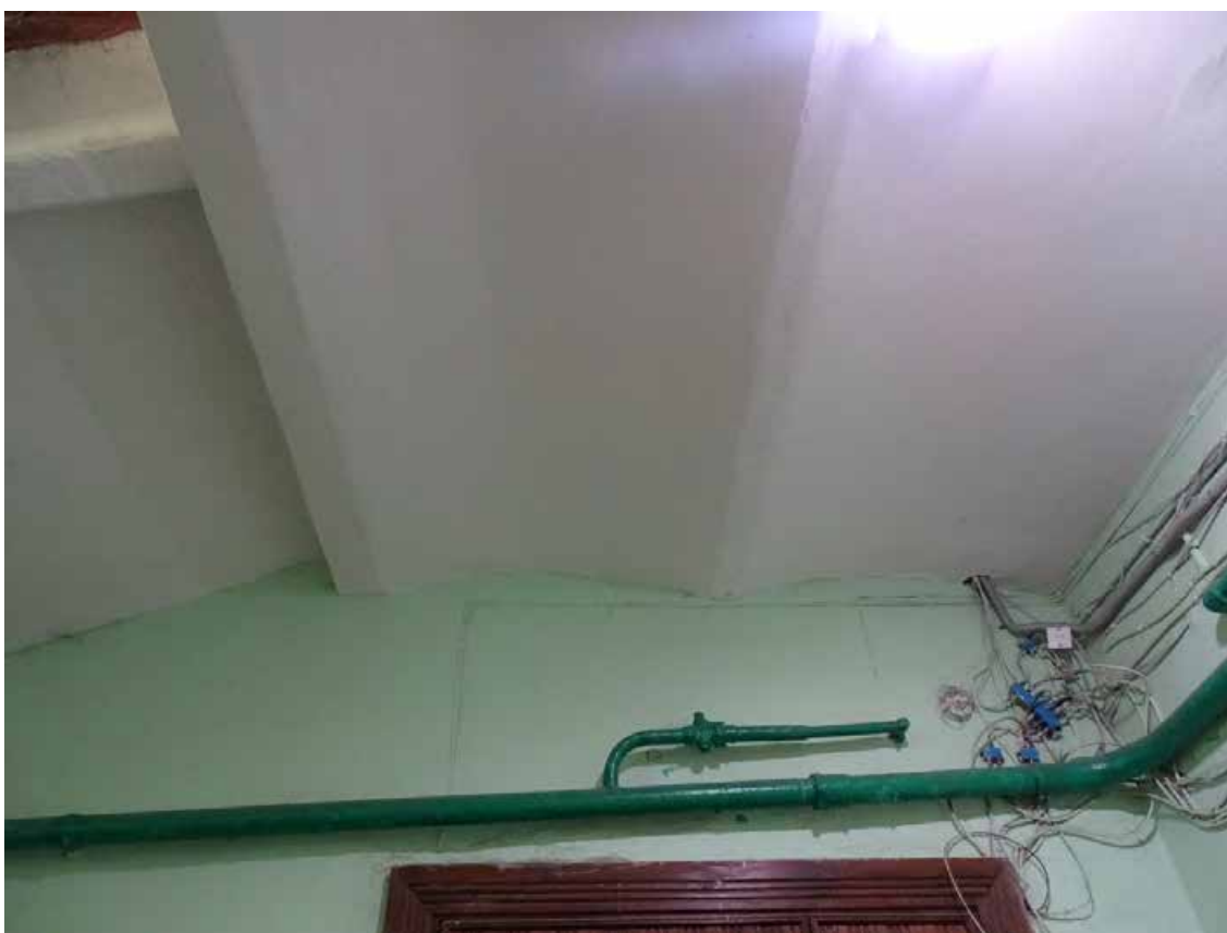
Фото 91. Лестница ЗЛК. 1-й этаж. Вестибюль. Своды. Съемка 19.04.2021 г. Штиглиц М. С.
