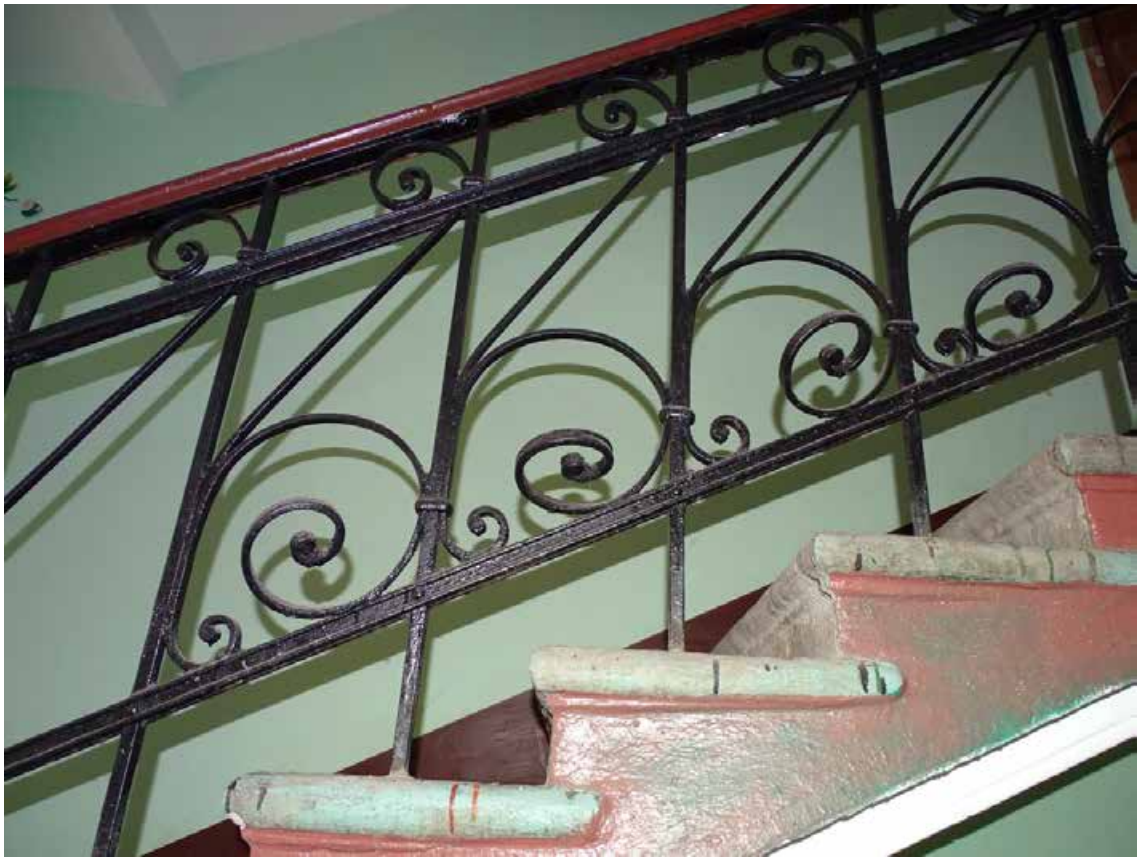
Фото 100. Лестница ЗЛК. Фрагмент ограждения лестницы. Съемка 19.04.2021 г. Штиглиц М. С.
