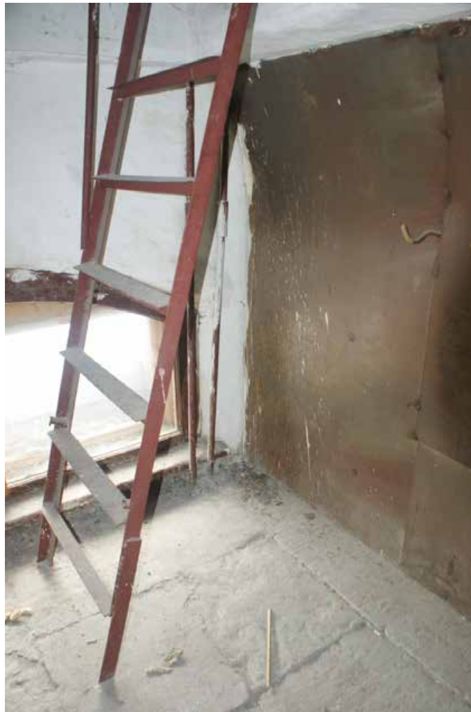
Фото 81. Лестница 2ЛК. Технический этаж. Выход на кровлю. Съёмка 19.04.2021 г. Штиглиц М. С.
