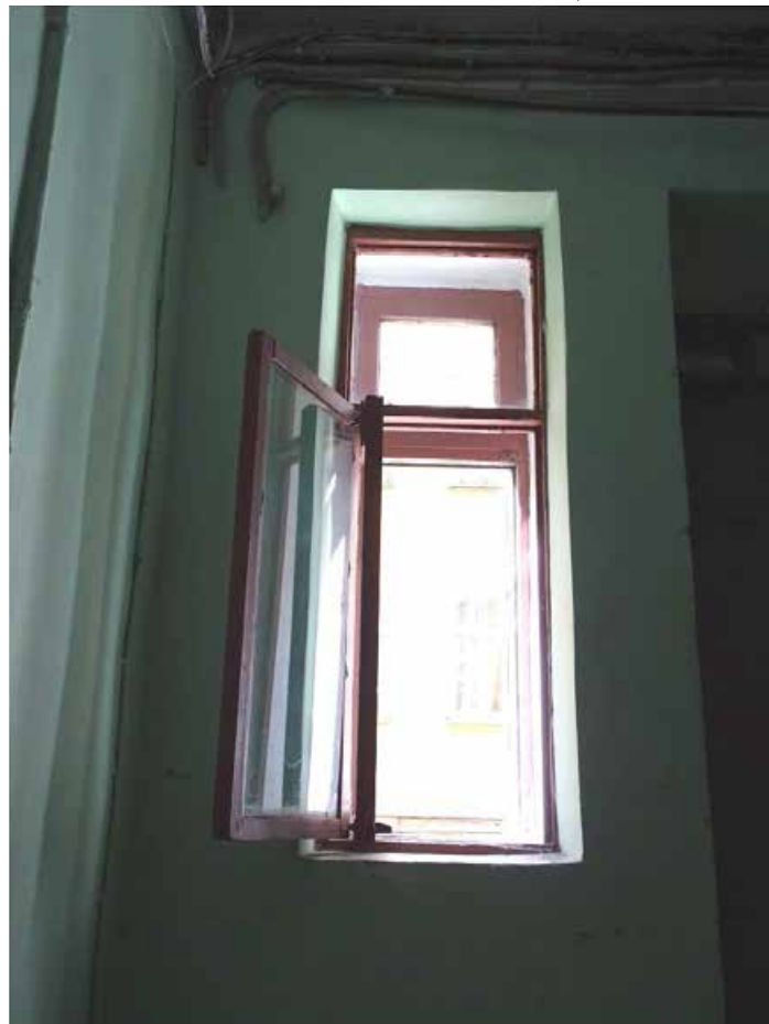
Фото 93. Лестница ЗЛК. Площадка между 1-м и 2-м этажом. Съемка 19.04.2021 г. Штиглиц М. С.
