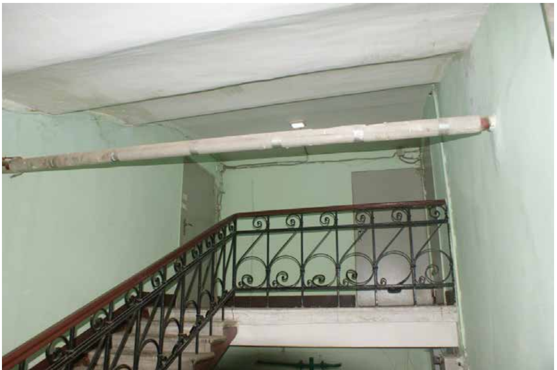
Фото 114. Лестница ЗЛК. Чердачный этаж. Съемка 19.04.2021 г. Штиглиц М. С.
