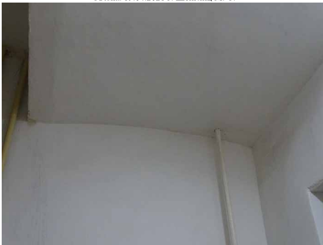
Фото 24. Лестница 1ЛК. Площадка между 4-м и 5-м этажом. Съемка 19.04.2021 г. Штиглиц М. С.
