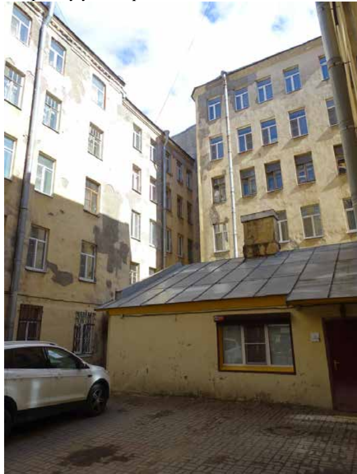
Фото 18. Здание по адресу: г. Санкт-Петербург, Большая Зеленина ул., дом 29, литера Б. Дворовой фасад. Съемка 19.04.2021 г. Штиглиц М. С.
