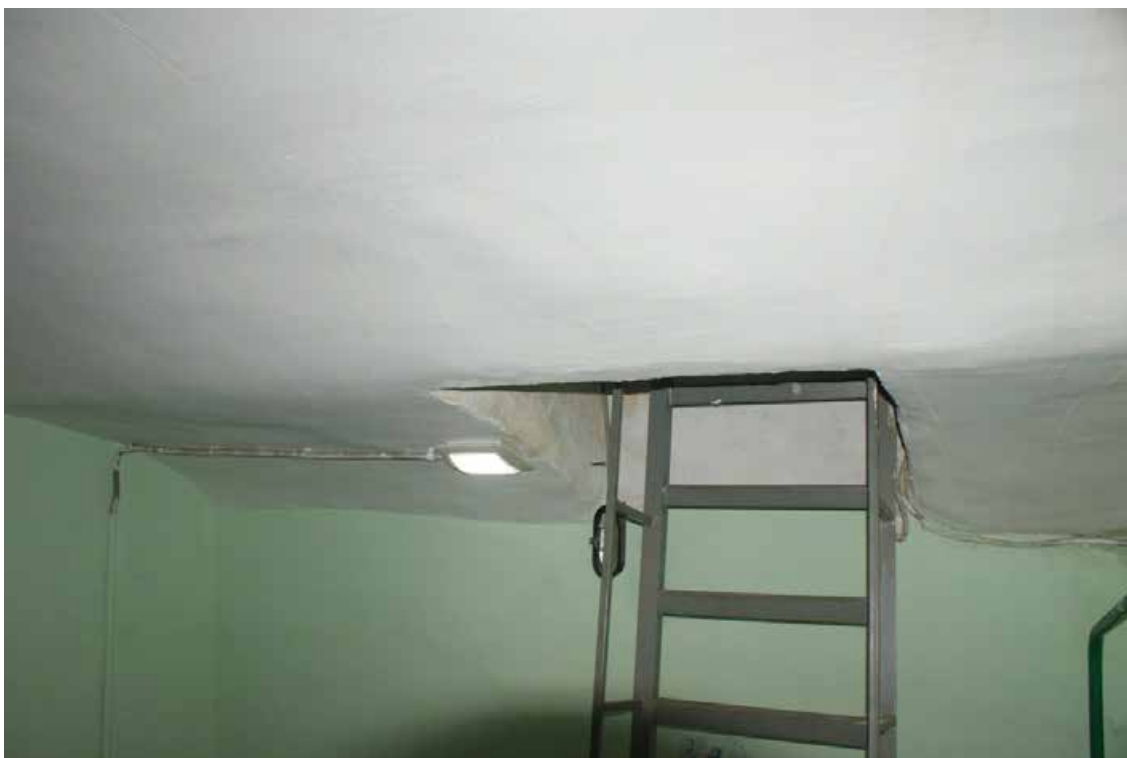
Фото 112. Лестница ЗЛК. Площадка между 5-м и 6-м этажом. Выход на кровлю. Съемка 19.04.2021 г. Штиглиц М. С.
