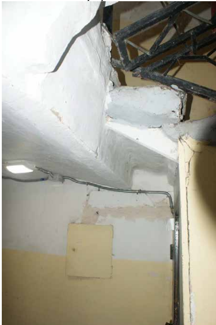
Фото 4. Лестница 1ЛК. 1-й этаж. Перекрытие. Съемка 19.04.2021 г. Штиглиц М. С.
