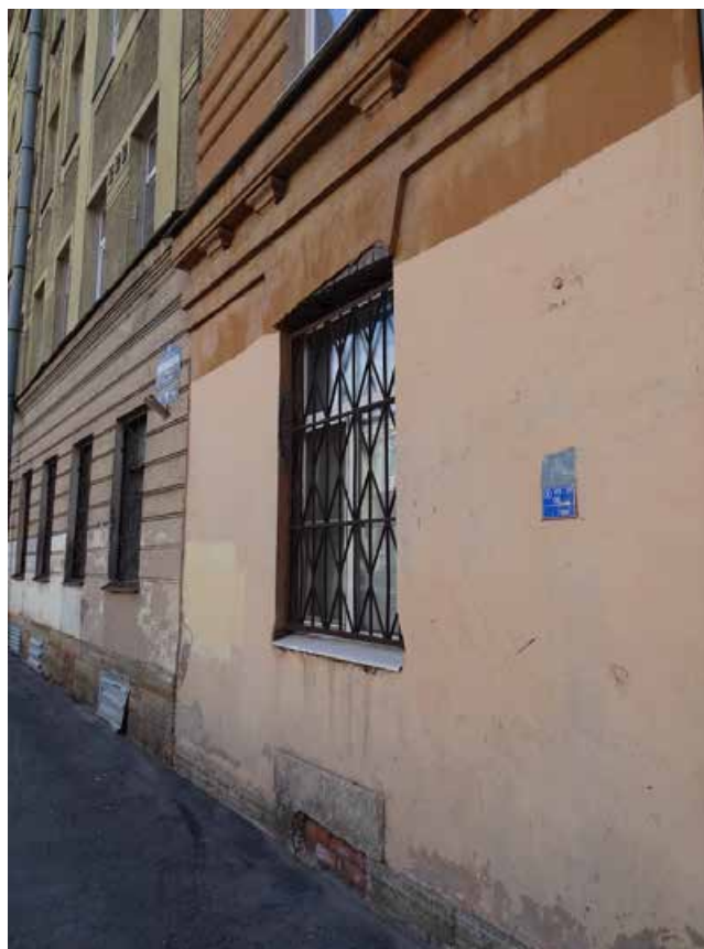
Фото 11. Здание по адресу: г. Санкт-Петербург, Большая Зеленина ул., дом 29, литера Б. Фрагмент лицевого фасада по ул. Петрозаводской. 1-й этаж. Съемка 19.04.2021 г. Штиглиц М. С.
