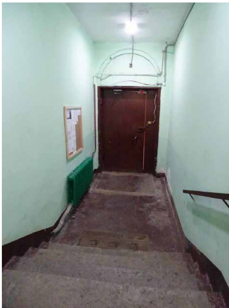
Фото 86. Лестница ЗЛК. 1-й этаж. Вестибюль. Съемка 19.04.2021 г. Штиглиц М. С.
