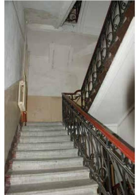
ограждение маршей черного металла, рисунок – вертикальные прутья квадратного сечения, техника исполнения (ковка, прокат, слесарная сборка); поручни деревянные профилированные);
