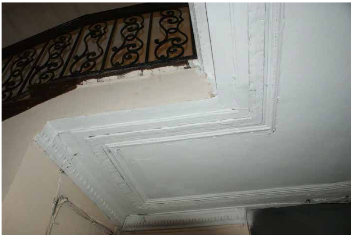
Фото 46. Лестница № 2. 1-й этаж. Вестибюль. Оформление потолка. Съемка 19.04.2021 г. Кириков Б. М.
