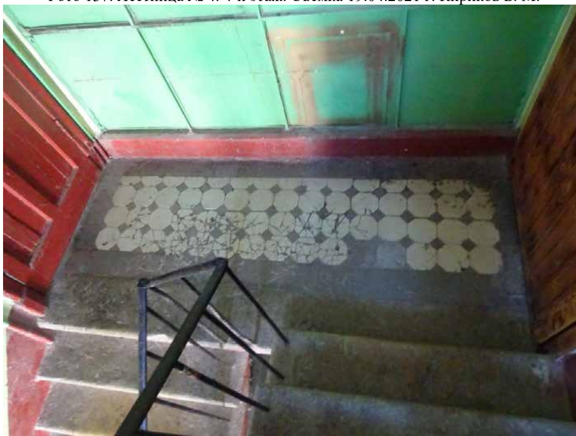
Фото 138. Лестница № 4. 4-й этаж. Покрытие пола. Съемка 19.04.2021 г. Кириков Б. М.
