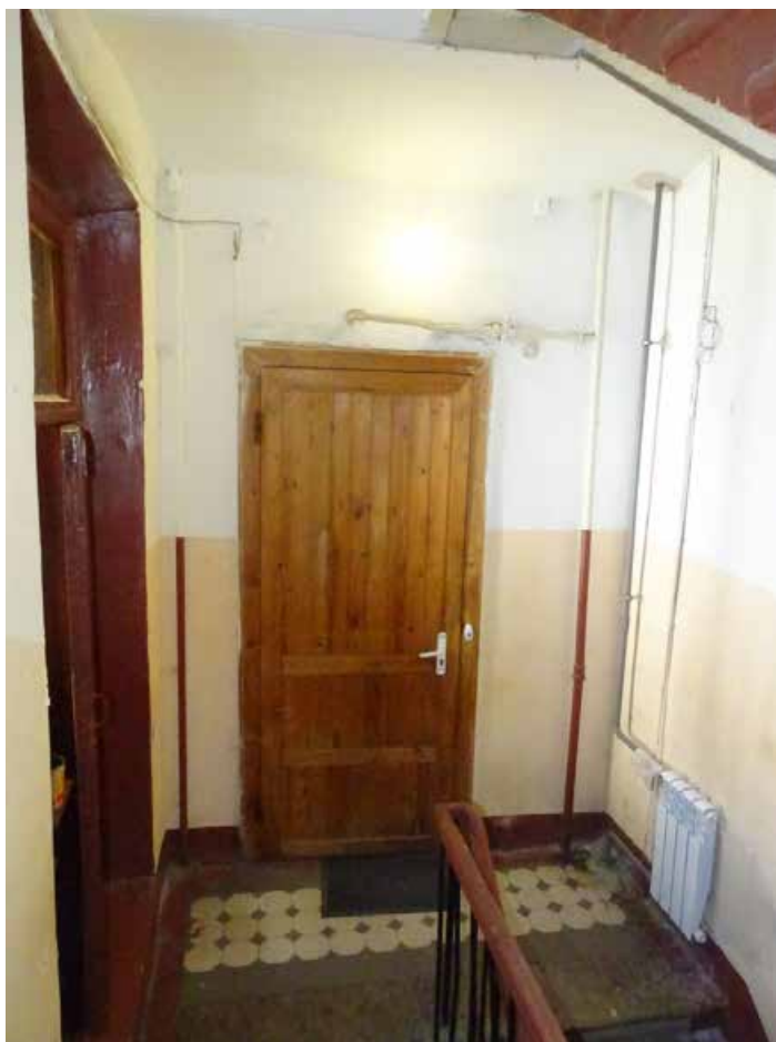
Фото 95. Лестница № 3. 4-й этаж. Съемка 19.04.2021 г. Кириков Б. М.
