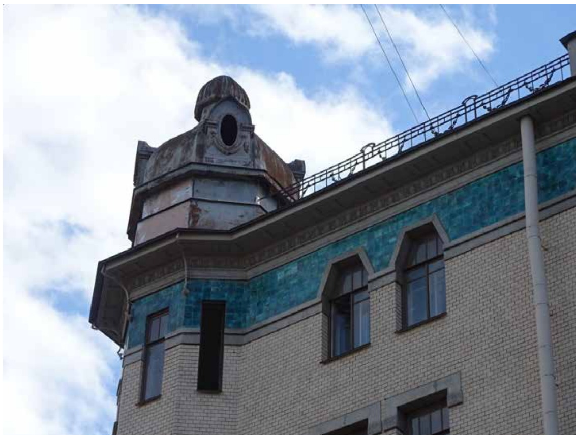
Фото 13. Здание по адресу: г. Санкт-Петербург, 11-я линия В. О., 34/47, литера А. Фрагмент фасада по 11-й линии. Съемка 19.04.2021 г. Кириков Б. М.
