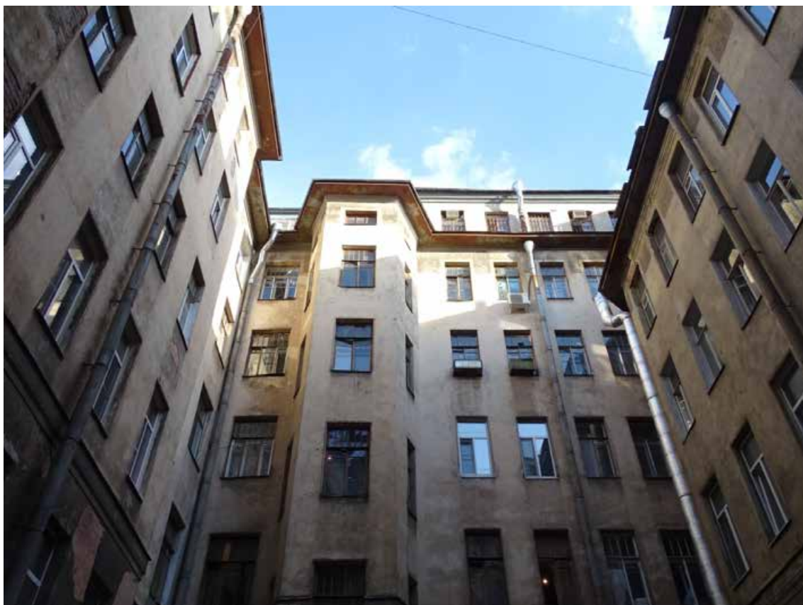
Фото 41. Здание по адресу: г. Санкт-Петербург, 11-я линия В. О., 34/47, литера А. Фрагмент южного дворового фасада. Съемка 19.04.2021 г. Кириков Б. М.
