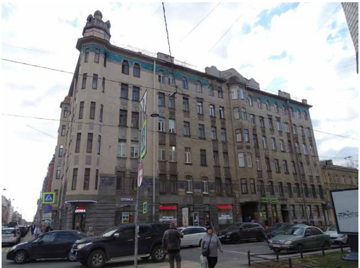
Фото 2. Здание по адресу: г. Санкт-Петербург, 11-я линия В. О., 34/47, литера А. Фасад по 11-й линии. Съемка 19.04.2021 г. Кириков Б. М.
