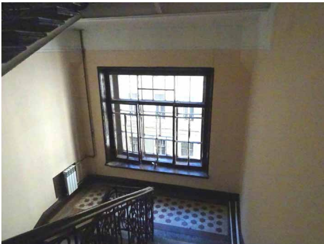
Фото 56. Лестница № 2. Площадка м/у 3-м и 4-м этажом. Съемка 19.04.2021 г. Кириков Б. М.
