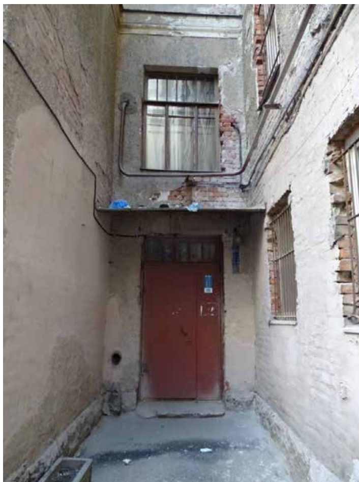
Фото 43. Здание по адресу: г. Санкт-Петербург, 11-я линия В. О., 34/47, литера А. Фрагмент дворового фасада. Входная дверь. Съемка 19.04.2021 г. Кириков Б. М.
