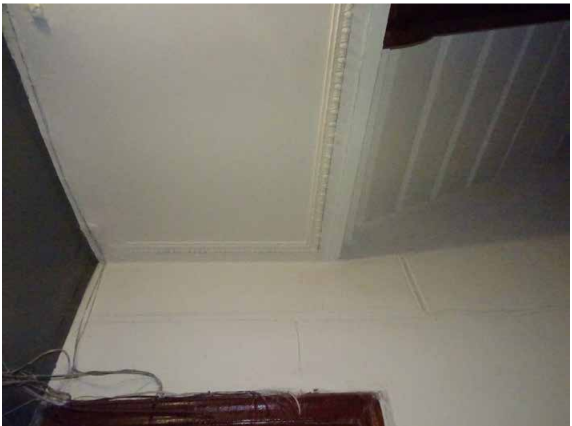
Фото 18. Лестница № 1. Площадка м/у 1-м и 2-м этажом. Оформление потолка. Съемка 19.04.2021 г. Кириков Б. М.
