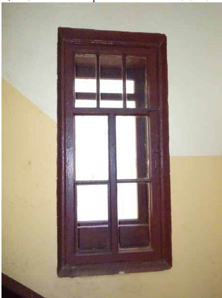
Фото 88. Лестница № 3. 2-й этаж. Съемка 19.04.2021 г. Кириков Б. М.
