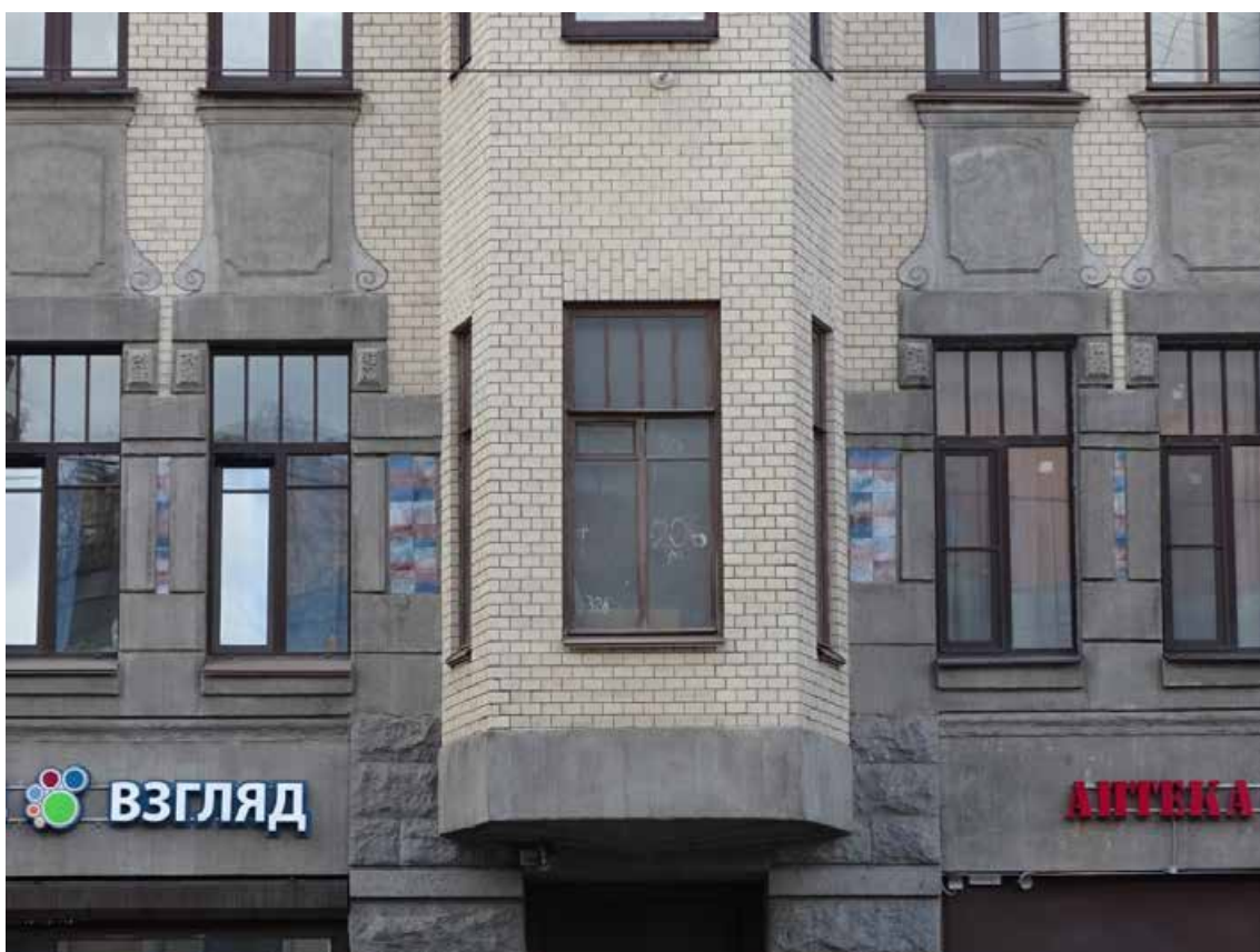
Фото 24. Здание по адресу: г. Санкт-Петербург, 11-я линия В. О., 34/47, литера А. Фрагмент фасада. Эркер 2-й этаж. Вид с Среднего пр. Съемка 19.04.2021 г. Кириков Б. М.
