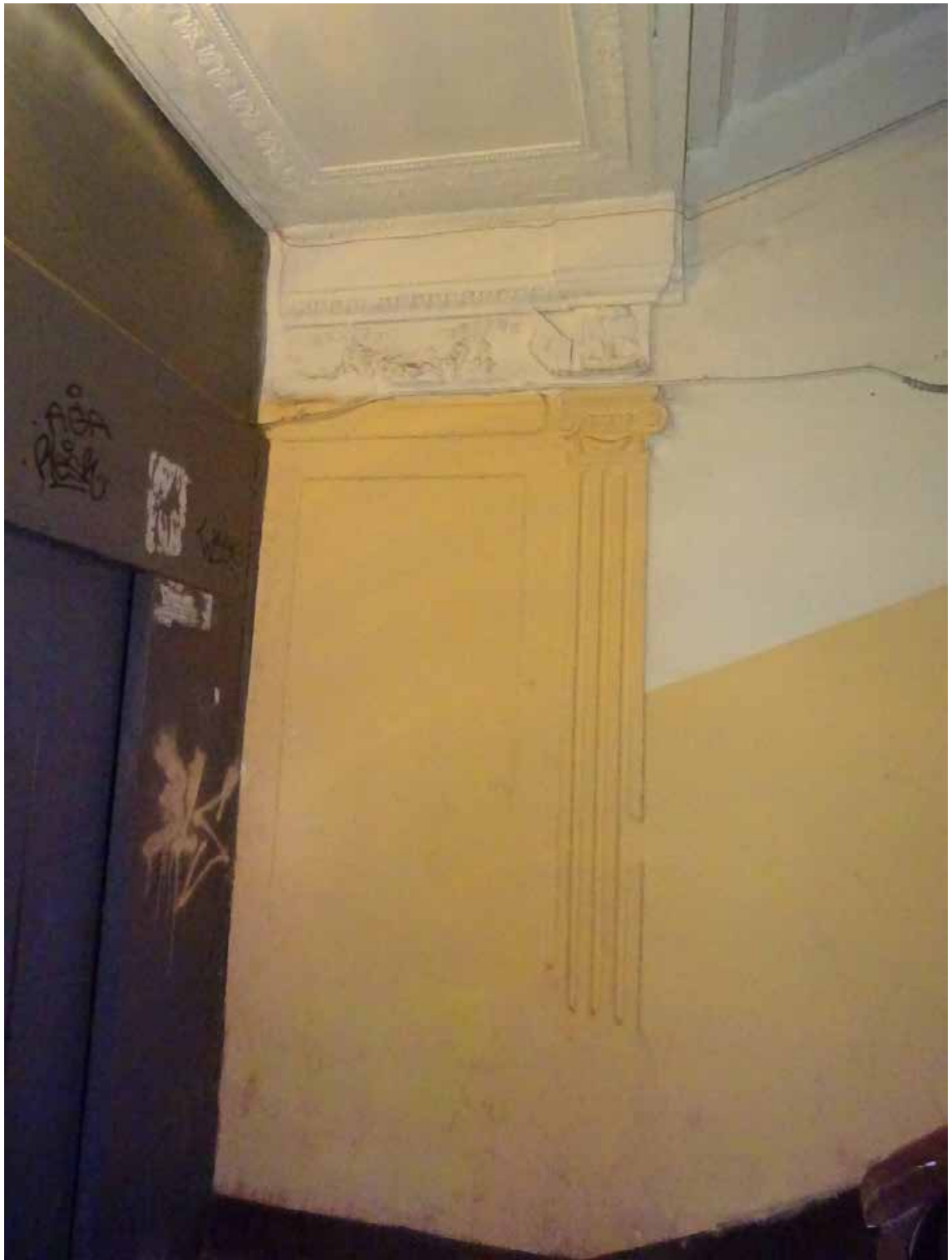
Фото 11. Лестница № 1. 1-й этаж. Вестибюль. Съемка 19.04.2021 г. Кириков Б. М.
