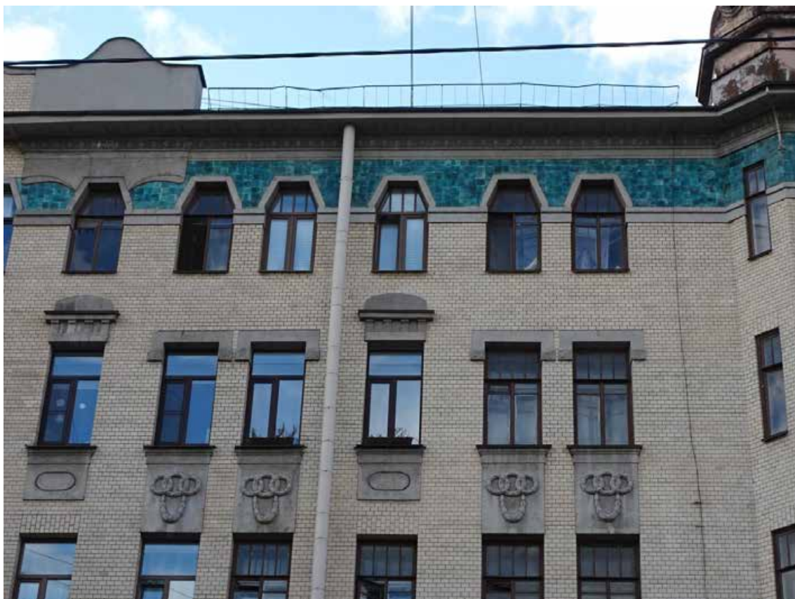
Фото 19. Здание по адресу: г. Санкт-Петербург, 11-я линия В. О., 34/47, литера А. Фрагмент фасада. Вид с Среднего пр. Съемка 19.04.2021 г. Кириков Б. М.
