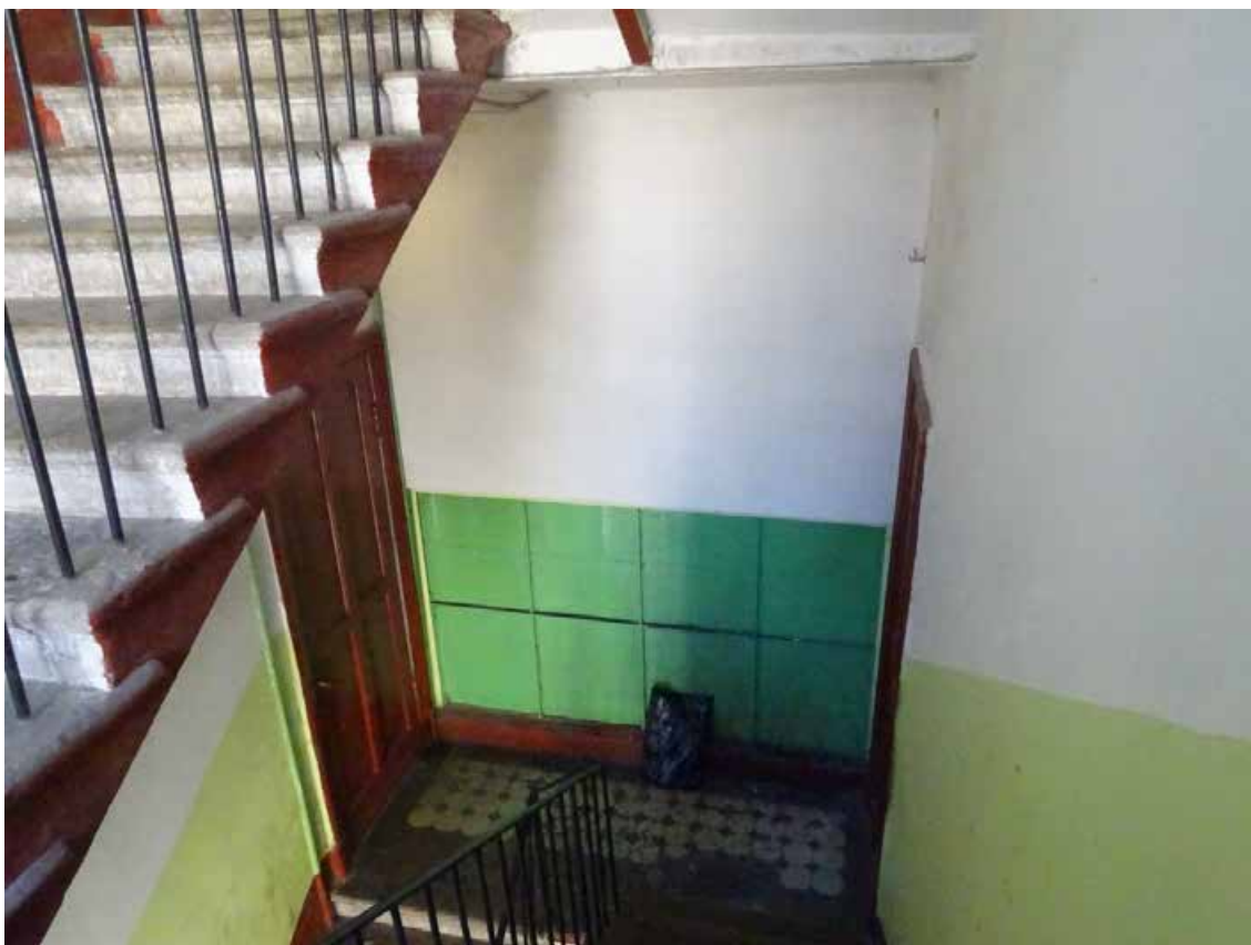
Фото 141. Лестница № 4. 5-й этаж. Съемка 19.04.2021 г. Кириков Б. М.
