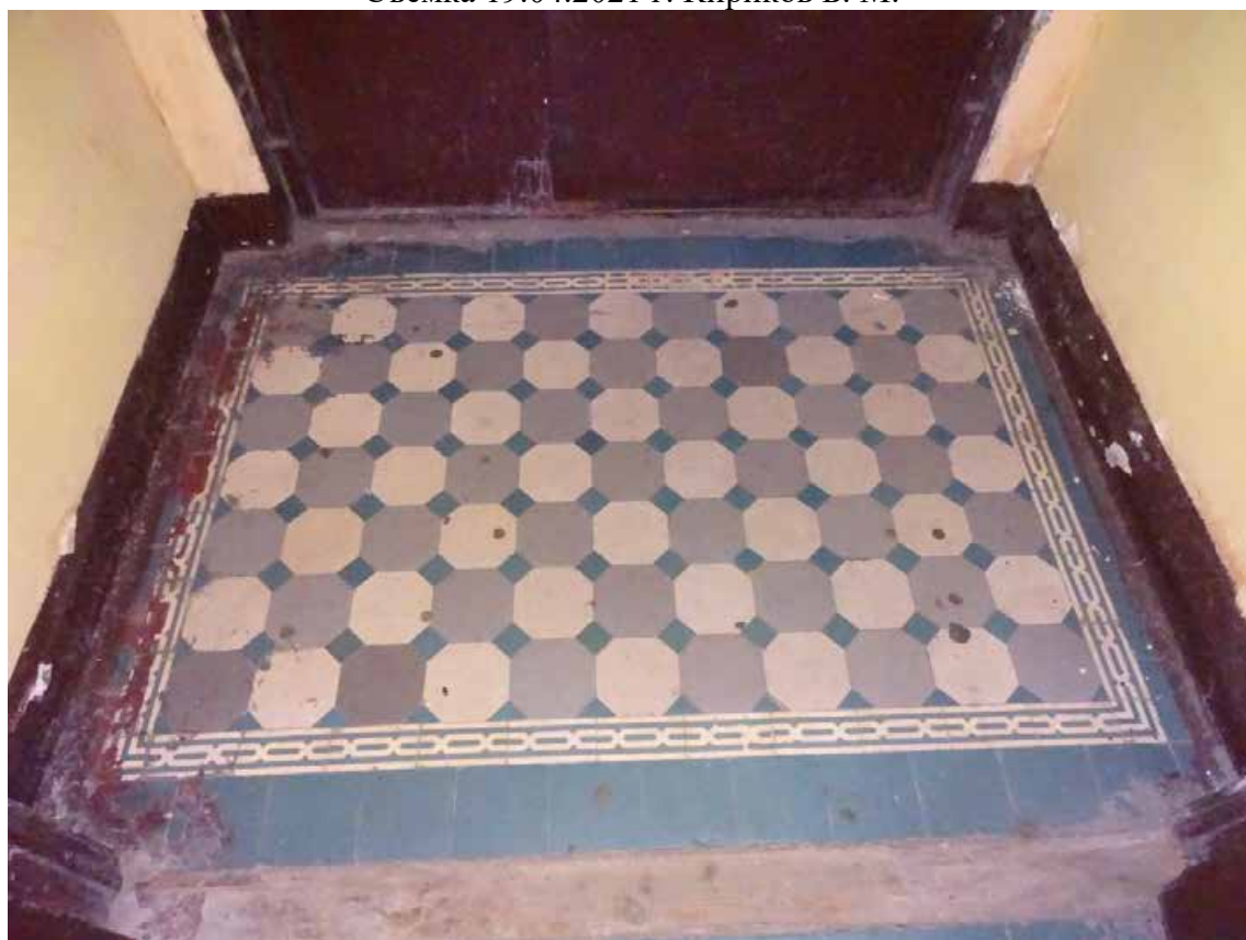
Фото 7. Лестница № 1. 1-й этаж. Входной тамбур. Покрытие пола. Съемка 19.04.2021 г. Кириков Б. М.
