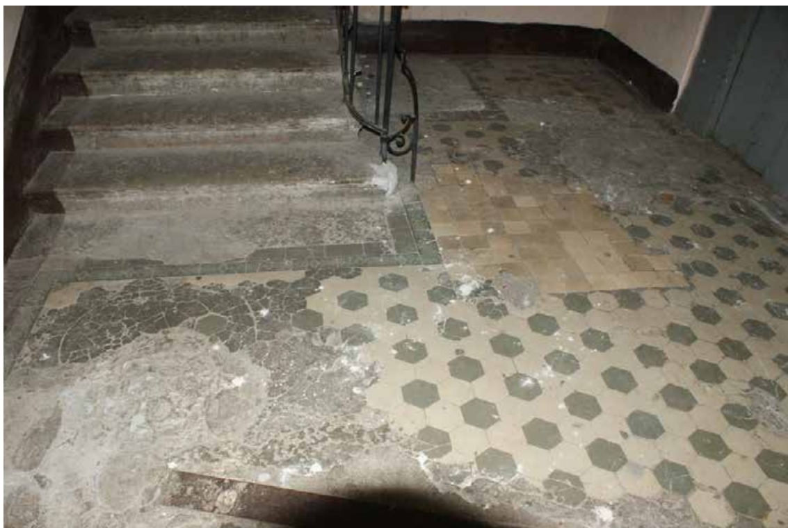
Фото 44. Лестница № 2. 1-й этаж. Вестибюль. Покрытие пола. Съемка 19.04.2021 г. Кириков Б. М.
