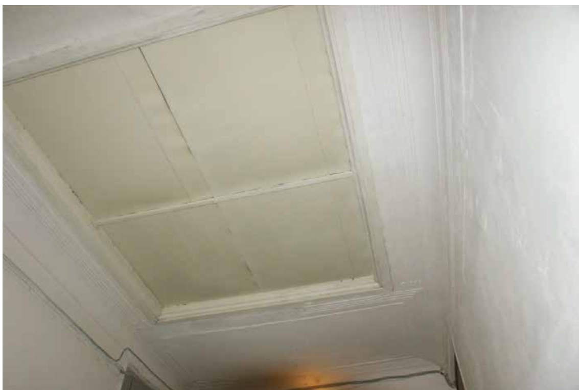
Фото 34. Лестница № 1. Чердачный этаж. Оформление потолка. Съемка 19.04.2021 г. Кириков Б. М.
