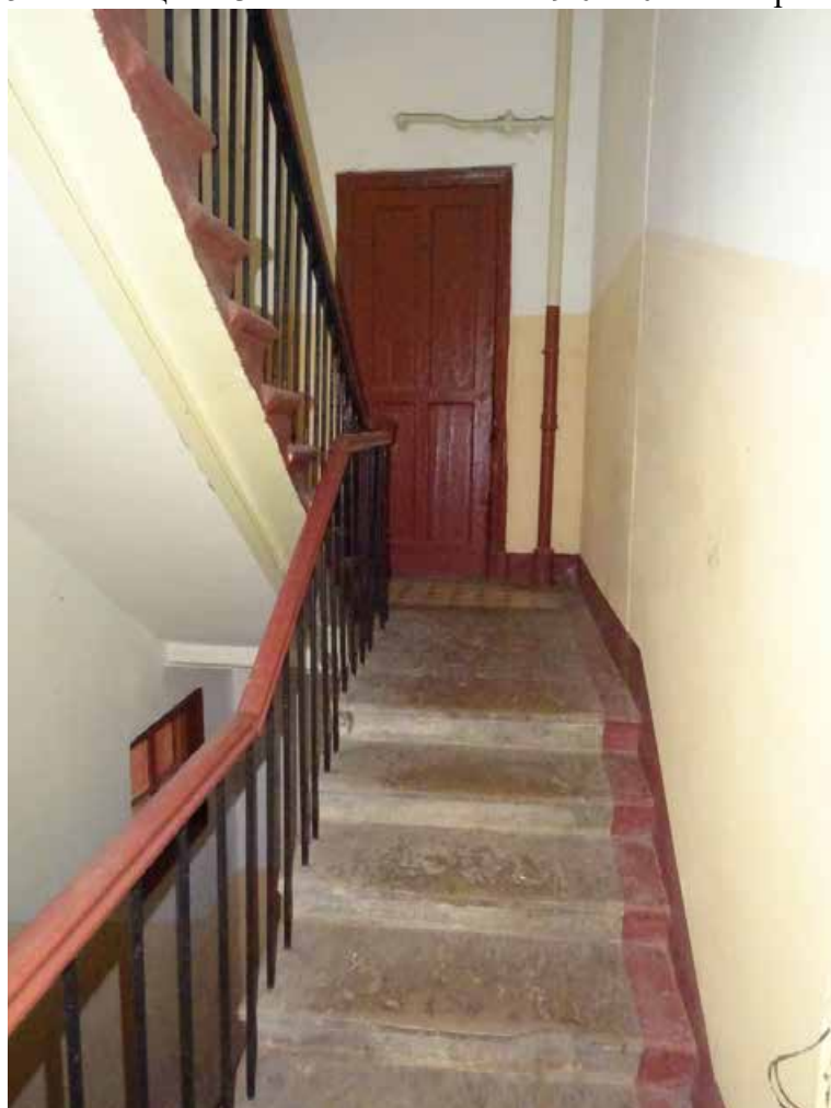
Фото 86. Лестница № 3. 2-й этаж. Съемка 19.04.2021 г. Кириков Б. М.
