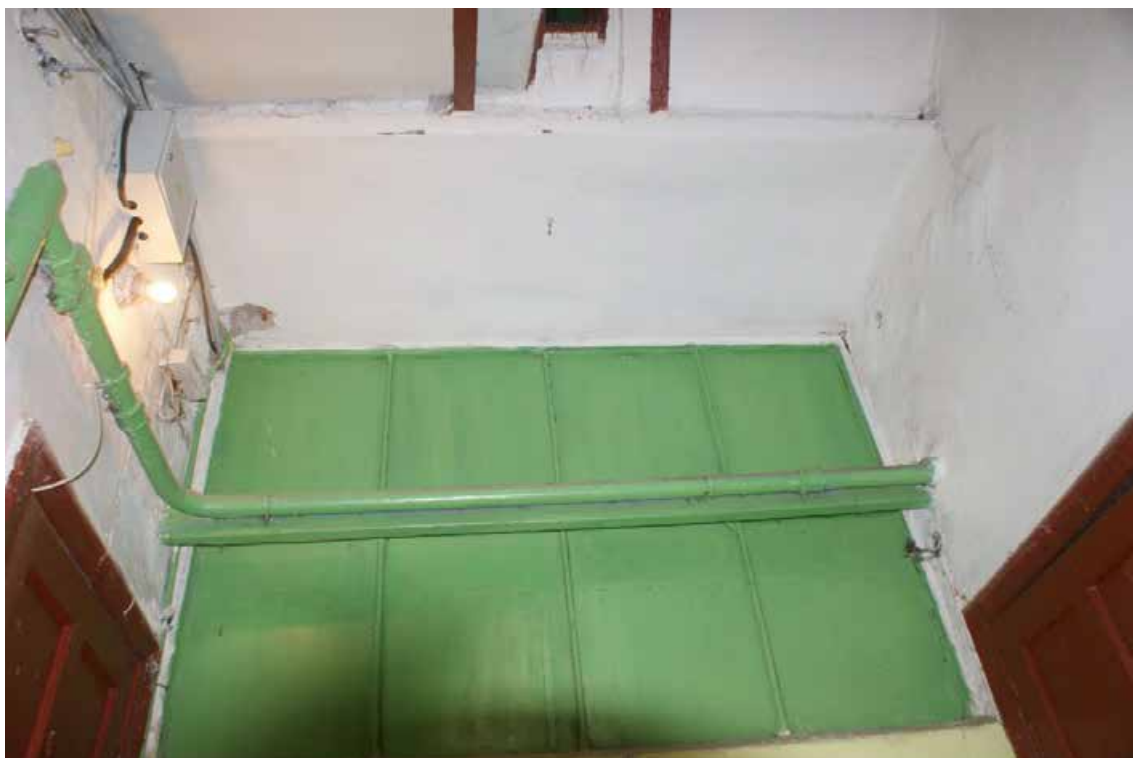
Фото 127. Лестница № 4. 2-й этаж. Съемка 19.04.2021 г. Кириков Б. М.
