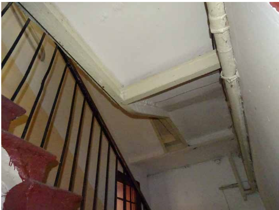
Фото 7 . Лестница № 3. Лестничный марш. Съемка 19.04.2021 г. Кириков Б. М.
