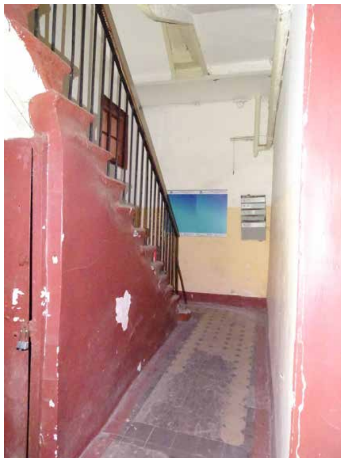
Фото 69. Лестница № 3. 1-й этаж. Съемка 19.04.2021 г. Кириков Б. М.
