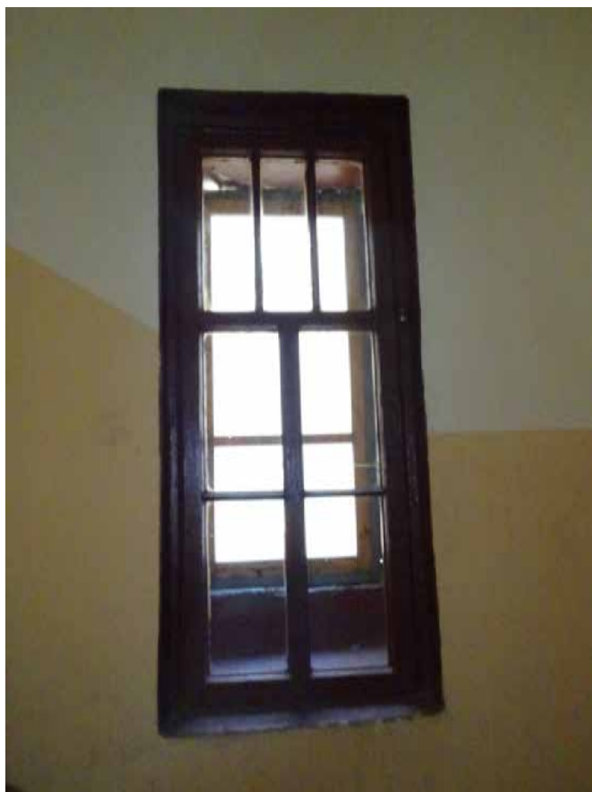
Фото 101. Лестница № 3. 4-й этаж. Съемка 19.04.2021 г. Кириков Б. М.
