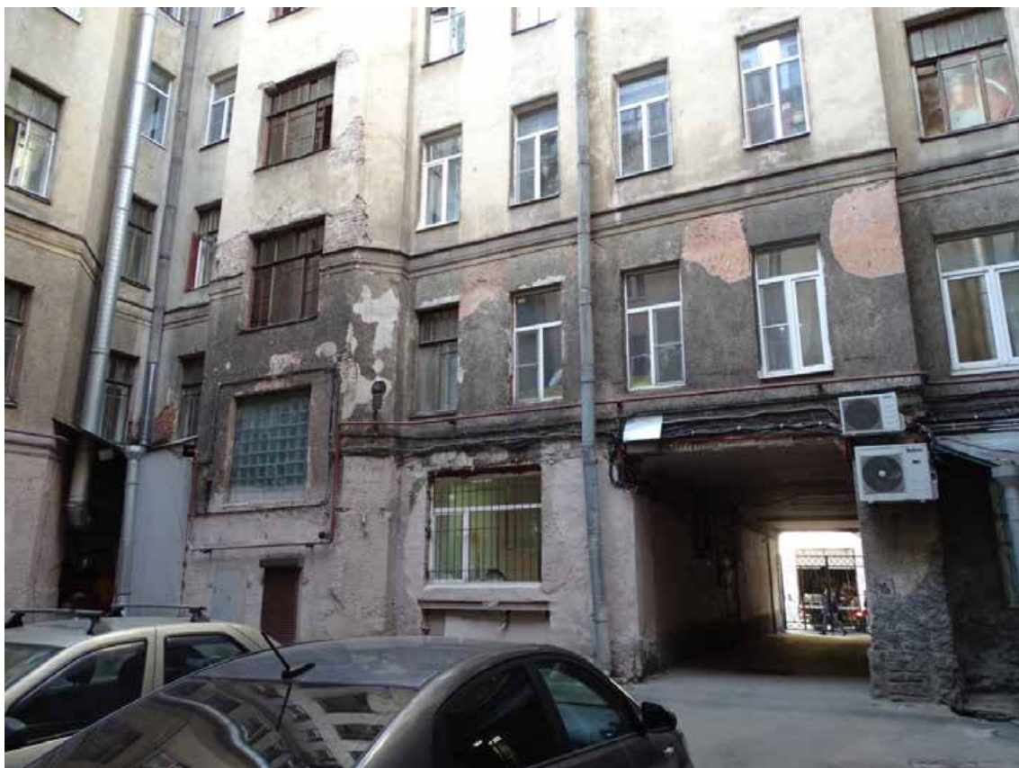
Фото 39. Здание по адресу: г. Санкт-Петербург, 11-я линия В. О., 34/47, литера А. Фрагмент восточного дворового фасада. Съемка 19.04.2021 г. Кириков Б. М.
