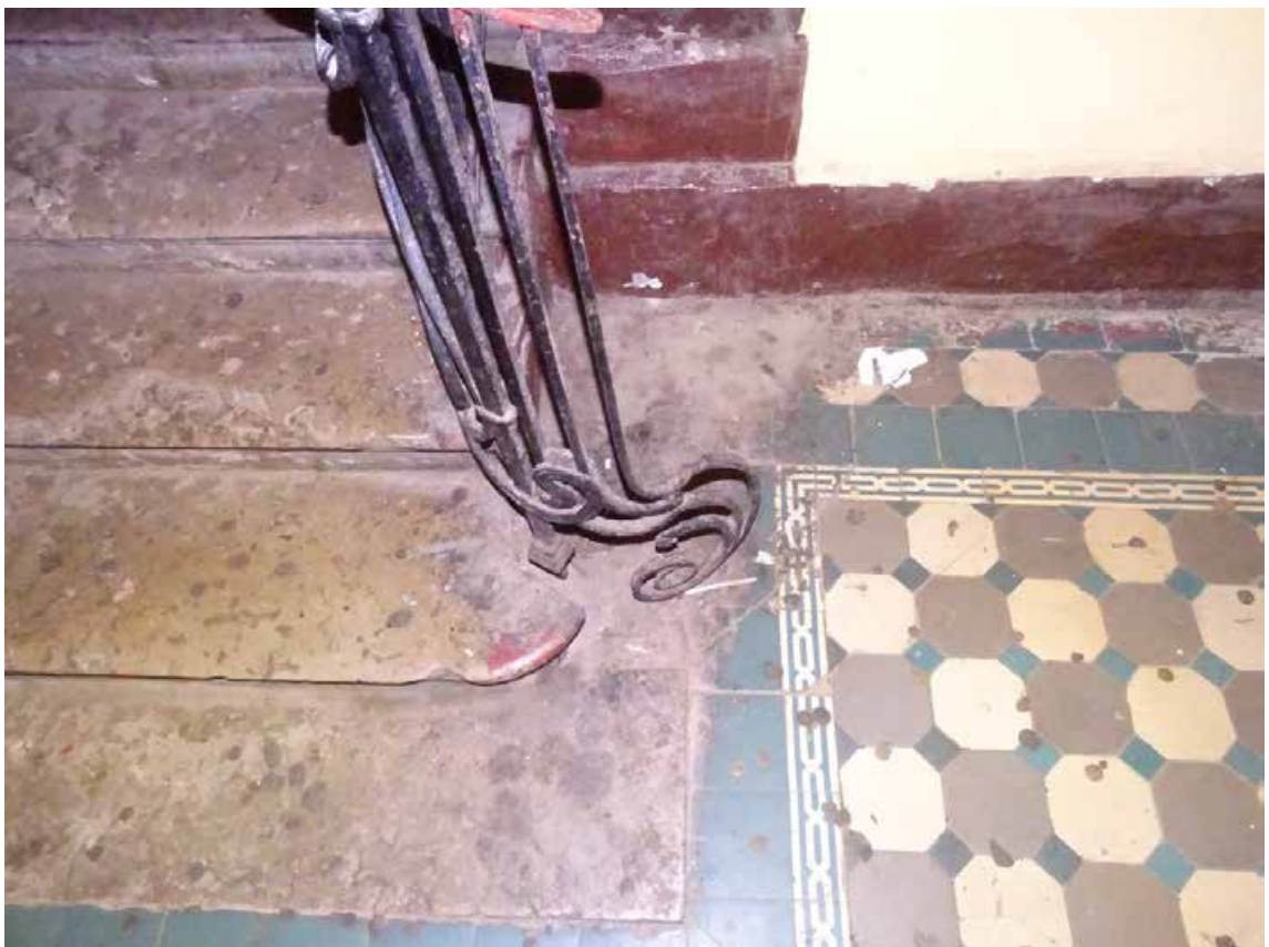
Фото 15. Лестница № 1. 1-й этаж. Оформление стен и потолка. Съемка 19.04.2021 г. Кириков Б. М.
