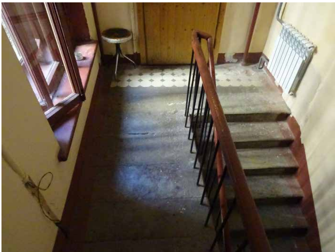
Фото 85. Лестница № 3. 2-й этаж. Съемка 19.04.2021 г. Кириков Б. М.
