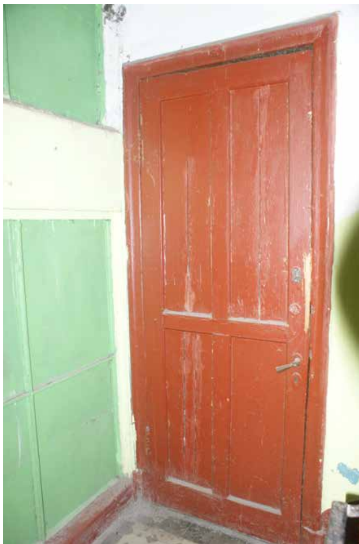
Фото 129. Лестница № 4. 2-й этаж. Съемка 19.04.2021 г. Кириков Б. М.
