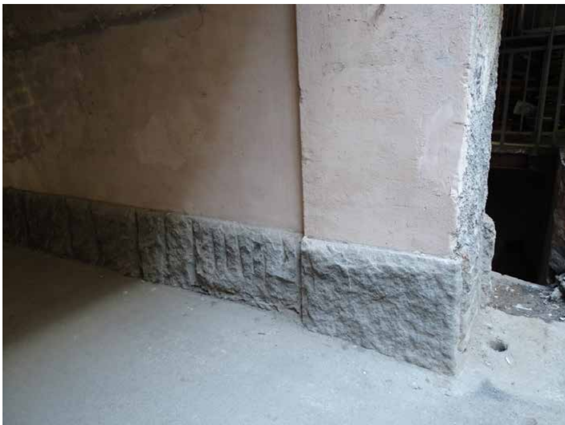
Фото 45. Здание по адресу: г. Санкт-Петербург, 11-я линия В. О., 34/47, литера А. Гранитный цоколь. Съемка 19.04.2021 г. Кириков Б. М.
