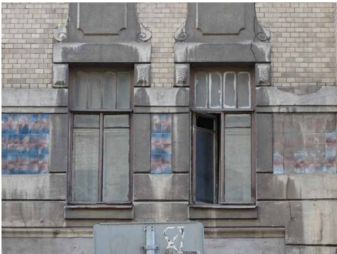
Фото 11. Здание по адресу: г. Санкт-Петербург, 11-я линия В. О., 34/47, литера А. Оформление оконного проема. Фрагмент фасада по 11-й линии. Съемка 19.04.2021 г. Кириков Б. М.
