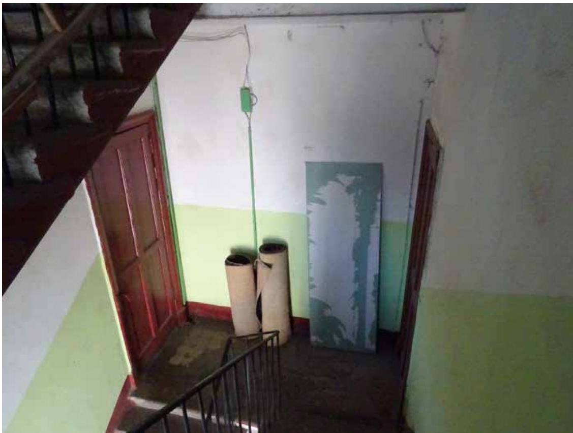
Фото 143. Лестница № 4. 6-й этаж. Съемка 19.04.2021 г. Кириков Б. М.
