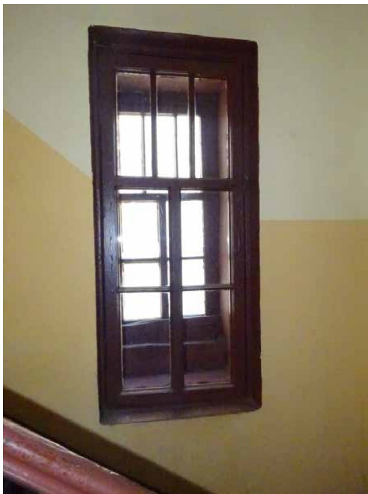
Фото 93. Лестница № 3. 3-й этаж. Съемка 19.04.2021 г. Кириков Б. М.
