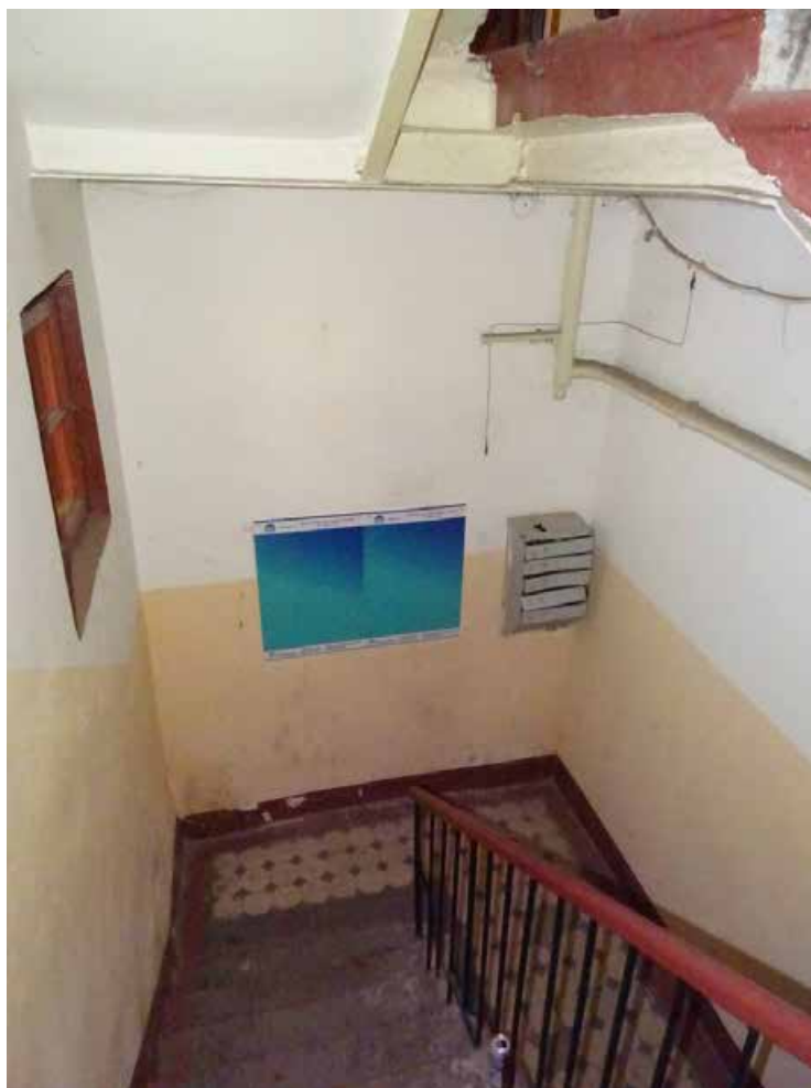
Фото 79. Лестница № 3. 1-й этаж. Съемка 19.04.2021 г. Кириков Б. М.
