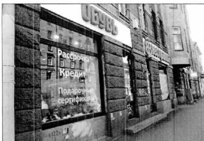
Лицевой фасад со стороны 11-й линии В.О. Оконные проемы пом 1-Н (1-й этаж), в том числе видеоизмененные. Съемка май 2012 г. М. С. Розанова.
