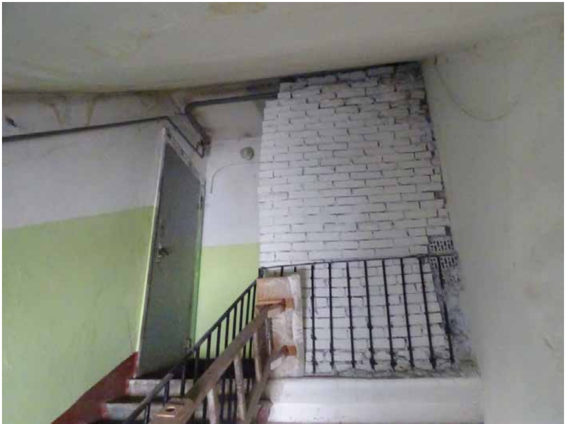
Фото 147. Лестница № 4. Чердачный этаж. Съемка 19.04.2021 г. Кириков Б. М.
