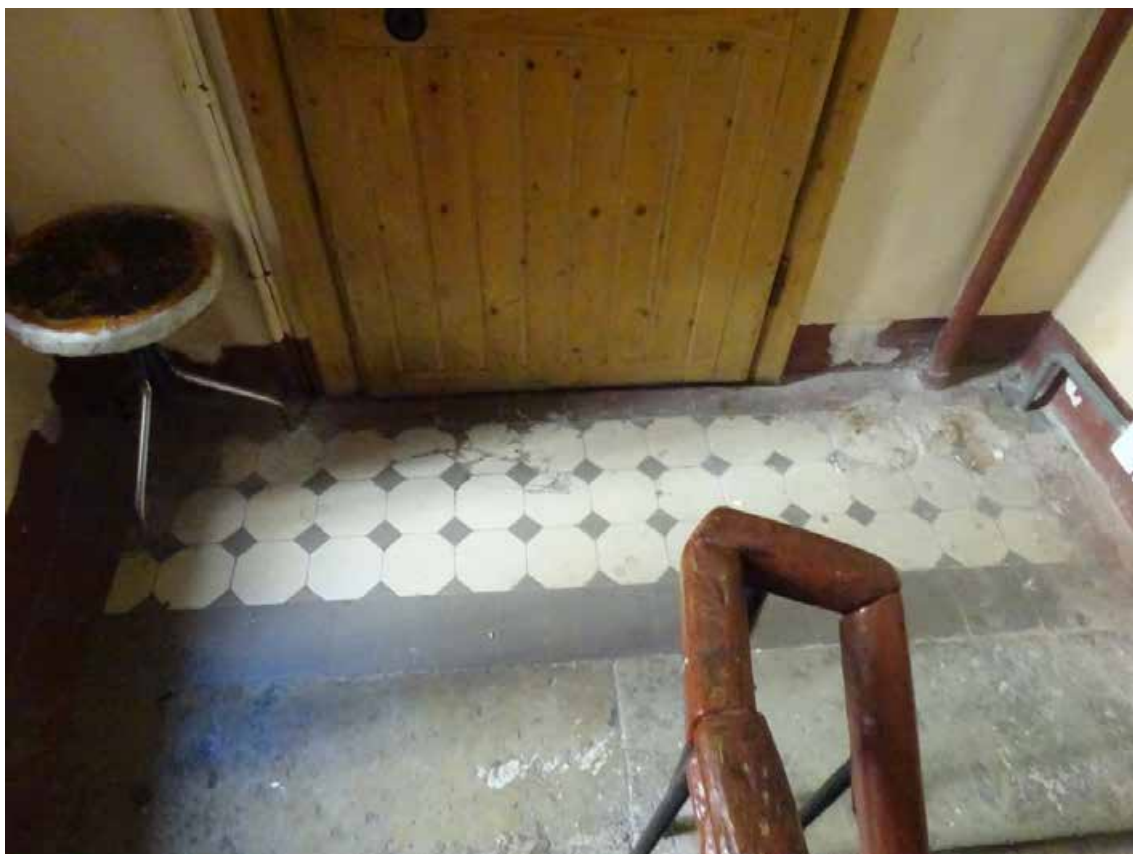
Фото 83. Лестница № 3. 2-й этаж. Покрытие пола. Съёмка 19.04.2021 г. Кириков Б. М.
