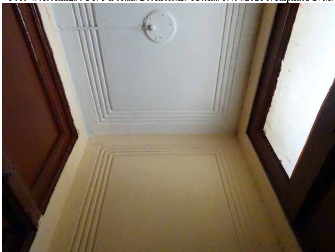
Фото 5. Лестница № 1. 1-й этаж. Входной тамбур. Съемка 19.04.2021 г. Кириков Б. М.
