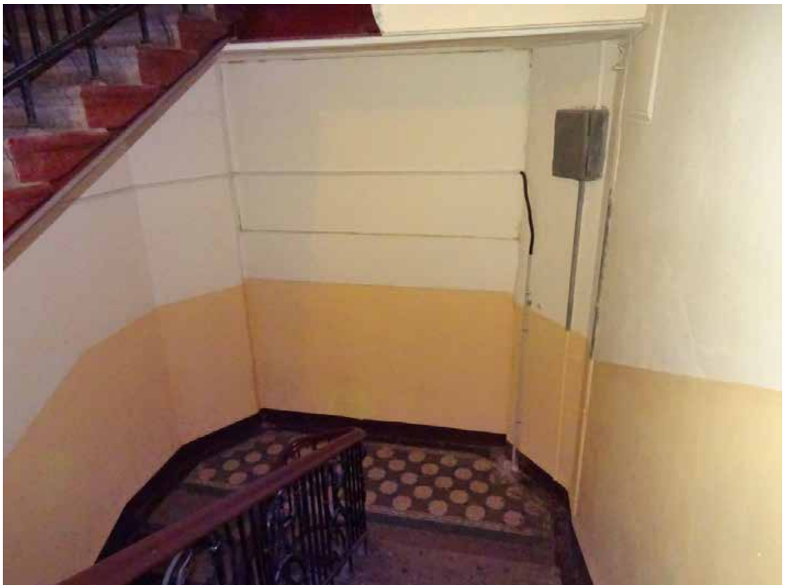
Фото 28. Лестница № 1. Площадка м/у 4-м и 5-м этажом. Съемка 19.04.2021 г. Кириков Б. М.
