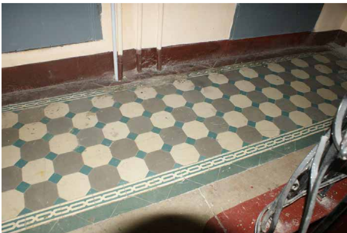
Фото 36. Лестница № 1. Чердачный этаж. Покрытие пола. Съемка 19.04.2021 г. Кириков Б. М.
