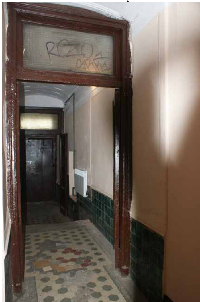
Фото 45. Лестница № 2. 1-й этаж. Вестибюль. Съемка 19.04.2021 г. Кириков Б. М.
