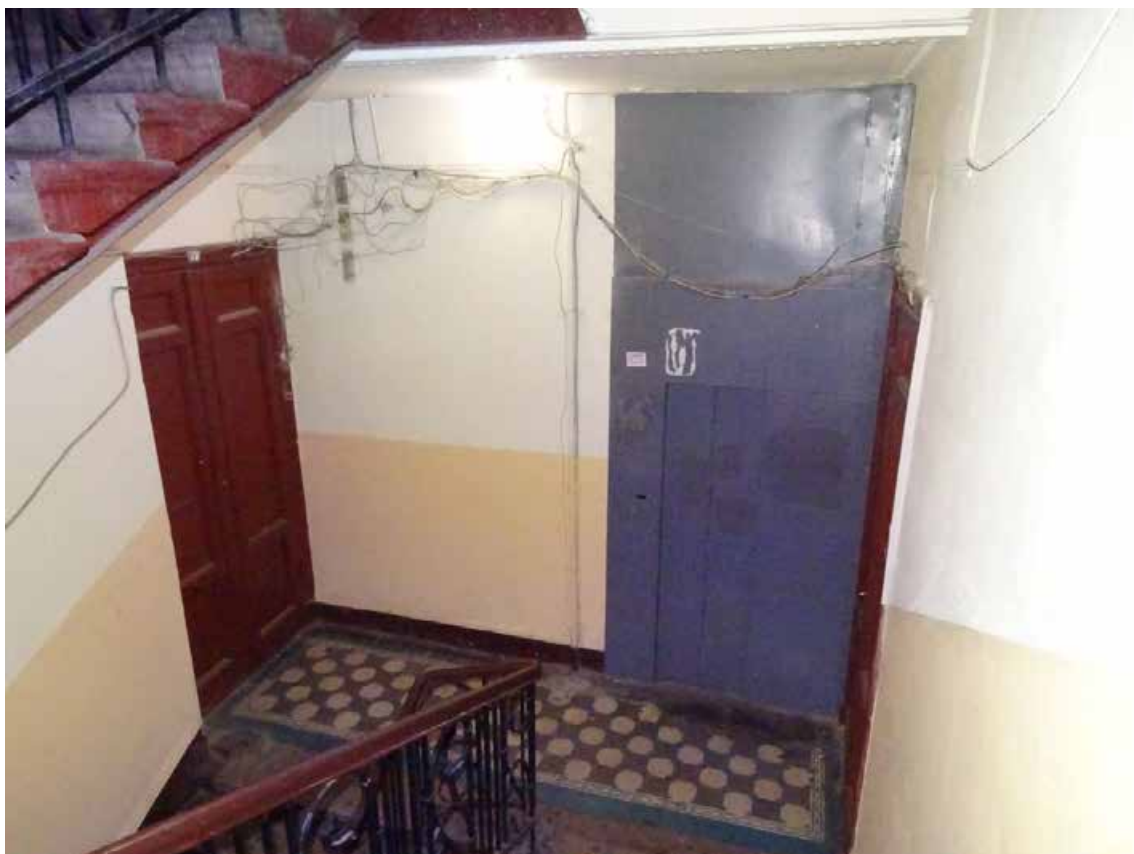
Фото 19. Лестница № 1. 2-й этаж. Съемка 19.04.2021 г. Кириков Б. М.
