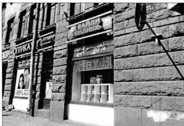
Лицевой фасад со стороны Среднего пр. В.О. Оконные проемы пом 1-Н (1-й этаж). Съемка май 2012 г. М. С. Розанова.
