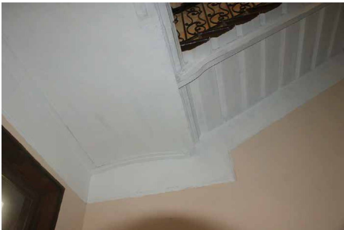
Фото 54. Лестница № 2. Площадка м/у 2-м и 3-м этажом. Оформление потолка. Съемка 19.04.2021 г. Кириков Б. М.
