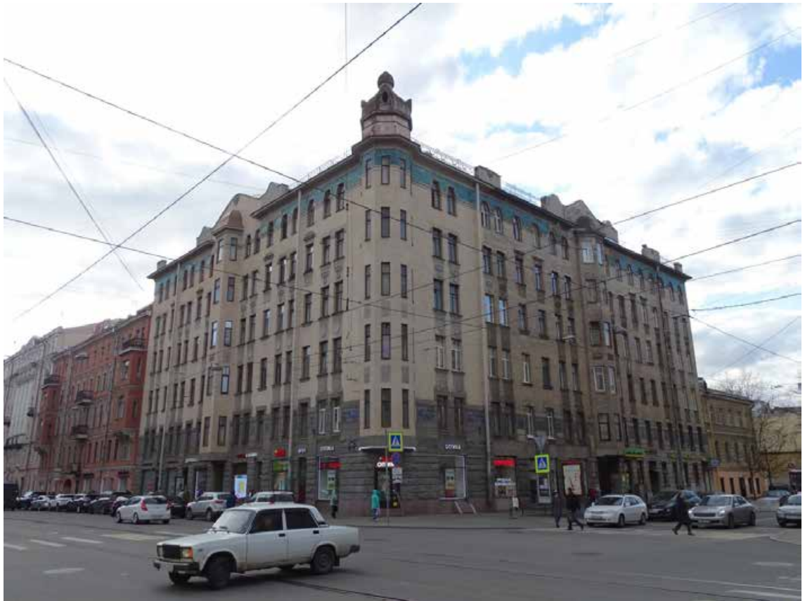
Фото 1. Здание по адресу: г. Санкт-Петербург, 11-я линия В. О., 34/47, литера А. Вид с пересечения Среднего пр. и 11-й линии. Съемка 19.04.2021 г. Кириков Б. М.
