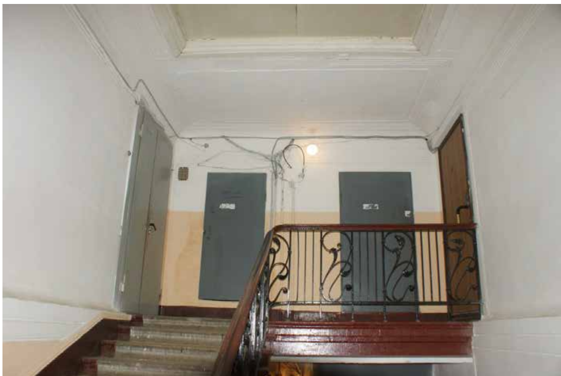
Фото 35. Лестница № 1. Чердачный этаж. Съемка 19.04.2021 г. Кириков Б. М.
