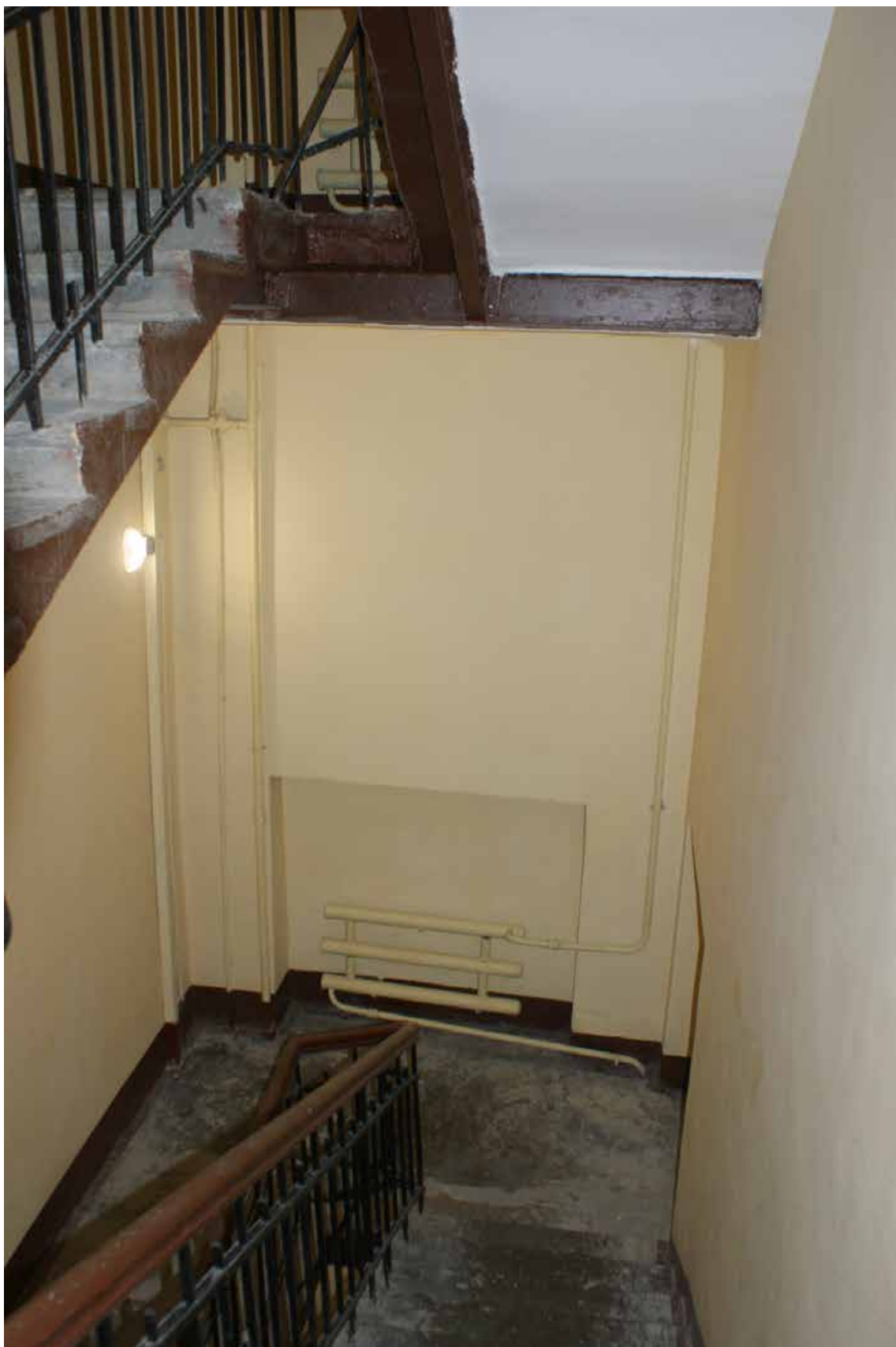
Фото 252. ЛК-9. Вид на площадку между 2-м и 3-м этажом. Съемка 19.04.2021 г. Трушковский В.Э.
