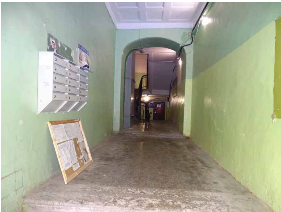
Фото 4. ЛК-1. Вестибюль 1-го этажа. Съемка 19.04.2021 г. Трушковский В.Э.
