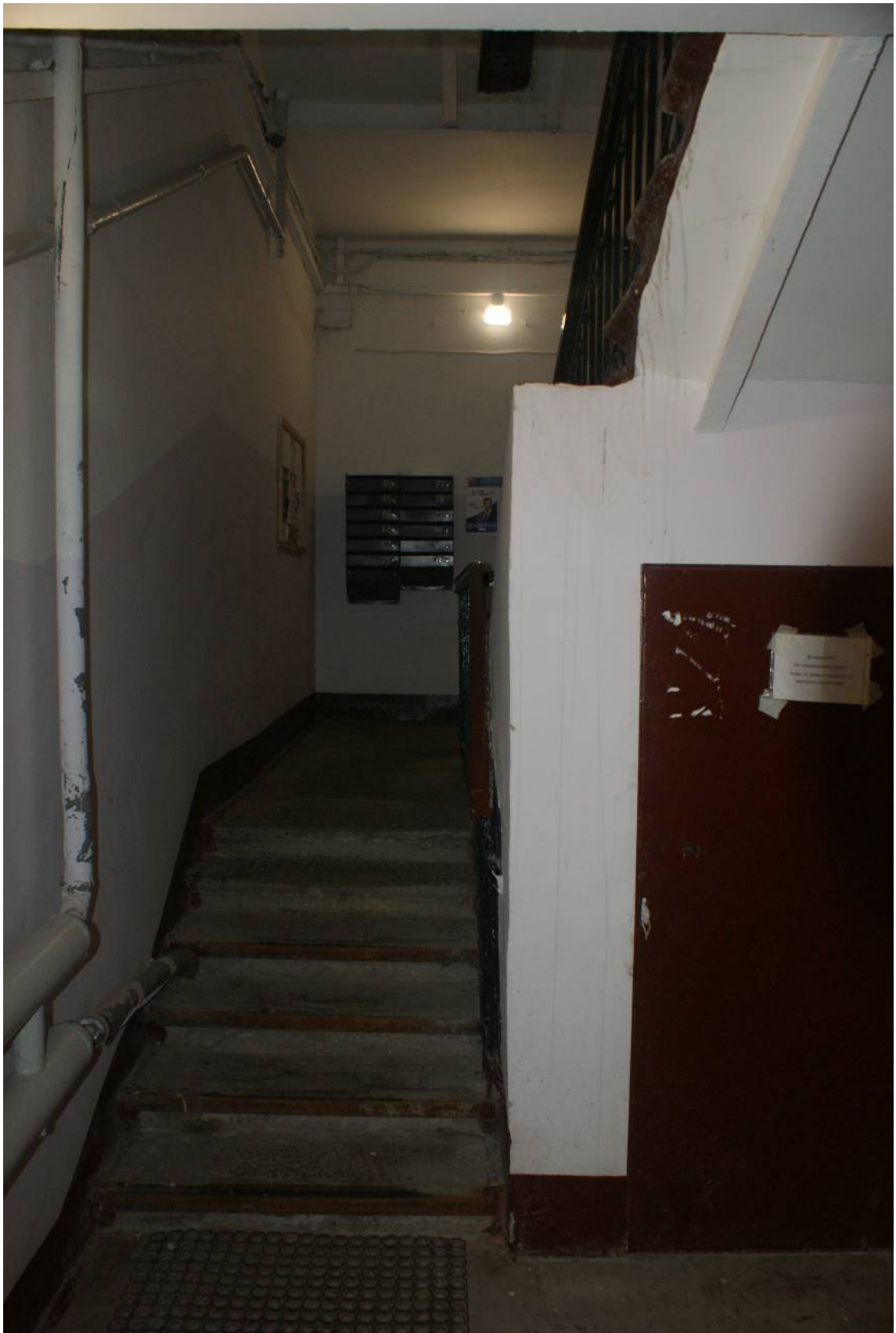
Фото 41. ЛК-2. Вестибюль 1-го этажа. Съемка 19.04.2021 г. Трушковский В.Э.
