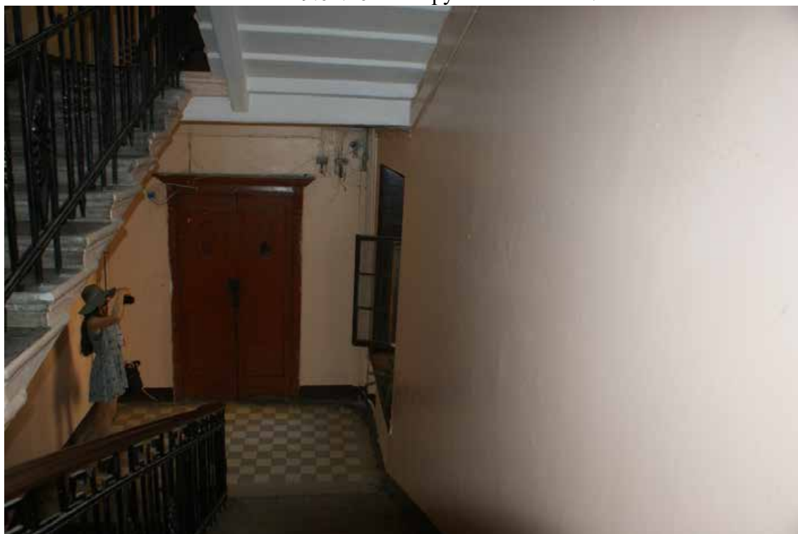
Фото 98. ЛК-3. Вид на площадку между 3-м и 4-м этажом. Съемка 19.04.2021 г. Трушковский В.Э.
