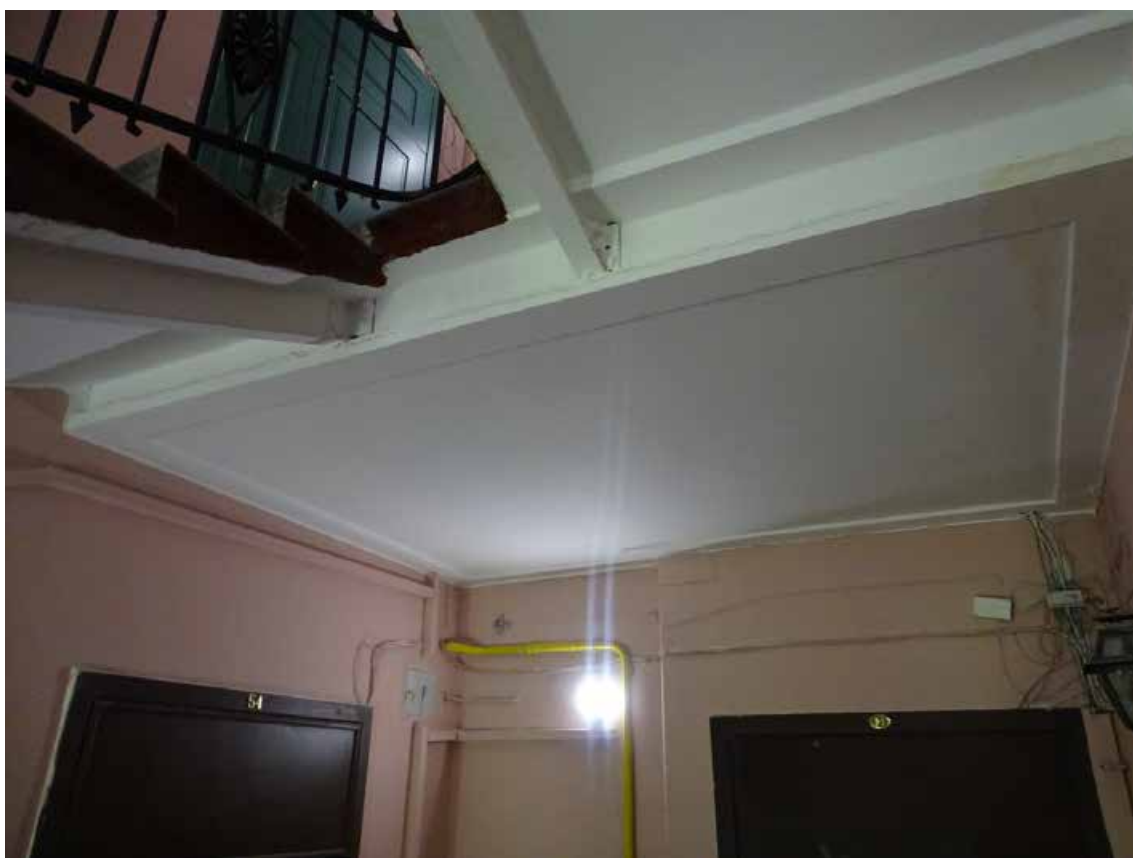
Фото 226. ЛК-8. Площадка 2-го этажа. Съемка 19.04.2021 г. Трушковский В.Э.
