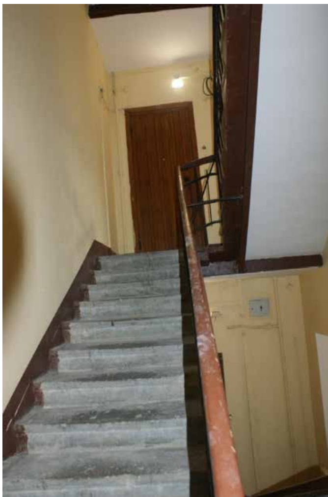
Фото 257. ЛК-9. Вид на площадку 4-го этажа. Съемка 19.04.2021 г. Трушковский В.Э.
