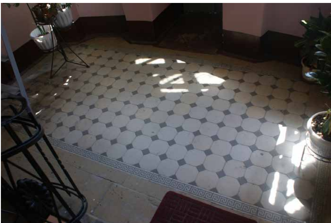
Фото 240. ЛК-8. Площадка между 5-м и 6-м этажом. Покрытие пола. Съемка 19.04.2021 г. Трушковский В.Э.
