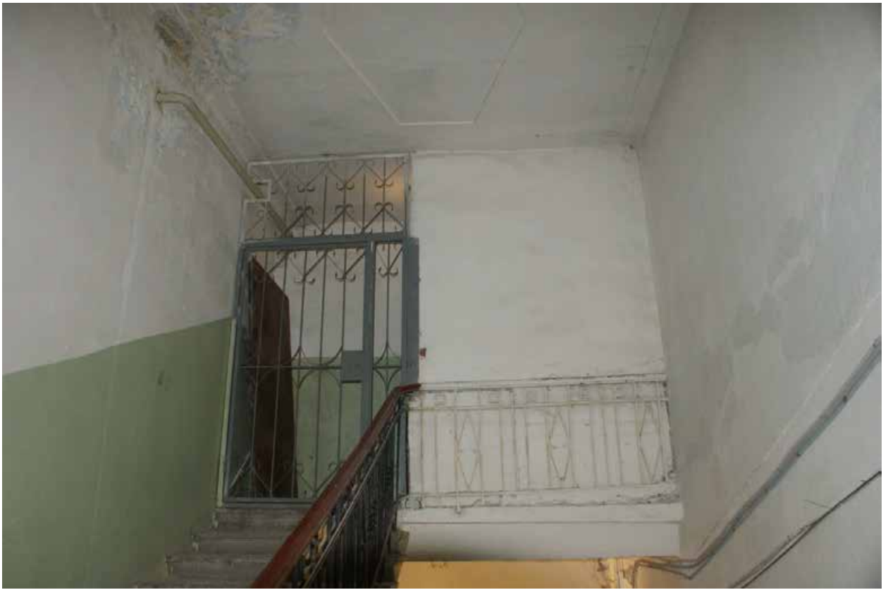
Фото 39. ЛК-1. Чердачный этаж. Съемка 19.04.2021 г. Трушковский В.Э.
