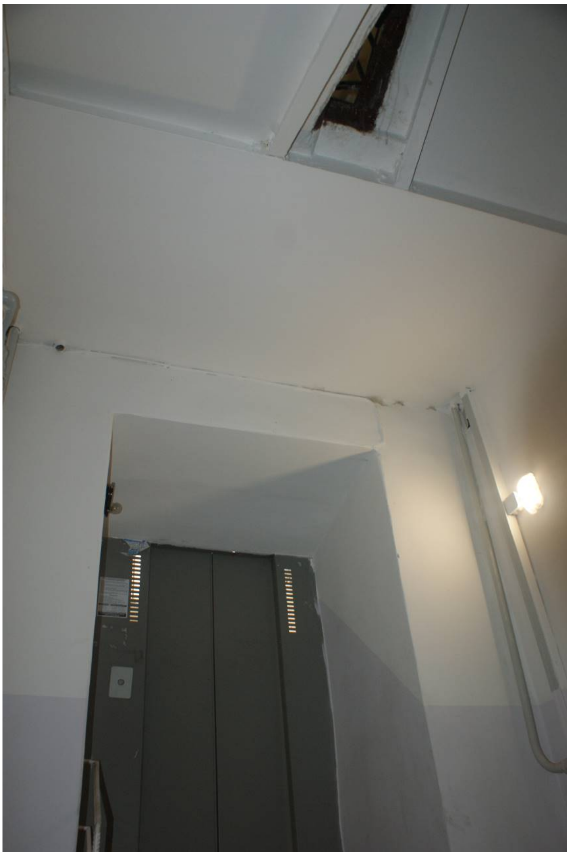
Фото 46. ЛК-2. Площадка между 1-м и 2-м этажом. Съемка 19.04.2021 г. Трушковский В.Э.
