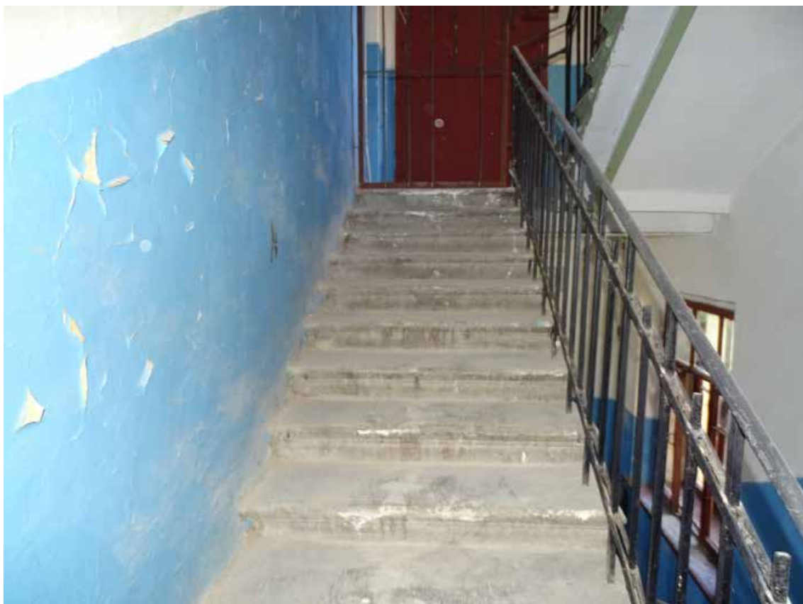
Фото 155. ЛК-5. Вид на площадку между 6-м и чердачным этажом. Съемка 19.04.2021 г. Трушковский В.Э.
