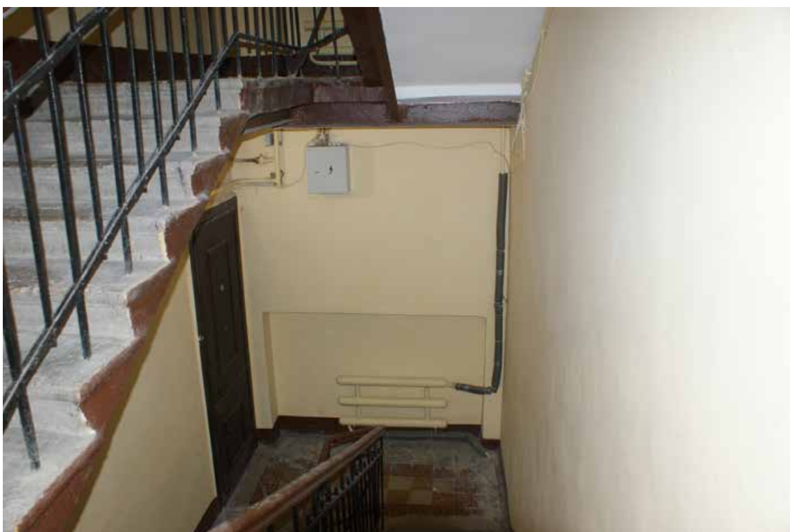
Фото 248. ЛК-9. Площадка между 1-м и 2-м этажом. Съемка 19.04.2021 г. Трушковский В.Э.
