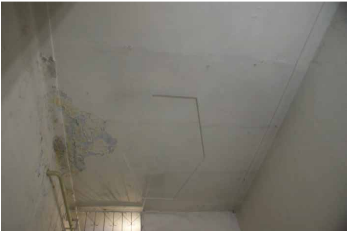
Фото 38. ЛК-1. Площадка 6-го этажа. Оформление потолка. Съемка 19.04.2021 г. Трушковский В.Э.
