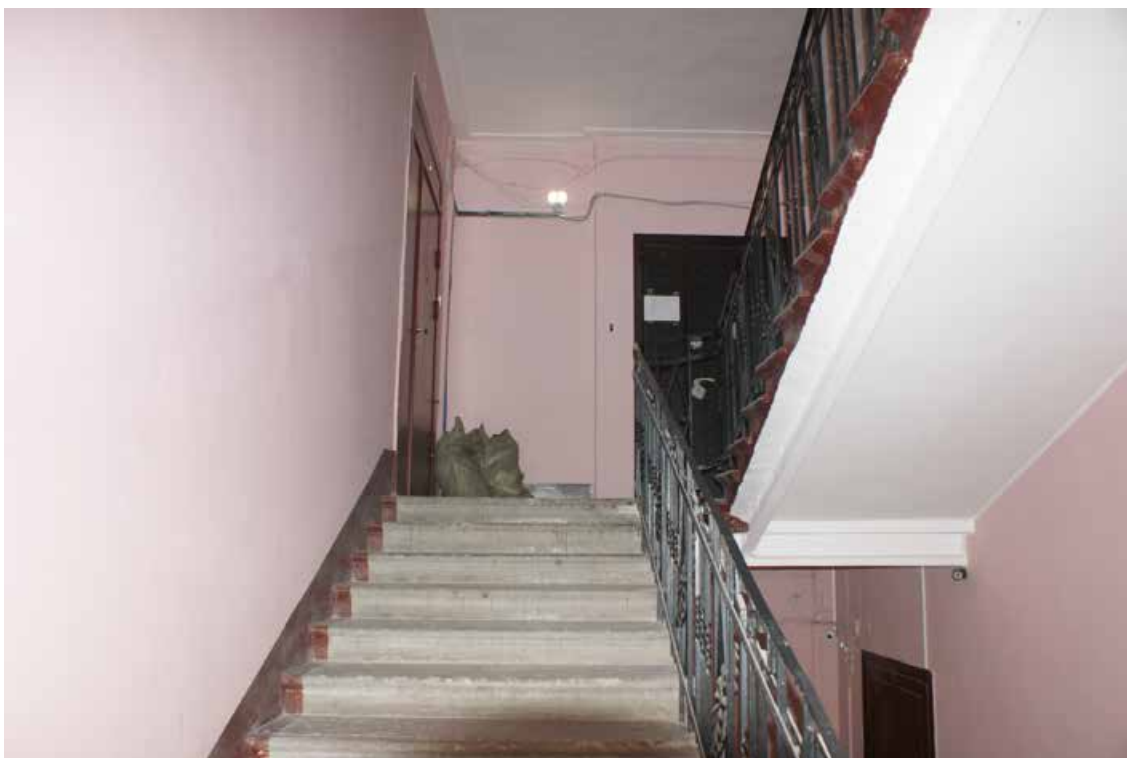
Фото 237. ЛК-8. Вид на площадку 5-го этажа. Съемка 19.04.2021 г. Трушковский В.Э.
