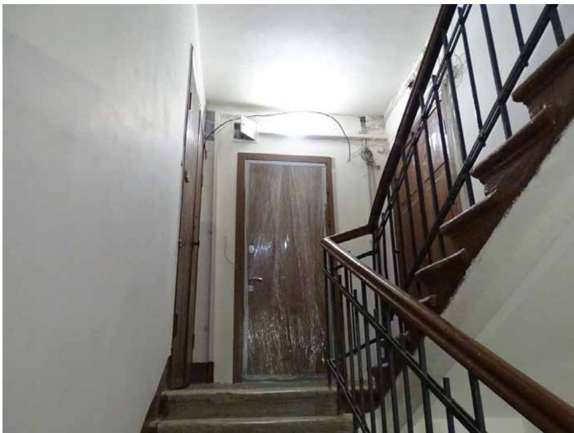
Фото 57. ЛК-2. Вид на площадку 4-го этажа. Съемка 19.04.2021 г. Трушковский В.Э.
