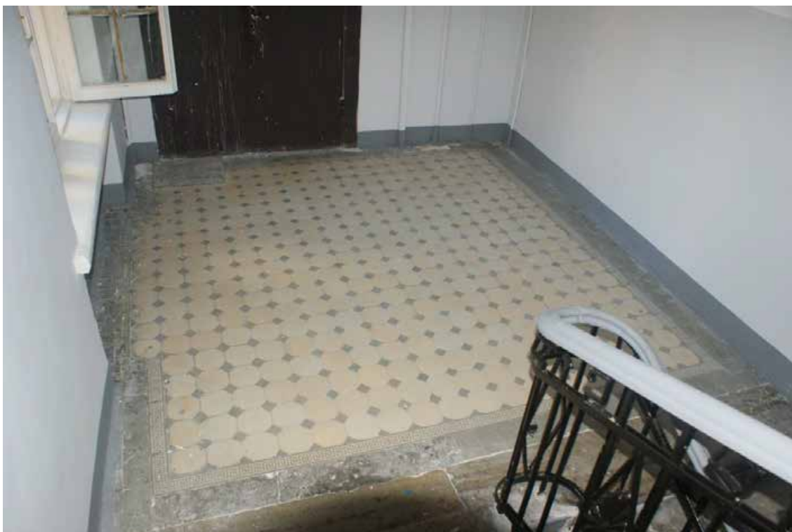
Фото 200. ЛК-6. Площадка между 5-м и 6-м этажом. Покрытие пола. Съемка 19.04.2021 г. Трушковский В.Э.
