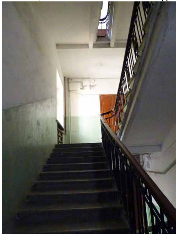
Фото 20. ЛК-1. Площадка между 2-м и 3-м этажом. Съемка 19.04.2021 г. Трушковский В.Э.
