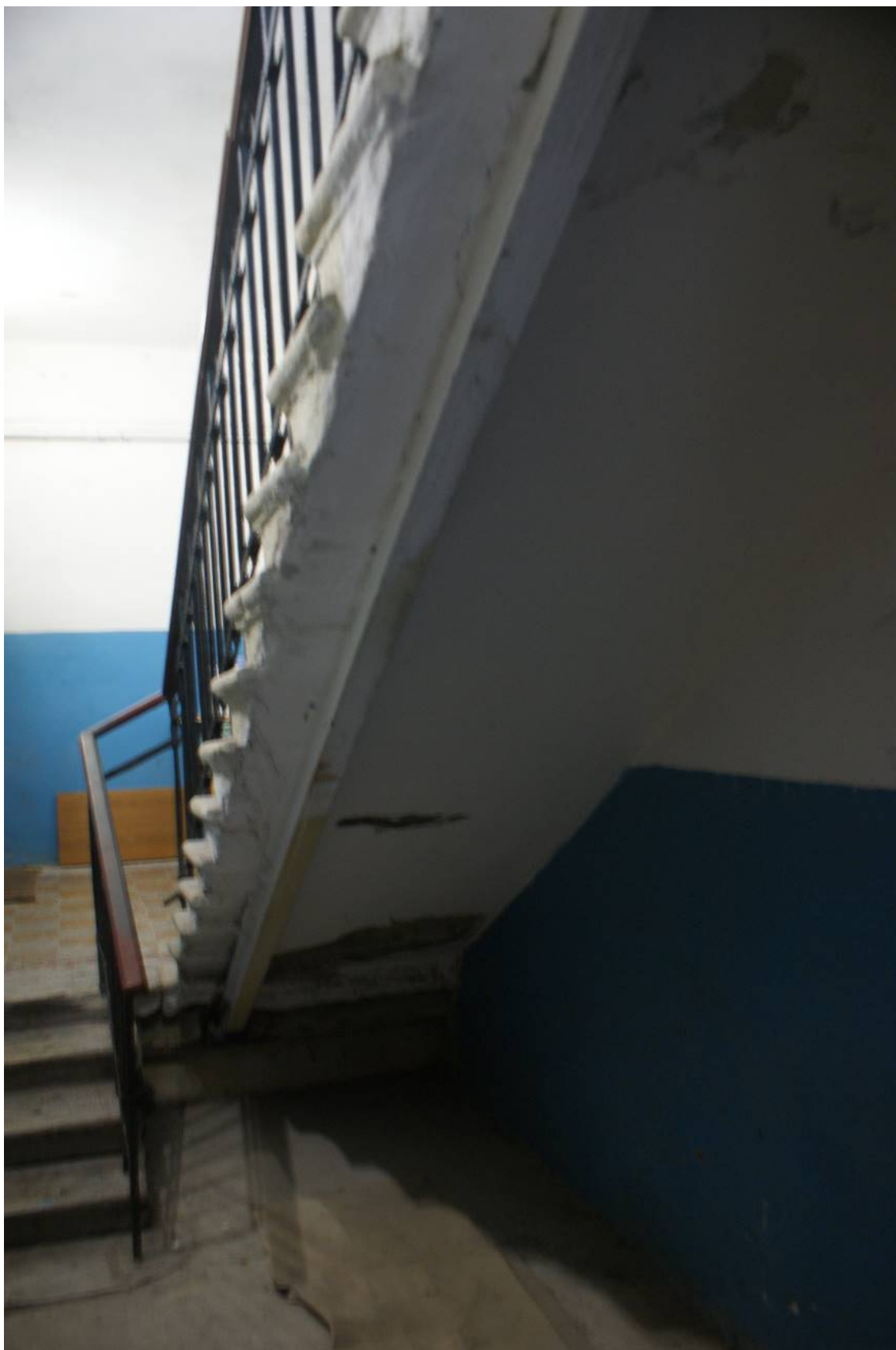
Фото 120. ЛК-5. Вестибюль 1-го этажа. Пространство под лестницей. Съемка 19.04.2021 г. Трушковский В.Э.
