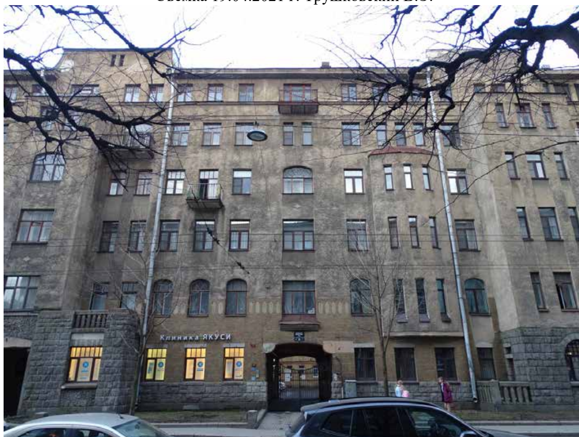
Фото 8. Здание по адресу: г. Санкт-Петербург, Большая Монетная ул., дом 29, литера А. Фрагмент фасада по Большой Монетной ул. Съемка 19.04.2021 г. Трушковский В.Э.
