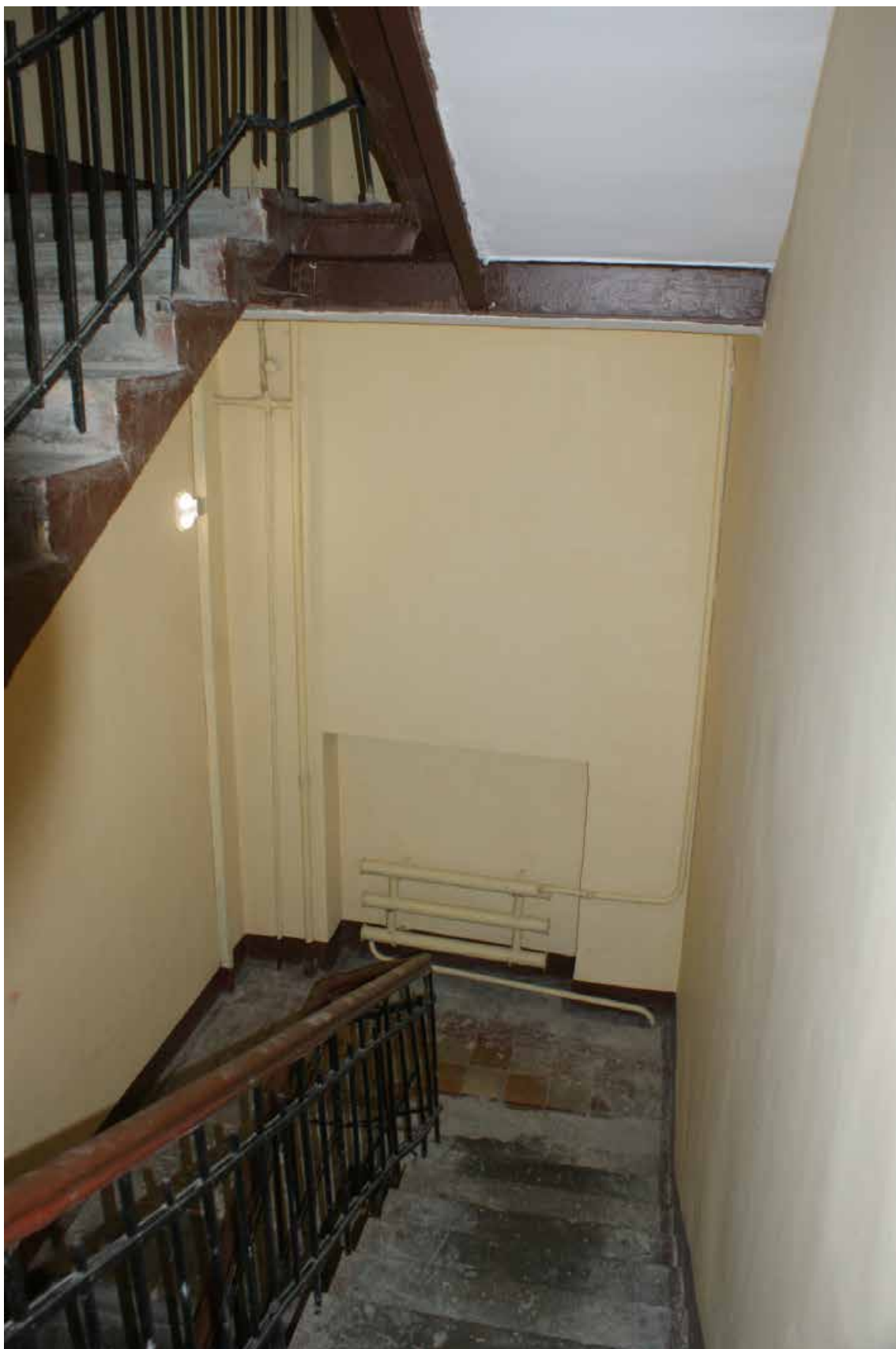
Фото 255. ЛК-9. Вид на площадку между 3-м и 4-м этажом. Съемка 19.04.2021 г. Трушковский В.Э.
