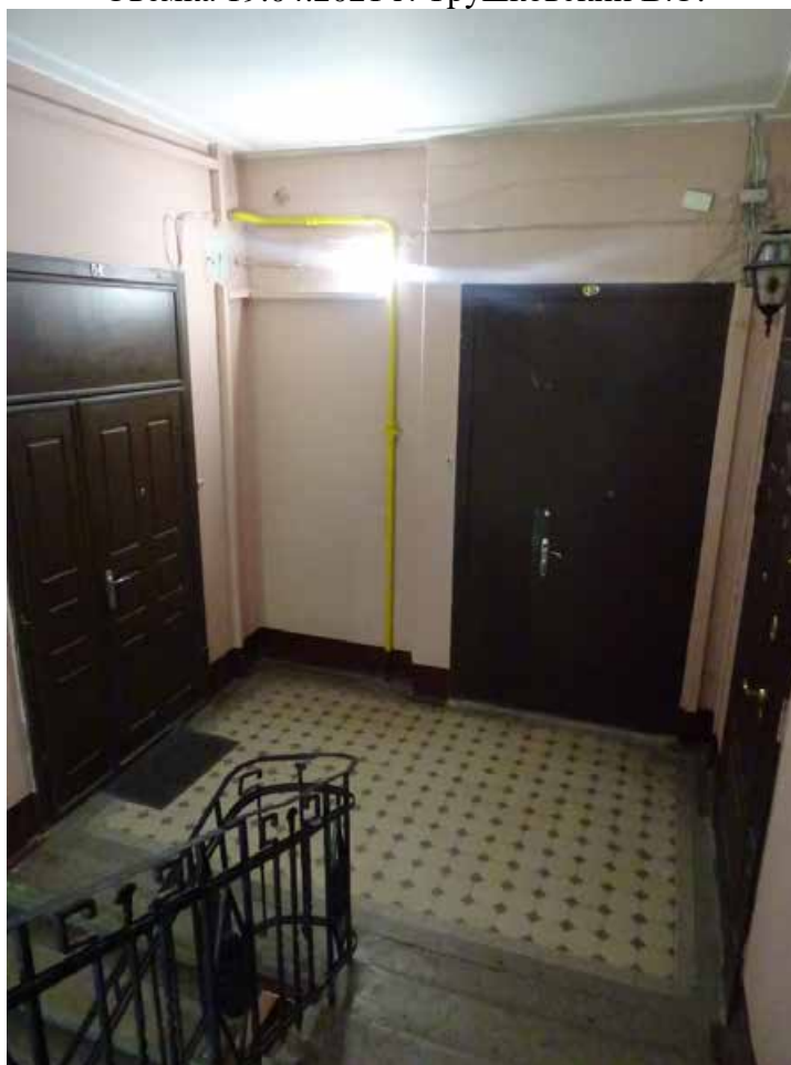
Фото 224. ЛК-8. Вид на площадку 2-го этажа. Съемка 19.04.2021 г. Трушковский В.Э.
