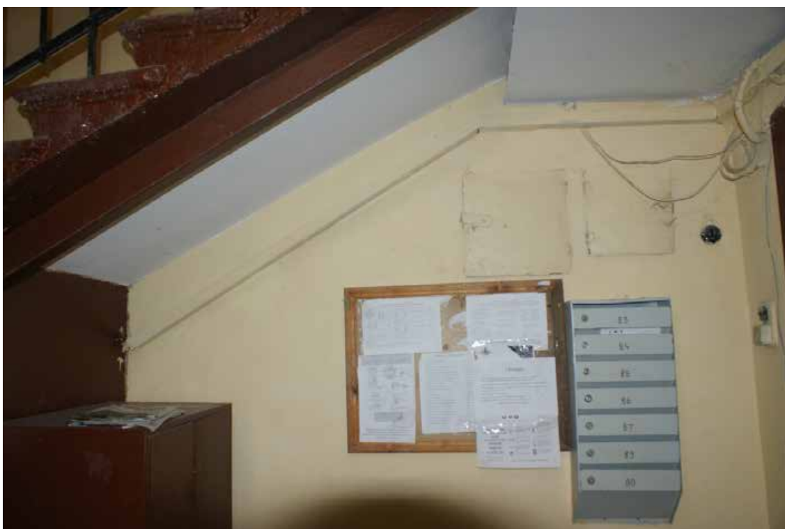
Фото 244. ЛК-9. Вестибюль 1-го этажа. Съемка 19.04.2021 г. Трушковский В.Э.
