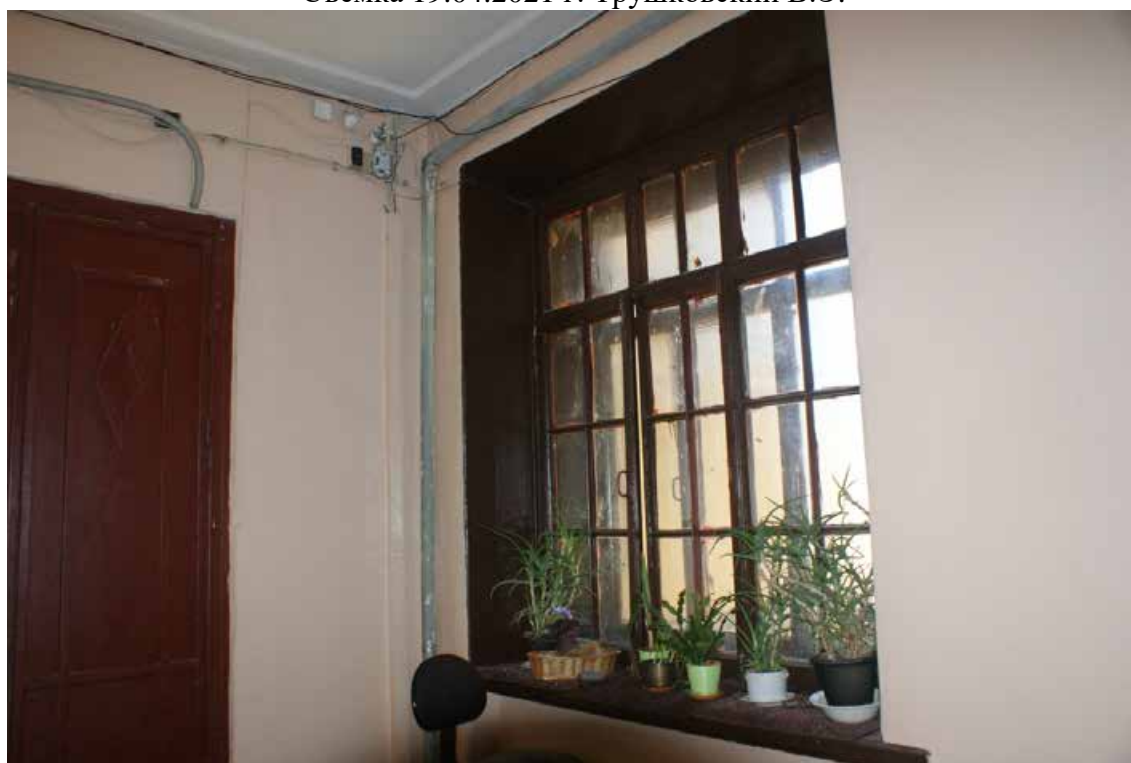
Фото 109. ЛК-3. Площадка между 5-м и 6-м этажом. Съемка 19.04.2021 г. Трушковский В.Э.
