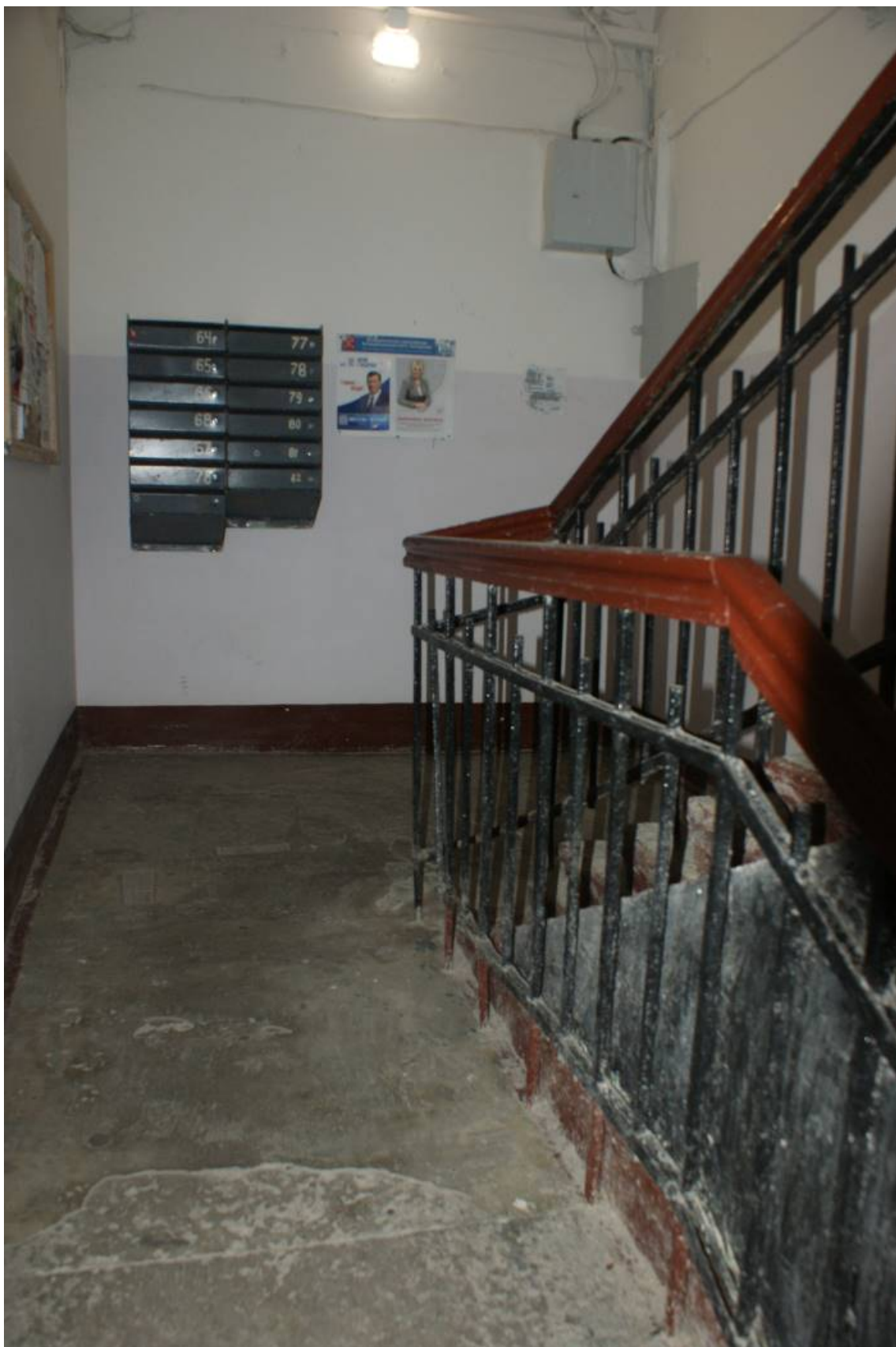
Фото 43. ЛК-2. Площадка 1-го этажа. Съемка 19.04.2021 г. Трушковский В.Э.
