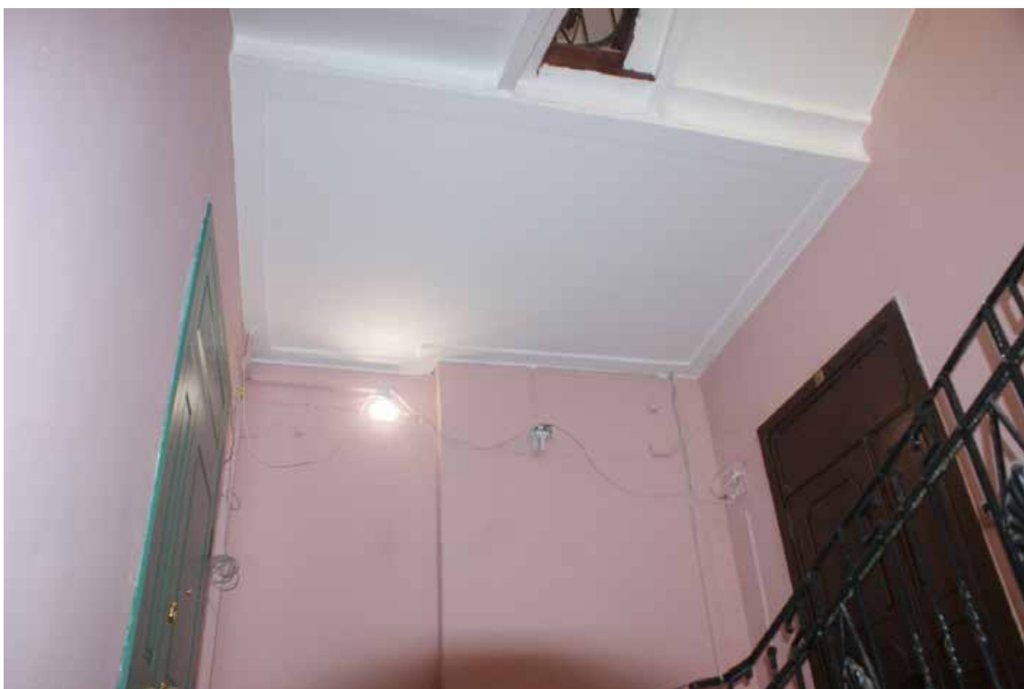
Фото 230. ЛК-8. Площадка 3-го этажа. Съемка 19.04.2021 г. Трушковский В.Э.
