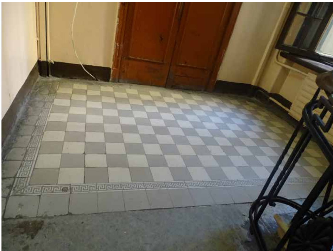
Фото 95. ЛК-3. Площадка между 3-м и 4-м этажом. Съемка 19.04.2021 г. Трушковский В.Э.
