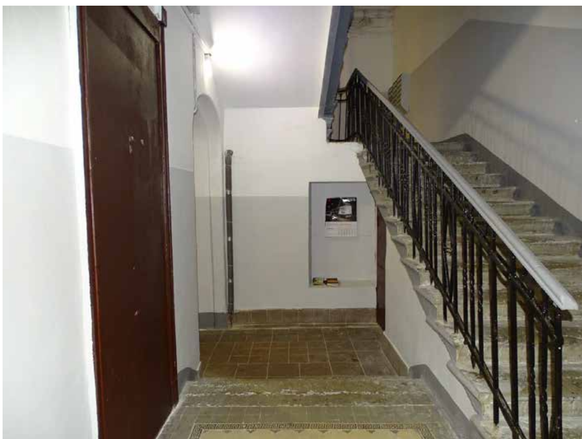
Фото 168. ЛК-6. Площадка 1-го этажа. Съемка 19.04.2021 г. Трушковский В.Э.
