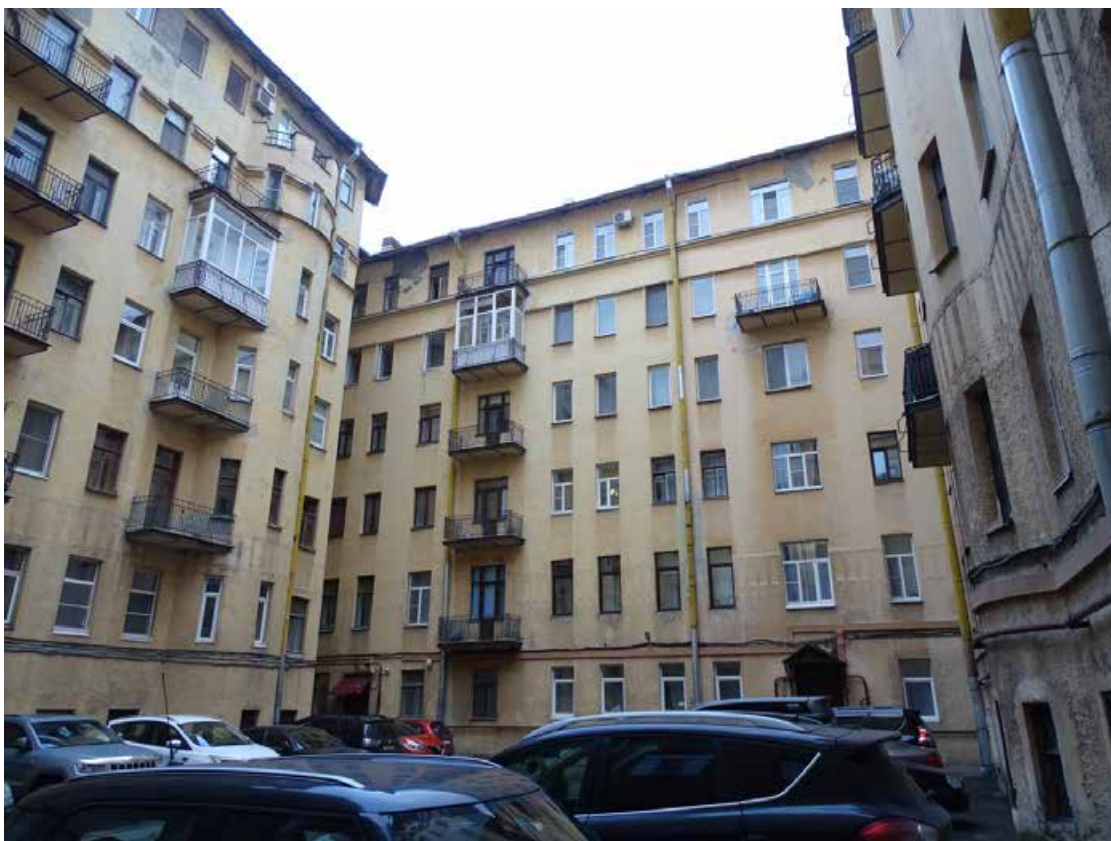
Фото 27. Здание по адресу: г. Санкт-Петербург, Большая Монетная ул., дом 29, литера А. Юго-восточный дворовой фасад. Съемка 19.04.2021 г. Трушковский В.Э.
