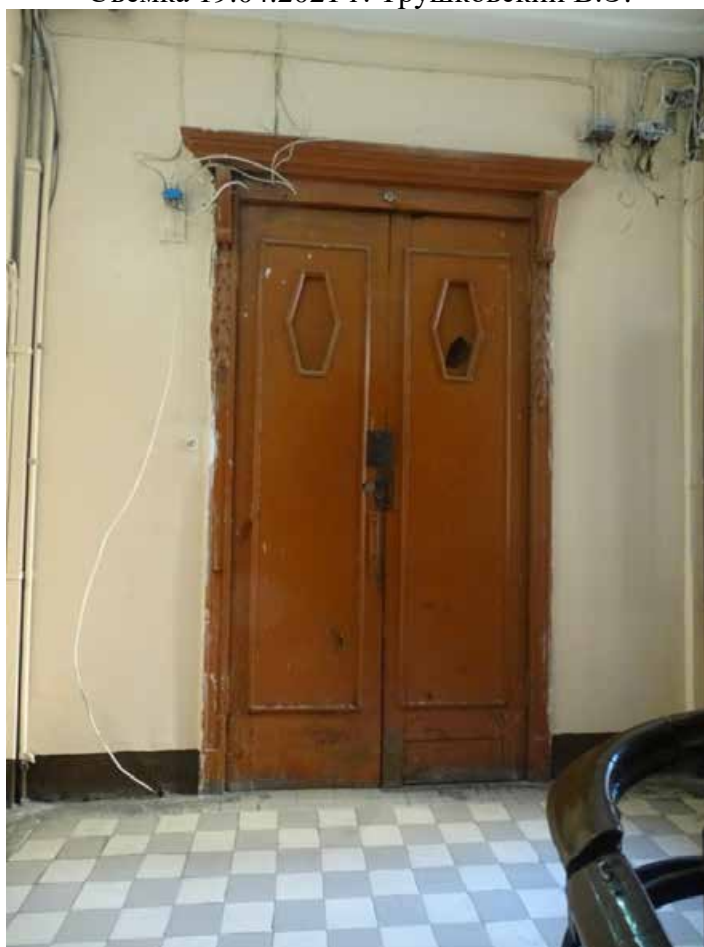
Фото 96. ЛК-3. Площадка между 3-м и 4-м этажом. Съемка 19.04.2021 г. Трушковский В.Э.
