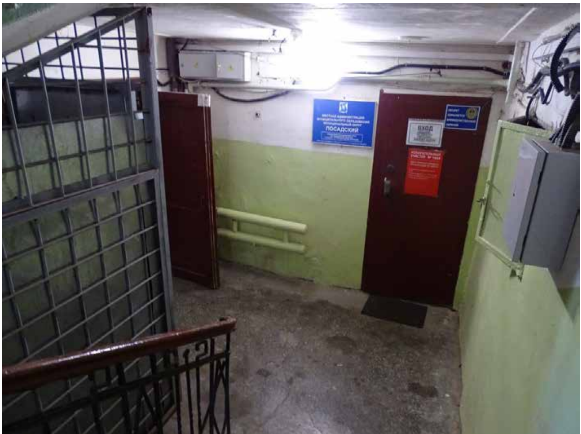
Фото 8. ЛК-1. Площадка 1-го этажа. Пространство под лестницей. Съемка 19.04.2021 г. Трушковский В.Э.
