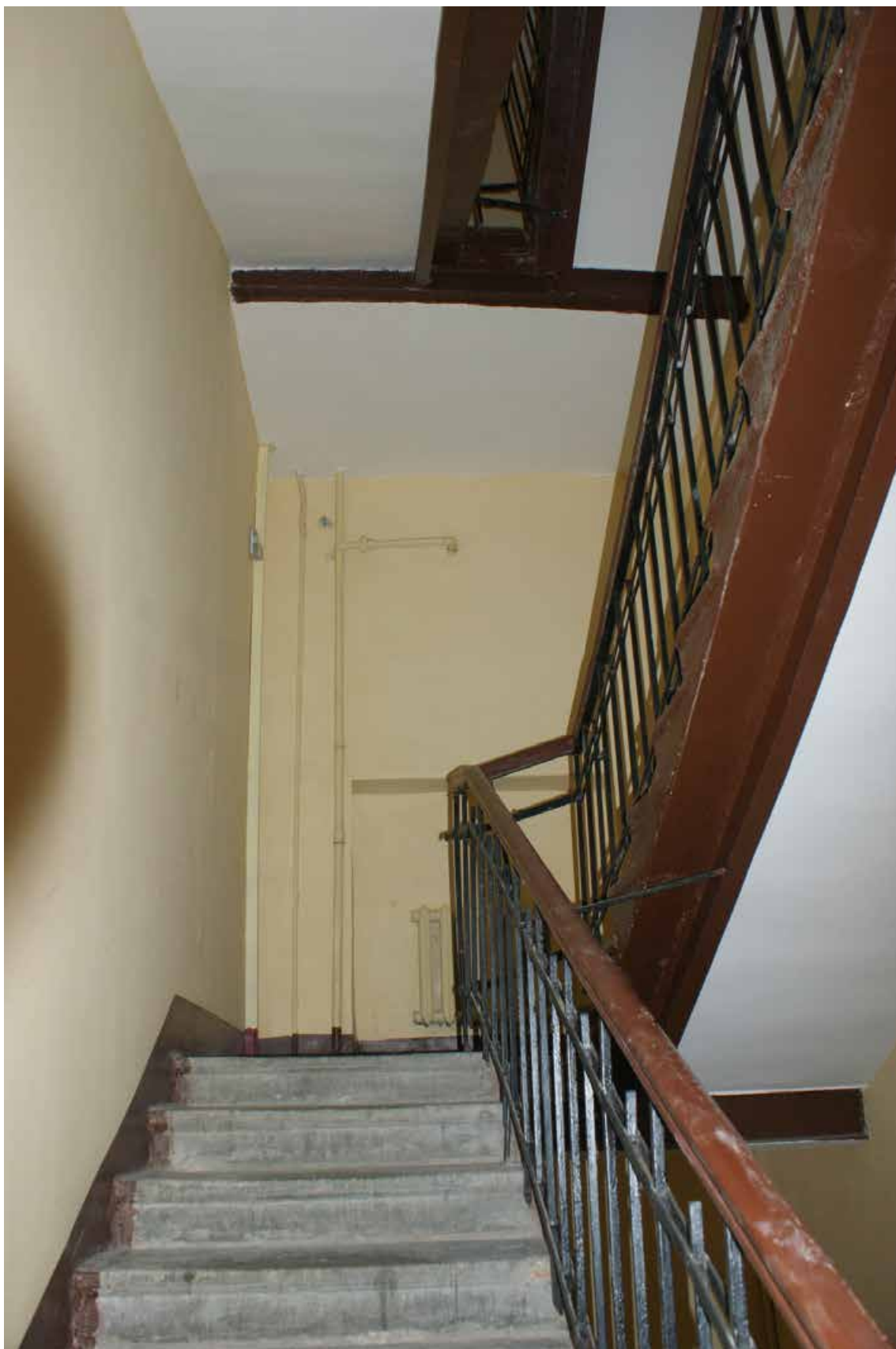
Фото 256. ЛК-9. Вид на площадку между 3-м и 4-м этажом. Съемка 19.04.2021 г. Трушковский В.Э.
