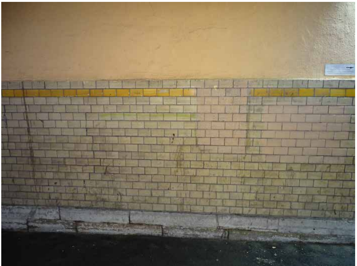
Фото 24. Здание по адресу: г. Санкт-Петербург, Большая Монетная ул., дом 29, литера А. Оформление стен воротного проезда. Съемка 19.04.2021 г. Трушковский В.Э.
