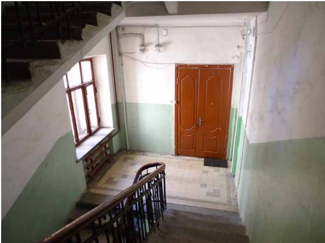
Фото 22. ЛК-1. Площадка между 2-м и 3-м этажом. Съемка 19.04.2021 г. Трушковский В.Э.
