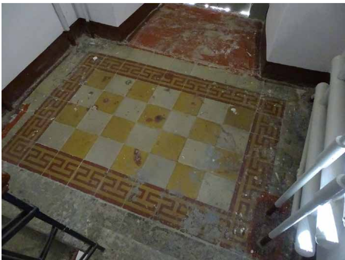
Фото 60. ЛК-2. Площадка между 4-м и 5-м этажом. Покрытие пола. Съемка 19.04.2021 г. Трушковский В.Э.
