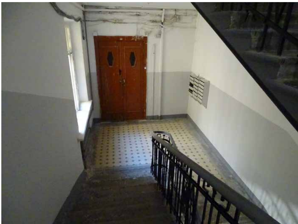
Фото 175. ЛК-6. Площадка между 1-м и 2-м этажом. Съемка 19.04.2021 г. Трушковский В.Э.
