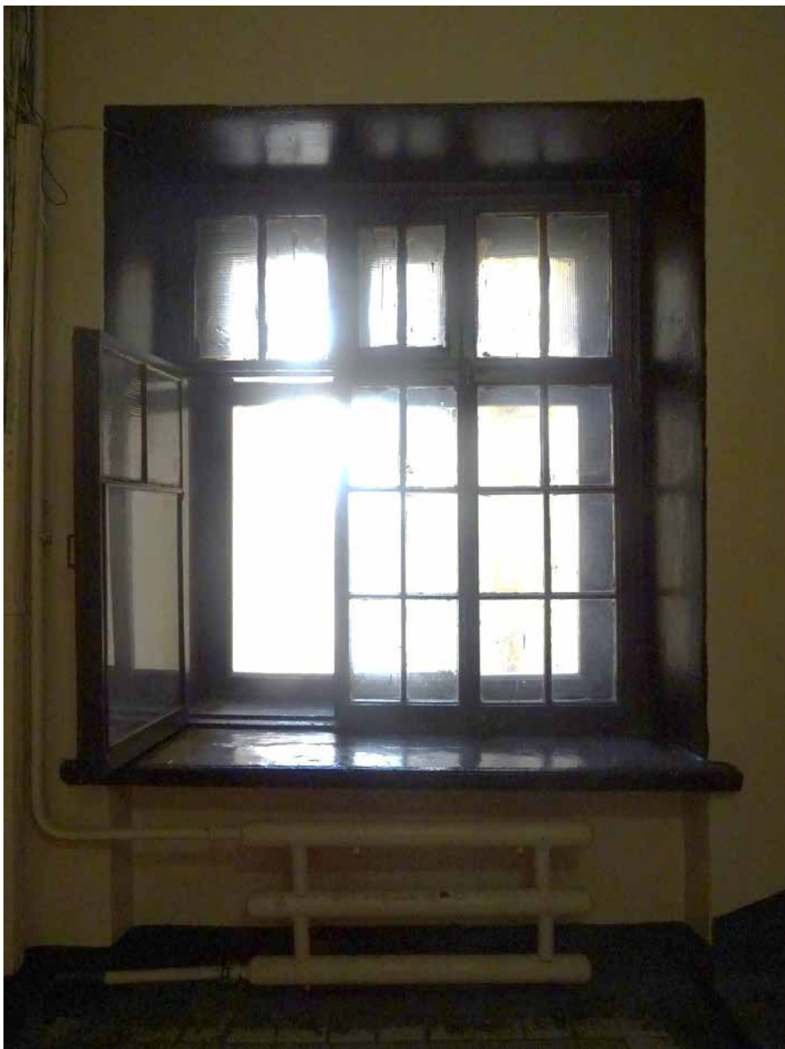
Фото 89. ЛК-3. Площадка между 2-м и 3-м этажом. Съемка 19.04.2021 г. Трушковский В.Э.
