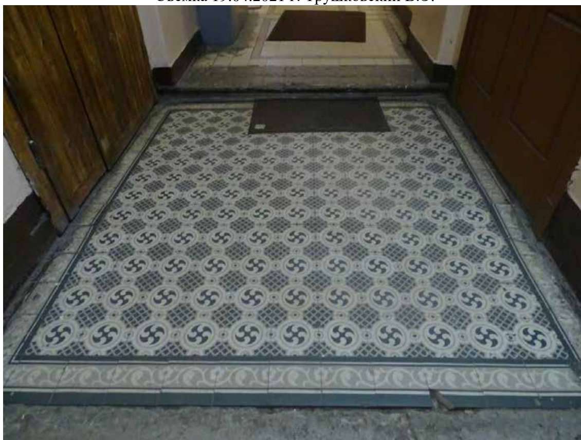
Фото 76. ЛК-3. Вестибюль 1-го этажа. Покрытие пола. Съемка 19.04.2021 г. Трушковский В.Э.
