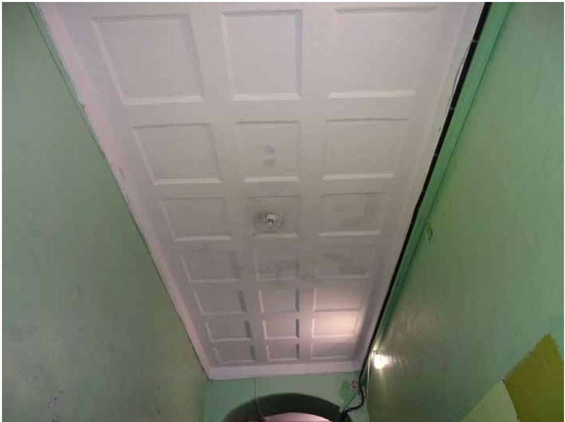
Фото 5. ЛК-1. Вестибюль 1-го этажа. Оформление потолка. Съемка 19.04.2021 г. Трушковский В.Э.
