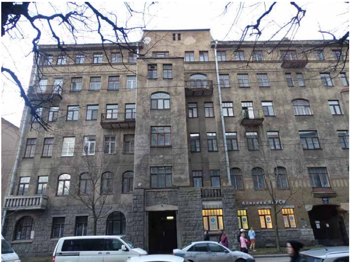
Фото 12. Здание по адресу: г. Санкт-Петербург, Большая Монетная ул., дом 29, литера А. Фрагмент фасада по Большой Монетной ул. Съемка 19.04.2021 г. Трушковский В.Э.
