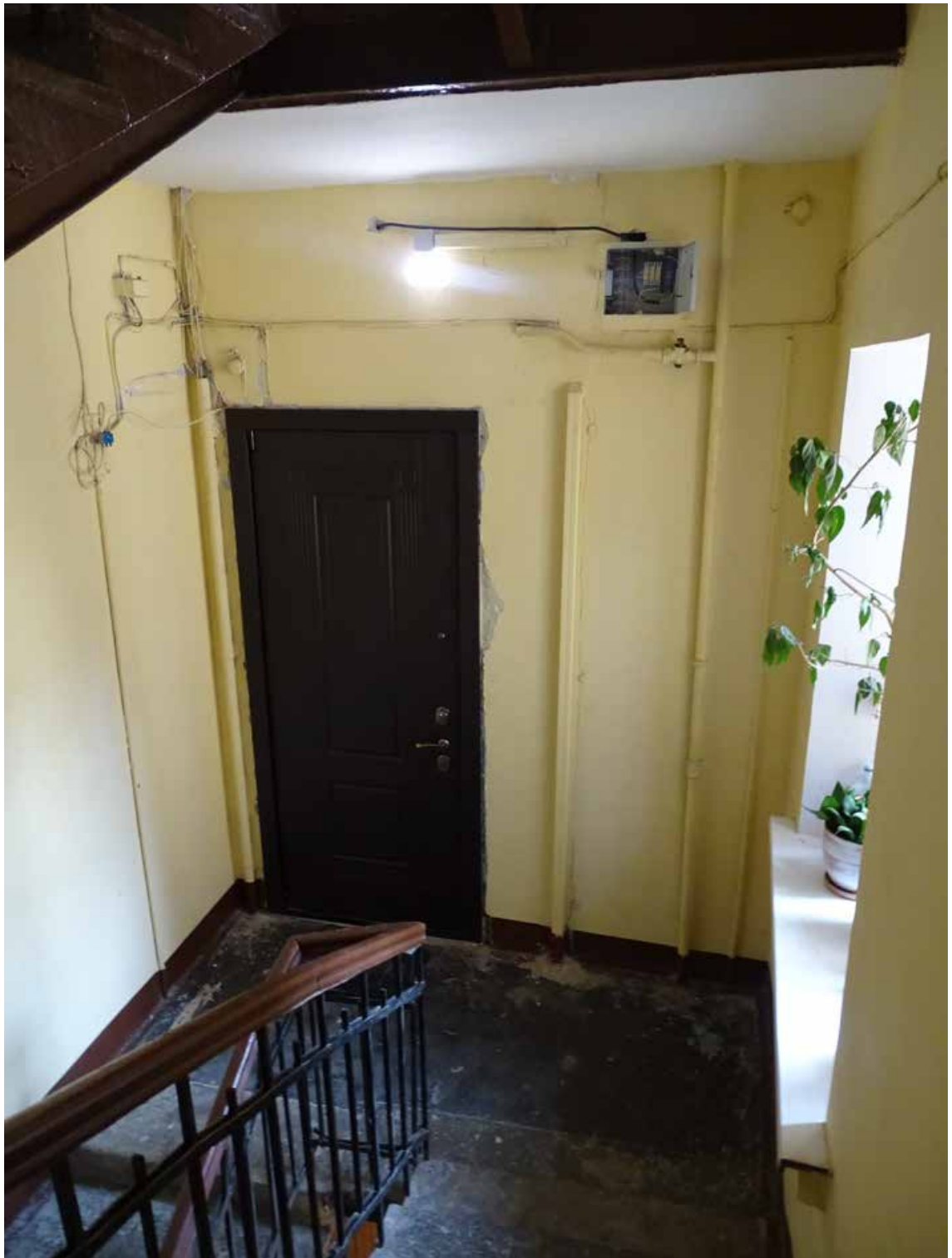
Фото 262. ЛК-9. Вид на площадку 5-го этажа. Съемка 19.04.2021 г. Трушковский В.Э.
