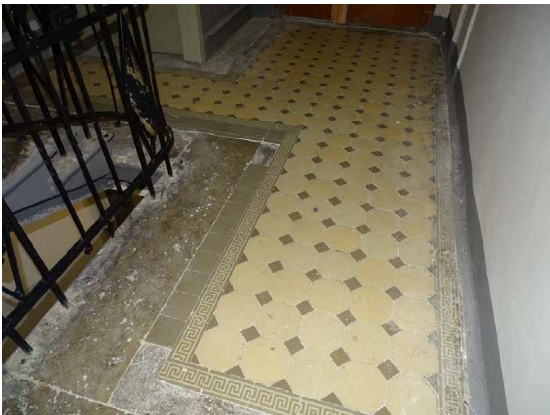
Фото 181. ЛК-6. Площадка 2-го этажа. Покрытие пола. Съемка 19.04.2021 г. Трушковский В.Э.
