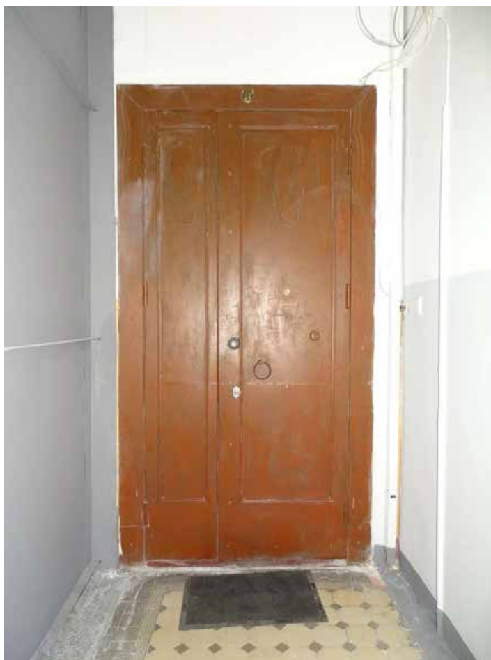
Фото 186. ЛК-6. Площадка 3-го этажа. Оформление двери. Съемка 19.04.2021 г. Трушковский В.Э.
