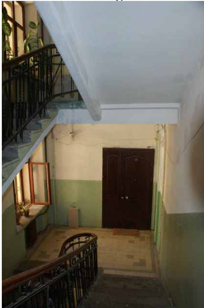
Фото 30. ЛК-1. Площадка между 4-м и 5-м этажом. Съемка 19.04.2021 г. Трушковский В.Э.
