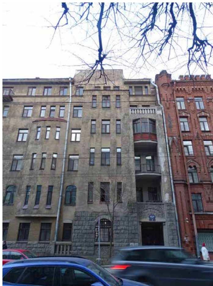
Фото 3. Здание по адресу: г. Санкт-Петербург, Большая Монетная ул., дом 29, литера А. Фрагмент фасада по Большой Монетной ул. Съемка 19.04.2021 г. Трушковский В.Э.
