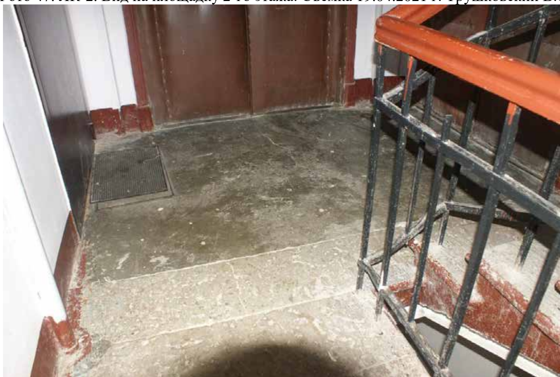
Фото 48. ЛК-2. Вид на площадку 2-го этажа. Съемка 19.04.2021 г. Трушковский В.Э.
