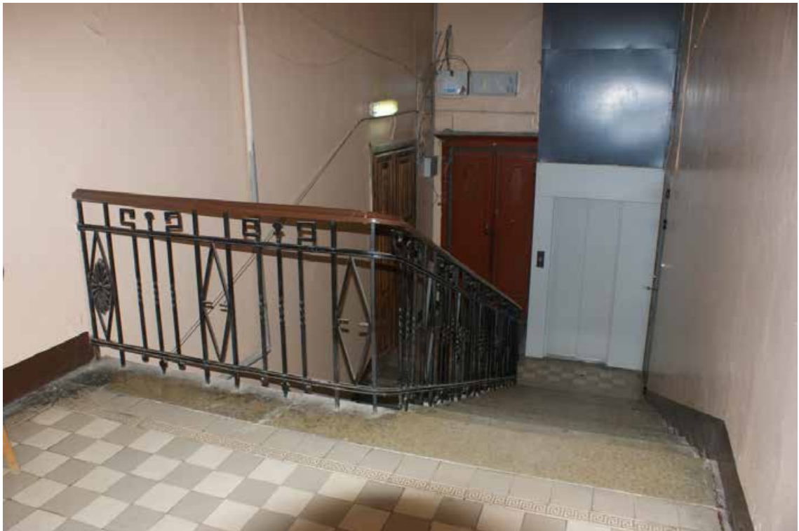
Фото 110. ЛК-3. Вид на площадку 6-го этажа. Съемка 19.04.2021 г. Трушковский В.Э.
