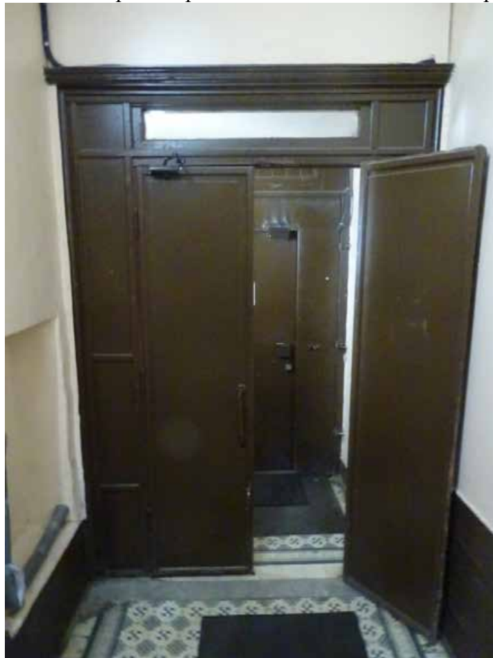
Фото 72. ЛК-3. Вестибюль 1-го этажа. Входная дверь. Съемка 19.04.2021 г. Трушковский В.Э
