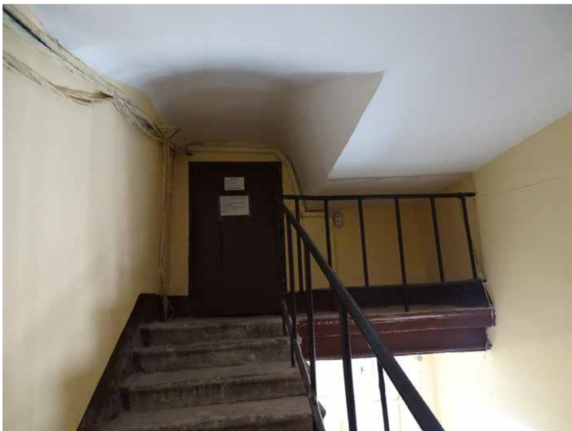
Фото 271. ЛК-9. Чердачный этаж. Съемка 19.04.2021 г. Трушковский В.Э.
