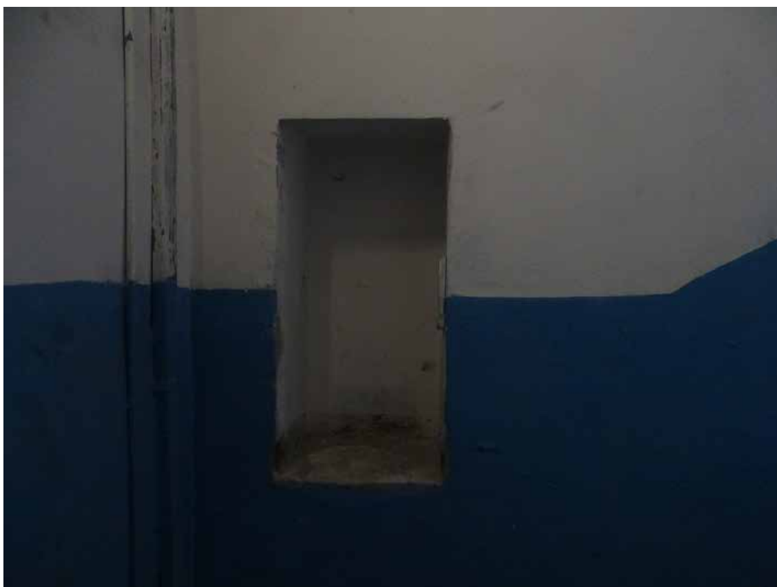
Фото 142. ЛК-5. Площадка 4-го этажа. Съемка 19.04.2021 г. Трушковский В.Э.
