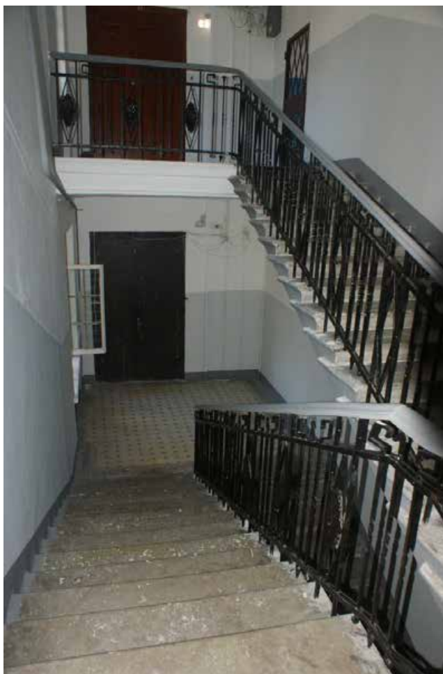
Фото 198. ЛК-6. Вид на площадку между 5-м и 6-м этажом. Съемка 19.04.2021 г. Трушковский В.Э.
