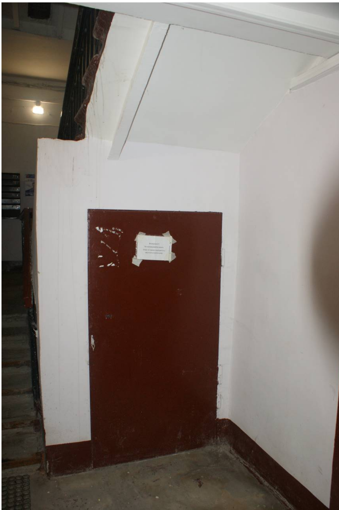
Фото 42. ЛК-2. Вестибюль 1-го этажа. Дверь в подвал. Съемка 19.04.2021 г. Трушковский В.Э.
