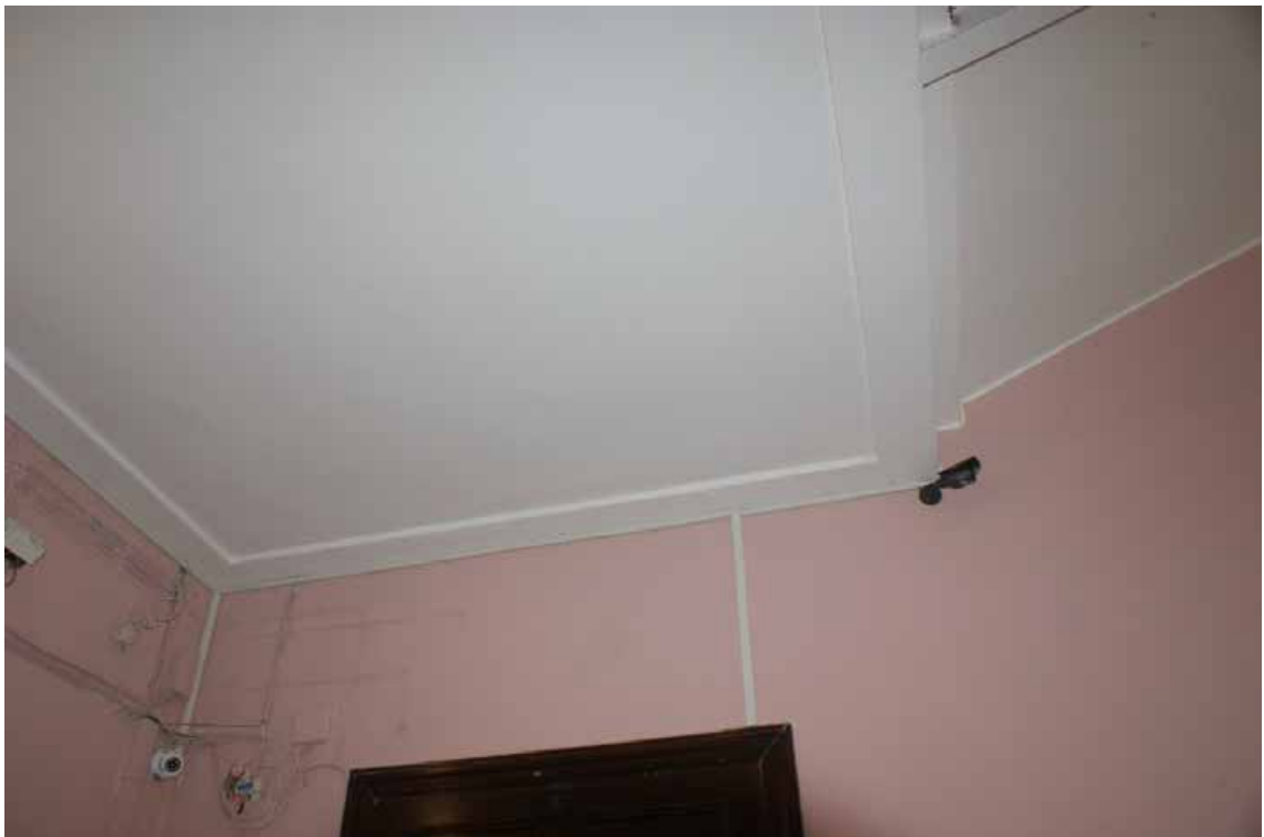
Фото 234. ЛК-8. Площадка 4-го этажа. Съемка 19.04.2021 г. Трушковский В.Э.
