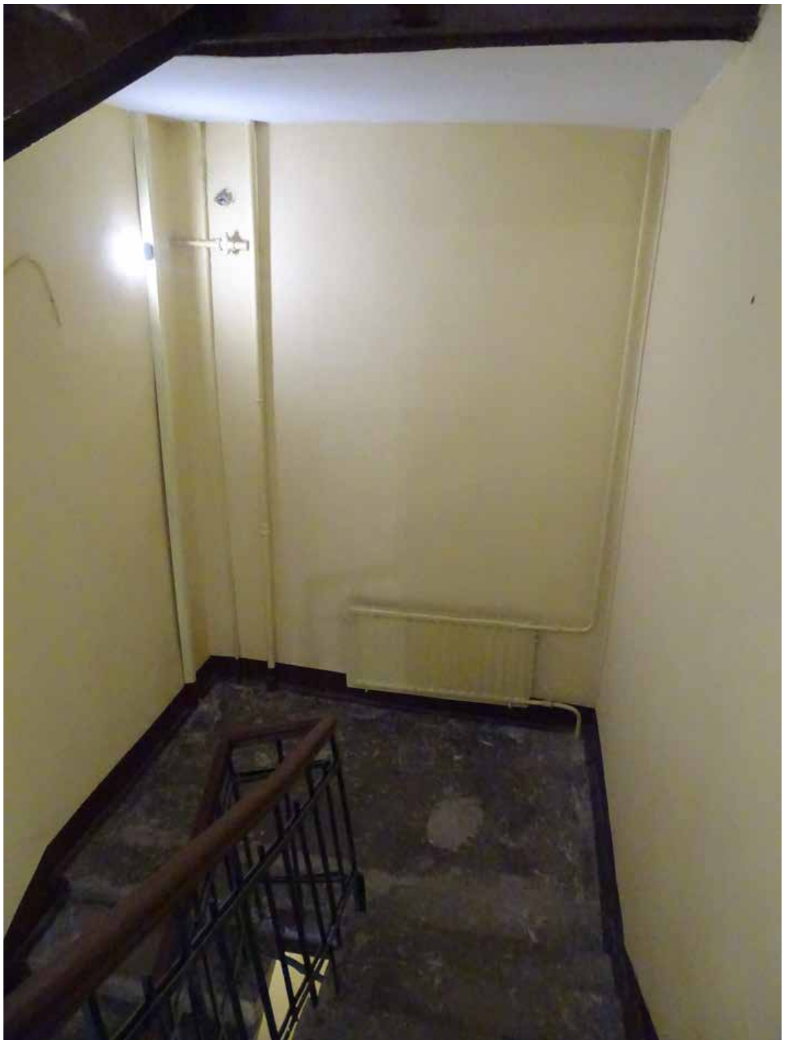
Фото 263. ЛК-9. Вид на площадку между 5-м и 6-м этажом. Съемка 19.04.2021 г. Трушковский В.Э.
