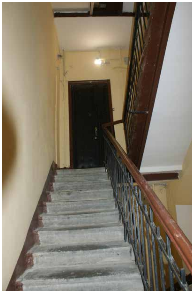
Фото 253. ЛК-9. Вид на площадку 3-го этажа. Съемка 19.04.2021 г. Трушковский В.Э.
