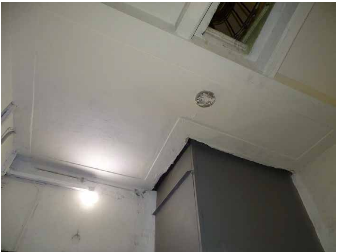
Фото 18. ЛК-1. Площадка 2-го этажа. Оформление потолка. Съемка 19.04.2021 г. Трушковский В.Э.
