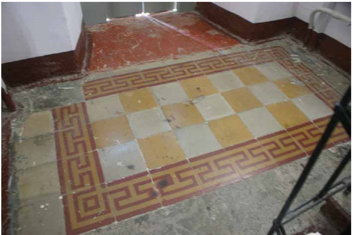
Фото 51. ЛК-2. Площадка между 2-м и 3-м этажом. Съемка 19.04.2021 г. Трушковский В.Э.
