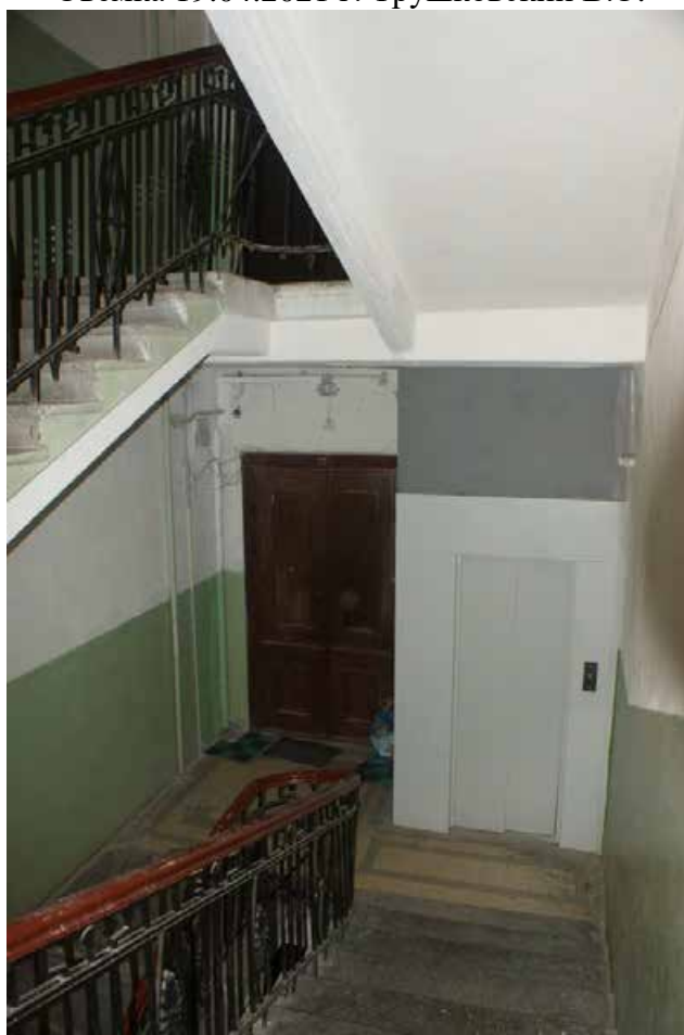
Фото 28. ЛК-1. Вид на площадку 4-го этажа. Съемка 19.04.2021 г. Трушковский В.Э.
