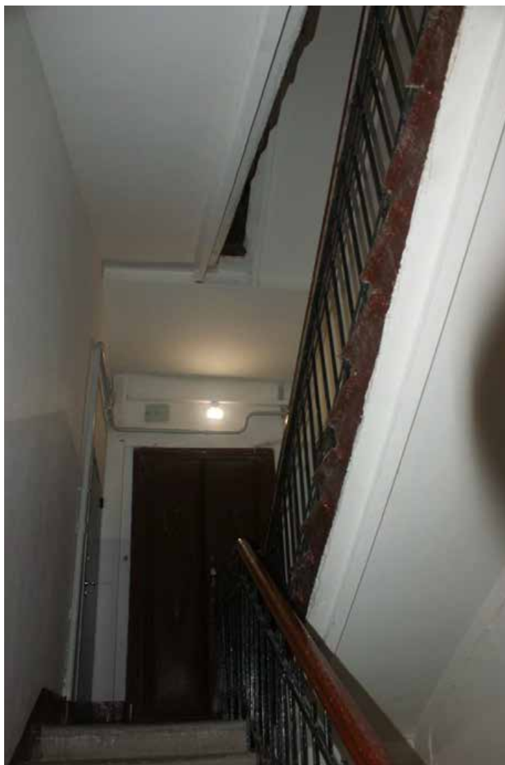
Фото 47. ЛК-2. Вид на площадку 2-го этажа. Съемка 19.04.2021 г. Трушковский В.Э.
