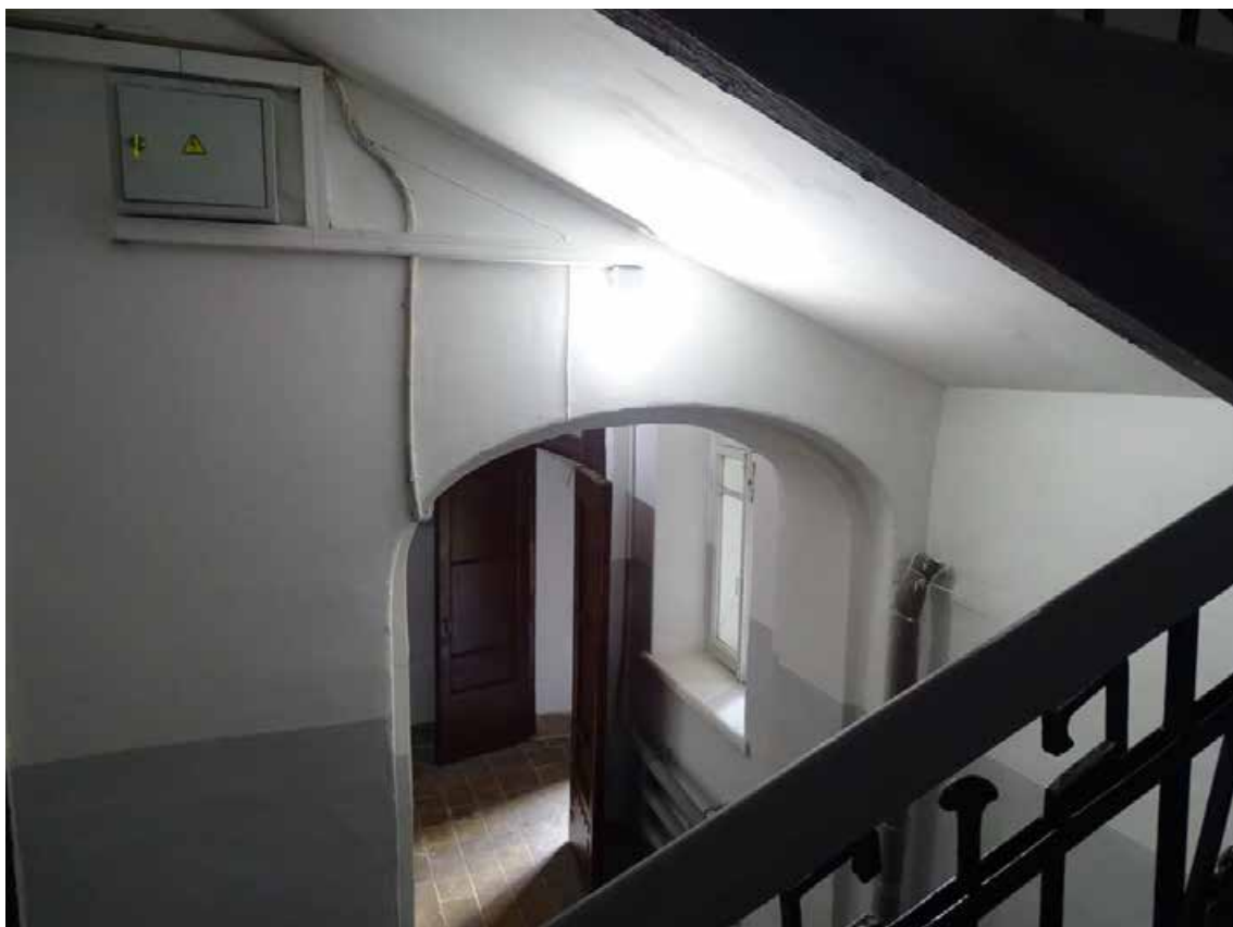
Фото 167. ЛК-6. Вестибюль 1-го этажа. Съемка 19.04.2021 г. Трушковский В.Э.
