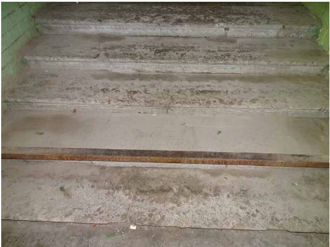
Фото 6. ЛК-1. Вестибюль 1-го этажа. Одномаршевая лестница. Съемка 19.04.2021 г. Трушковский В.Э.
