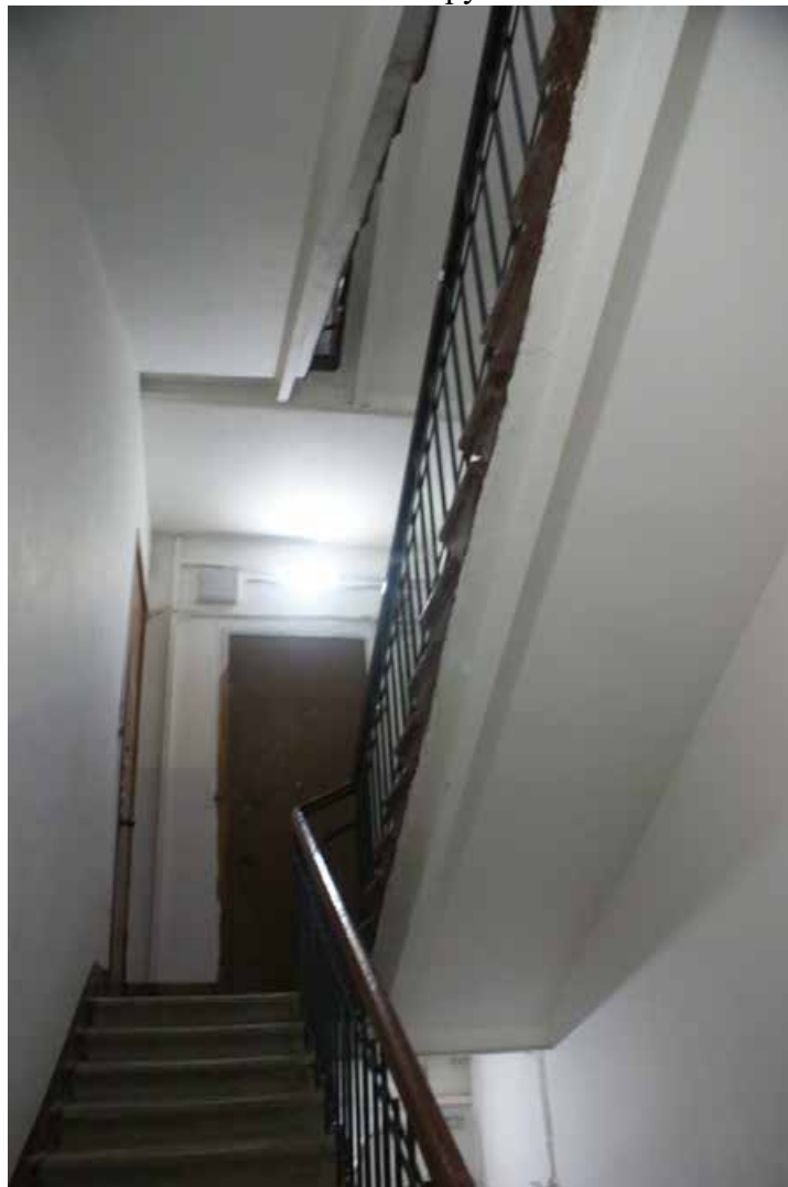
Фото 52. ЛК-2. Вид на площадку 3-го этажа. Съемка 19.04.2021 г. Трушковский В.Э.
