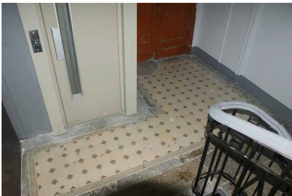
Фото 203. ЛК-6. Площадка 6-го этажа. Съемка 19.04.2021 г. Трушковский В.Э.
