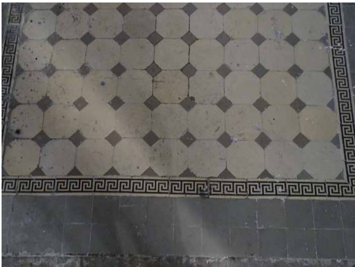
Фото 171. ЛК-6. Площадка 1-го этажа. Покрытие пола. Съемка 19.04.2021 г. Трушковский В.Э.
