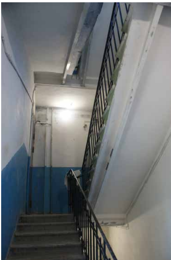
Фото 4 . ЛК-5 Вид на площадку 3-го этажа. Съемка 001 г. Трушковский В.Э.
