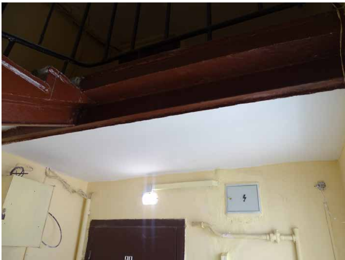
Фото 269. ЛК-9. Площадка 7-го этажа. Съемка 19.04.2021 г. Трушковский В.Э.
