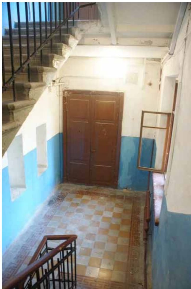
Фото 124. ЛК-5. Площадка между 1-м и 2-м этажом. Съемка 19.04.2021 г. Трушковский В.Э.
