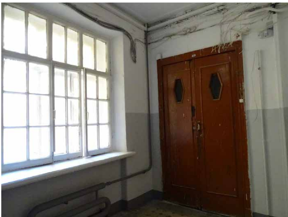
Фото 176. ЛК-6. Площадка между 1-м и 2-м этажом. Съемка 19.04.2021 г. Трушковский В.Э.
