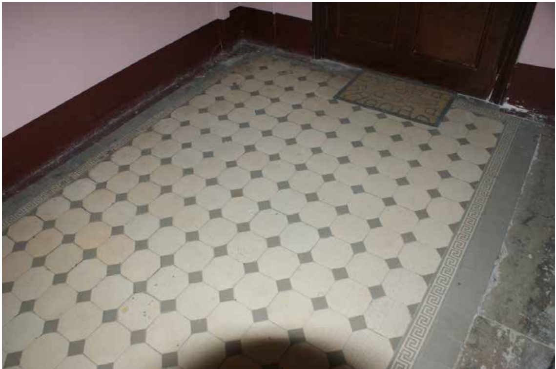
Фото 233. ЛК-8. Площадка 4-го этажа. Покрытие пола. Съемка 19.04.2021 г. Трушковский В.Э.
