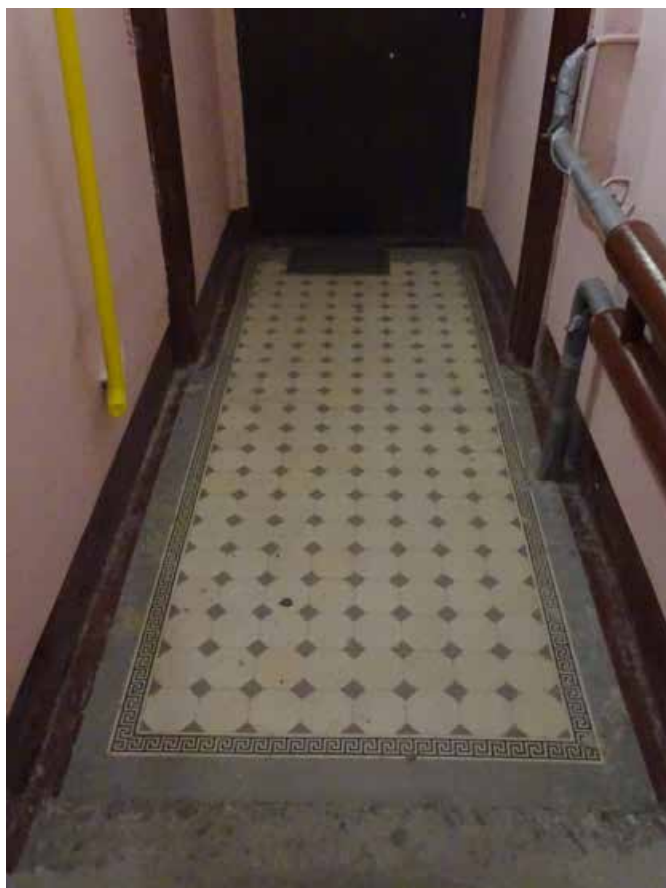
Фото 212. ЛК-8. Вестибюль 1-го этажа. Покрытие пола. Съемка 19.04.2021 г. Трушковский В.Э.
