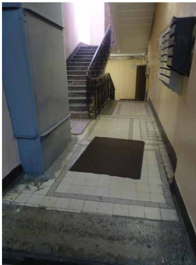
Фото 77. ЛК-3. Вестибюль 1-го этажа. Съемка 19.04.2021 г. Трушковский В.Э.
