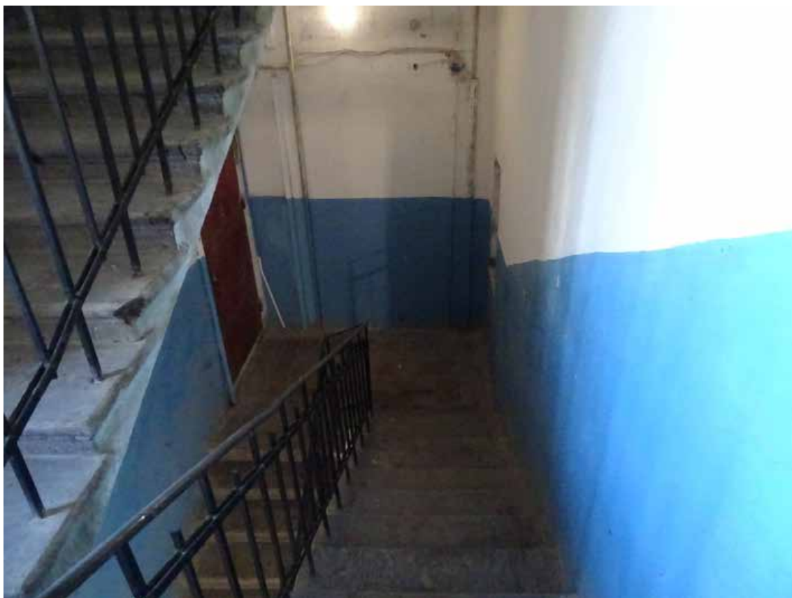
Фото 140. ЛК-5. Вид на площадку 4-го этажа. Съемка 19.04.2021 г. Трушковский В.Э.
