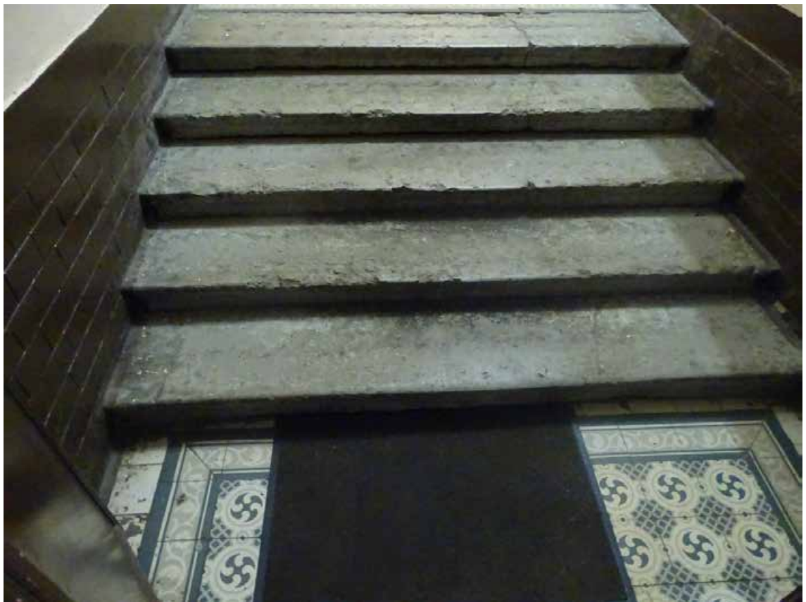
Фото 74. ЛК-3. Вестибюль 1-го этажа. Покрытие пола. Съемка 19.04.2021 г. Трушковский В.Э.
