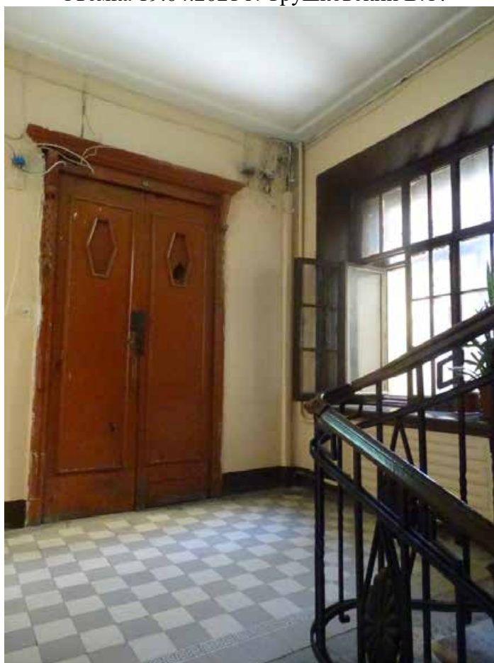
Фото 94. ЛК-3. Площадка между 3-м и 4-м этажом. Съемка 19.04.2021 г. Трушковский В.Э.
