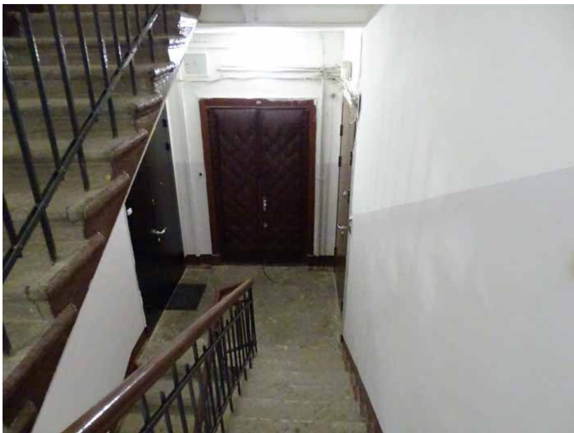
Фото 61. ЛК-2. Вид на площадку 5-го этажа. Съемка 19.04.2021 г. Трушковский В.Э.
