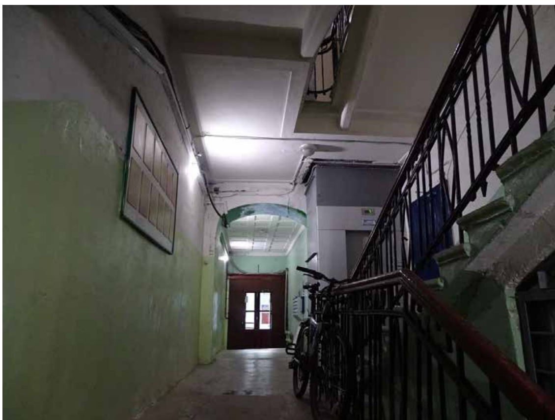
Фото 10. ЛК-1. Площадка 1-го этажа. Съемка 19.04.2021 г. Трушковский В.Э.
