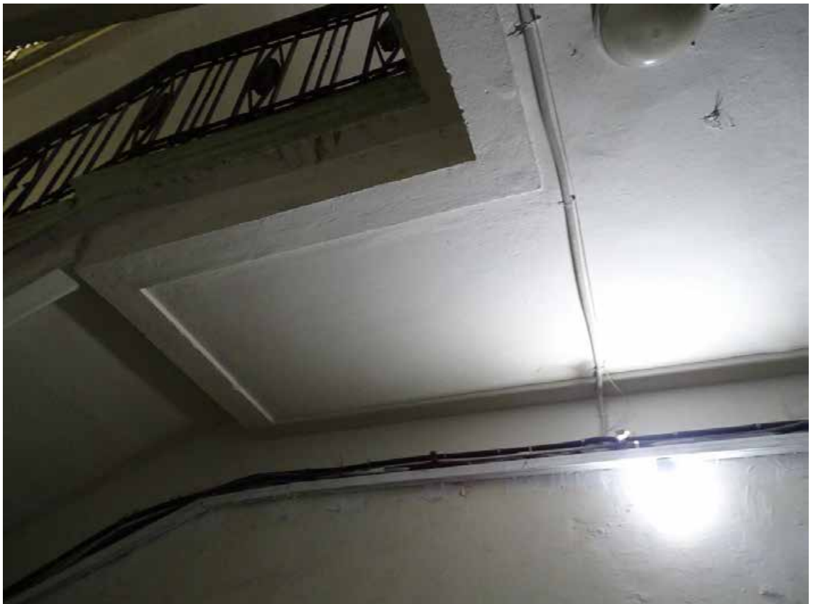
Фото 12. ЛК-1. Площадка 1-го этажа. Съемка 19.04.2021 г. Трушковский В.Э.
