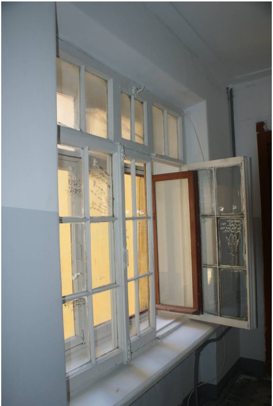
Фото 195. ЛК-6. Площадка между 4-м и 5-м этажом. Оформление окна. Съемка 19.04.2021 г. Трушковский В.Э.
