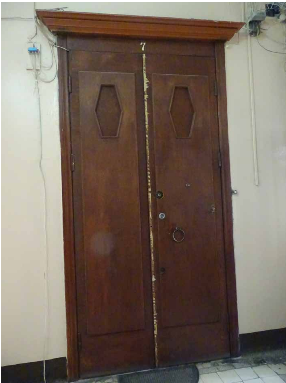
Фото 88. ЛК-3. Площадка между 2-м и 3-м этажом. Съемка 19.04.2021 г. Трушковский В.Э.
