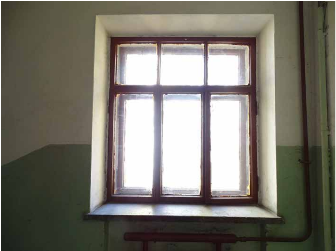
Фото 23. ЛК-1. Площадка между 2-м и 3-м этажом. Оформление окна. Съемка 19.04.2021 г. Трушковский В.Э.
