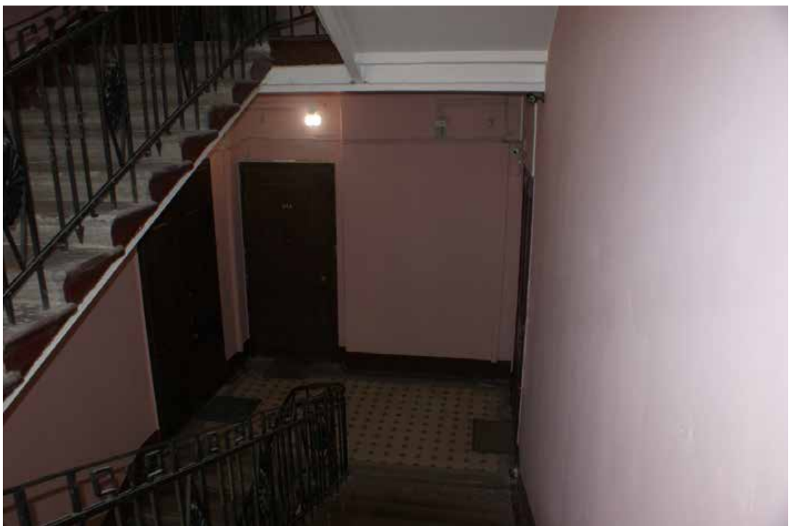
Фото 232. ЛК-8. Вид на площадку 4-го этажа. Съемка 19.04.2021 г. Трушковский В.Э.
