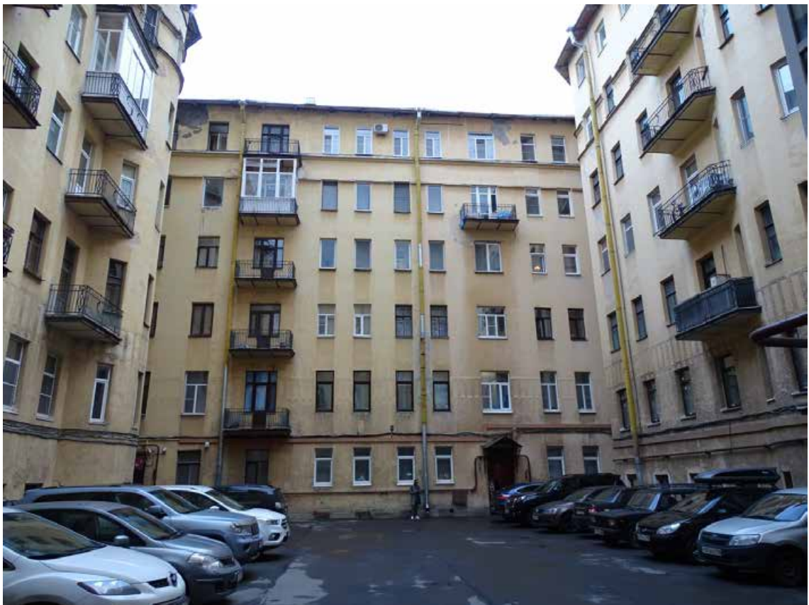
Фото 26. Здание по адресу: г. Санкт-Петербург, Большая Монетная ул., дом 29, литера А. Юго-восточный дворовой фасад. Съемка 19.04.2021 г. Трушковский В.Э.
