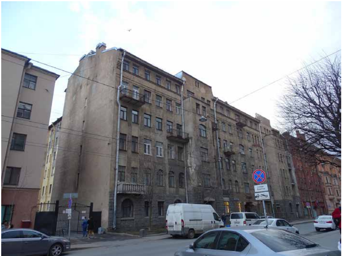
Фото 11. Здание по адресу: г. Санкт-Петербург, Большая Монетная ул., дом 29, литера А. Фрагмент фасада по Большой Монетной ул. Съемка 19.04.2021 г. Трушковский В.Э.
