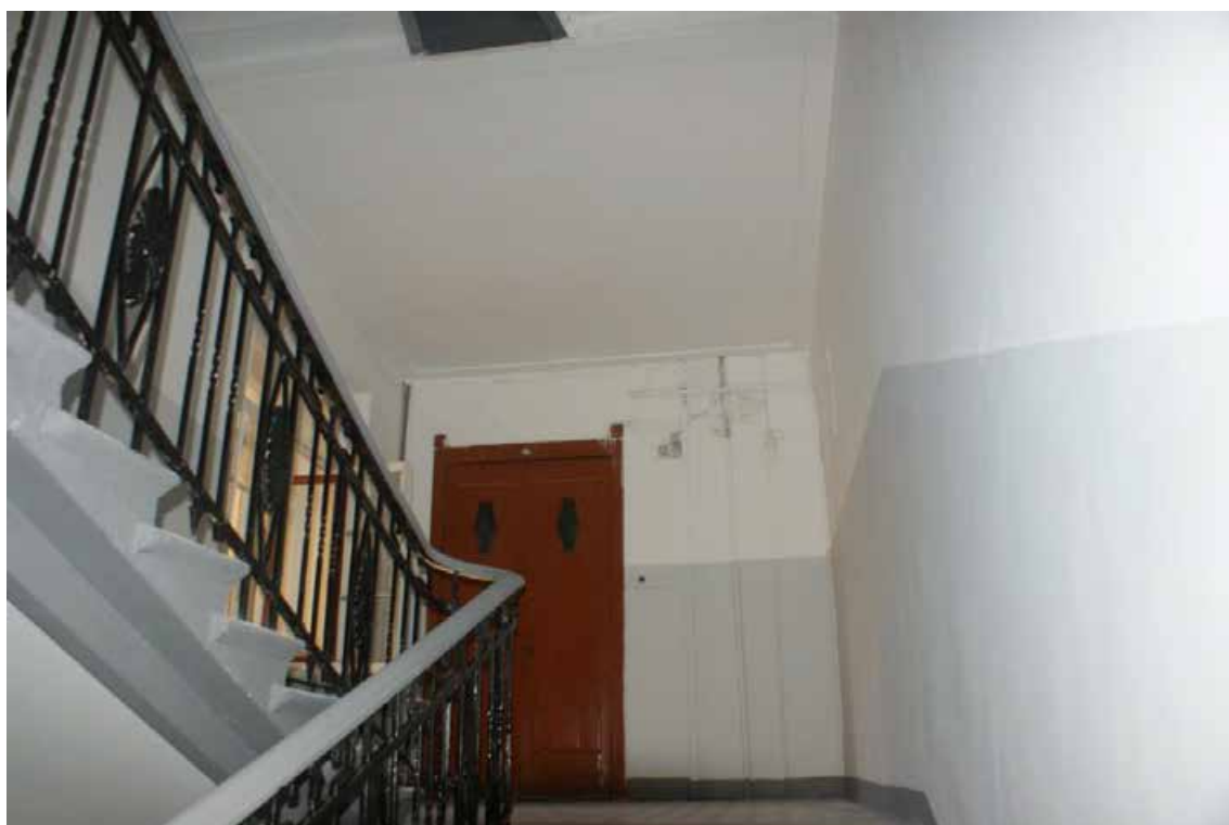
Фото 192. ЛК-6. Вид на площадку между 4-м и 5-м этажом. Съемка 19.04.2021 г. Трушковский В.Э.
