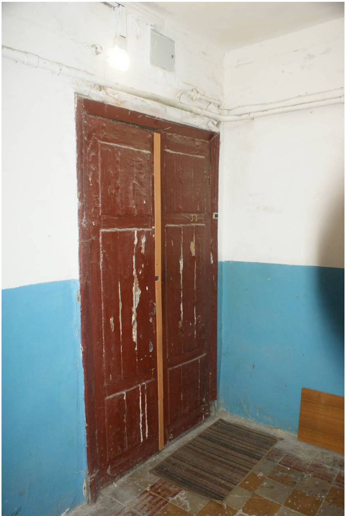
Фото 123. ЛК-5. Площадка 1-го этажа. Съемка 19.04.2021 г. Трушковский В.Э.
