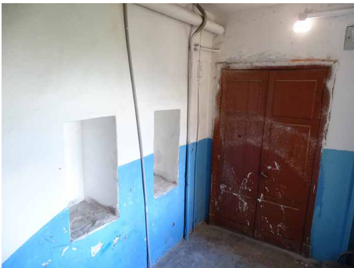
Фото 150. ЛК-5. Площадка между 5-м и 6-м этажом. Съемка 19.04.2021 г. Трушковский В.Э.
