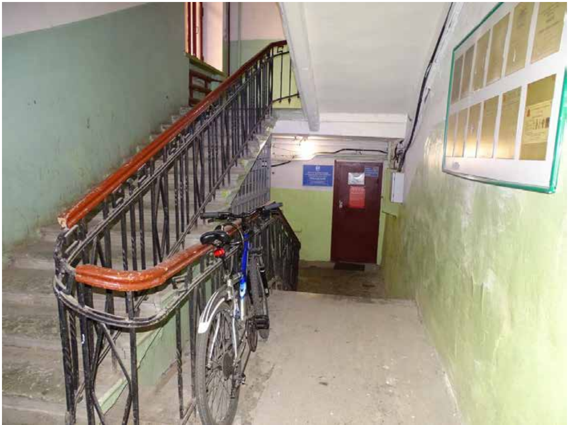
Фото 7. ЛК-1. Площадка 1-го этажа. Пространство под лестницей. Съемка 19.04.2021 г. Трушковский В.Э.
