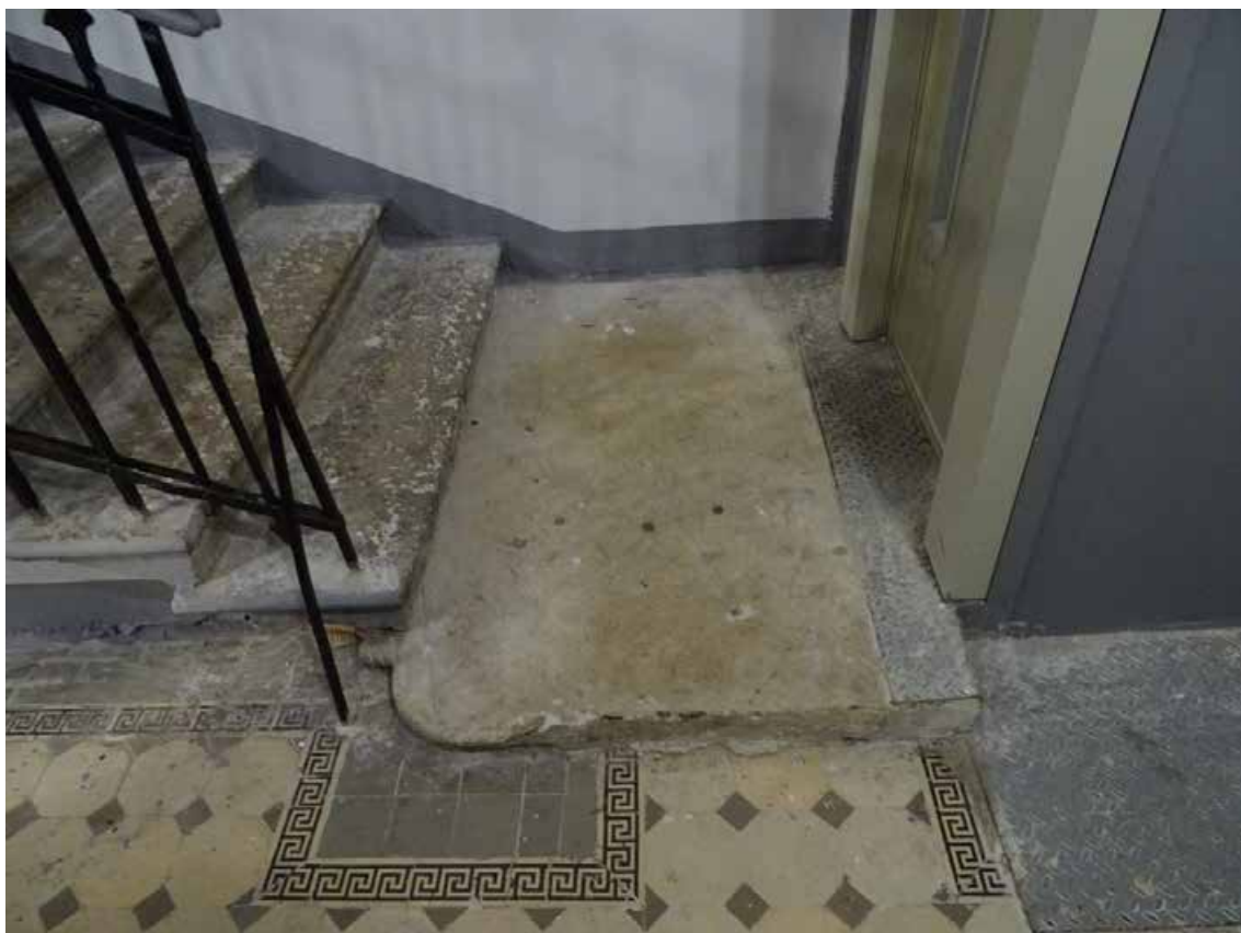
Фото 173. ЛК-6. Площадка 1-го этажа. Съемка 19.04.2021 г. Трушковский В.Э.
