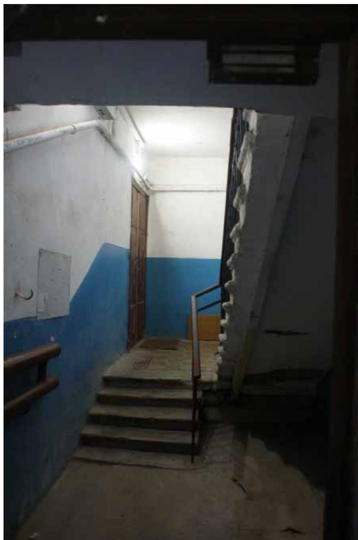
Фото 121. ЛК-5. Площадка 1-го этажа. Съемка 19.04.2021 г. Трушковский В.Э.
