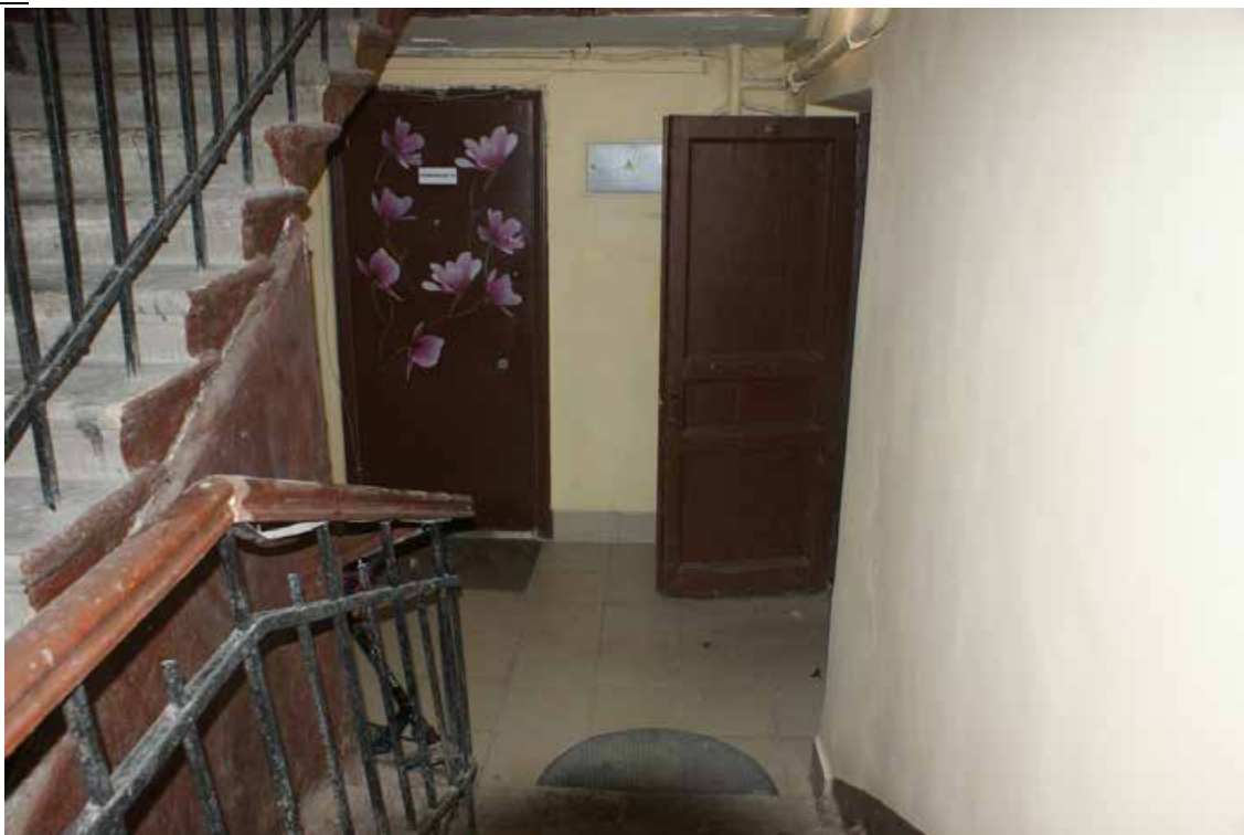
Фото 243. ЛК-9. Вестибюль 1-го этажа. Съемка 19.04.2021 г. Трушковский В.Э.
