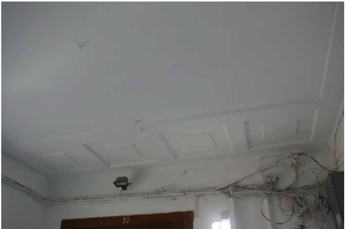
Фото 207. ЛК-6. Вид на площадку между 6-м и чердачным этажом. Оформление потолка. Съемка 19.04.2021 г. Трушковский В.Э.
