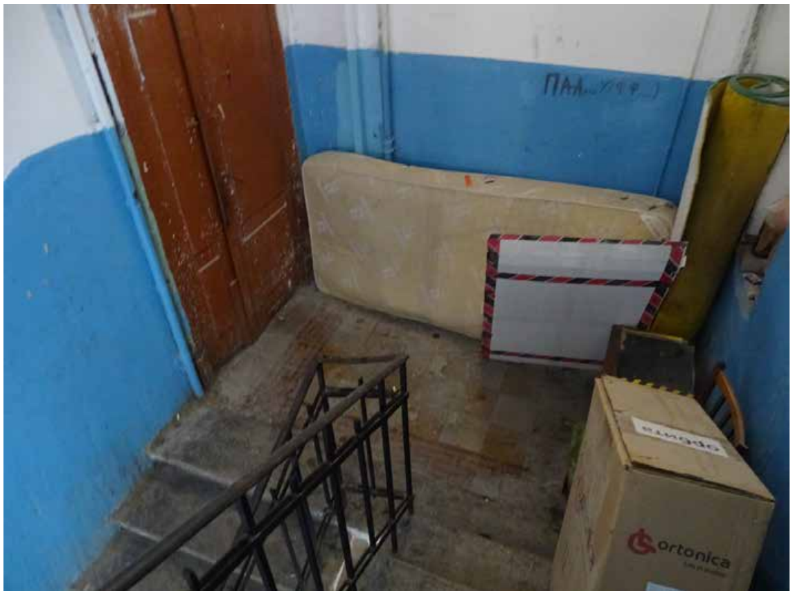
Фото 147. ЛК-5. Площадка 5-го этажа. Съемка 19.04.2021 г. Трушковский В.Э.
