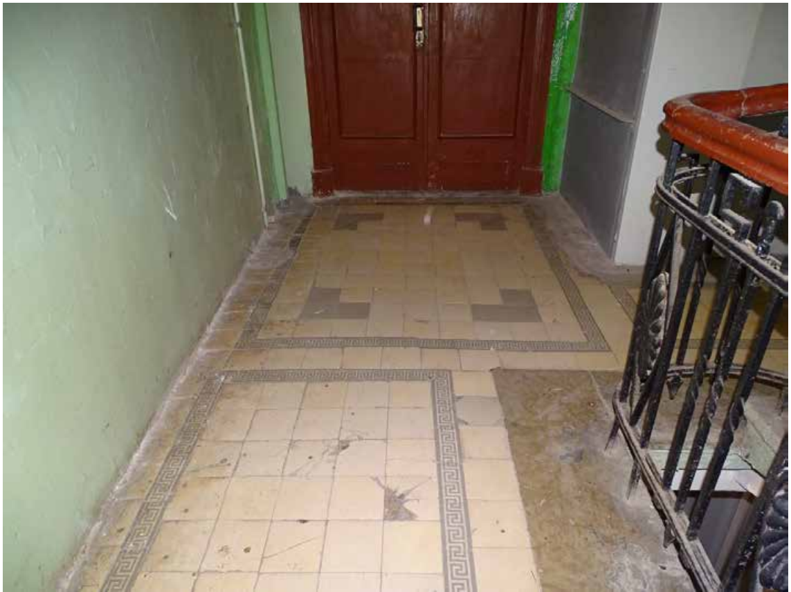
Фото 17. ЛК-1. Площадка 2-го этажа. Покрытие пола. Съемка 19.04.2021 г. Трушковский В.Э.
