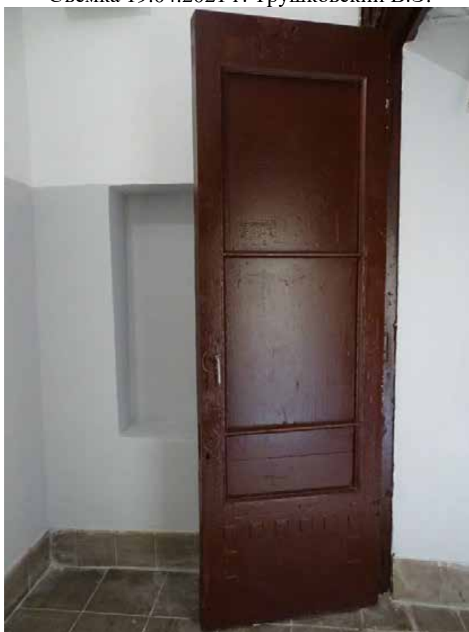
Фото 160. ЛК-6. Вестибюль 1-го этажа. Входная дверь. Съемка 19.04.2021 г. Трушковский В.Э.
