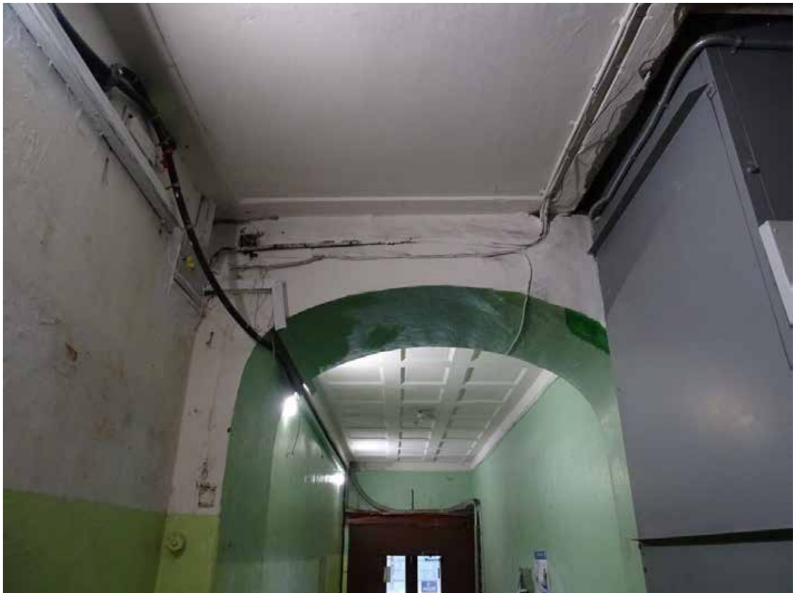
Фото 11. ЛК-1. Площадка 1-го этажа. Съемка 19.04.2021 г. Трушковский В.Э.
