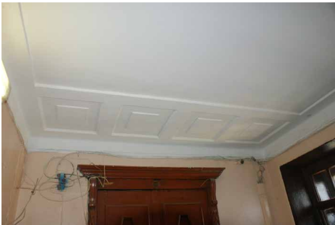
Фото 112. ЛК-3. Площадка 6-го этажа. Съемка 19.04.2021 г. Трушковский В.Э.
