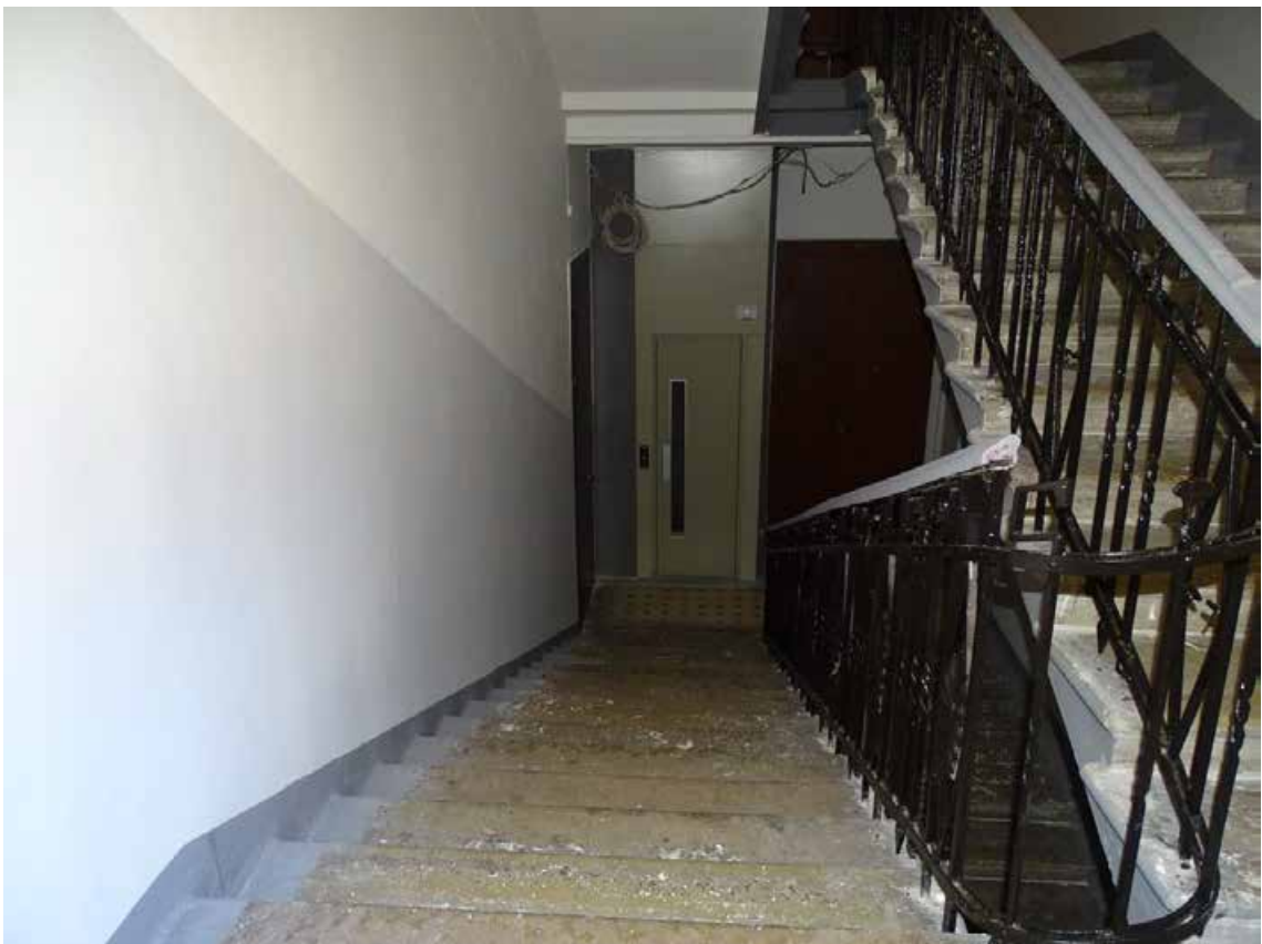
Фото 190. ЛК-6. Вид на площадку 4-го этажа. Съемка 19.04.2021 г. Трушковский В.Э.
