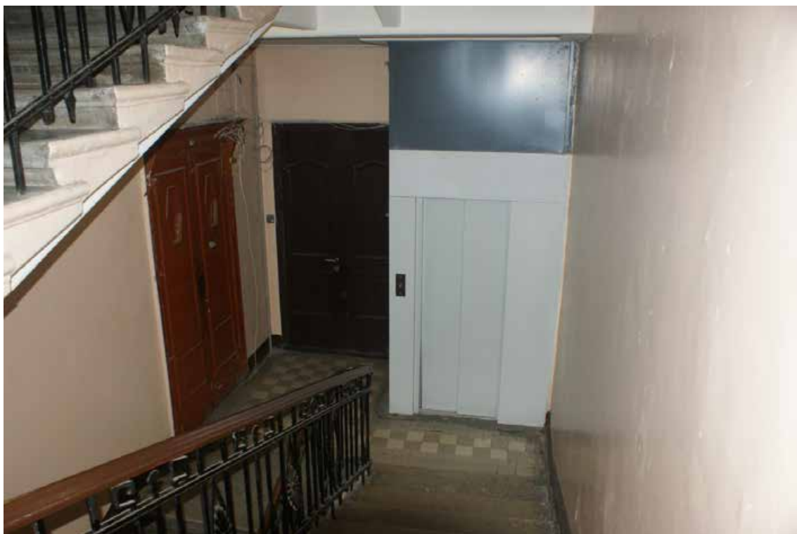
Фото 99. ЛК-3. Вид на площадку 4-го этажа. Съемка 19.04.2021 г. Трушковский В.Э.
