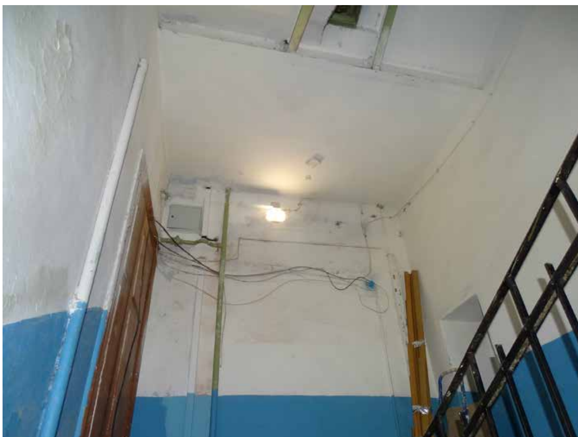
Фото 154. ЛК-5. Площадка 6-го этажа. Съемка 19.04.2021 г. Трушковский В.Э.
