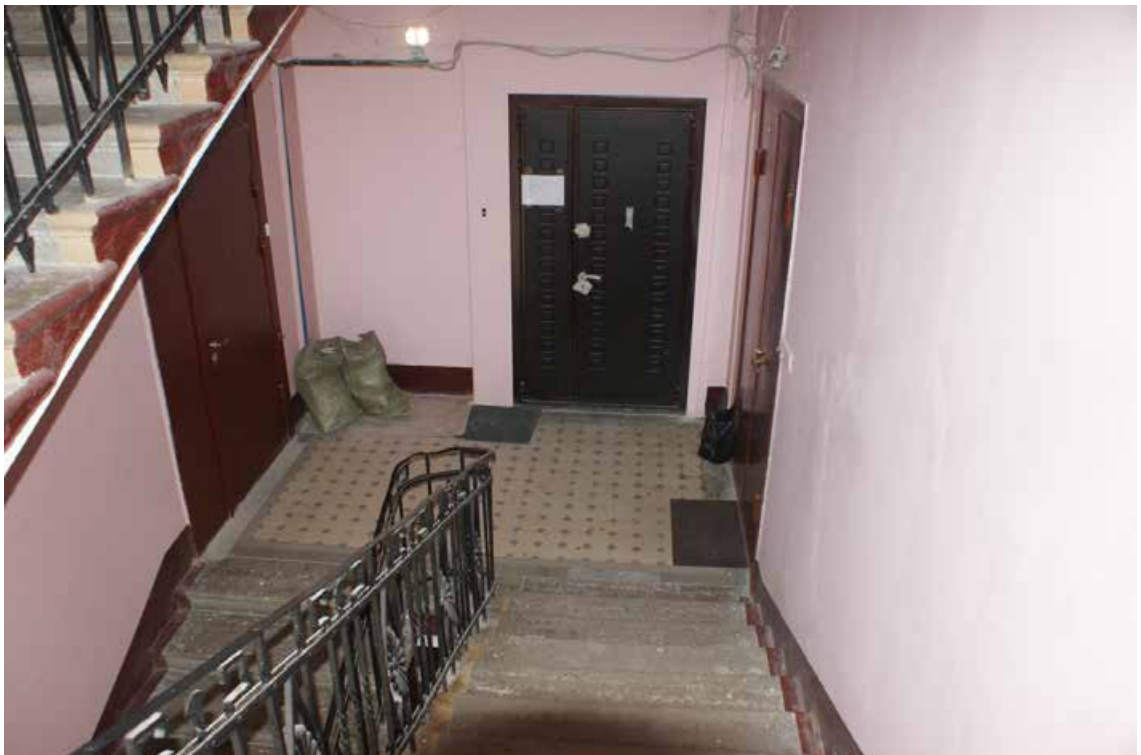
Фото 236. ЛК-8. Вид на площадку 5-го этажа. Съемка 19.04.2021 г. Трушковский В.Э.
