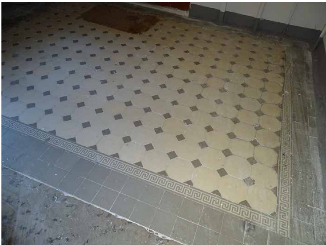
Фото 183. ЛК-6. Площадка между 2-м и 3-м этажом. Покрытие пола. Съемка 19.04.2021 г. Трушковский В.Э.
