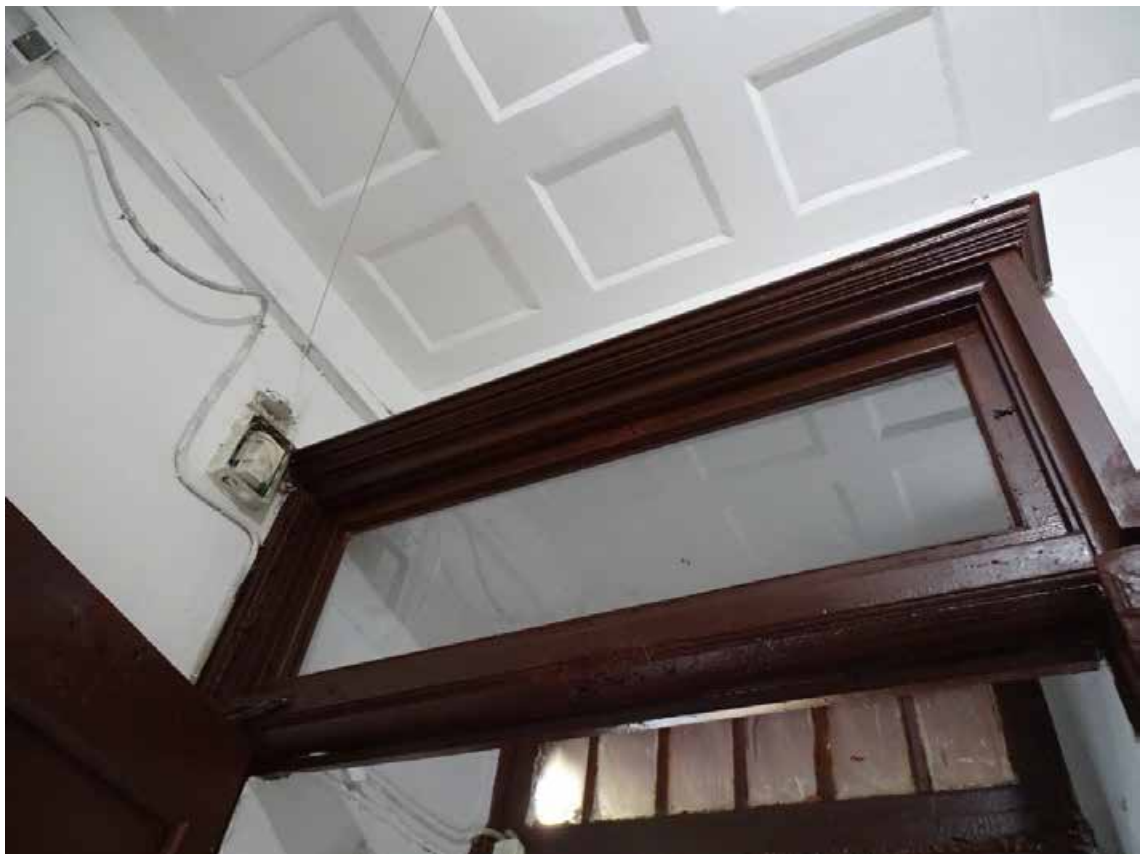
Фото 161. ЛК-6. Вестибюль 1-го этажа. Входная дверь. Съемка 19.04.2021 г. Трушковский В.Э.
