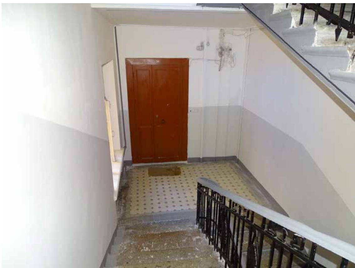
Фото 182. ЛК-6. Вид на площадку между 2-м и 3-м этажом. Съемка 19.04.2021 г. Трушковский В.Э.
