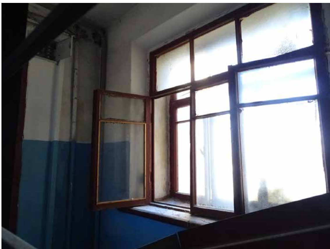
Фото 156. ЛК-5. Площадка между 6-м и чердачным этажом. Оформление окна. Съемка 19.04.2021 г. Трушковский В.Э.
