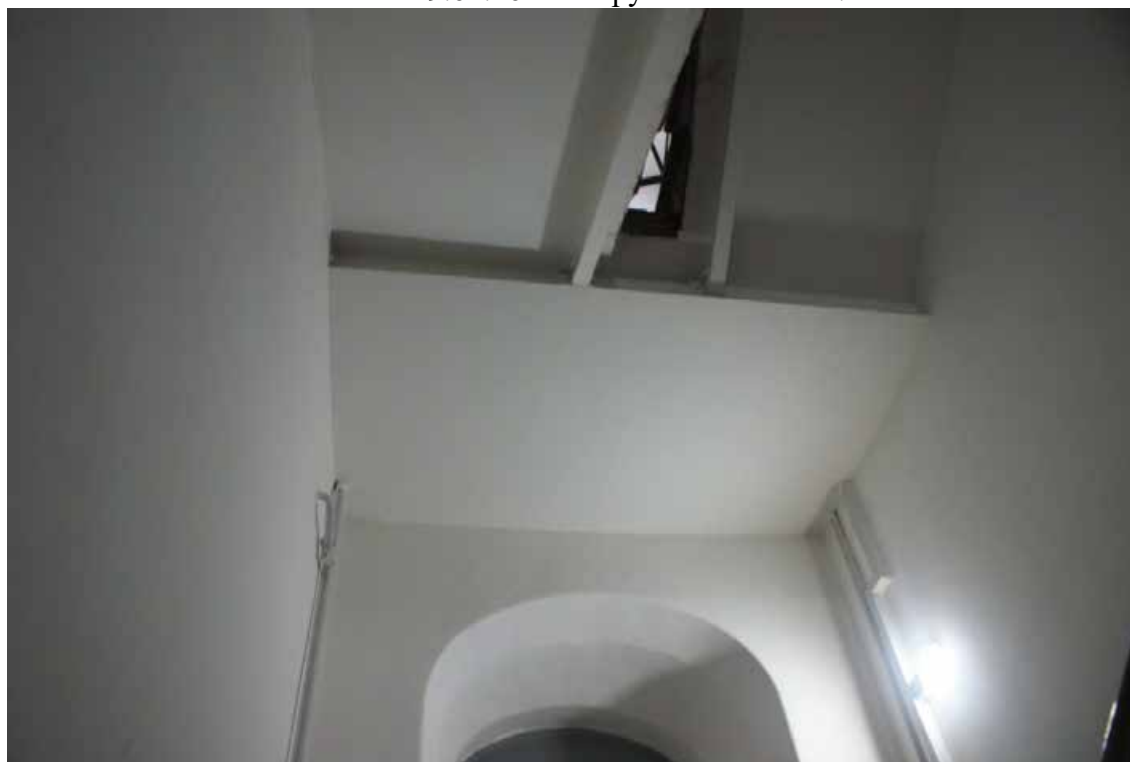
Фото 50. ЛК-2. Площадка между 2-м и 3-м этажом. Съемка 19.04.2021 г. Трушковский В.Э.
