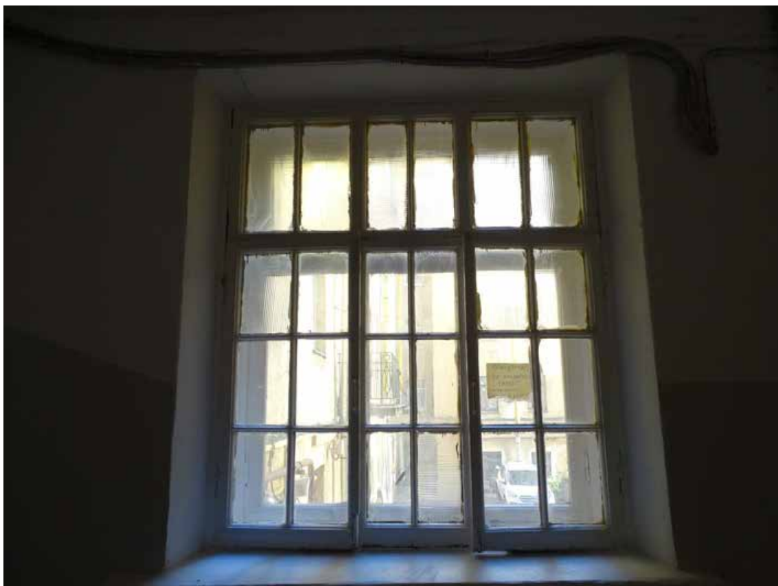
Фото 177. ЛК-6. Площадка между 1-м и 2-м этажом. Съемка 19.04.2021 г. Трушковский В.Э.
