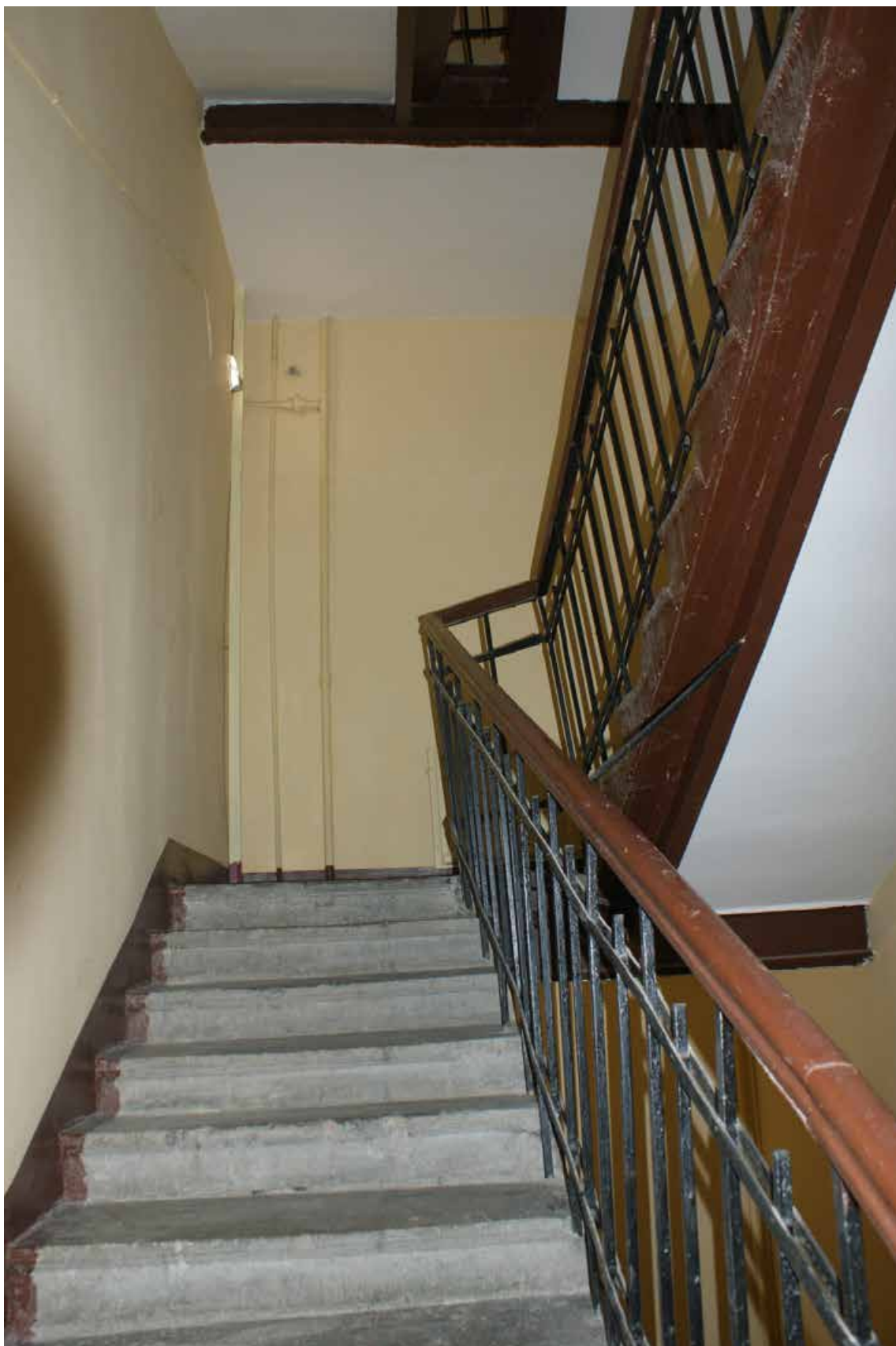
Фото 259. ЛК-9. Вид на площадку между 4-м и 5-м этажом. Съемка 19.04.2021 г. Трушковский В.Э.
