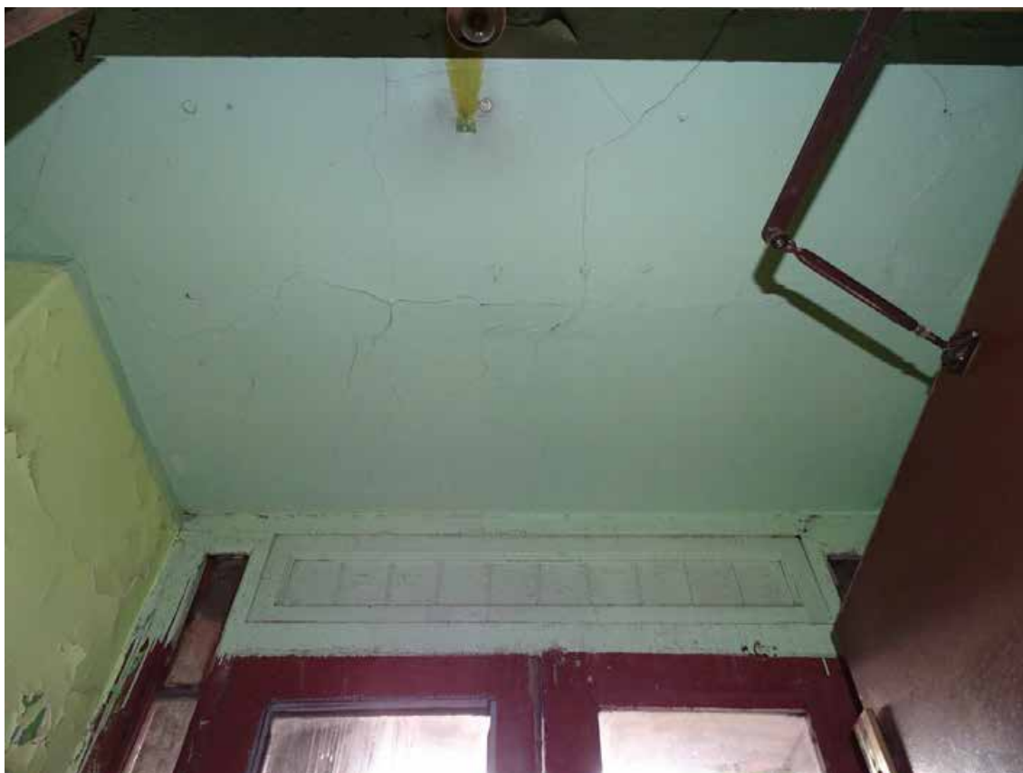
Фото 3. ЛК-1. Тамбур. 1-й этаж. Съемка 19.04.2021 г. Трушковский В.Э.
