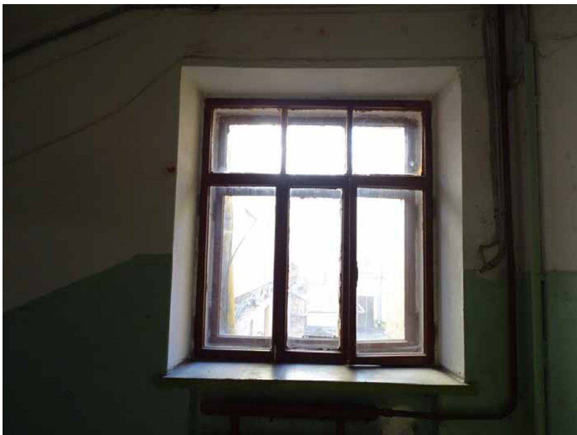
Фото 15. ЛК-1. Площадка между 1-м и 2-м этажом. Съемка 19.04.2021 г. Трушковский В.Э.
