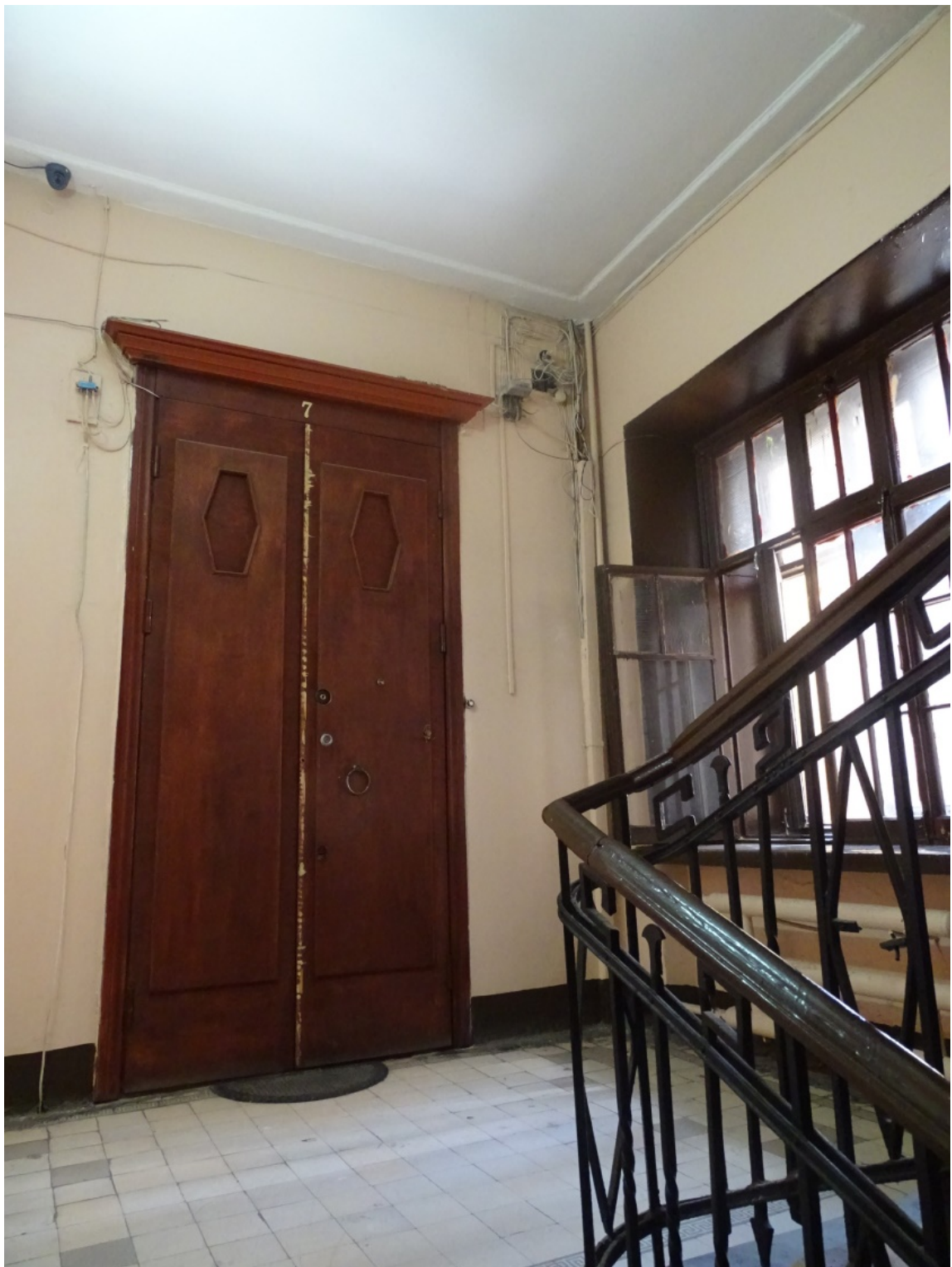
Фото 87. ЛК-3. Площадка между 2-м и 3-м этажом. Съемка 19.04.2021 г. Трушковский В.Э.
