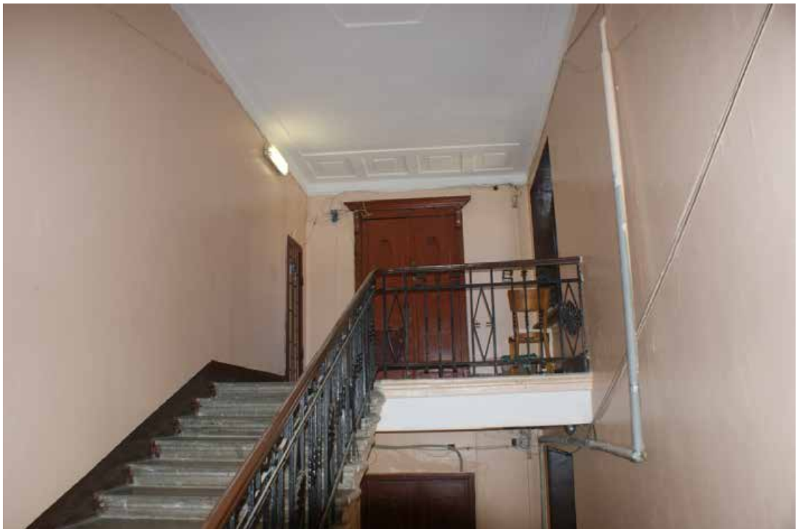
Фото 111. ЛК-3. Вид на площадку 6-го этажа. Съемка 19.04.2021 г. Трушковский В.Э.
