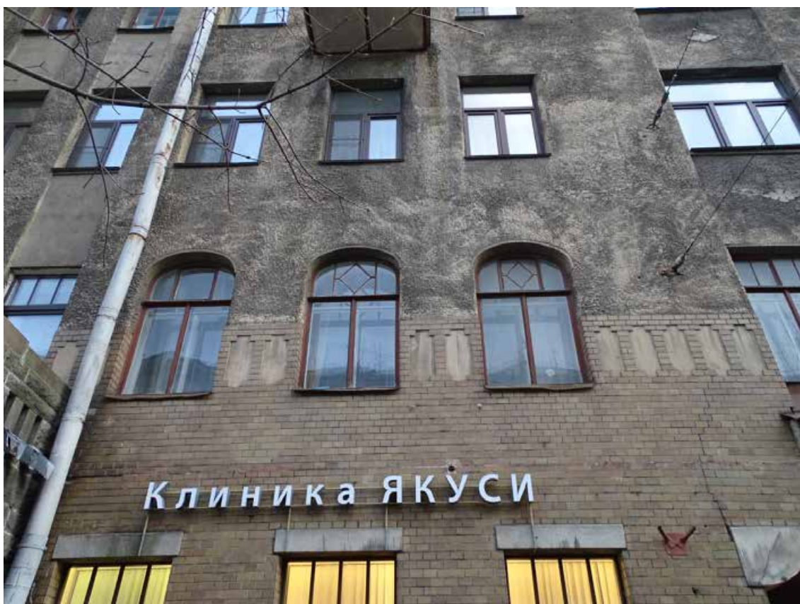
Фото 19 Здание по адресу: г. Санкт-Петербург, Большая Монетная ул., дом 29, литера А. Фрагмент фасада по Большой Монетной ул. Съемка 19.04.2021 г. Трушковский В.Э.
