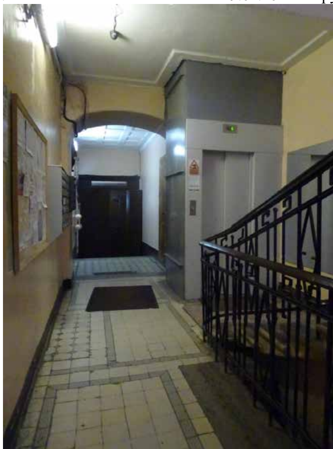
Фото 82. ЛК-3. Вестибюль 1-го этажа. Съемка 19.04.2021 г. Трушковский В.Э.
