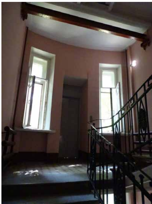
Фото 227. ЛК-8. Вид на площадку между 2-м и 3-м этажом. Съемка 19.04.2021 г. Трушковский В.Э.
