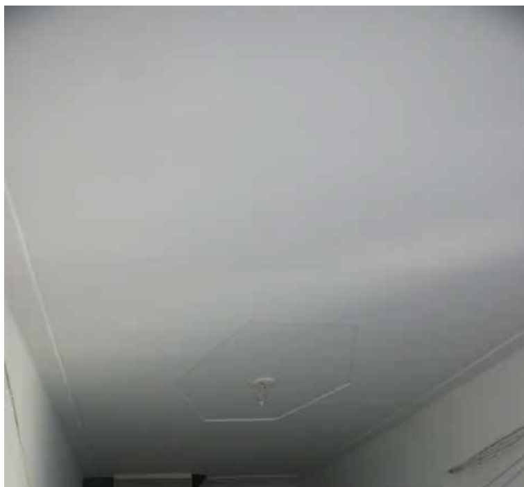
Фото 208. ЛК-6. Вид на площадку между 6-м и чердачным этажом. Оформление потолка. Съемка 19.04.2021 г. Трушковский В.Э.
