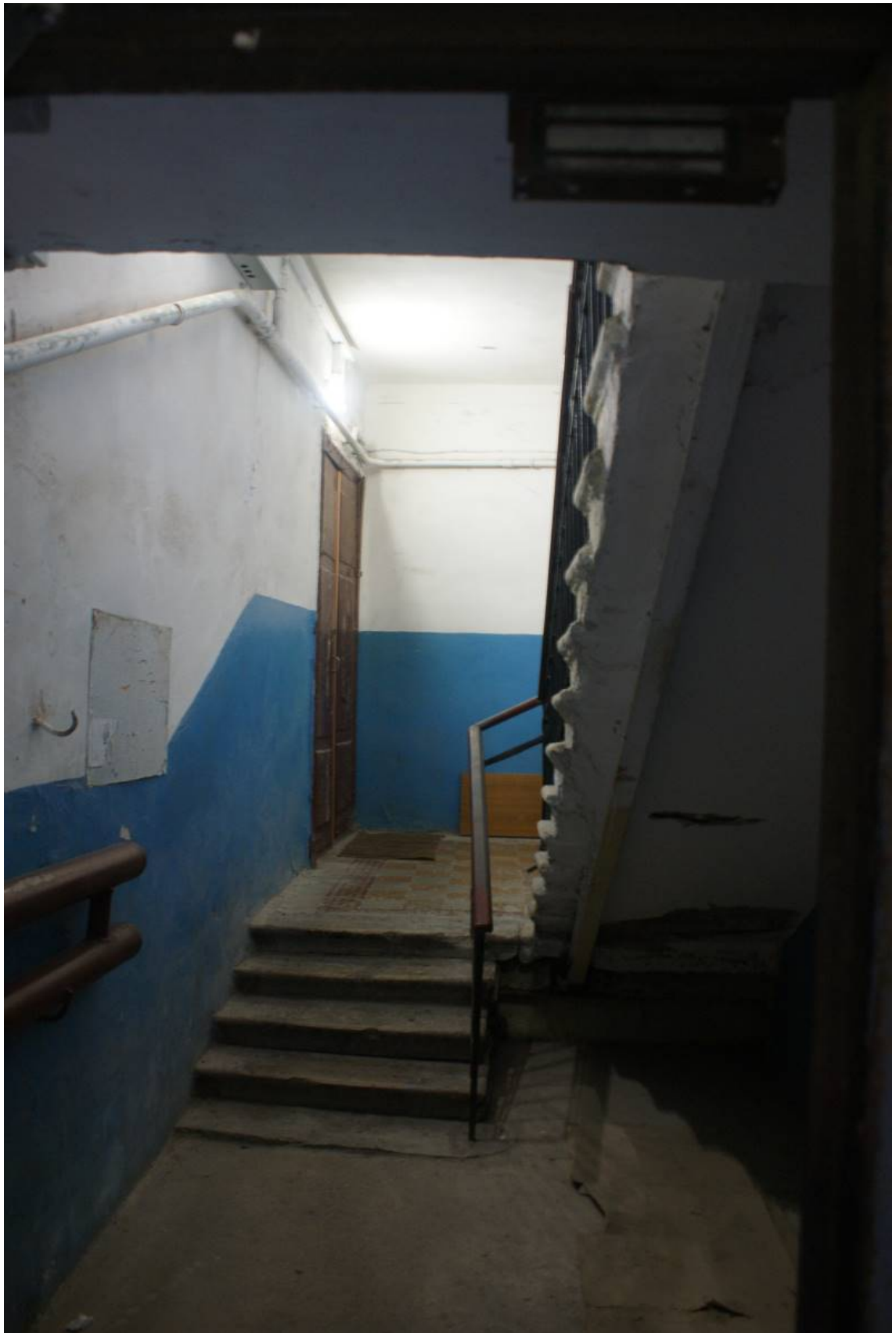
Фото 119. ЛК-5. Вестибюль 1-го этажа. Съемка 19.04.2021 г. Трушковский В.Э.
