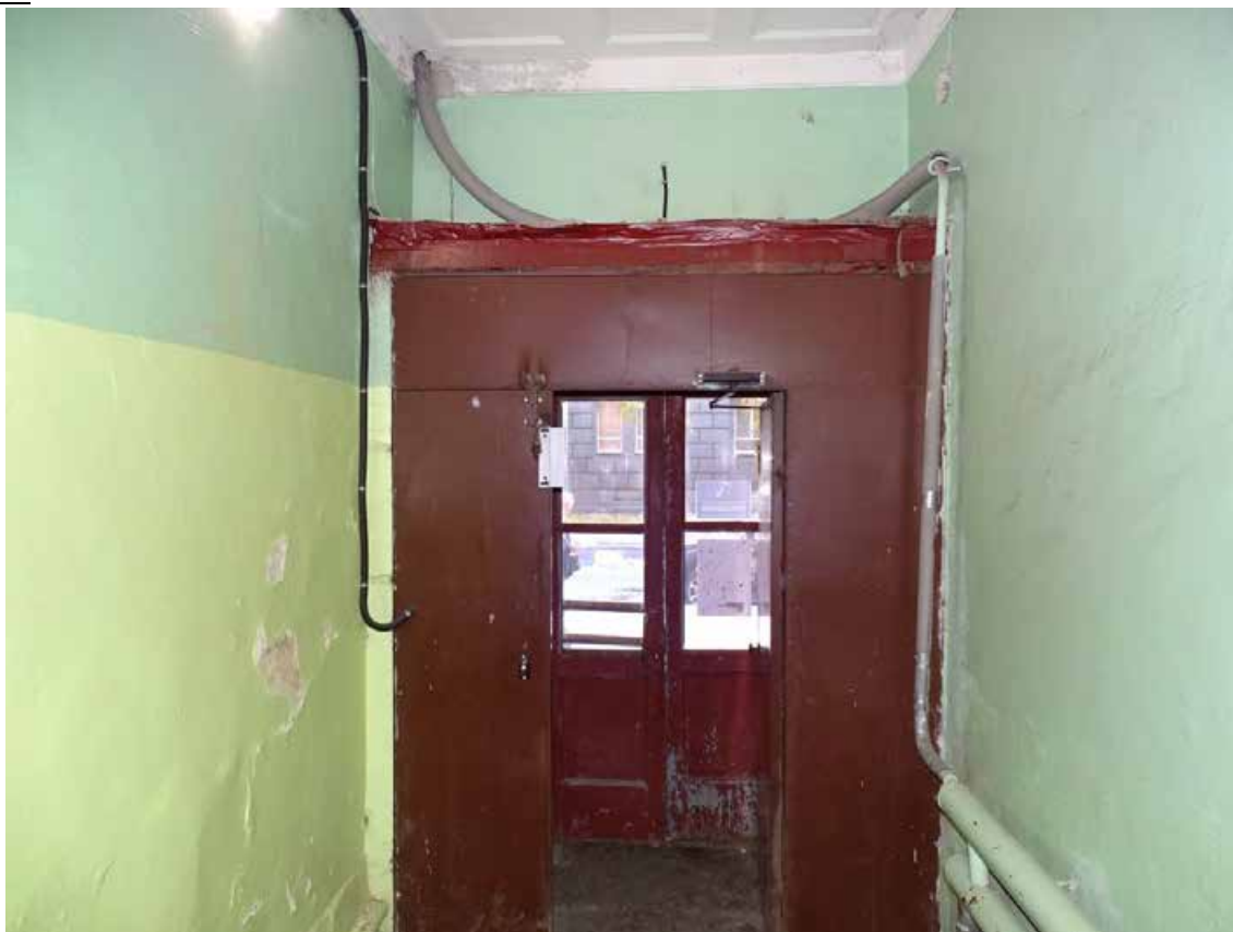
Фото 1. ЛК-1 Вестибюль 1-го этажа. Входная дверь. Съемка 001 г. Трушковский В.Э.
