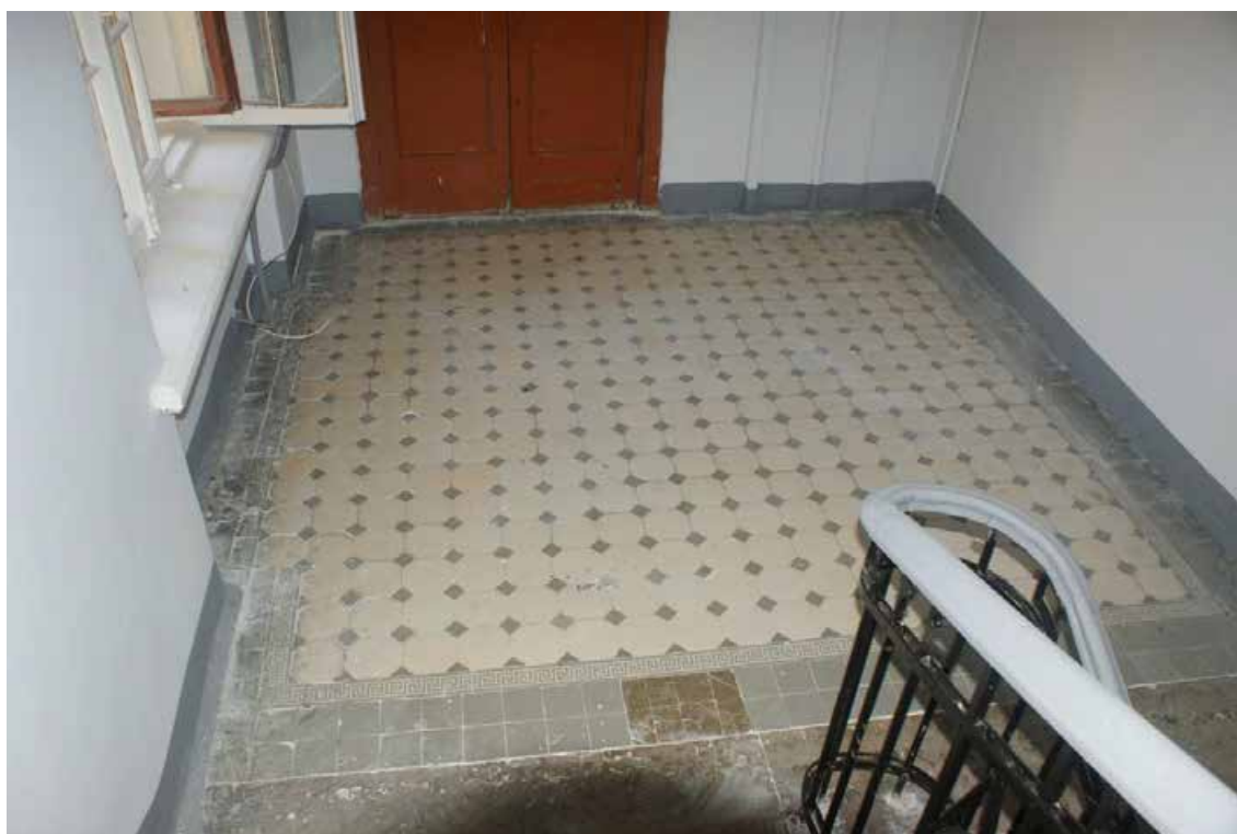
Фото 194. ЛК-6. Площадка между 4-м и 5-м этажом. Покрытие пола. Съемка 19.04.2021 г. Трушковский В.Э.
