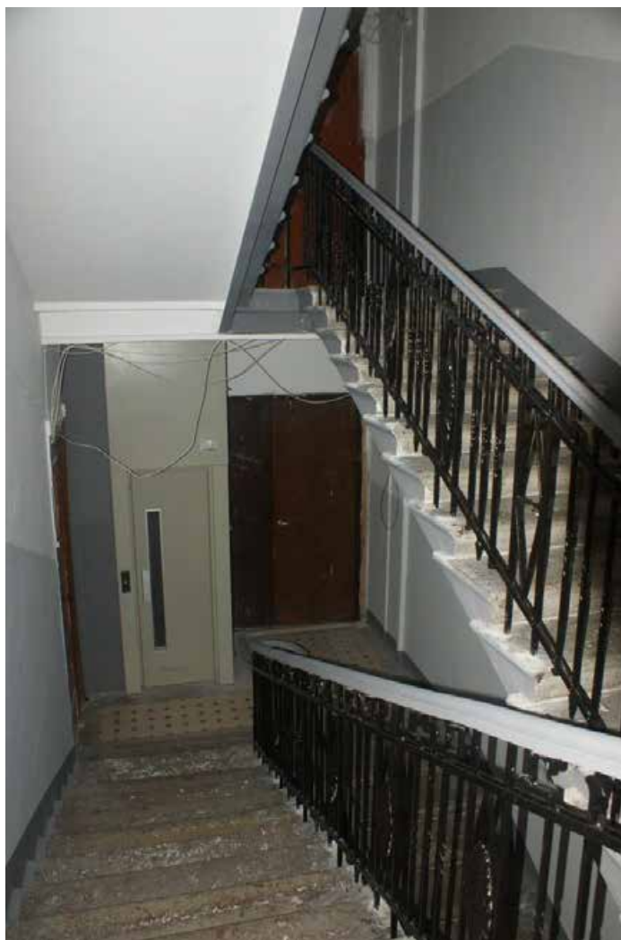
Фото 196. ЛК-6. Вид на площадку 5-го этажа. Съемка 19.04.2021 г. Трушковский В.Э.
