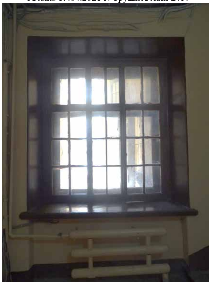
Фото 84. ЛК-3. Площадка между 1-м и 2-м этажом. Съемка 19.04.2021 г. Трушковский В.Э.
