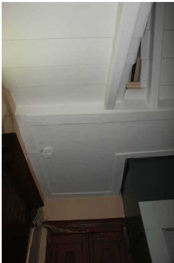
Фото 101. ЛК-3. Площадка 4-го этажа. Съемка 19.04.2021 г. Трушковский В.Э.
