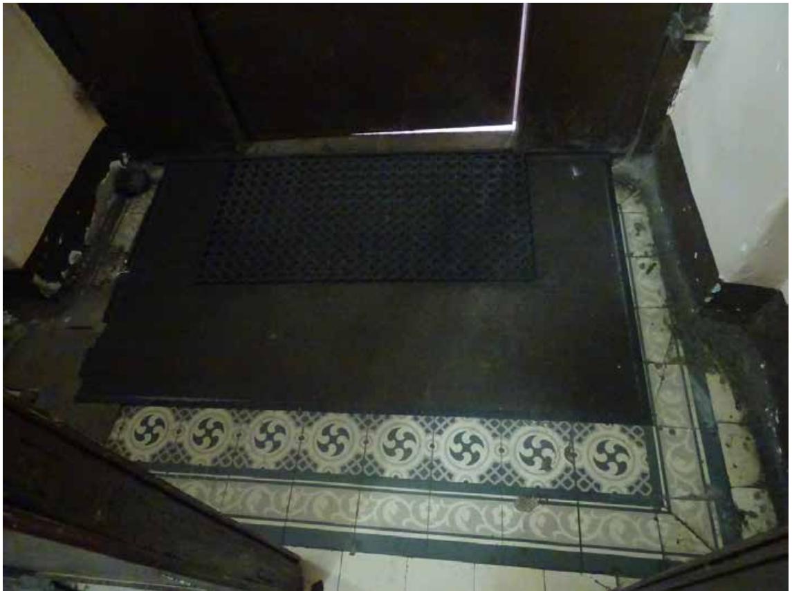
Фото 73. ЛК-3:Вестибюль 1-го этажа. Покрытие пола. Съемка 19.04.2021 г. Трушковский В.Э.
