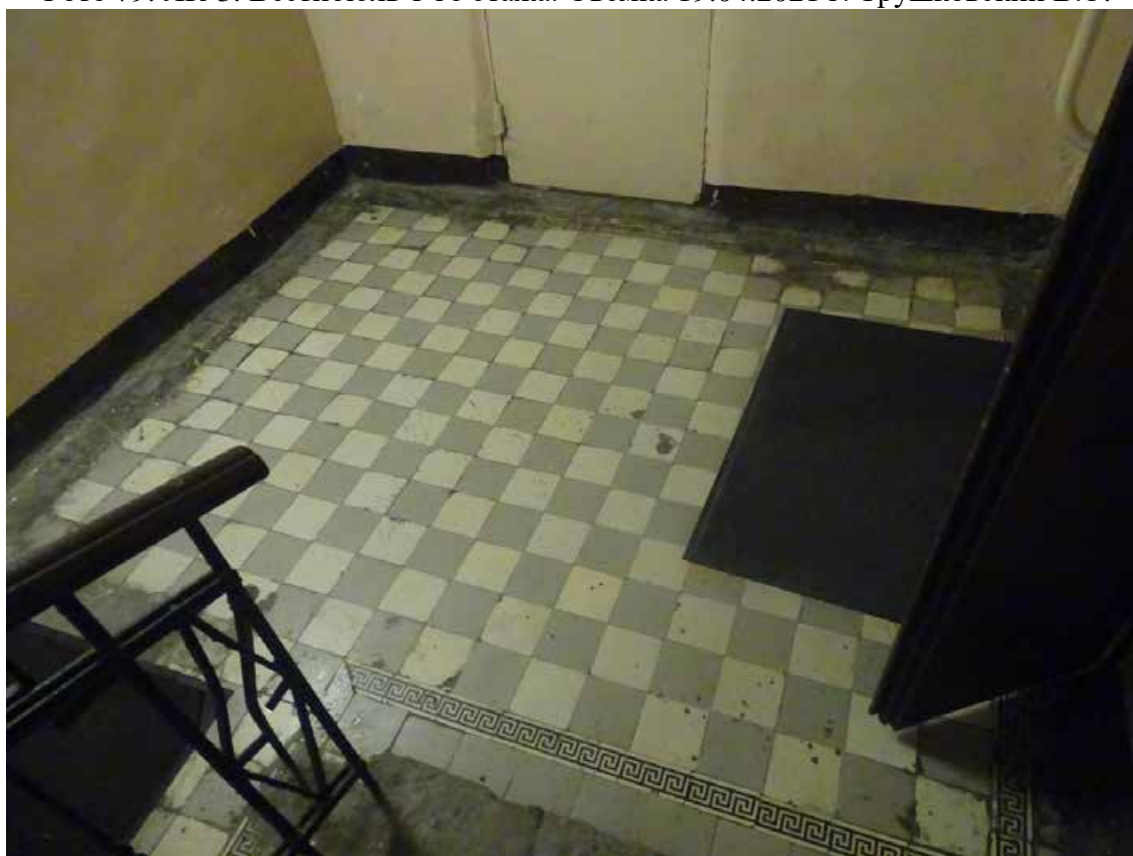
Фото 80. ЛК-3. Вестибюль 1-го этажа. Покрытие пола. Съемка 19.04.2021 г. Трушковский В.Э.
