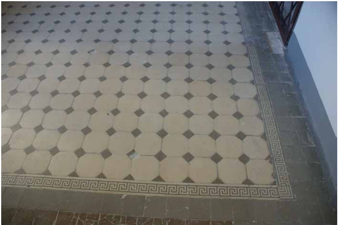
Фото 206. ЛК-6. Вид на площадку между 6-м и чердачным этажом. Покрытие пола. Съемка 19.04.2021 г. Трушковский В.Э.
