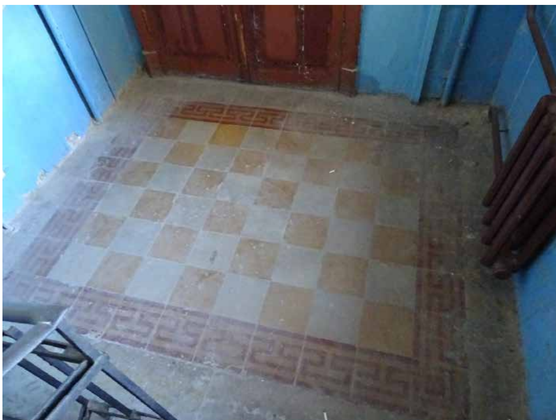
Фото 144. ЛК-5. Площадка между 4-м и 5-м этажом. Съемка 19.04.2021 г. Трушковский В.Э.
