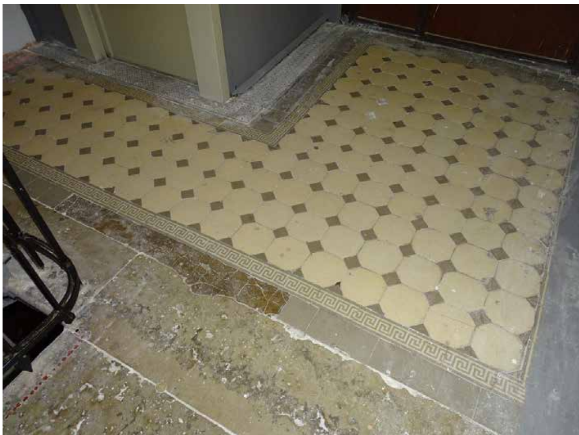
Фото 191. ЛК-6. Площадка 4-го этажа. Покрытие пола. Съемка 19.04.2021 г. Трушковский В.Э.
