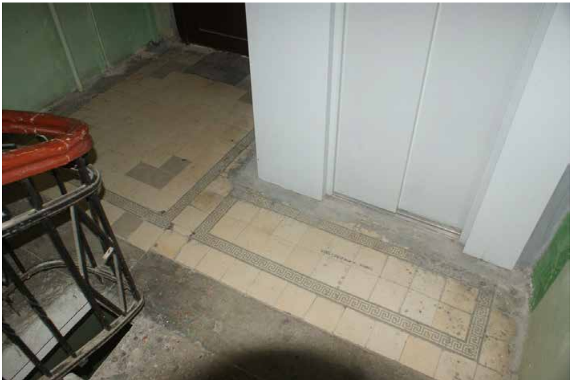
Фото 32. ЛК-1. 5-й этаж. Покрытие пола. Съемка 19.04.2021 г. Трушковский В.Э.
