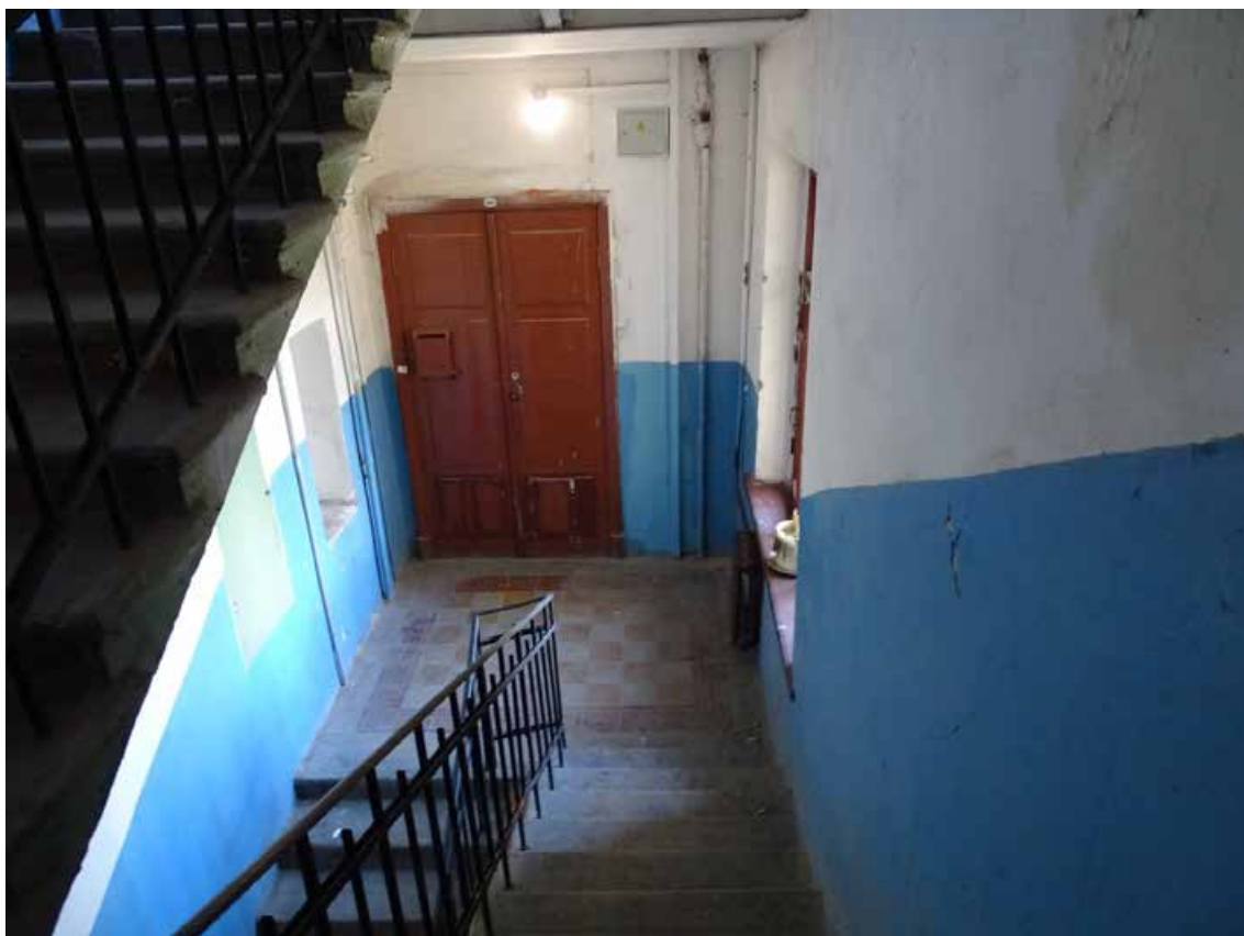
Фото 143. ЛК-5. Вид на площадку между 4-м и 5-м этажом. Съемка 19.04.2021 г. Трушковский В.Э.
