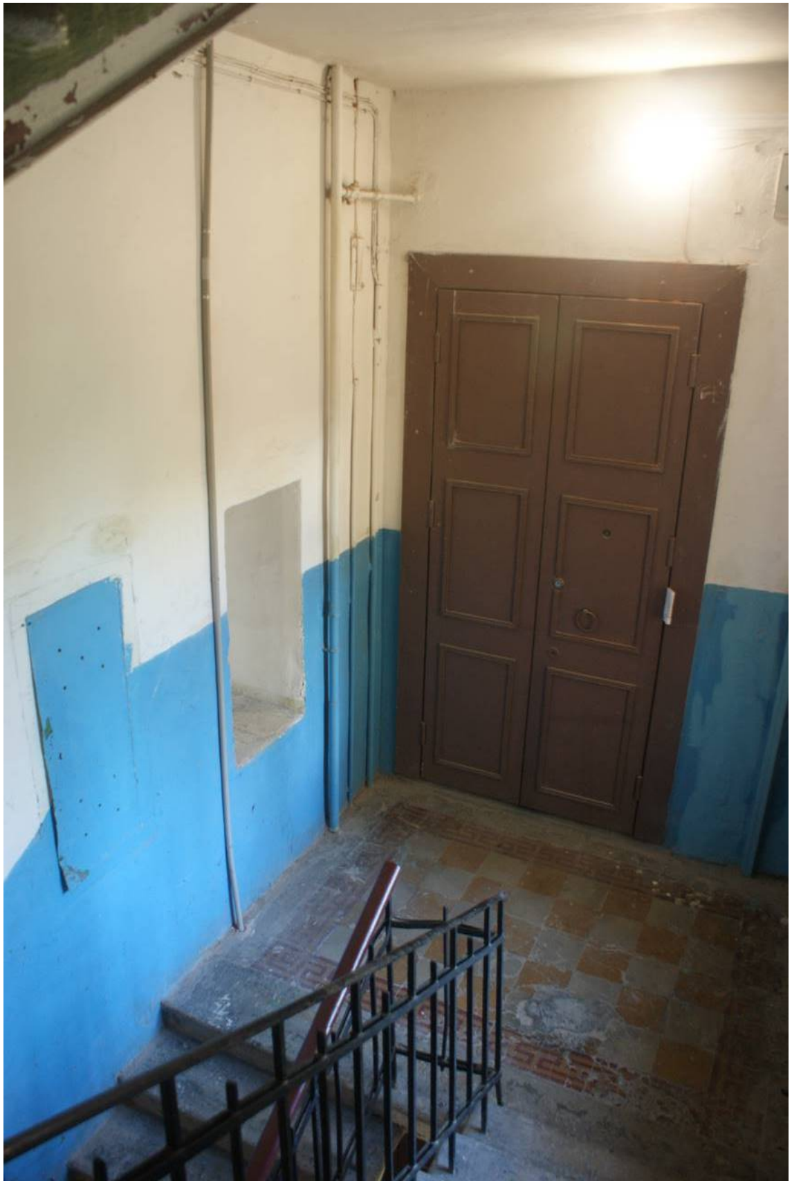
Фото 131. ЛК-5. Вид на площадку между 2-м и 3-м этажом. Съемка 19.04.2021 г. Трушковский В.Э.
