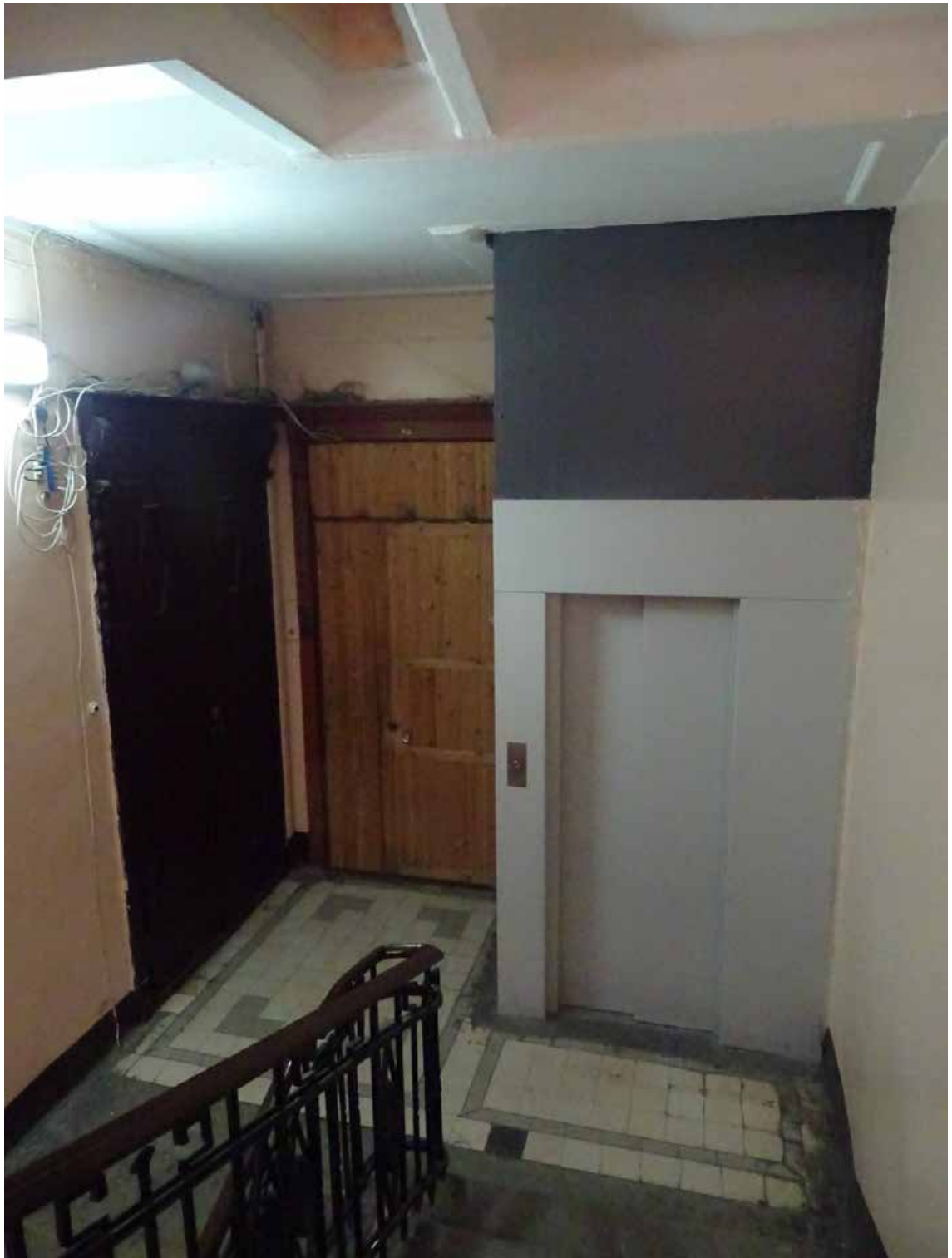
Фото 91. ЛК-3. Площадка 3-го этажа. Съемка 19.04.2021 г. Трушковский В.Э.
