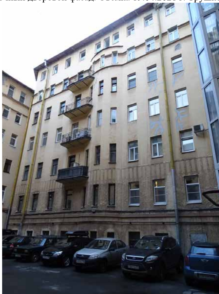
Фото 28. Здание по адресу: г. Санкт-Петербург, Большая Монетная ул., дом 29, литера А. Фрагмент западного дворового фасада. Съемка 19.04.2021 г. Трушковский В.Э.
