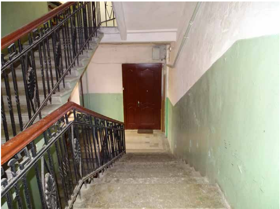
Фото 14. ЛК-1. Площадка между 1-м и 2-м этажом. Съемка 19.04.2021 г. Трушковский В.Э.
