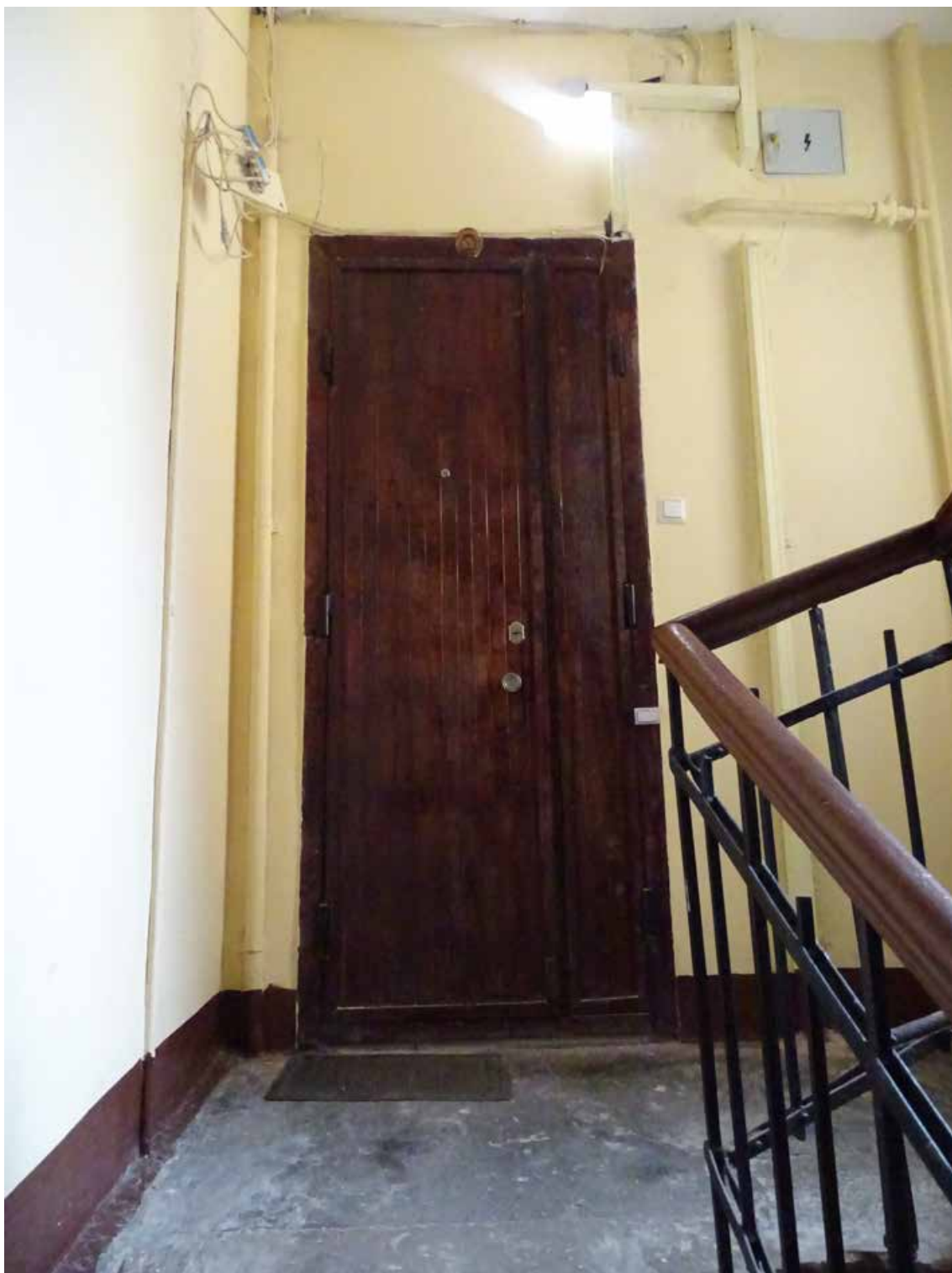
Фото 264. ЛК-9. Площадка 6-го этажа. Дверной проем. Съемка 19.04.2021 г. Трушковский В.Э.
