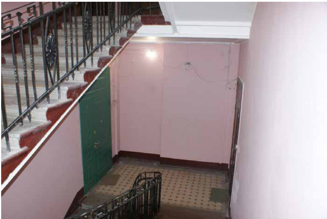
Фото 229. ЛК-8. Вид на площадку 3-го этажа. Съемка 19.04.2021 г. Трушковский В.Э.
