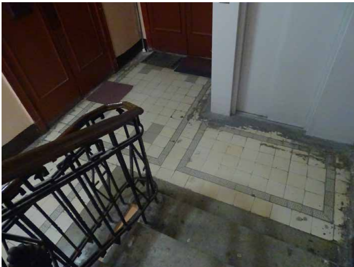
Фото 85. ЛК-3. Площадка 2-го этажа. Съемка 19.04.2021 г. Трушковский В.Э.
