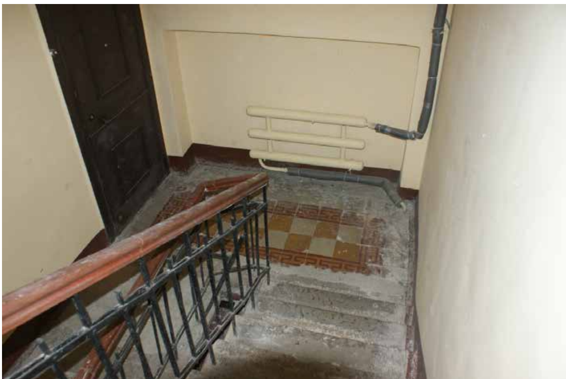
Фото 247. ЛК-9. Площадка между 1-м и 2-м этажом. Съемка 19.04.2021 г. Трушковский В.Э.
