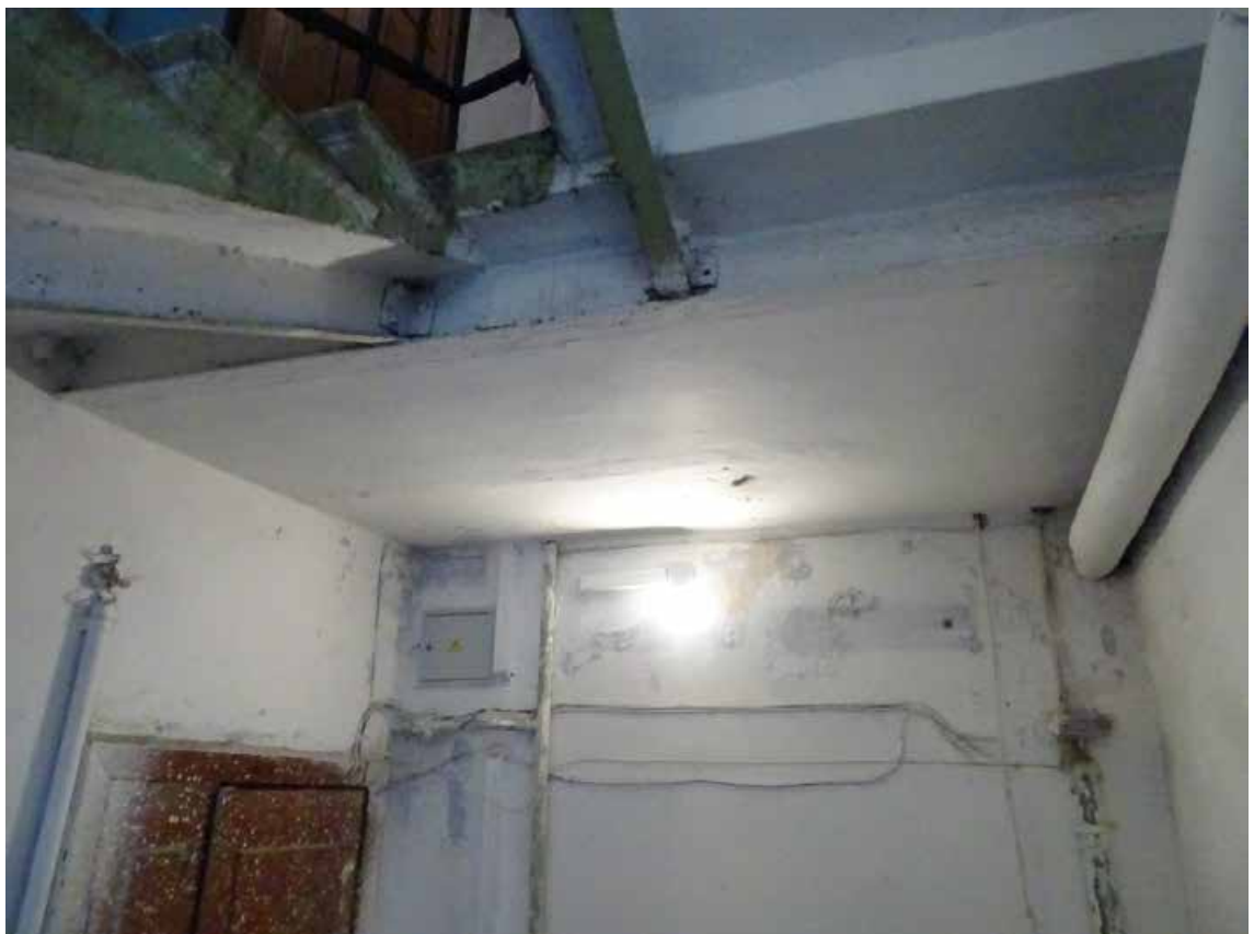
Фото 148. ЛК-5. Площадка 5-го этажа. Съемка 19.04.2021 г. Трушковский В.Э.
