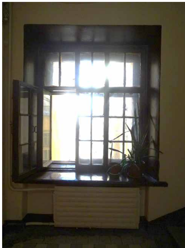
Фото 97. ЛК-3. Площадка между 3-м и 4-м этажом. Съемка 19.04.2021 г. Трушковский В.Э.
