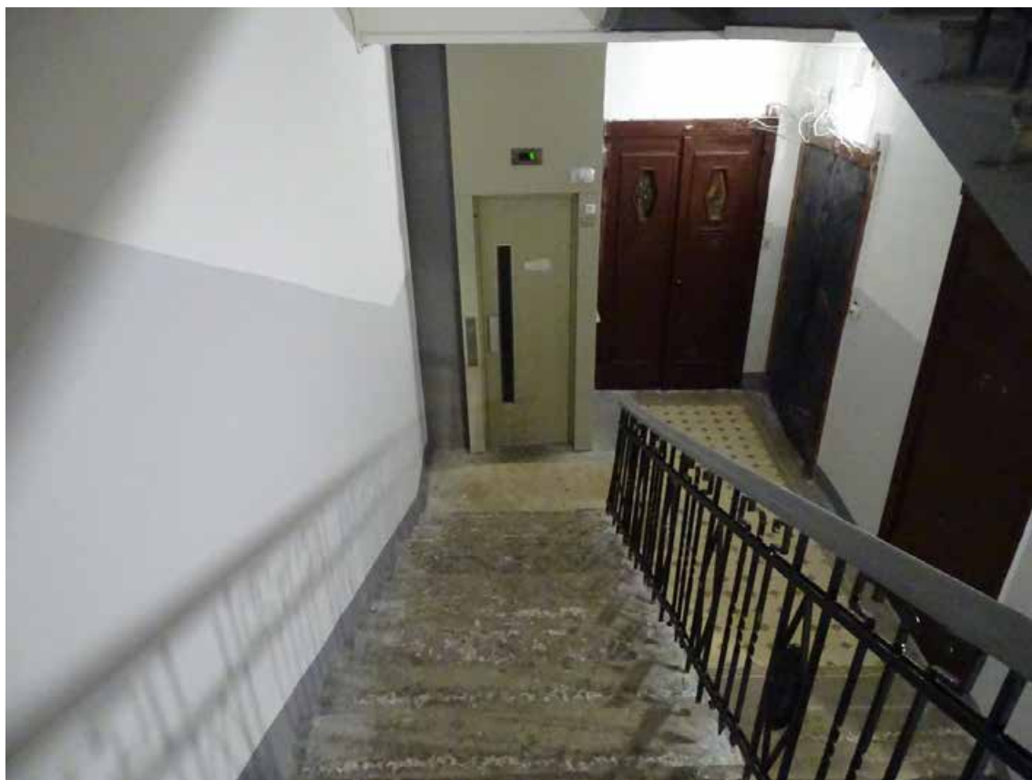
Фото 170. ЛК-6. Площадка 1-го этажа. Съемка 19.04.2021 г. Трушковский В.Э.
