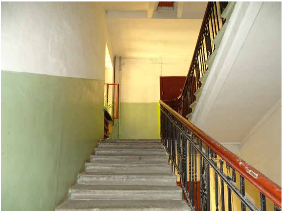
Фото 26. ЛК-1. Площадка между 3-м и 4-м этажом. Съемка 19.04.2021 г. Трушковский В.Э.
