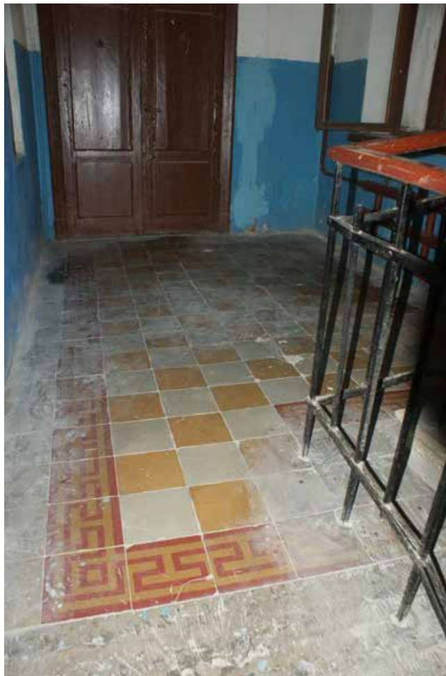
Фото 127. ЛК-5. Площадка между 1-м и 2-м этажом. Покрытие пола. Съемка 19.04.2021 г. Трушковский В.Э.
