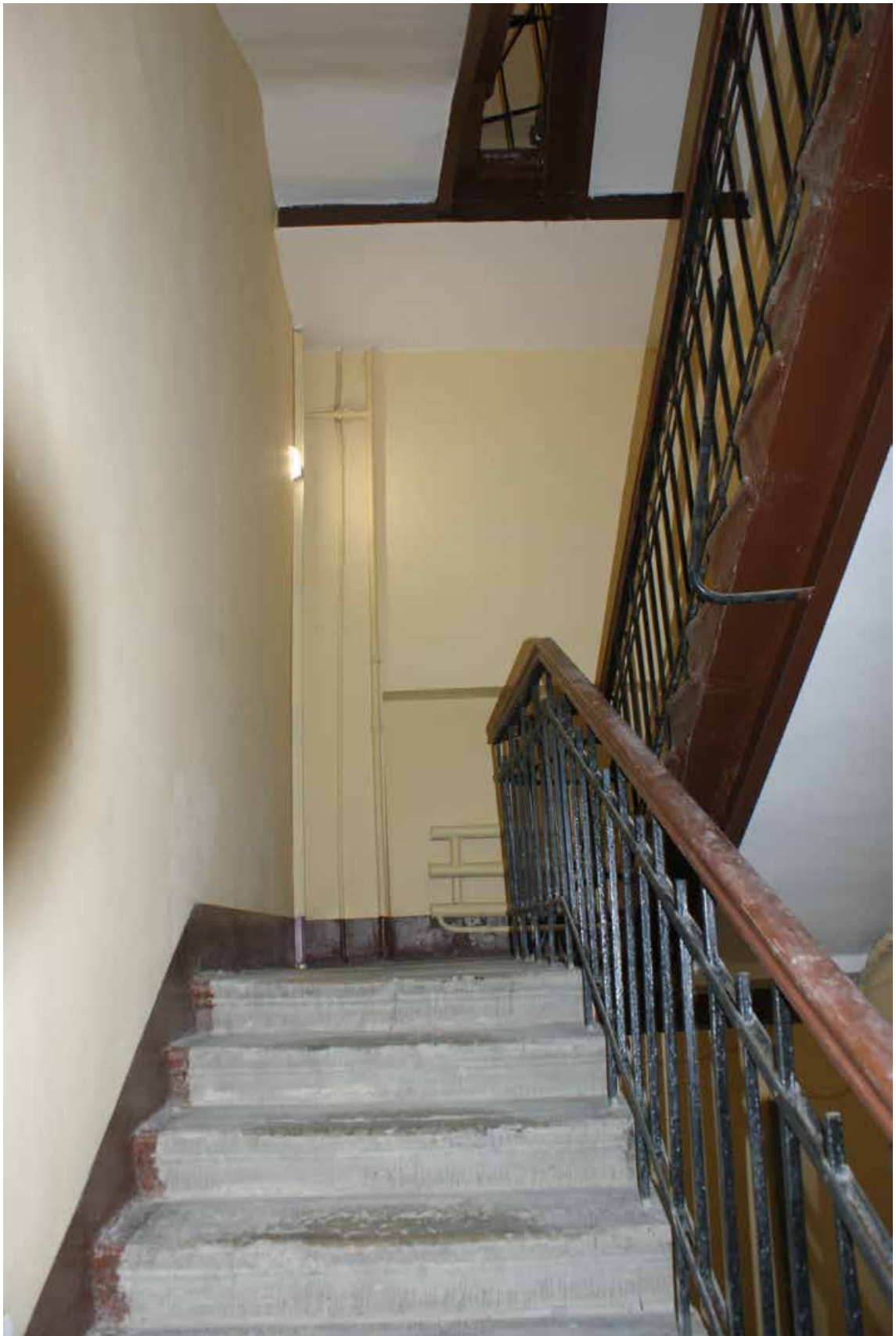
Фото 251. ЛК-9. Вид на площадку между 2-м и 3-м этажом. Съемка 19.04.2021 г. Трушковский В.Э.
