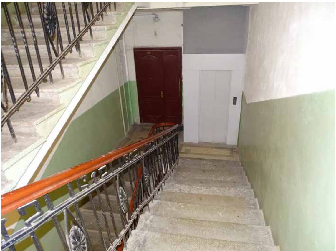
Фото 24. ЛК-1. Площадка 3-го этажа. Съемка 19.04.2021 г. Трушковский В.Э.
