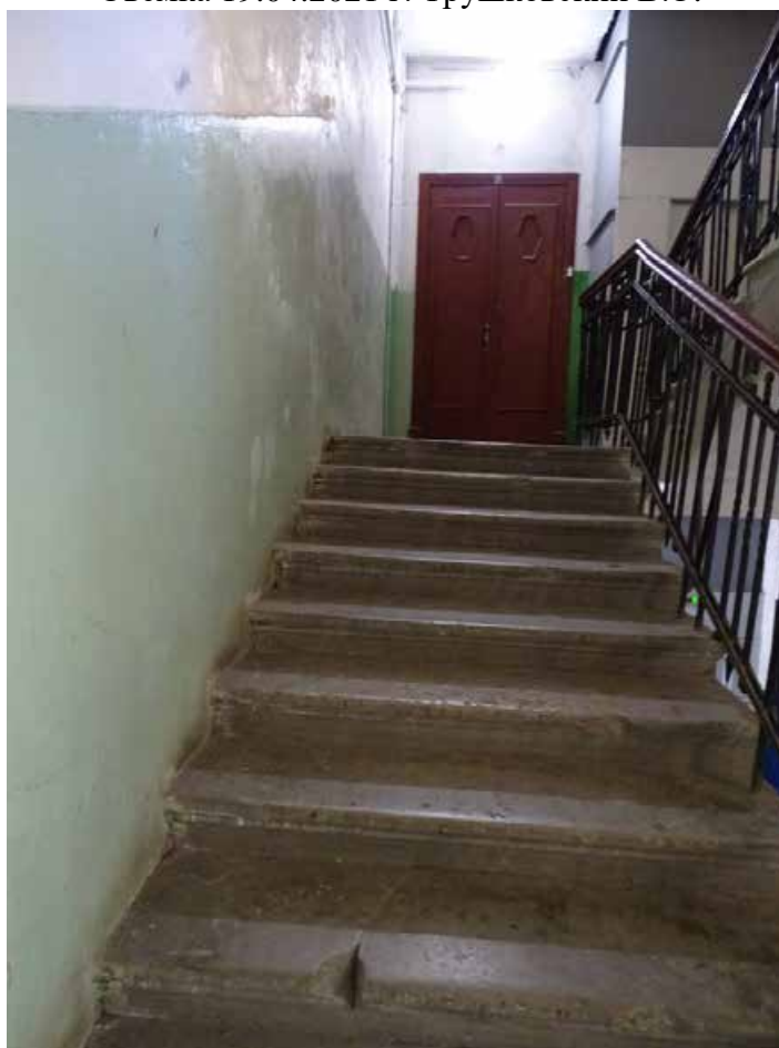
Фото 16. ЛК-1. Площадка 2-го этажа. Съемка 19.04.2021 г. Трушковский В.Э.
