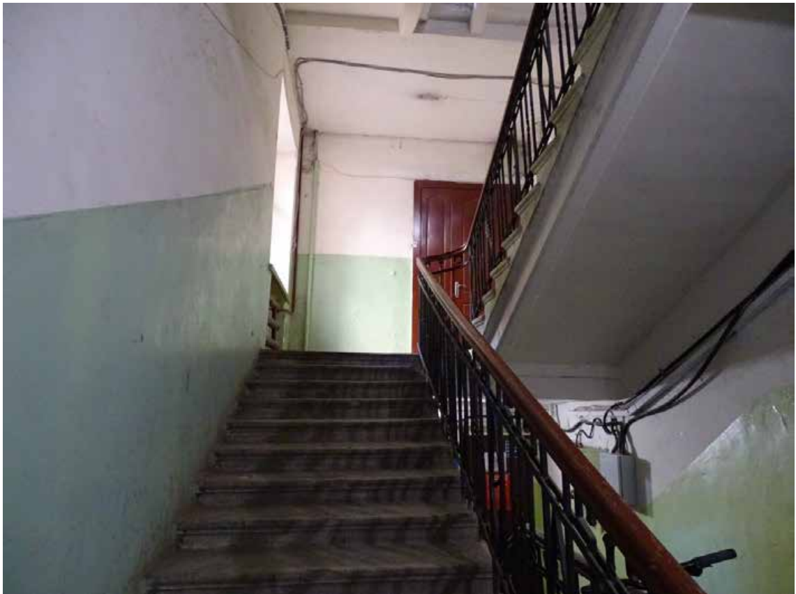
Фото 13. ЛК-1. Площадка между 1-м и 2-м этажом. Съемка 19.04.2021 г. Трушковский В.Э.
