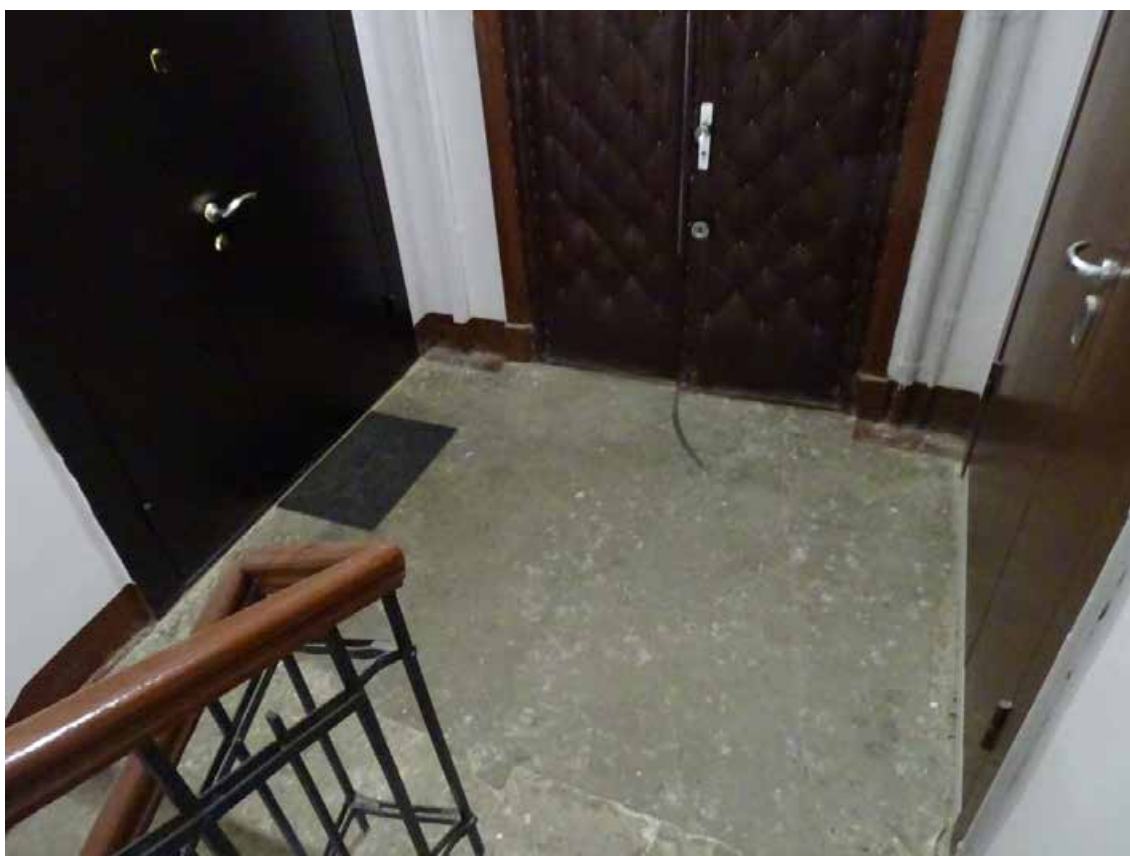
Фото 62. ЛК-2. Площадка 5-го этажа. Съемка 19.04.2021 г. Трушковский В.Э.
