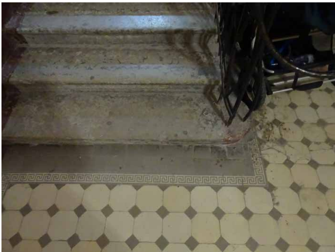
Фото 219. ЛК-8. Вестибюль 1-го этажа. Оформление пола. Съемка 19.04.2021 г. Трушковский В.Э.
