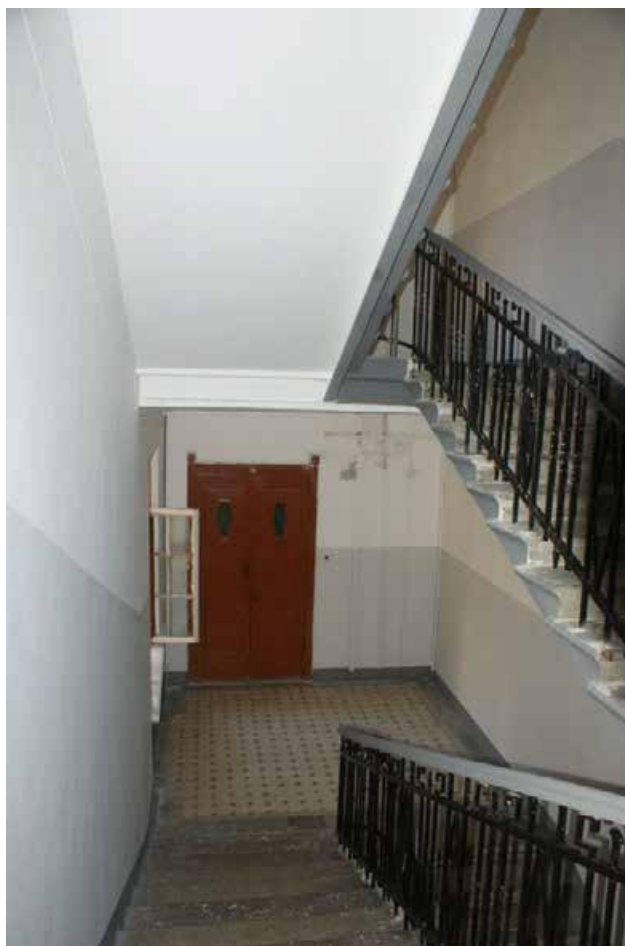
Фото 193. ЛК-6. Вид на площадку между 4-м и 5-м этажом. Съемка 19.04.2021 г. Трушковский В.Э.
