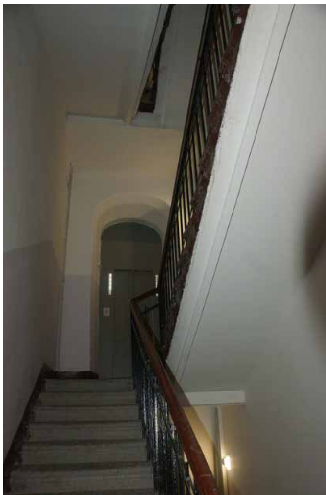
Фото 49. ЛК-2. Вид на площадку между 2-м и 3-м этажом. Съемка 19.04.2021 г. Трушковский В.Э.
