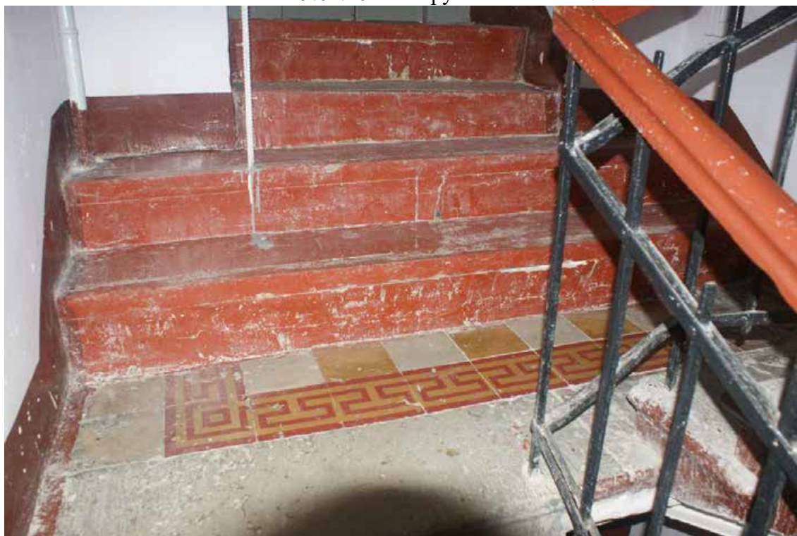
Фото 45. ЛК-2. Площадка между 1-м и 2-м этажом. Съемка 19.04.2021 г. Трушковский В.Э.
