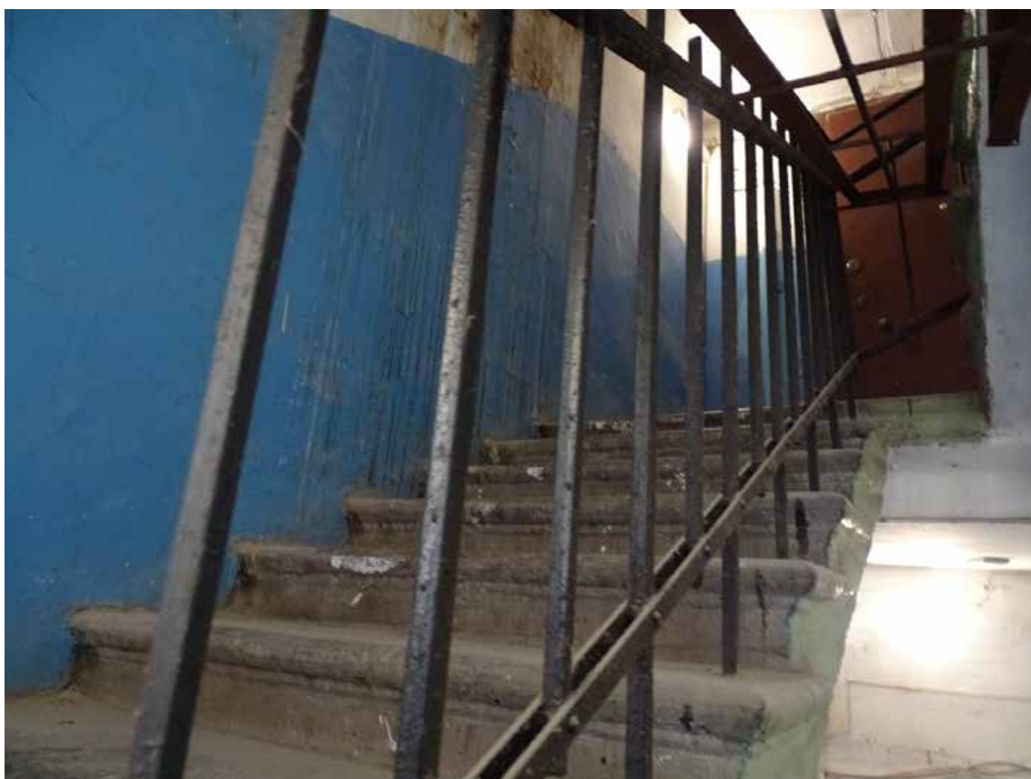
Фото 158. ЛК-5. Вид на чердачный этаж. Съемка 19.04.2021 г. Трушковский В.Э.
