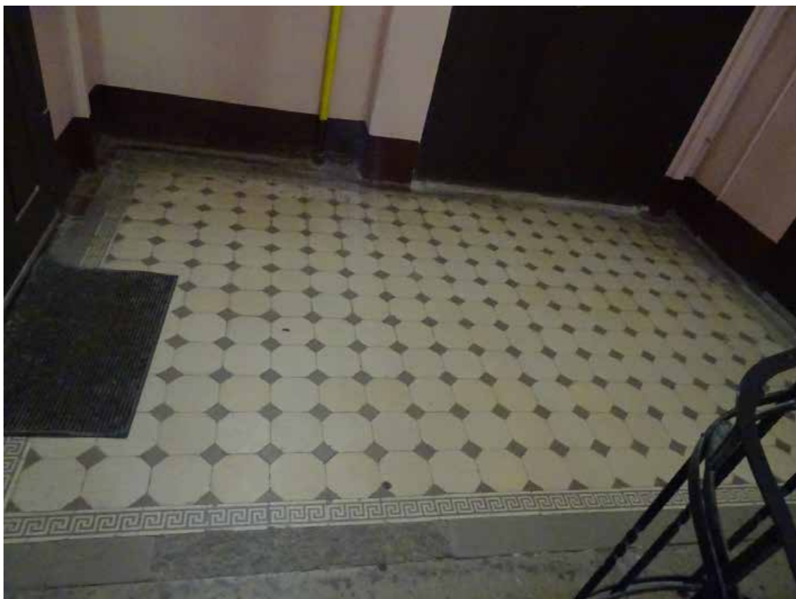
Фото 225. ЛК-8. Площадка 2-го этажа. Покрытие пола. Съемка 19.04.2021 г. Трушковский В.Э.
