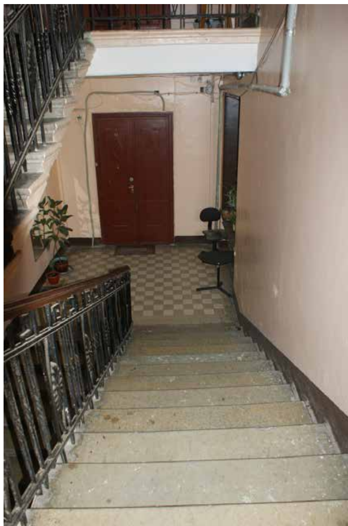
Фото 108. ЛК-3. Вид на площадку между 5-м и 6-м этажом. Съемка 19.04.2021 г. Трушковский В.Э.
