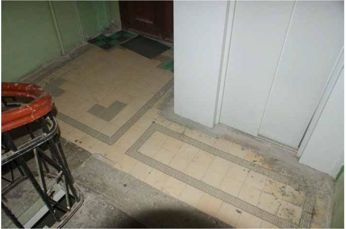
Фото 29. ЛК-1. Площадка 4-го этажа. Покрытие пола. Съемка 19.04.2021 г. Трушковский В.Э.
