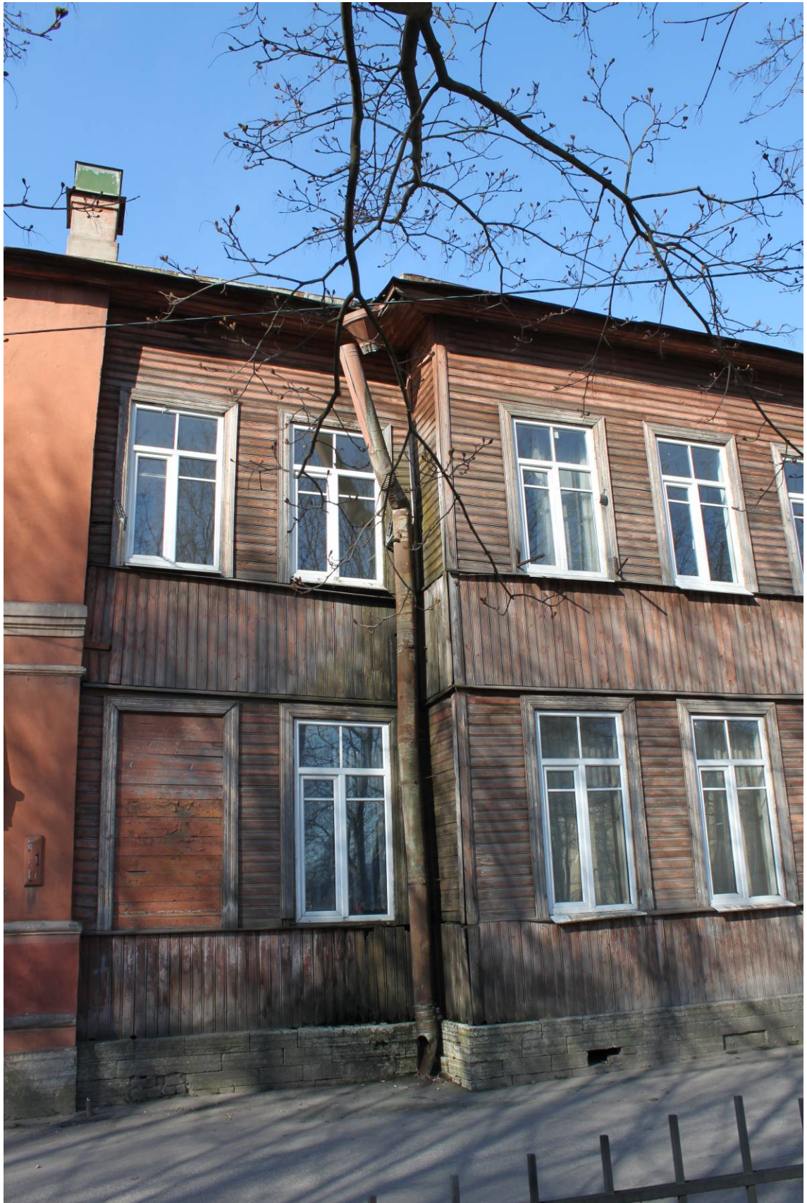
Фото 15. Восточный фасад. Фрагмент. Оформление оконного проема. 1-й, 2-й этаж. Съемка 19.05.2021 г. Трушковский В.Э.
