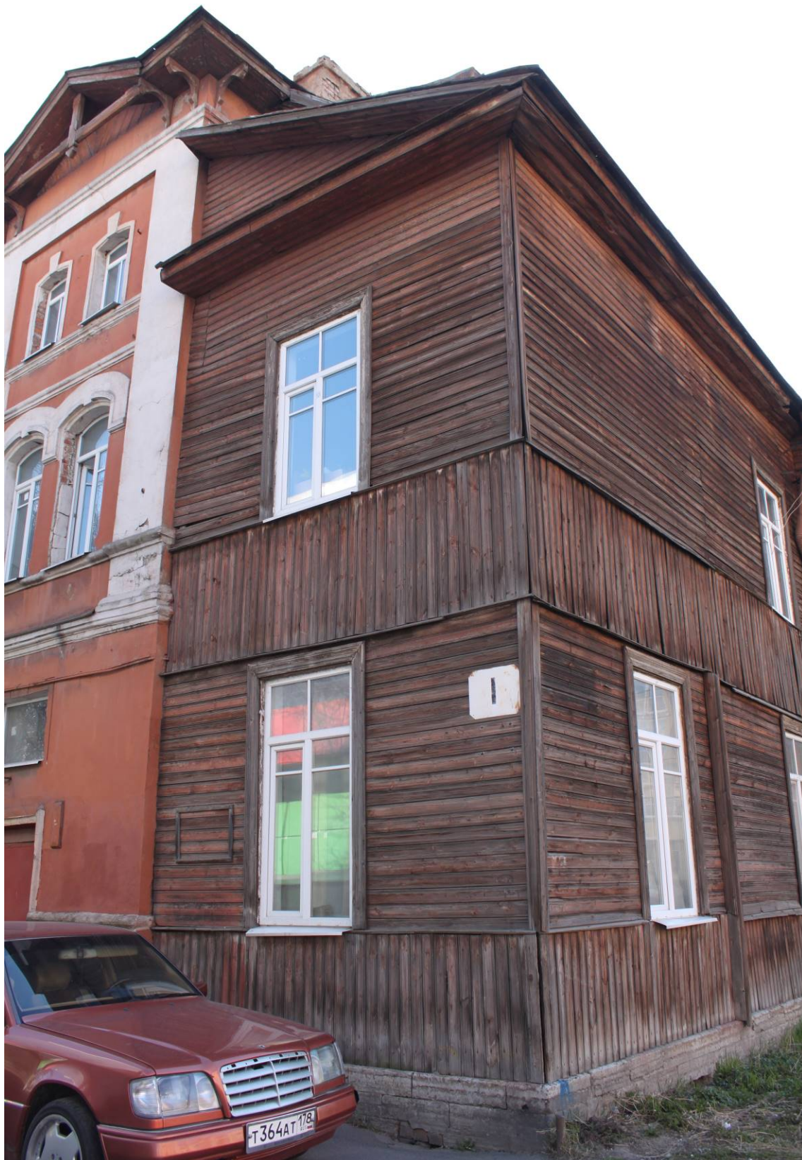
Фото 23. Северо-западный угол здания. Съемка 19.05.2021 г. Трушковский В.Э.
