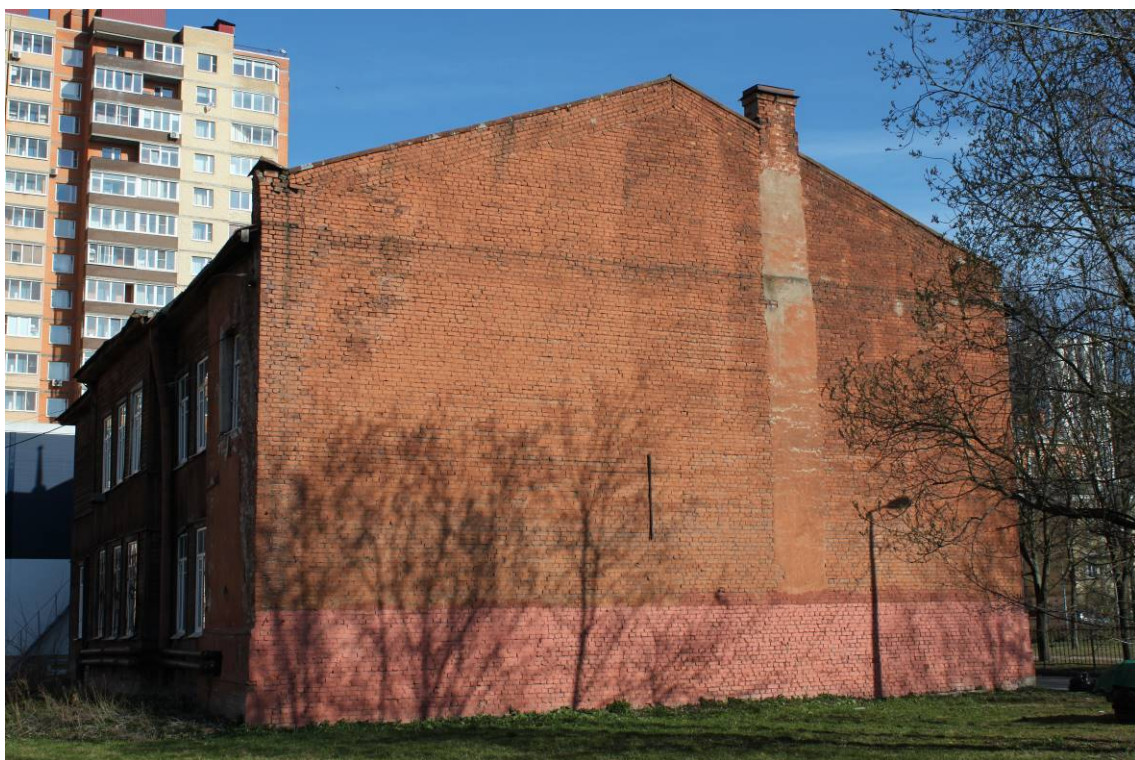
Фото 4. Юго-западный фасад. Съемка 19.05.2021 г. Трушковский В.Э.
