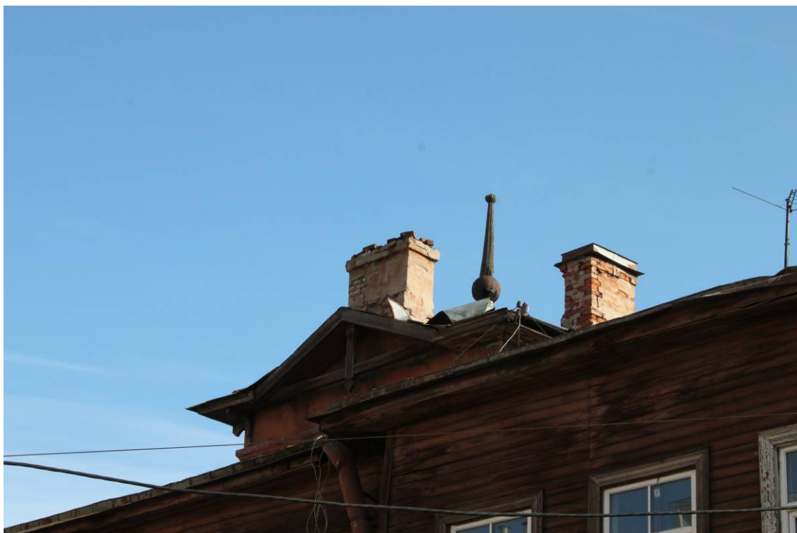
Фото 19. Западный фасад. Фрагмент. Деревянный резной шпиль. Съемка 19.05.2021 г. Трушковский В.Э.
