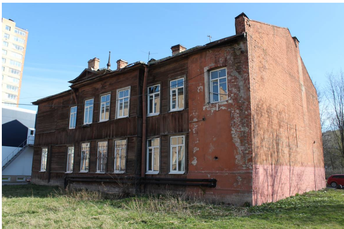
Фото 18. Западный фасад. Съемка 19.05.2021 г. Трушковский В.Э.
