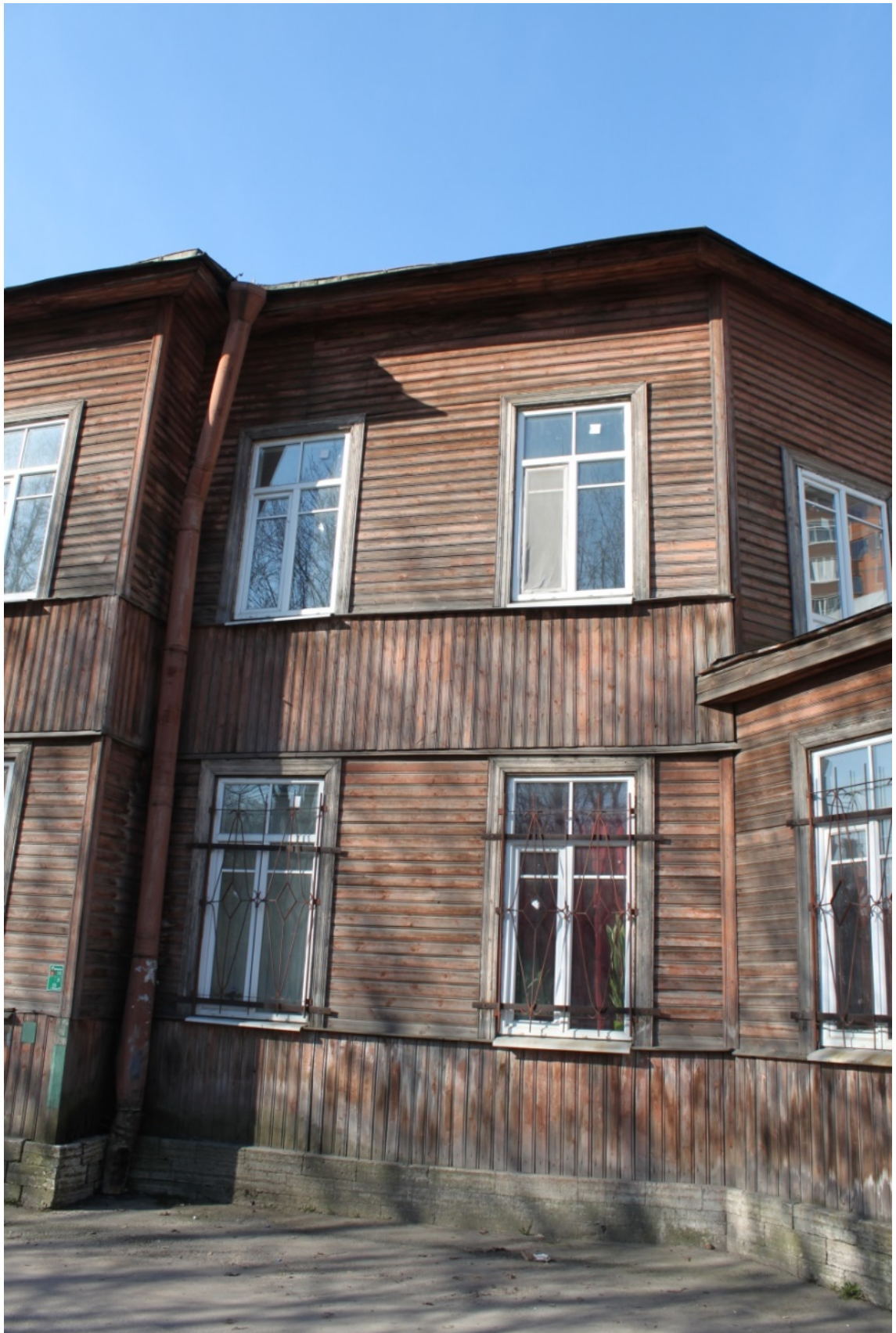
Фото 11. Восточный фасад. Фрагмент. 1-й, 2-й этаж. Съемка 19.05.2021 г. Трушковский В.Э.
