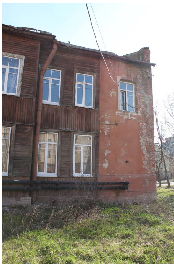
Фото 20. Западный фасад. Фрагмент. Ризалит. Кирпичный оштукатуренный ризалит. Съемка 19.05.2021 г. Трушковский В.Э.
