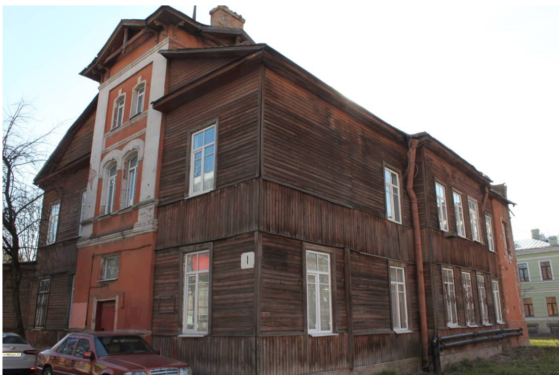
Фото 6. Северо-западный фасад. Съемка 19.05.2021 г. Трушковский В.Э.
