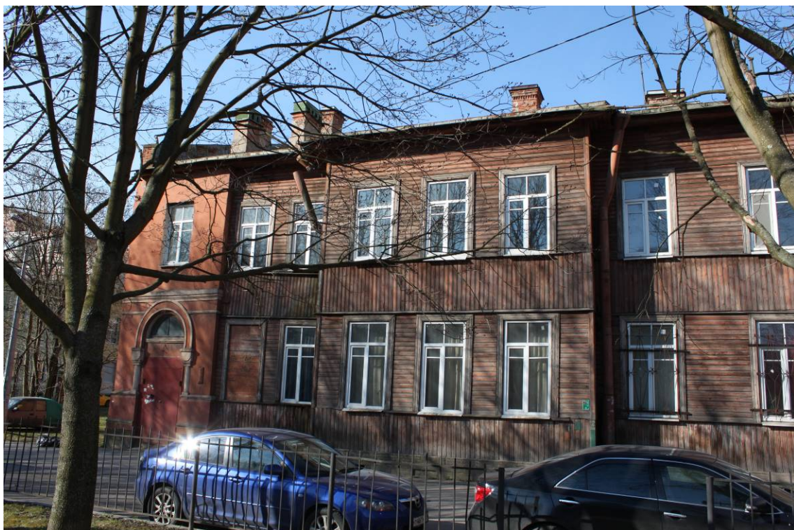
Фото 13. Восточный фасад. Фрагмент. Ризалит. Съемка 19.05.2021 г. Трушковский В.Э.
