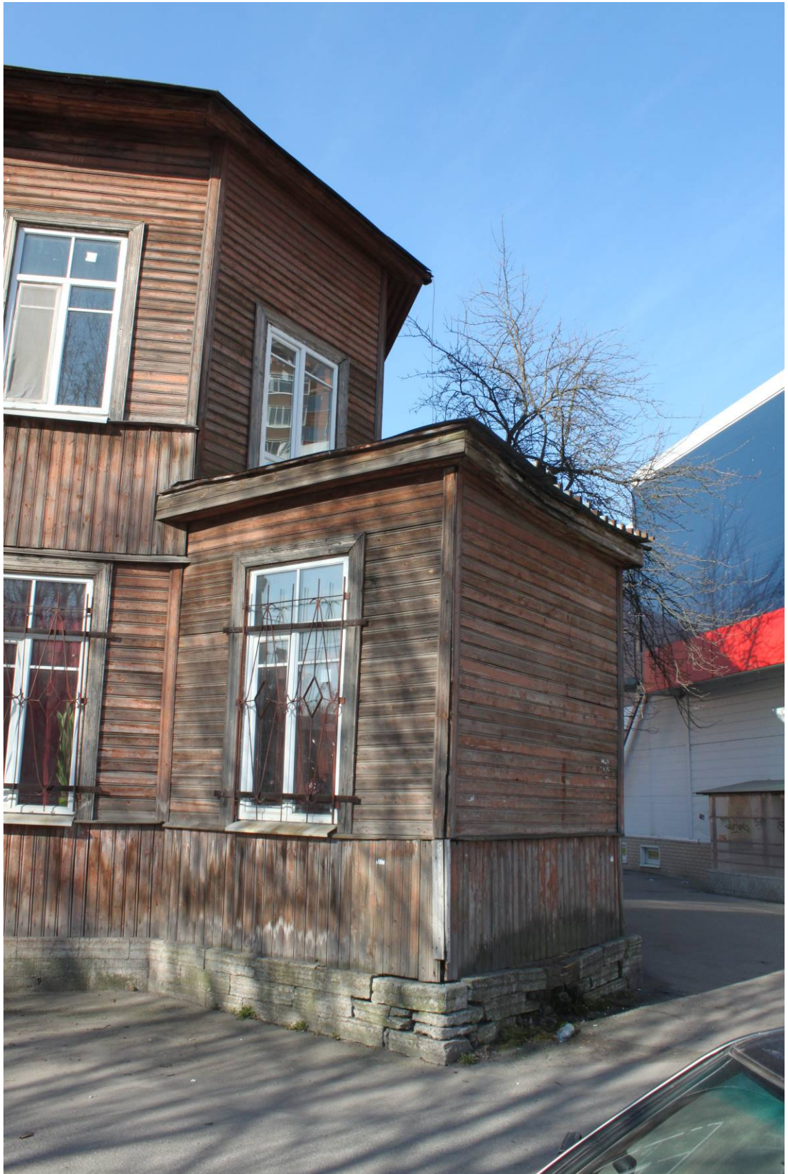
Фото 12. Восточный фасад. Фрагмент. Съемка 19.05.2021 г. Трушковский В.Э.
