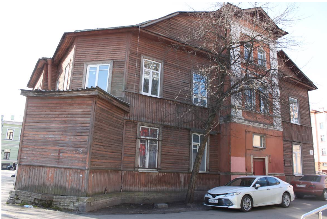
Фото 7. Северный фасад. Съемка 19.05.2021 г. Трушковский В.Э.
