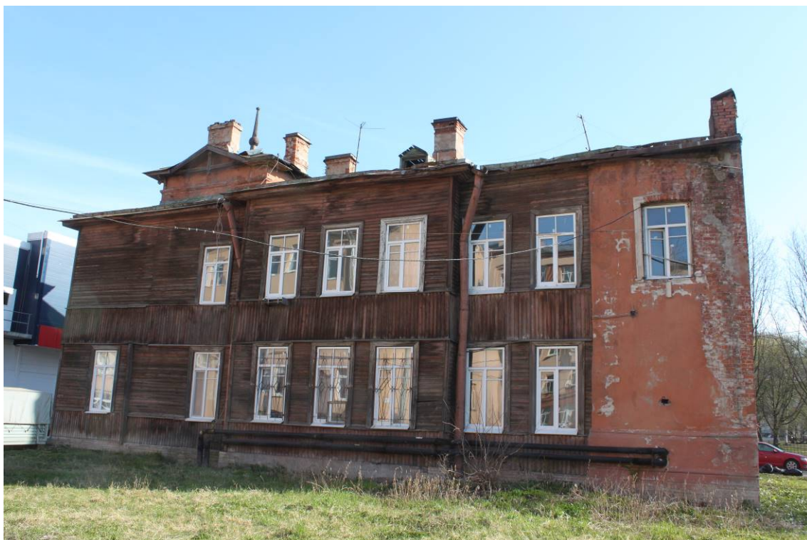
Фото 5. Западный фасад. Съемка 19.05.2021 г. Трушковский В.Э.
