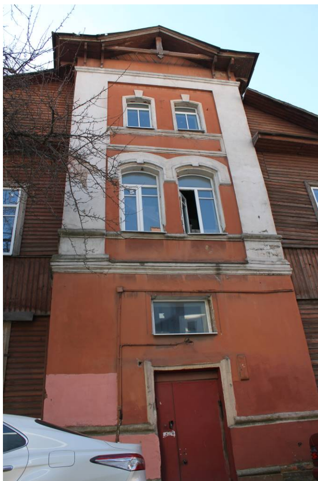
Фото 25. Северный фасад. Фрагмент. Оформление ризалита. Съемка 19.05.2021 г. Трушковский В.Э.
