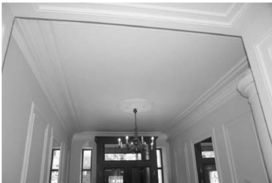
Фото 30. 4ЛК. 1-й этаж. Вестибюль. Оформление потолка. Съемка 19.04.2021 г. Михайловская Г. В.
