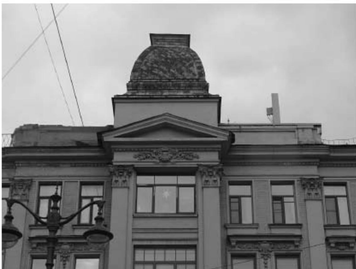
Фото 3. Здание по адресу: г. Санкт-Петербург, Большой проспект П.С., дом 49/18, литера А. Лицевой фасад по Большому пр. Фрагмент. Съемка 19.04.2021 г. Михайловская Г. В.
