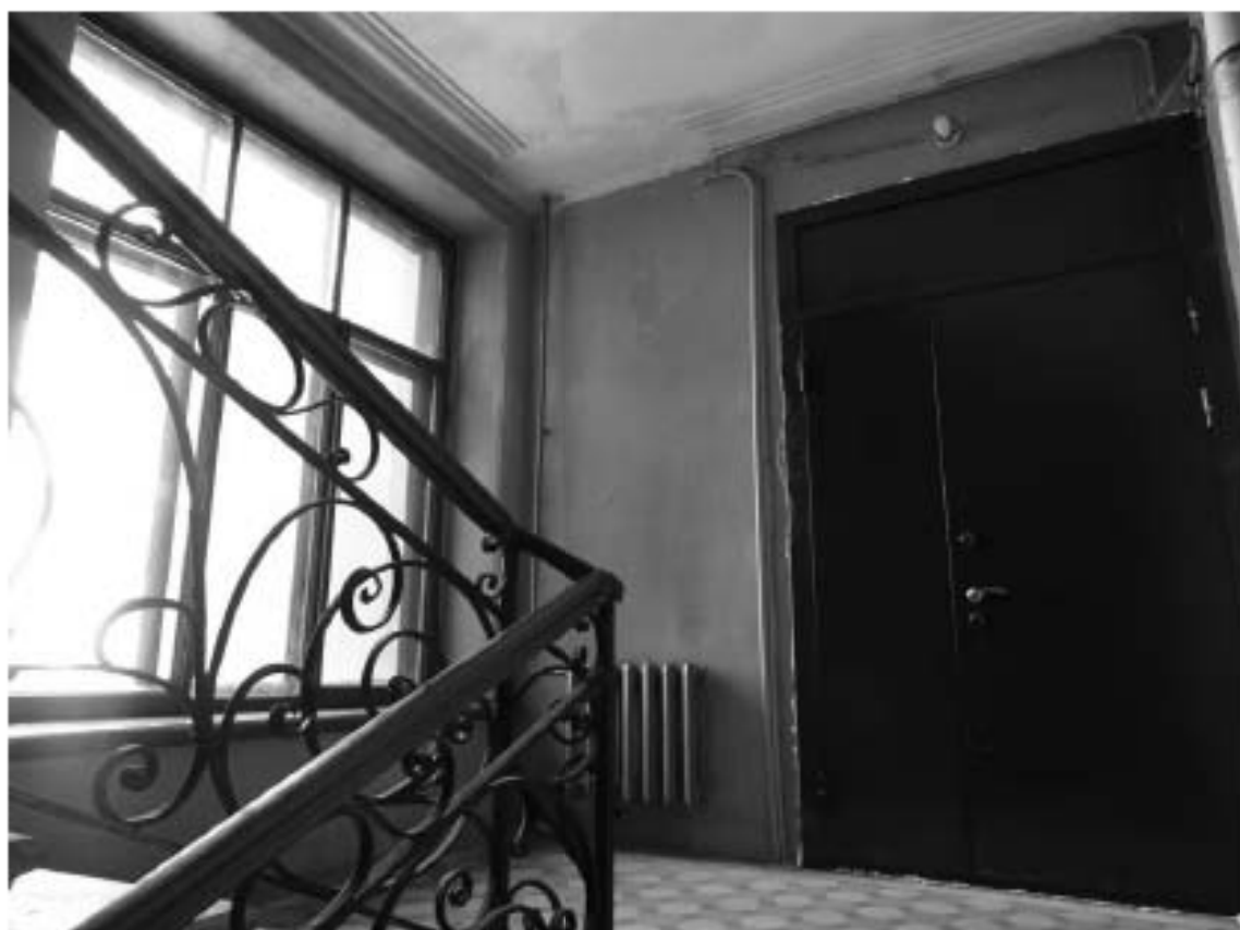
Фото 48. 4ЛК. 3-й этаж. Съемка 19.04.2021 г. Михайловская Г. В.
