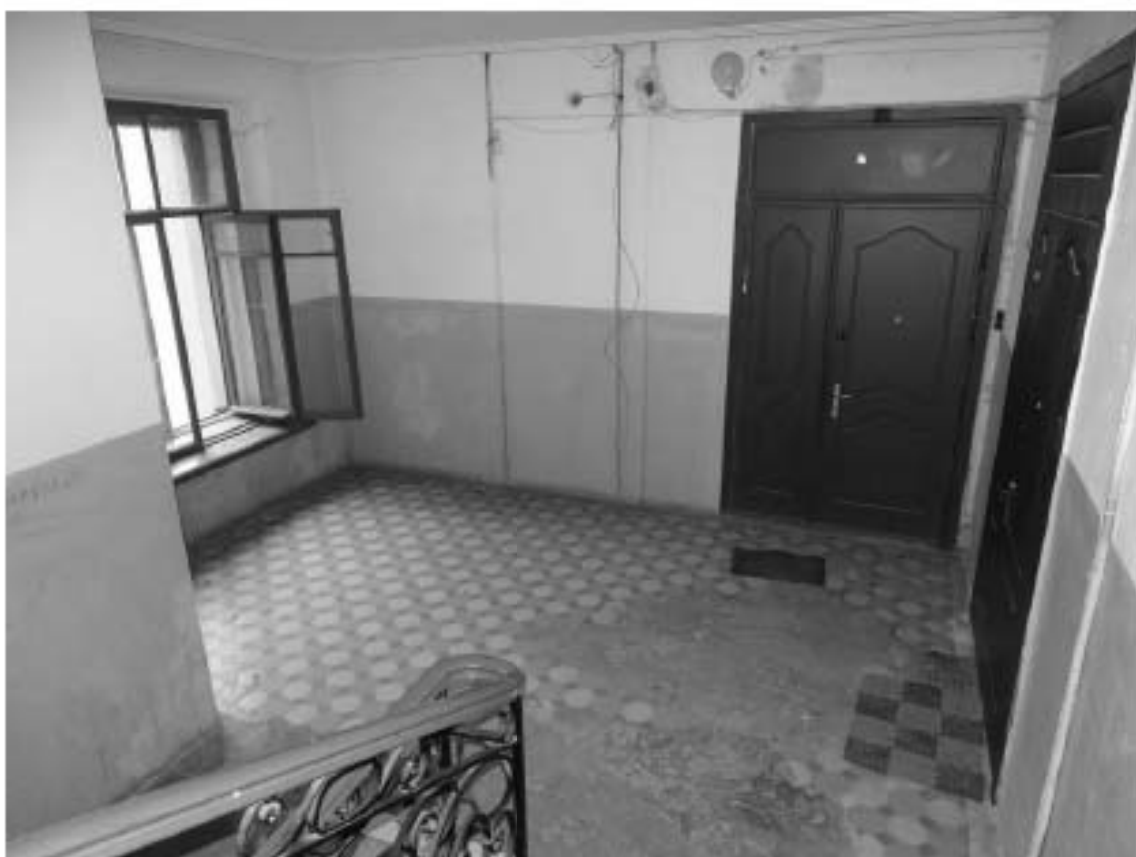
Фото 81. 1ЛК. 4-й этаж. Съемка 19.04.2021 г. Михайловская Г. В.
