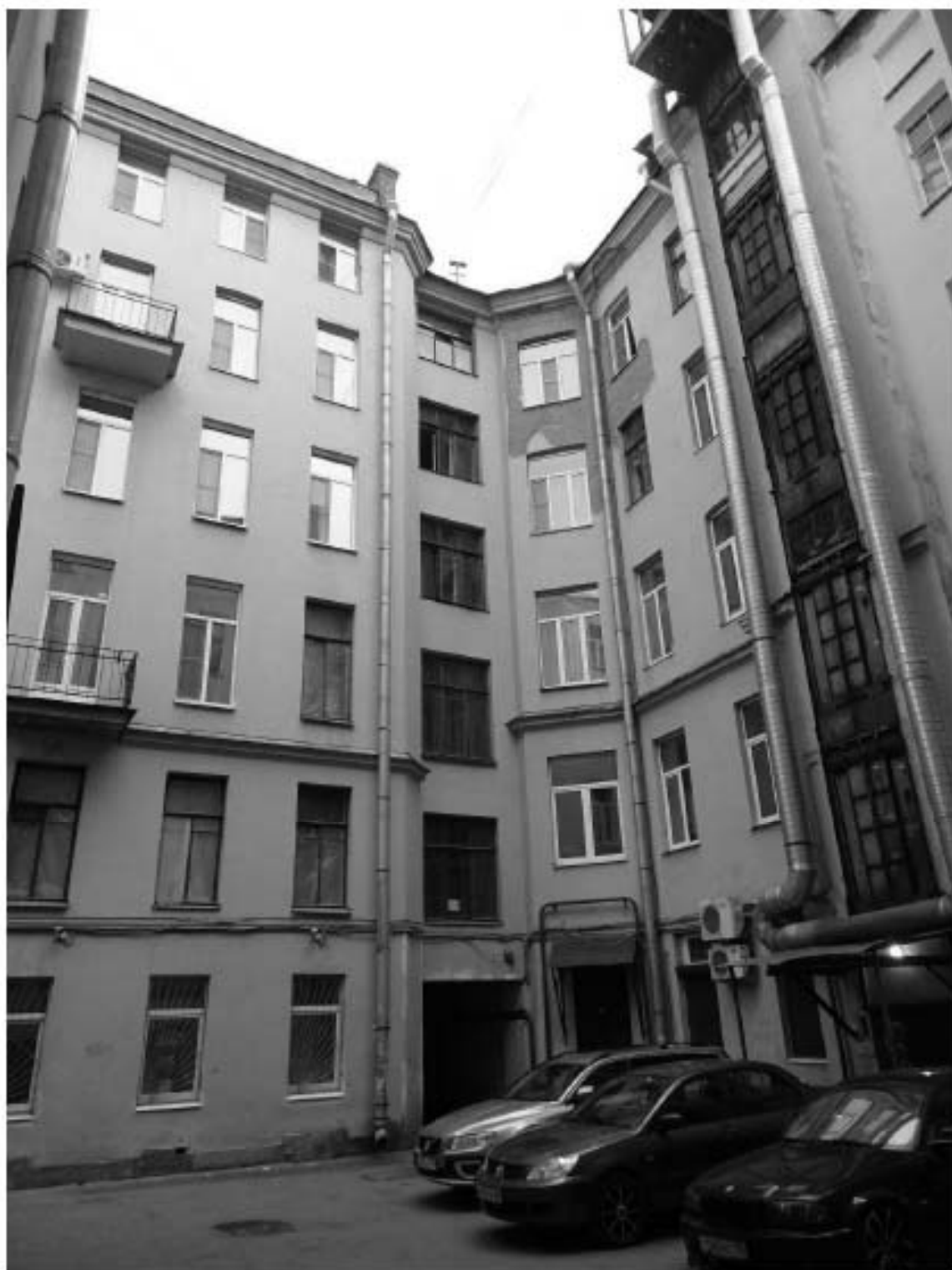
Фото 17. Здание по адресу: г. Санкт-Петербург, Большой проспект П.С., дом 49/18, литера А. Восточный внутренний двор. Съемка 19.04.2021 г. Михайловская Г. В.
