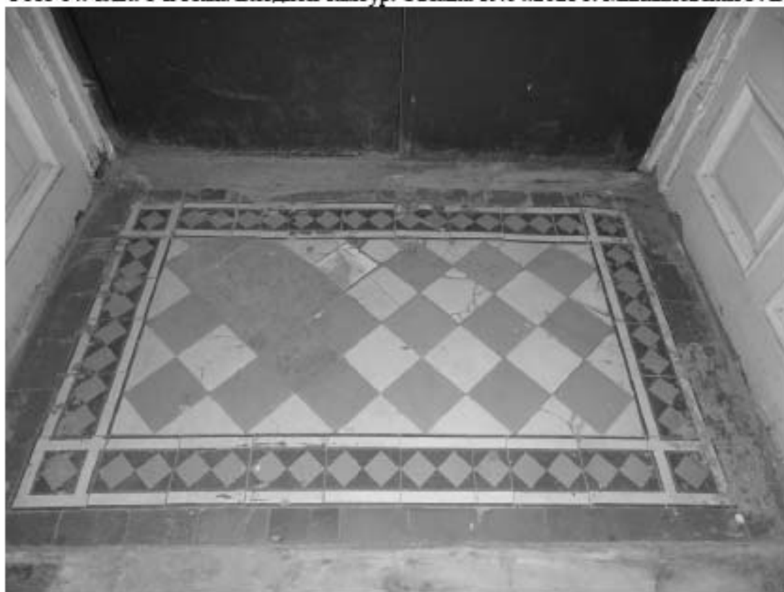
Фото 65. 1ЛК. 1-й этаж. Входной тамбур. Покрытие пола. Съемка 19.04.2021 г. Михайловская Г. В.
