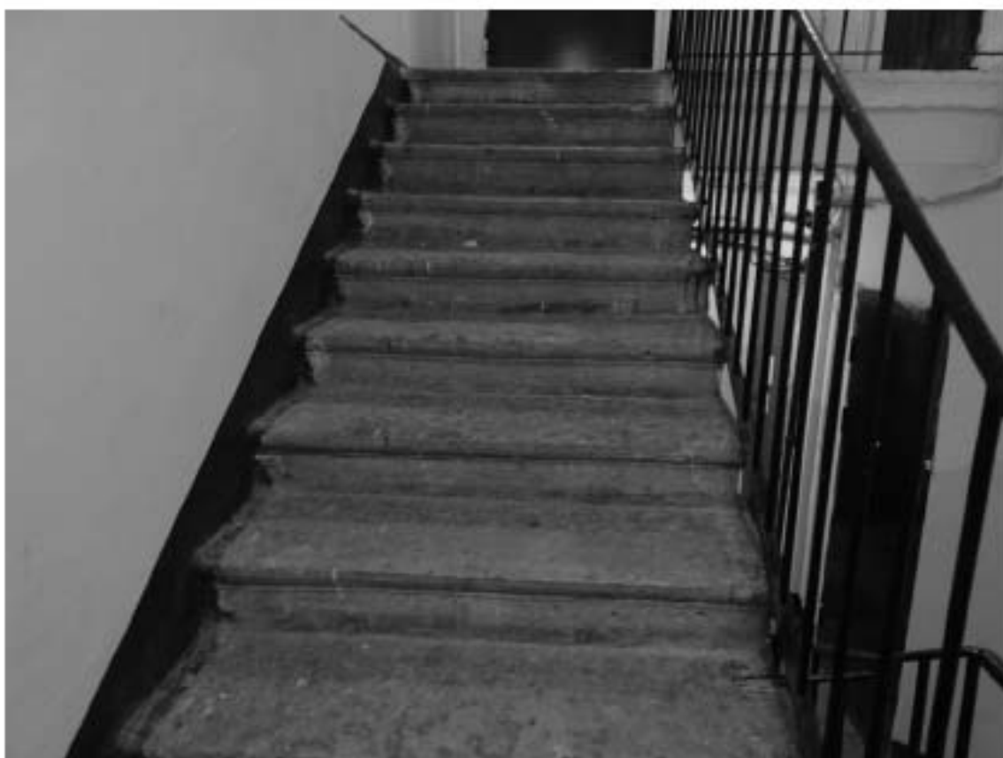
Фото 109. 6ЛК. Фрагмент лестницы. Съемка 19.04.2021 г. Михайловская Г. В.
