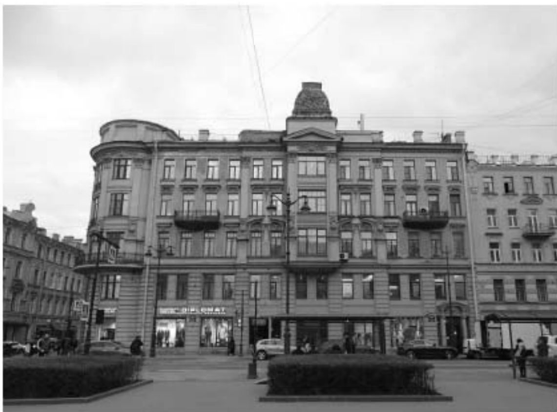
Фото 2. Здание по адресу: г. Санкт-Петербург, Большой проспект П.С., дом 49/18, литера А. Лицевой фасад по Большому пр. Съемка 19.04.2021 г. Михайловская Г. В.
