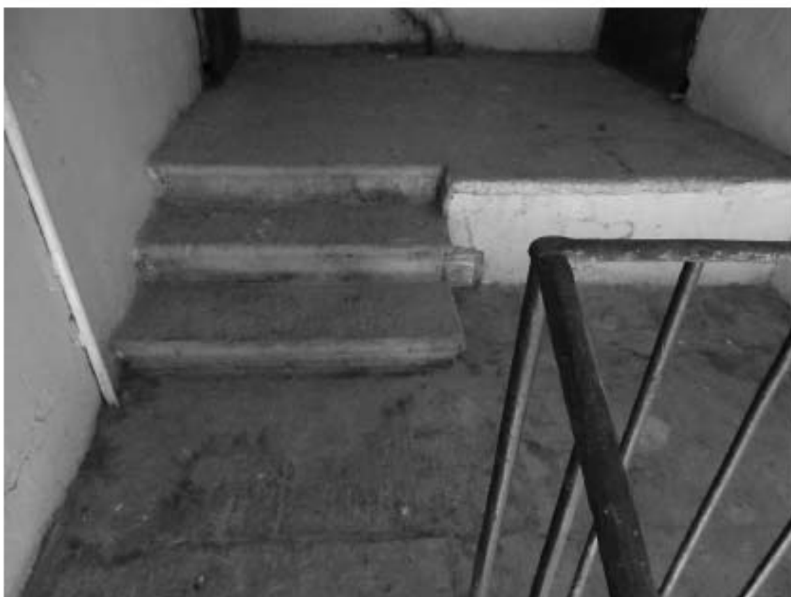
Фото 130. 5ЛК. 6-й этаж. Съемка 19.04.2021 г. Михайловская Г. В.
