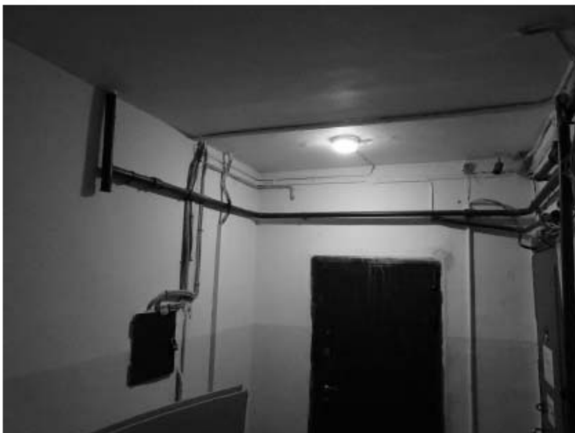
Фото 106. 6ЛК. 5-й этаж. Съемка 19.04.2021 г. Михайловская Г. В.
