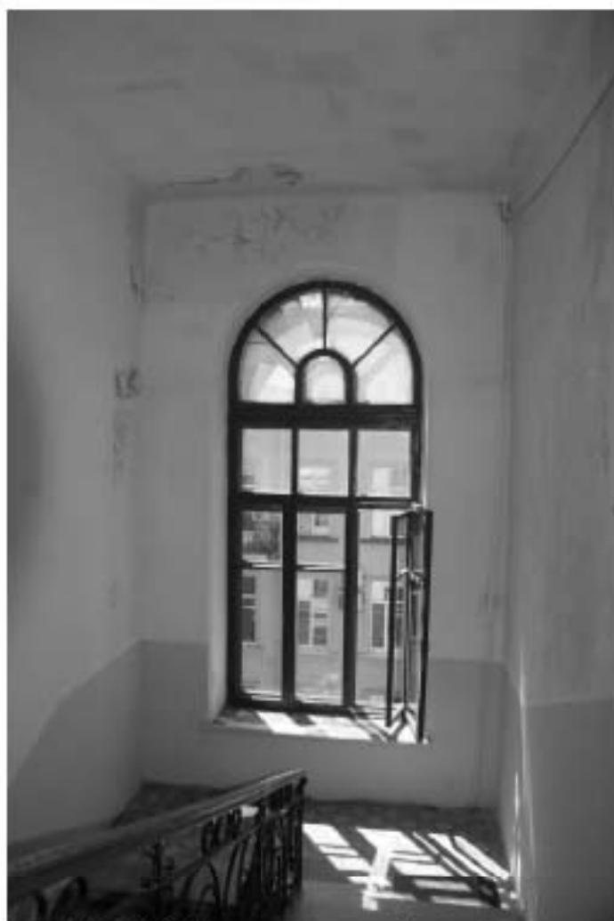
Фото 26. 2ЛК. Площадка между 5-м и 6-м этажом. Съемка 19.04.2021 г. Михайловская Г. В.
