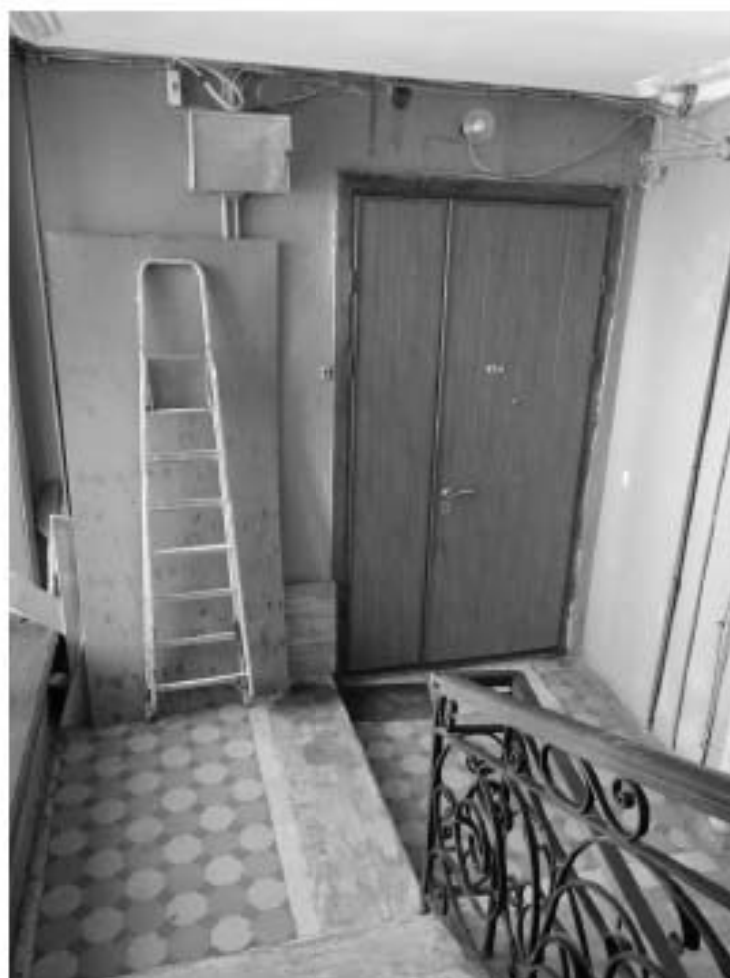
Фото 54. 4ЛК. 4-й этаж. Съемка 19.04.2021 г. Михайловская Г. В.
