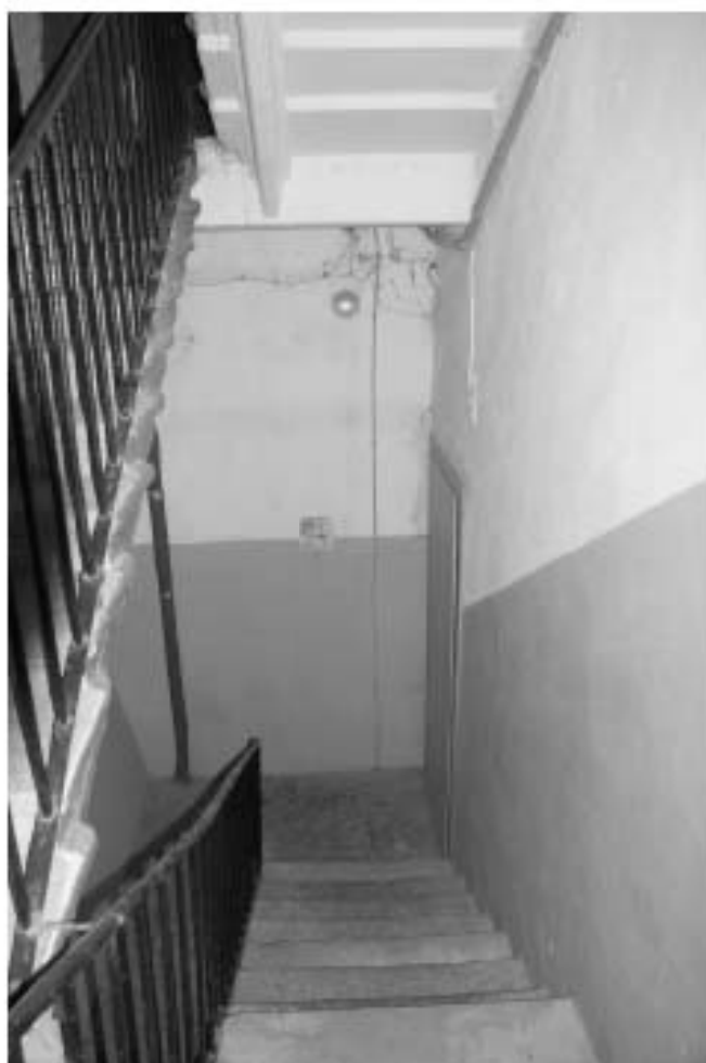
Фото 116. 5ЛК. 1-й этаж. Съемка 19.04.2021 г. Михайловская Г. В.
