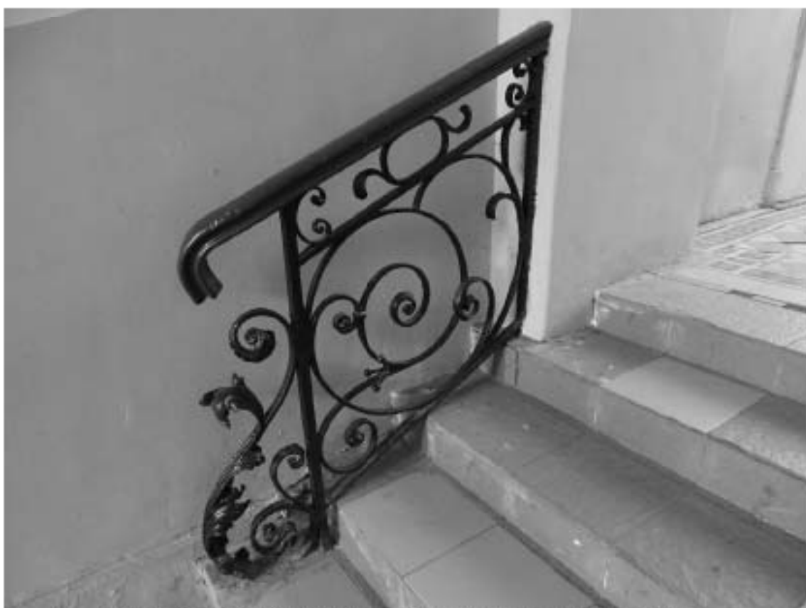
Фото 10. 2ЛК. 1-й этаж. Вестибюль. Лестничное ограждение. Съемка 19.04.2021 г. Михайловская Г. В.
