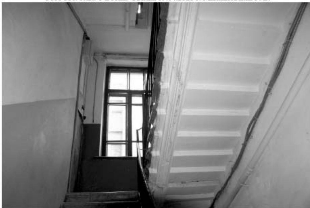
Фото 117. 5ЛК. Площадка между 1-м и 2-м этажом. Съемка 19.04.2021 г. Михайловская Г. В.
