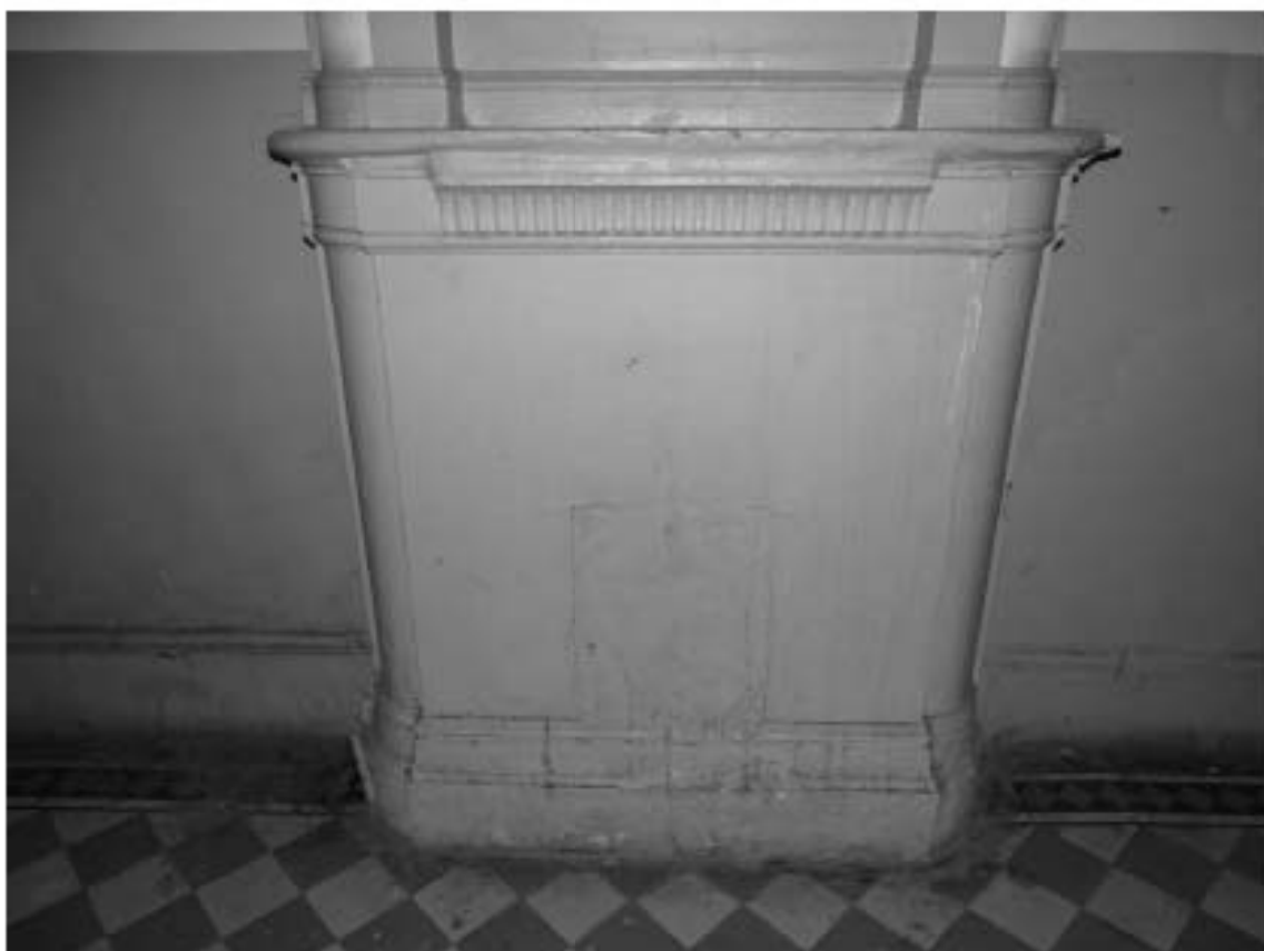
Фото 69. 1ЛК. 1-й этаж. Печь. Съёмка 19.04.2021 г. Михайловская Г. В.
