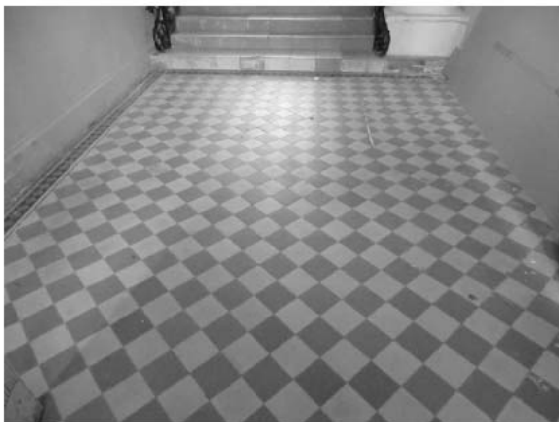
Фото 6. 2ЛК. 1-й этаж. Вестибюль. Покрытие пола. Съемка 19.04.2021 г. Михайловская Г. В.
