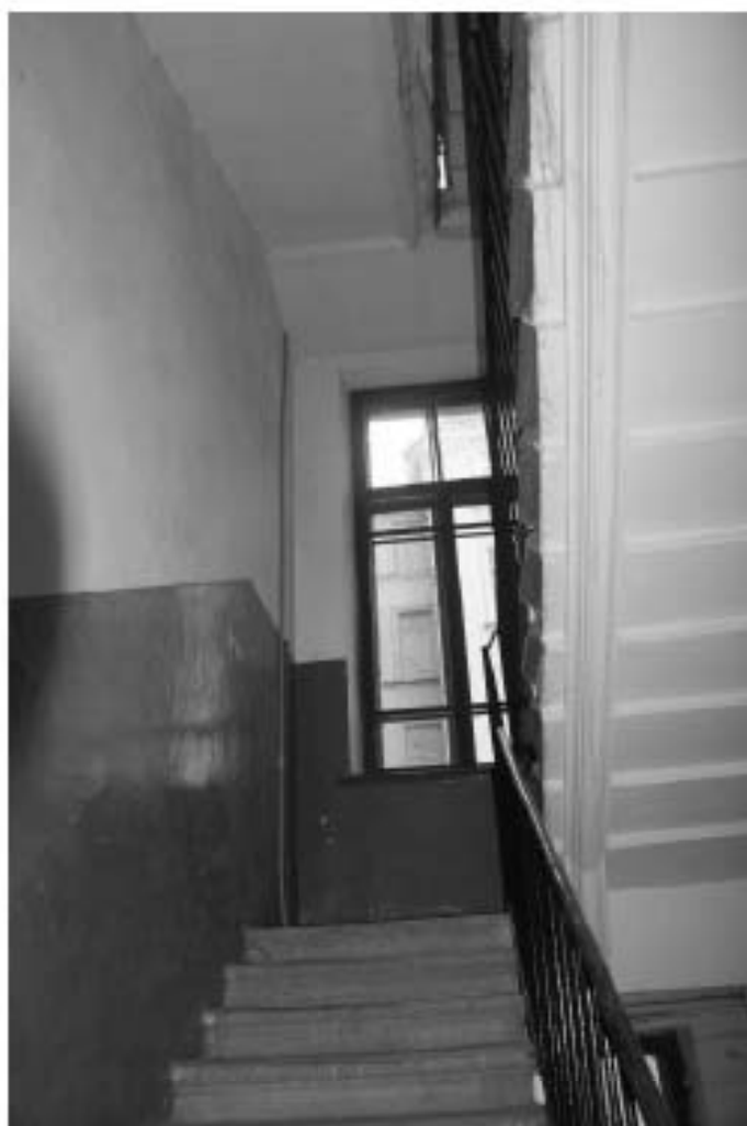
Фото 119. 5ЛК. Площадка между 2-м и 3-м этажом. Съемка 19.04.2021 г. Михайловская Г. В.
