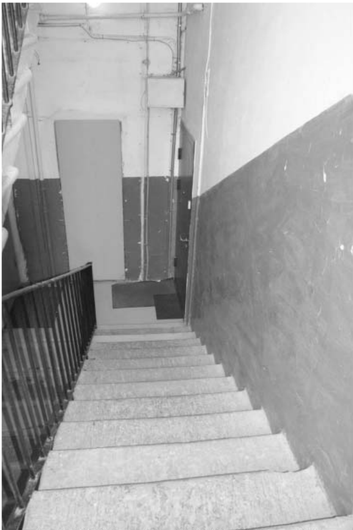
Фото 121. 5ЛК. 3-й этаж. Съемка 19.04.2021 г. Михайловская Г. В.
