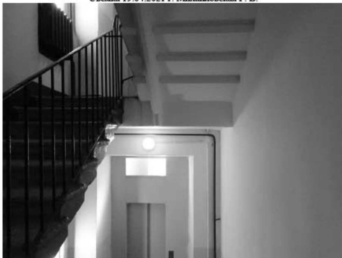
Фото 98. 6ЛК. Площадка между 3-м и 4-м этажом. Съемка 19.04.2021 г. Михайловская Г. В.
