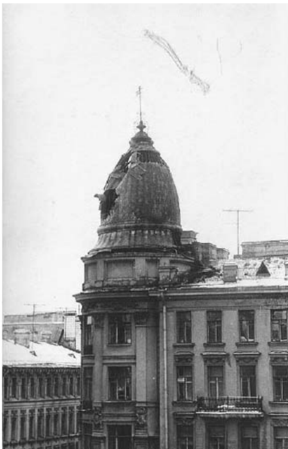
27. Дом на углу Большого пр. П.С. и ул. Ленина после пожара в ноябре 1964 года. URL: https://pastvu.com/p/532605
