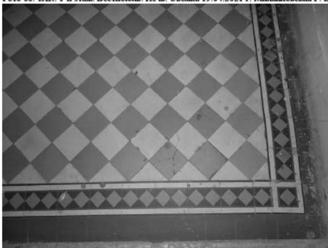
Фото 67. 1ЛК. 1-й этаж. Покрытие пола. Съемка 19.04.2021 г. Михайловская Г. В.
