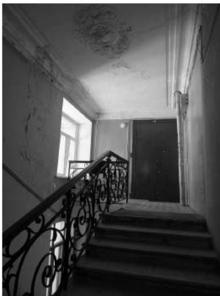
Фото 59. 4ЛК. 5-й этаж. Съемка 19.04.2021 г. Михайловская Г. В.
