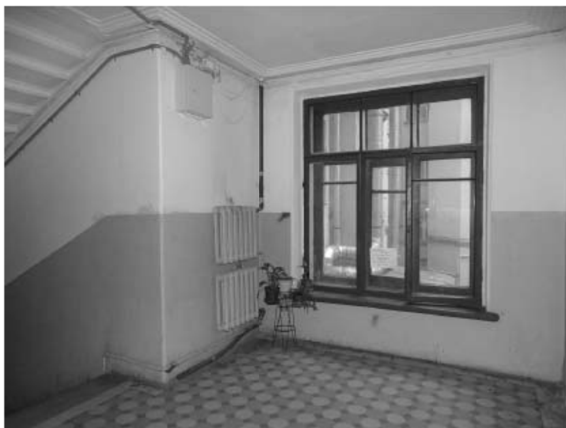
Фото 74. 1ЛК. 1-й этаж. Съемка 19.04.2021 г. Михайловская Г. В.
