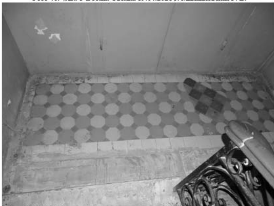
Фото 47. 4ЛК. 3-й этаж. Покрытие пола. Съемка 19.04.2021 г. Михайловская Г. В.
