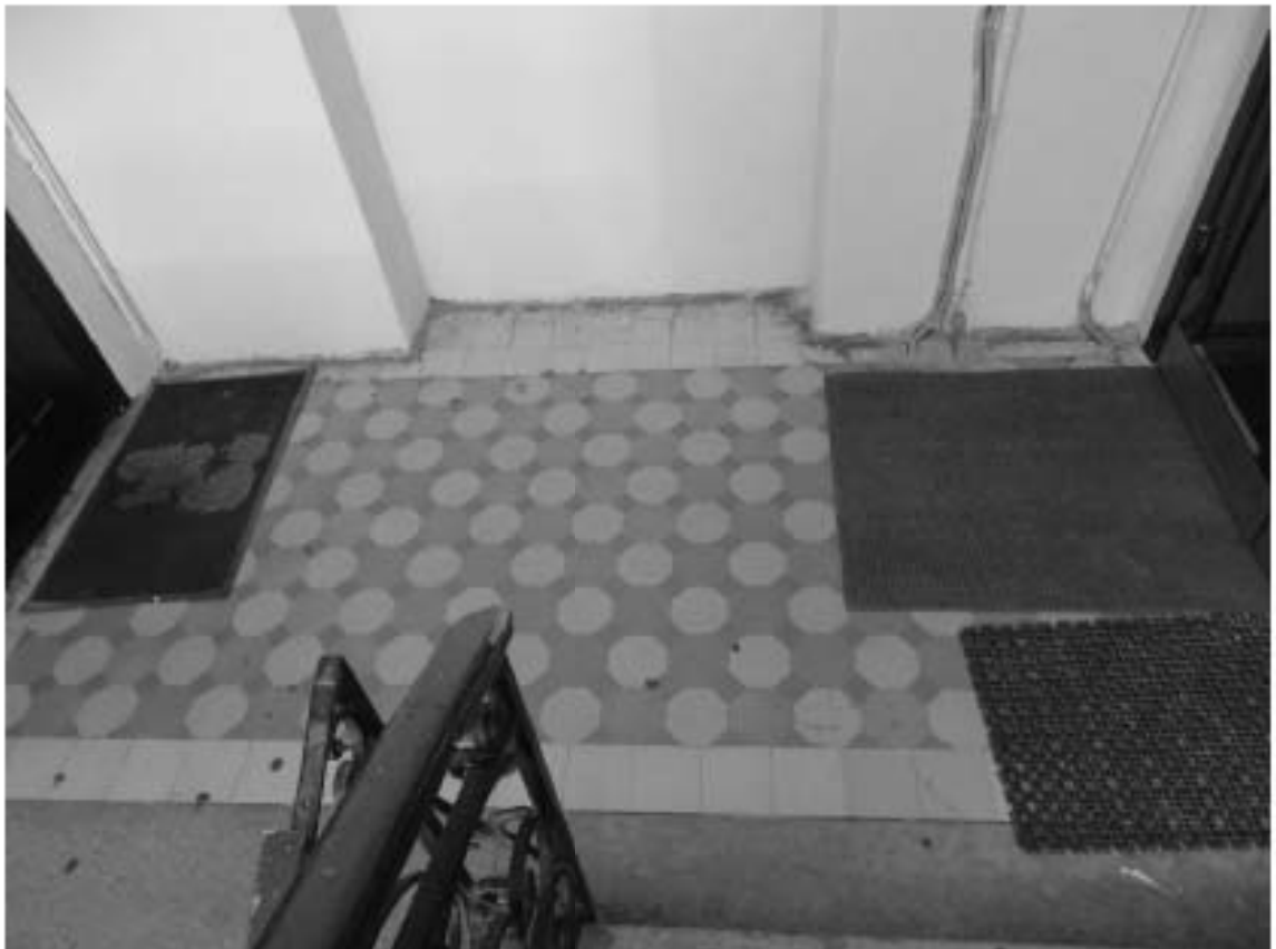
Фото 17. 2ЛК. 2-й этаж. Покрытие пола. Съемка 19.04.2021 г. Михайловская Г. В.
