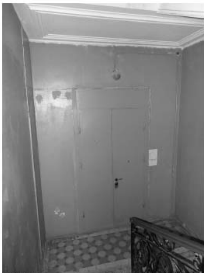
Фото 46. 4ЛК. 3-й этаж. Съемка 19.04.2021 г. Михайловская Г. В.
