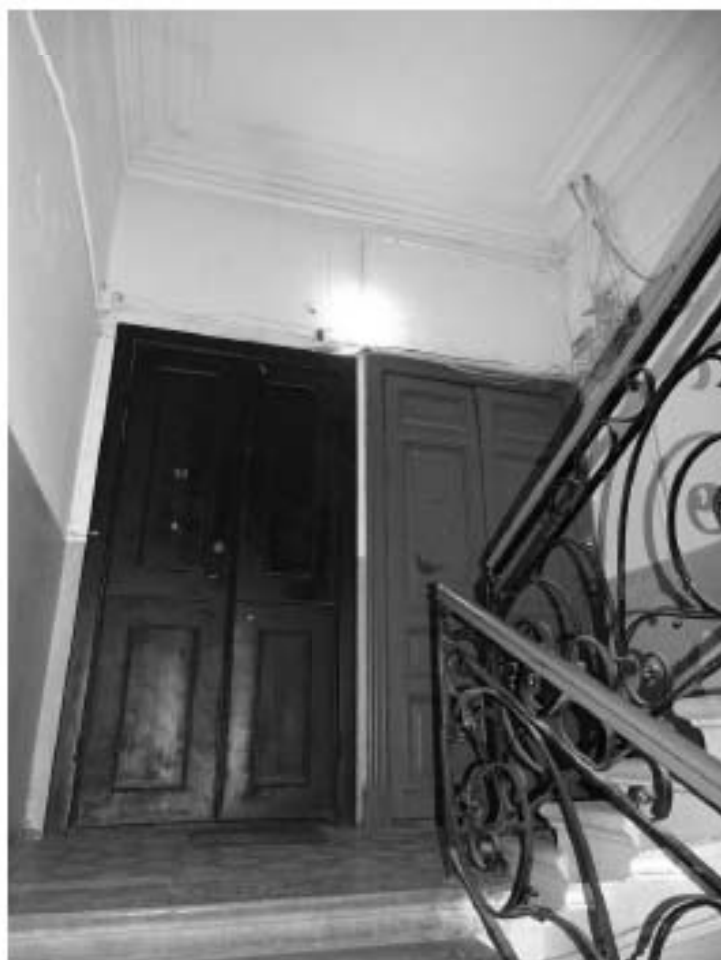
Фото 82. 1ЛК. 5-й этаж. Съемка 19.04.2021 г. Михайловская Г. В.
