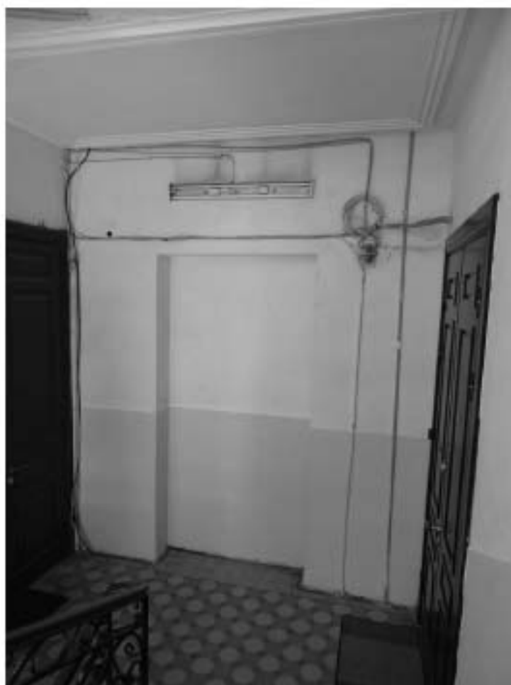
Фото 20. 2ЛК. 3-й этаж. Съемка 19.04.2021 г. Михайловская Г. В.
