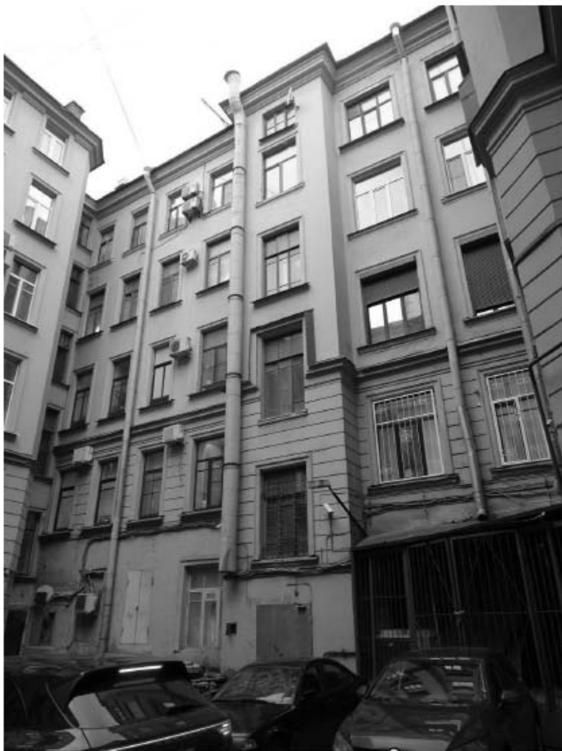
Фото 13. Здание по адресу: г. Санкт-Петербург, Большой проспект П.С., дом 49/18, литера А. Западный внутренний двор. Съемка 19.04.2021 г. Михайловская Г. В.
