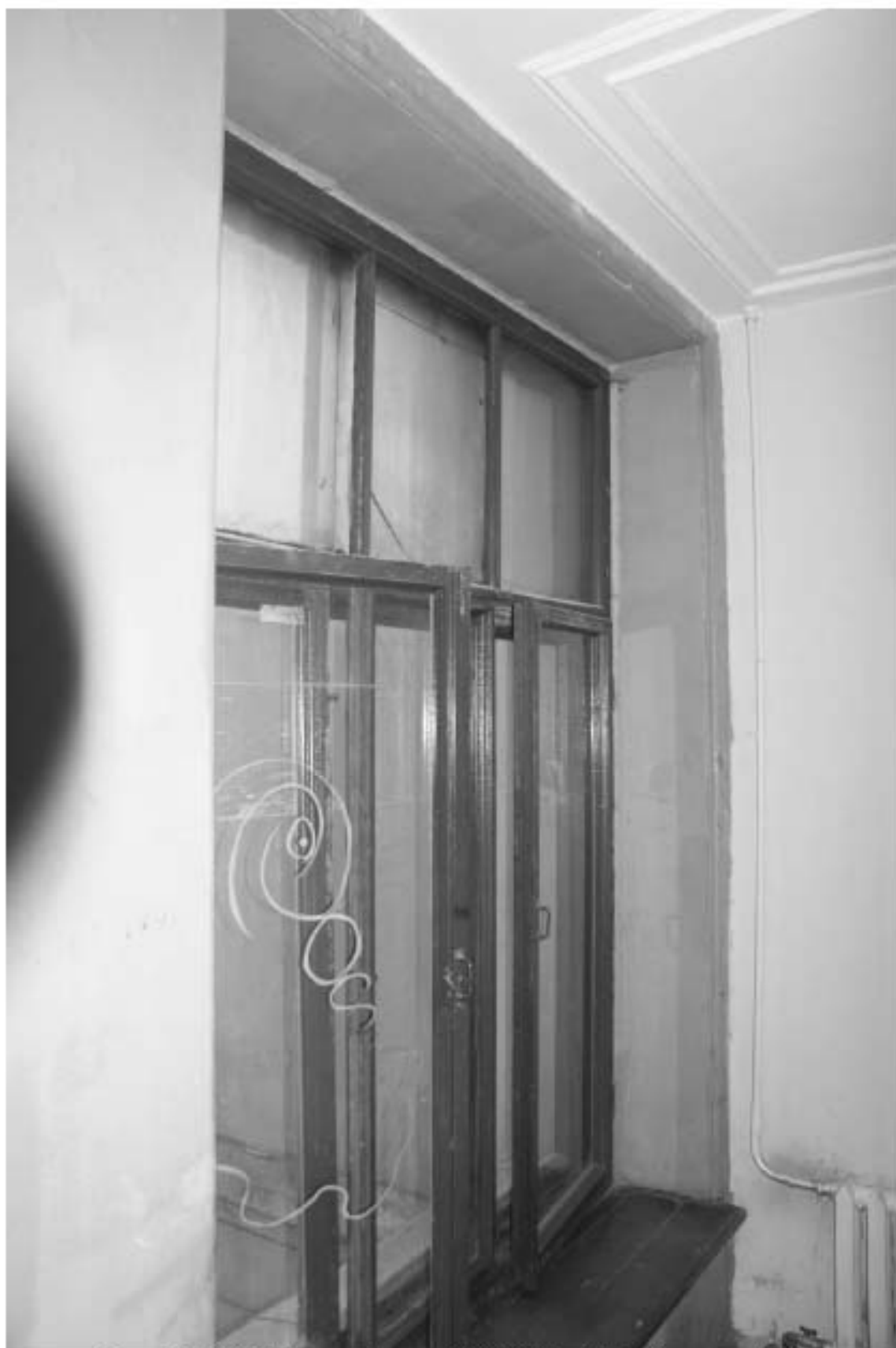
Фото 45. 4ЛК. 2-й этаж. Съемка 19.04.2021 г. Михайловская Г. В.
