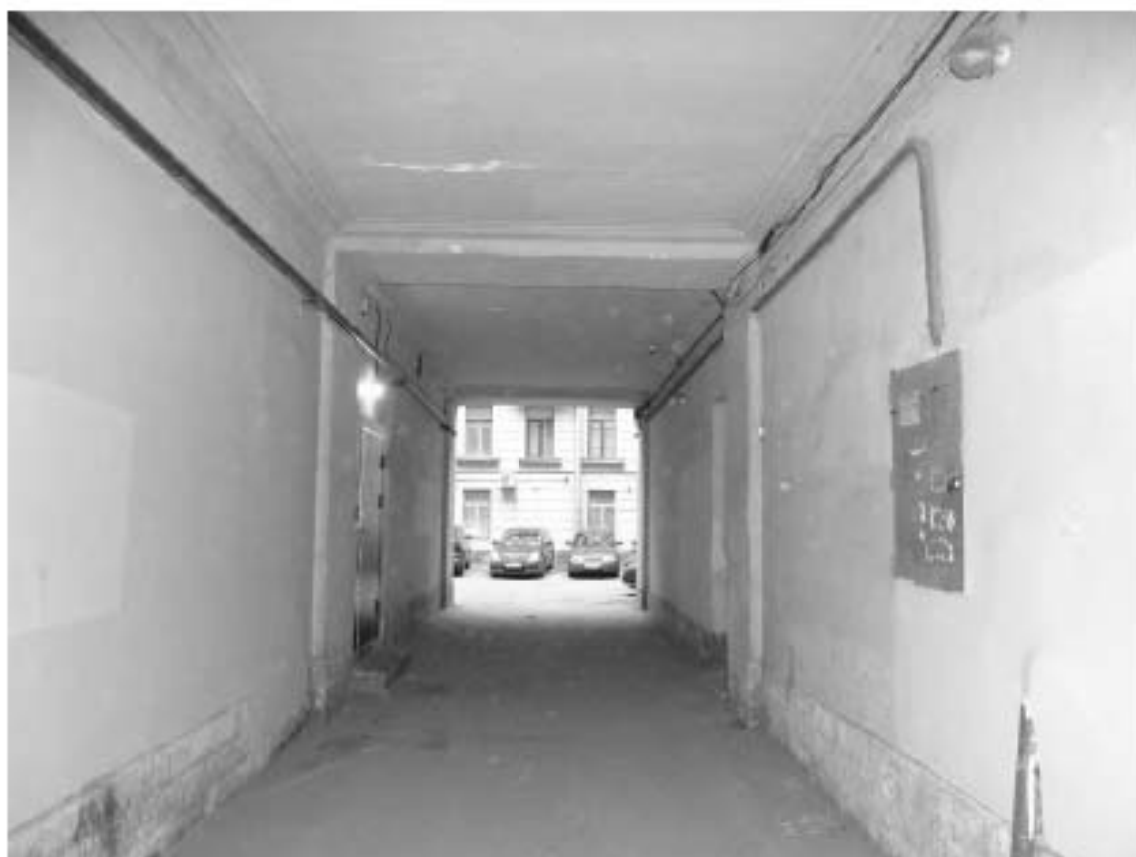
Фото 10. Здание по адресу: г. Санкт-Петербург, Большой проспект П.С., дом 49/18, литера А. Въездная арка. Съемка 19.04.2021 г. Михайловская Г. В.
