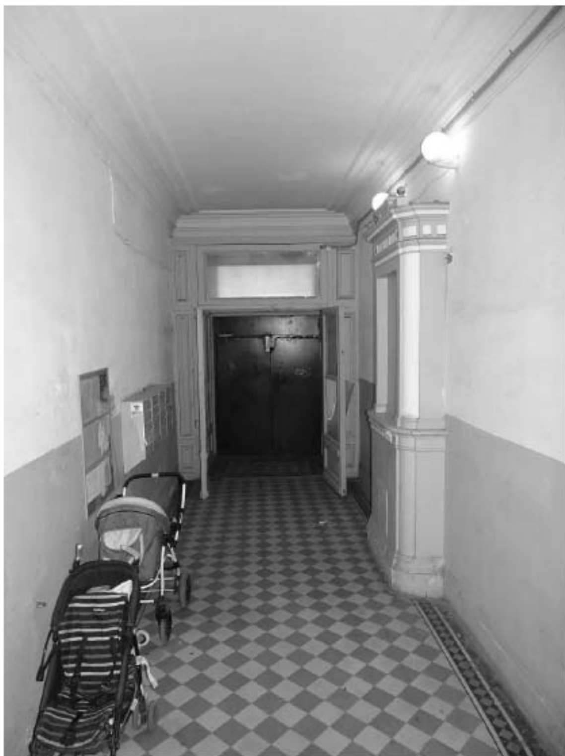
Фото 70. 1ЛК. 1-й этаж. Вестибюль. Съемка 19.04.2021 г. Михайловская Г. В.
