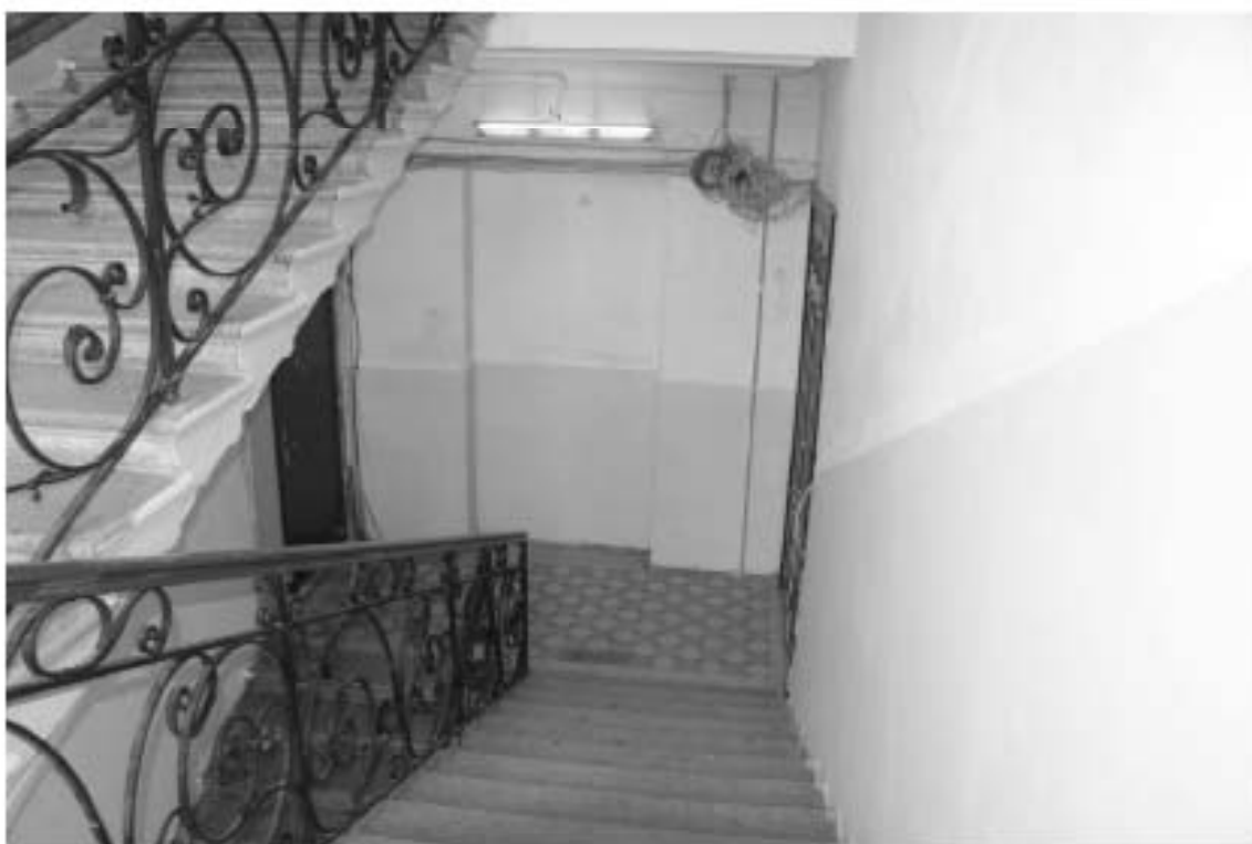
Фото 23. 2ЛК. 4-й этаж. Съемка 19.04.2021 г. Михайловская Г. В.
