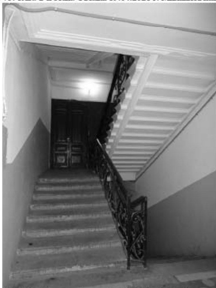
Фото 76. 1ЛК. 2-й этаж. Съемка 19.04.2021 г. Михайловская Г. В.
