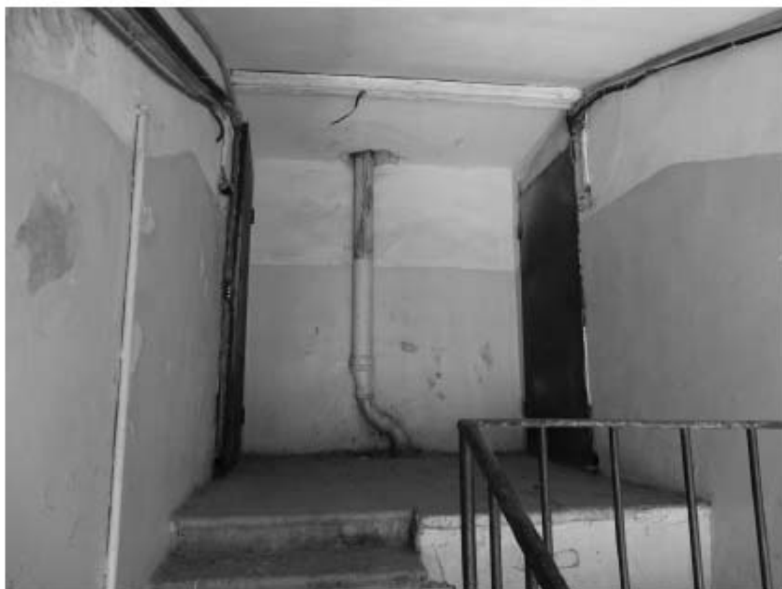
Фото 129. 5ЛК. 6-й этаж. Съемка 19.04.2021 г. Михайловская Г. В.
