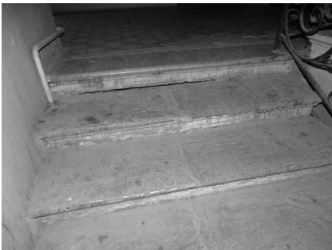
Фото 71. 1ЛК. 1-й этаж. Вестибюль. Ступени. Съемка 19.04.2021 г. Михайловская Г. В.
