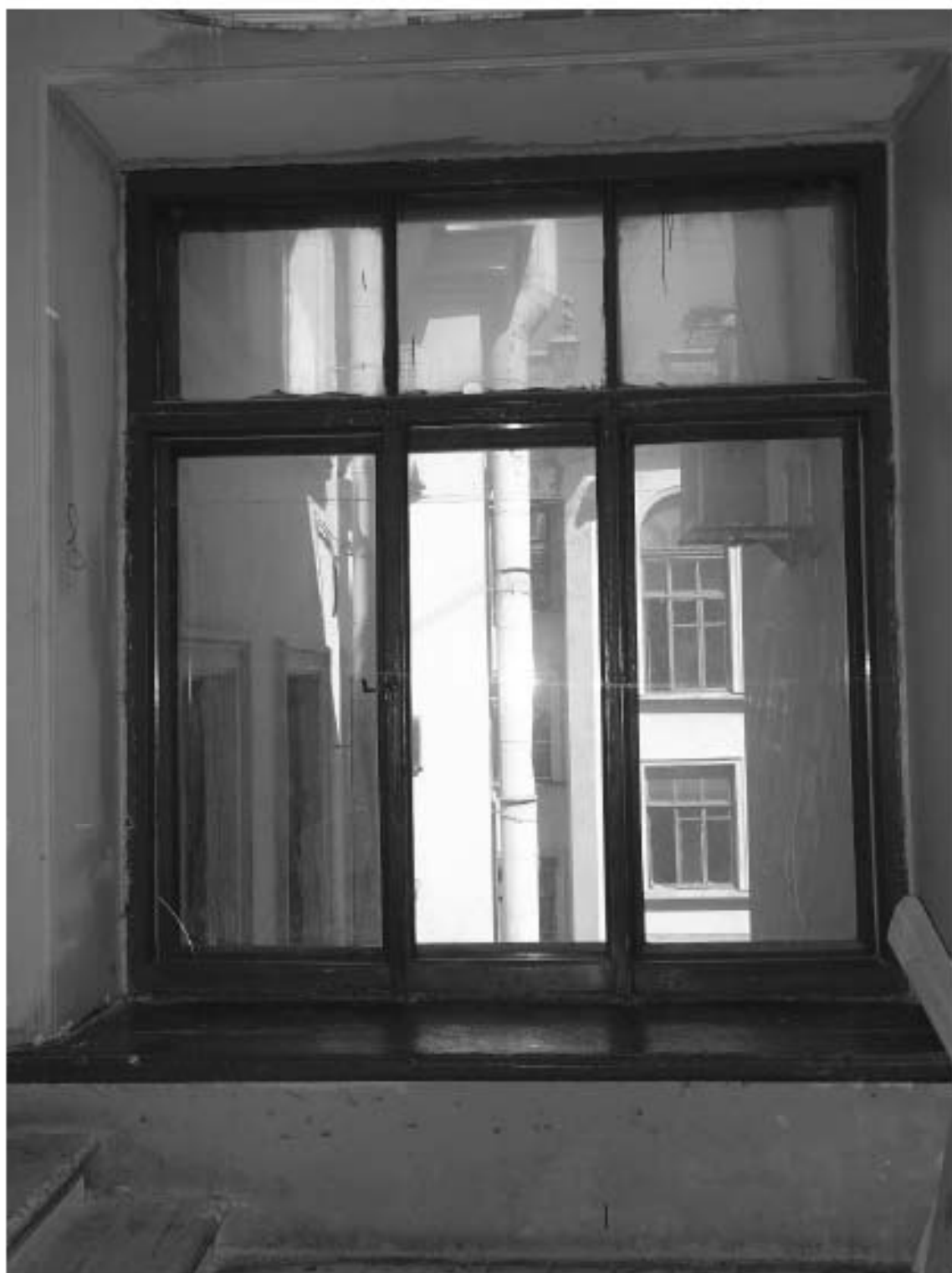
Фото 56. 4ЛК. 4-й этаж. Съемка 19.04.2021 г. Михайловская Г. В.
