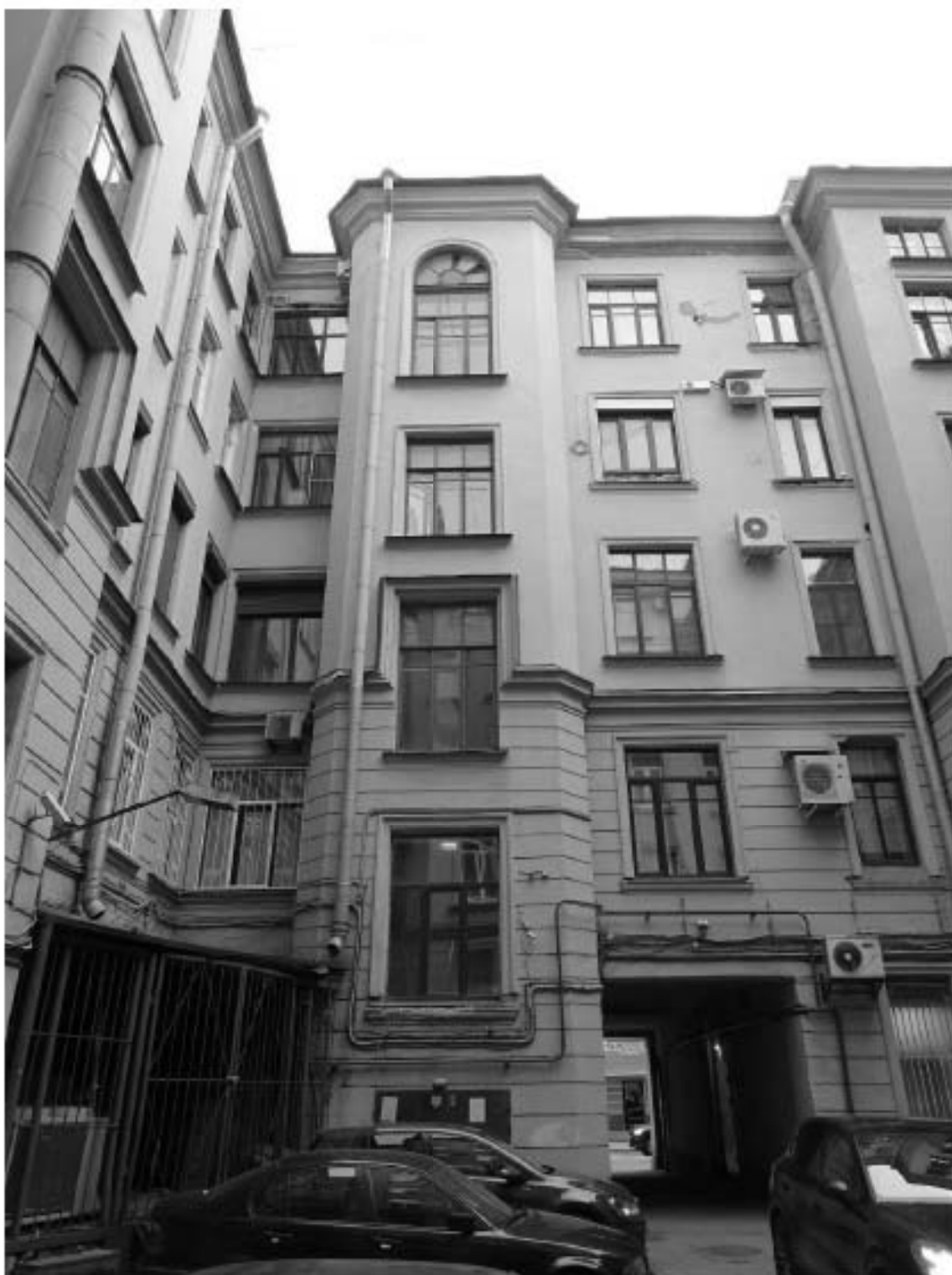
Фото 14. Здание по адресу: г. Санкт-Петербург, Большой проспект П.С., дом 49/18, литера А. Западный внутренний двор. Съемка 19.04.2021 г. Михайловская Г. В.
