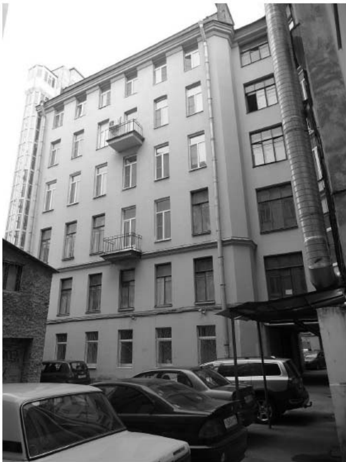
Фото 18. Здание по адресу: г. Санкт-Петербург, Большой проспект П.С., дом 49/18, литера А. Восточный внутренний двор. Съемка 19.04.2021 г. Михайловская Г. В.
