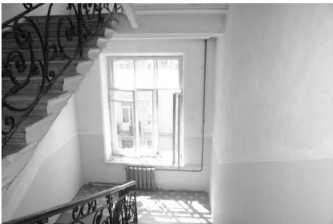
Фото 22. 2ЛК. Площадка между 3-м и 4-м этажом. Съемка 19.04.2021 г. Михайловская Г. В.
