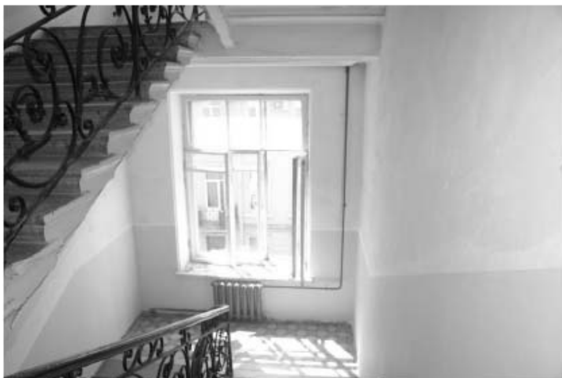
Фото 24. 2ЛК. Площадка между 4-м и 5-м этажом. Съемка 19.04.2021 г. Михайловская Г. В.
