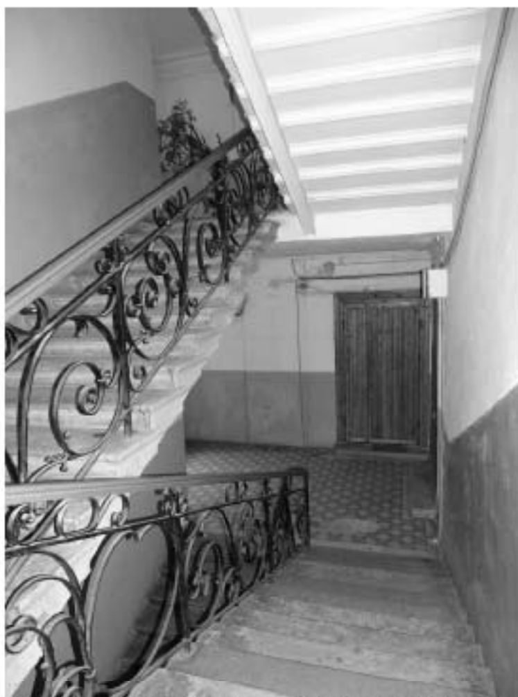
Фото 77. 1ЛК. 2-й этаж. Съемка 19.04.2021 г. Михайловская Г. В.
