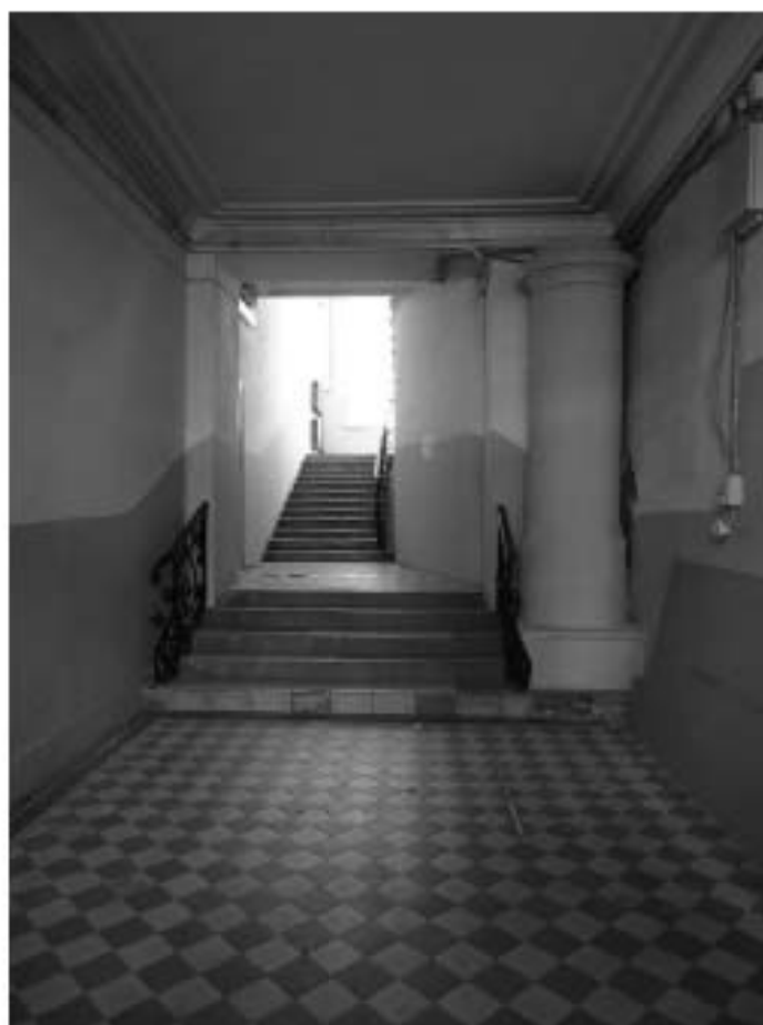
Фото 5. 2ЛК. 1-й этаж. Вестибюль. Съемка 19.04.2021 г. Михайловская Г. В.
