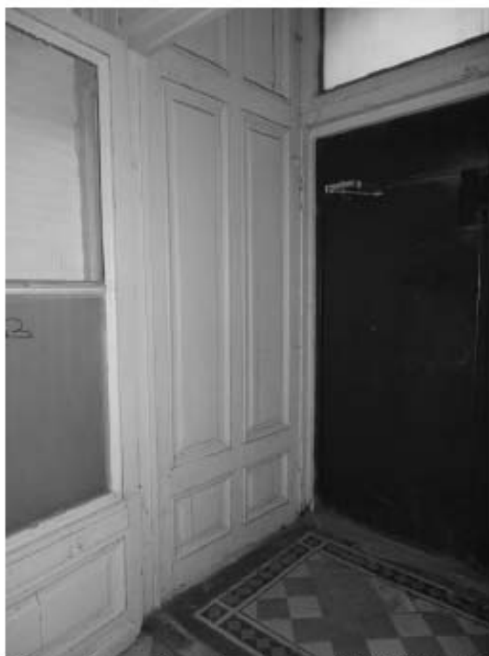
Фото 64. 1ЛК. 1-й этаж. Входной тамбур. Съемка 19.04.2021 г. Михайловская Г. В.
