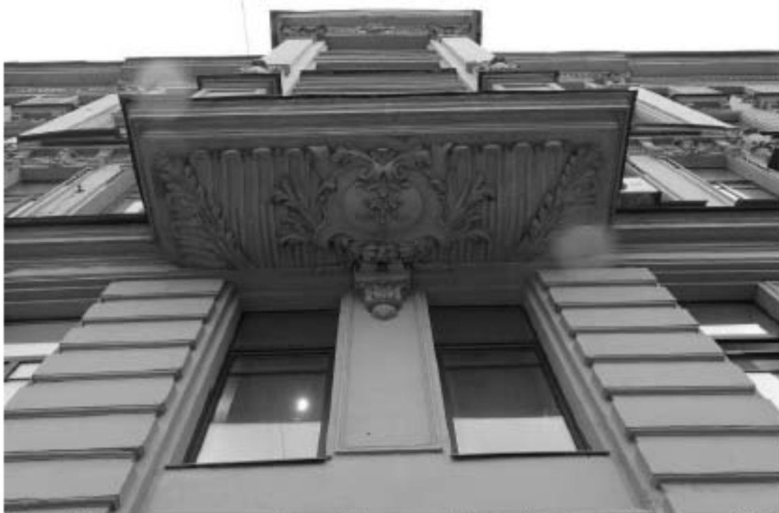
Фото 4. Здание по адресу: г. Санкт-Петербург, Большой проспект П.С., дом 49/18, литера А. Лицевой фасад по Большому пр. Фрагмент. Съемка 19.04.2021 г. Михайловская Г. В.
