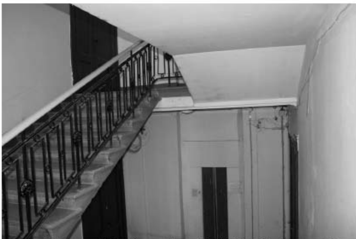
Фото 65. Лестница № 2: 6-й этаж. Съемка 19.04.2021 г. Михайловская Г. В.
