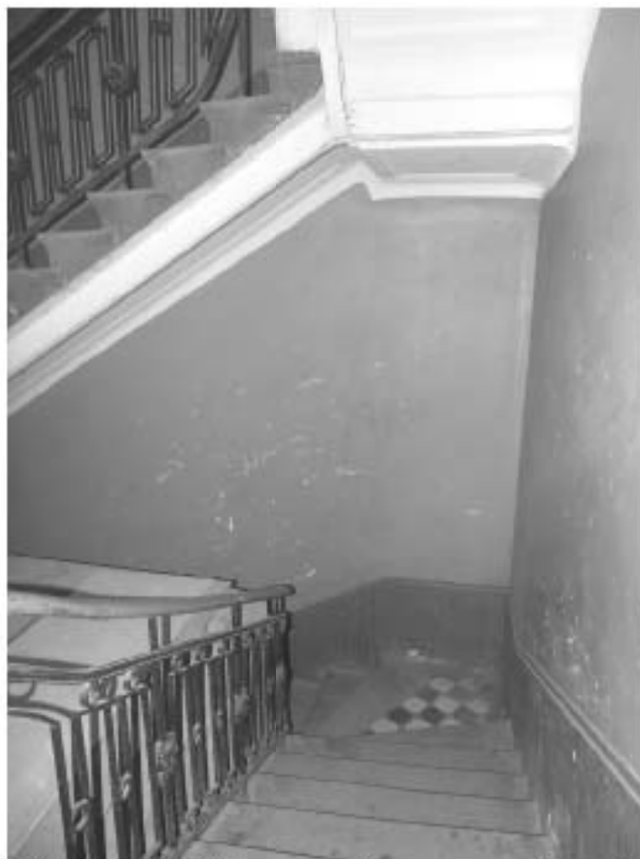
Фото 103. Лестница № 6: Лестничный марш между 1-м и 2-м этажом. Съемка 19.04.2021 г. Михайловская Г. В.
