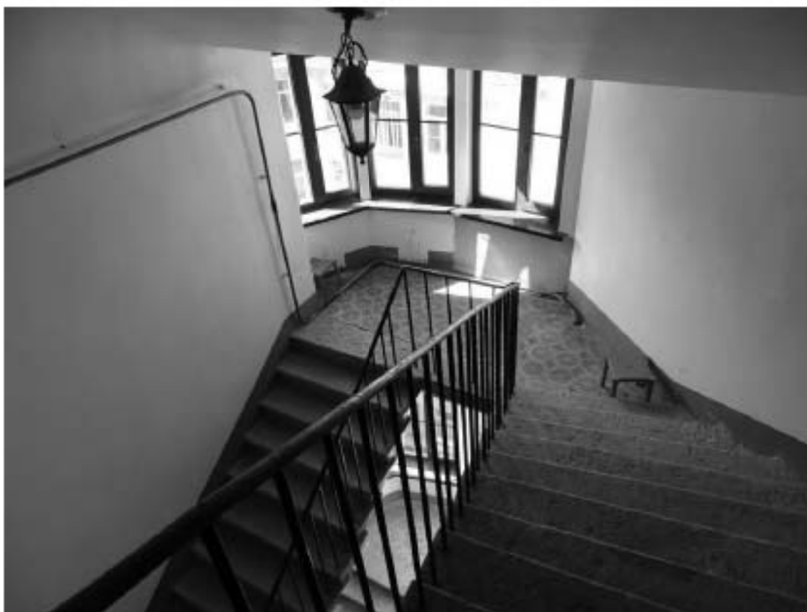
Фото 117. Лестница № 11: Площадка между 7-м и 8-м этажом. Съёмка 19.04.2021 г. Михайловская Г. В.
