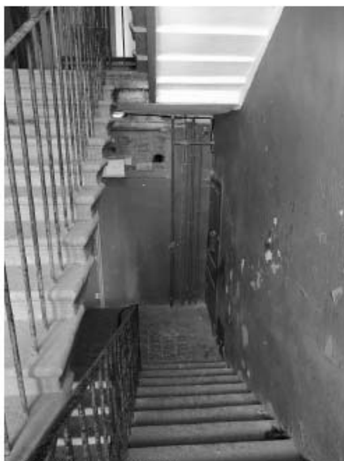
Фото 139. Лестница № 12: Вид на площадку 6-го этажа. Съемка 19.04.2021 г. Михайловская Г. В.
