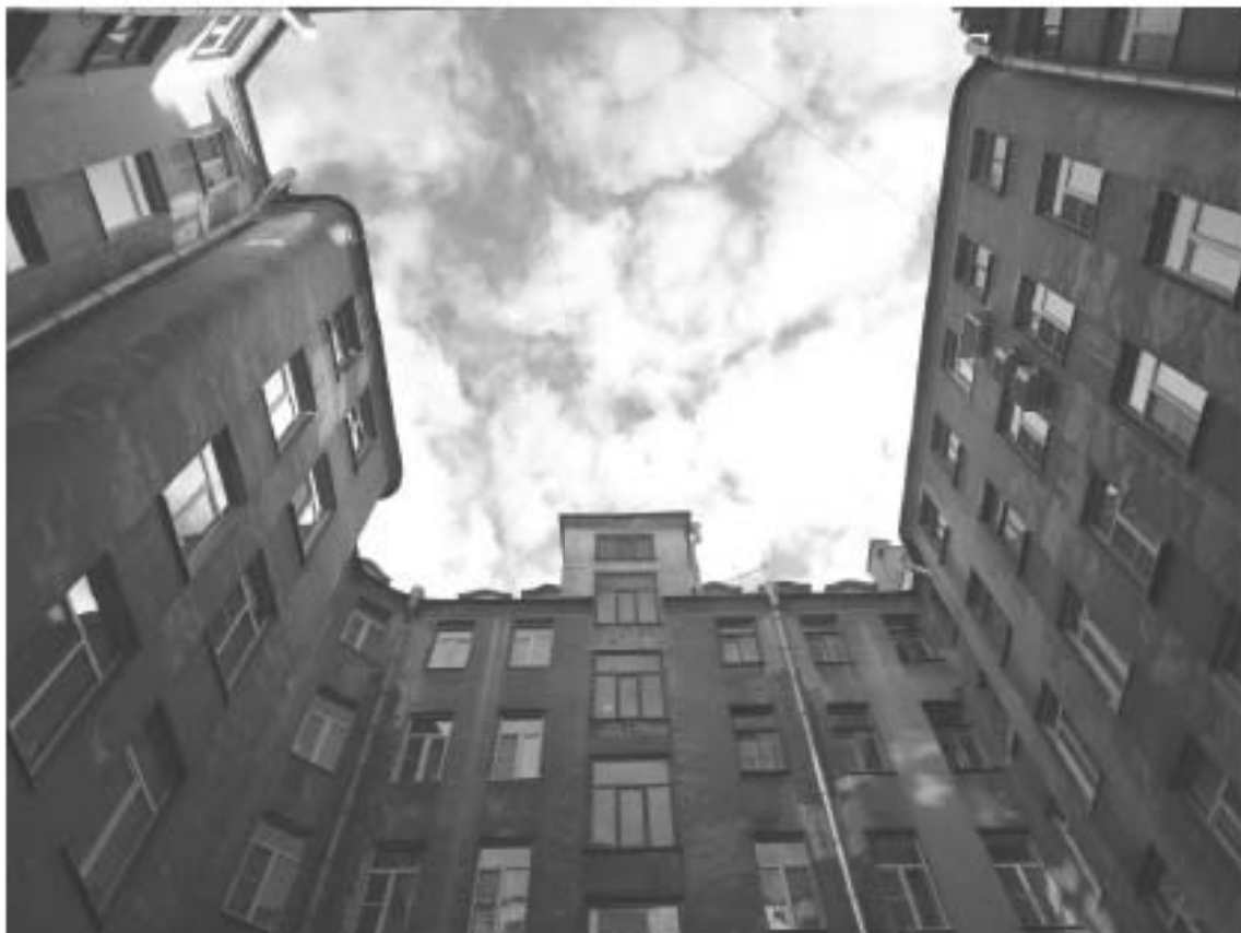
Фото 30. Здание по адресу: г. Санкт-Петербург, Большой проспект П.С., дом 74, литера А. Западный внутренний двор. Съемка 19.04.2021 г. Михайловская Г. В.
