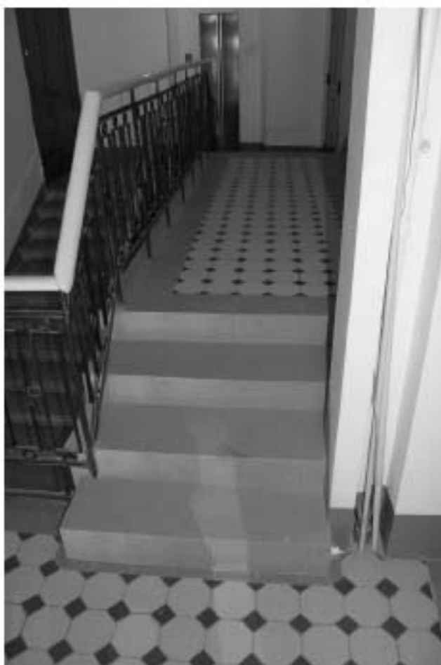
Фото 70. Лестница № 2: 7-й этаж. Переход между лестницами. Съемка 19.04.2021 г. Михайловская Г. В.
