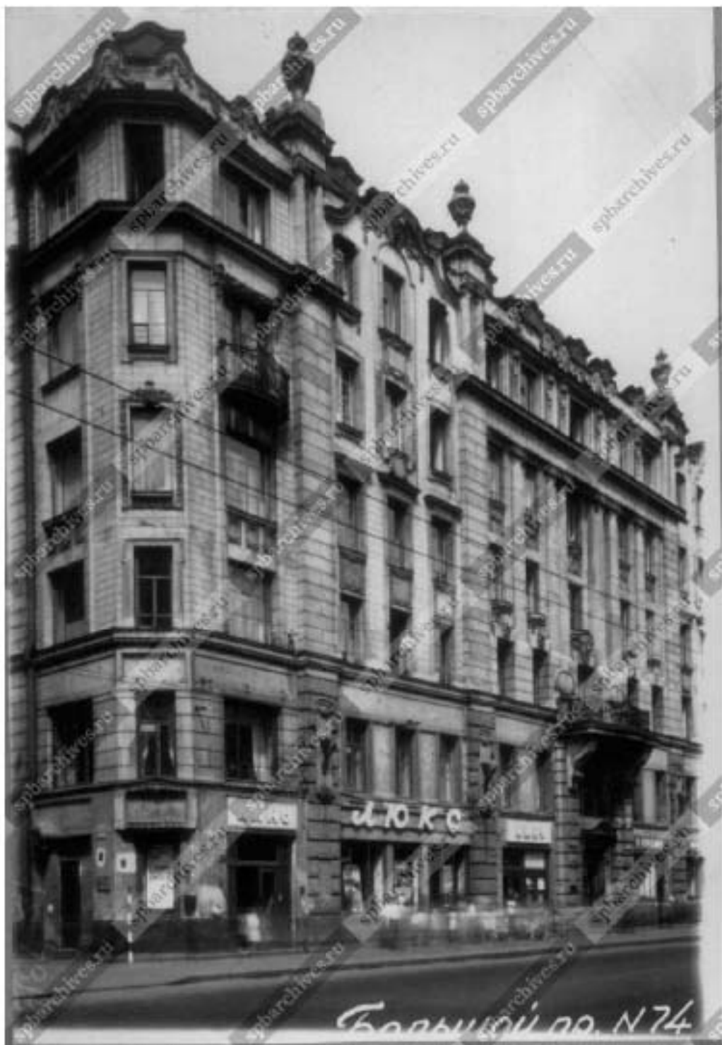
46. Большой проспект П.С., д. 74. 1949 г. ЦГАКФФД, шифр Гр 73131 URL: https://www.citywalls.ru/photo465606.html
