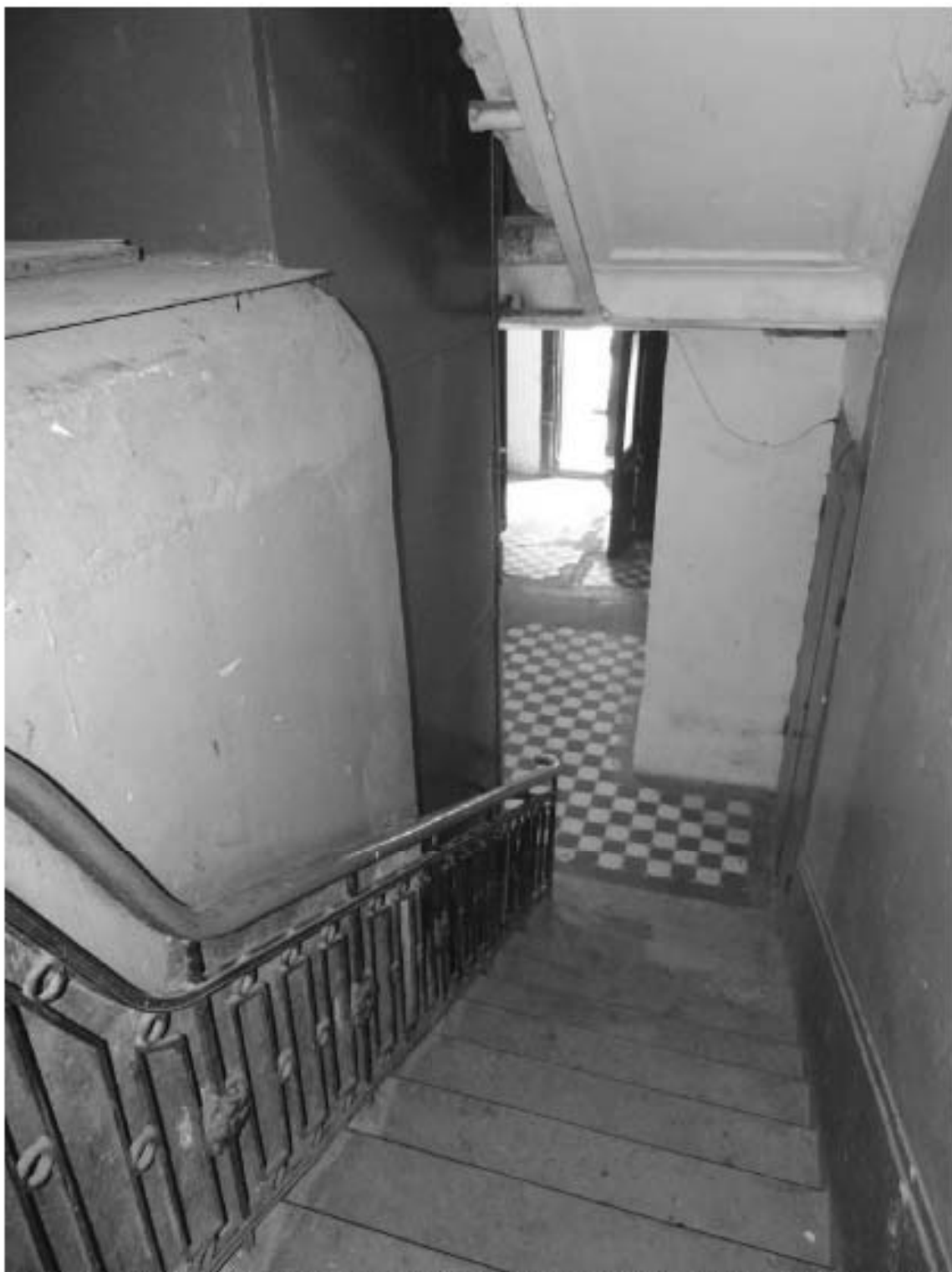
Фото 101. Лестница № 6: Лестничный марш на площадку между 1-м и 2-м этажом. Съемка 19.04.2021 г. Михайловская Г. В.
