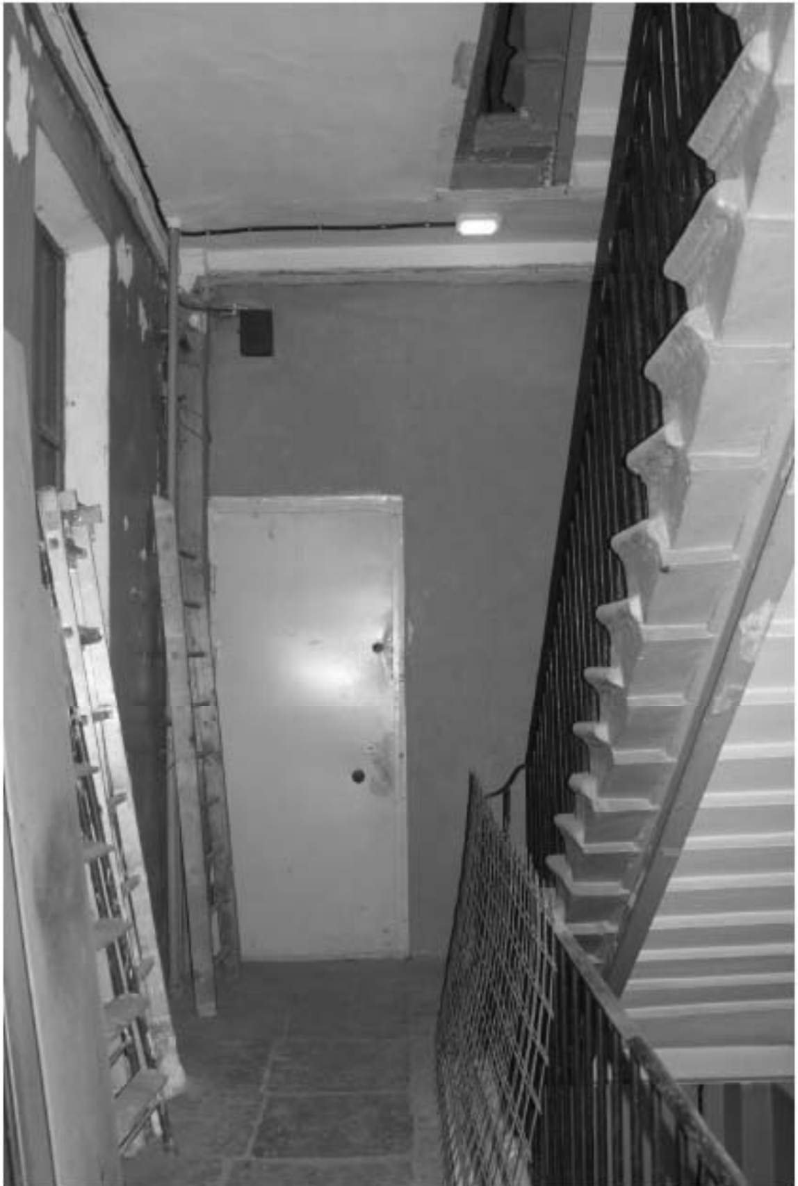
Фото 138. Лестница № 7: 3-й этаж. Съемка 19.04.2021 г. Михайловская Г. В.
