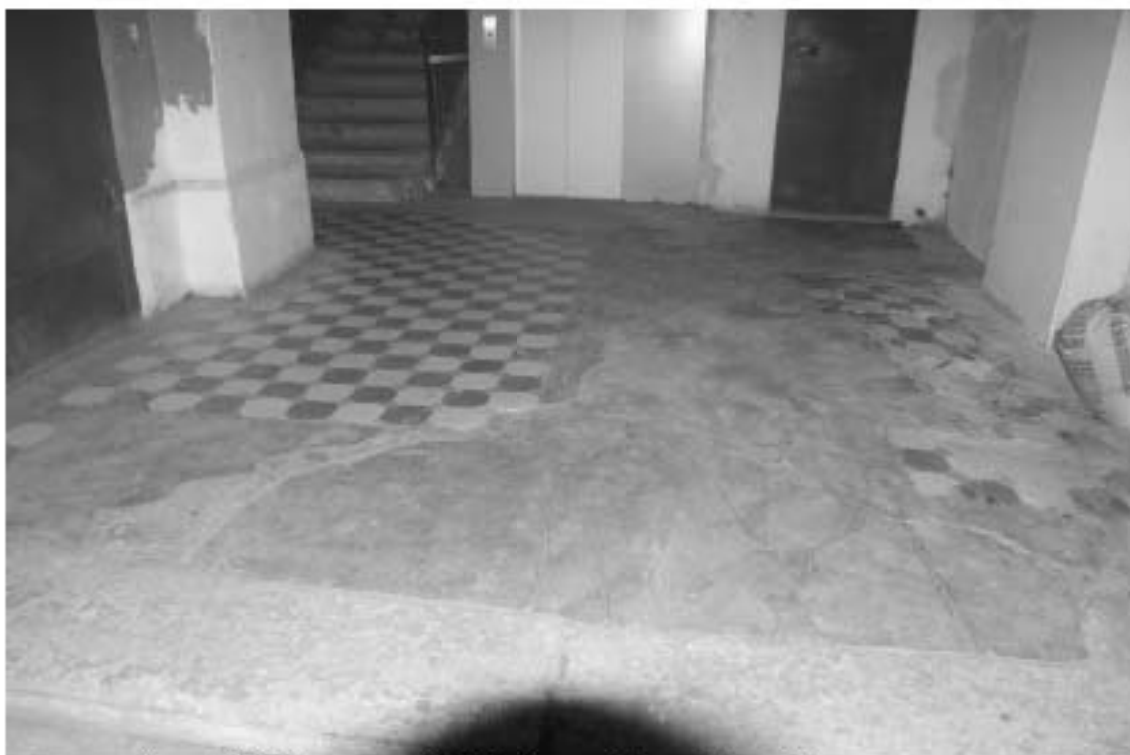
Фото 100. Лестница № 6: 1-й этаж. Вестибюль. Покрытие пола. Съемка 19.04.2021 г. Михайловская Г. В.
