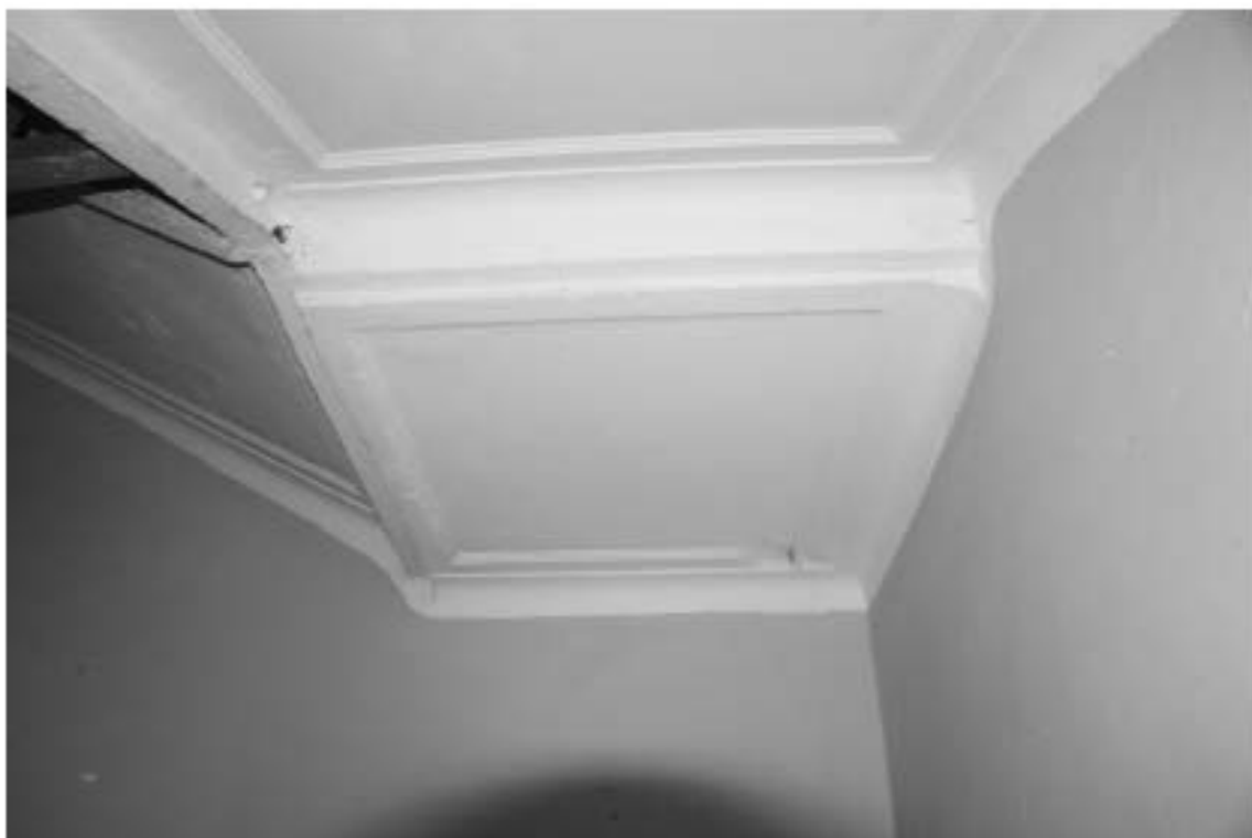
Фото 34. Лестница № 4: Лестничная площадка между 1-м и 2-м этажом. Оформление потолка. Съемка 19.04.2021 г. Михайловская Г. В.
