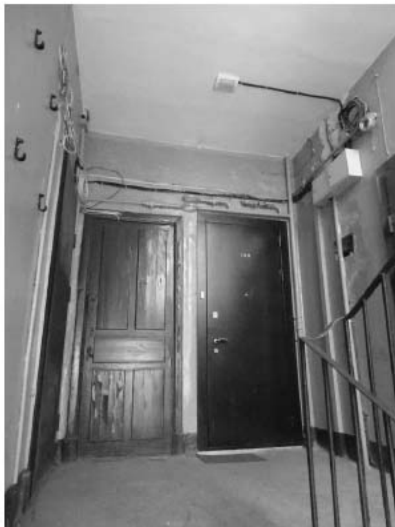
Фото 166. Лестница № 8: 4-й этаж. Съемка 19.04.2021 г. Михайловская Г. В.
