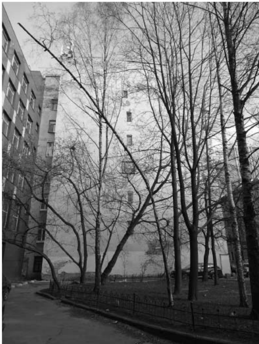
Фото 23. Здание по адресу: г. Санкт-Петербург, Большой проспект П.С., дом 74, литера А. Западный торцевой фасад. Съемка 19.04.2021 г. Михайловская Г. В.
