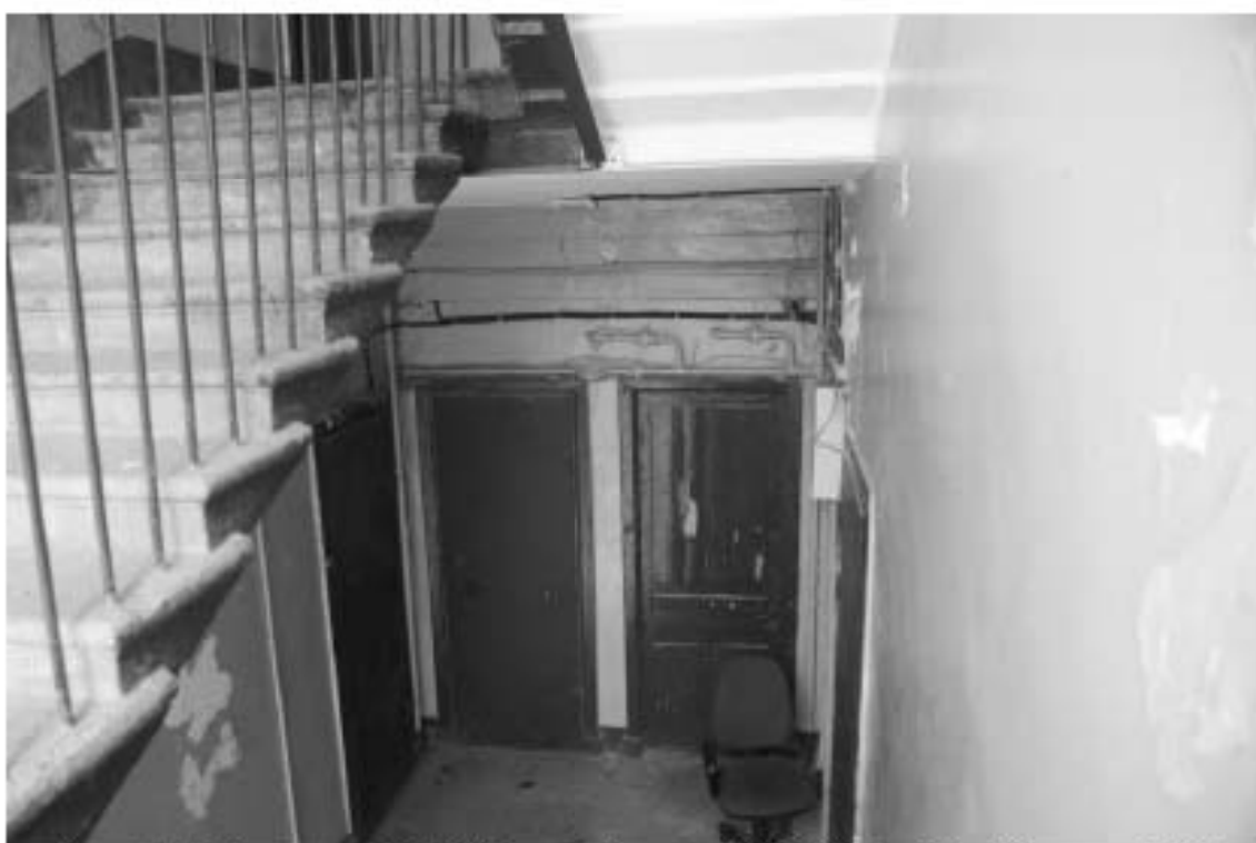
Фото 172. Лестница № 8: 6-й этаж. Съемка 19.04.2021 г. Михайловская Г. В.
