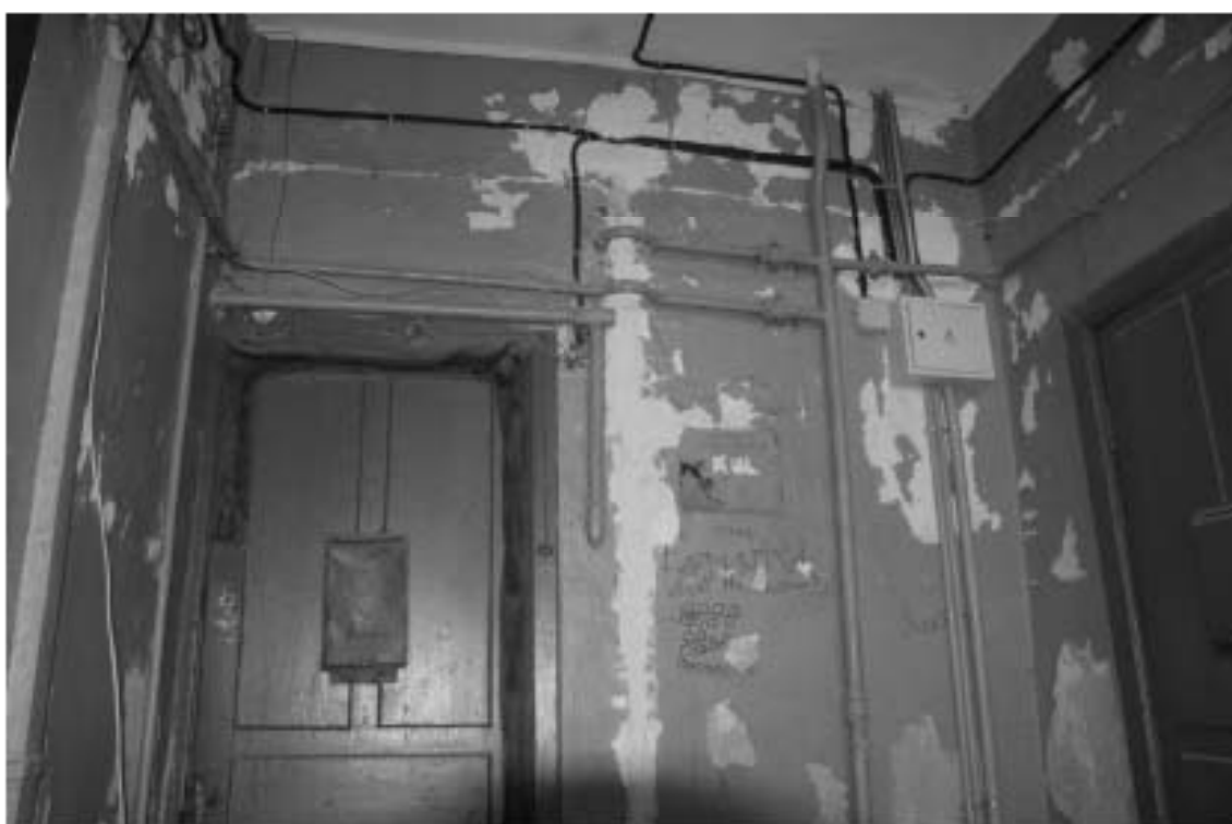
Фото 188. Лестница № 9: 4-й этаж. Съемка 19.04.2021 г. Михайловская Г. В.
