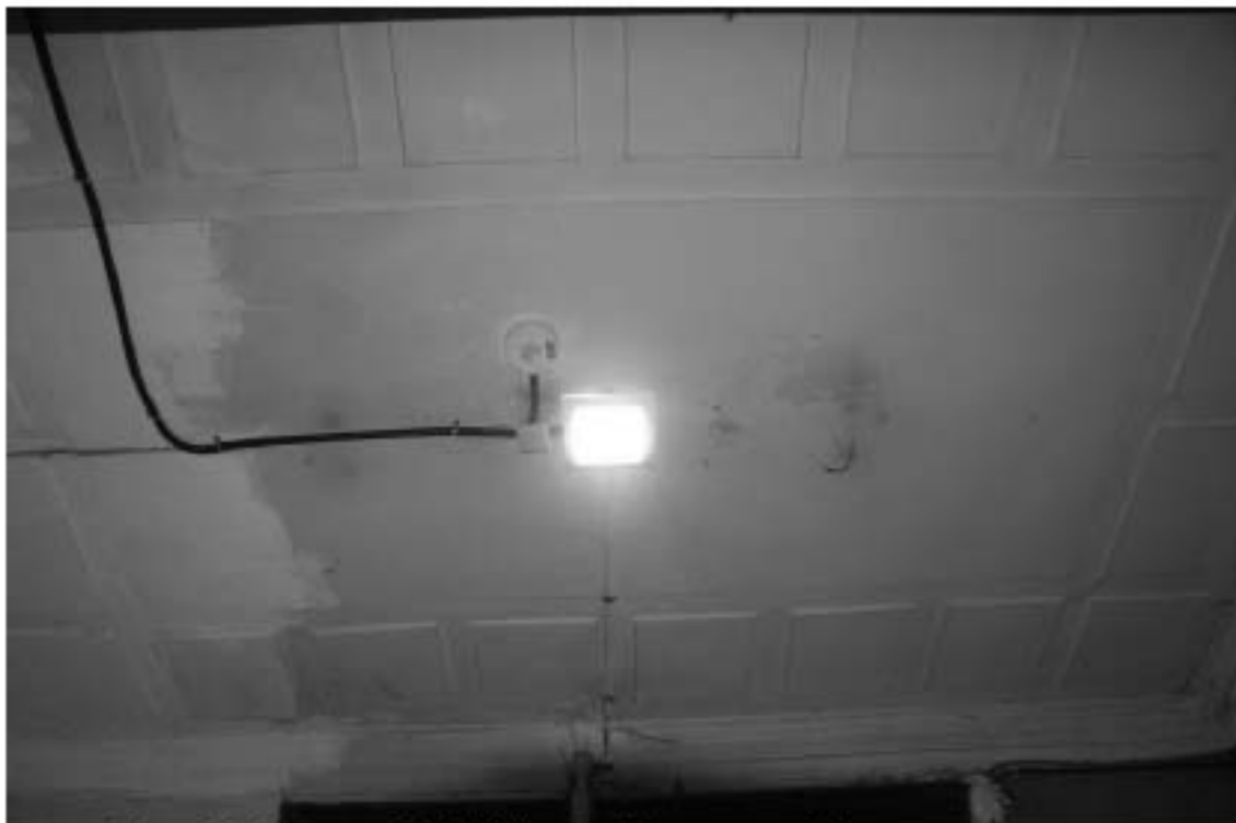
Фото 99. Лестница № 6: 1-й этаж. Вестибюль. Оформление потолка. Съемка 19.04.2021 г. Михайловская Г. В.
