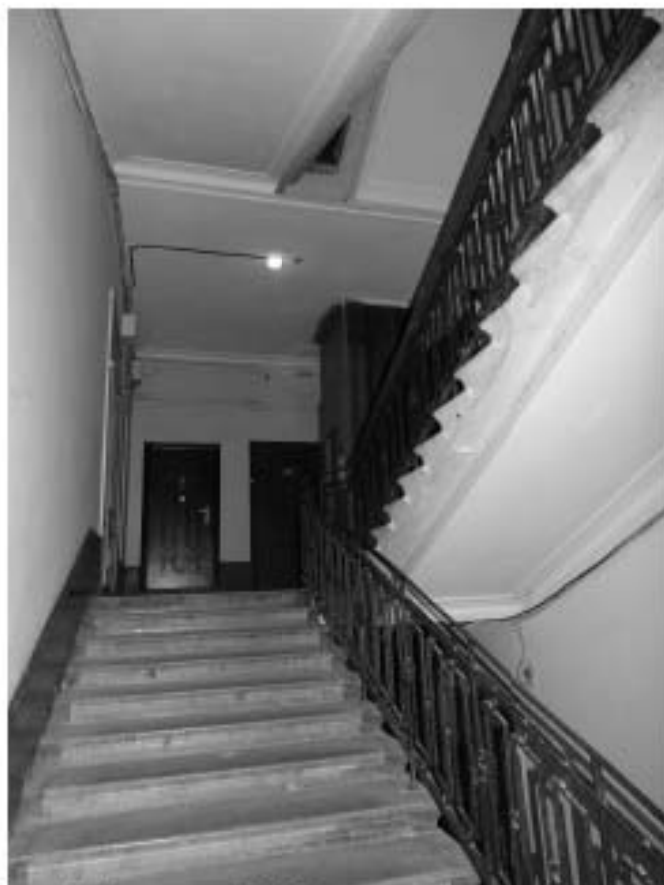
Фото 7. Лестница № 3: Вид на площадку 2-го этажа. Съемка 19.04.2021 г. Михайловская Г. В.
