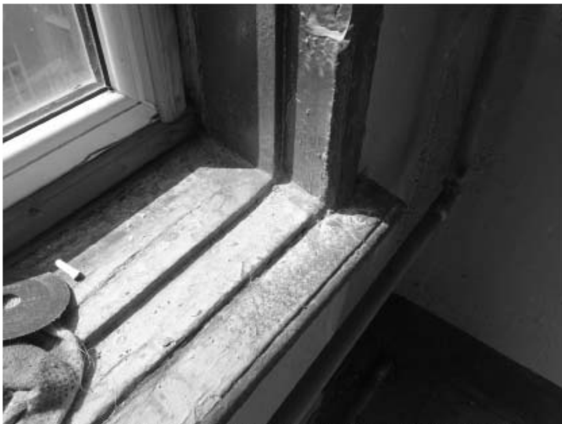
Фото 168. Лестница № 8: Заполнение оконного проема. Подоконник. Съемка 19.04.2021 г. Михайловская Г. В.
