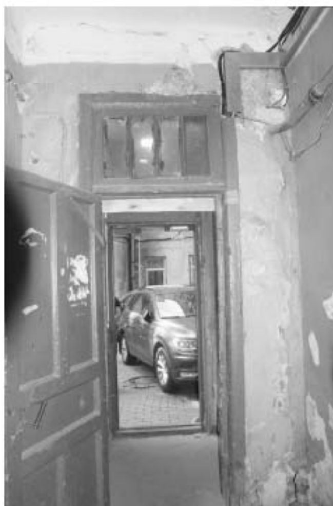
Фото 131. Лестница № 7: 1-й этаж. Вестибюль. Заполнение дверного проема. Съемка 19.04.2021 г. Михайловская Г. В.
