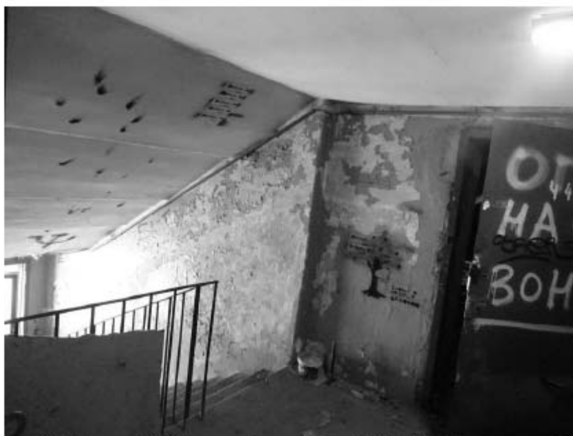
Фото 201. Лестница № 9: Чердачный этаж. Съемка 19.04.2021 г. Михайловская Г. В.
