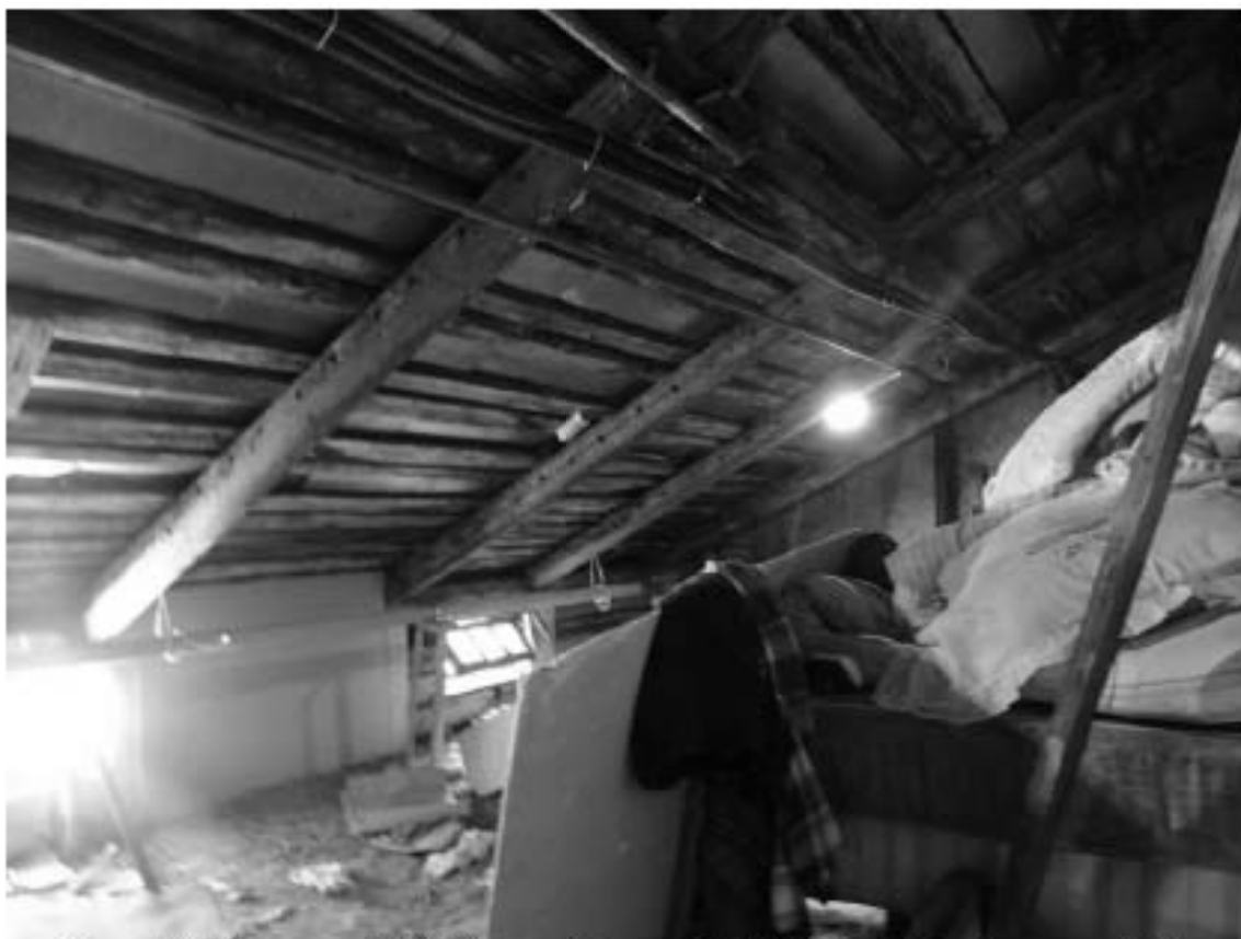
Фото 152. Лестница № 7: Чердак. Съёмка 19.04.2021 г. Михайловская Г. В.
