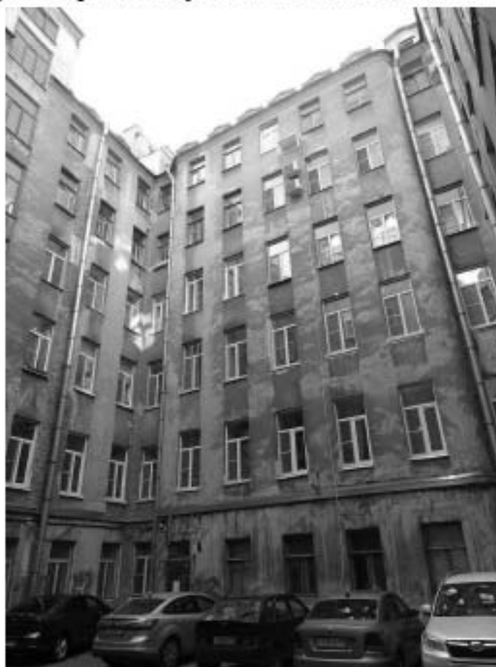
Фото 27. Здание по адресу: г. Санкт-Петербург, Большой проспект П.С., дом 74, литера А. Западный внутренний двор. Съемка 19.04.2021 г. Михайловская Г. В.
