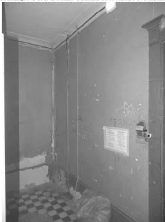
Фото 109. Лестница № 6: 2-й этаж. Съемка 19.04.2021 г. Михайловская Г. В.
