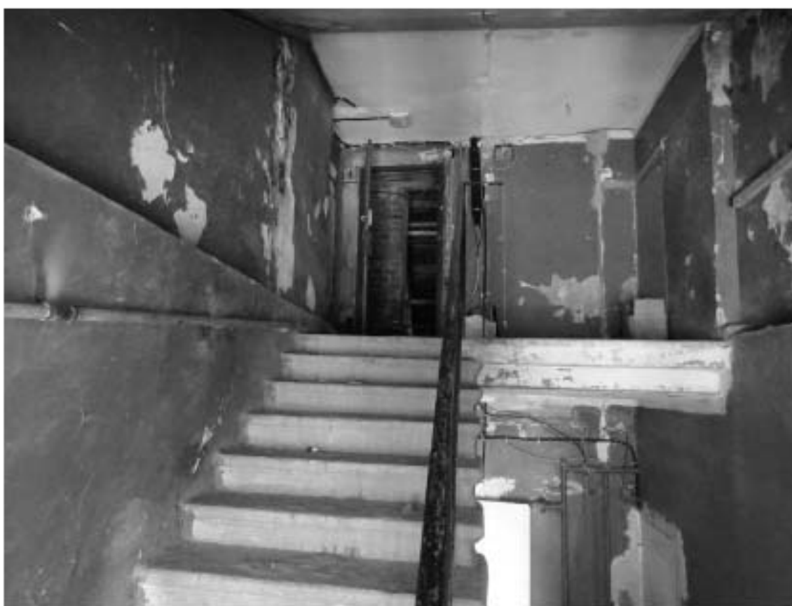
Фото 146. Лестница № 12: Площадка чердачного этажа. Съемка 19.04.2021 г. Михайловская Г. В.
