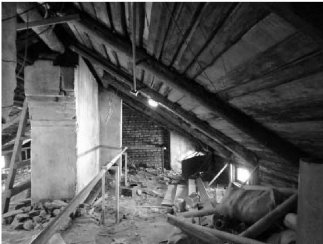
Фото 204. Лестница № 9: Чердачный этаж. Съемка 19.04.2021 г. Михайловская Г. В.
