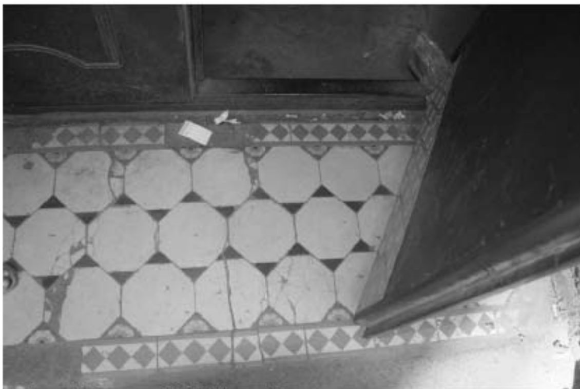
Фото 95. Лестница № 6: 1-й этаж. Покрытие пола перед входным тамбуром. Съемка 19.04.2021 г. Михайловская Г. В.
