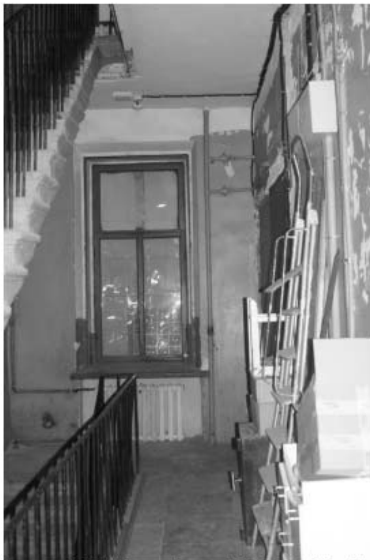
Фото 139. Лестница № 7: 4-й этаж. Съемка 19.04.2021 г. Михайловская Г. В.
