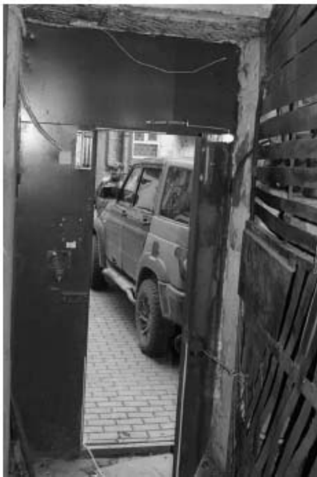
Фото 147. Лестница № 13: Вестибюль 1-го этажа. Входная дверь. Съемка 19.04.2021 г. Михайловская Г. В.
