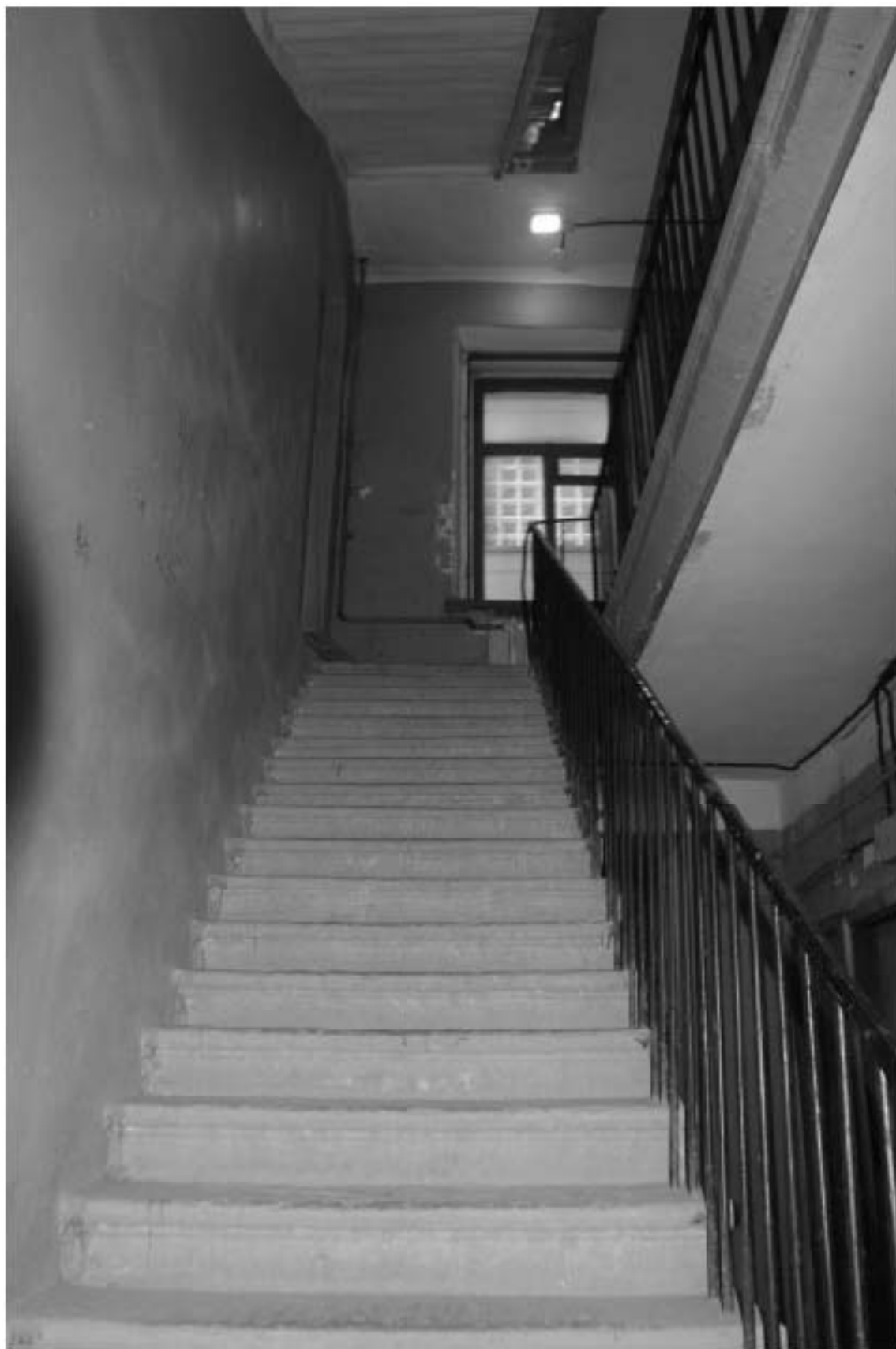
Фото 134. Лестница № 7: Лестничный марш на 2-й этаж. Съемка 19.04.2021 г. Михайловская Г. В.
