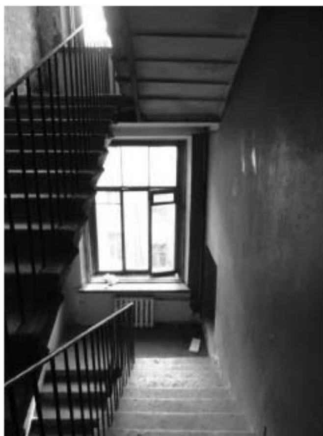
Фото 132. Лестница № 12: Вид на площадку между 3-м и 4-м этажом. Съемка 19.04.2021 г. Михайловская Г. В.
