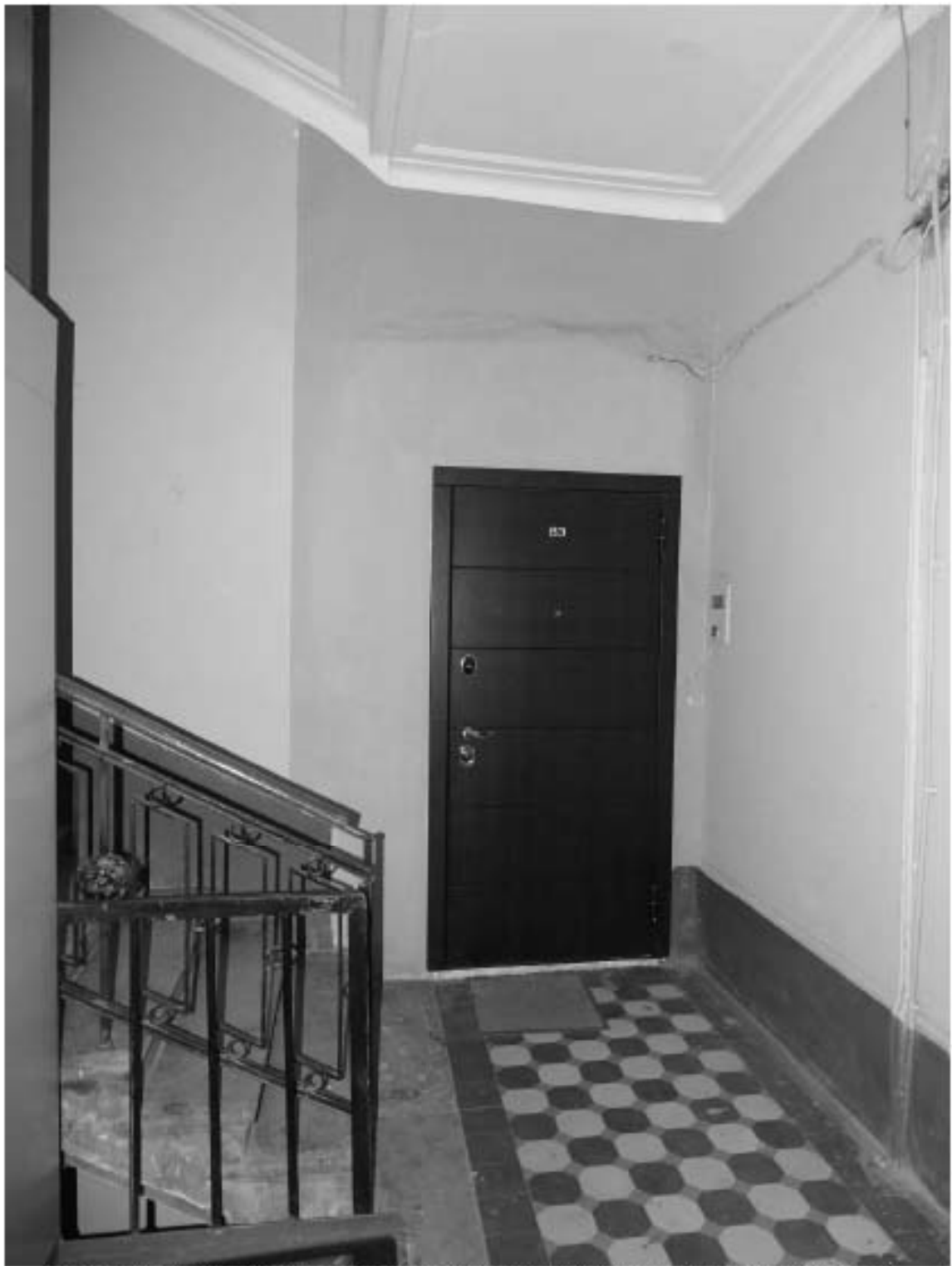
Фото 40. Лестница № 4: 4-й этаж. Съемка 19.04.2021 г. Михайловская Г. В.
