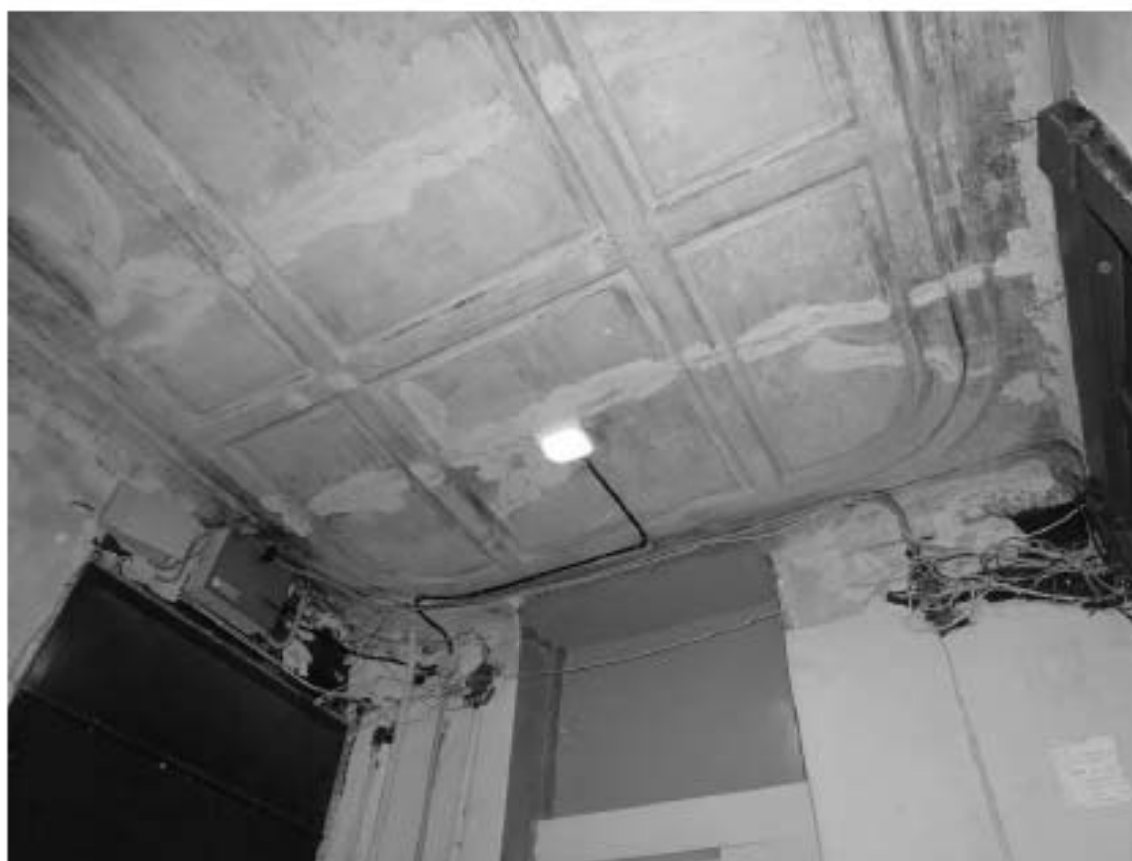
Фото 43. Лестница № 1: Площадка между 7-го этажа. Оформление потолка. Съемка 19.04.2021 г. Михайловская Г. В.
