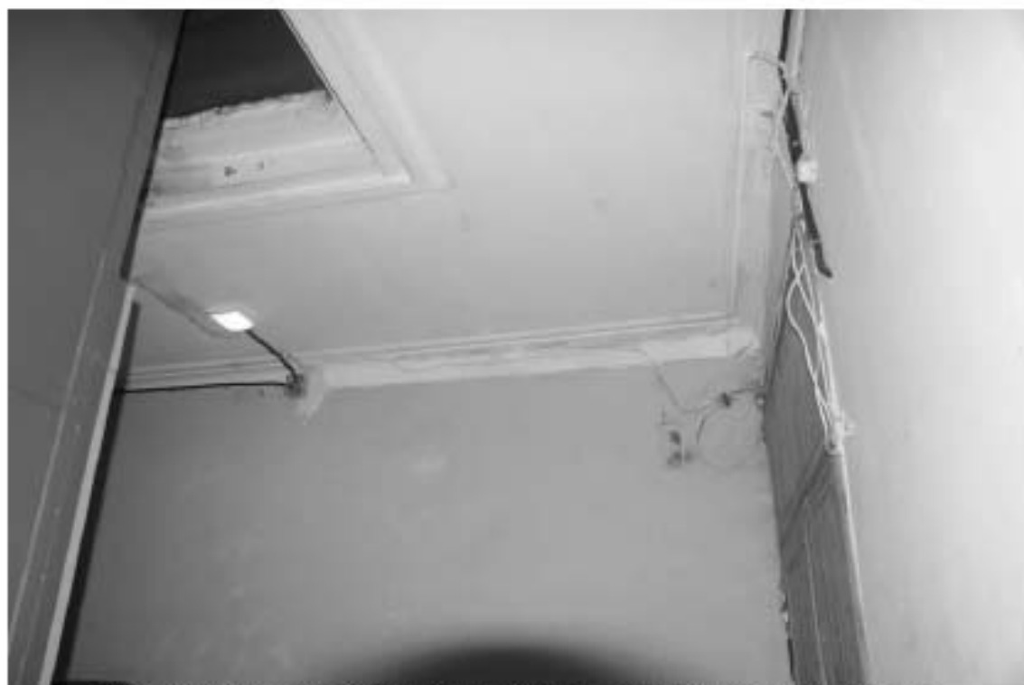
Фото 30. Лестница № 4: 1-й этаж. Вестибюль. Оформление потолка. Съемка 19.04.2021 г. Михайловская Г. В.
