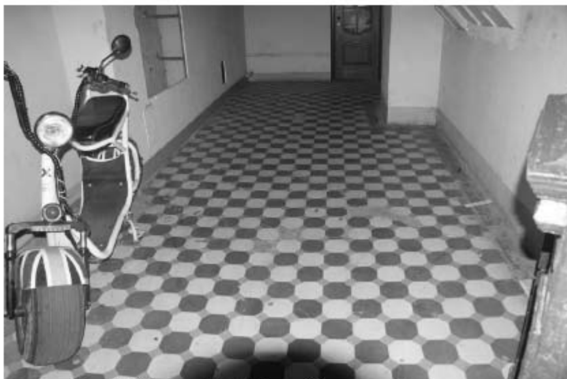
Фото 28. Лестница № 4: 1-й этаж. Вестибюль. Покрытие пола. Съемка 19.04.2021 г. Михайловская Г. В.
