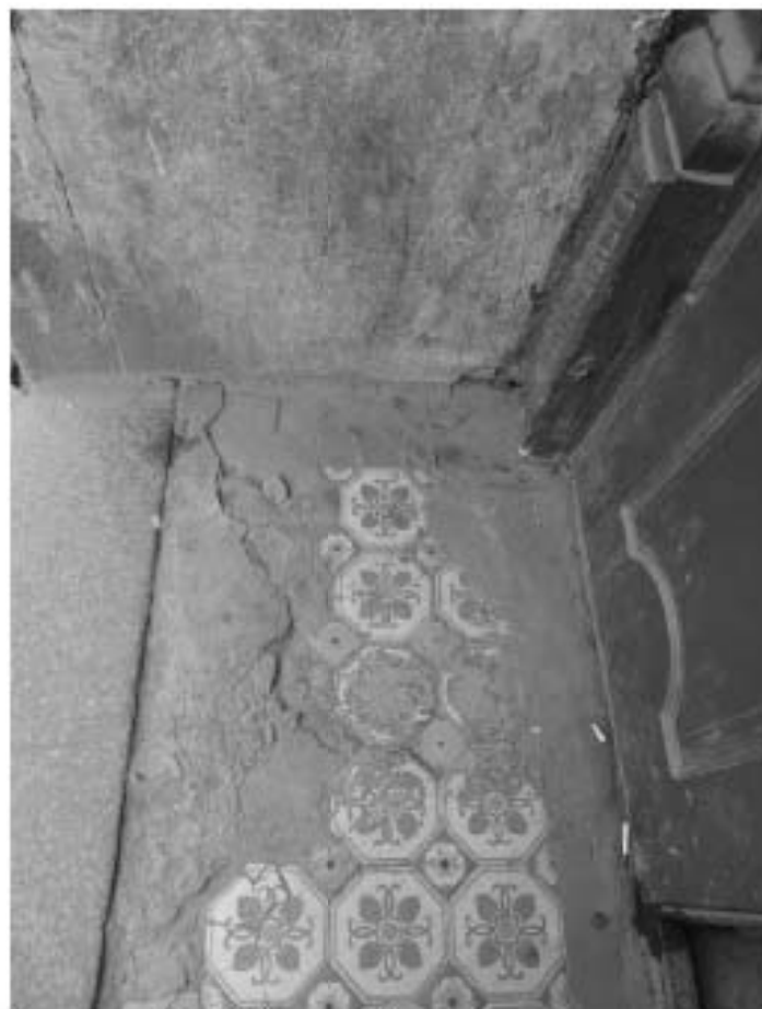
Фото 58. Лестница № 5: 1-й этаж. Покрытие перед входным тамбуром. Съемка 19.04.2021 г. Михайловская Г. В.
