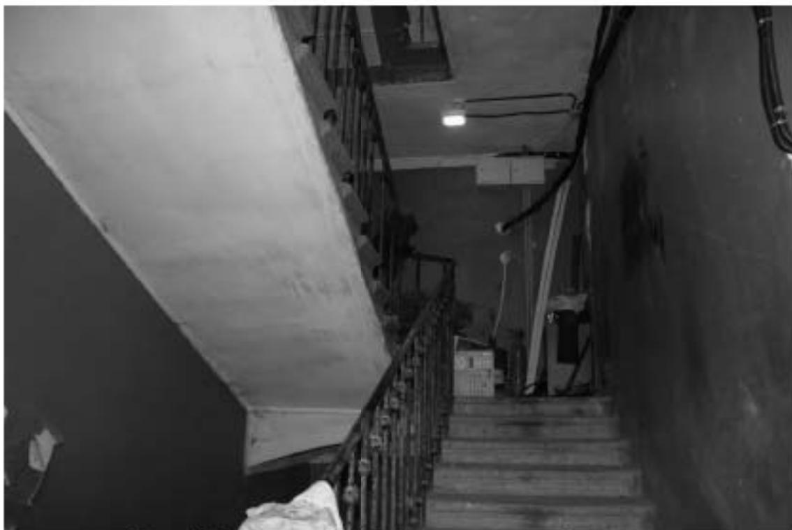
Фото 160. Лестница № 13: Вид на площадку 3-го этажа. Съемка 19.04.2021 г. Михайловская Г. В.
