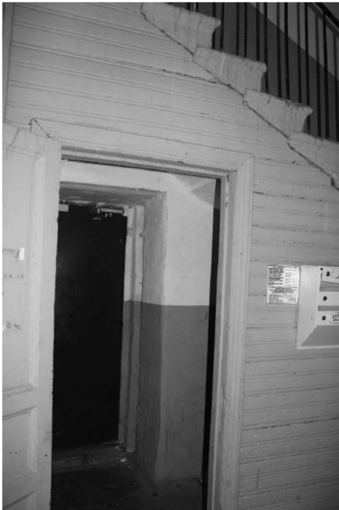
Фото 72. Лестница № 10: 1-й этаж. Тамбур. Входная дверь. Съемка 19.04.2021 г. Михайловская Г. В.
