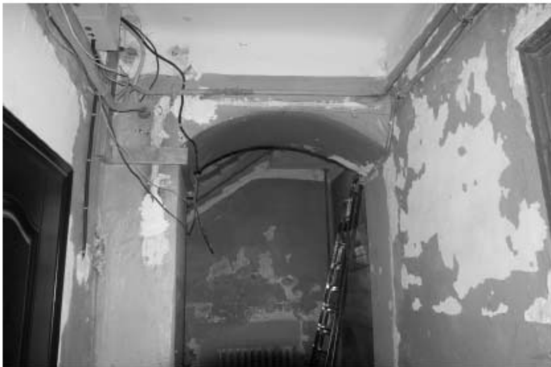
Фото 132. Лестница № 7: 1-й этаж. Вестибюль. Съемка 19.04.2021 г. Михайловская Г. В.
