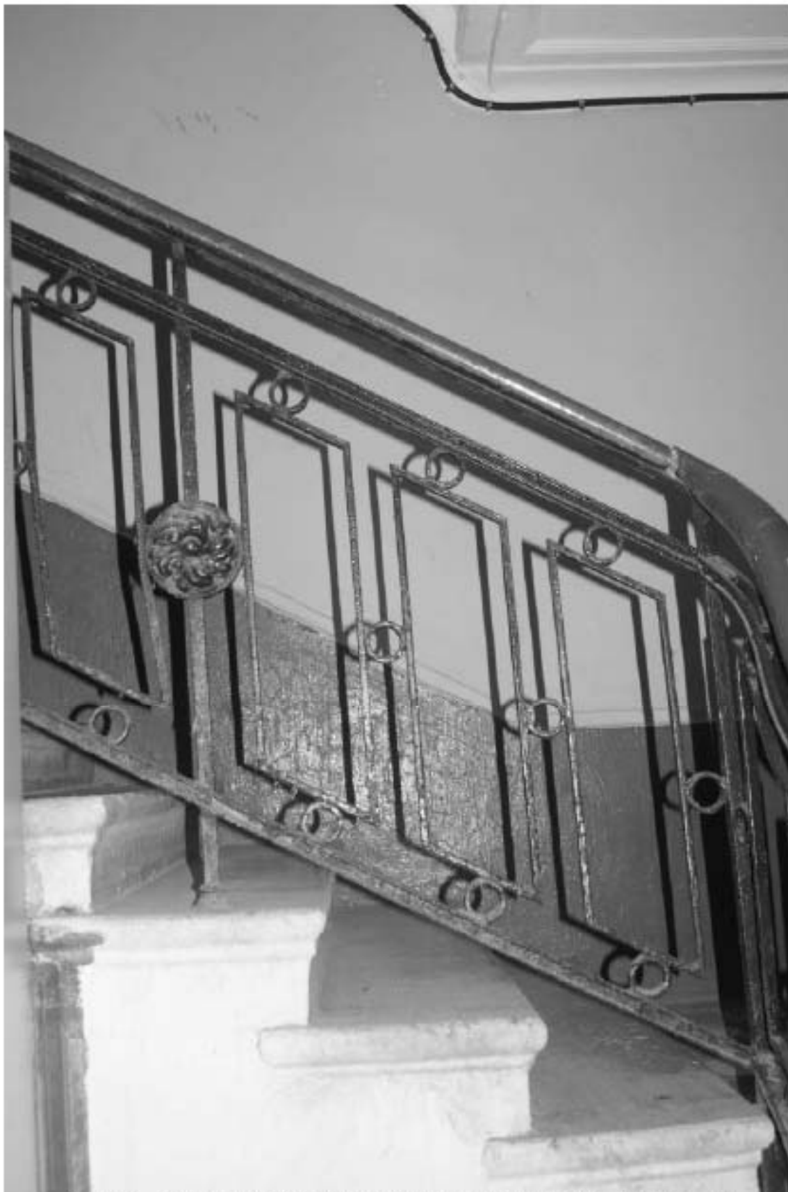
Фото 31. Лестница № 4: 1-й этаж. Фрагмент лестничного ограждения. Съемка 19.04.2021 г. Михайловская Г. В.
