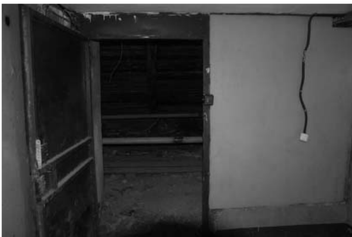
Фото 178. Лестница № 8: Выход на чердачный этаж. Съемка 19.04.2021 г. Михайловская Г. В.
