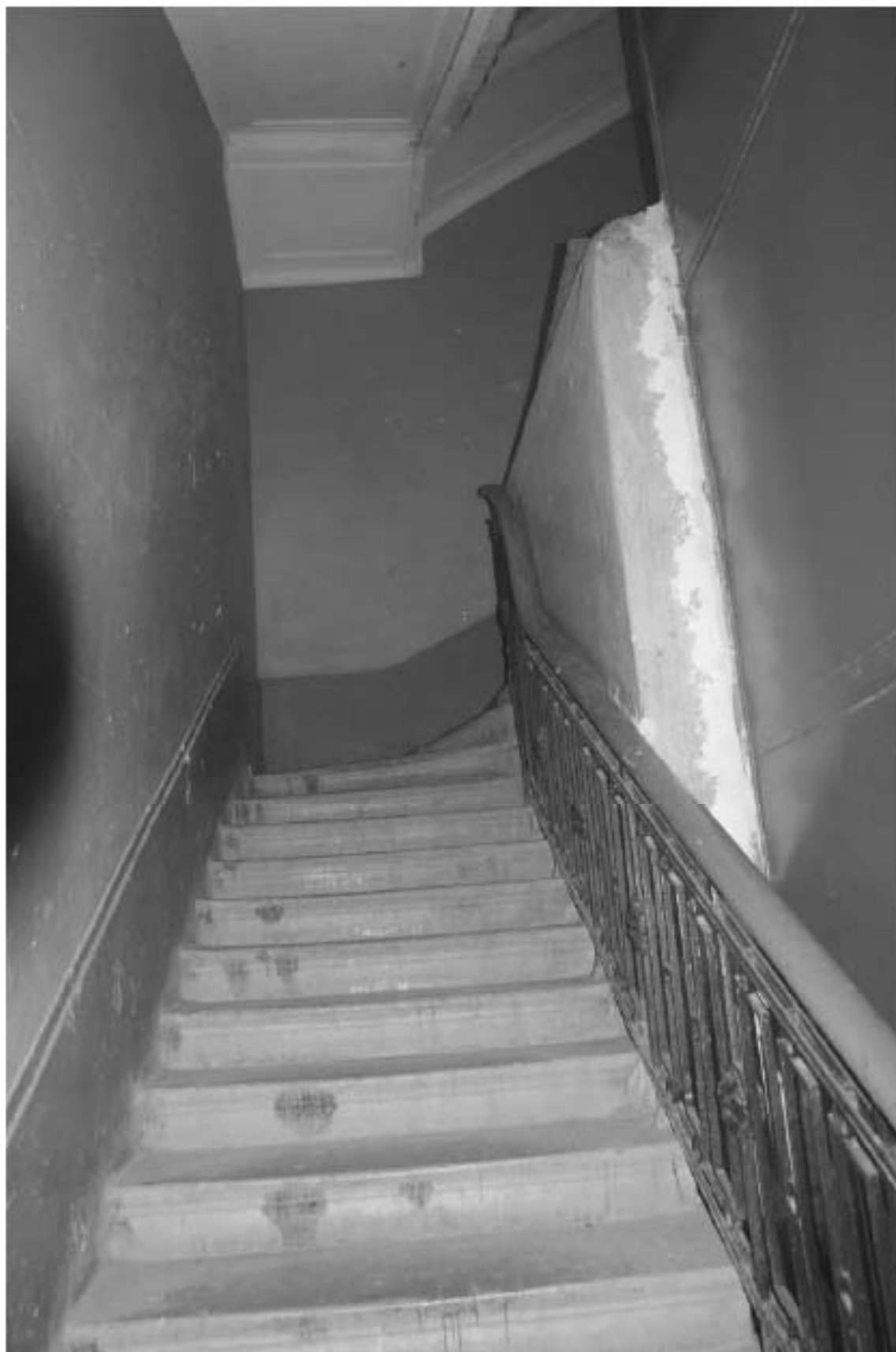
Фото 102. Лестница № 6: Лестничный марш на площадку между 1-м и 2-м этажом. Съемка 19.04.2021 г. Михайловская Г. В.
