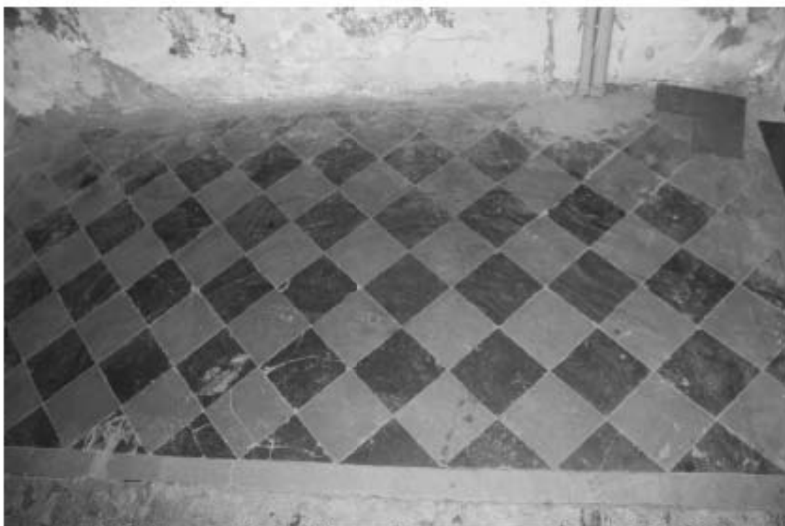
Фото 150. Лестница № 13: 1-й этаж. Покрытие пола. Съемка 19.04.2021 г. Михайловская Г. В.
