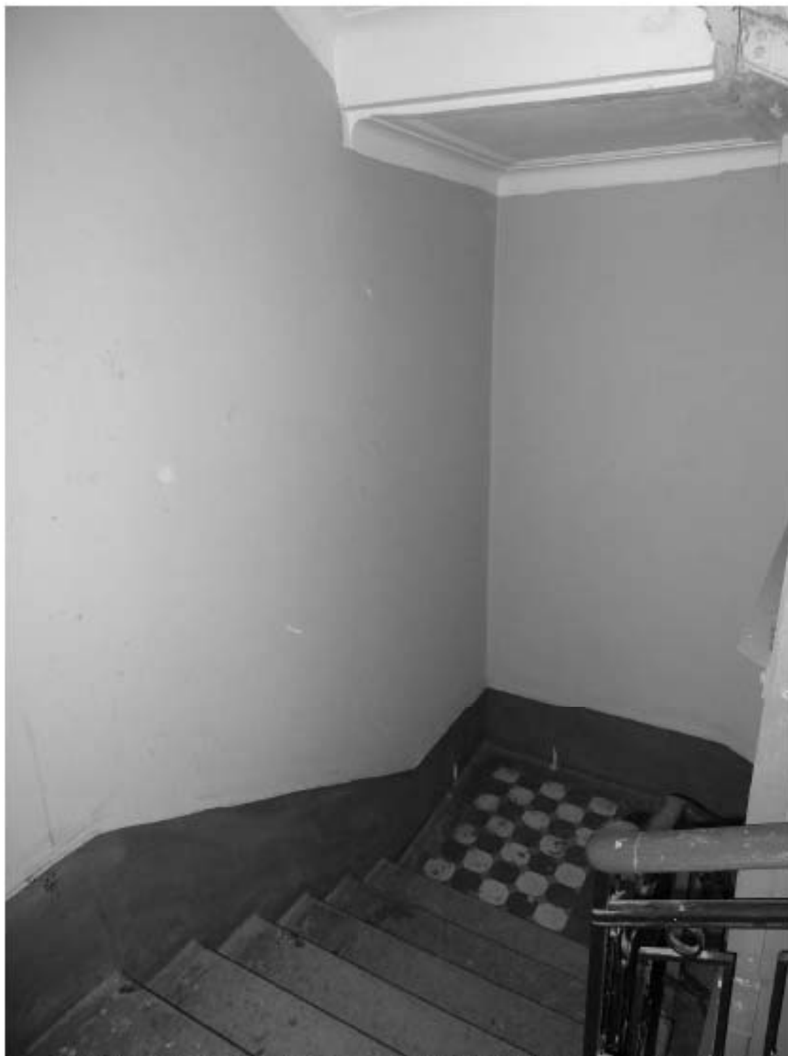
Фото 46. Лестница № 4: Лестничная площадка между 5-м и 6-м этажом. Съемка 19.04.2021 г. Михайловская Г. В.
