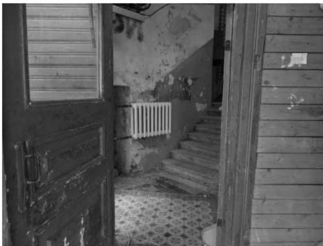
Фото 89. Лестница № 11: 1-й этаж. Тамбур. Съемка 19.04.2021 г. Михайловская Г. В.
