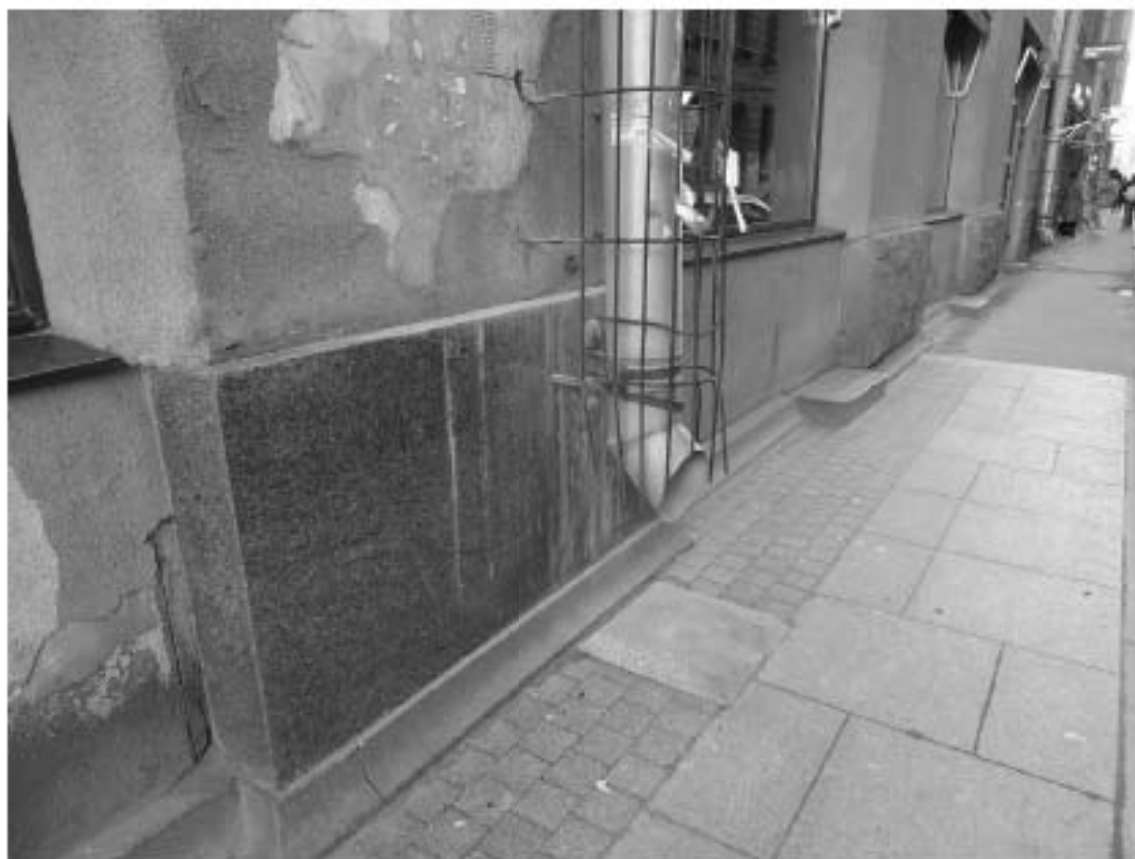
Фото 12. Здание по адресу: г. Санкт-Петербург, Большой проспект П.С., дом 74, литера А. Лицевой фасад по Бармалеевой ул. Фрагмент. Съемка 19.04.2021 г. Михайловская Г. В.
