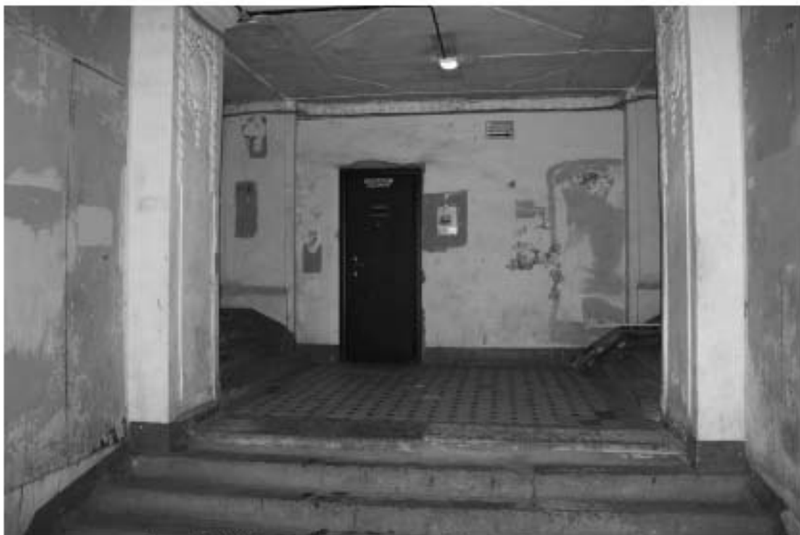
Фото 5. 1-й этаж. Вестибюль по Большому проспекту. Съемка 19.04.2021 г. Михайловская Г. В.
