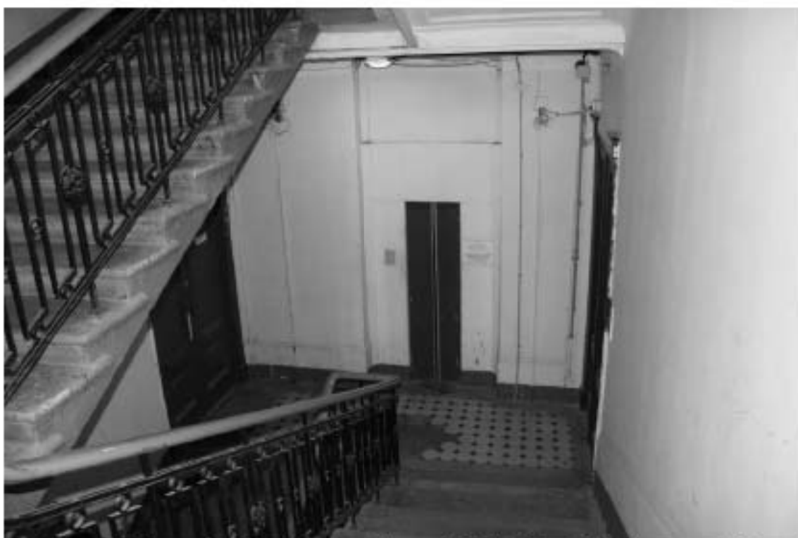
Фото 56. Лестница № 2: 4-й этаж. Съемка 19.04.2021 г. Михайловская Г. В.
