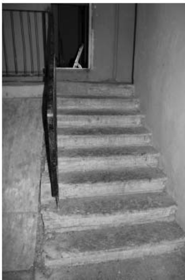
Фото 74. Лестница № 10: Лестничный марш на площадку 2-го этажа. Съемка 19.04.2021 г. Михайловская Г. В.
