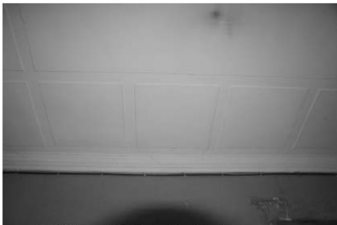
Фото 98. Лестница № 6: 1-й этаж. Вестибюль. Оформление потолка. Съемка 19.04.2021 г. Михайловская Г. В.
