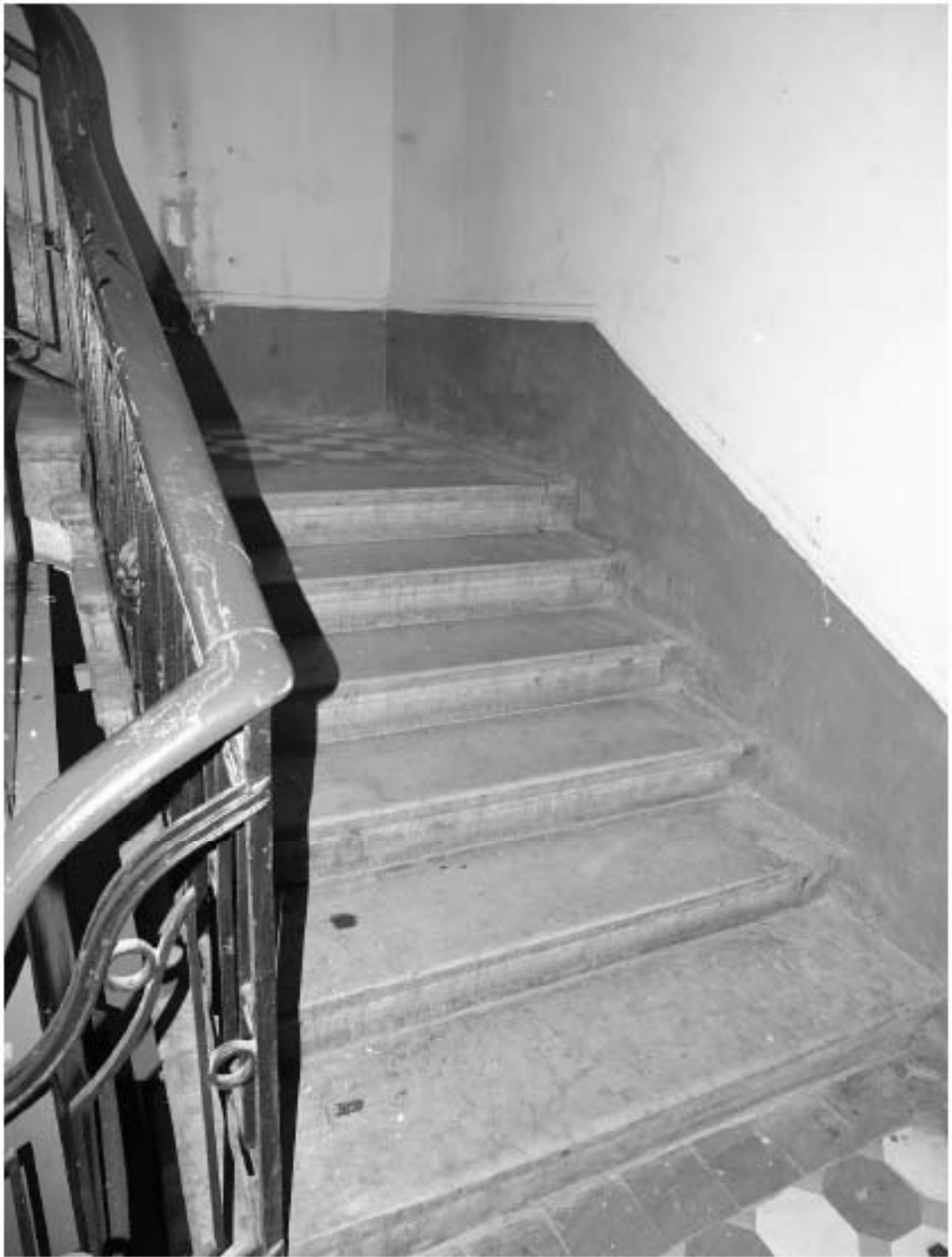
Фото 38. Лестница № 4: Лестничная площадка между 3-м и 4-м этажом. Съемка 19.04.2021 г. Михайловская Г. В.
