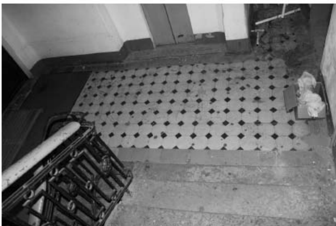
Фото 51. Лестница № 2: 2-й этаж. Покрытие пола. Съемка 19.04.2021 г. Михайловская Г. В.
