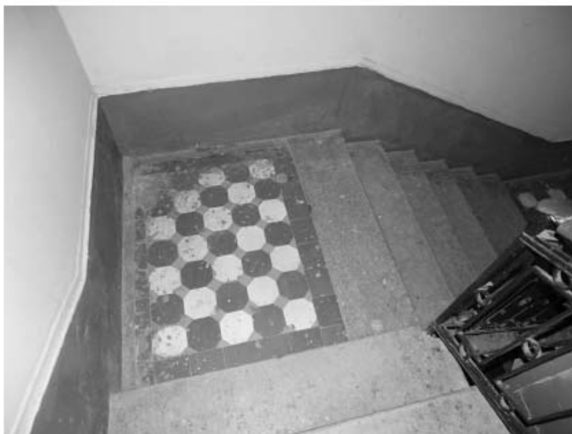
Фото 52. Лестница № 4: Лестничная площадка между 6-м и 7-м этажом. Покрытие пола. Съемка 19.04.2021 г. Михайловская Г. В.
