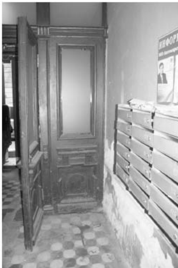
Фото 97. Лестница № 6: 1-й этаж. Вестибюль. Заполнение дверного проема. Съемка 19.04.2021 г. Михайловская Г. В.
