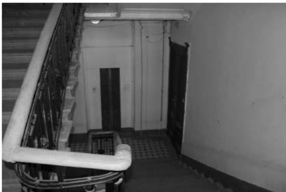
Фото 62. Лестница № 2: 5-й этаж. Съемка 19.04.2021 г. Михайловская Г. В.
