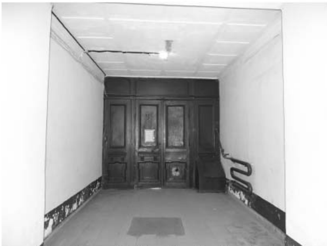
Фото 3. Лестница № 3: 1-й этаж. Вестибюль. Входной тамбур. Съемка 19.04.2021 г. Михайловская Г. В.
