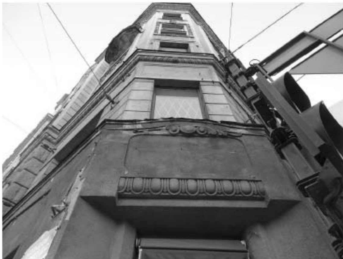
Фото 11. Здание по адресу: г. Санкт-Петербург, Большой проспект П.С., дом 74, литера А. Угловая часть здания (угол Большого пр. и Бармалеевой ул.). Съемка 19.04.2021 г. Михайловская Г. В.
