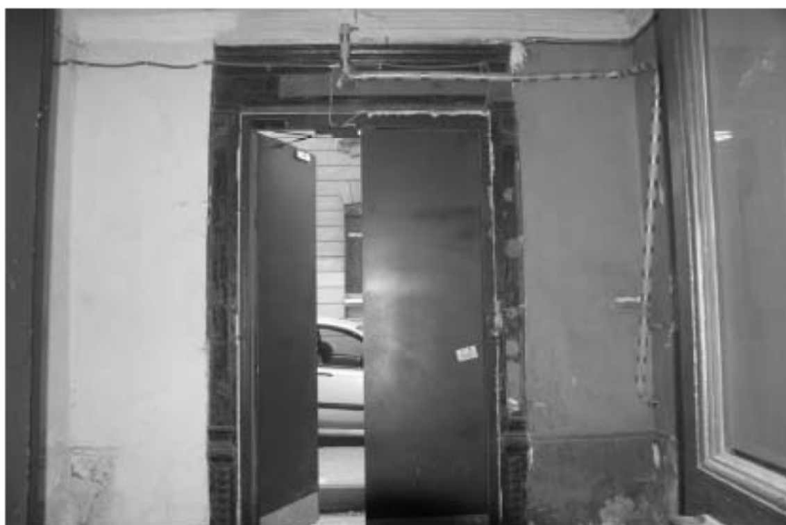
Фото 94. Лестница № 6: 1-й этаж. Вестибюль. Съемка 19.04.2021 г. Михайловская Г. В.
