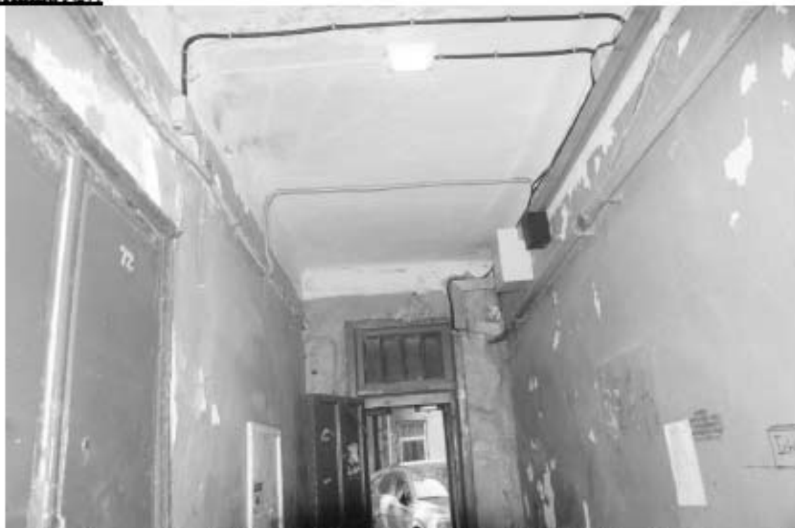
Фото 130. Лестница № 7: 1-й этаж. Вестибюль. Съемка 19.04.2021 г. Михайловская Г. В.
