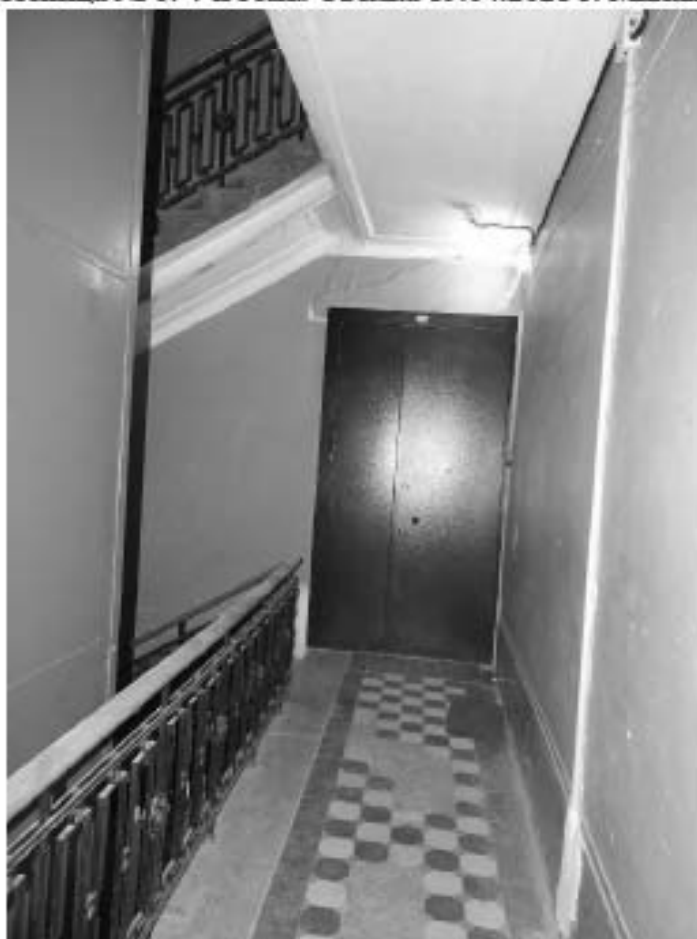
Фото 117. Лестница № 6: 4-й этаж. Съемка 19.04.2021 г. Михайловская Г. В.
