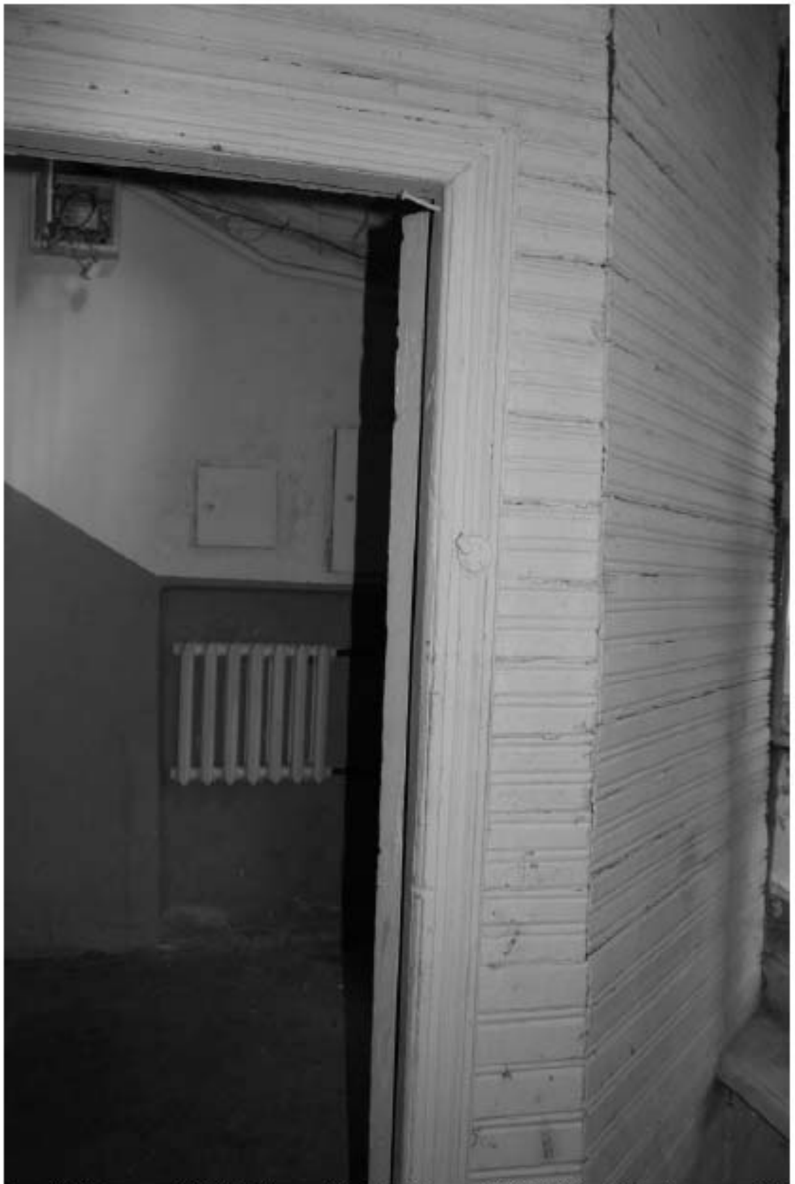
Фото 73. Лестница № 10: 1-й этаж. Тамбур. Съемка 19.04.2021 г. Михайловская Г. В.
