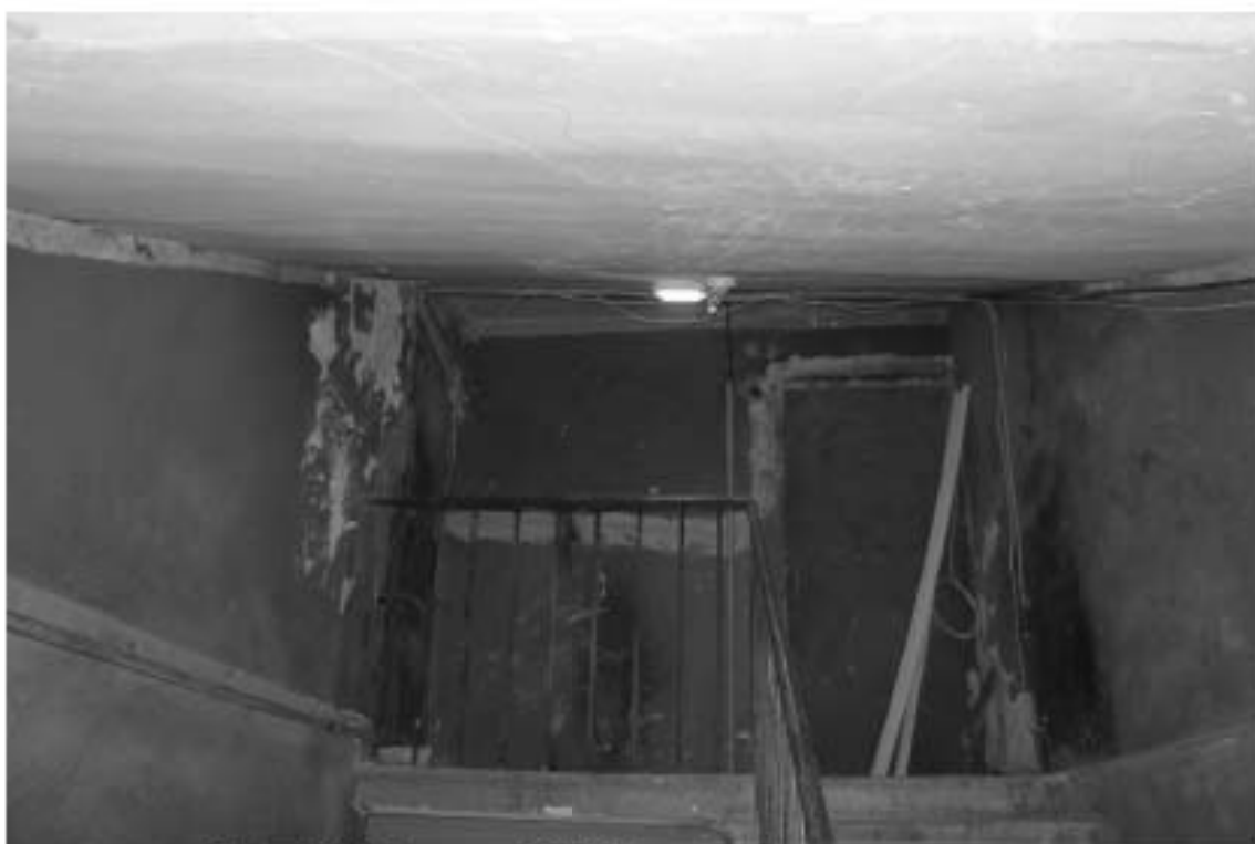
Фото 175. Лестница № 13: Площадка чердачного этажа. Съемка 19.04.2021 г. Михайловская Г. В.
