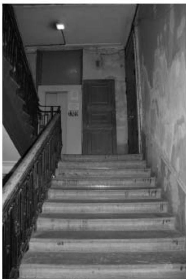
Фото 23. Лестница № 1: Вид на площадку 3-го этажа. Съемка 19.04.2021 г. Михайловская Г. В.
