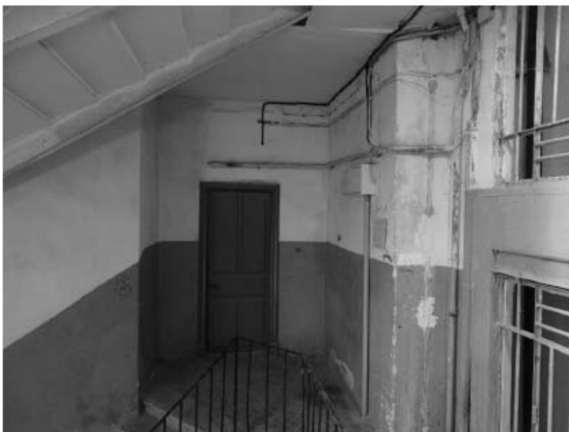
Фото 102. Лестница № 11: Площадка 4-го этажа. Съемка 19.04.2021 г. Михайловская Г. В.
