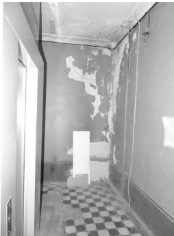
Фото 118. Лестница № 6: 4-й этаж. Съемка 19.04.2021 г. Михайловская Г. В.
