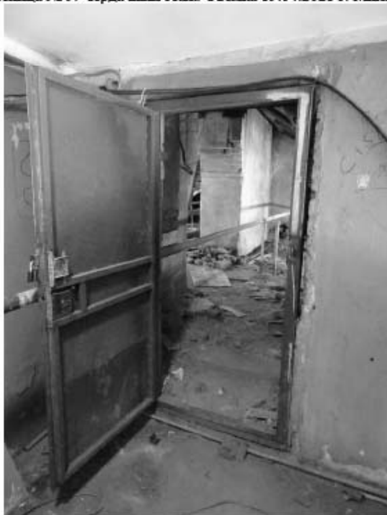
Фото 203. Лестница № 9: Чердачный этаж. Съемка 19.04.2021 г. Михайловская Г. В.
