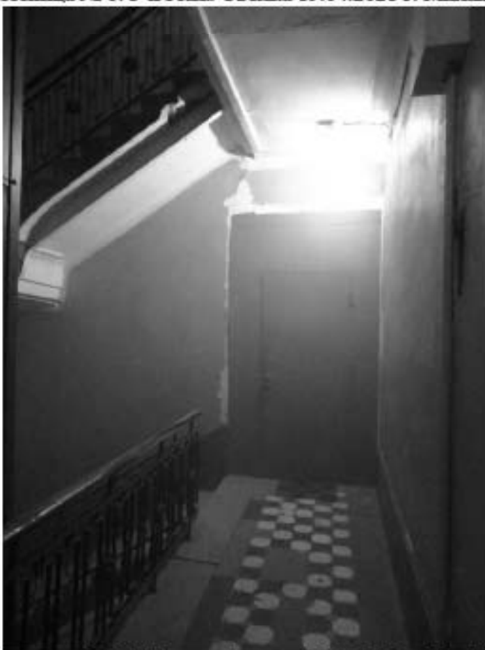
Фото 113. Лестница № 6: 3-й этаж. Съемка 19.04.2021 г. Михайловская Г. В.
