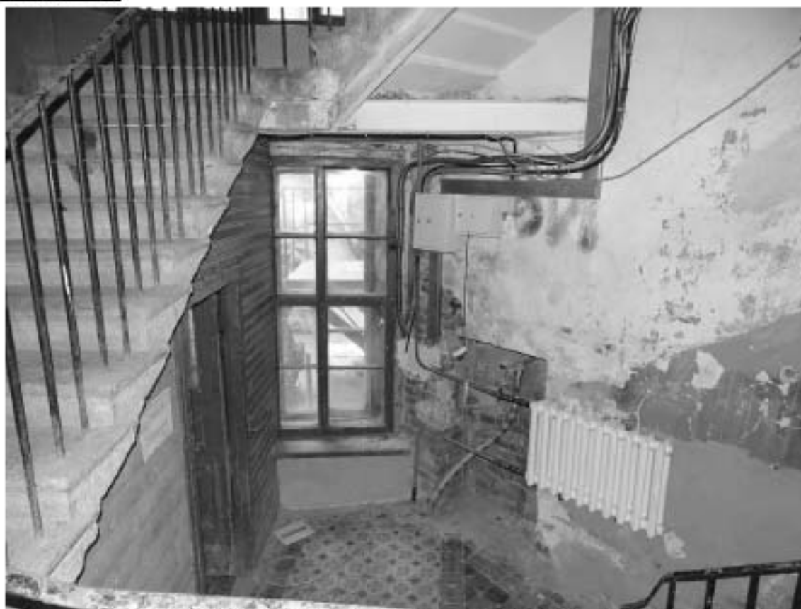
Фото 88. Лестница № 11: Вестибюль 1-го этажа. Тамбур. Съемка 19.04.2021 г. Михайловская Г. В.
