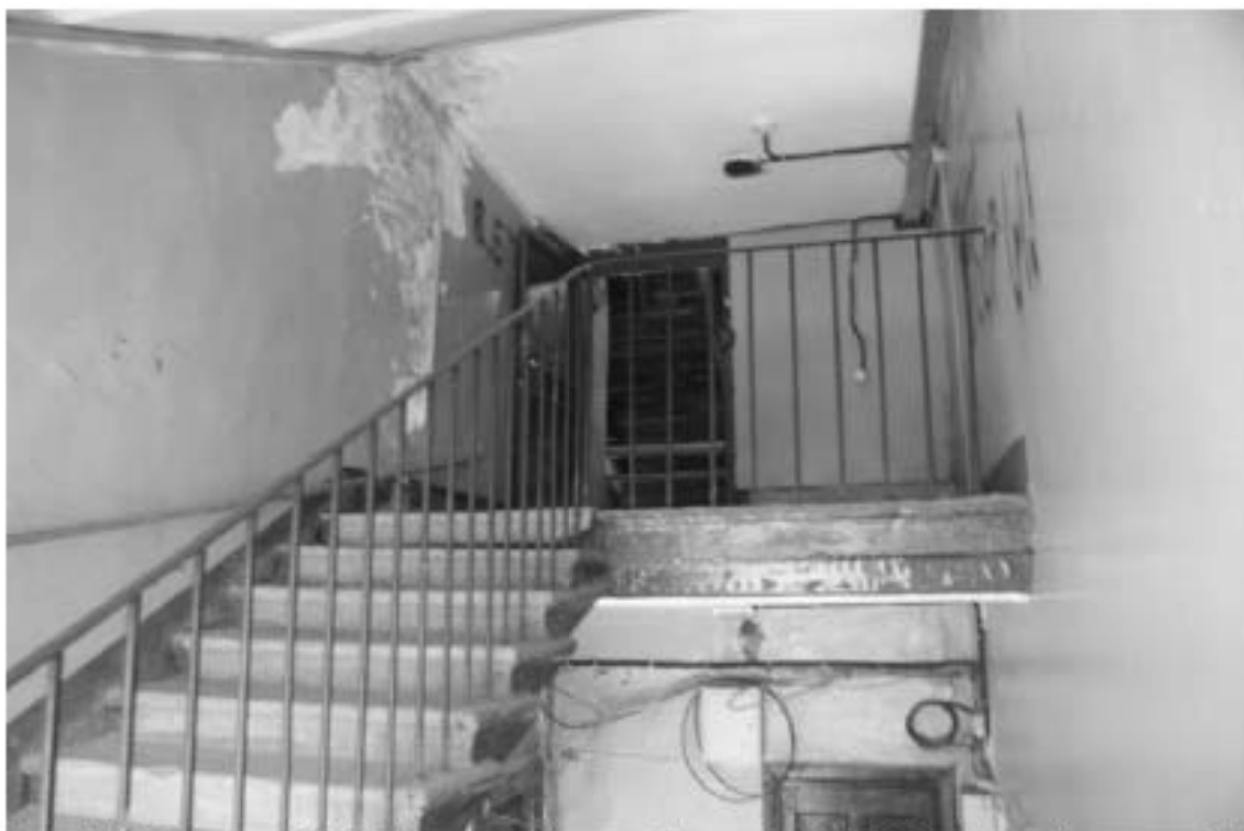
Фото 177. Лестница № 8: Чердачный этаж. Съемка 19.04.2021 г. Михайловская Г. В.
