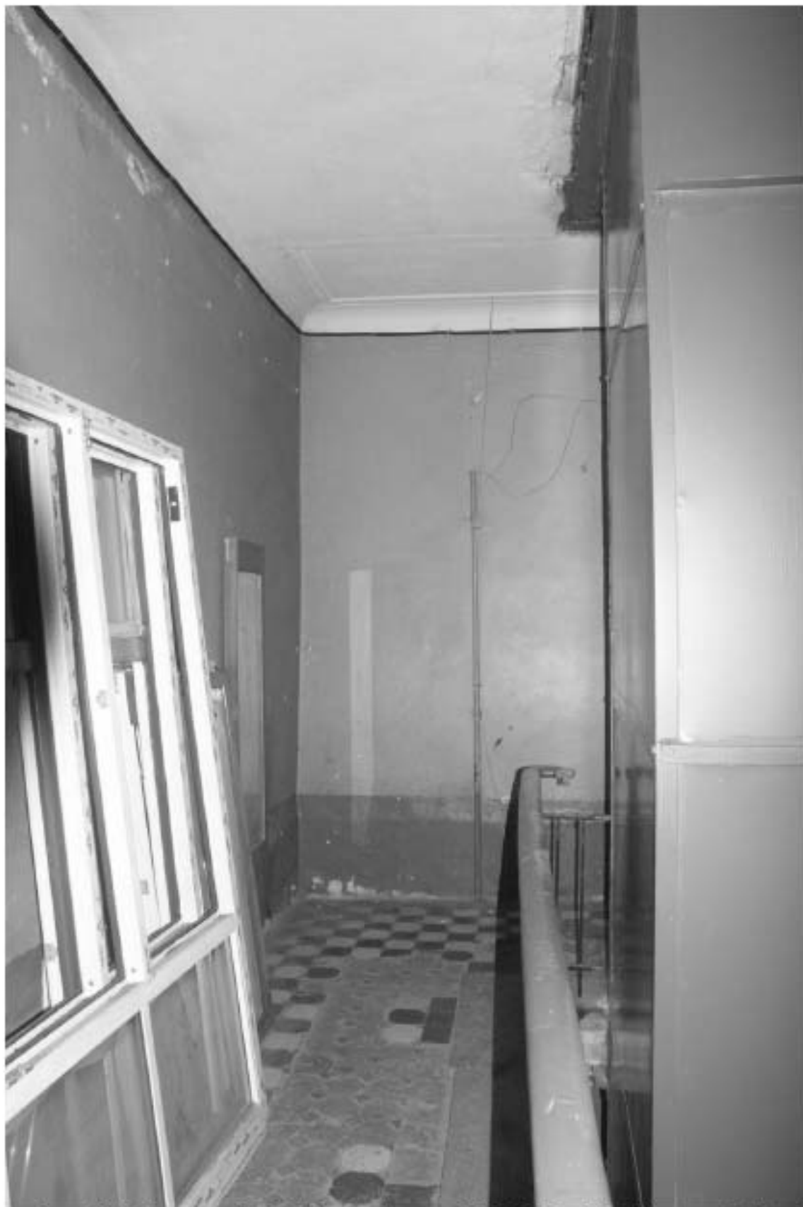
Фото 107. Лестница № 6: 2-й этаж. Съемка 19.04.2021 г. Михайловская Г. В.
