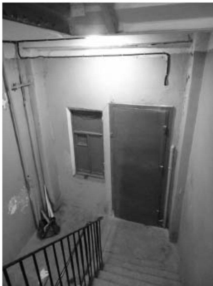
Фото 144. Лестница № 7: 6-й этаж. Съемка 19.04.2021 г. Михайловская Г. В.
