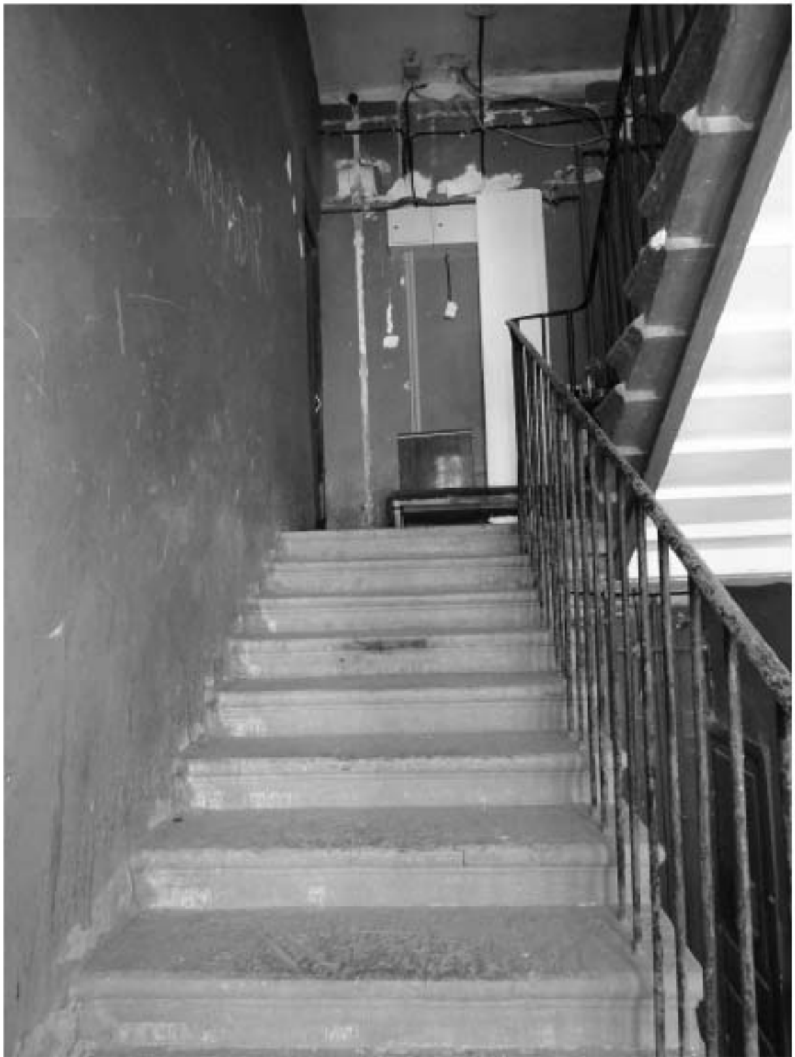
Фото 142. Лестница № 12: Лестничный марш на площадку 7-го этажа. Съемка 19.04.2021 г. Михайловская Г. В.
