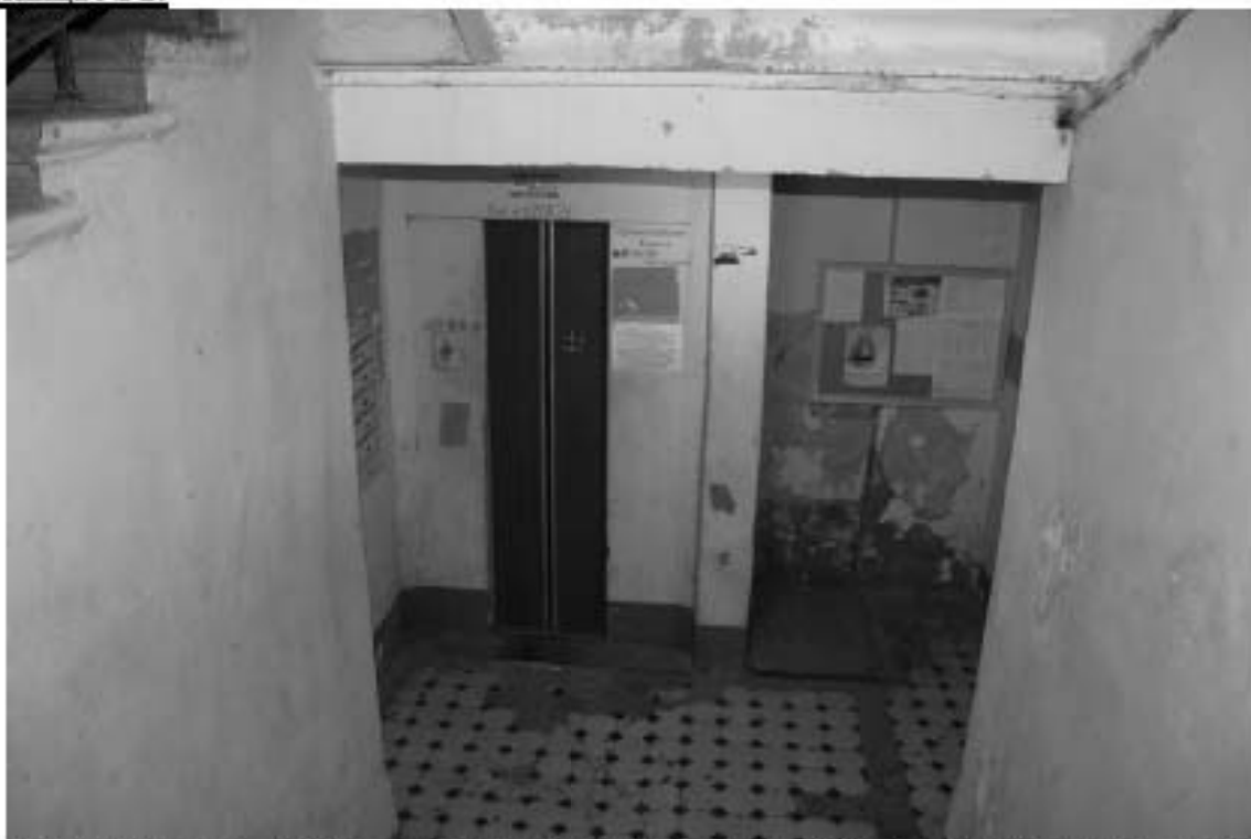
Фото 48. Лестница № 2: Вестибюль. 1-й этаж. Съемка 19.04.2021 г. Михайловская Г. В.
