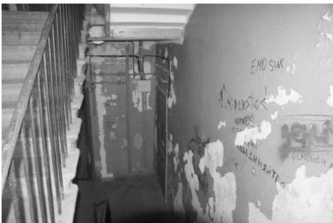
Фото 190. Лестница № 9: 5-й этаж. Съемка 19.04.2021 г. Михайловская Г. В.
