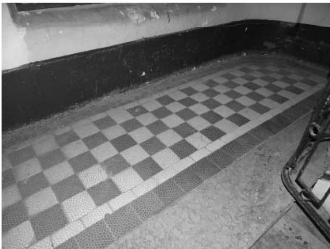
Фото 6. Лестница № 3: Площадка между 1-м и 2-м этажом. Покрытие пола. Съемка 19.04.2021 г. Михайловская Г. В.
