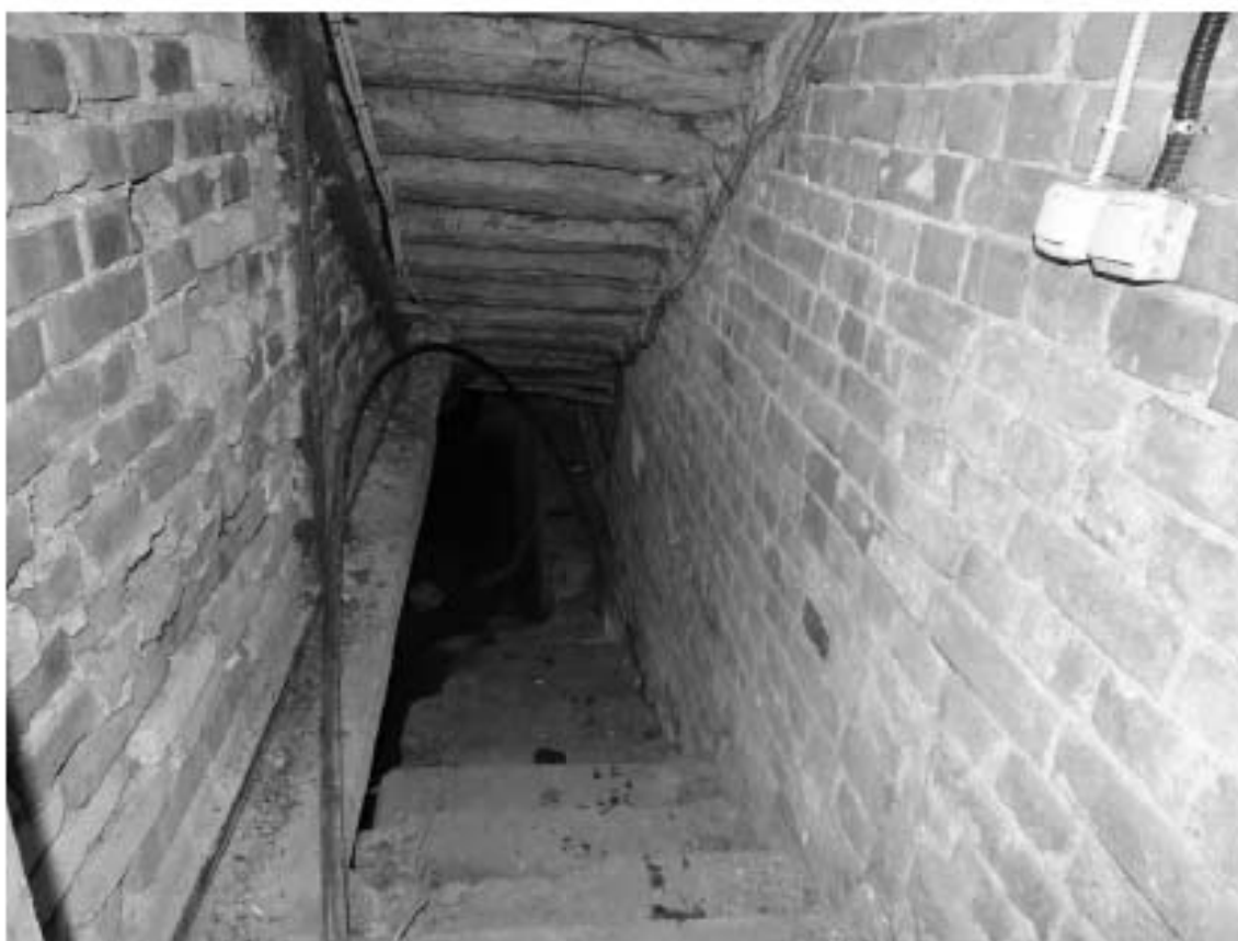
Фото 123. Лестница № 12: 1-й этаж. Лестница в подвальное помещение. Съемка 19.04.2021 г. Михайловская Г. В.
