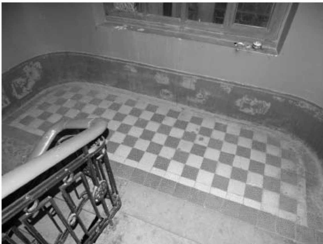
Фото 20. Лестница № 3: Площадка между 6-м и 7-м этажом. Покрытие пола. Съемка 19.04.2021 г. Михайловская Г. В.
