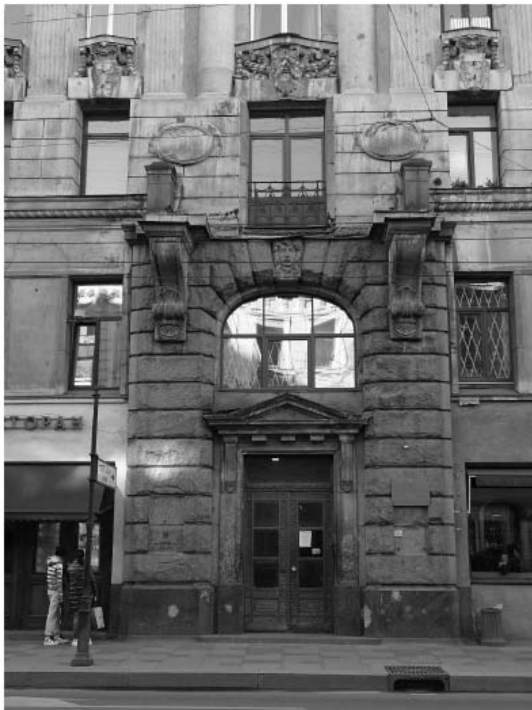
Фото 4. Здание по адресу: г. Санкт-Петербург, Большой проспект П.С., дом 74, литера А. Лицевой фасад по Большому пр. Фрагмент. Съемка 19.04.2021 г. Михайловская Г. В.
