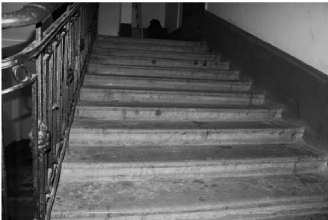
Фото 18. Лестница № 1: Лестничный марш на площадку 2-го этажа. Съемка 19.04.2021 г. Михайловская Г. В.
