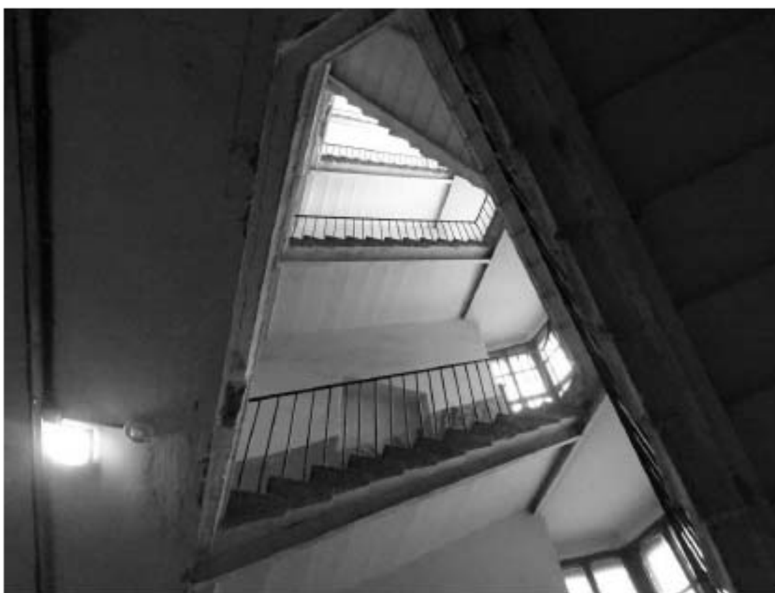
Фото 93. Лестница № 11: Лестничные марши. Съемка 19.04.2021 г. Михайловская Г. В.
