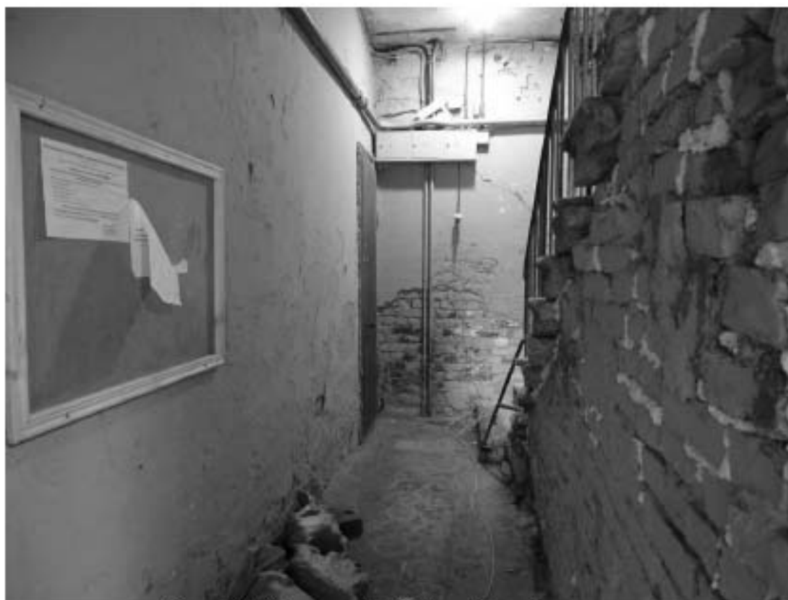
Фото 122. Лестница № 12: Вестибюль 1-го этажа. Съемка 19.04.2021 г. Михайловская Г. В.
