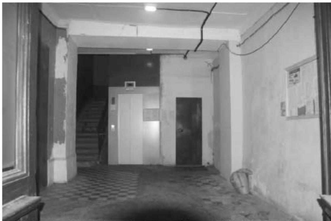
Фото 93. Лестница № 6: 1-й этаж. Вестибюль. Съемка 19.04.2021 г. Михайловская Г. В.
