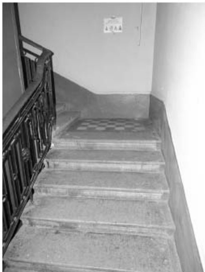
Фото 51. Лестница № 4: Лестничная площадка между 6-м и 7-м этажом. Съемка 19.04.2021 г. Михайловская Г. В.
