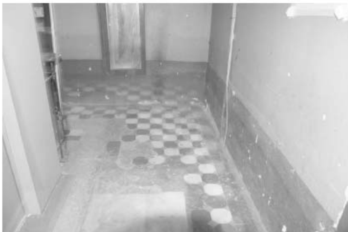
Фото 104. Лестница № 6: 2-й этаж. Съемка 19.04.2021 г. Михайловская Г. В.
