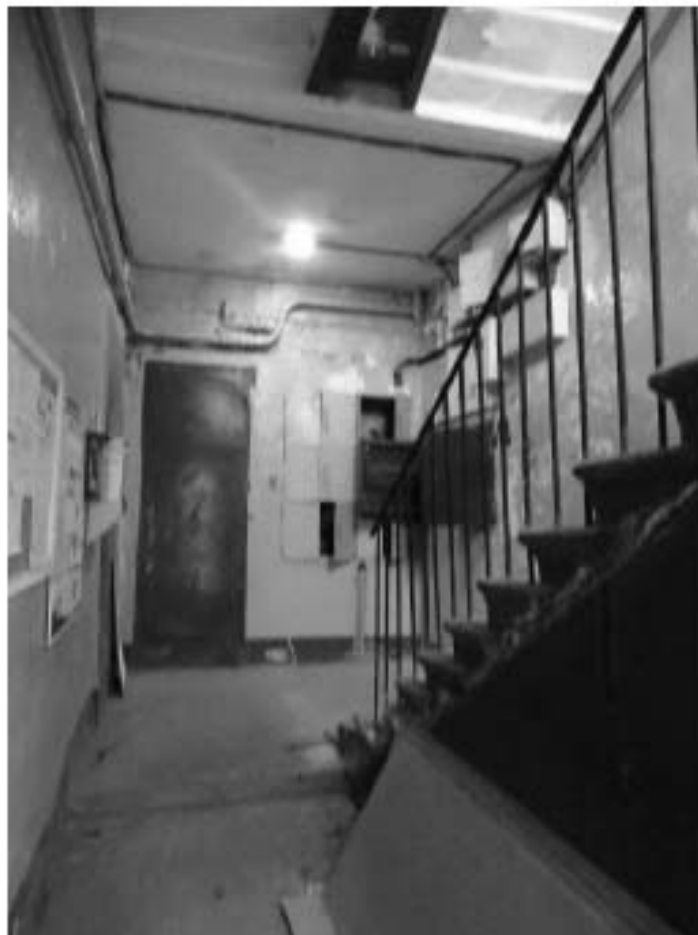
Фото 158. Лестница № 8: 1-й этаж. Съемка 19.04.2021 г. Михайловская Г. В.
