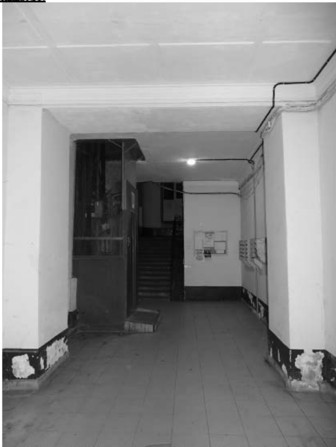
Фото 1. Лестница № 3: 1-й этаж. Вестибюль. Съемка 19.04.2021 г. Михайловская Г. В.
