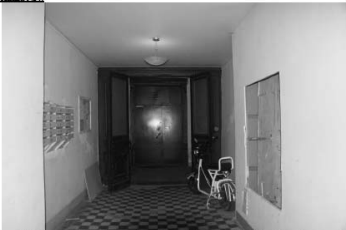
Фото 21. Лестница № 4: 1-й этаж. Вестибюль. Съемка 19.04.2021 г. Михайловская Г. В.
