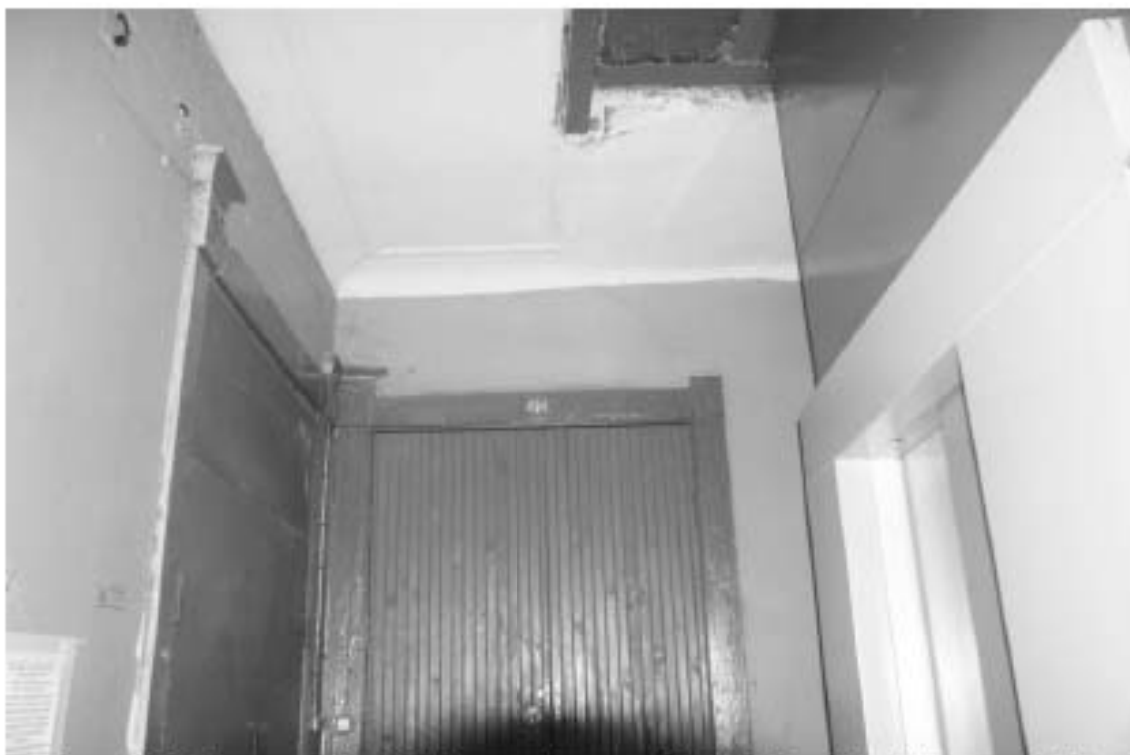
Фото 105. Лестница № 6: 2-й этаж. Съемка 19.04.2021 г. Михайловская Г. В.
