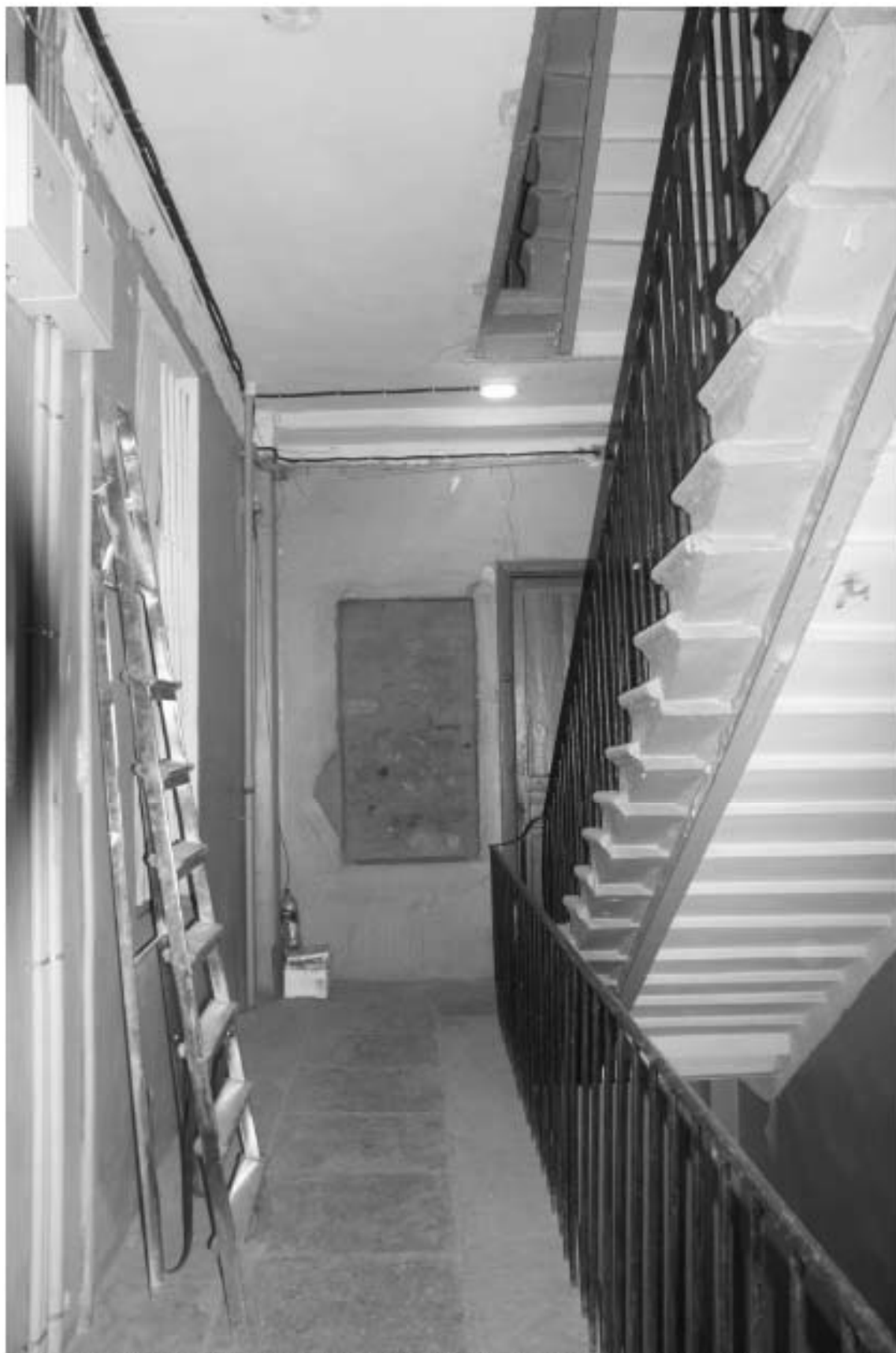
Фото 135. Лестница № 7: 2-й этаж. Съемка 19.04.2021 г. Михайловская Г. В.
