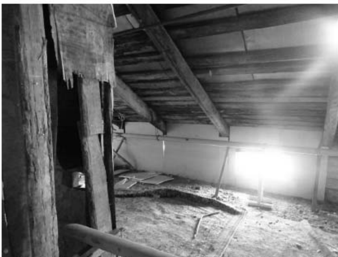
Фото 153. Лестница № 7: Чердак. Съёмка 19.04.2021 г. Михайловская Г. В.
