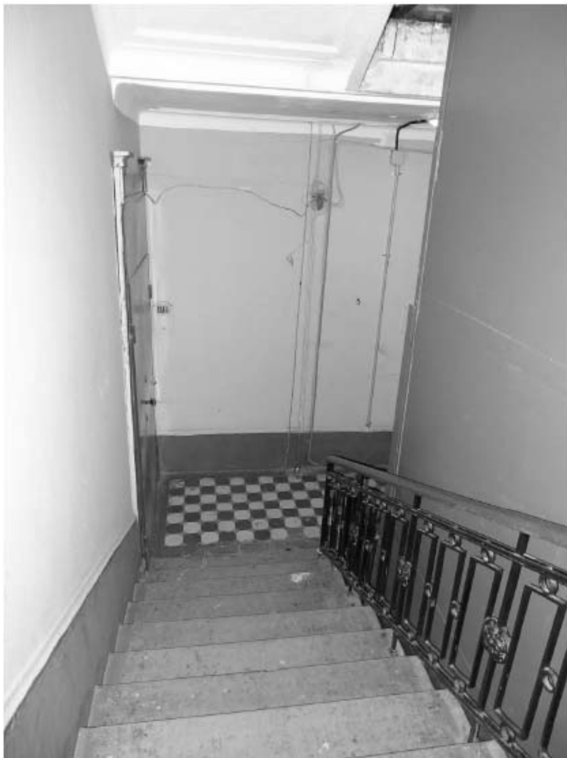
Фото 45. Лестница № 4: 5-й этаж. Съемка 19.04.2021 г. Михайловская Г. В.
