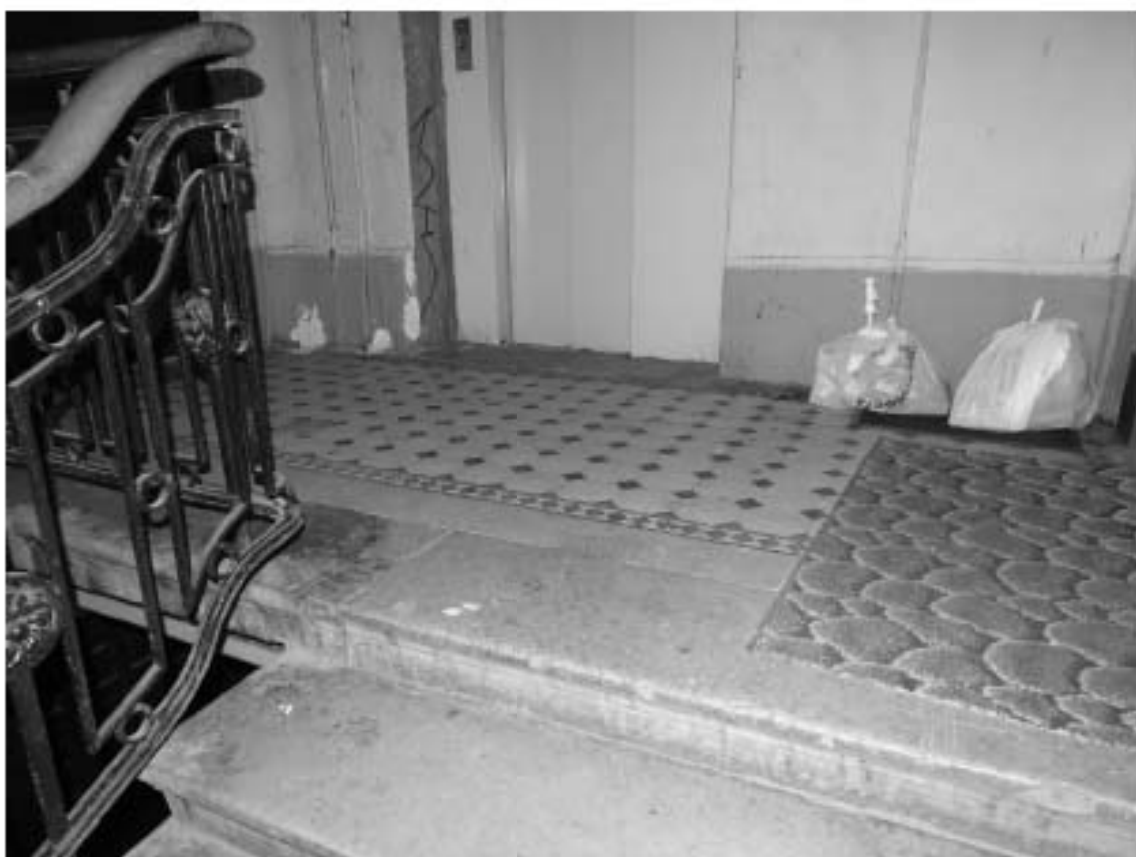
Фото 46. Лестница № 1: Площадка между 7-го этажа. Покрытие пола. Съемка 19.04.2021 г. Михайловская Г. В.
