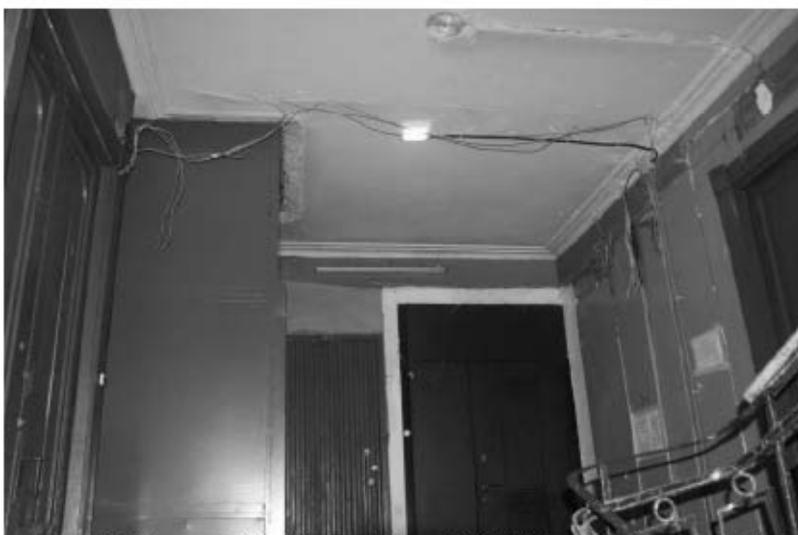
Фото 84. Лестница № 5: 5-й этаж. Съемка 19.04.2021 г. Михайловская Г. В.
