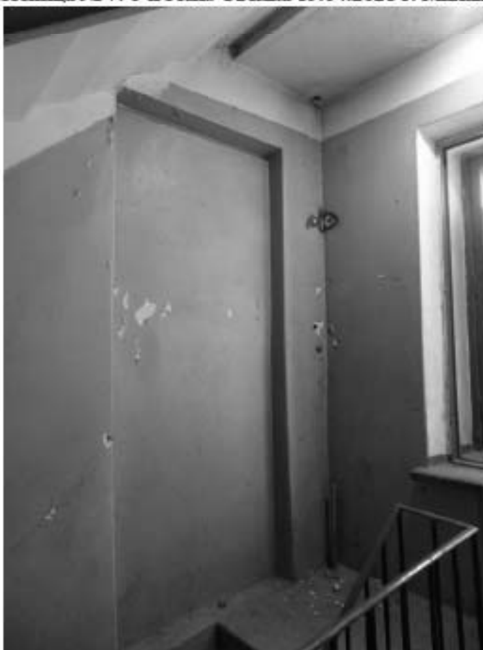
Фото 145. Лестница № 7: 6-й этаж. Съемка 19.04.2021 г. Михайловская Г. В.
