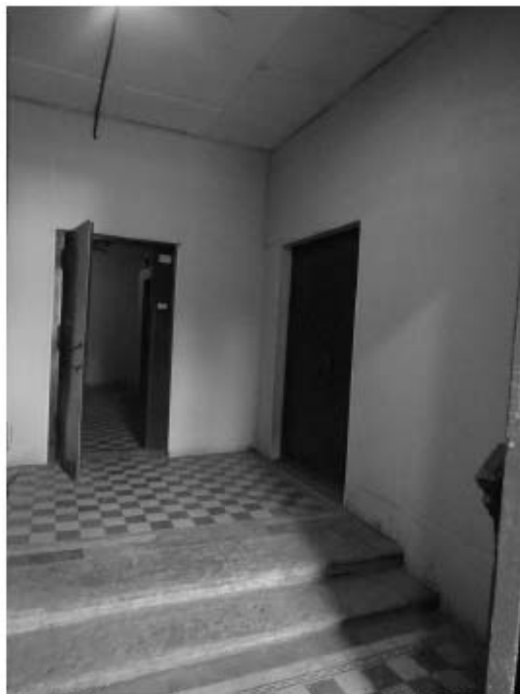
Фото 63. Лестница № 5: 1-й этаж. Вестибюль. Съемка 19.04.2021 г. Михайловская Г. В.
