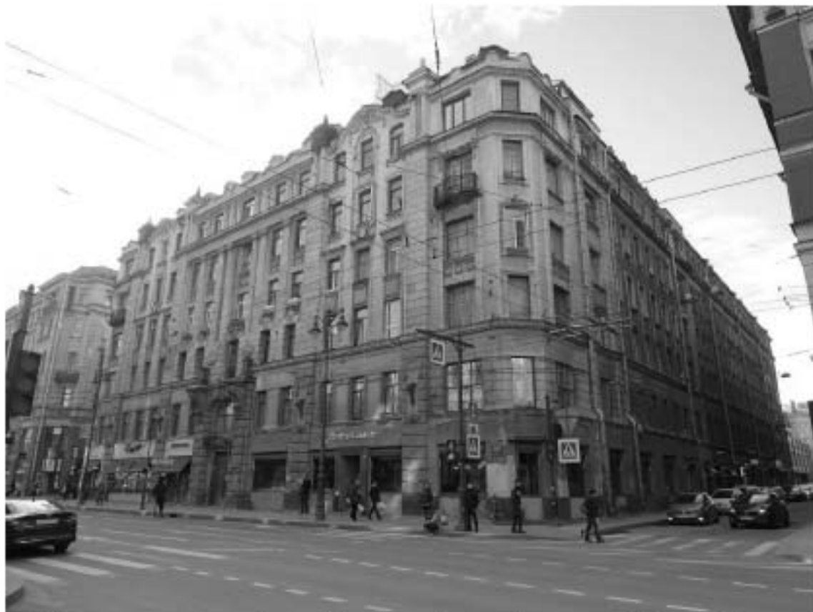
Фото 1. Здание по адресу: г. Санкт-Петербург, Большой проспект П.С., дом 74, литера А. Вид с пересечения Большого пр. и Бармалеевой ул. Съемка 19.04.2021 г. Михайловская Г. В.
