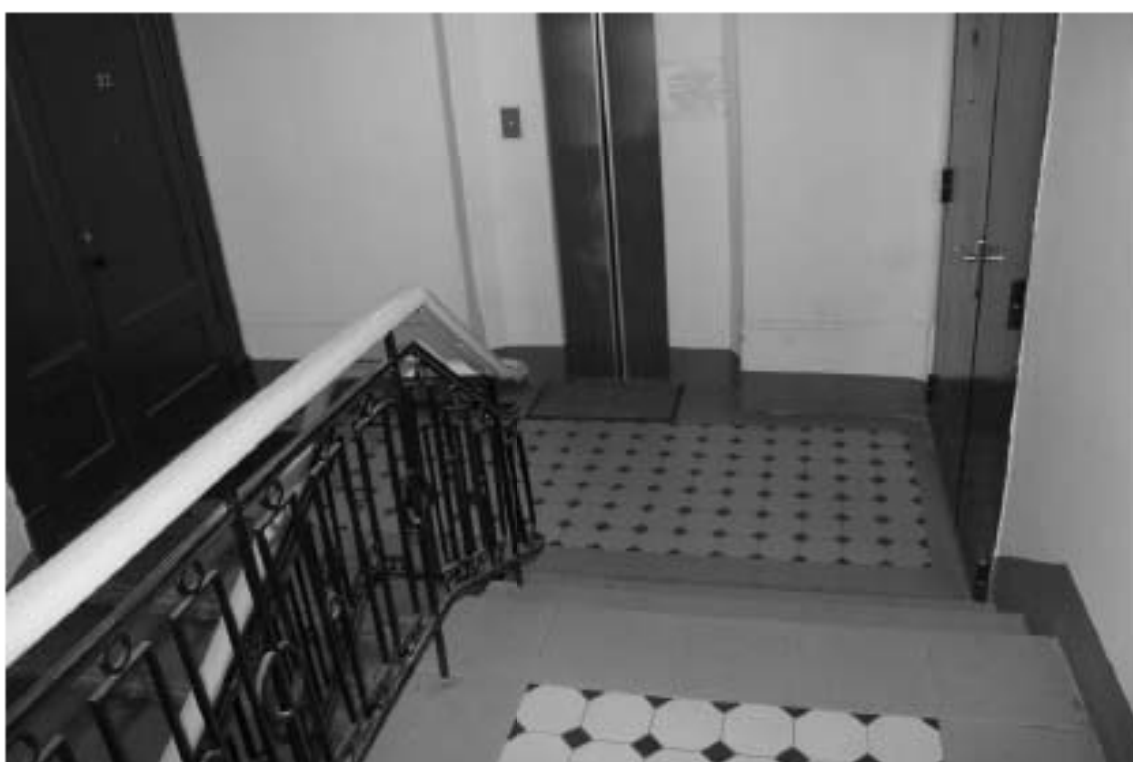
Фото 68. Лестница № 2: 7-й этаж. Съемка 19.04.2021 г. Михайловская Г. В.
