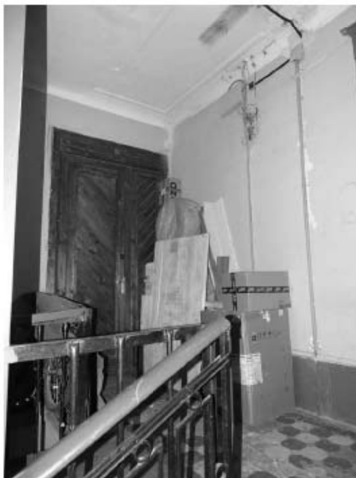
Фото 56. Лестница № 4: 7-й этаж. Съемка 19.04.2021 г. Михайловская Г. В.
