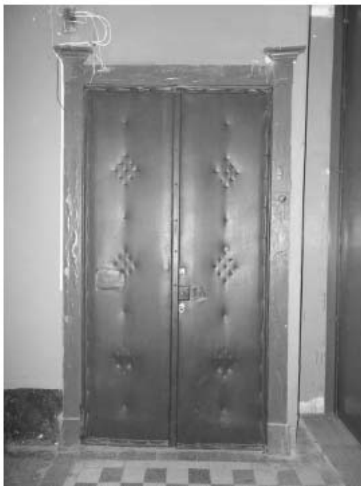
Фото 74. Лестница № 5: 2-й этаж. Заполнение дверного проема.
