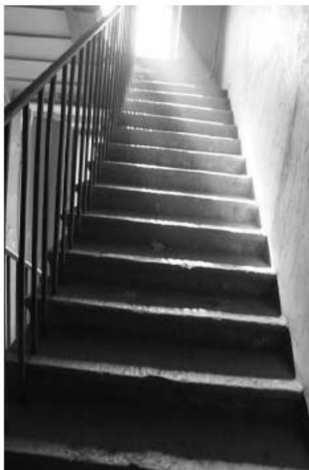
Фото 173. Лестница № 13: Лестничный марш на площадку между 7-м и чердачным этажом. Съемка 19.04.2021 г. Михайловская Г. В.
