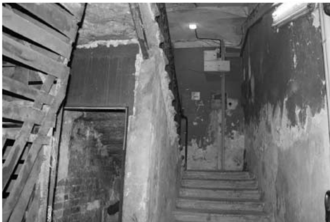
Фото 148. Лестница № 13: Вестибюль 1-го этажа. Съемка 19.04.2021 г. Михайловская Г. В.
