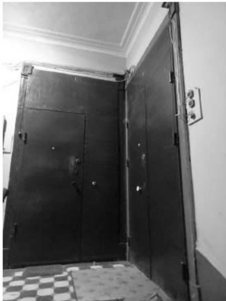
Фото 47. Лестница № 4: 6-й этаж. Съемка 19.04.2021 г. Михайловская Г. В.
