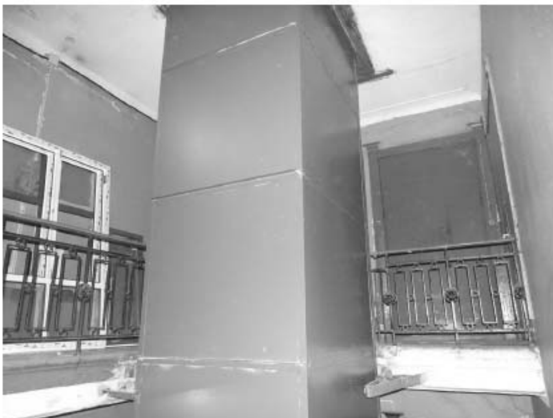
Фото 129. Лестница № 6: 7-й этаж. Съемка 19.04.2021 г. Михайловская Г. В.
