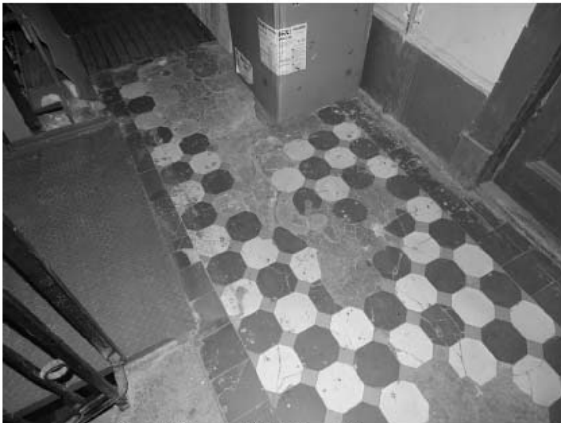
Фото 55. Лестница № 4: 7-й этаж. Покрытие пола. Съемка 19.04.2021 г. Михайловская Г. В.
