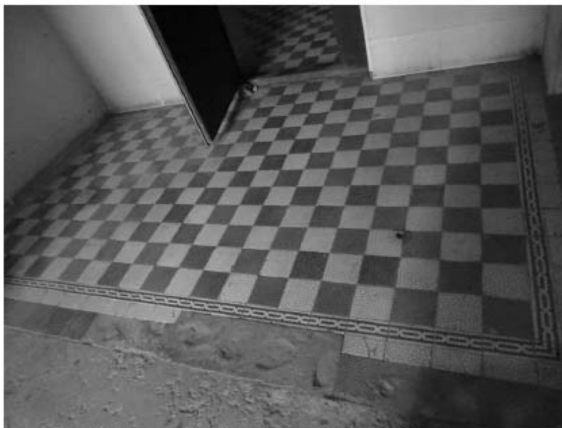
Фото 64. Лестница № 5: 1-й этаж. Входной тамбур. Покрытие пола. Съемка 19.04.2021 г. Михайловская Г. В.
