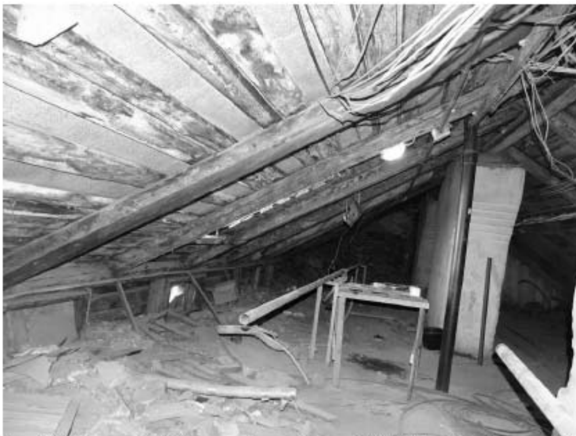
Фото 202. Лестница № 9: Чердачный этаж. Съемка 19.04.2021 г. Михайловская Г. В.
