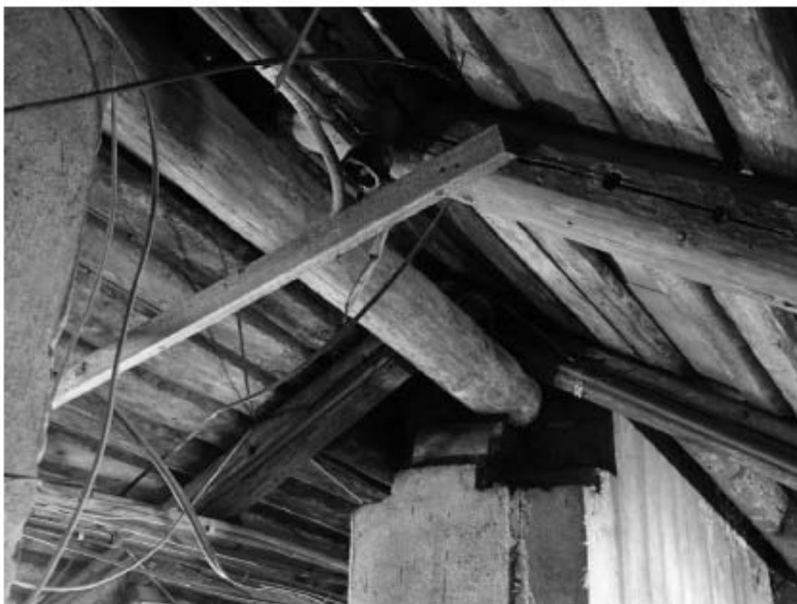
Фото 205. Лестница № 9: Чердачный этаж. Съемка 19.04.2021 г. Михайловская Г. В.
