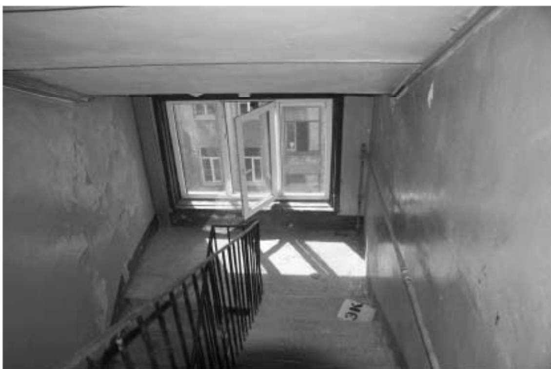
Фото 176. Лестница № 8: Площадка между 7-м и чердачным этажом. Съёмка 19.04.2021 г. Михайловская Г. В.
