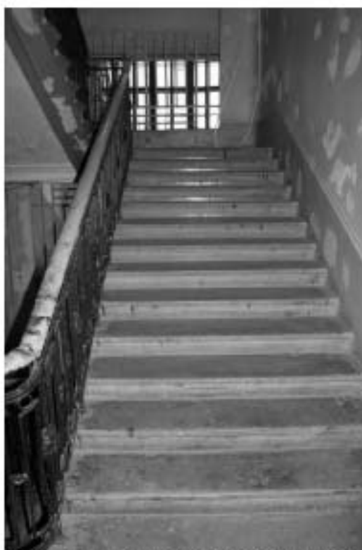
Фото 30. Лестница № 1: Лестничный марш на площадку между 4-м и 5-м этажом. Съемка 19.04.2021 г. Михайловская Г. В.
