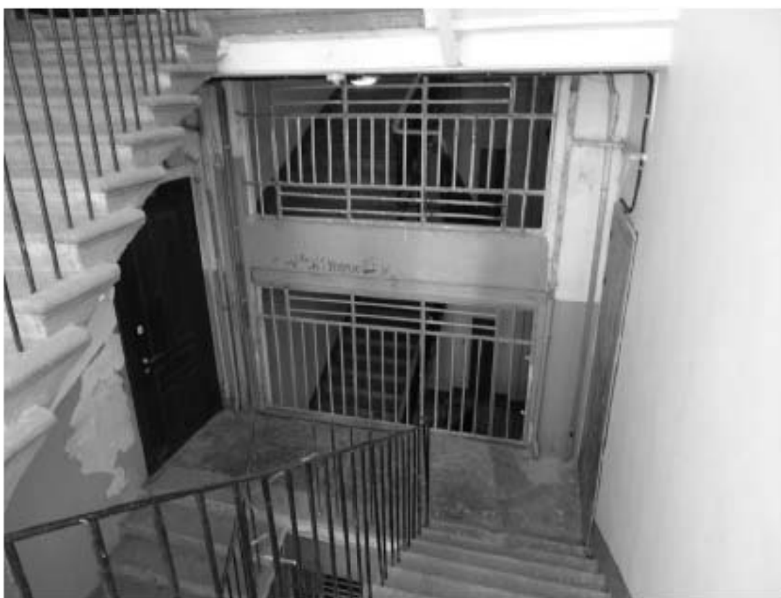
Фото 111. Лестница № 11: Вид на площадку 6-го этажа. Съемка 19.04.2021 г. Михайловская Г. В.
