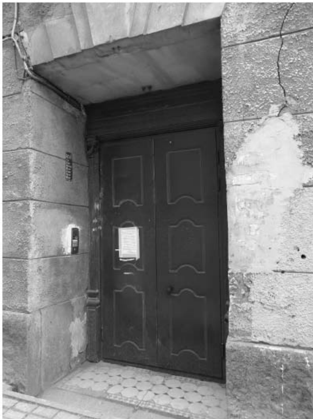
Фото 16. Здание по адресу: г. Санкт-Петербург, Большой проспект П.С., дом 74, литера А. Лицевой фасад по Бармалеевой ул. Вход в парадную, расположенную в западной части фасада. Съемка 19.04.2021 г. Михайловская Г. В.
