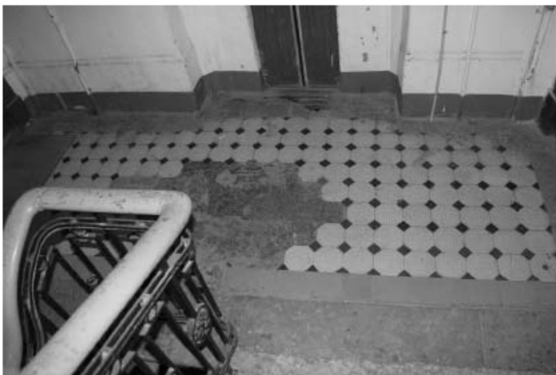
Фото 57. Лестница № 2: 4-й этаж. Покрытие пола. Съемка 19.04.2021 г. Михайловская Г. В.
