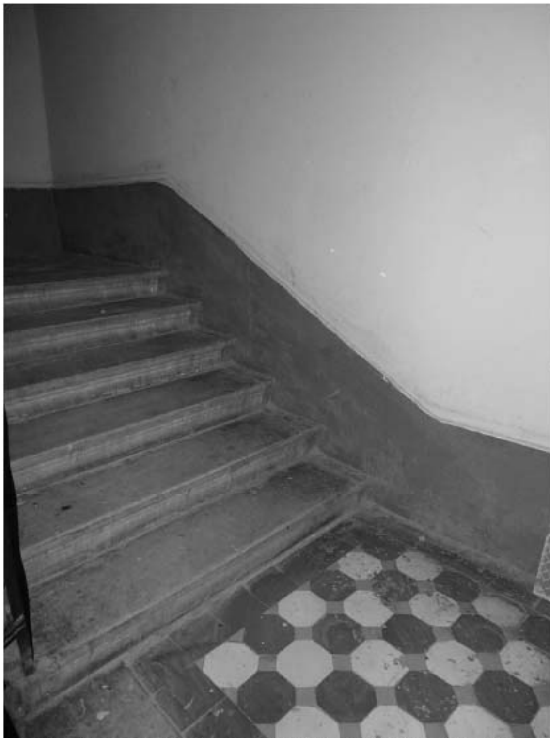
Фото 42. Лестница № 4: Лестничная площадка между 4-м и 5-м этажом. Съемка 19.04.2021 г. Михайловская Г. В.
