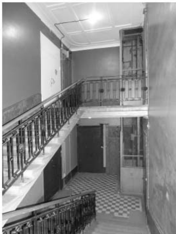
Фото 17. Лестница № 3: Вид с площадки между 6-м и 7-м этажом. Съемка 19.04.2021 г. Михайловская Г. В.
