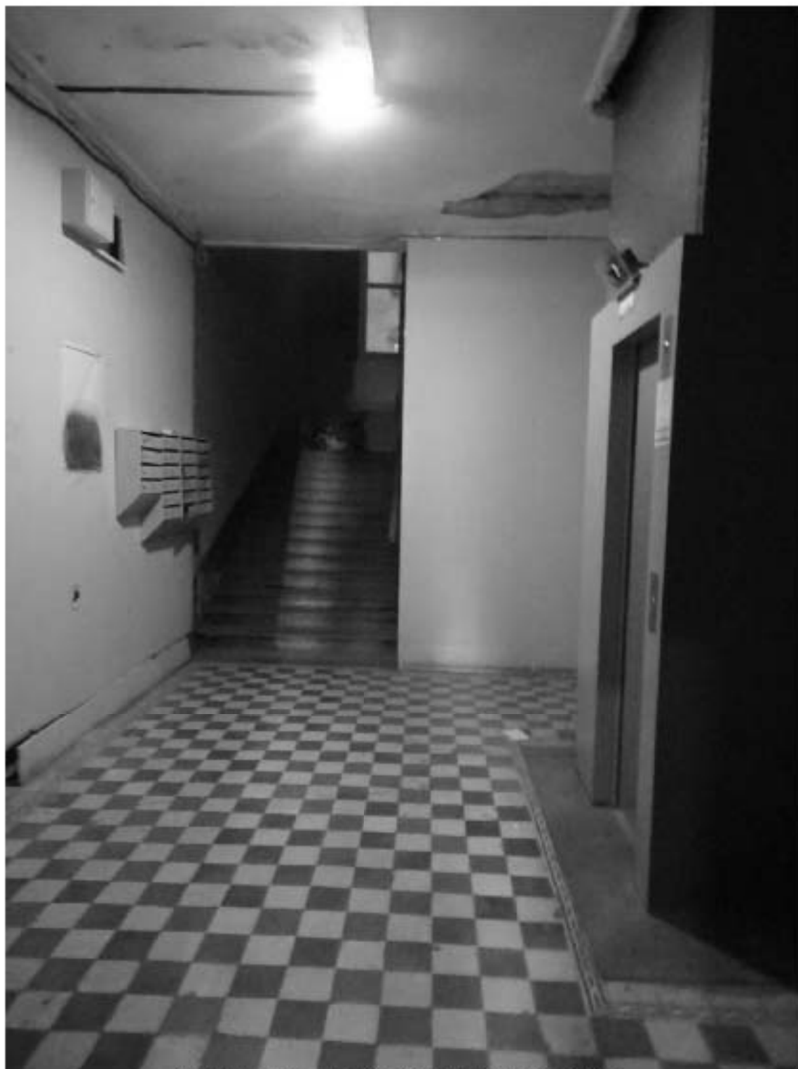
Фото 65. Лестница № 5: 1-й этаж. Вестибюль. Съемка 19.04.2021 г. Михайловская Г. В.
