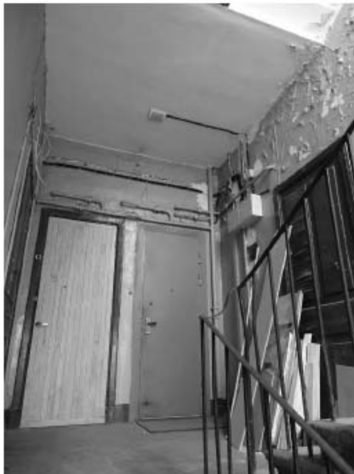
Фото 164. Лестница № 8: 3-й этаж. Съемка 19.04.2021 г. Михайловская Г. В.
