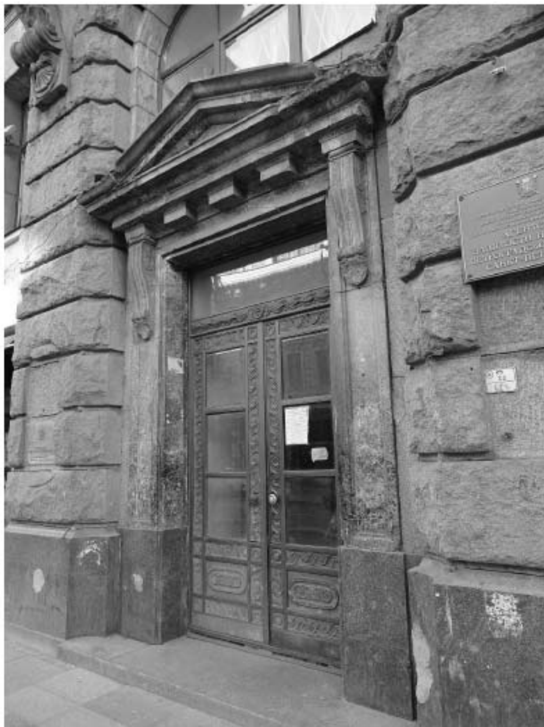
Фото 5. Здание по адресу: г. Санкт-Петербург, Большой проспект П.С., дом 74, литера А. Лицевой фасад по Большому пр. Центральный входной портал. Съемка 19.04.2021 г. Михайловская Г. В.
