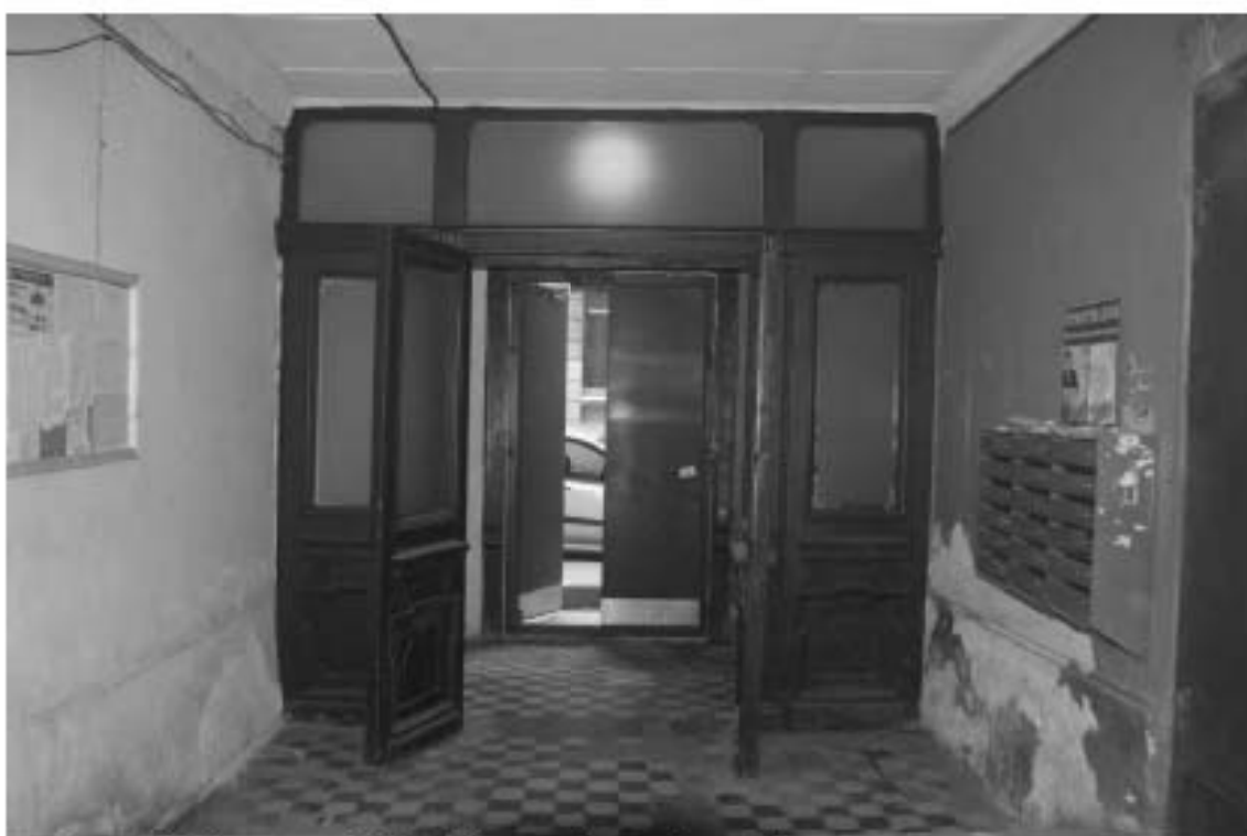
Фото 96. Лестница № 6: 1-й этаж. Вестибюль. Заполнение дверного проема. Съемка 19.04.2021 г. Михайловская Г. В.
