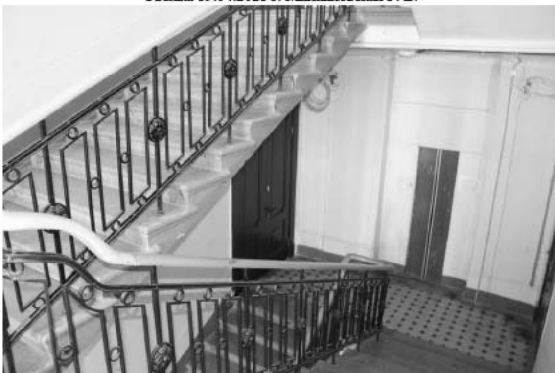
Фото 64. Лестница № 2: 6-й этаж. Съемка 19.04.2021 г. Михайловская Г. В.
