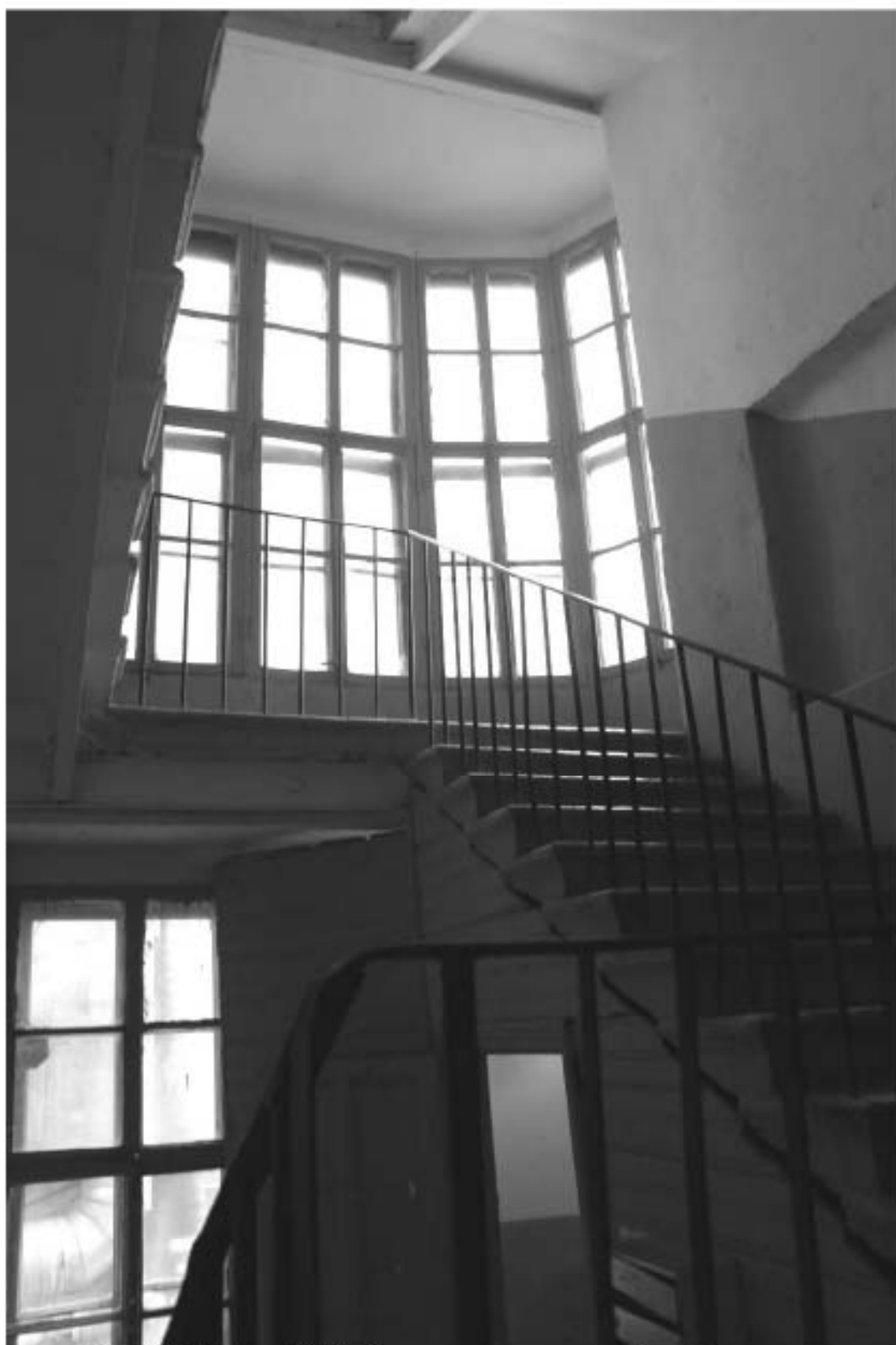
Фото 78. Лестница № 10: Вид на площадку между 2-м и 3-м этажом. Съемка 19.04.2021 г. Михайловская Г. В.
