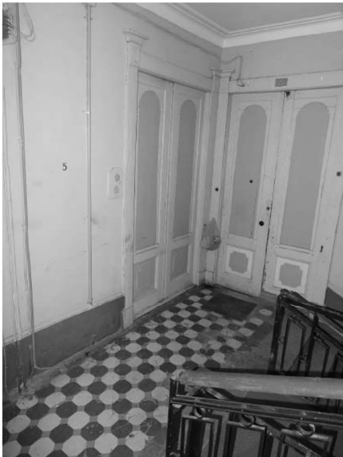
Фото 43. Лестница № 4: 5-й этаж. Съемка 19.04.2021 г. Михайловская Г. В.
