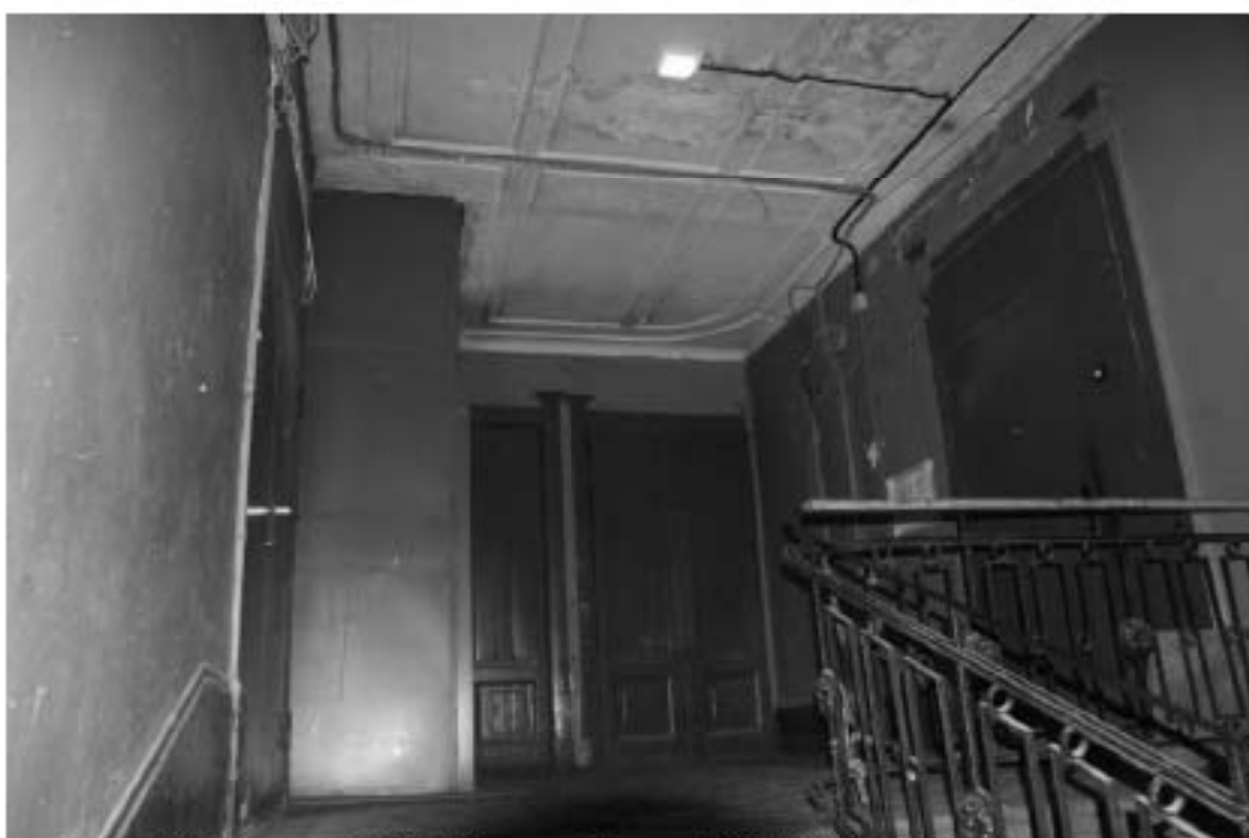
Фото 90. Лестница № 5: 7-й этаж. Съемка 19.04.2021 г. Михайловская Г. В.
