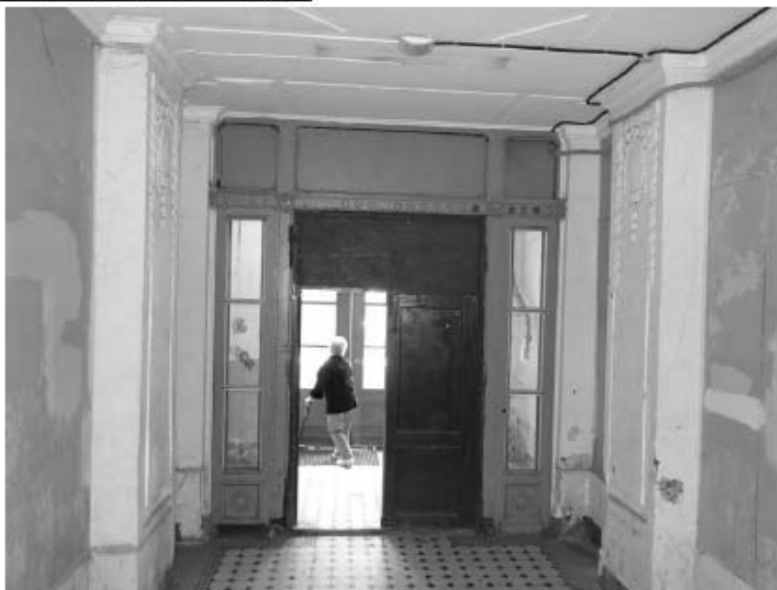
Фото 1. 1-й этаж. Вестибюль по Большому проспекту. Входная дверь. Съемка 19.04.2021 г. Михайловская Г. В.
