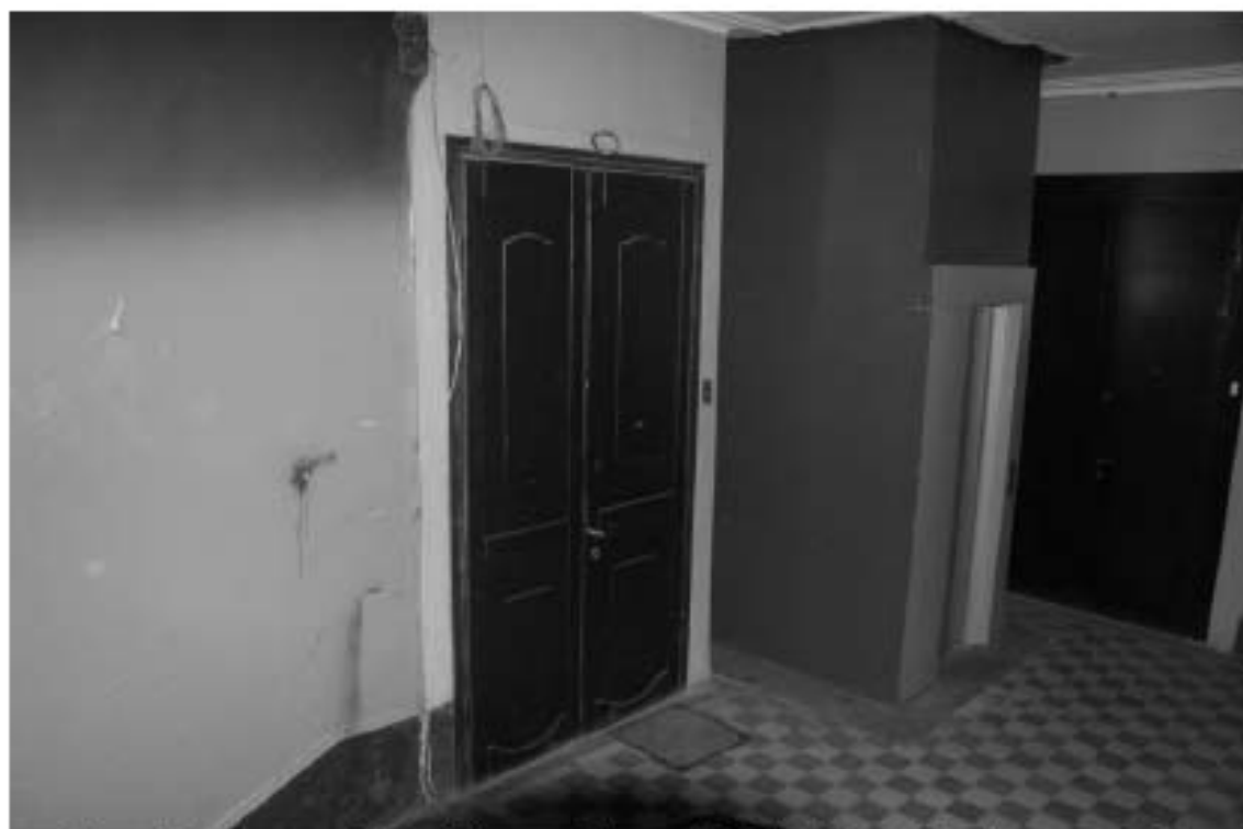
Фото 82. Лестница № 5: 4-й этаж. Съемка 19.04.2021 г. Михайловская Г. В.
