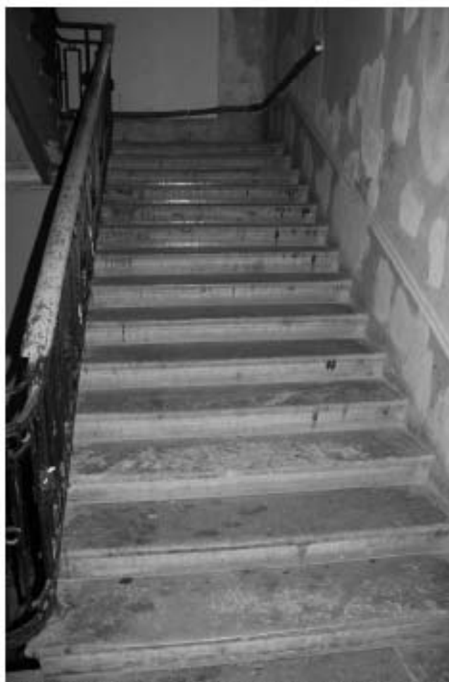
Фото 25. Лестница № 1: Лестничный марш на площадку между 3-м и 4-м этажом. Съемка 19.04.2021 г. Михайловская Г. В.
