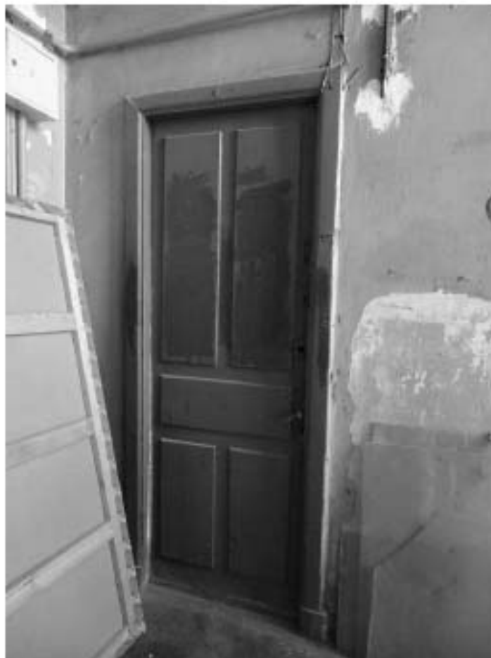
Фото 194. Лестница № 9: 6-й этаж. Съемка 19.04.2021 г. Михайловская Г. В.
