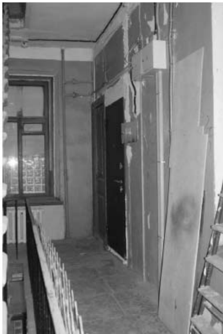
Фото 136. Лестница № 7: 2-й этаж. Съемка 19.04.2021 г. Михайловская Г. В.
