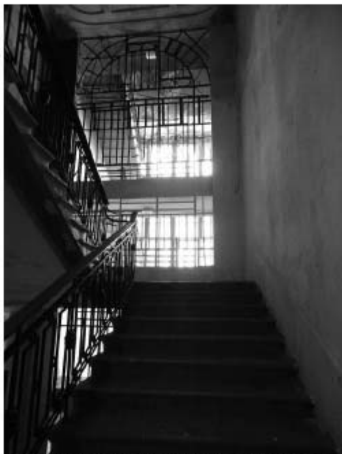
Фото 40. Лестница № 1: Вид с площадки между 6-м и 7-м этажом. Съемка 19.04.2021 г. Михайловская Г. В.
