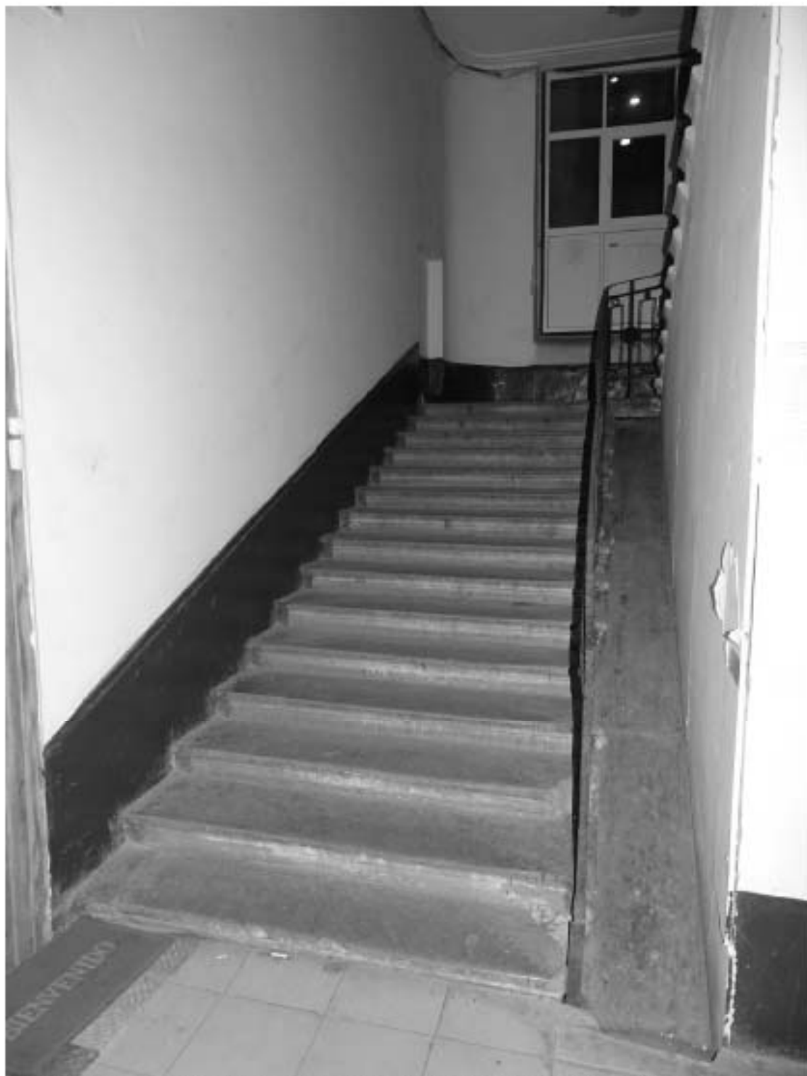
Фото 2. Лестница № 3: 1-й этаж. Вестибюль. Съемка 19.04.2021 г. Михайловская Г. В.
