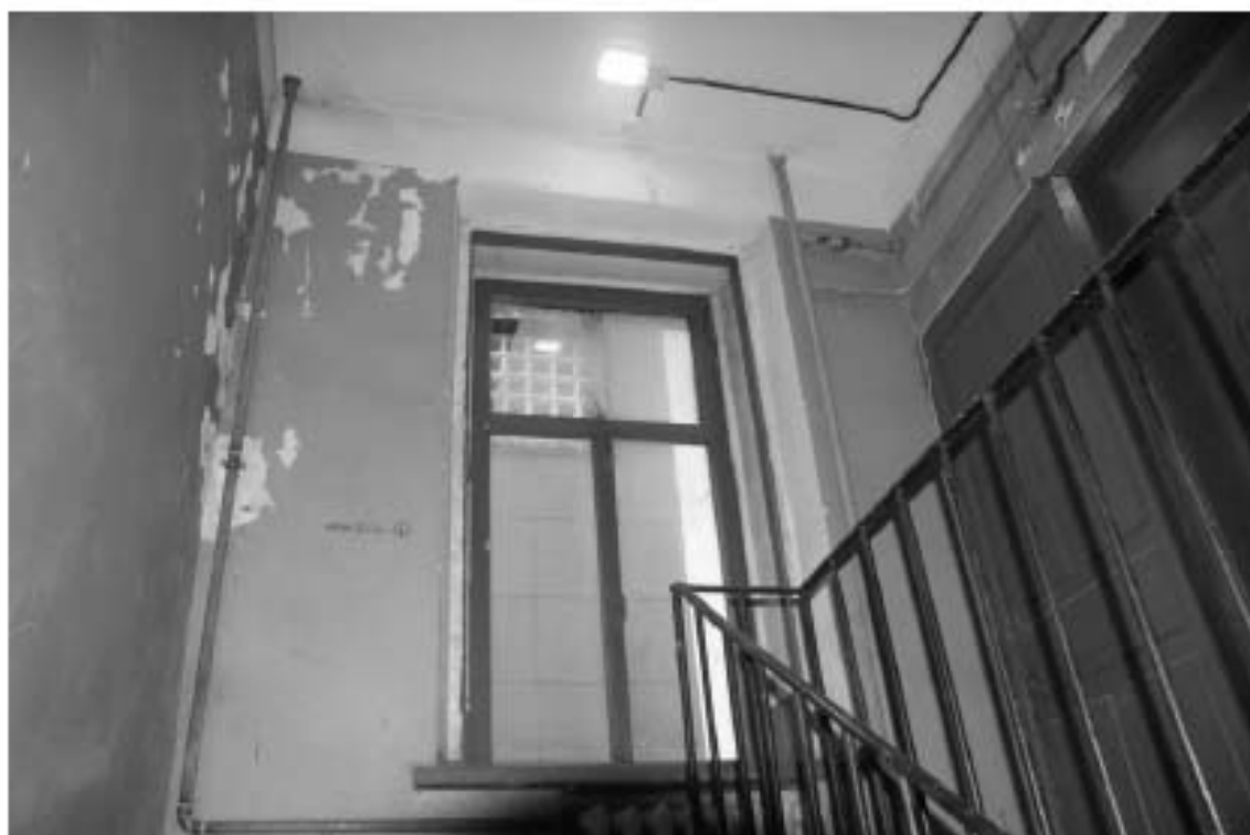
Фото 137. Лестница № 7: 3-й этаж. Съемка 19.04.2021 г. Михайловская Г. В.
