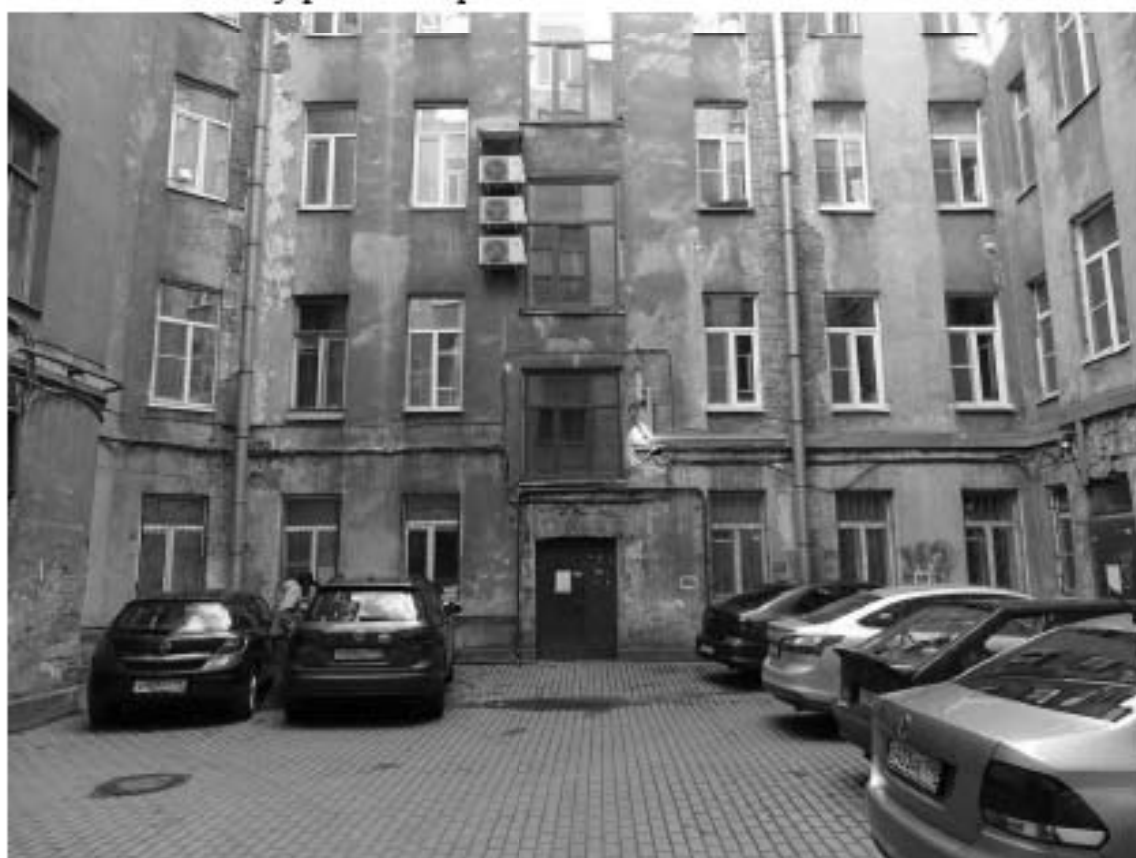
Фото 29. Здание по адресу: г. Санкт-Петербург, Большой проспект П.С., дом 74, литера А. Западный внутренний двор. Съемка 19.04.2021 г. Михайловская Г. В.
