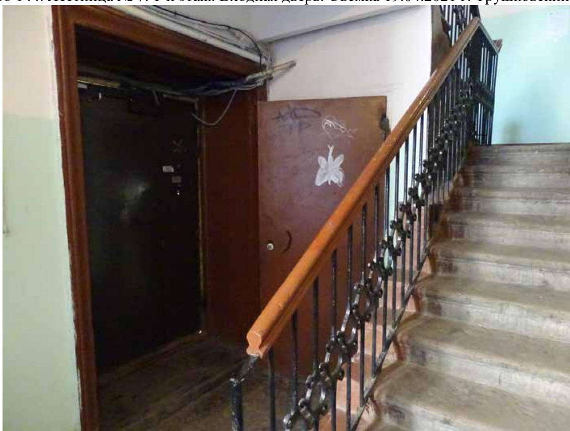
Фото 145. Лестница № 7. 1-й этаж. Съемка 19.04.2021 г. Трушковский В.Э.
