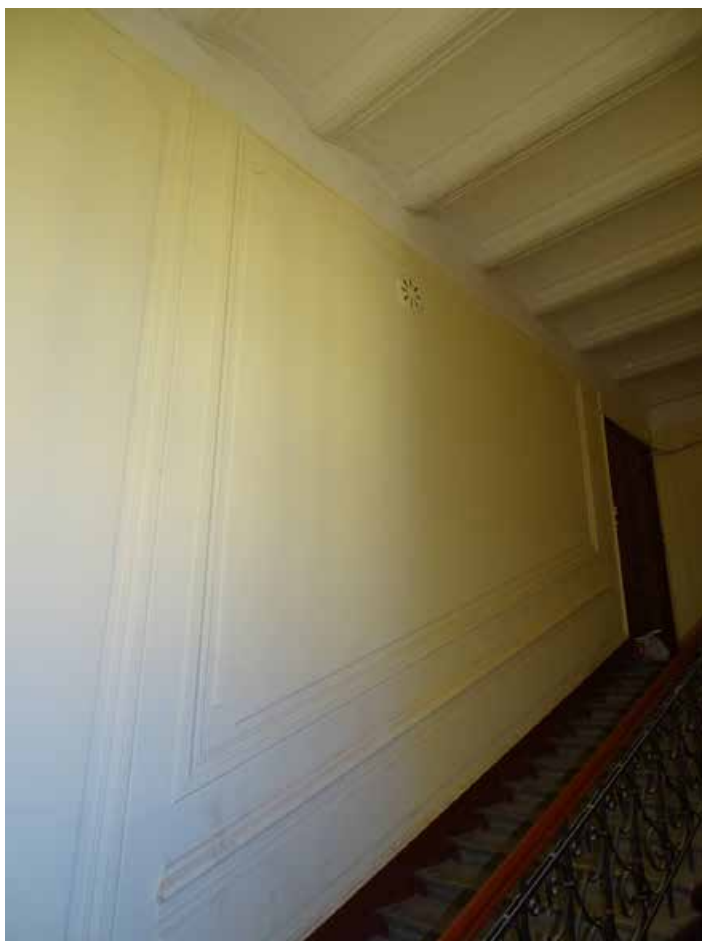
Фото 30. Лестница № 1. Площадка м/у 3-м и 4-м этажом. Оформление стен. Съемка 19.04.2021 г. Трушковский В.Э.
