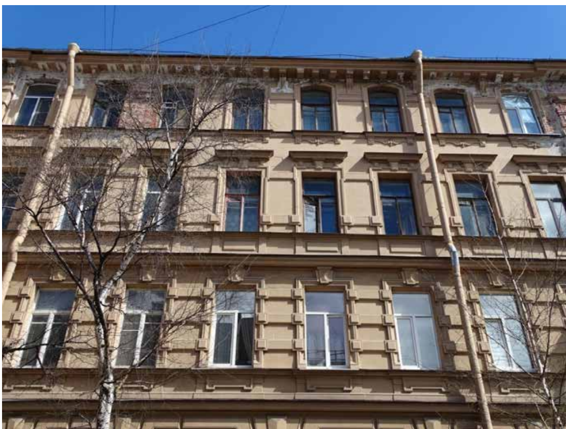
Фото 10. Здание по адресу: г. Санкт-Петербург, Тучков пер., 11/5, литера А. Фрагмент лицевого фасада со стороны Тучкова пер. 3-й, 4-й, 5-й этаж. Съемка 19.04.2021 г. Трушковский В.Э.
