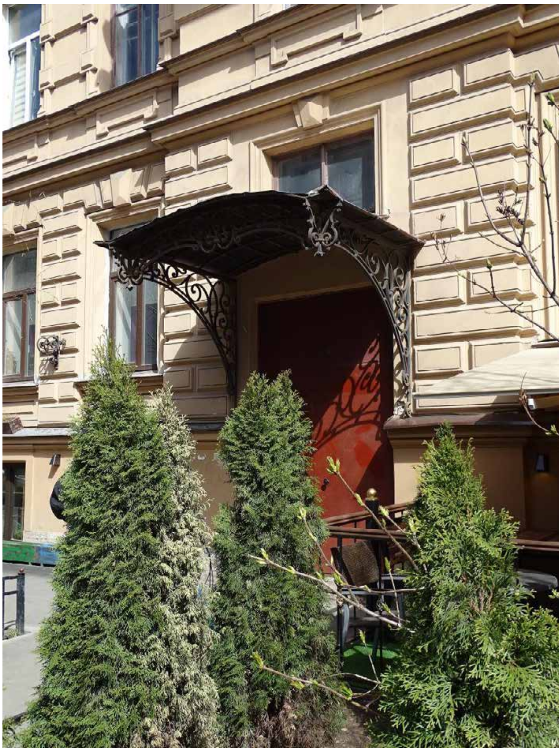
Фото 19. Здание по адресу: г. Санкт-Петербург, Тучков пер., 11/5, литера А. Фрагмент лицевого фасада со стороны Тучкова пер. Вход в парадную. Оформление навеса. Съемка 19.04.2021 г. Трушковский В.Э.
