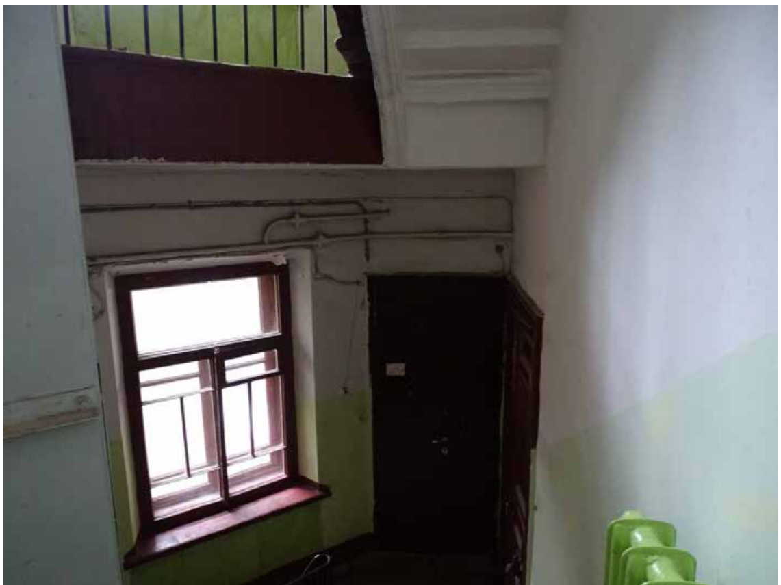
Фото 195. Лестница № 8. Площадка 4-го этажа. Съемка 19.04.2021 г. Трушковский В.Э.
