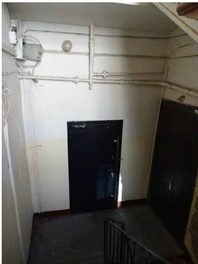
Фото 131. Лестница № 6. Площадка 1-го этажа. Съемка 19.04.2021 г. Трушковский В.Э.
