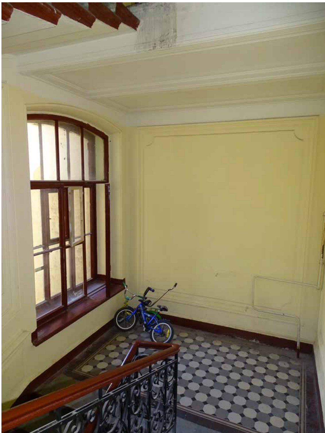
Фото 25. Лестница № 1. Вид на площадку м/у 2-м и 3-м этажом. Съемка 19.04.2021 г. Трушковский В.Э.
