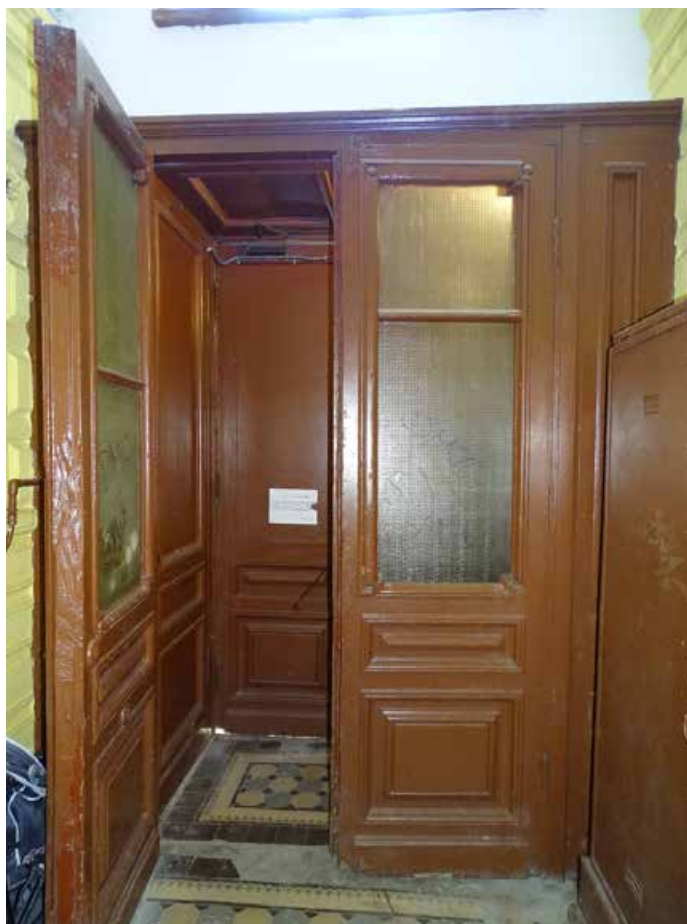
Фото 67. Лестница № 3. 1-й этаж. Вестибюль. Дверное заполнение. Съемка 19.04.2021 г. Трушковский В.Э.
