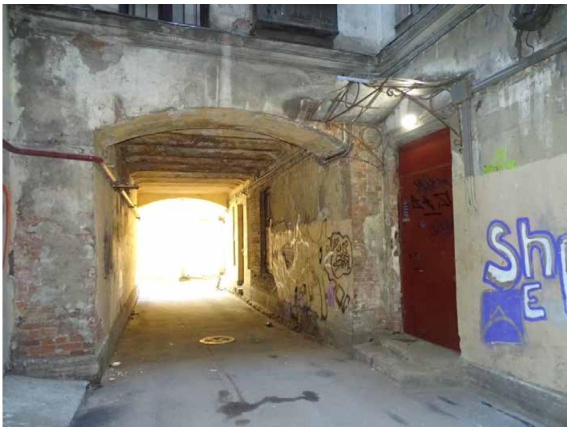
Фото 34. Здание по адресу: г. Санкт-Петербург, Тучков пер., 11/5, литера А. Воротный проезд в северо-восточный двор. Съемка 19.04.2021 г. Трушковский В.Э.
