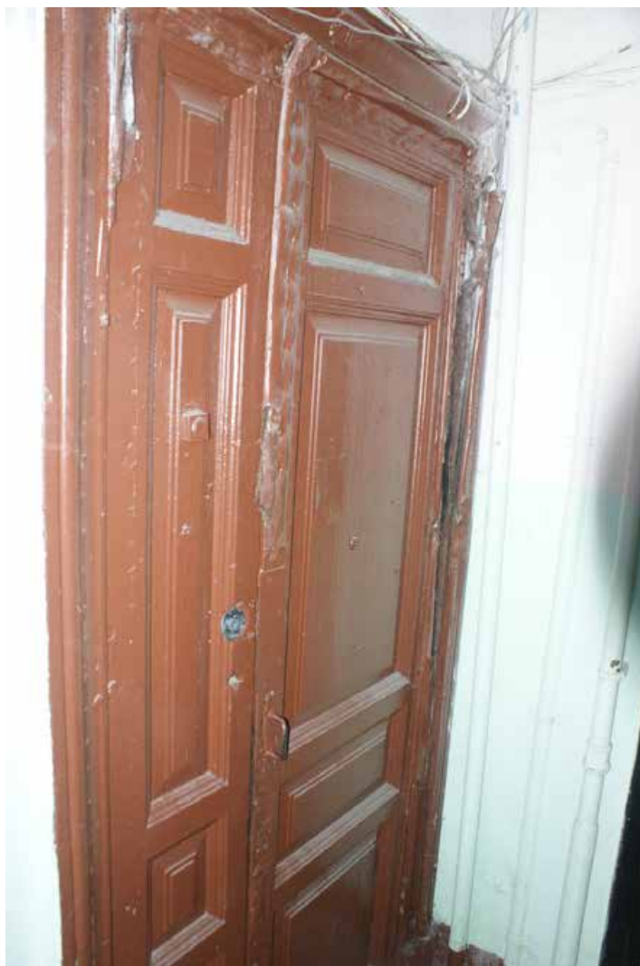
Фото 160. Лестница № 7. Площадка 3-го этажа. Дверное заполнение. Съемка 19.04.2021 г. Трушковский В.Э.
