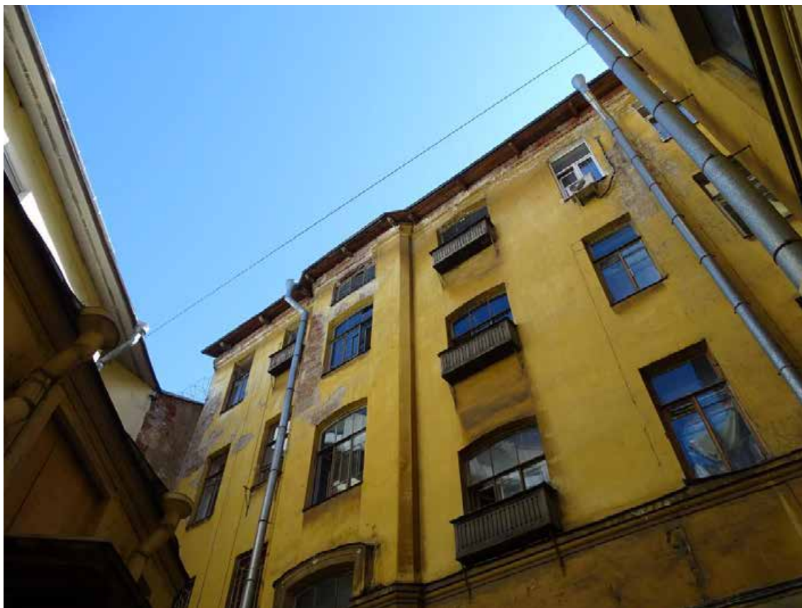
Фото 42. Здание по адресу: г. Санкт-Петербург, Тучков пер., 11/5, литера А. Фрагмент северо-восточного дворового фасада. Съемка 19.04.2021 г. Трушковский В.Э.
