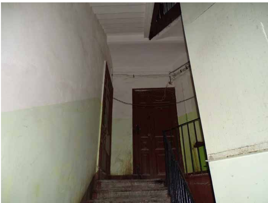
Фото 191. Лестница № 8. Площадка 3-го этажа. Съемка 19.04.2021 г. Трушковский В.Э.
