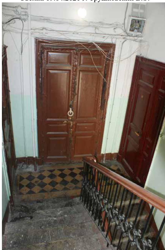
Фото 165. Лестница № 7. Площадка 4-го этажа. Съемка 19.04.2021 г. Трушковский В.Э.
