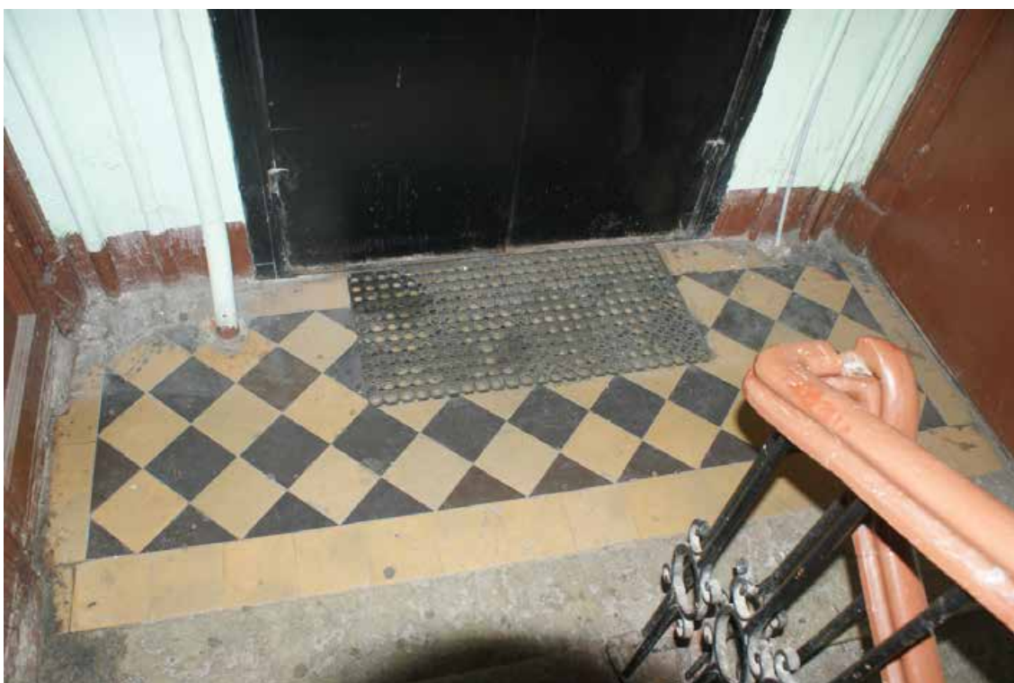
Фото 159. Лестница № 7. Площадка 3-го этажа. Покрытие пола. Съемка 19.04.2021 г. Трушковский В.Э.
