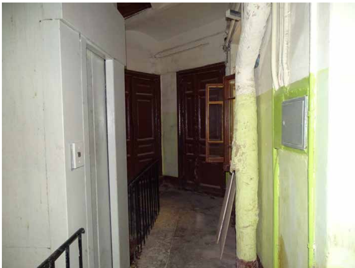
Фото 185. Лестница № 8. Площадка 2-го этажа. Съемка 19.04.2021 г. Трушковский В.Э.
