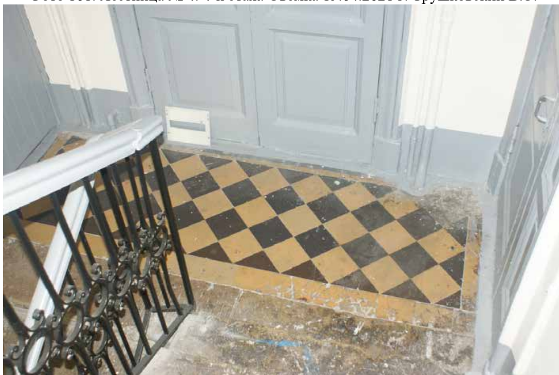
Фото 102. Лестница № 4. 4-й этаж. Покрытие пола. Съемка 19.04.2021 г. Трушковский В.Э.
