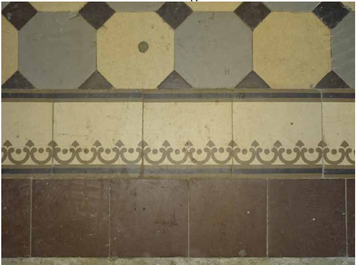
Фото 78. Лестница № 3. 1-й этаж. Вестибюль. Покрытие пола. Съемка 19.04.2021 г. Трушковский В.Э.
