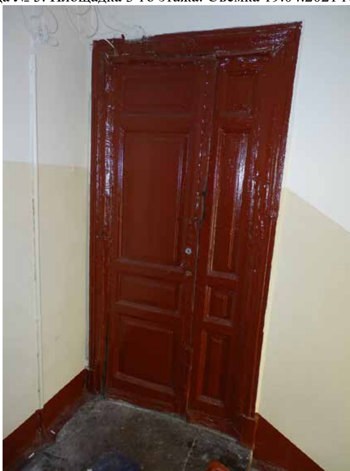
Фото 119. Лестница № 5. Площадка 3-го этажа. Дверное заполнение. Съемка 19.04.2021 г. Трушковский В.Э.
