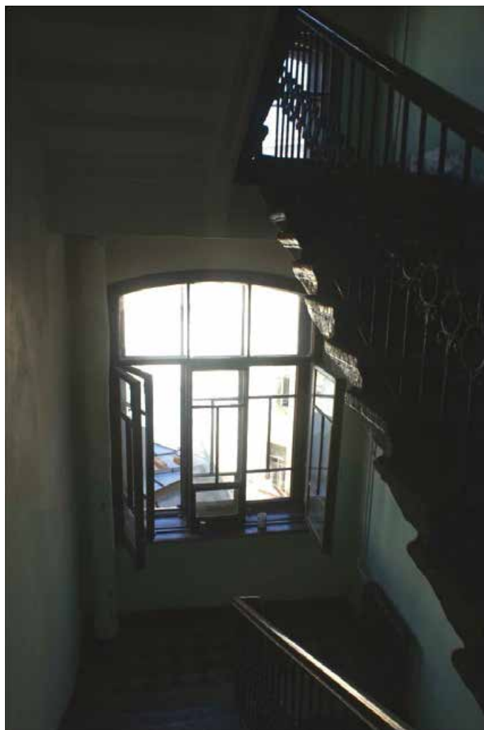
Фото 162. Лестница № 7. Площадка м/у 3-м и 4-м этажом. Съемка 19.04.2021 г. Трушковский В.Э.
