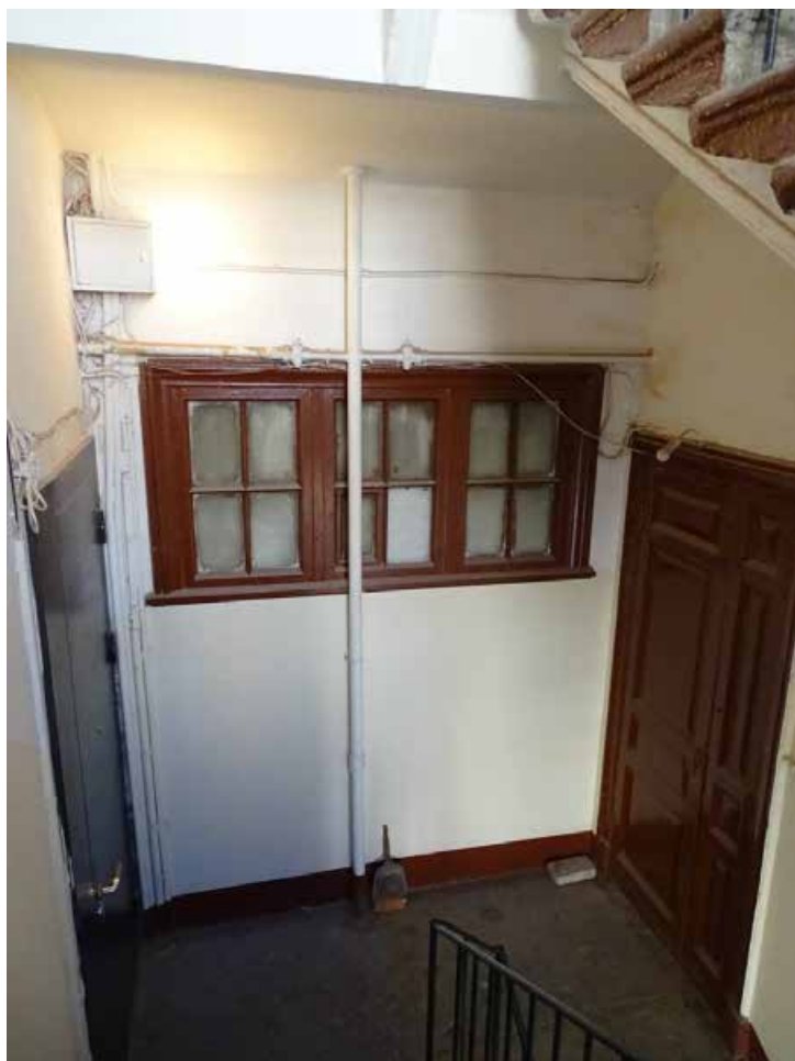
Фото 133. Лестница № 6. Площадка 2-го этажа. Съёмка 19.04.2021 г. Трушковский В.Э.
