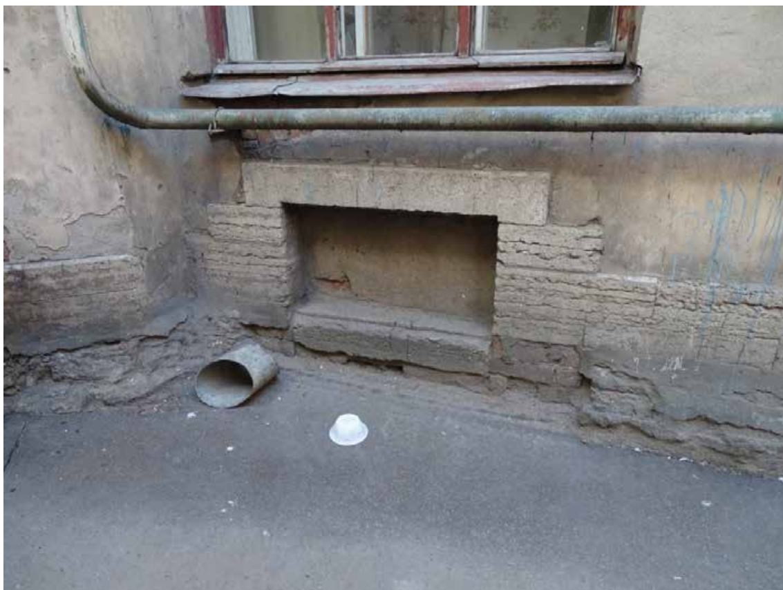
Фото 28. Здание по адресу: г. Санкт-Петербург, Тучков пер., 11/5, литера А. Дворовой фасад. Цоколь из известняка. Съемка 19.04.2021 г. Трушковский В.Э
