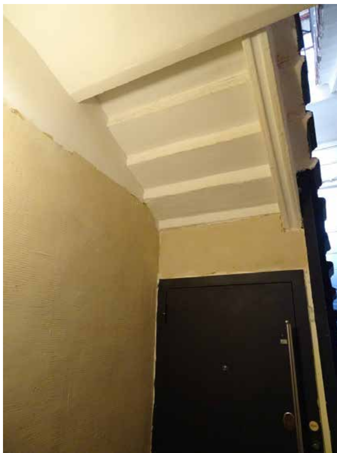
Фото 129. Лестница № 6. 1-й этаж. Дверь в подвал. Съемка 19.04.2021 г. Трушковский В.Э.
