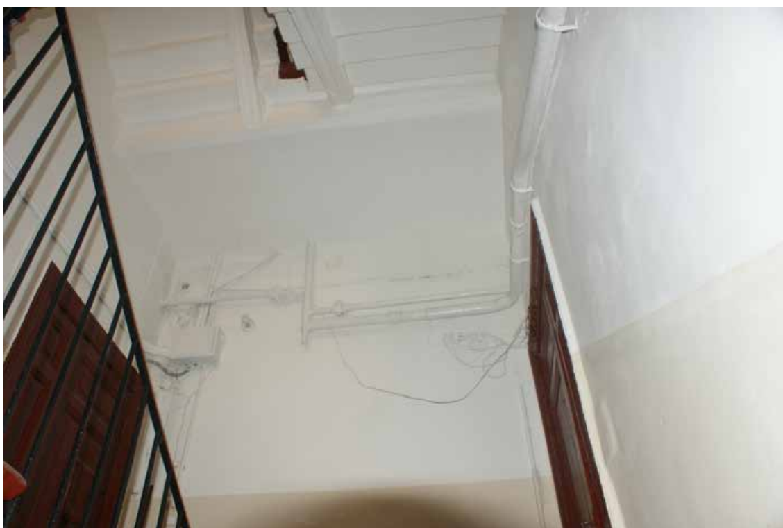
Фото 111. Лестница № 5. Площадка 1-го этажа. Оформление потолка. Съемка 19.04.2021 г. Трушковский В.Э.
