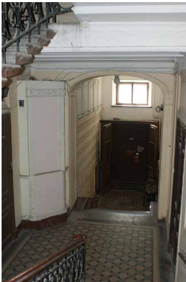
Фото 43. Лестница № 2. Вестибюль 1-го этажа. Съемка 19.04.2021 г. Трушковский В.Э.
