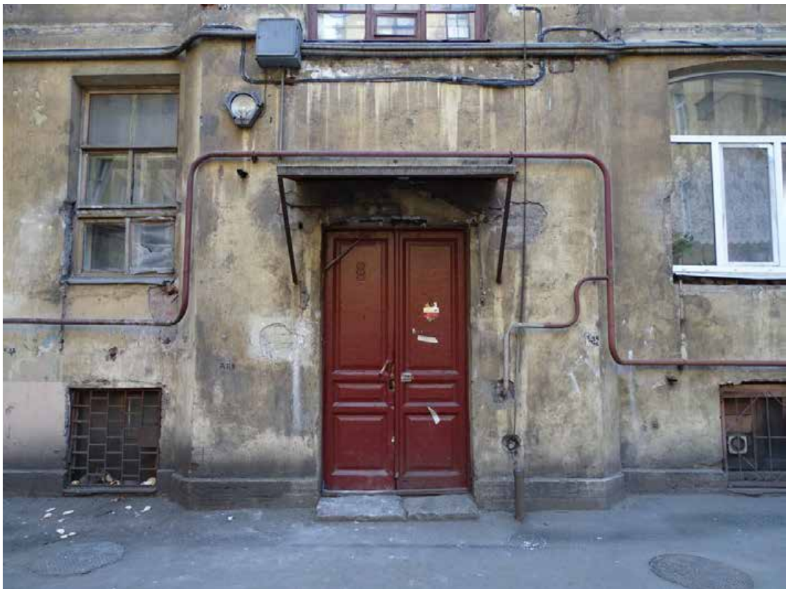
Фото 61. Здание по адресу: г. Санкт-Петербург, Тучков пер., 11/5, литера А. Фрагмент дворового фасада. Лицевой корпус. Съемка 19.04.2021 г. Трушковский В.Э.
