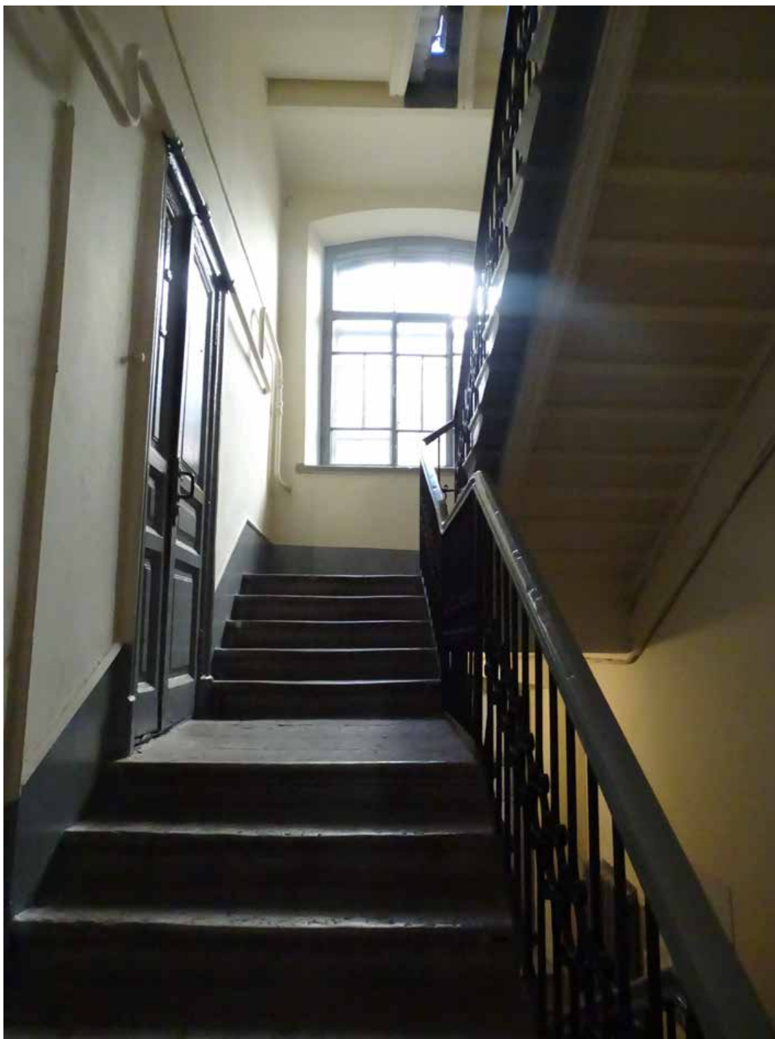
Фото 91. Лестница № 4. Промежуточная площадка м/у 1-м и 2-м этажом. Съемка 19.04.2021 г. Трушковский В.Э.
