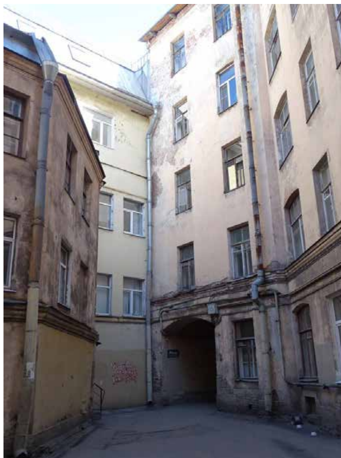
Фото 24. Здание по адресу: г. Санкт-Петербург, Тучков пер., 11/5, литера А. Северо-западный дворовой фасад. Съемка 19.04.2021 г. Трушковский В.Э.
