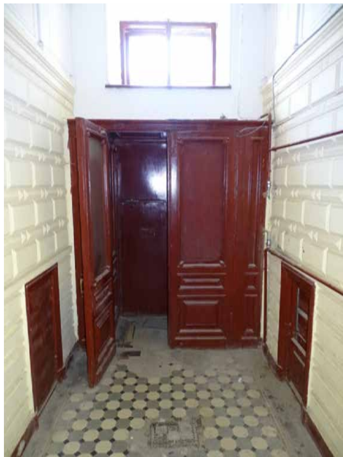
Фото 1. Лестница № 1. Вестибюль 1-го этажа. Съемка 19.04.2021 г. Трушковский В.Э.
