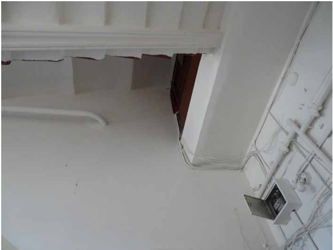
Фото 122. Лестница № 5. Площадка 4-го этажа. Оформление потолка. Съемка 19.04.2021 г. Трушковский В.Э.
