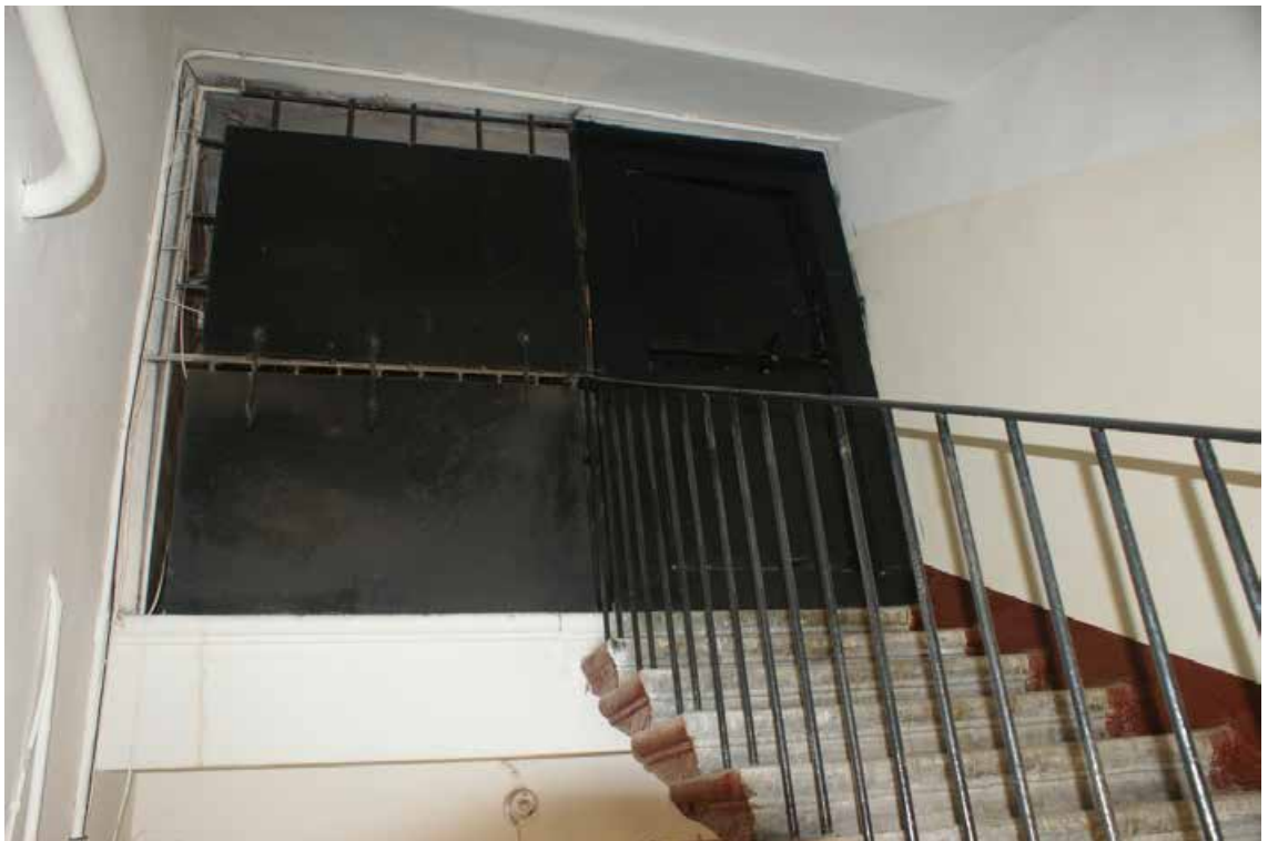
Фото 142. Лестница № 6. Площадка 5-го этажа. Чердак. Съемка 19.04.2021 г. Трушковский В.Э.
