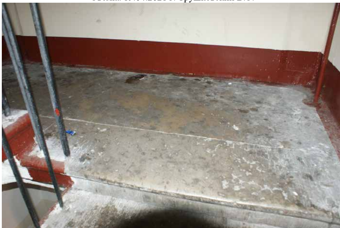
Фото 113. Лестница № 5. Площадка м/у 1-м и 2-м этажом. Покрытие пола. Съемка 19.04.2021 г. Трушковский В.Э.
