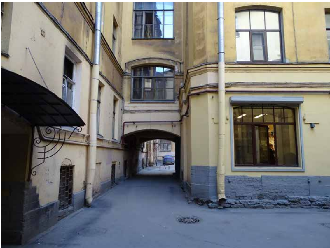
Фото 49. Здание по адресу: г. Санкт-Петербург, Тучков пер., 11/5, литера А. Фрагмент северо-восточного дворового фасада. Съемка 19.04.2021 г. Трушковский В.Э.
