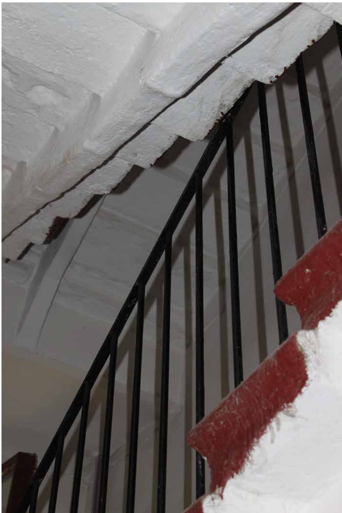
Фото 219. Лестница службы: Лестничный марш. Съемка 19.04.2021 г. Трушковский В.Э.
