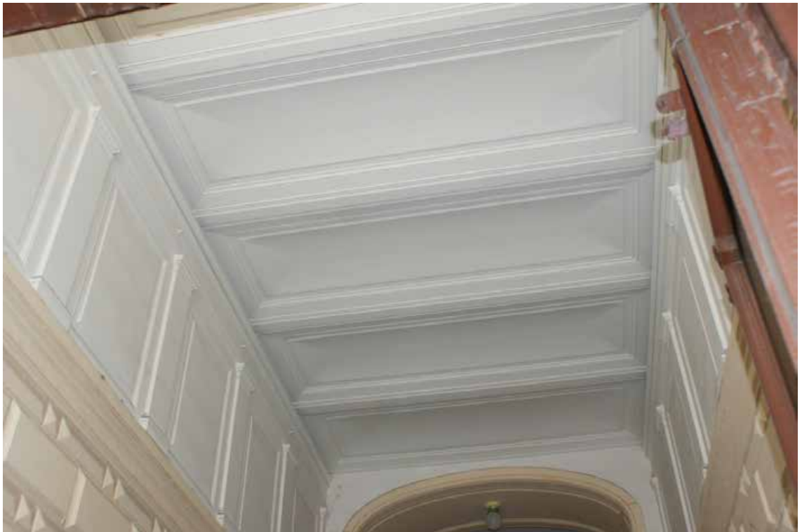
Фото 39. Лестница № 2. Вестибюль 1-го этажа. Оформление потолка. Съемка 19.04.2021 г. Трушковский В.Э.
