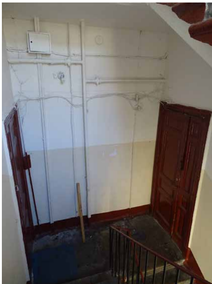
Фото 118. Лестница № 5. Площадка 3-го этажа. Съемка 19.04.2021 г. Трушковский В.Э.
