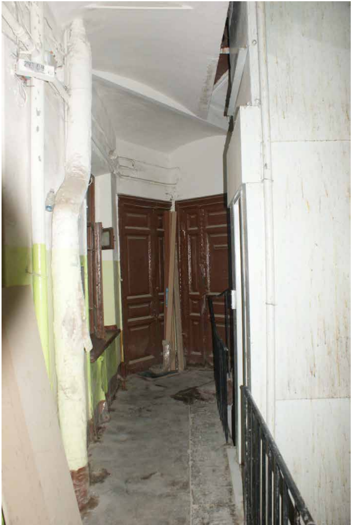
Фото 183. Лестница № 8. Площадка 2-го этажа. Съемка 19.04.2021 г. Трушковский В.Э.
