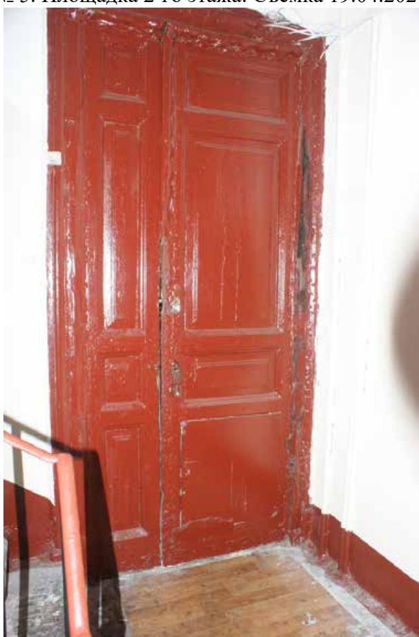
Фото 115. Лестница № 5. Площадка 2-го этажа. Дверное заполнение. Съемка 19.04.2021 г. Трушковский В.Э.
