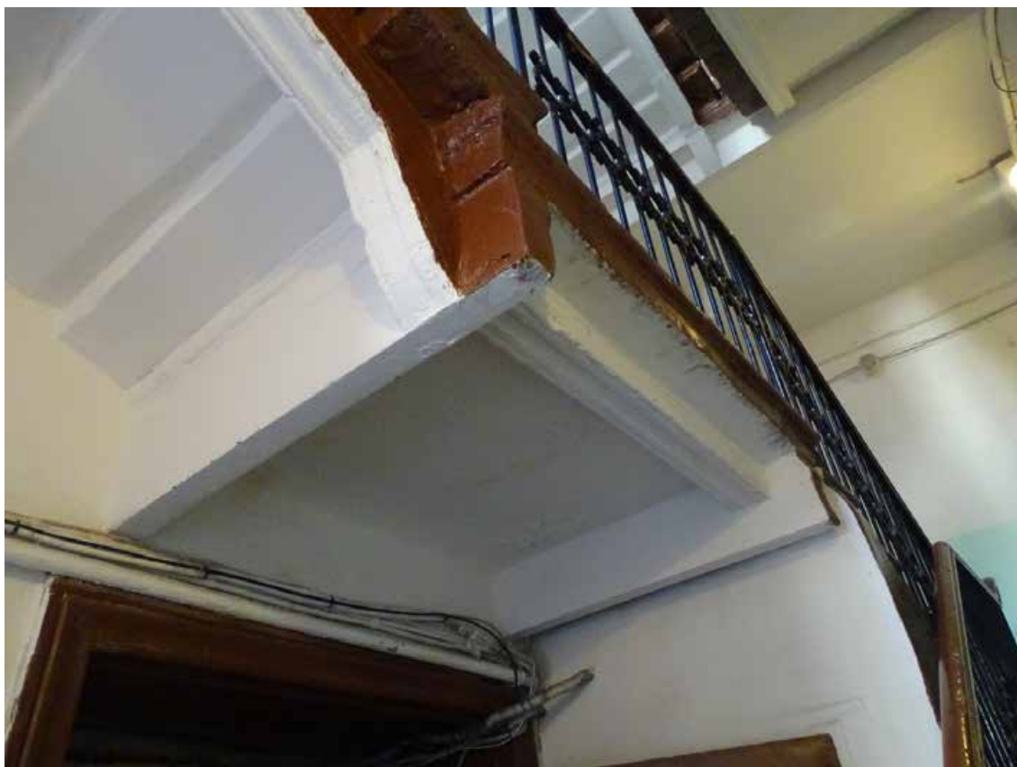
Фото 146. Лестница № 7. 1-й этаж. Съемка 19.04.2021 г. Трушковский В.Э.
