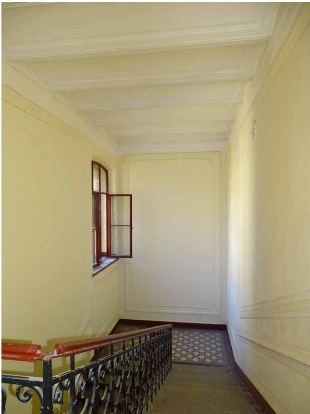
Фото 32. Лестница № 1. Вид на площадку м/у 3-м и 4-м этажом. Съемка 19.04.2021 г. Трушковский В.Э.
