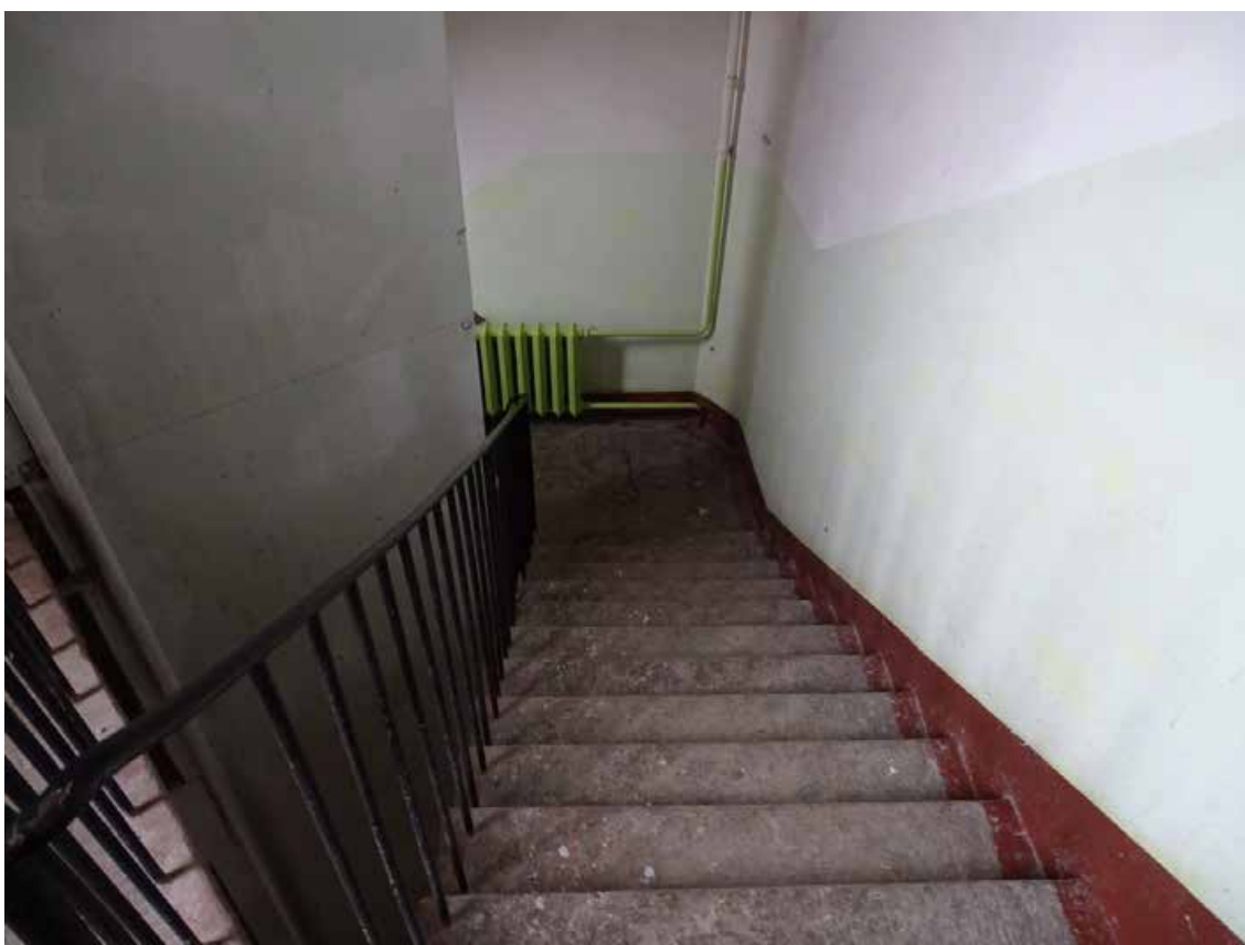
Фото 199. Лестница № 8. Площадка м/у 4-м и 5-м этажом. Съемка 19.04.2021 г. Трушковский В.Э.
