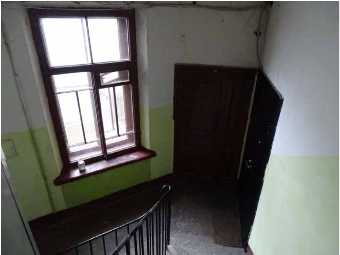
Фото 200. Лестница № 8. Площадка 5-го этажа. Съемка 19.04.2021 г. Трушковский В.Э.
