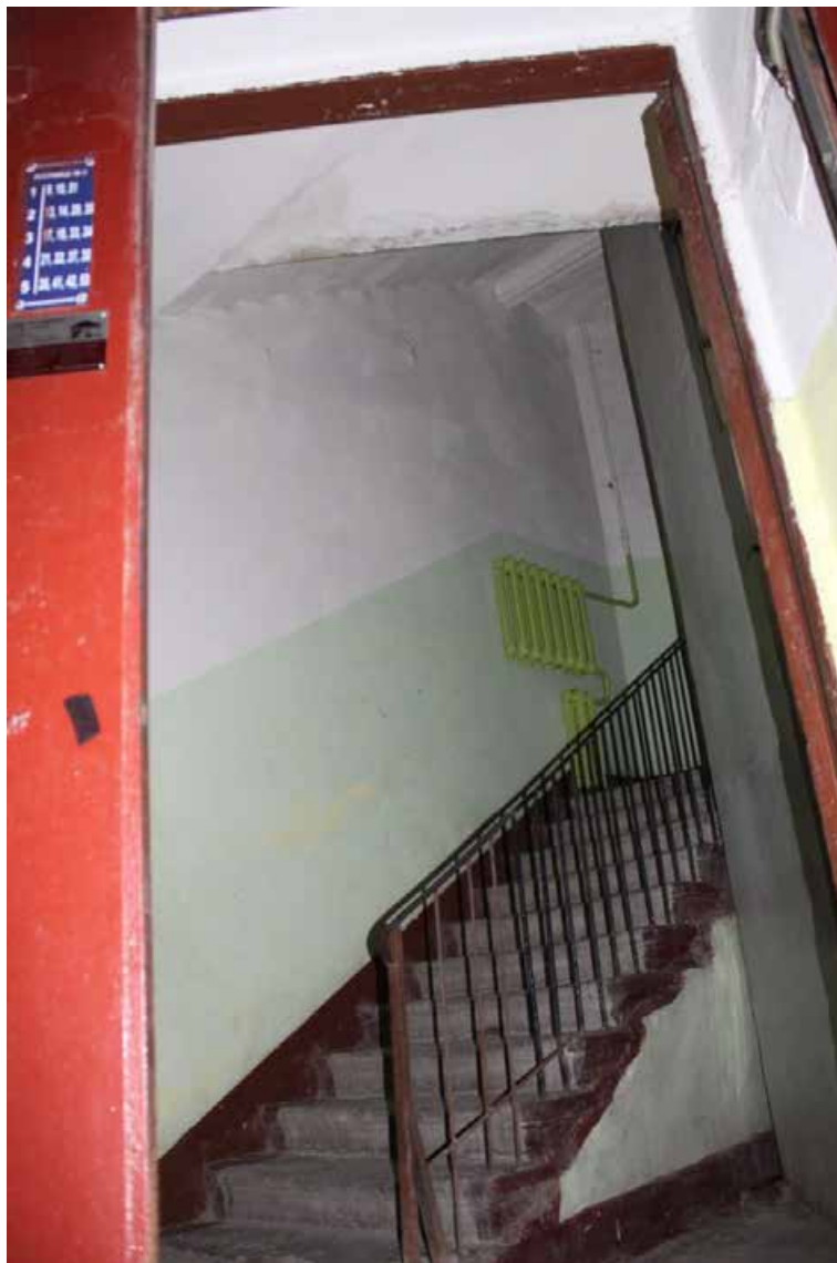
Фото 172. Лестница № 8. Вестибюль 1-го этаж. Входная дверь. Съемка 19.04.2021 г. Трушковский В.Э.
