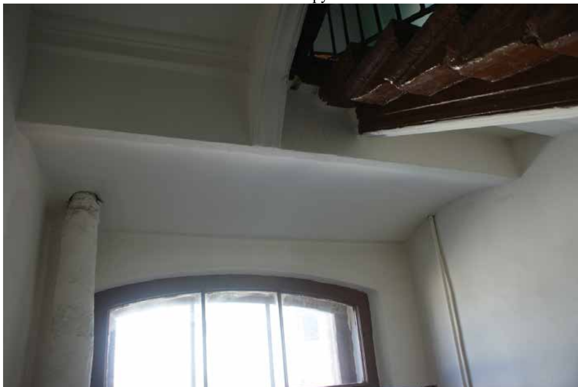
Фото 163. Лестница № 7. Площадка м/у 3-м и 4-м этажом. Оформление потолка. Съемка 19.04.2021 г. Трушковский В.Э.
