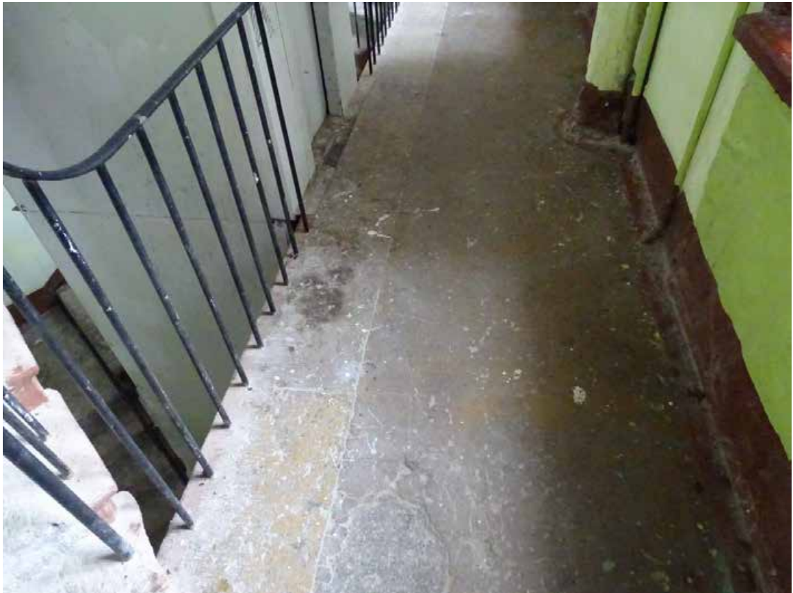
Фото 206. Лестница № 8. Площадка 5-го этажа. Покрытие пола. Съемка 19.04.2021 г. Трушковский В.Э.
