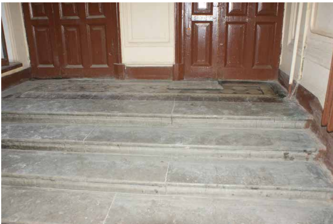
Фото 47. Лестница № 2. Площадка между 1-м и 2-м этажом. Съемка 19.04.2021 г. Трушковский В.Э.
