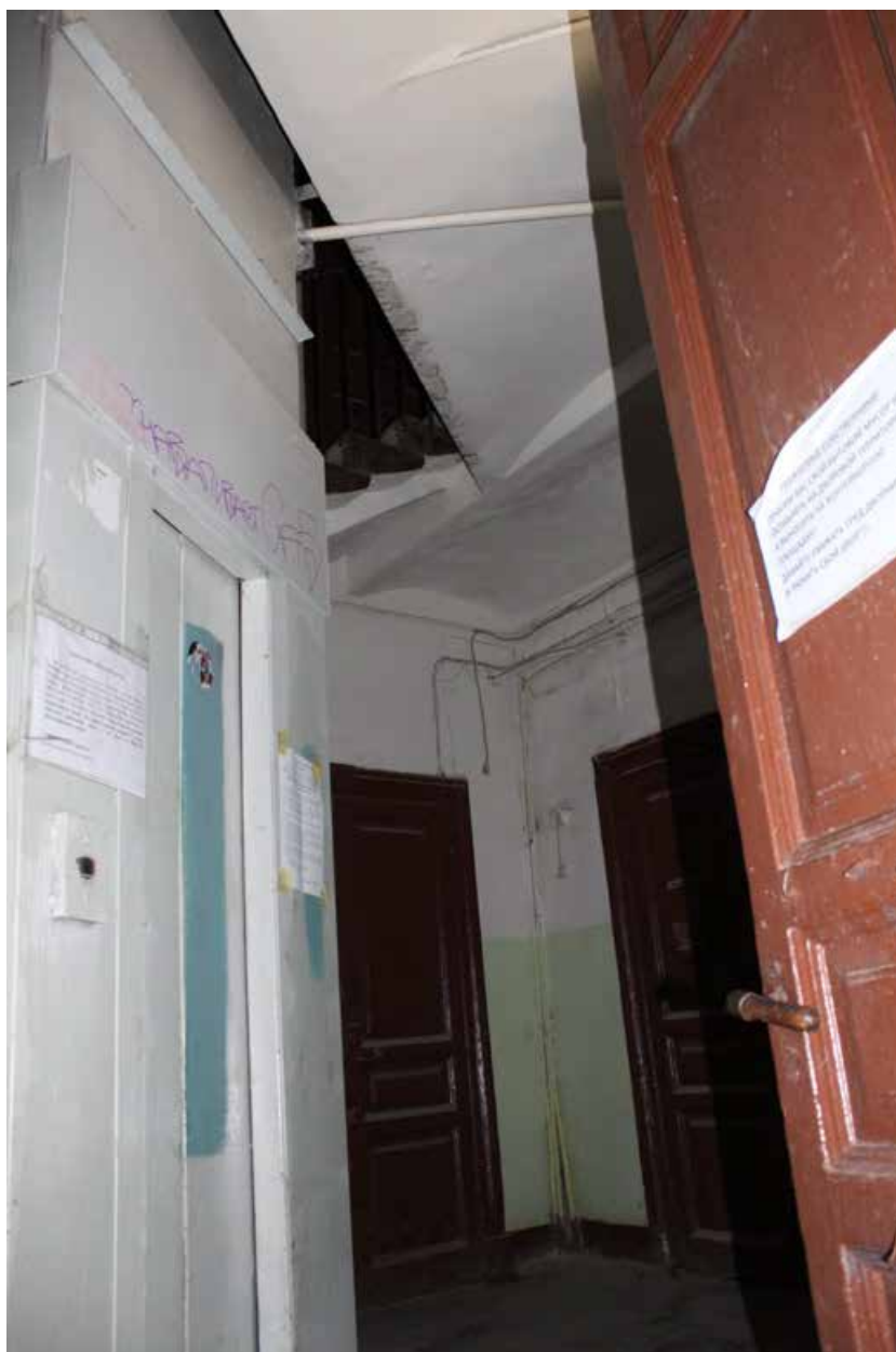
Фото 175. Лестница № 8. Вестибюль 1-го этажа. Съемка 19.04.2021 г. Трушковский В.Э.
