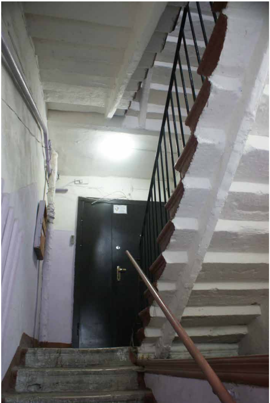
Фото 213. Лестница службы: 1-й этаж. Съемка 19.04.2021 г. Трушковский В.Э.
