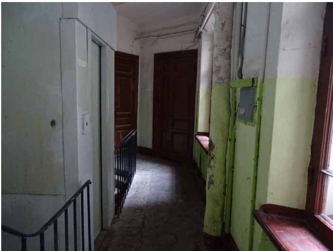
Фото 196. Лестница № 8. Площадка 4-го этажа. Съёмка 19.04.2021 г. Трушковский В.Э.
