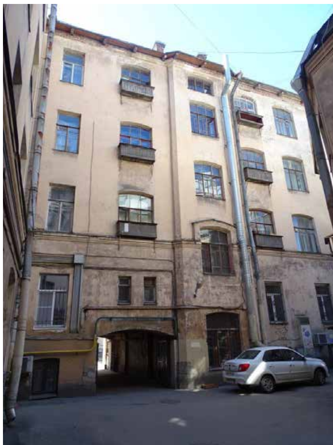
Фото 30. Здание по адресу: г. Санкт-Петербург, Тучков пер., 11/5, литера А. Северо-западный дворовой фасад. Воротный проезд на Тучков пер. Съемка 19.04.2021 г. Трушковский В.Э.
