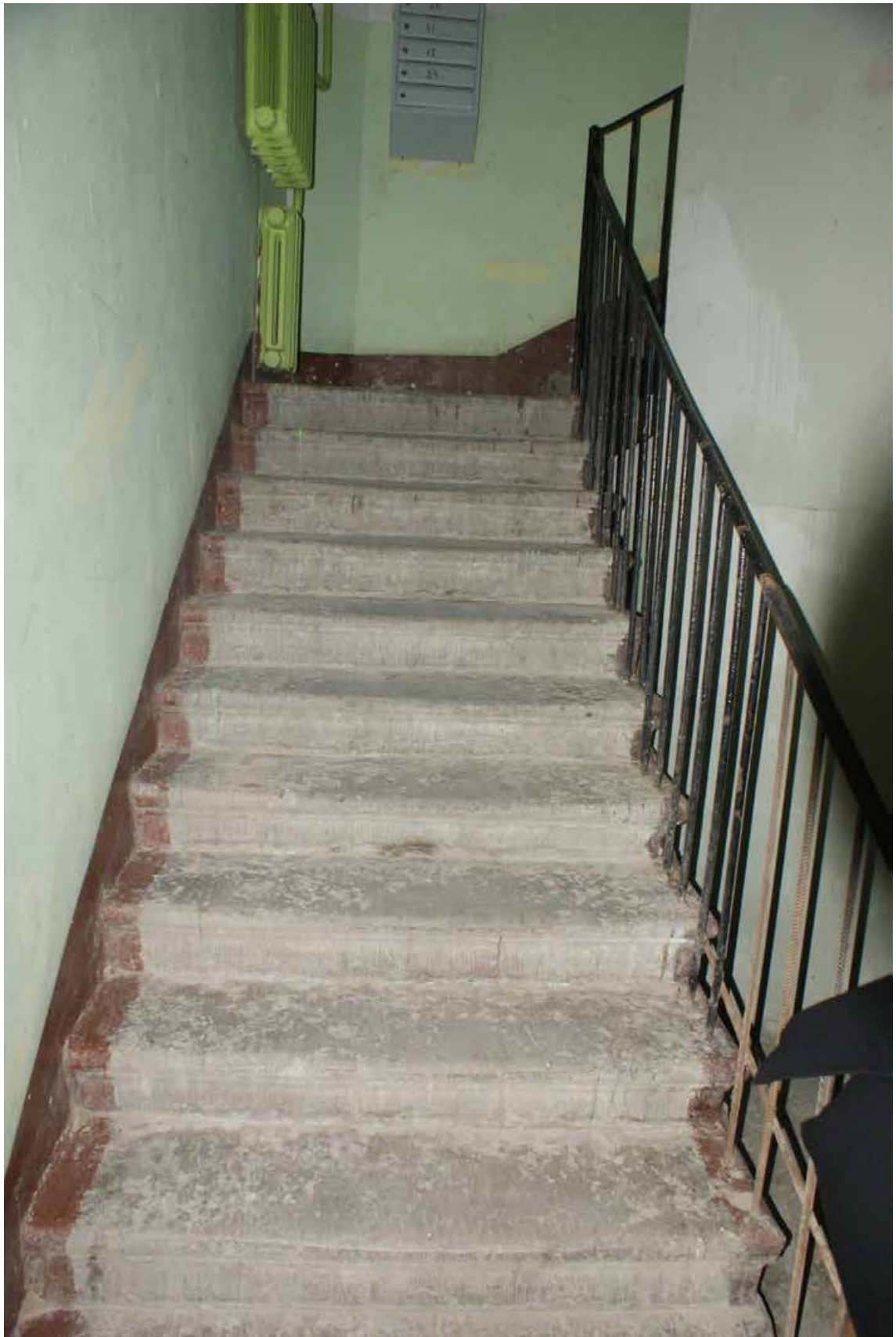
Фото 182. Лестница № 8. Лестничный марш м/у 1-м и 2-м этажом. Съемка 19.04.2021 г. Трушковский В.Э.
