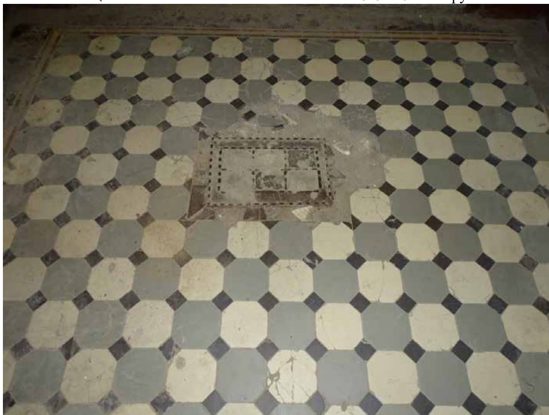
Фото 2. Лестница № 1. Вестибюль 1-го этажа. Покрытие пола. Съемка 19.04.2021 г. Трушковский В.Э.
