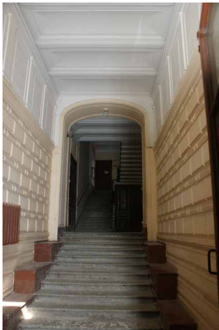
Фото 37. Лестница № 2. Вестибюль 1-го этажа. Съемка 19.04.2021 г. Трушковский В.Э.
