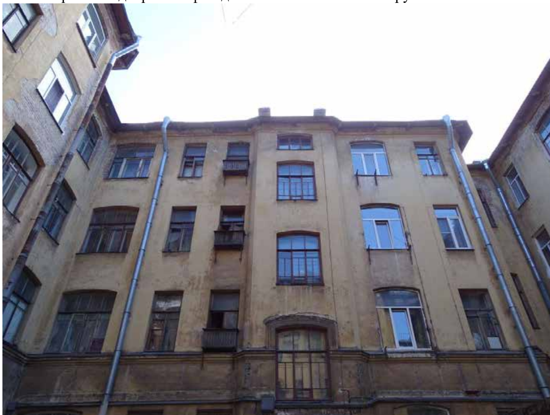
Фото 59. Здание по адресу: г. Санкт-Петербург, Тучков пер., 11/5, литера А. Фрагмент дворового фасада. Лицевой корпус. Съемка 19.04.2021 г. Трушковский В.Э.
