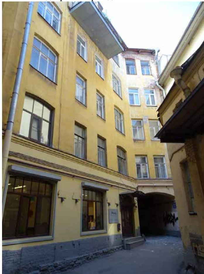
Фото 44. Здание по адресу: г. Санкт-Петербург, Тучков пер., 11/5, литера А. Фрагмент северо-восточного дворового фасада. Съемка 19.04.2021 г. Трушковский В.Э.
