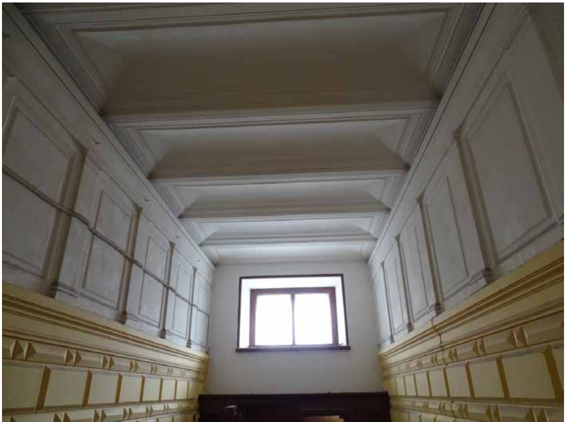
Фото 66. Лестница № 3. 1-й этаж. Вестибюль. Оформление потолка. Съемка 19.04.2021 г. Трушковский В.Э.
