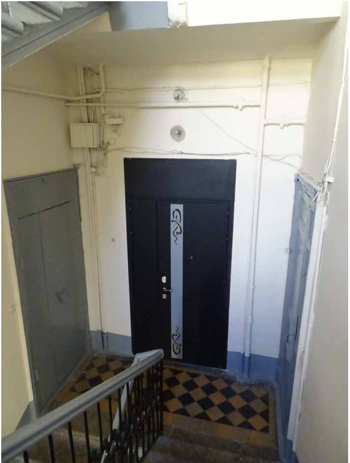
Фото 96. Лестница № 4. Площадка 3-го этажа. Съемка 19.04.2021 г. Трушковский В.Э.
