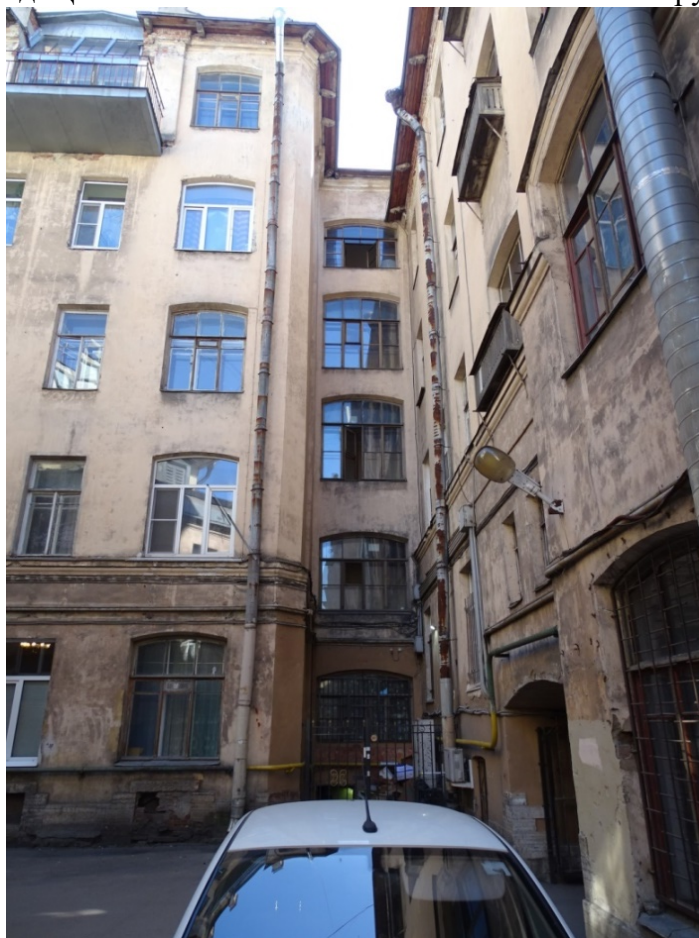
Фото 29. Здание по адресу: г. Санкт-Петербург, Тучков пер., 11/5, литера А. Северо-западный дворовой фасад. Съемка 19.04.2021 г. Трушковский В.Э.
