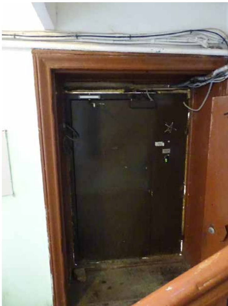
Фото 144. Лестница № 7. 1-й этаж. Входная дверь. Съемка 19.04.2021 г. Трушковский В.Э.
