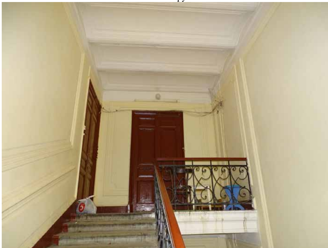
Фото 31. Лестница № 1. Вид на площадку 4-го этажа. Съемка 19.04.2021 г. Трушковский В.Э.
