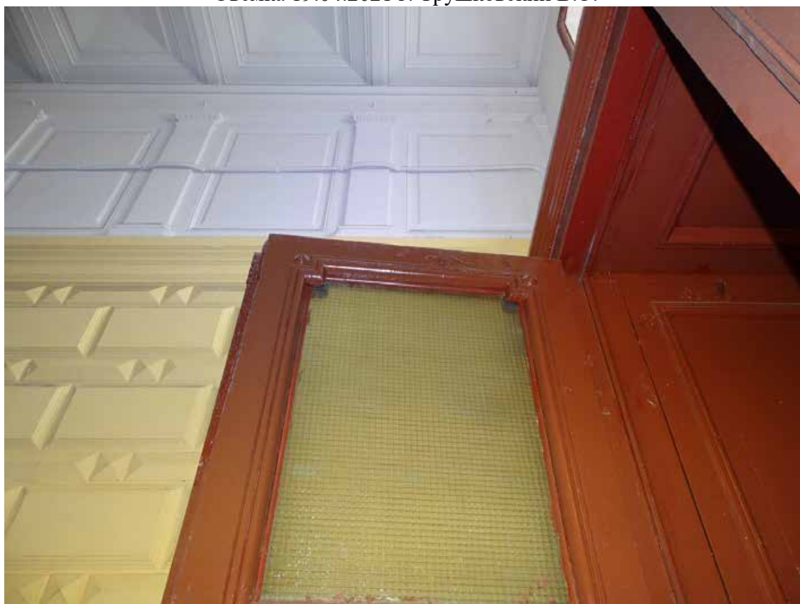
Фото 68. Лестница № 3. 1-й этаж. Вестибюль. Дверное заполнение. Съемка 19.04.2021 г. Трушковский В.Э.
