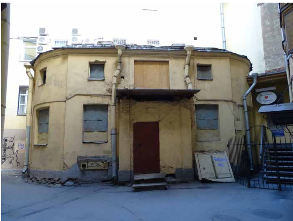
Фото 48. Здание по адресу: г. Санкт-Петербург, Тучков пер., 11/5, литера А. Северо-восточная служба 2-х этажная. Съемка 19.04.2021 г. Трушковский В.Э.
