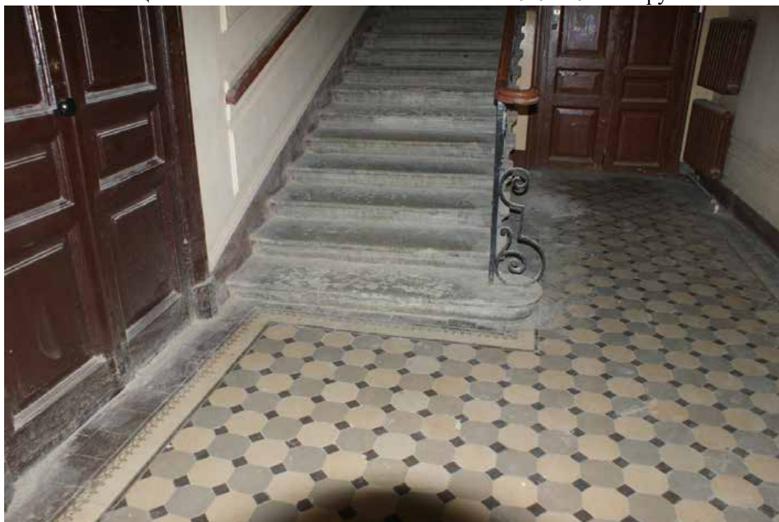
Фото 42. Лестница № 2. Вестибюль 1-го этажа. Покрытие пола. Съемка 19.04.2021 г. Трушковский В.Э.
