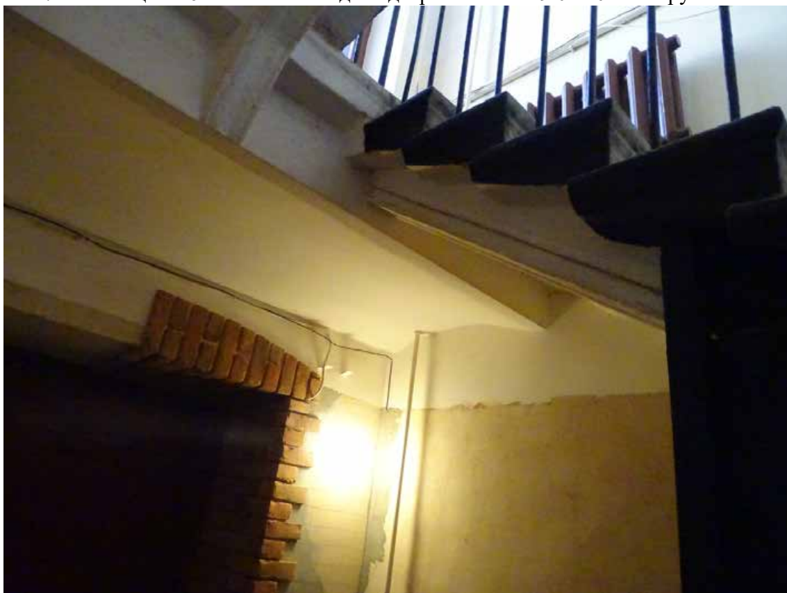
Фото 128. Лестница № 6. 1-й этаж. Съемка 19.04.2021 г. Трушковский В.Э.
