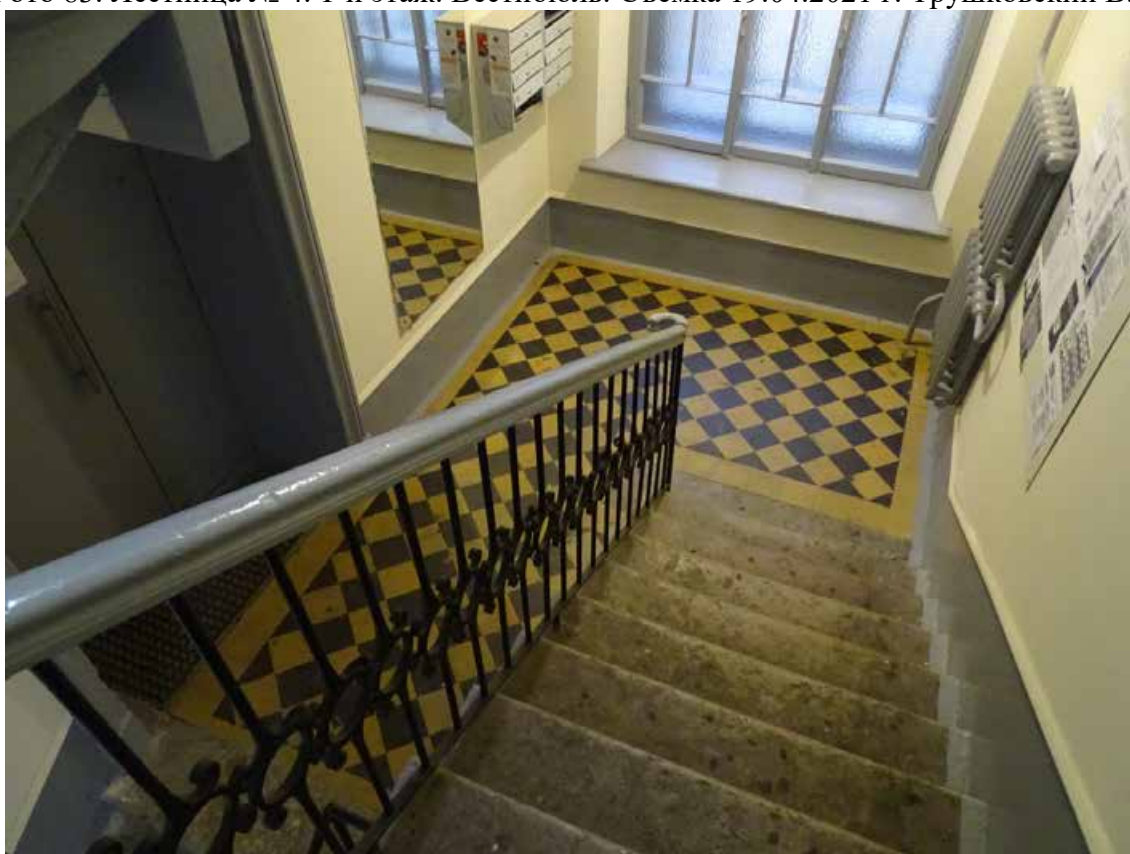
Фото 84. Лестница № 4. 1-й этаж. Вестибюль. Съемка 19.04.2021 г. Трушковский В.Э.
