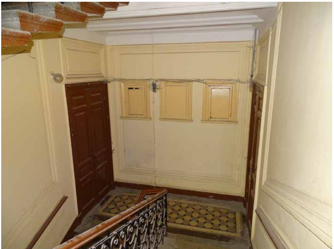
Фото 55. Лестница № 2. 3-й этаж. Съемка 19.04.2021 г. Трушковский В.Э.
