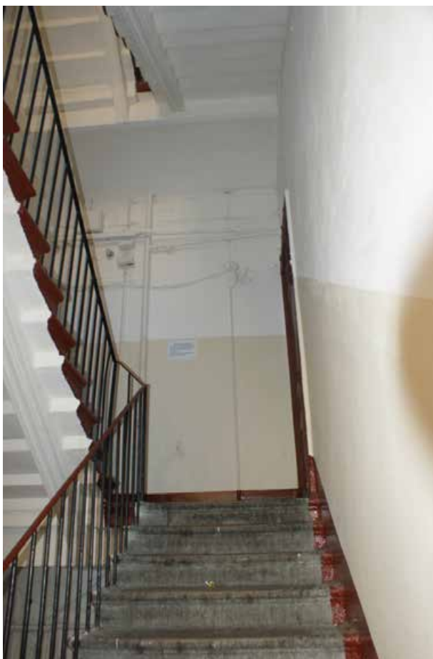
Фото 114. Лестница № 5. Площадка 2-го этажа. Съемка 19.04.2021 г. Трушковский В.Э.
