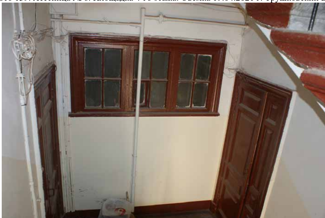
Фото 140. Лестница № 6. Площадка 4-го этажа. Съемка 19.04.2021 г. Трушковский В.Э.
