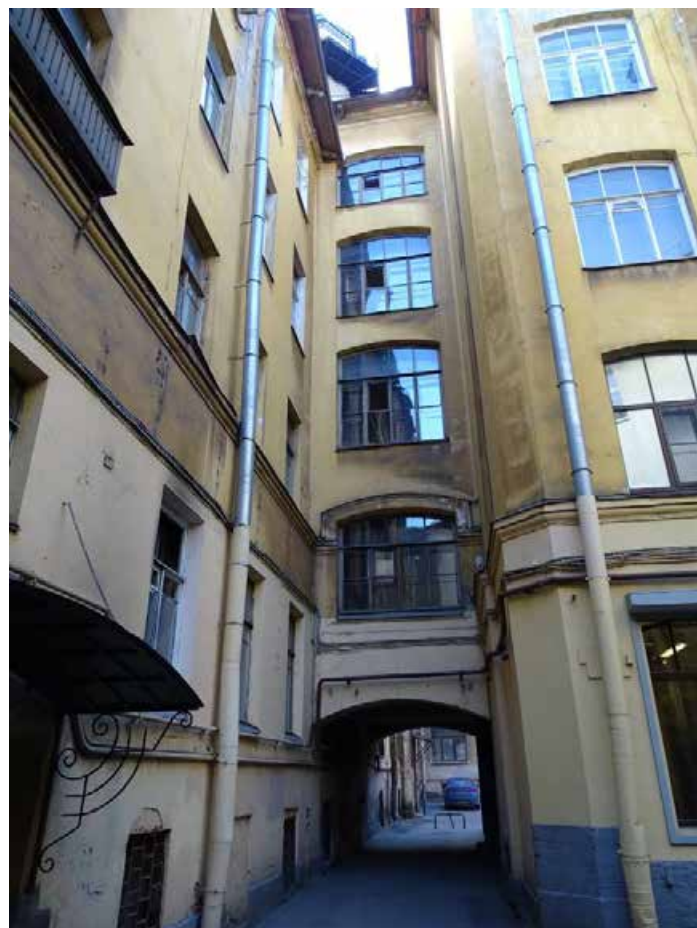
Фото 45. Здание по адресу: г. Санкт-Петербург, Тучков пер., 11/5, литера А. Фрагмент северо-восточного дворового фасада. Съемка 19.04.2021 г. Трушковский В.Э.
