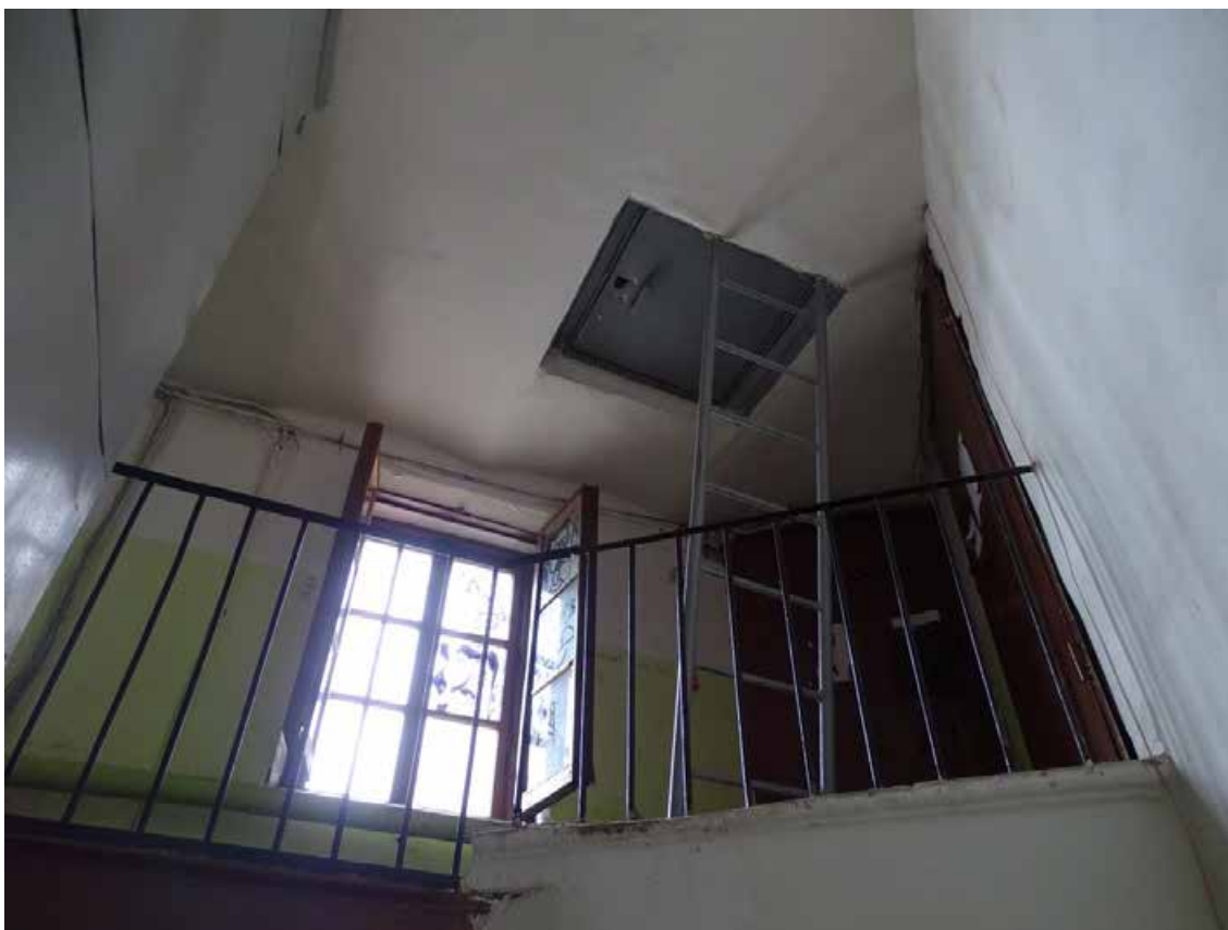
Фото 209. Лестница № 8. Площадка 6-го этажа. Съемка 19.04.2021 г. Трушковский В.Э.
