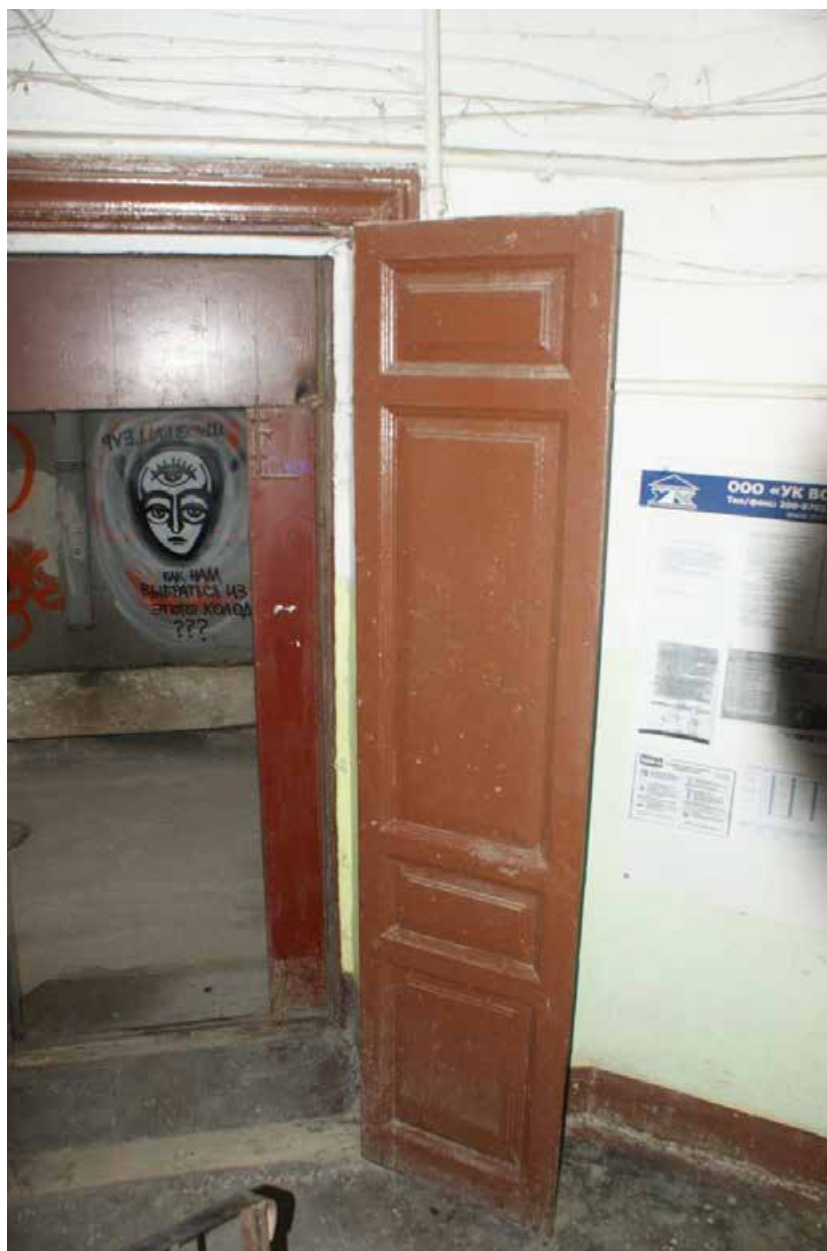
Фото 173. Лестница № 8. Вестибюль 1-го этажа. Входная дверь. Съемка 19.04.2021 г. Трушковский В.Э.
