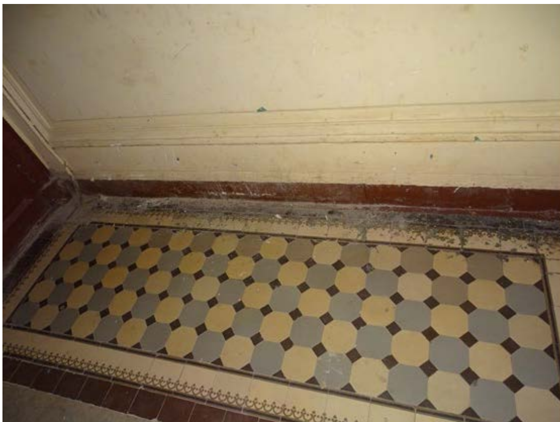
Фото 50. Лестница № 2. 2-й этаж. Покрытие пола. Съемка 19.04.2021 г. Трушковский В.Э.
