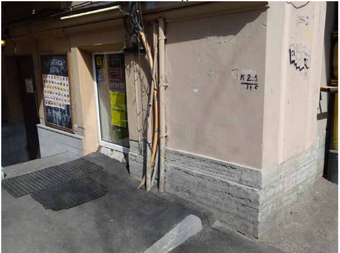
Фото 16. Здание по адресу: г. Санкт-Петербург, Тучков пер., 11/5, литера А. Фрагмент лицевого фасада со стороны Тучкова пер. Цоколь из известняка. Съемка 19.04.2021 г. Трушковский В.Э.
