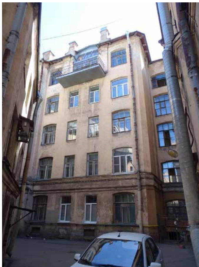
Фото 26. Здание по адресу: г. Санкт-Петербург, Тучков пер., 11/5, литера А. Дворовой фасад. Съемка 19.04.2021 г. Трушковский В.Э.
