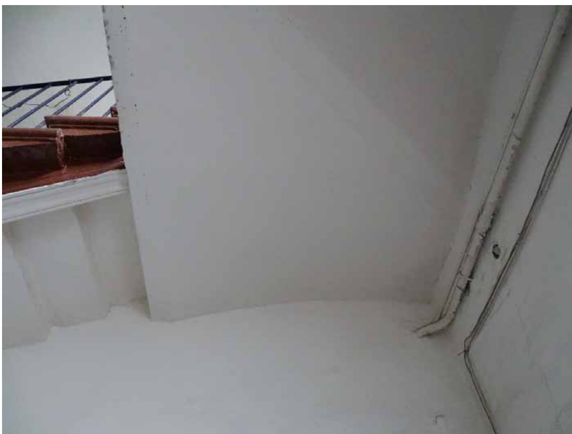
Фото 205. Лестница № 7. Площадка 5-го этажа. Съемка 19.04.2021 г. Трушковский В.Э.
