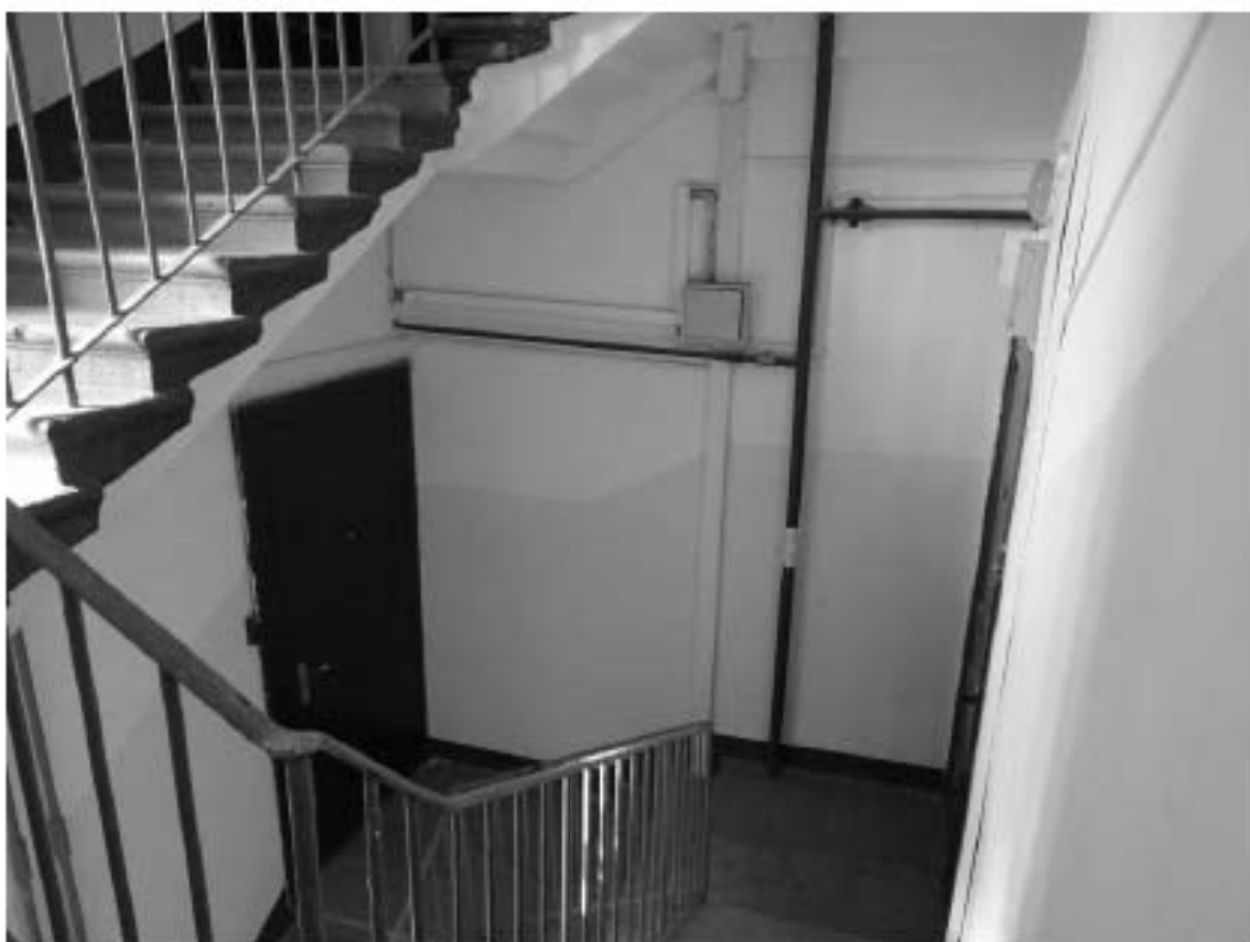
Фото 103. Лестница № 2. Площадка 5-го этажа. Съемка 26.04.2021 г. Михайловская Г. В.
