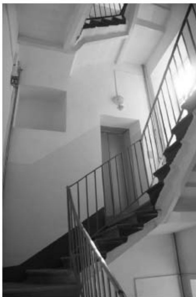
Фото 96. Лестница № 2. Площадка между 2-м и 3-м этажом. Съемка 26.04.2021 г. Михайловская Г. В.
