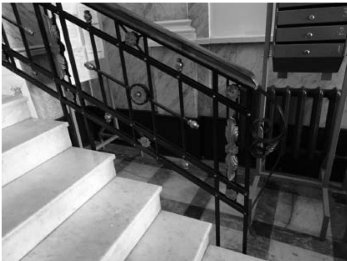
Фото 12. Лестница № 1. Вестибюль. 1-й этаж. Лестничное ограждение. Съемка 26.04.2021 г. Михайловская Г. В.
