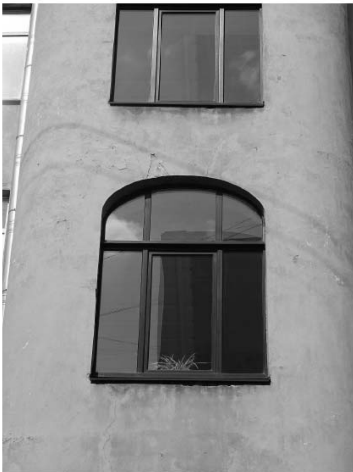
Фото 49. Фрагмент южного фасада. Ризалит. 3-й этаж. Съемка 26.04.2021 г. Михайловская Г. В.
