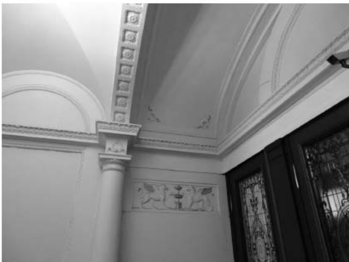
Фото 115. Лестница № 3. Вестибюль 1-й этаж. Съемка 26.04.2021 г. Михайловская Г. В.
