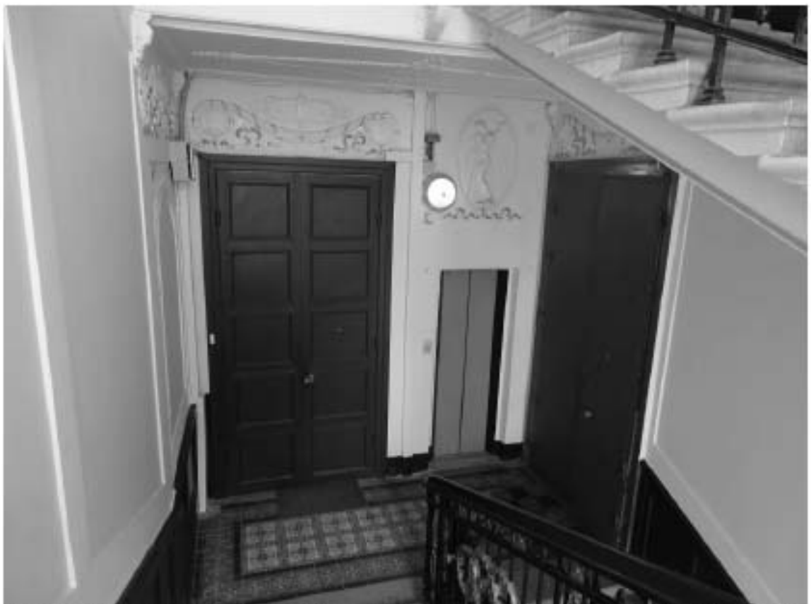
Фото 137. Лестница № 3. Площадка 2-го этажа. Съемка 26.04.2021 г. Михайловская Г. В.
