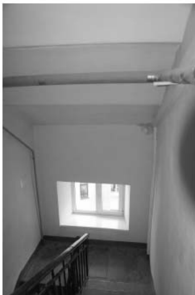
Фото 209. Лестница № 4. Площадка между 6-м чердачным этажом. Съемка 26.04.2021 г. Михайловская Г. В.
