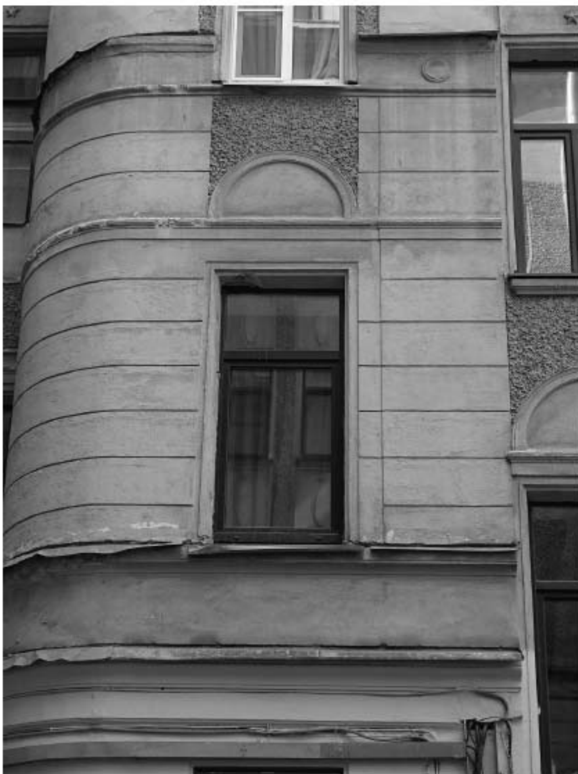
Фото 45. Фрагмент западного фасада внутреннего двора. 2-й этаж. Съемка 26.04.2021 г. Михайловская Г. В.
