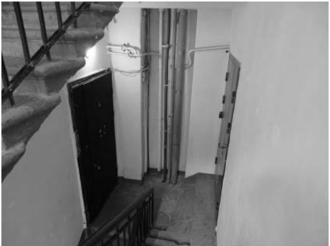
Фото 196. Лестница № 4. Площадка 3-го этажа. Съемка 26.04.2021 г. Михайловская Г. В.
