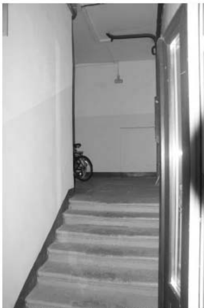
Фото 80. Лестница № 2. 1-й этаж. Съемка 26.04.2021 г. Михайловская Г. В.
