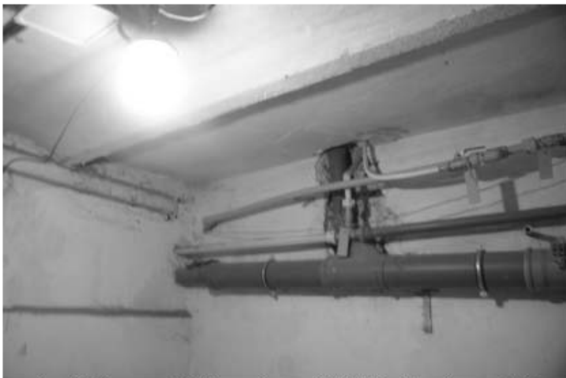
Фото 88. Лестница № 2. Подвал. Съёмка 26.04.2021 г. Михайловская Г. В.
