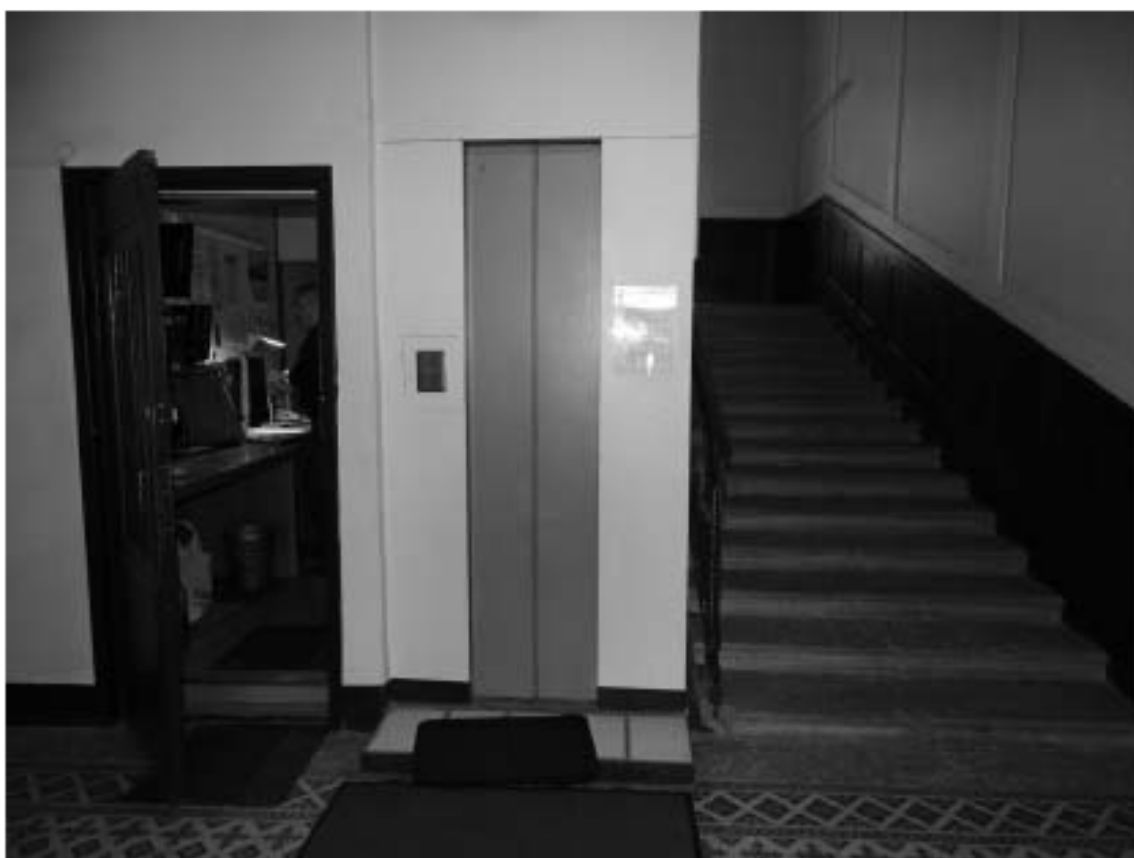
Фото 19. Лестница № 1. Площадка 1-го этажа. Съемка 26.04.2021 г. Михайловская Г. В.
