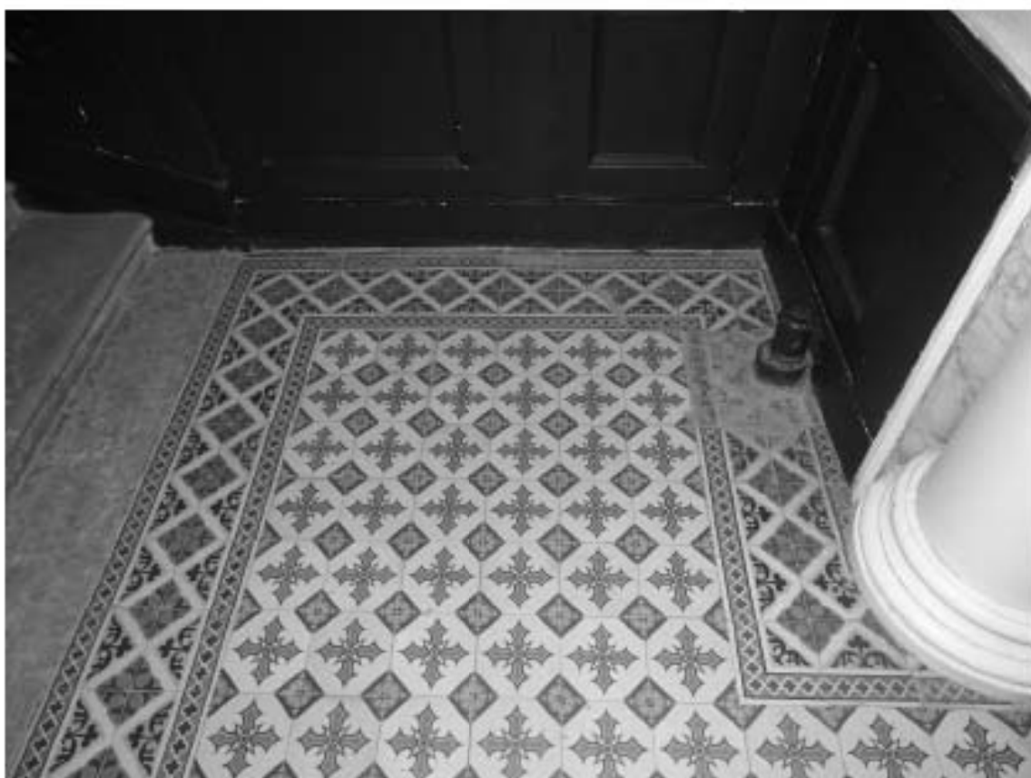
Фото 20. Лестница № 1. Площадка 1-го этажа. Покрытие пола. Съемка 26.04.2021 г. Михайловская Г. В.
