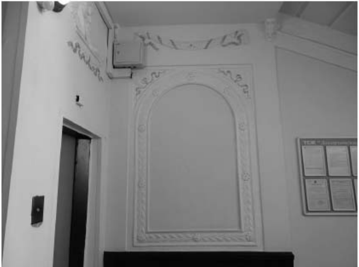
Фото 128. Лестница № 3. Площадка 1-го этажа. Панно с полуциркульным завершением. Съемка 26.04.2021 г. Михайловская Г. В.
