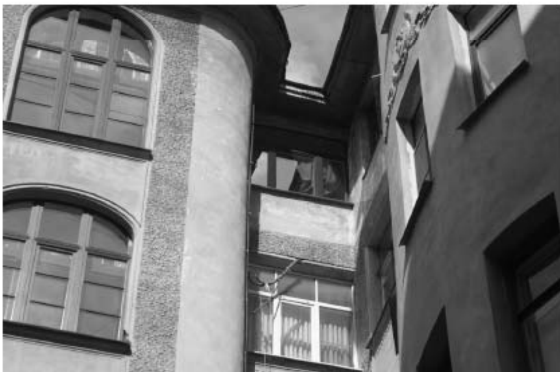
Фото 31. Фрагмент северного фасада внутреннего двора. 5-й и 6-й этажи. Съемка 26.04.2021 г. Михайловская Г. В.
