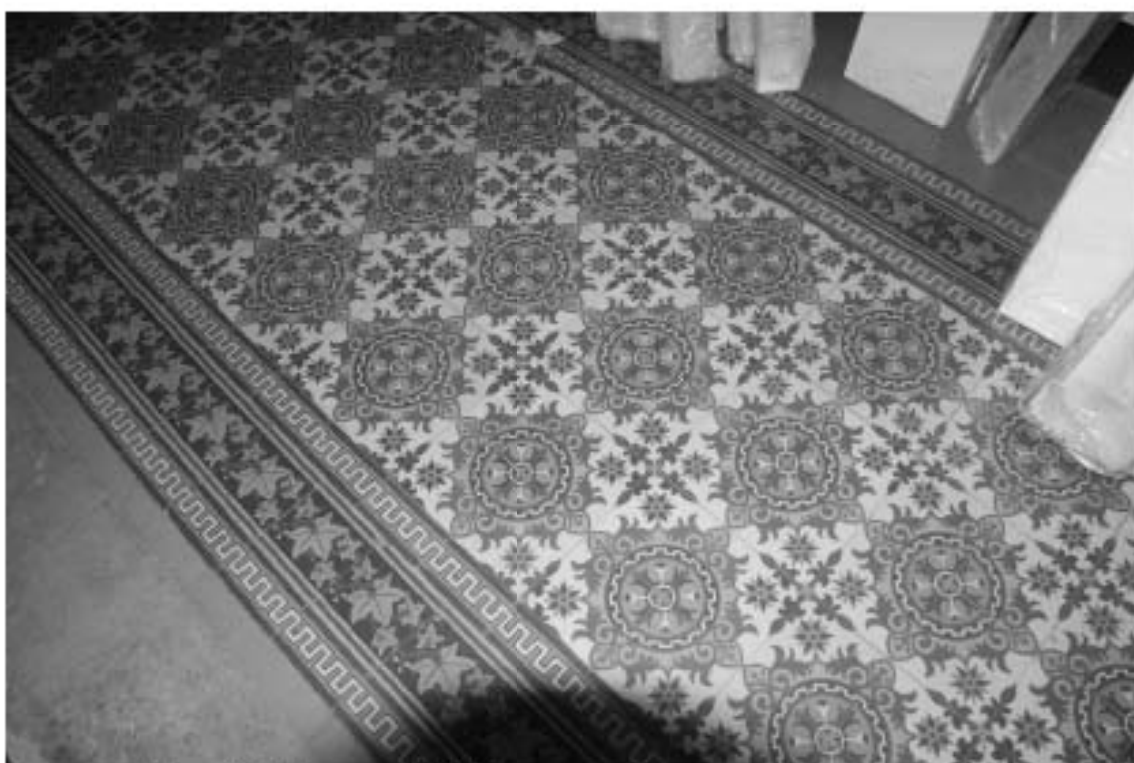
Фото 78. Лестница № 1. Площадка 6-го этажа. Покрытие пола. Съемка 26.04.2021 г. Михайловская Г. В.
