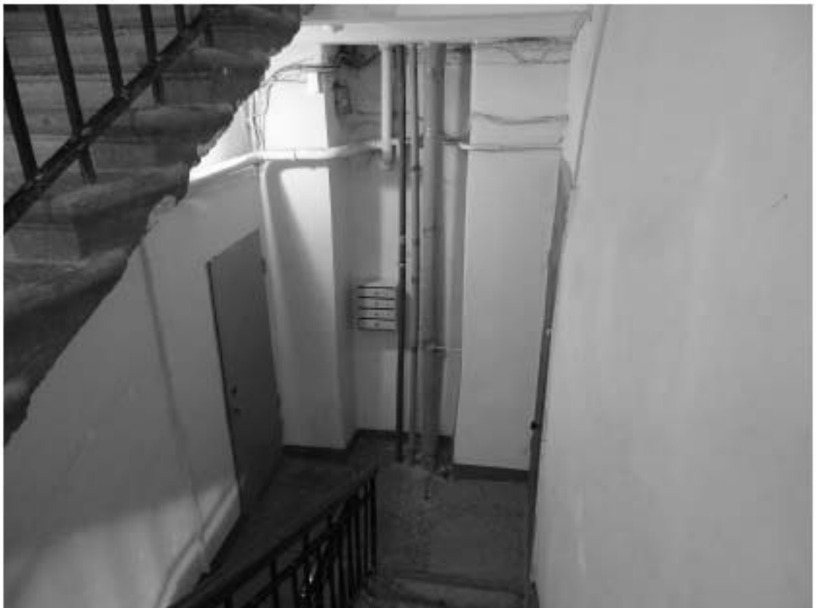
Фото 189. Лестница № 4. Площадка 1-го этажа. Съемка 26.04.2021 г. Михайловская Г. В.
