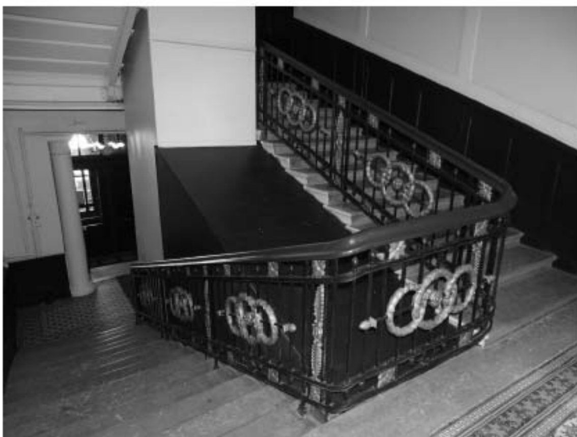
Фото 23. Лестница № 1. Площадка между 1-м и 2-м этажом. Лестничное ограждение. Съемка 26.04.2021 г. Михайловская Г. В.
