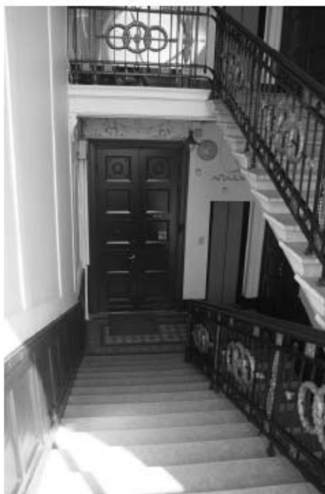
Фото 172. Лестница № 3. Площадка 5-го этажа. Съемка 26.04.2021 г. Михайловская Г. В.
