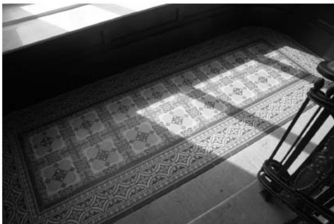
Фото 158. Лестница № 3. Площадка между 3-м и 4-м этажом. Покрытие пола. Съемка 26.04.2021 г. Михайловская Г. В.
