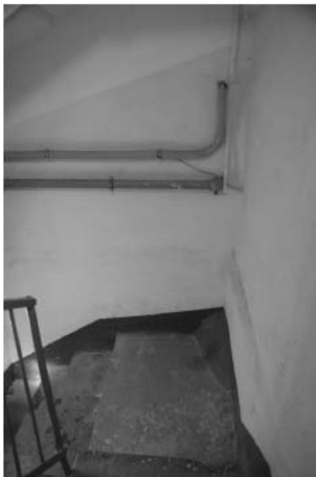
Фото 82. Лестница № 2. Спуск в подвал. Съемка 26.04.2021 г. Михайловская Г. В.
