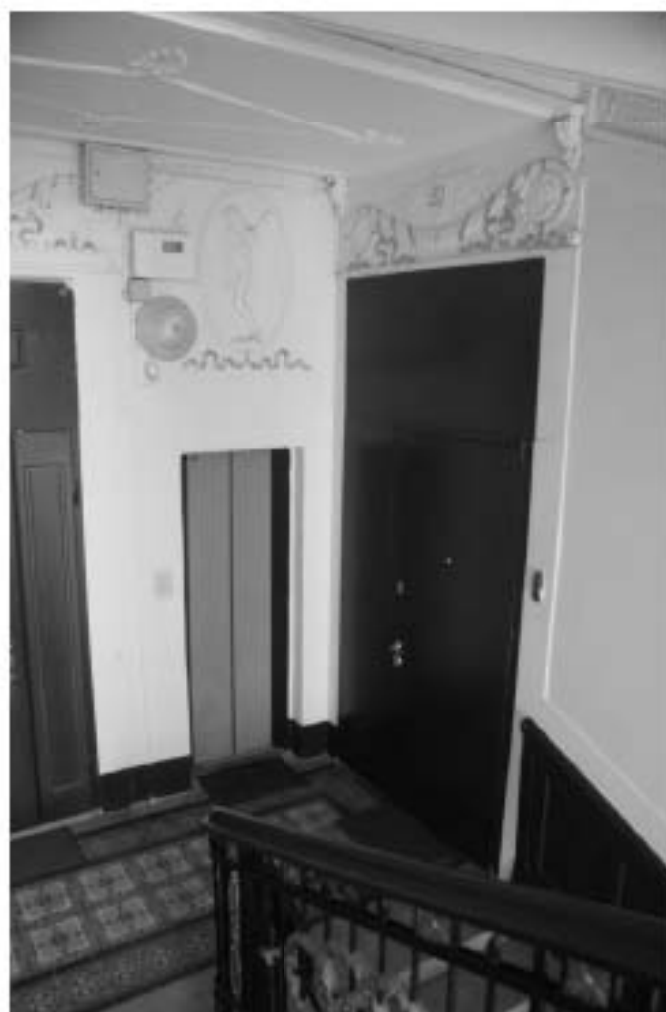
Фото 162. Лестница № 3. Площадка 4-го этажа. Съемка 26.04.2021 г. Михайловская Г. В.
