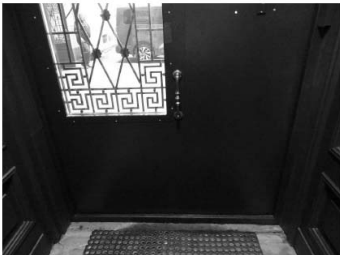
Фото 113. Лестница № 3. Тамбур. Съемка 26.04.2021 г. Михайловская Г. В.
