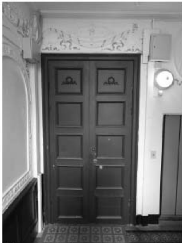
Фото 151. Лестница № 3. Площадка 3-го этажа. Дверной проем. Съемка 26.04.2021 г. Михайловская Г. В.
