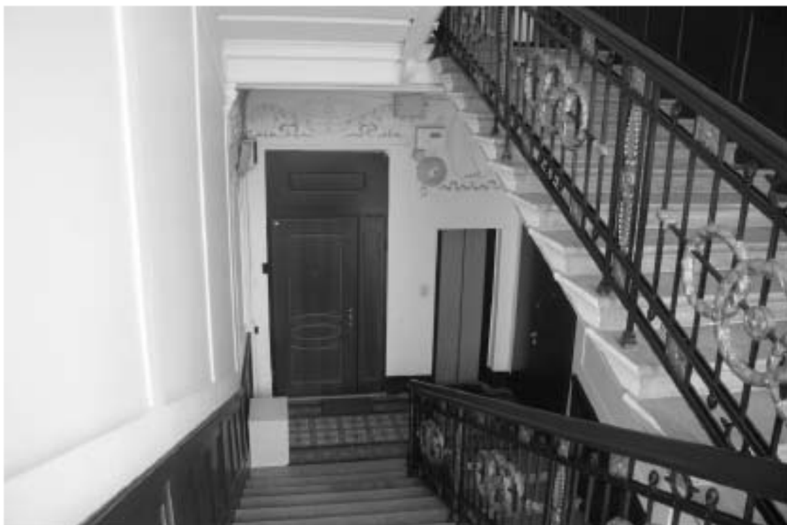
Фото 161. Лестница № 3. Площадка 4-го этажа. Съемка 26.04.2021 г. Михайловская Г. В.
