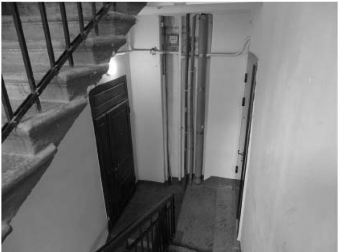
Фото 199. Лестница № 4. Площадка 4-го этажа. Съемка 26.04.2021 г. Михайловская Г. В.
