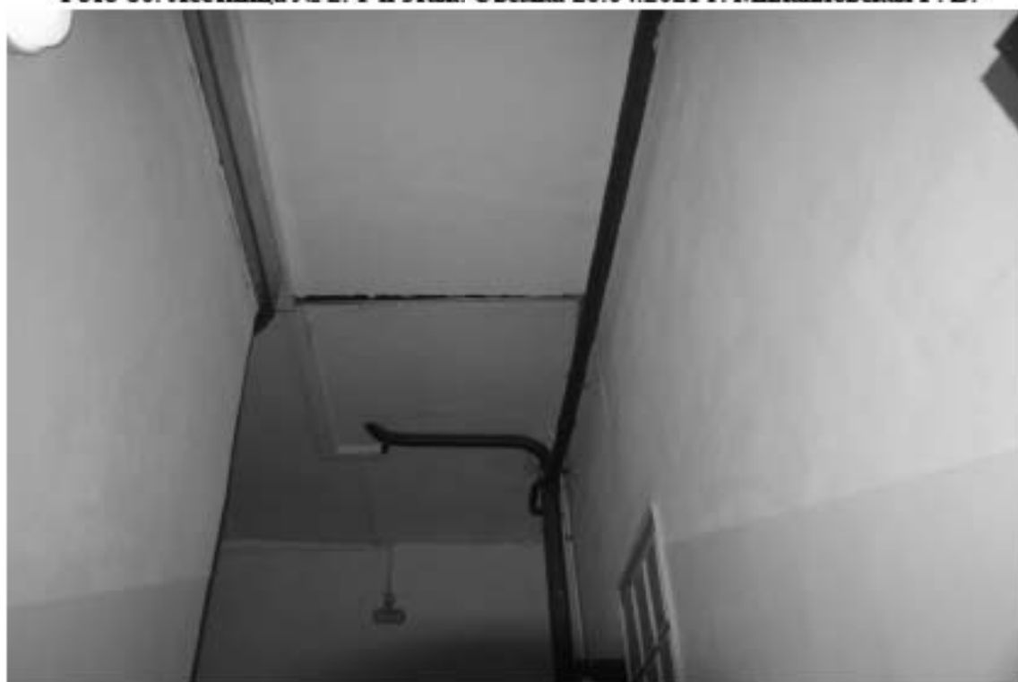
Фото 81. Лестница № 2. 1-й этаж. Оформление перекрытия. Съемка 26.04.2021 г. Михайловская Г. В.
