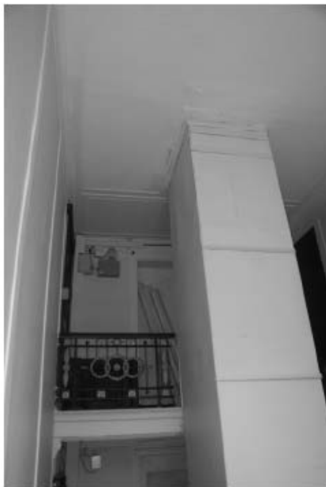
Фото 74. Лестница № 1. Площадка 6-го этажа. Съемка 26.04.2021 г. Михайловская Г. В.
