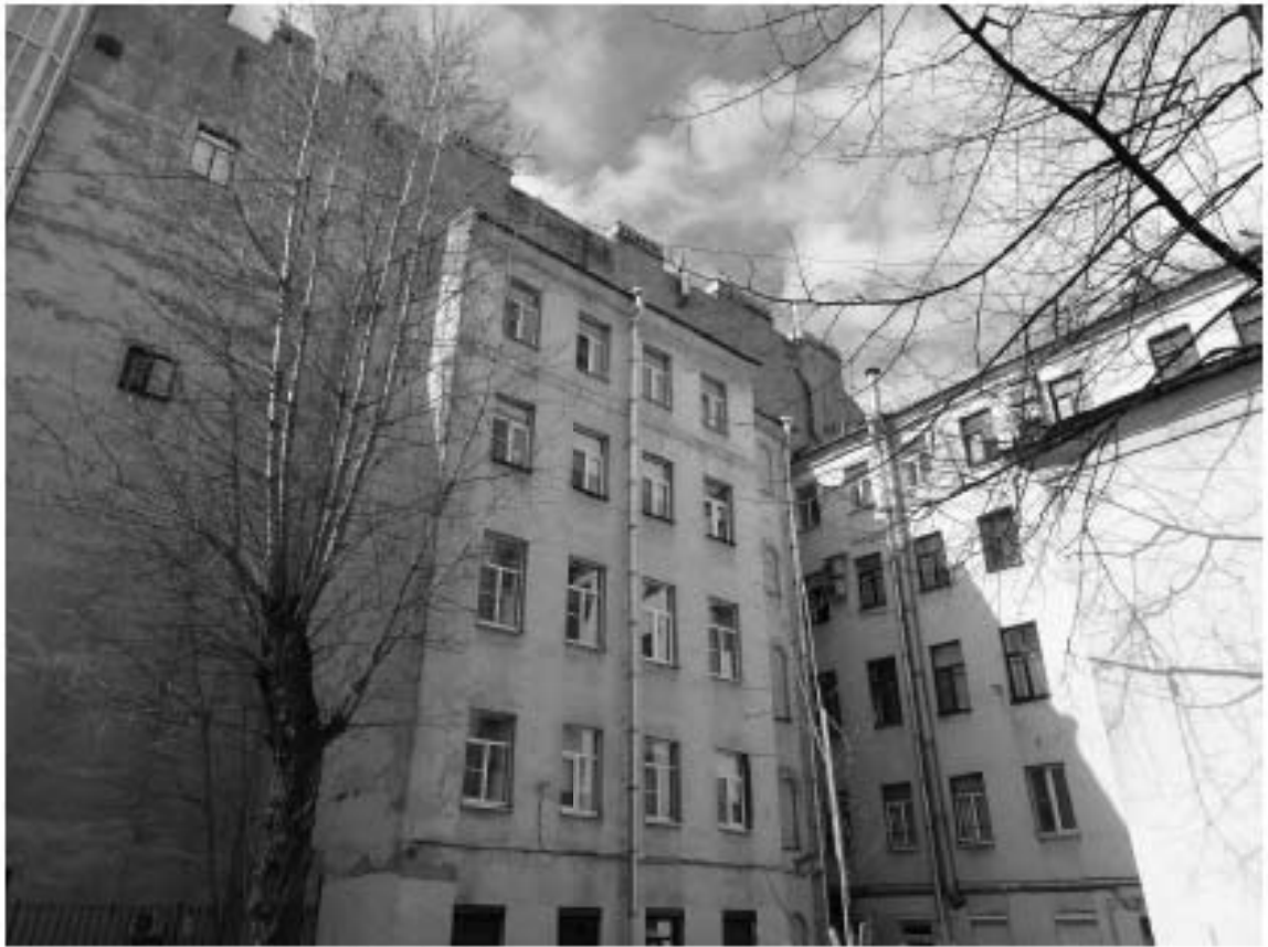
Фото 54. Фрагмент восточного фасада. Съемка 26.04.2021 г. Михайловская Г. В.
