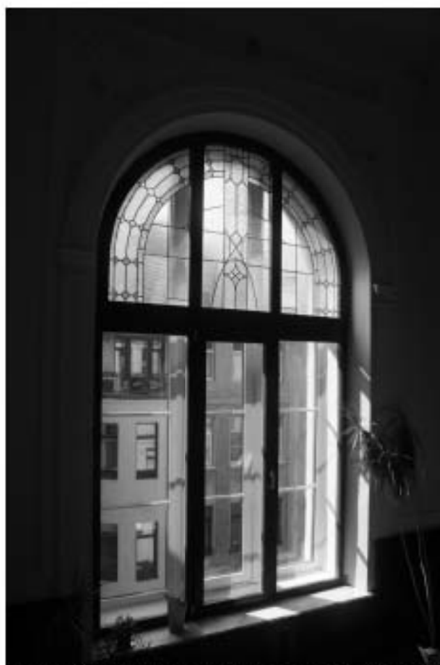
Фото 72. Лестница № 1. Площадка между 5-м и 6-м этажом. Заполнение оконных проемов. Съемка 26.04.2021 г. Михайловская Г. В.
