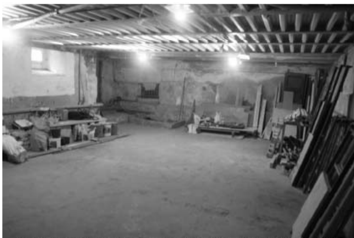
Фото 85. Лестница № 2. Подвал. Съемка 26.04.2021 г. Михайловская Г. В.
