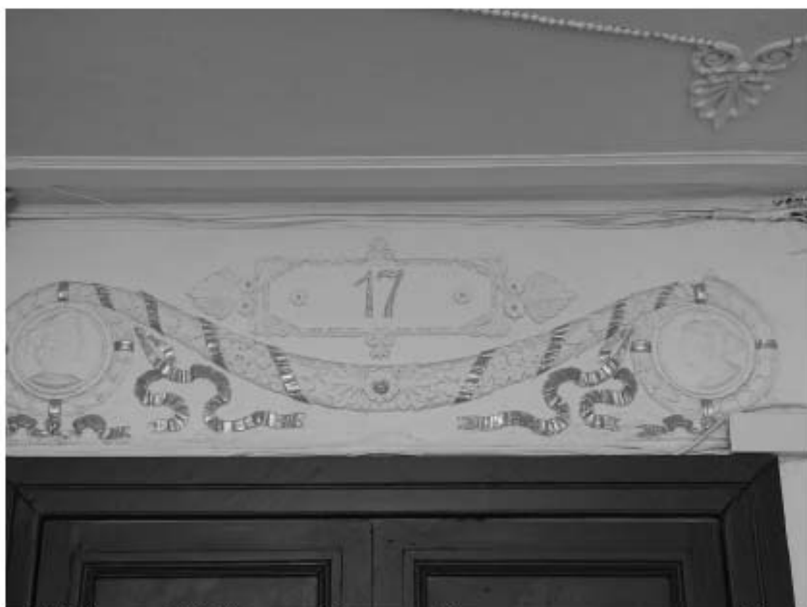
Фото 139. Лестница № 3. Площадка 2-го этажа. Лепные композиции над входной дверью. Съемка 26.04.2021 г. Михайловская Г. В.
