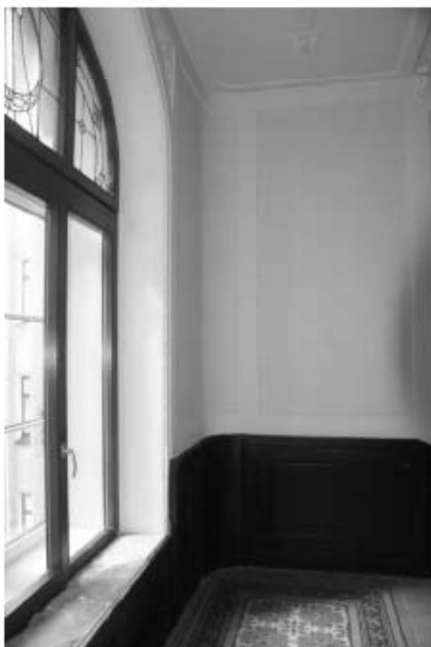
Фото 62. Лестница № 1. Площадка между 4-м и 5-м этажом. Оформление стен лестничных маршей. Съемка 26.04.2021 г. Михайловская Г. В.
