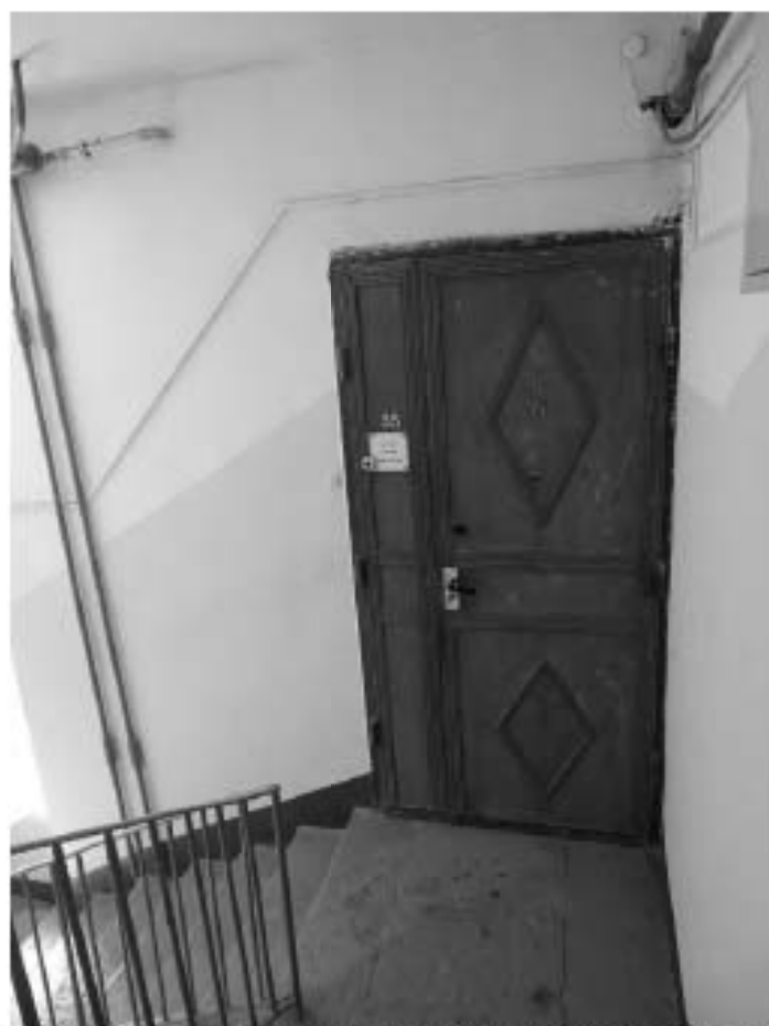
Фото 109. Лестница № 2. Площадка 7-го этажа. Съемка 26.04.2021 г. Михайловская Г. В.
