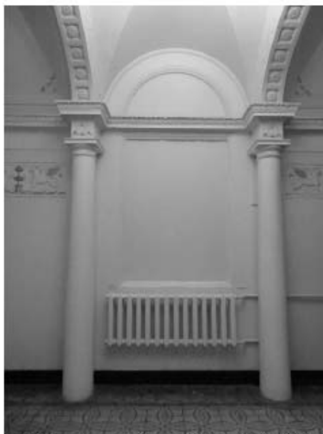
Фото 117. Лестница № 3. Вестибюль 1-й этаж. Съемка 26.04.2021 г. Михайловская Г. В.
