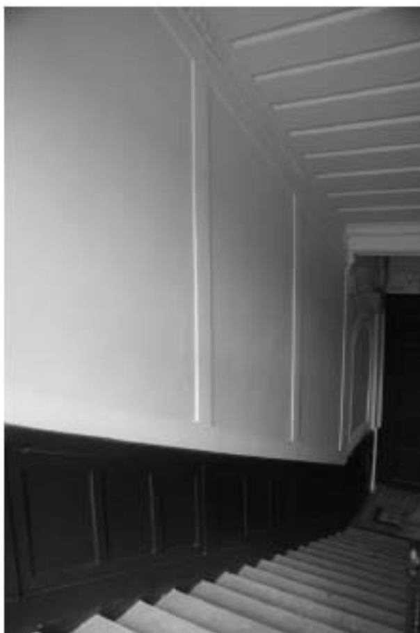
Фото 160. Лестница № 3. Площадка между 3-м и 4-м этажом. Оформление стен лестничных маршей. Съемка 26.04.2021 г. Михайловская Г. В.
