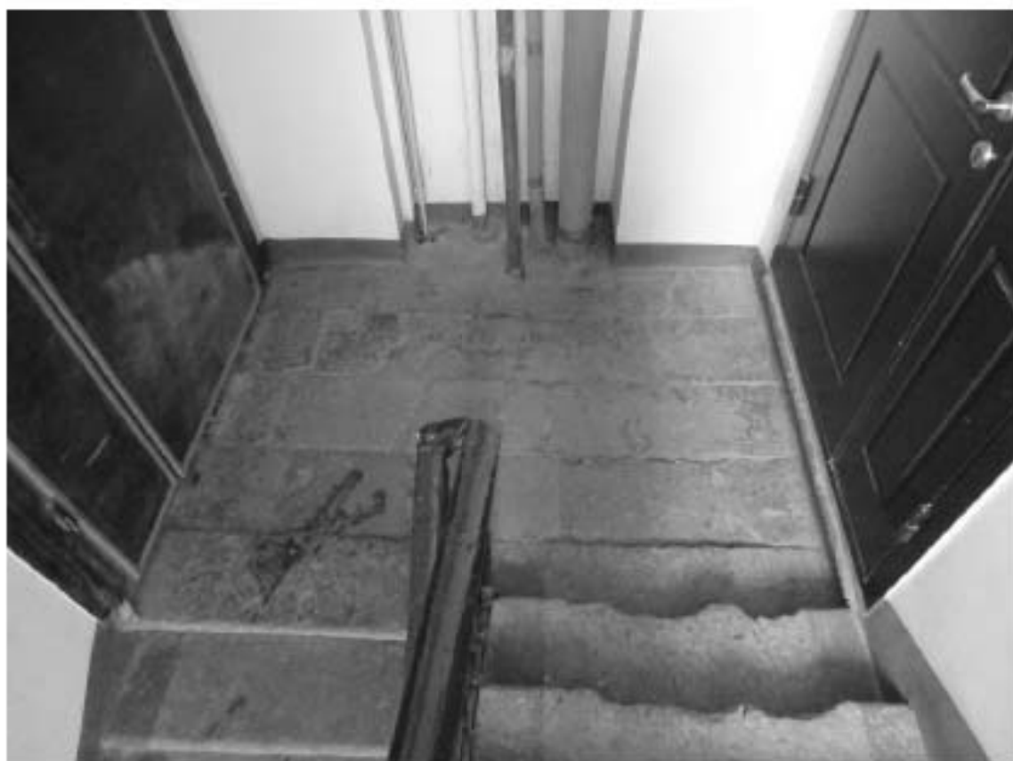
Фото 203. Лестница № 4. Площадка 5-го этажа. Съемка 26.04.2021 г. Михайловская Г. В.
