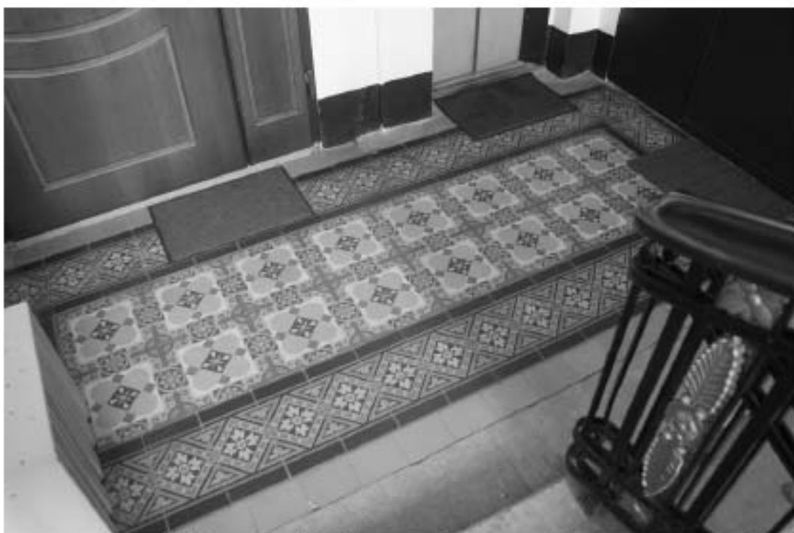
Фото 167. Лестница № 3. Площадка 4-го этажа. Покрытие пола. Съемка 26.04.2021 г. Михайловская Г. В.
