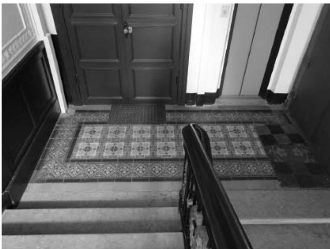
Фото 143. Лестница № 3. Площадка 2-го этажа. Покрытие пола. Съемка 26.04.2021 г. Михайловская Г. В.
