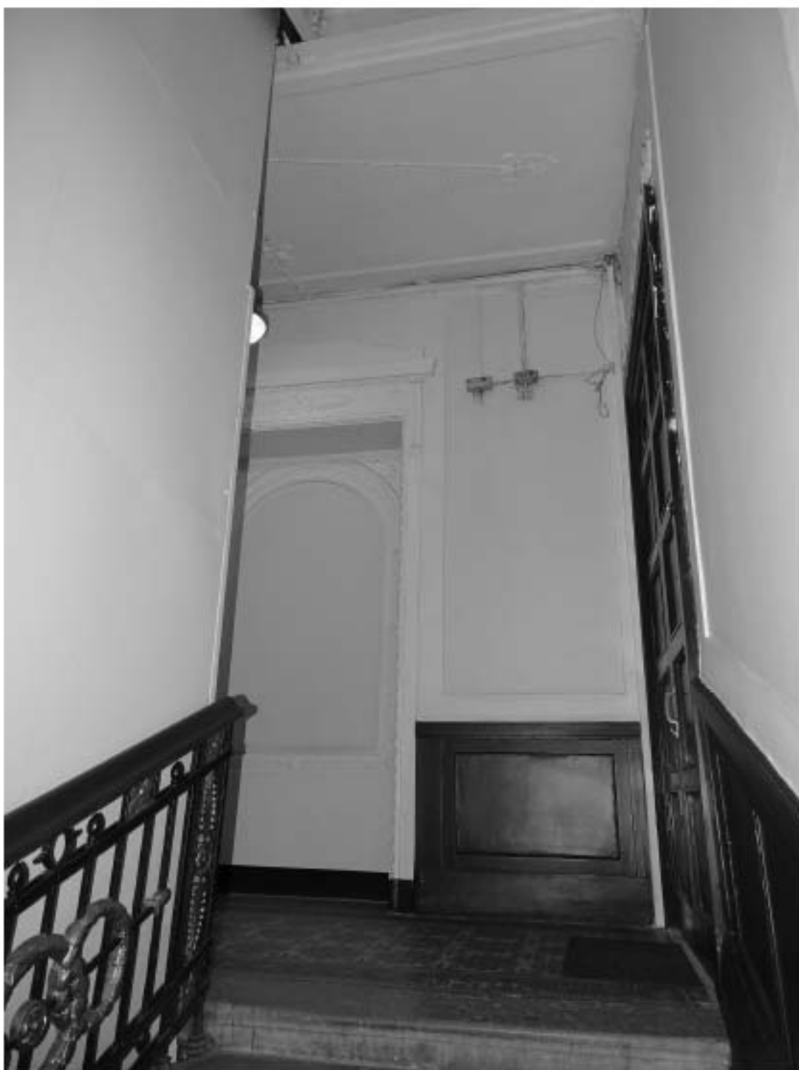
Фото 30. Лестница № 1. Площадка 2-го этажа. Съемка 26.04.2021 г. Михайловская Г. В.
