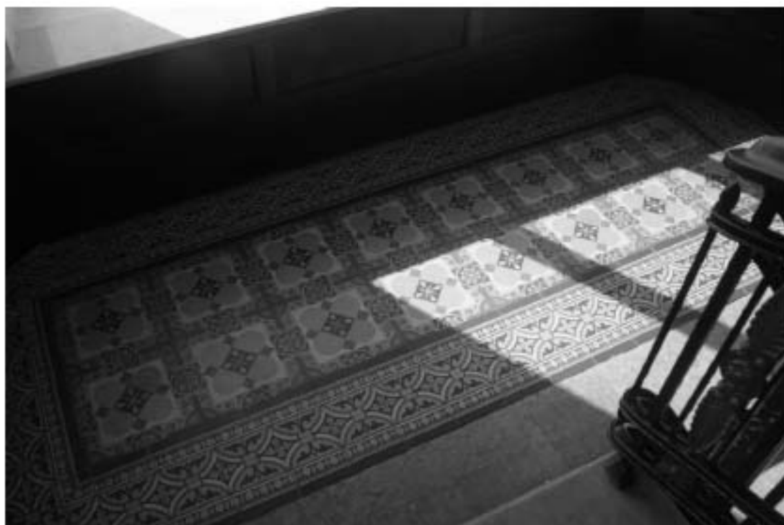
Фото 178. Лестница № 3. Площадка между 5-м и 6-м этажом. Покрытие пола. Съемка 26.04.2021 г. Михайловская Г. В.
