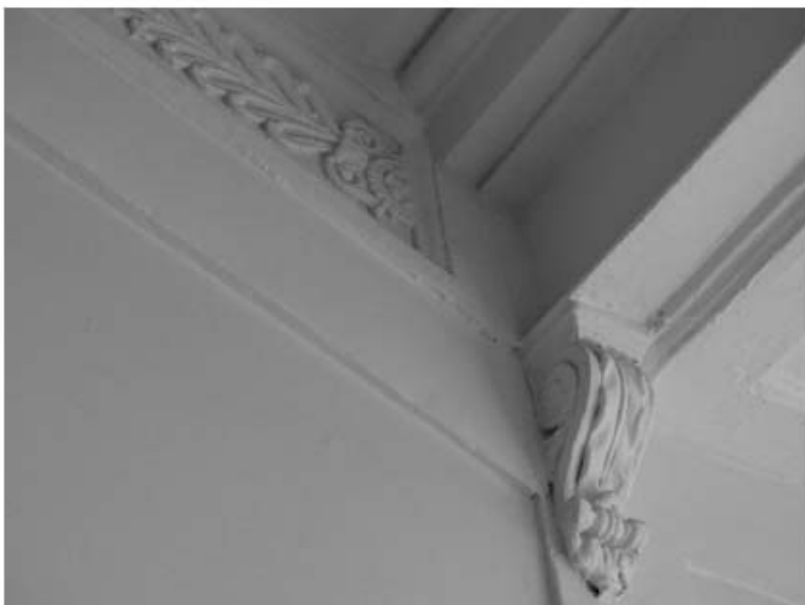
Фото 148. Лестница № 3. Площадка между 2-м и 3-м этажом. Кронштейн. Съемка 26.04.2021 г. Михайловская Г. В.
