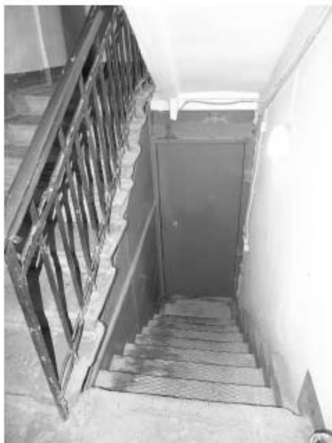
Фото 186. Лестница № 4. Дверь в подвал. Съемка 26.04.2021 г. Михайловская Г. В.
