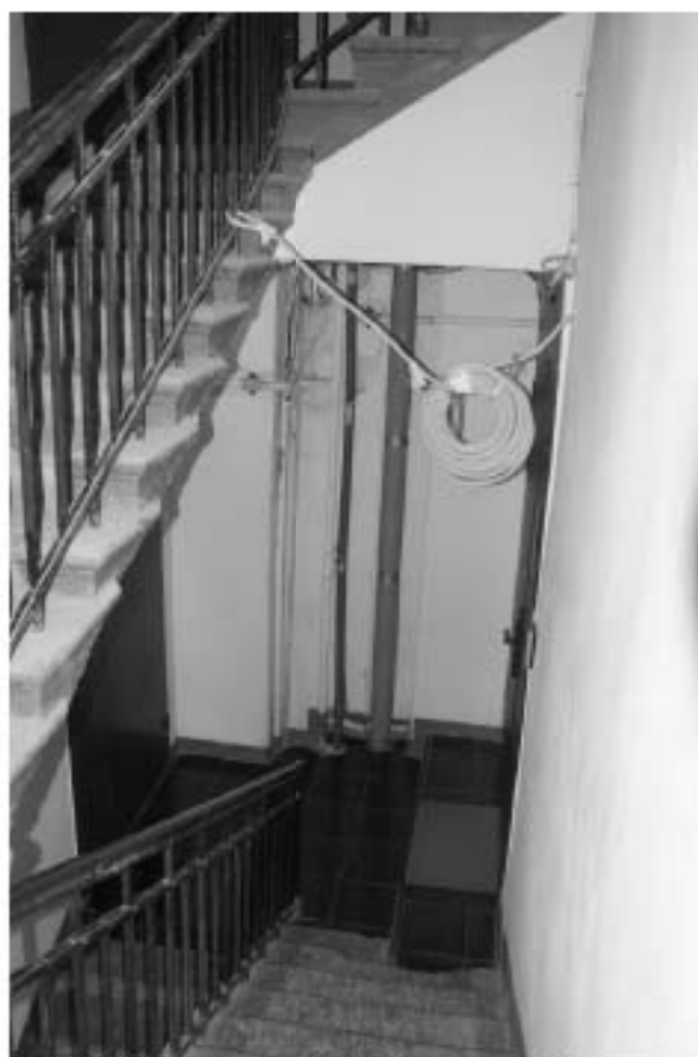
Фото 206. Лестница № 4. Площадка 6-го этажа. Съемка 26.04.2021 г. Михайловская Г. В.
