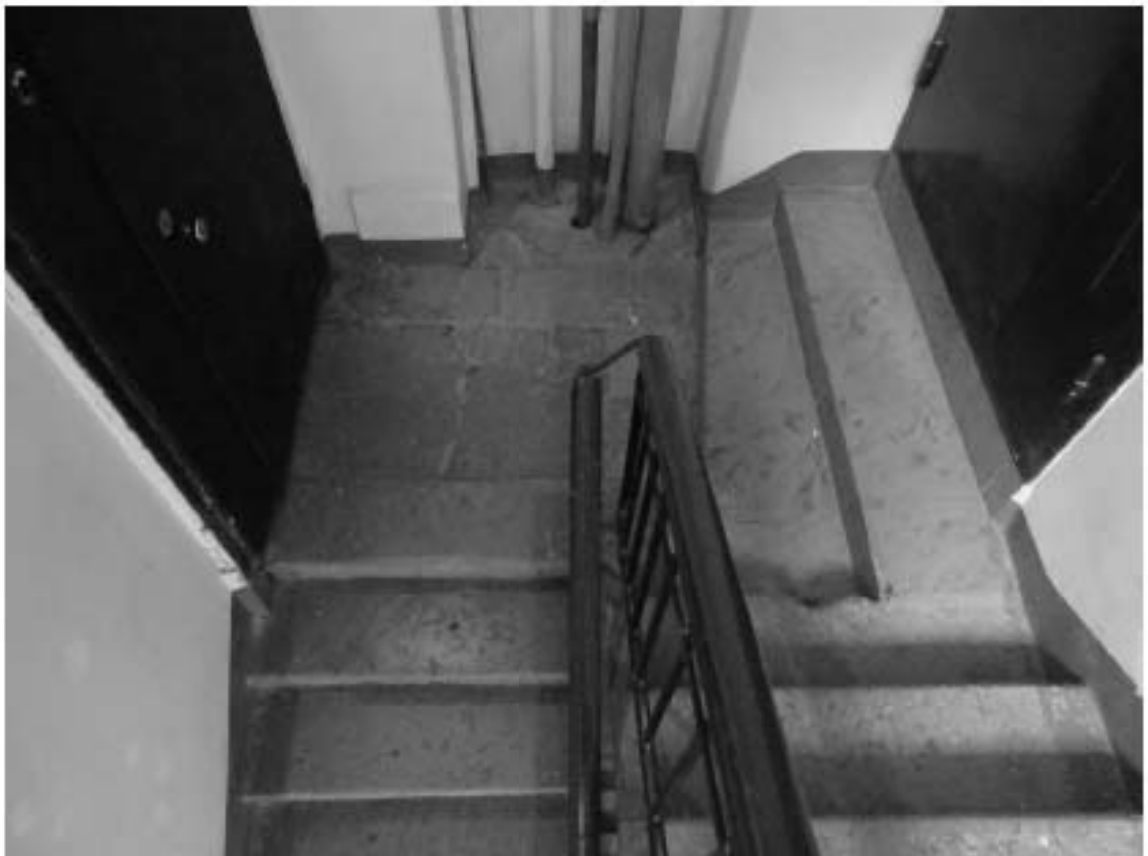
Фото 197. Лестница № 4. Площадка 3-го этажа. Съемка 26.04.2021 г. Михайловская Г. В.
