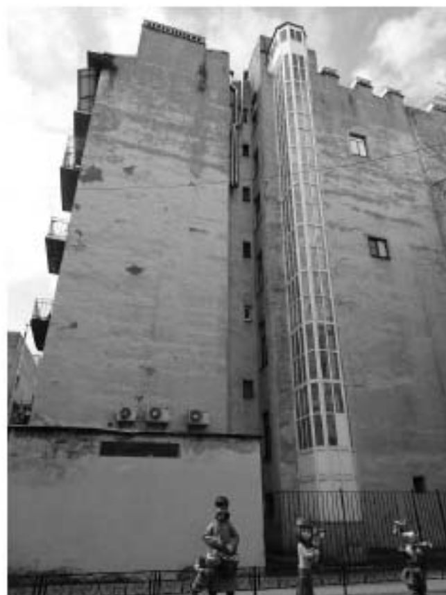
Фото 53. Фрагмент восточного фасада. Съемка 26.04.2021 г. Михайловская Г. В.
