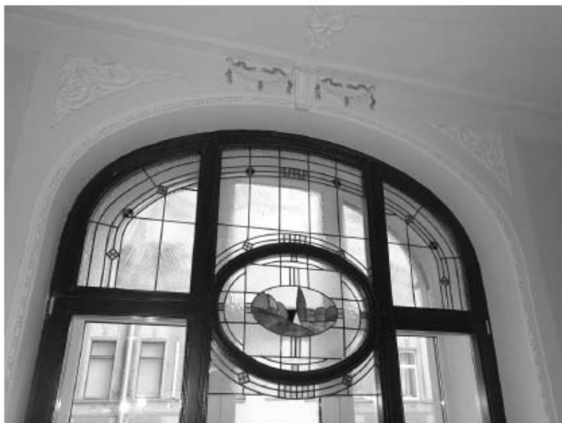
Фото 38. Лестница № 1. Площадка между 2-м и 3-м этажом. Витражи оконных проемов. Съемка 26.04.2021 г. Михайловская Г. В.
