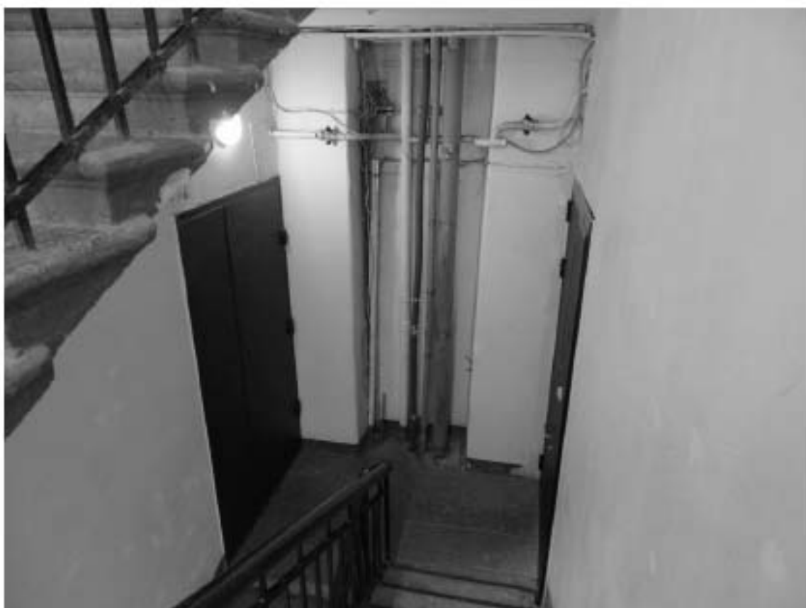
Фото 193. Лестница № 4. Площадка 2-го этажа. Съемка 26.04.2021 г. Михайловская Г. В.
