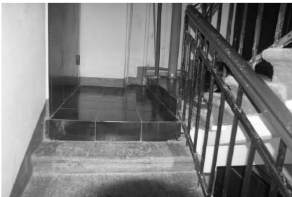
Фото 208. Лестница № 4. Площадка 6-го этажа. Съемка 26.04.2021 г. Михайловская Г. В.
