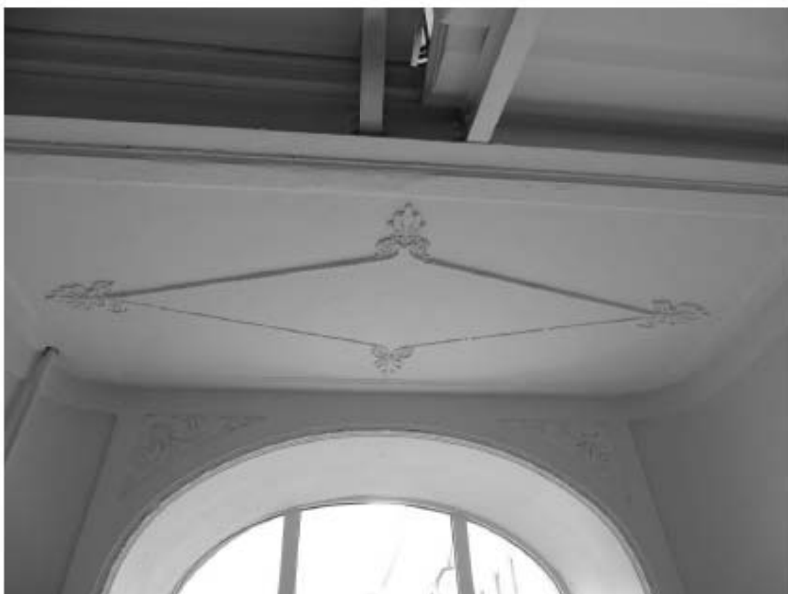
Фото 146. Лестница № 3. Площадка между 2-м и 3-м этажом. Оформление плафонов лестничных площадок. Съемка 26.04.2021 г. Михайловская Г. В.
