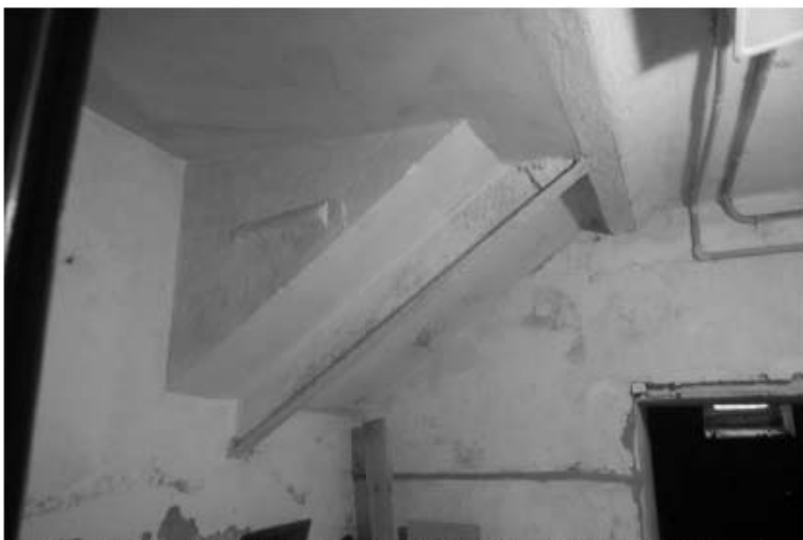
Фото 87. Лестница № 2. Подвал. Съемка 26.04.2021 г. Михайловская Г. В.
