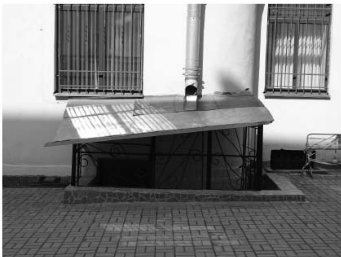
Фото 51. Фрагмент южного фасада. Приемок. Съемка 26.04.2021 г. Михайловская Г. В.
