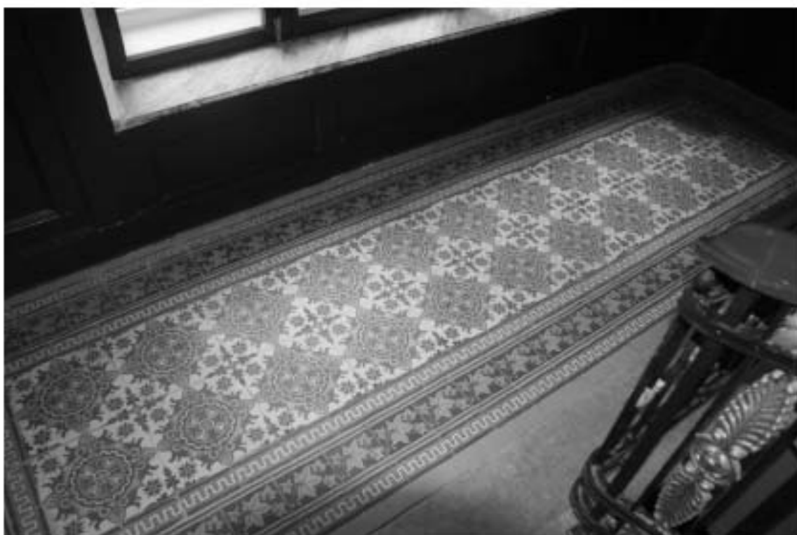
Фото 51. Лестница № 1. Площадка между 3-м и 4-м этажом. Покрытие пола. Съемка 26.04.2021 г. Михайловская Г. В.
