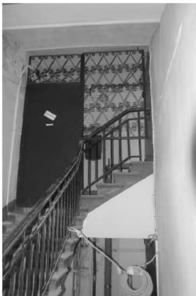
Фото 211. Лестница № 4. Чердачный этаж. Съемка 26.04.2021 г. Михайловская Г. В.
