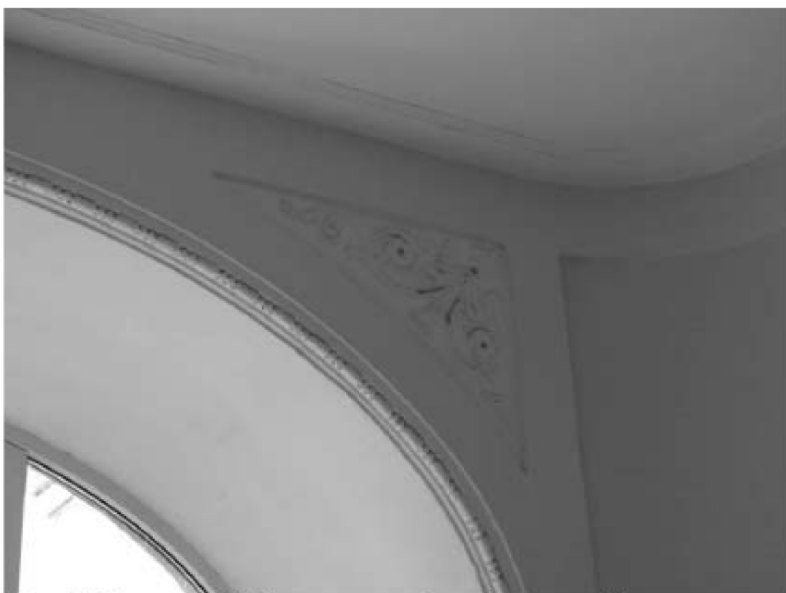
Фото 147. Лестница № 3. Площадка между 2-м и 3-м этажом. Оформление стены. Съемка 26.04.2021 г. Михайловская Г. В.
