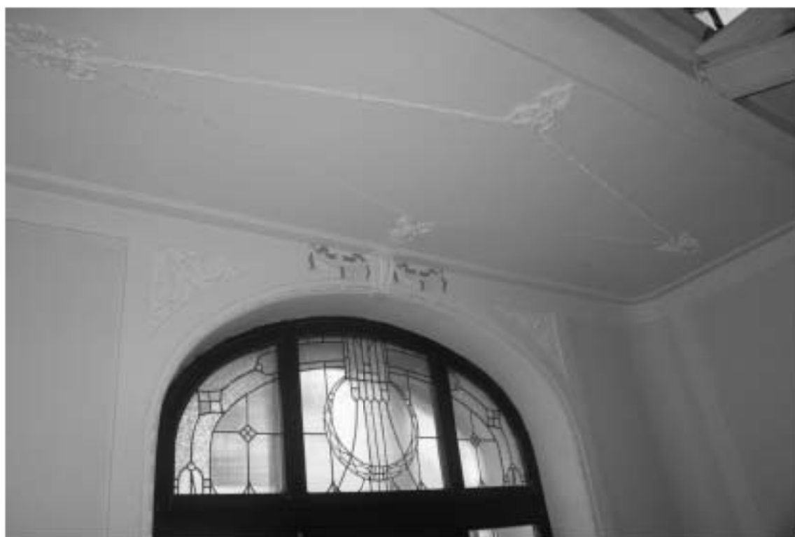
Фото 60. Лестница № 1. Площадка между 4-м и 5-м этажом. Заполнение оконных проемов. Съемка 26.04.2021 г. Михайловская Г. В.
