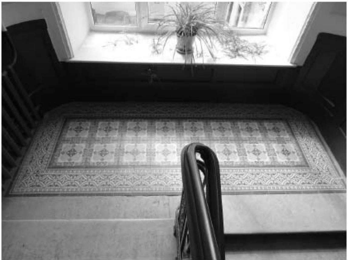
Фото 145. Лестница № 3. Площадка между 2-м и 3-м этажом. Покрытие пола. Съемка 26.04.2021 г. Михайловская Г. В.
