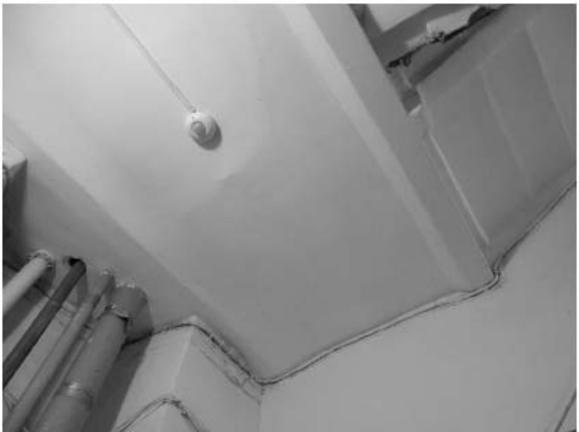
Фото 190. Лестница № 4. Площадка 1-го этажа. Лестничное перекрытие. Съемка 26.04.2021 г. Михайловская Г. В.
