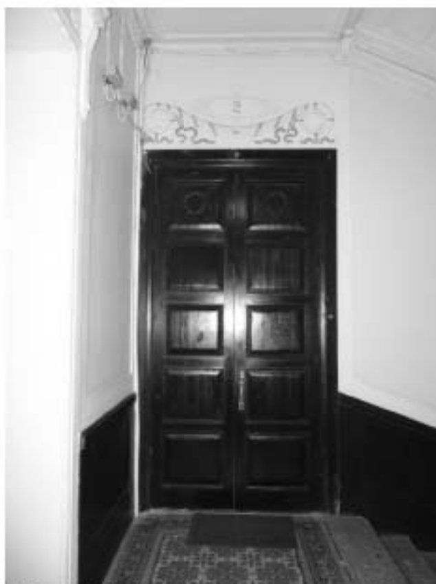
Фото 33. Лестница № 1. Площадка 2-го этажа. Входная дверь. Съемка 26.04.2021 г. Михайловская Г. В.
