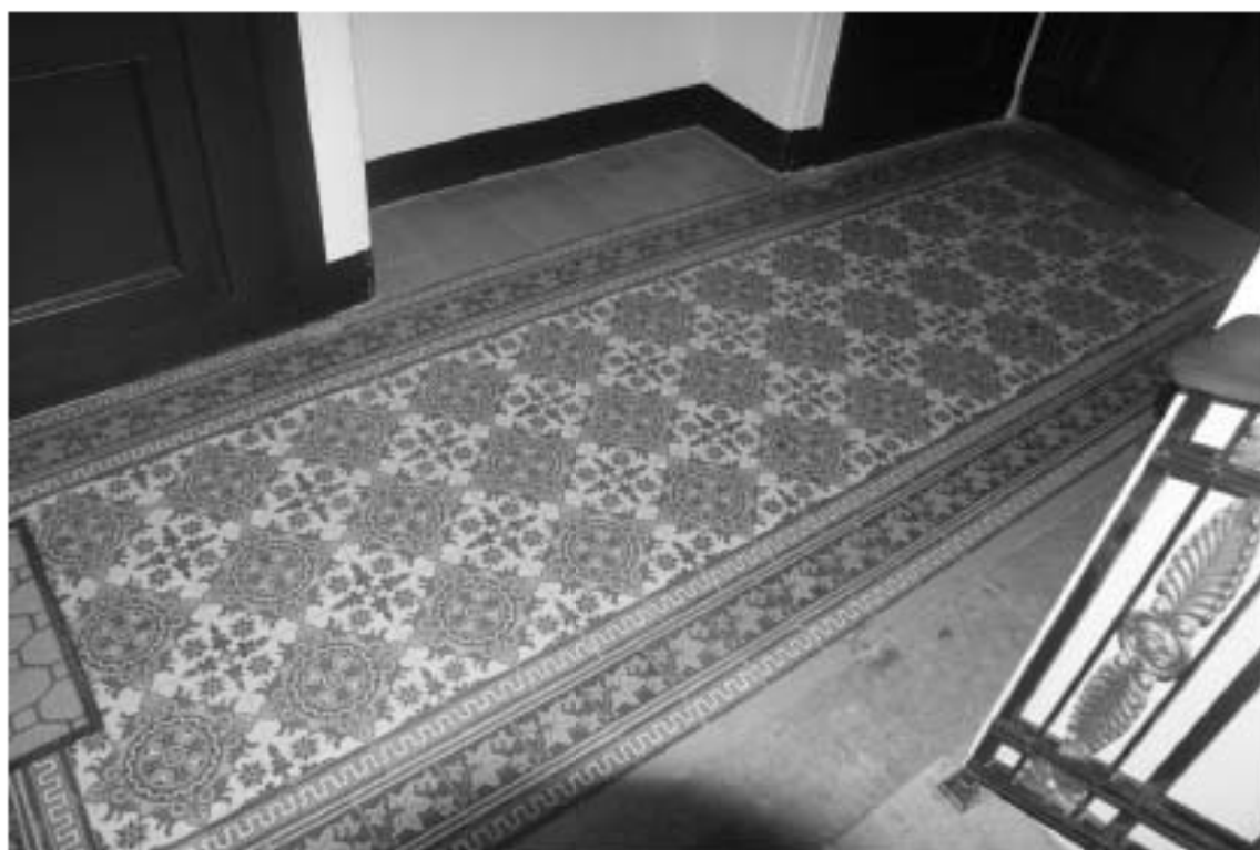
Фото 64. Лестница № 1. Площадка 5-го этажа. Покрытие пола. Съемка 26.04.2021 г. Михайловская Г. В.
