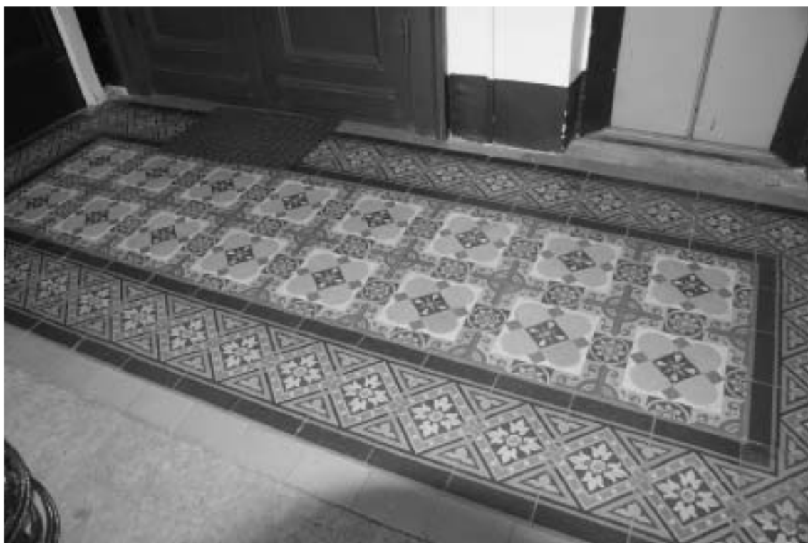
Фото 184. Лестница № 3. Площадка 6-го этажа. Покрытие пола. Съемка 26.04.2021 г. Михайловская Г. В.
