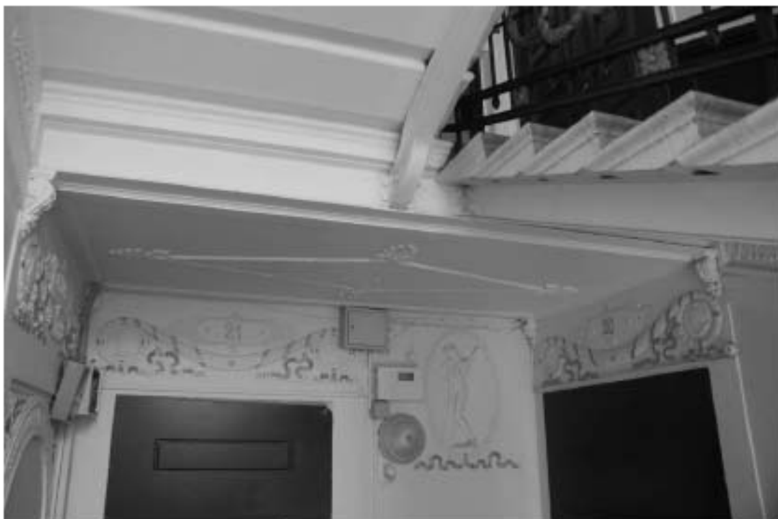
Фото 163. Лестница № 3. Площадка 4-го этажа. Съемка 26.04.2021 г. Михайловская Г. В.
