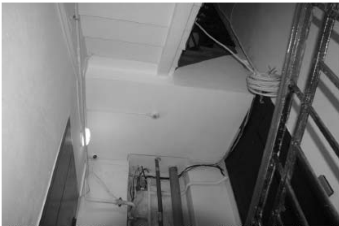
Фото 207. Лестница № 4. Площадка 6-го этажа. Съемка 26.04.2021 г. Михайловская Г. В.
