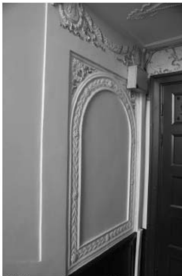
Фото 176. Лестница № 3. Площадка 5-го этажа. Панно с полуциркульным завершением. Съемка 26.04.2021 г. Михайловская Г. В.
