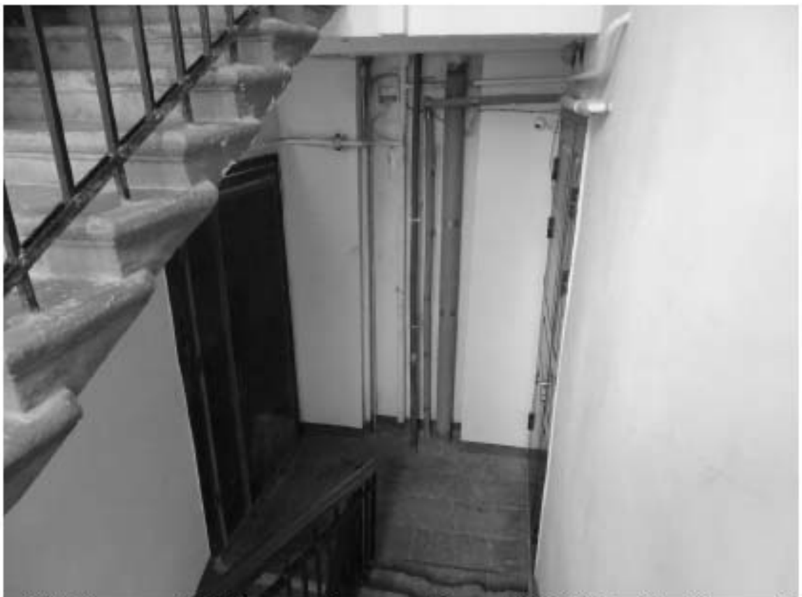
Фото 202. Лестница № 4. Площадка 5-го этажа. Съемка 26.04.2021 г. Михайловская Г. В.
