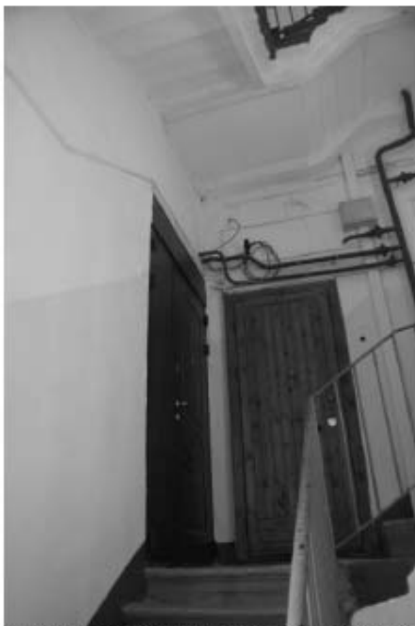
Фото 99. Лестница № 2. Площадка 3-го этажа. Съёмка 26.04.2021 г. Михайловская Г. В.
