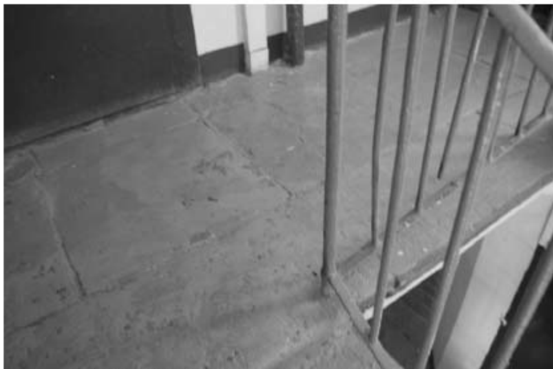
Фото 95. Лестница № 2. Площадка 2-го этажа. Покрытие пола. Съемка 26.04.2021 г. Михайловская Г. В.
