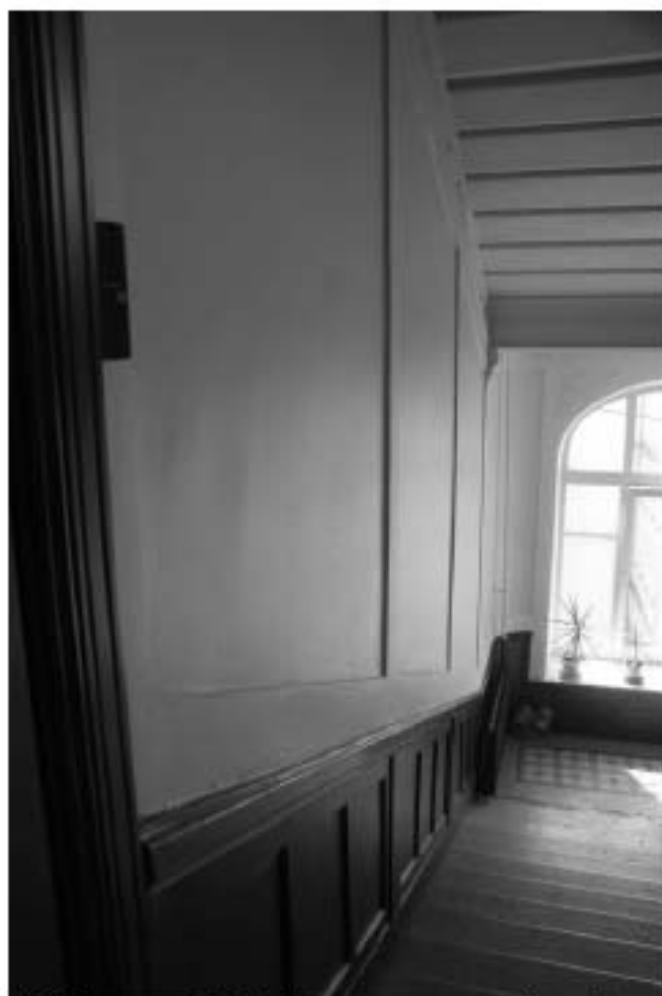
Фото 170. Лестница № 3. Площадка между 4-м и 5-м этажом. Оформление стен лестничных маршей. Съемка 26.04.2021 г. Михайловская Г. В.
