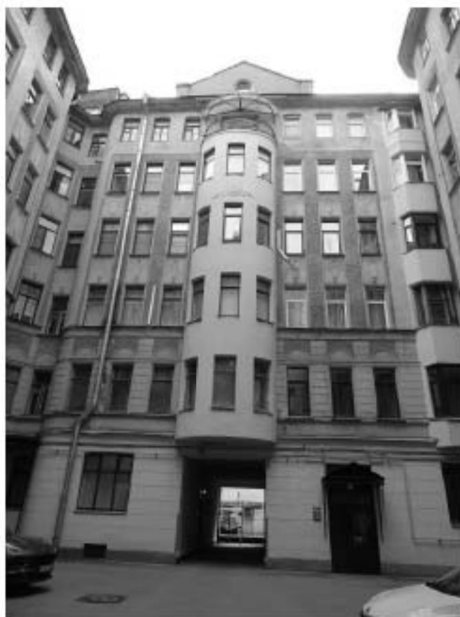
Фото 39. Южный фасад внутреннего двора. Съемка 26.04.2021 г. Михайловская Г. В.
