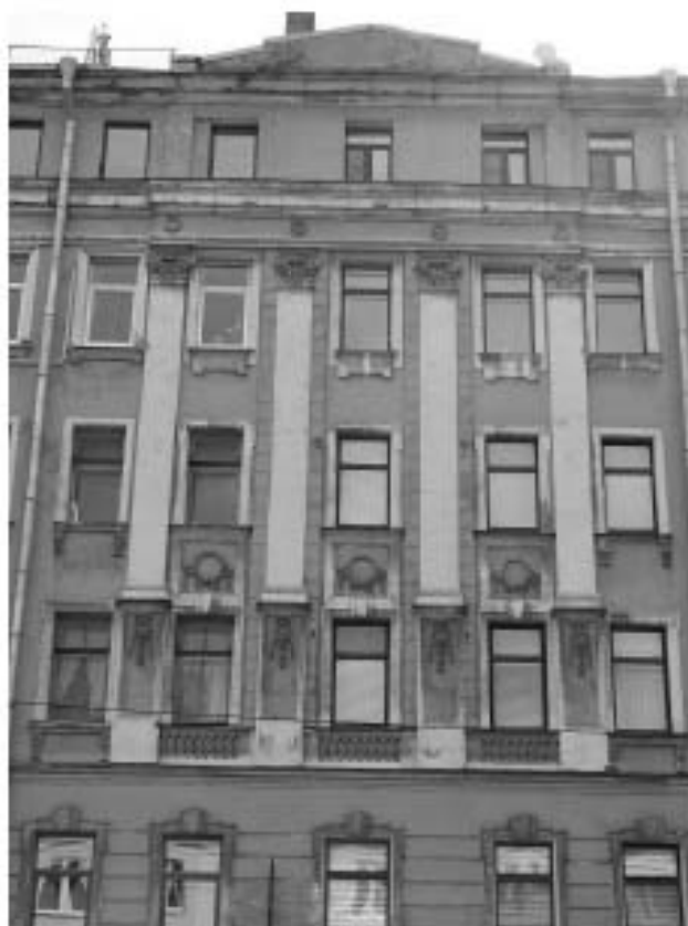
Фото 8. Фрагмент лицевого фасада. Оформление стены 3-го, 4-го, 5-го, 6-го этажей. Съемка 26.04.2021 г. Михайловская Г. В.
