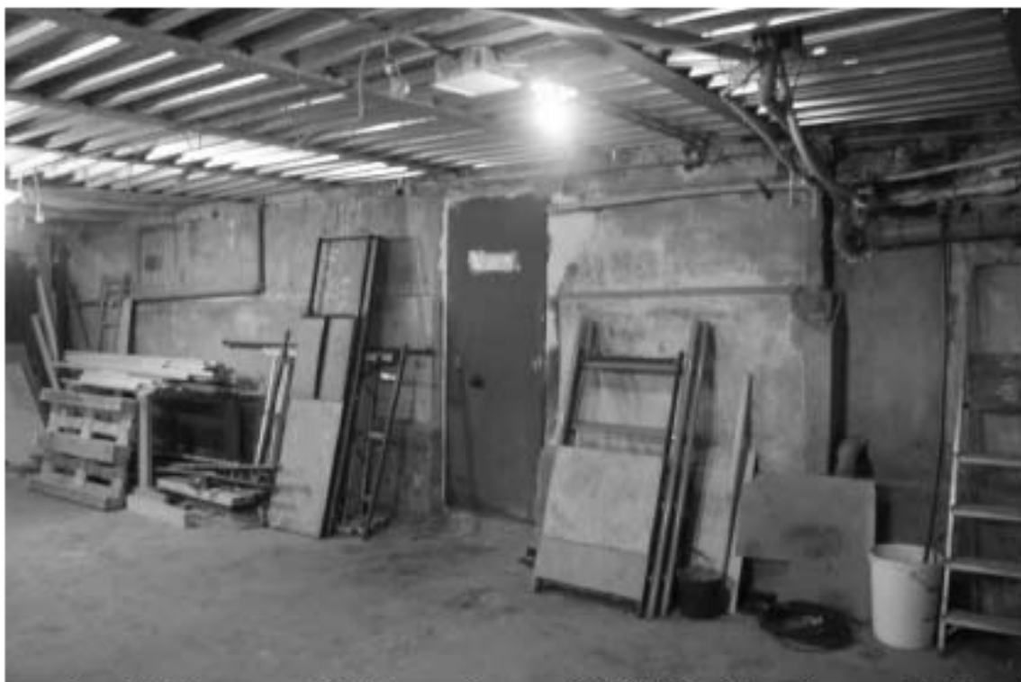
Фото 86. Лестница № 2. Подвал. Съемка 26.04.2021 г. Михайловская Г. В.
