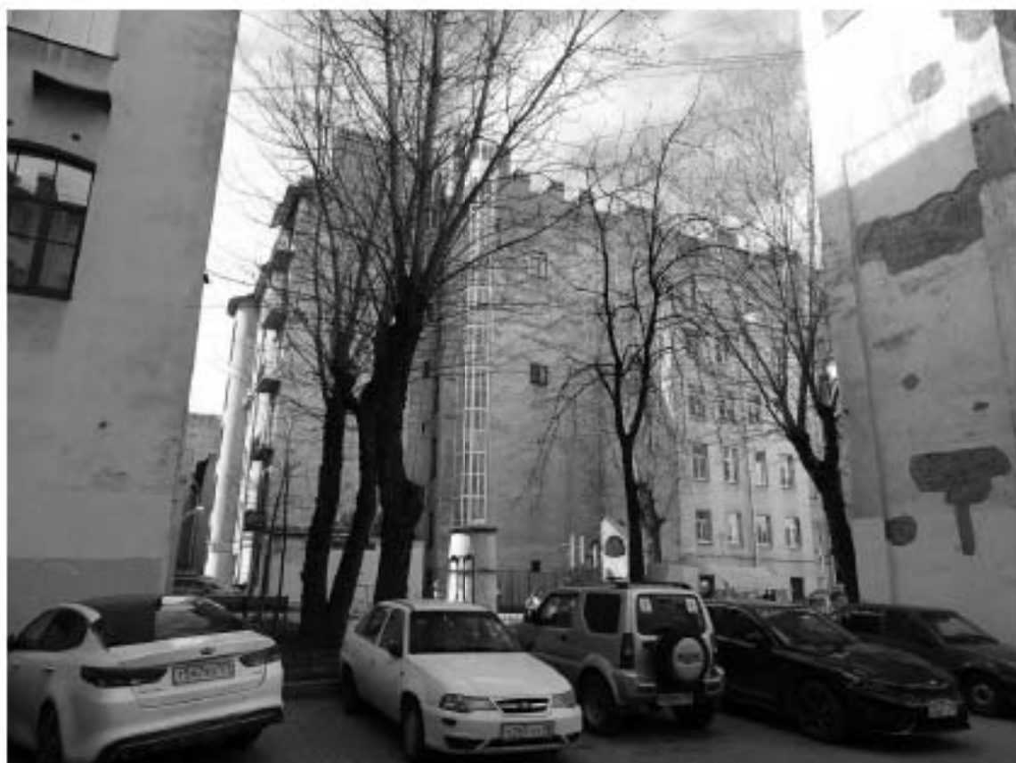
Фото 52. Фрагмент восточного фасада. Съемка 26.04.2021 г. Михайловская Г. В.
