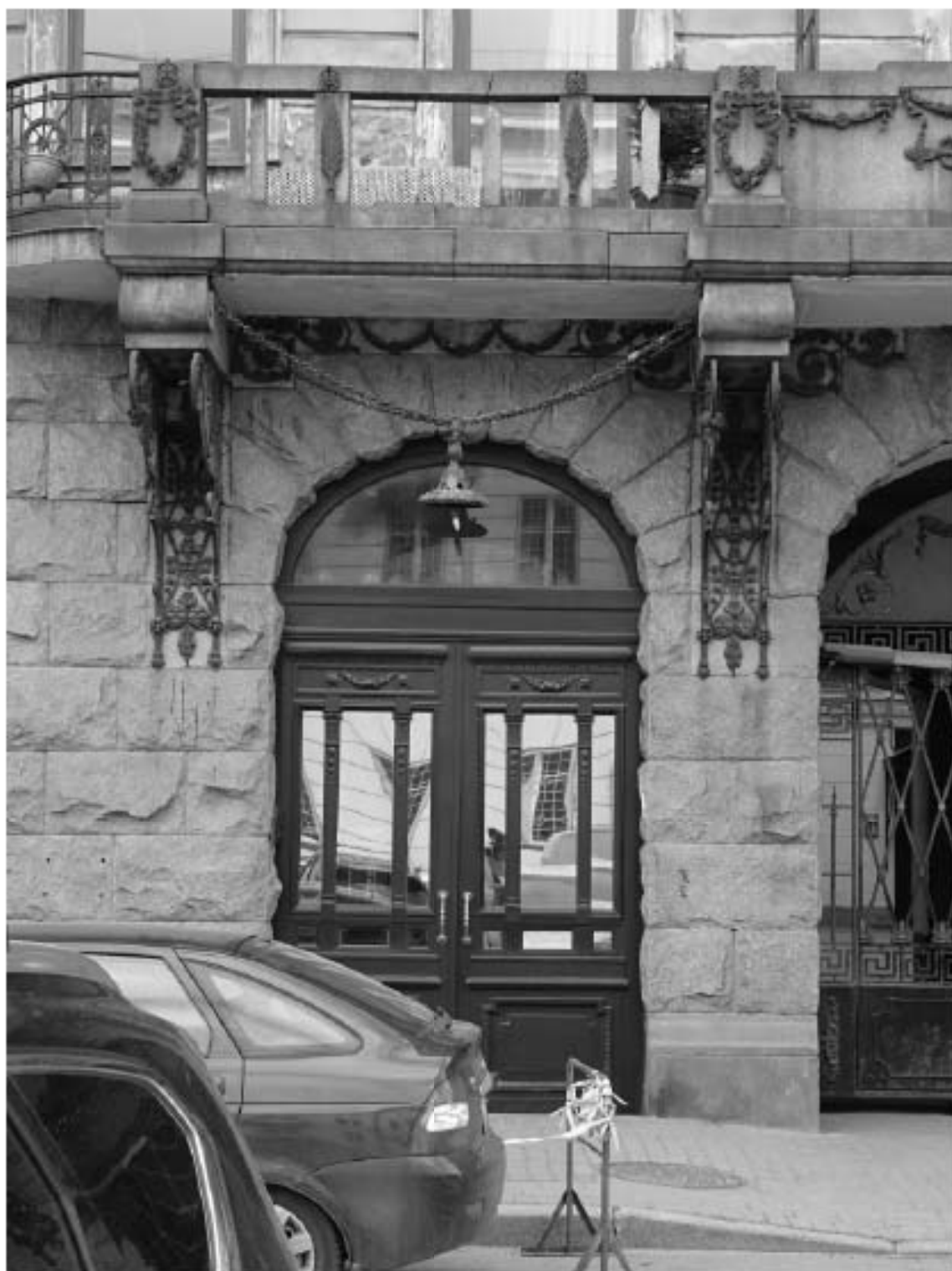
Фото 6. Фрагмент лицевого фасада. Дверной проем. Съемка 26.04.2021 г. Михайловская Г. В.
