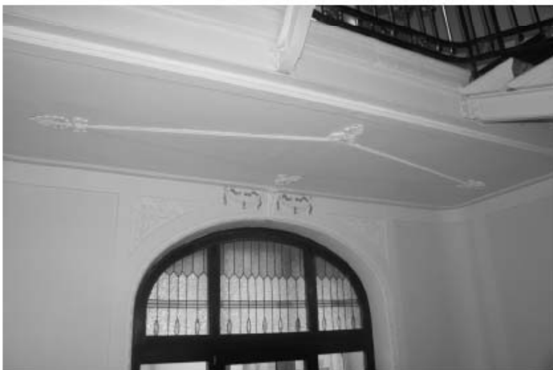
Фото 52. Лестница № 1. Площадка между 2-м и 3-м этажом. Заполнение оконных проемов. Съемка 26.04.2021 г. Михайловская Г. В.
