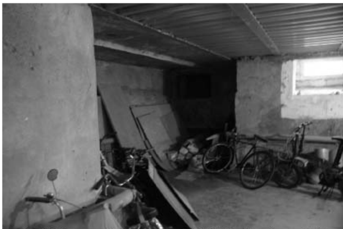
Фото 84. Лестница № 2. Подвал. Съемка 26.04.2021 г. Михайловская Г. В.
