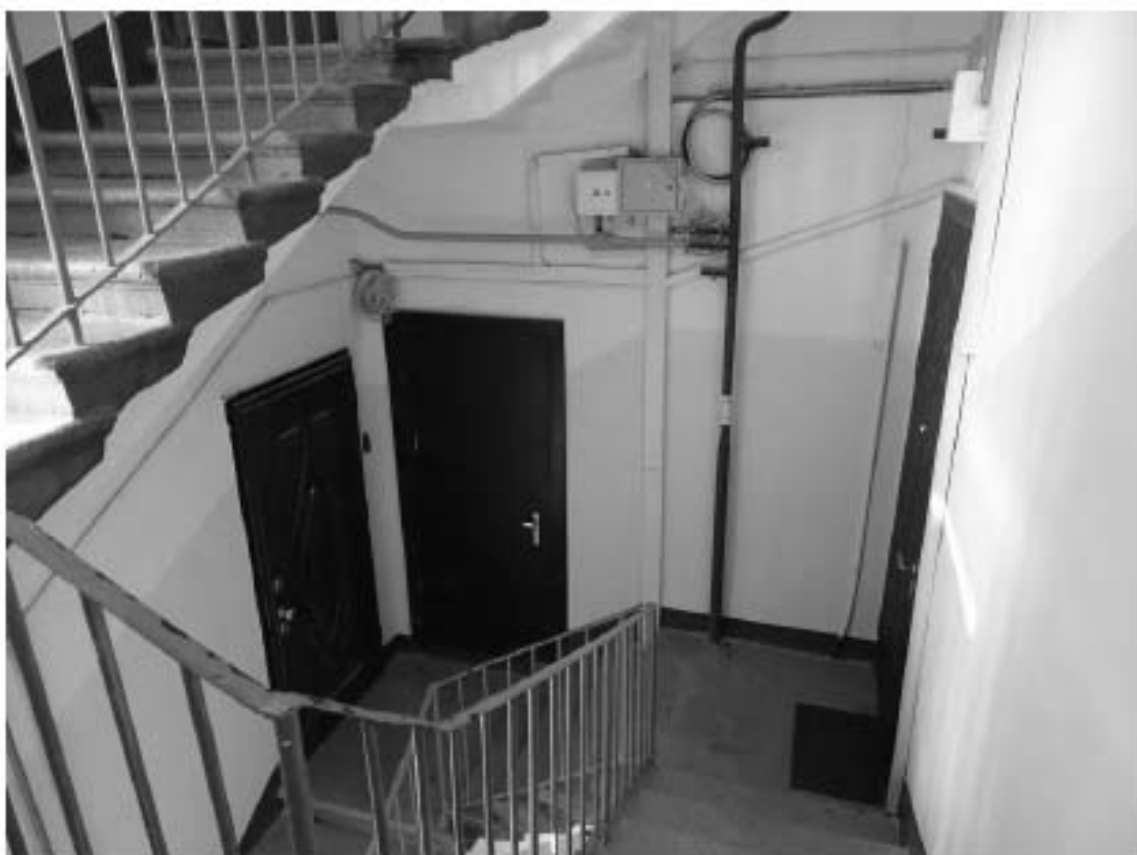
Фото 105. Лестница № 2. Площадка 6-го этажа. Съемка 26.04.2021 г. Михайловская Г. В.
