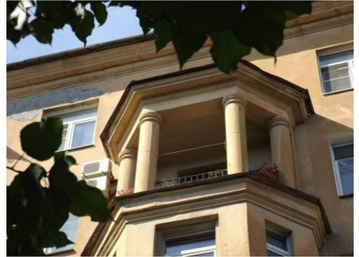
балконы – тип (прямоугольные), местоположение (со второго по шестой этажи дворового фасада), ограждения - материал (металл), техника исполнения (сварка, ковка), рисунок (простой геометрический с шишками);
