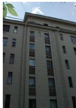
балконы – тип и местоположение (прямоугольные – на всех фасадах со второго по шестой этажи, лоджии (юго-восточный и юго-западный фасады), ограждения – материал (металл), техника исполнения (сварка), рисунок (простой геометрический, прутья крест накрест);
