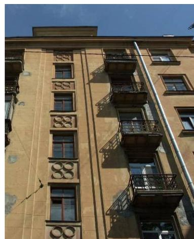
балконы – тип и местоположение (прямоугольные – на всех фасадах со второго по шестой этажи, лоджии – на юго-восточном фасаде), ограждения – материал (металл), техника исполнения (сварка), рисунок (простой геометрический, с кольцами);
