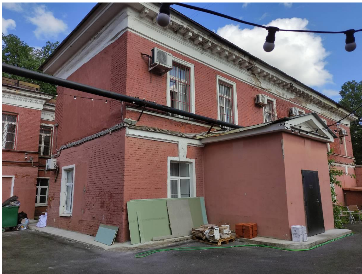
Фото 9. Фрагмент южного фасада выявленного объекта культурного наследия «Жилой дом для служащих», входное дверное заполнение
