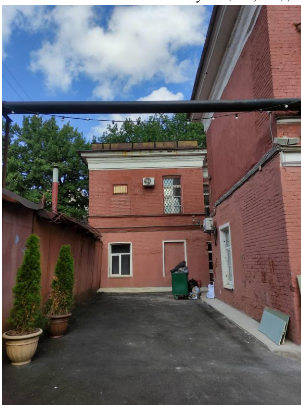
Фото 10. Фрагмент западного фасада выявленного объекта культурного наследия «Жилой дом для служащих»
