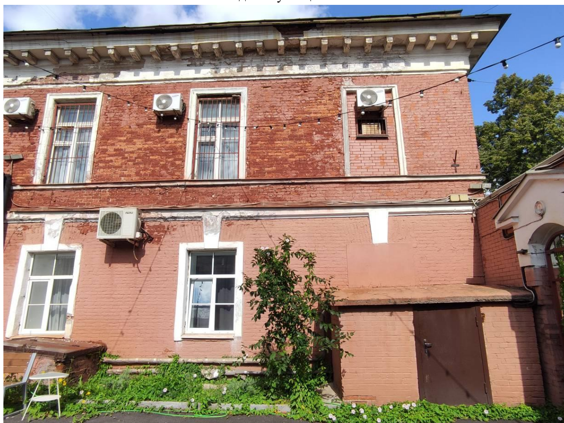
Фото 8. Фрагмент южного фасада выявленного объекта культурного наследия «Жилой дом для служащих»
