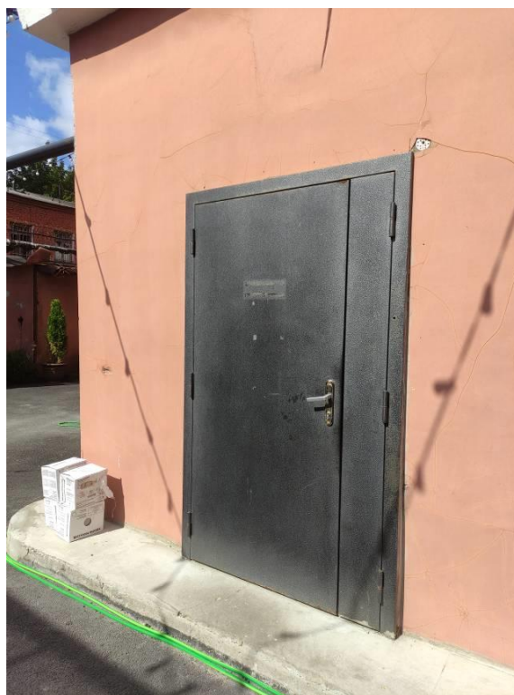
Фото 15. Фрагмент южного фасада выявленного объекта культурного наследия «Жилой дом для служащих», входное дверное заполнение
