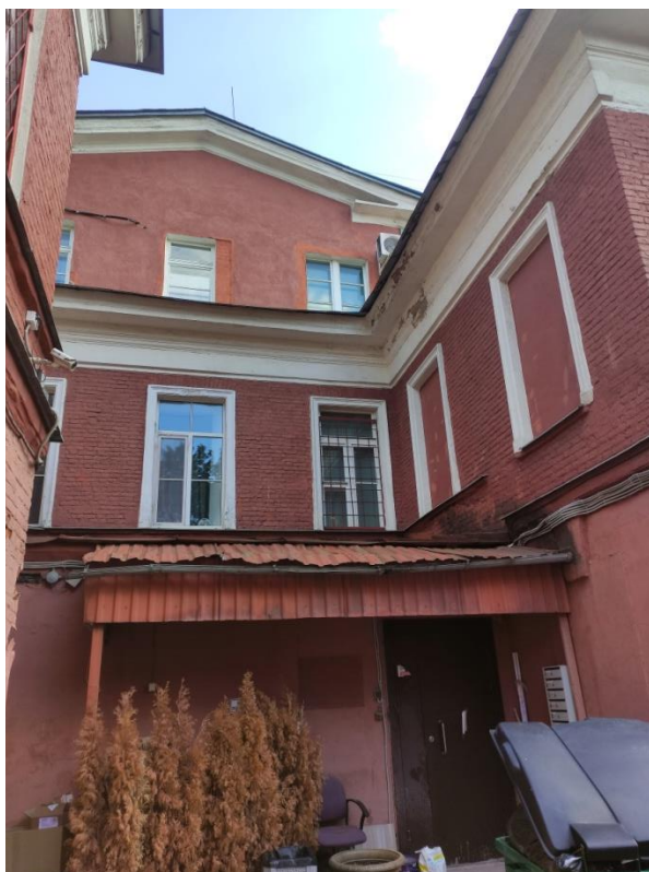
Фото 12. Фрагмент западного фасада выявленного объекта культурного наследия «Жилой дом для служащих»
