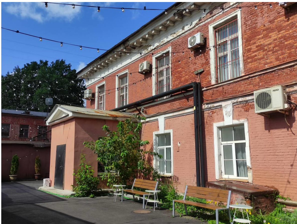
Фото 7. Фрагмент южного фасада выявленного объекта культурного наследия «Жилой дом для служащих»
