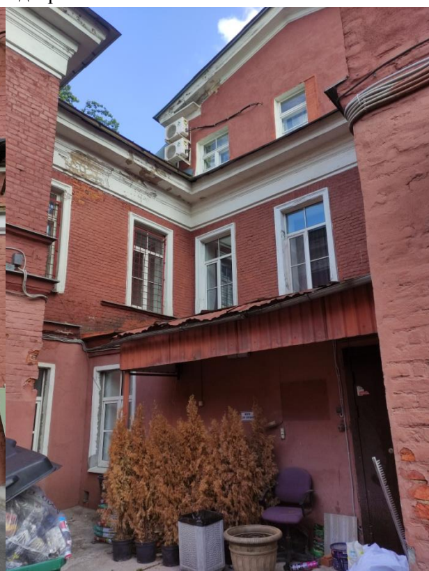
Фото 11. Фрагмент западного фасада выявленного объекта культурного наследия «Жилой дом для служащих»
