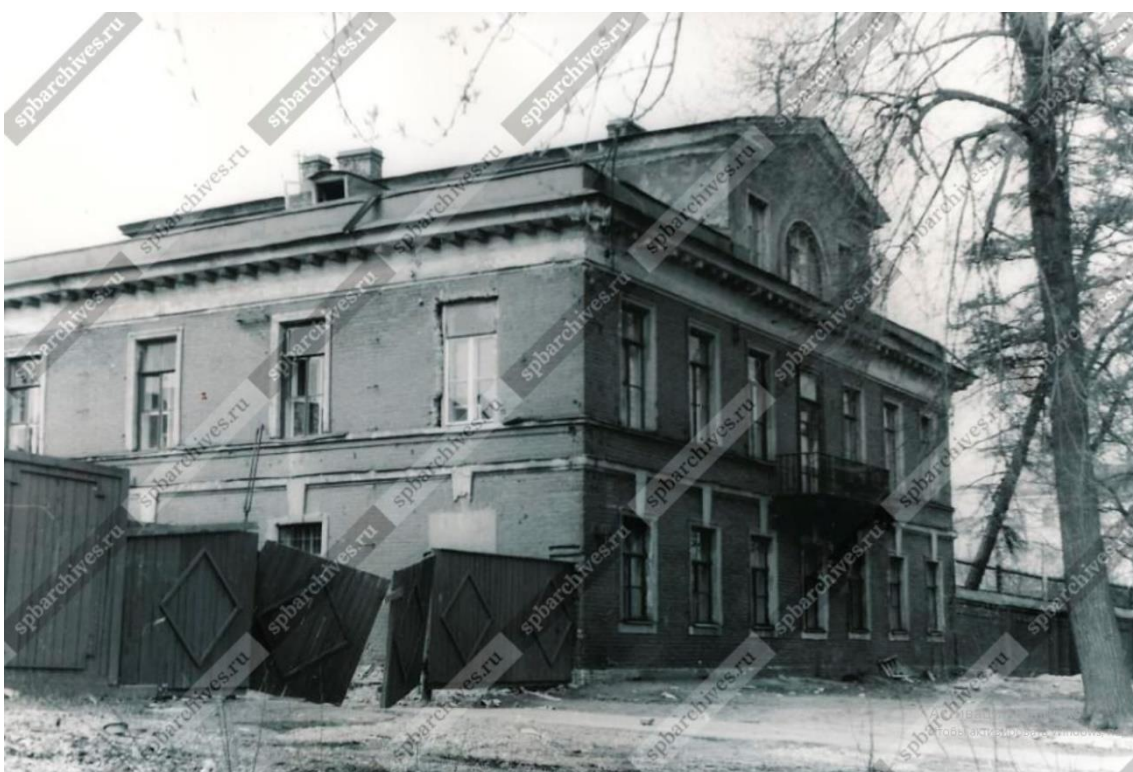
14. Вид 2-х этажного дома № 123-а на проспекте Обуховской обороны (бывшее здание Александровского чугунолитейного завода). Май 1973 г. — ЦГАКФФД СПб. Шифр: Ар 238531.
