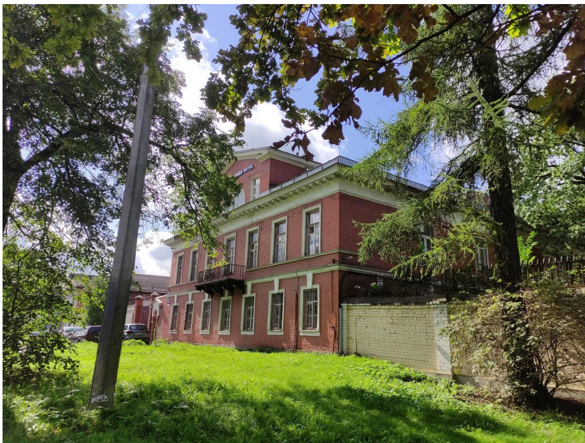
Фото 1. Общий вид выявленного объекта культурного наследия «Жилой дом для служащих», вид с проспекта Обуховской обороны
