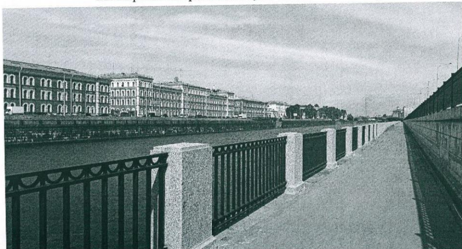
22. Парапет из гранитных тумб и металлической решетки
