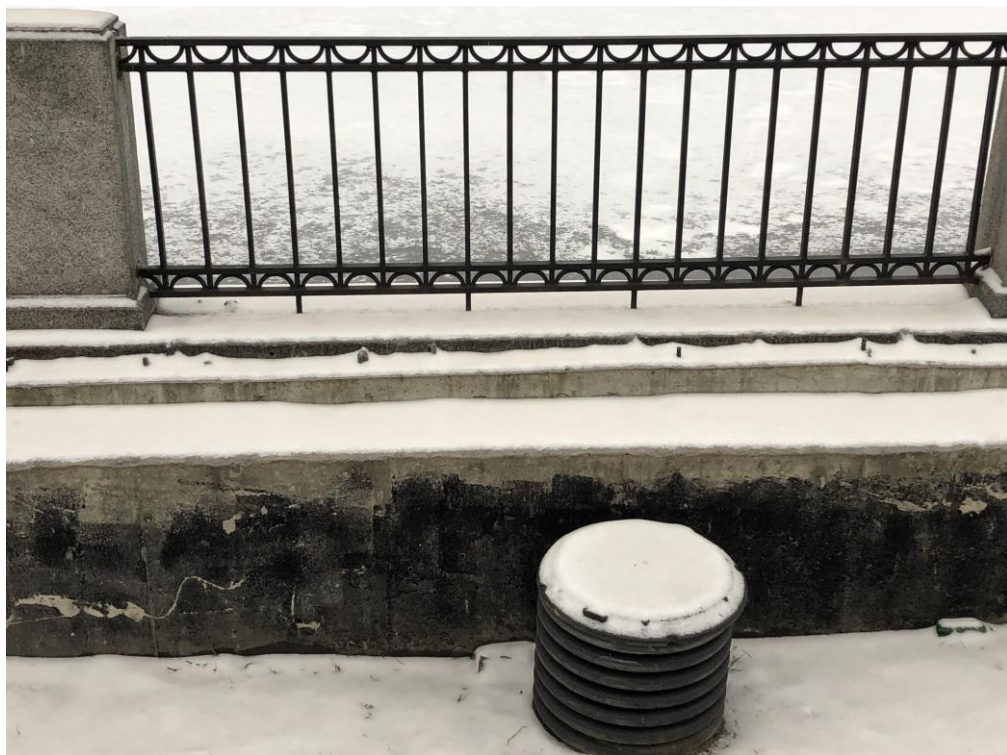
24. Объект культурного наследия регионального значения «Набережная Обводного канала» по адресу: от Шлиссельбургского моста до Московской ж. д. Участок от протоки Французского ковша до Атаманского моста, левый берег. Нижний уровень. Фрагмент. Перильное ограждение нижнего яруса. Узел инженерных коммуникаций.
