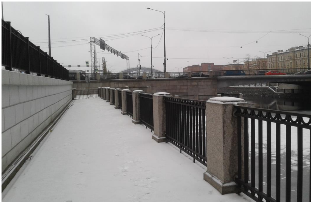
16. Объект культурного наследия регионального значения «Набережная Обводного канала» по адресу: от Шлиссельбургского моста до Московской ж. д. Участок от протоки Французского ковша до Атаманского моста, левый берег. Нижний уровень. Вид в западном направлении на Атаманский мост.
