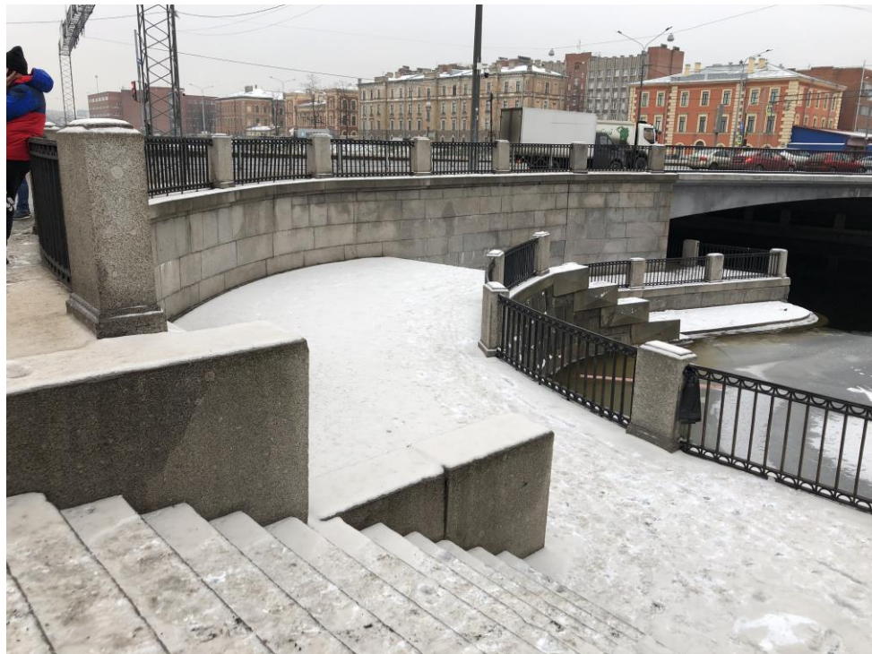
13. Объект культурного наследия регионального значения «Набережная Обводного канала» по адресу: от Шлиссельбургского моста до Московской ж. д. Участок от протоки Французского ковша до Атаманского моста, левый берег. Нижний уровень. Фрагмент. Вид в западном направлении на Атаманский мост с лестницы-схода.
