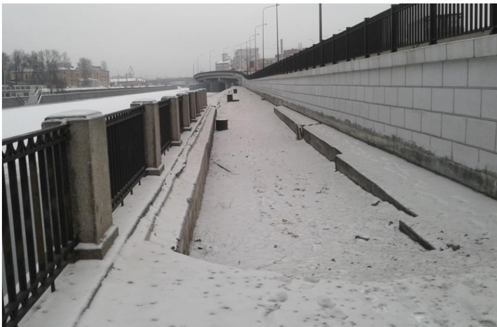
22. Объект культурного наследия регионального значения «Набережная Обводного канала» по адресу: от Шлиссельбургского моста до Московской ж. д. Участок от протоки Французского ковша до Атаманского моста, левый берег. Нижний уровень (в восточном направлении, в сторону Французского моста). Фрагмент.
