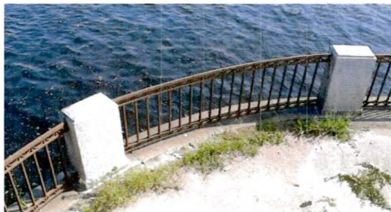
23. Полукруглый парапет у Казачьего моста, блоки из серого гранита
