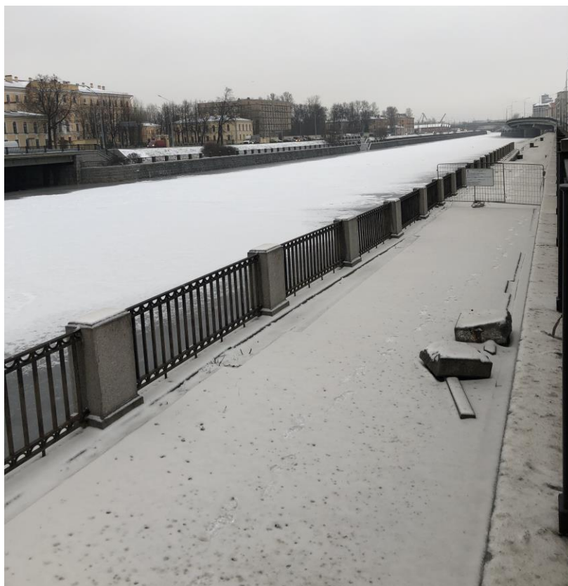
19. Объект культурного наследия регионального значения «Набережная Обводного канала» по адресу: от Шлиссельбургского моста до Московской ж. д. (Участок от протоки Французского ковша до Атаманского моста, левый берег). Нижний уровень. Общий вид в восточном направлении (в сторону Французского моста).
