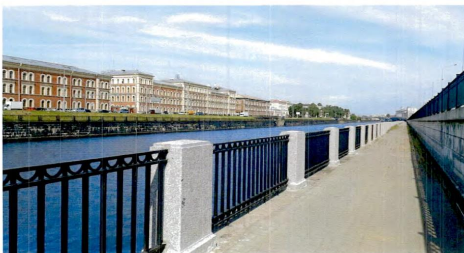
22. Парапет из гранитных тумб и металлической решетки
