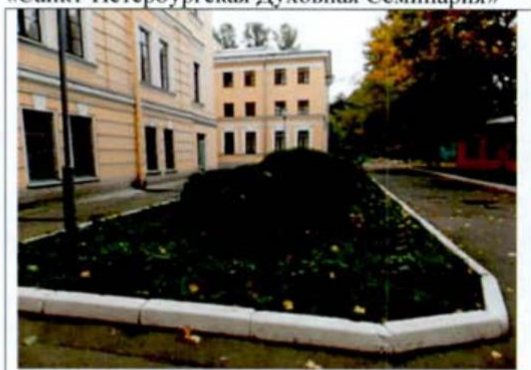
1. Восточный фасад Церковного корпуса. Вид на здание Больницы.
