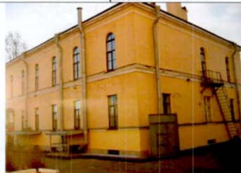
12. Восточный, северный фасады. Казачий квартирный флигель.
