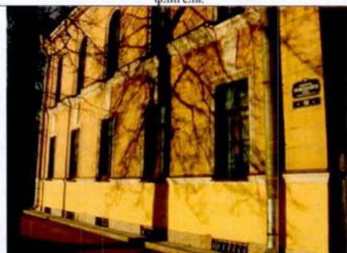
14. Южный фасад. Казачий квартирный флигель.
