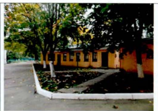
2. Северо-восточный участок между Главным зданием и Церковным корпусом. Вид на хозяйственную постройку.
