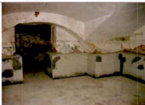
9. Подвал. Академический квартирный флигель.
