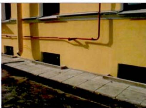
5. Фрагмент западного фасада. Академический квартирный флигель.
