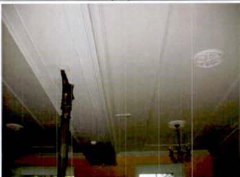
18. Фрагмент интерьера вестибюля.
