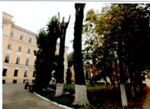
22. Восточная часть сада. Вид со стороны набережной Обводного канала на Главное здание и Академический квартирный флигель.
