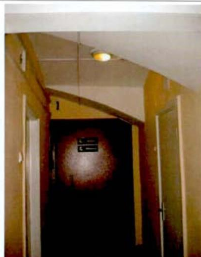
20. Помещения цокольного этажа.
