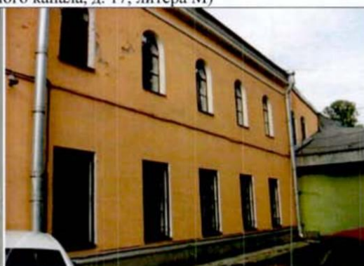
2. Фрагмент восточного фасада.
