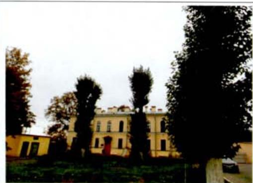
23. Западная часть сада. Вид на Казачий квартирный флигель.
