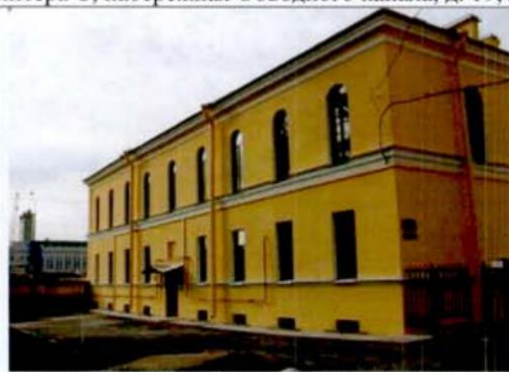
1. Восточный фасад. Академический квартирный флигель.
