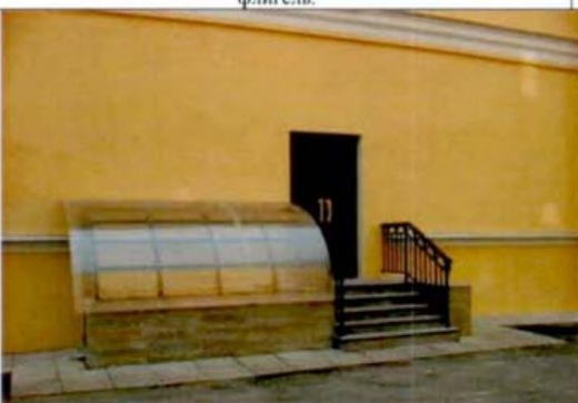
7. Входная группа восточный фасад. Академический квартирный флигель.
