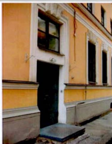
7. Дверной проем южного фасада.
