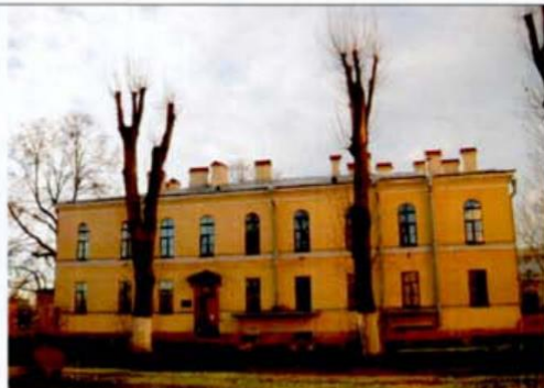
11. Восточный фасад. Казачий квартирный флигель.
