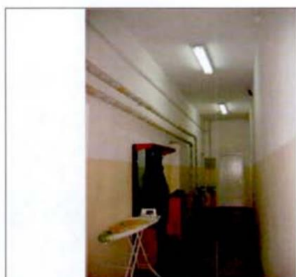
5. Коридор 1-го этажа. Общий вид
