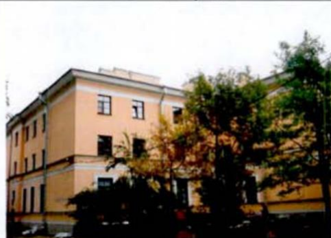
5. Северный, восточный фасады.
