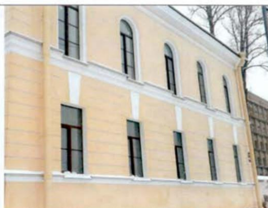
4. Южный фасад. Академический квартирный флигель.
