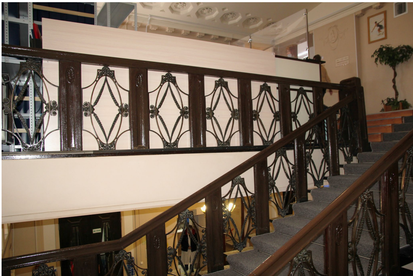
Фото 7. Фрагмент лестничной клетки, выход в помещение №68
