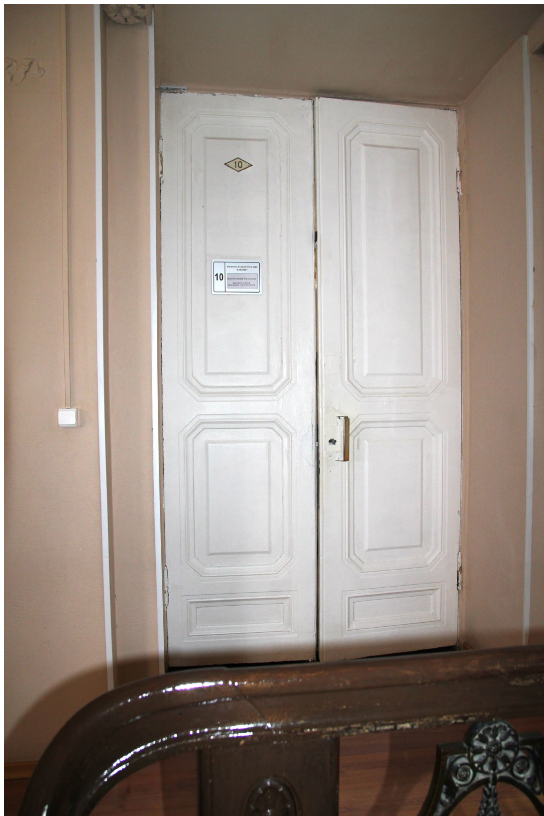
Фото 51. Помещение №68. Дверное заполнение ДВ-6б в помещение №77
