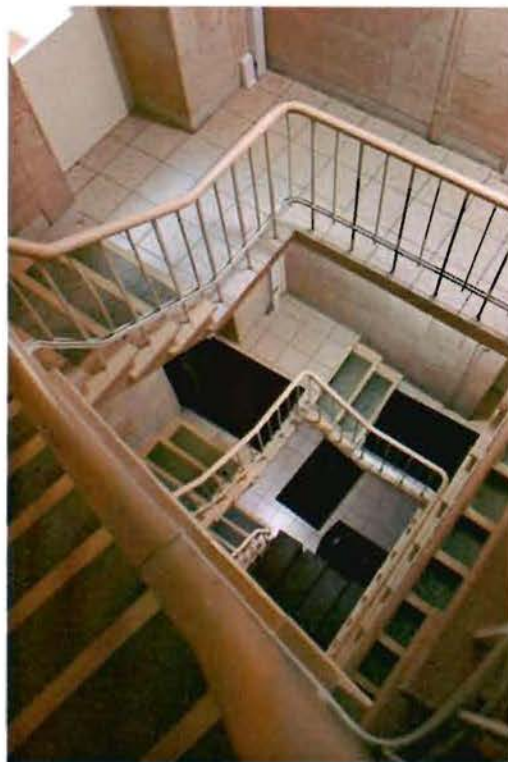
Фото №16. Трехмаршевая межэтажная лестница.
