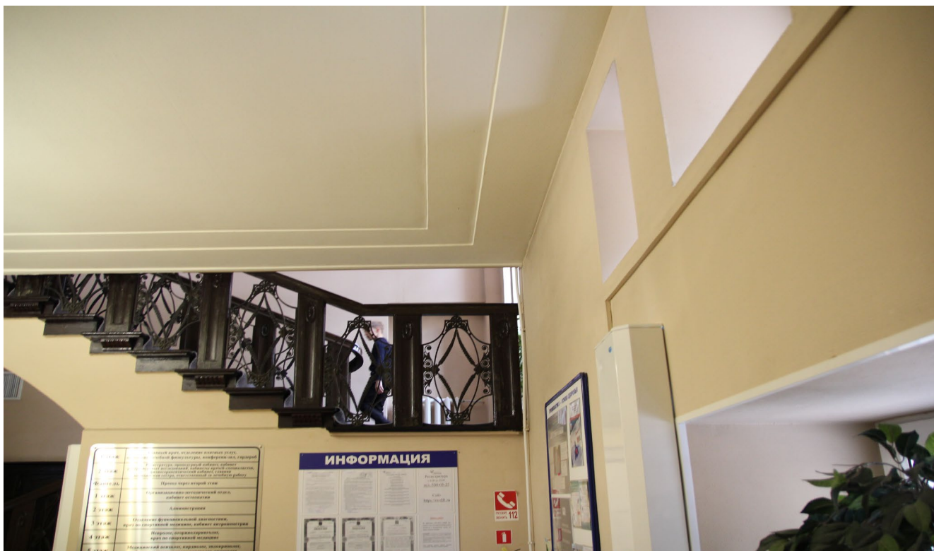
Фото 6. Помещения №43. Фрагмент ограждения лестницы
