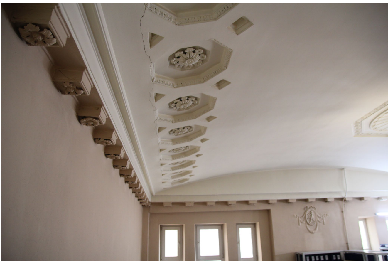
Фото 18. Помещение №68. Карниз с модульонами. Кессоны, декорированные розетками
