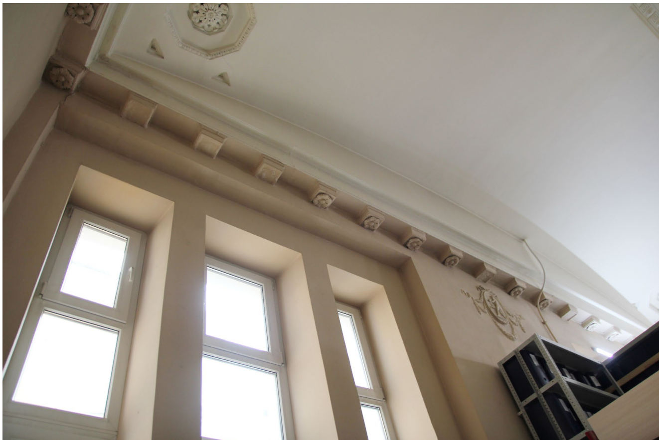
Фото 19. Помещение №68. Карниз с модульонами. Кессоны, декорированные розетками
