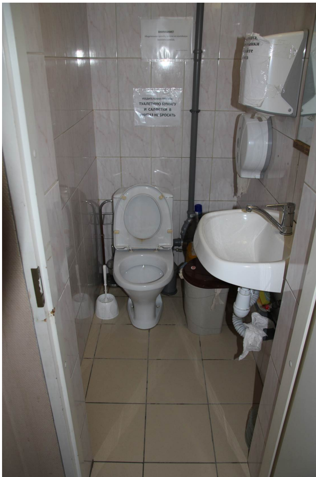
Фото 58. Фрагмент помещения №47. Вид на санузел
