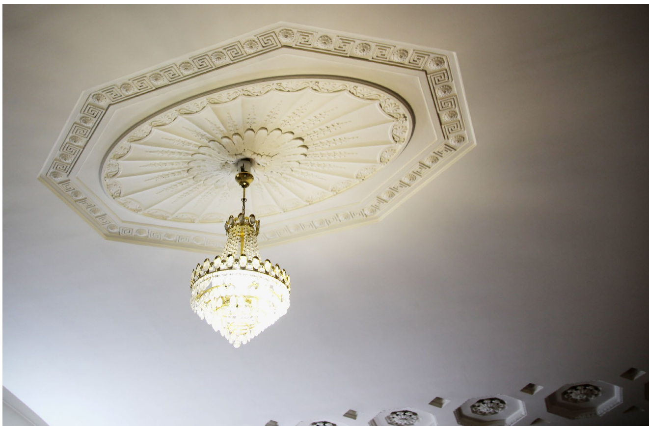
Фото 20. Помещение №68. Лепная розетка в центре потолка
