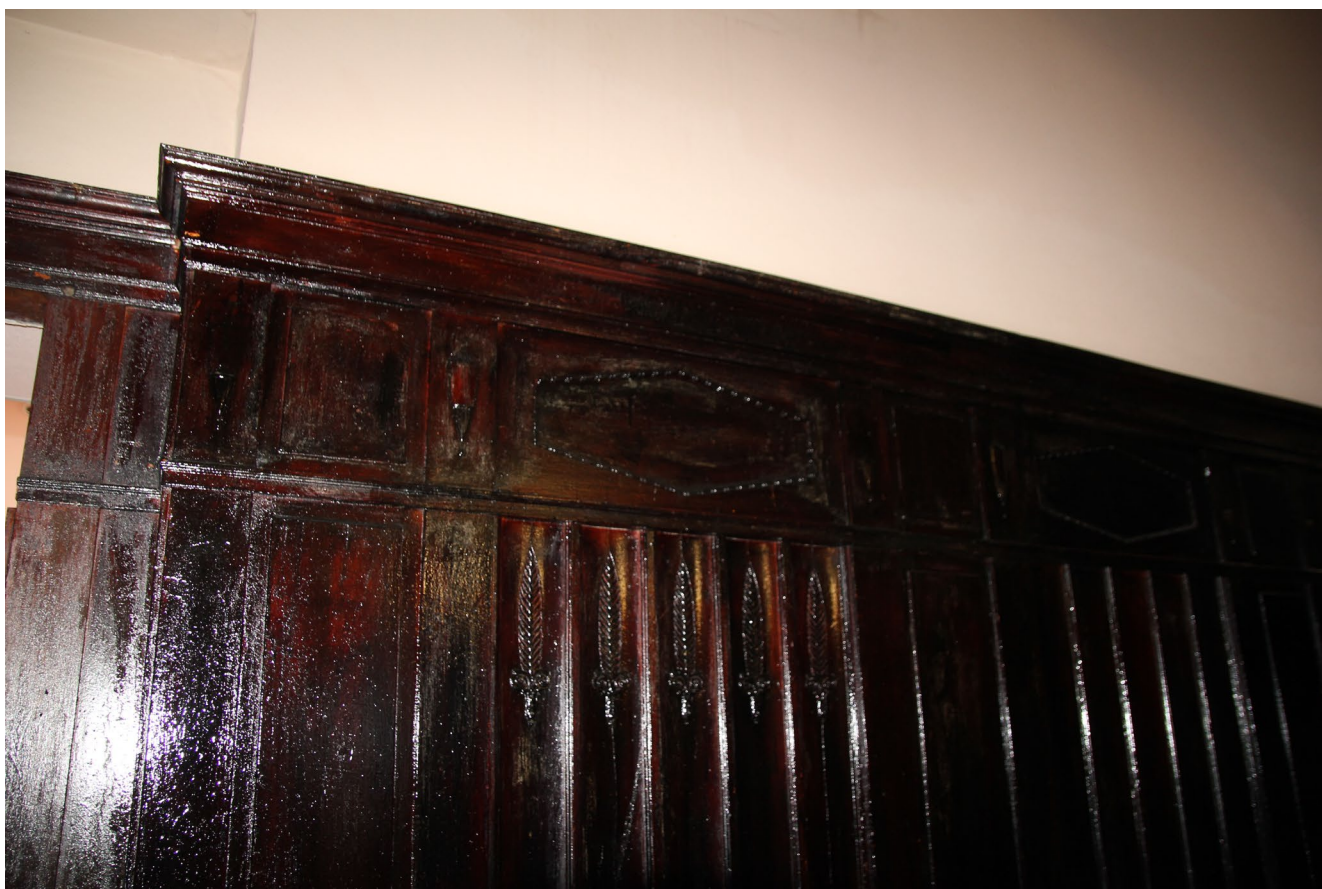
Фото 32. Помещение №43. Декоративные стеновые панели лестницы
