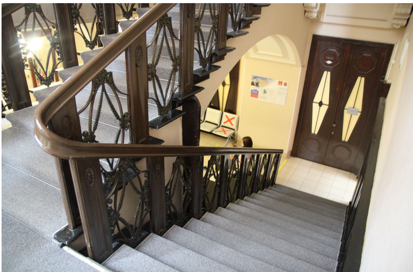
Фото 8. Фрагмент лестничной клетки, вид с междуэтажной площадки
