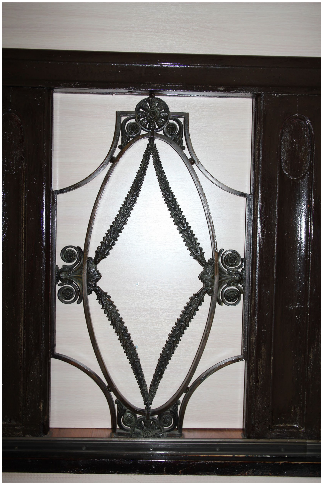
Фото 38. Помещение №68. Фрагмент ограждения. Деревянные стойки и металлическая секция ограждения 2 яруса
