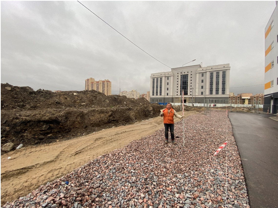
Рис. 14. СПб, Муниципальный округ Гагаринское, Витебский проспект, участок 6 (кадастровый номер: 78:14:0769203:6753). Photo 1. Общий вид территории обследования. Вид с ЮВ
