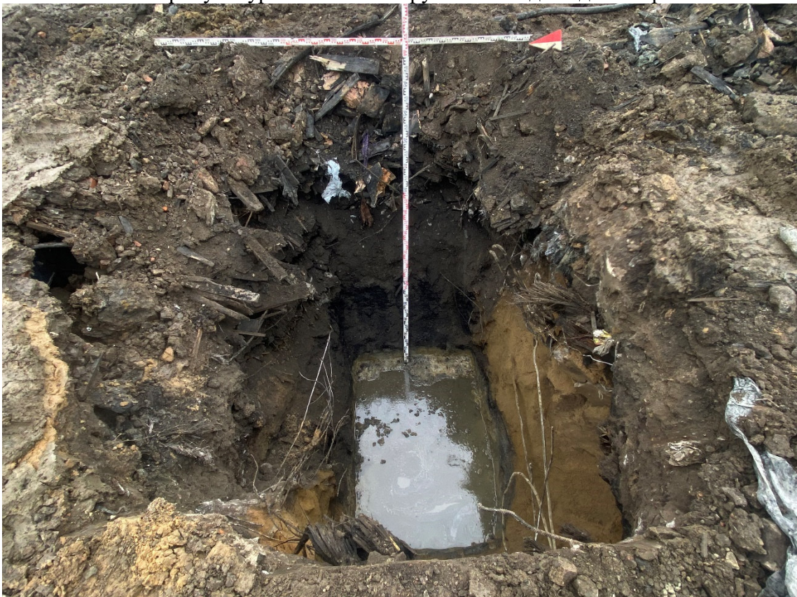
Рис. 35. СПб, Муниципальный округ Гагаринское, Витебский проспект, участок 6 (кадастровый номер: 78:14:0769203:6753). Шурф 1. Фиксация зачистки дна шурфа по материке на уровне стояния грунтовых вод. Вид с запада
