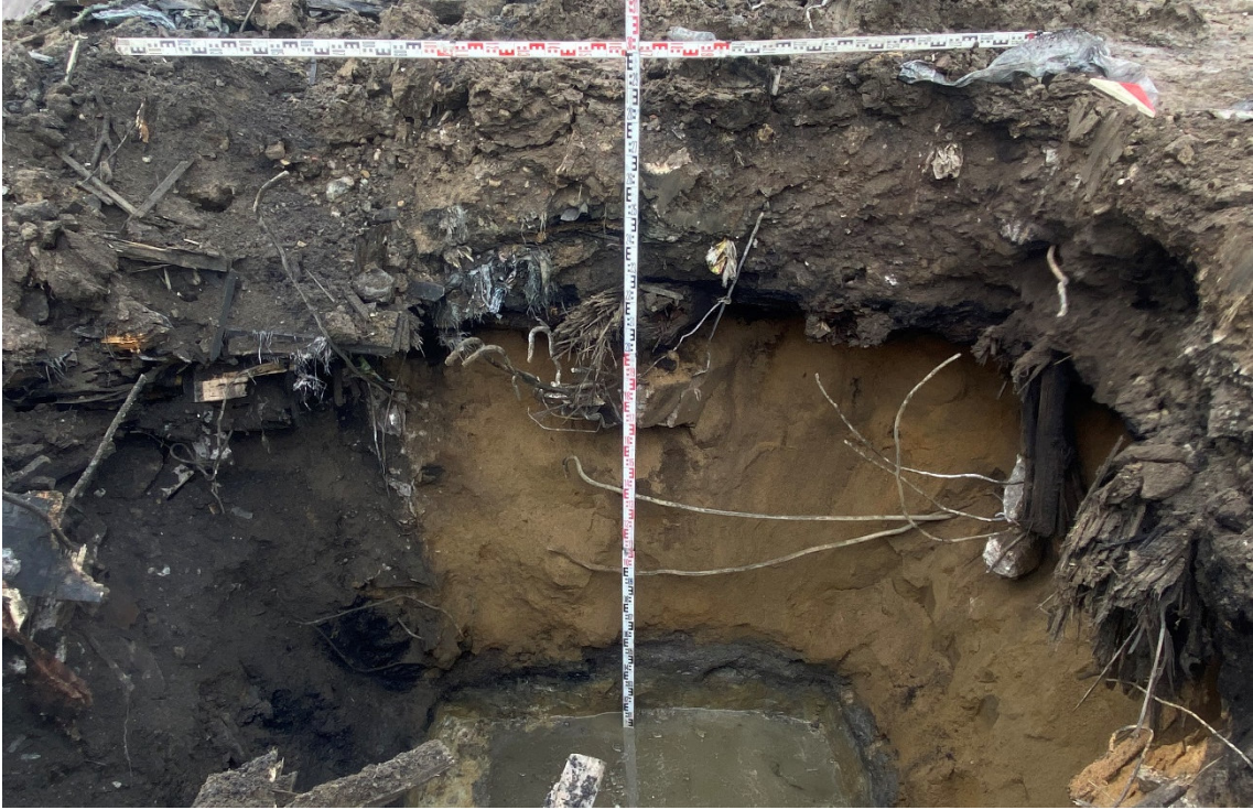
Рис. 40. СПб, Муниципальный округ Гагаринское, Витебский проспект, участок 6 (кадастровый номер: 78:14:0769203:6753). Шурф 1. Южная стенка. Вид с севера
