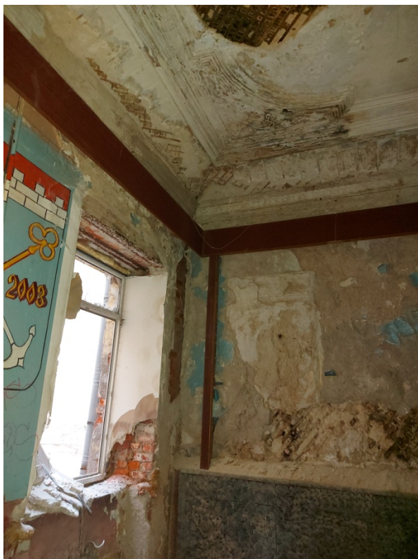
Фото 53. Фрагмент помещения 9, оконный проем.
