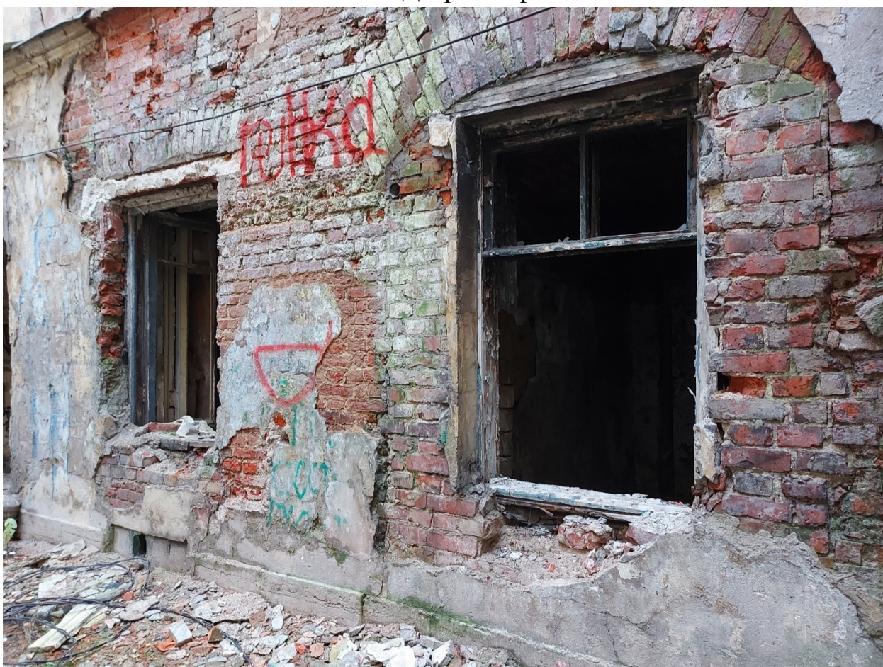
Фото 11. Проемы первого этажа.
