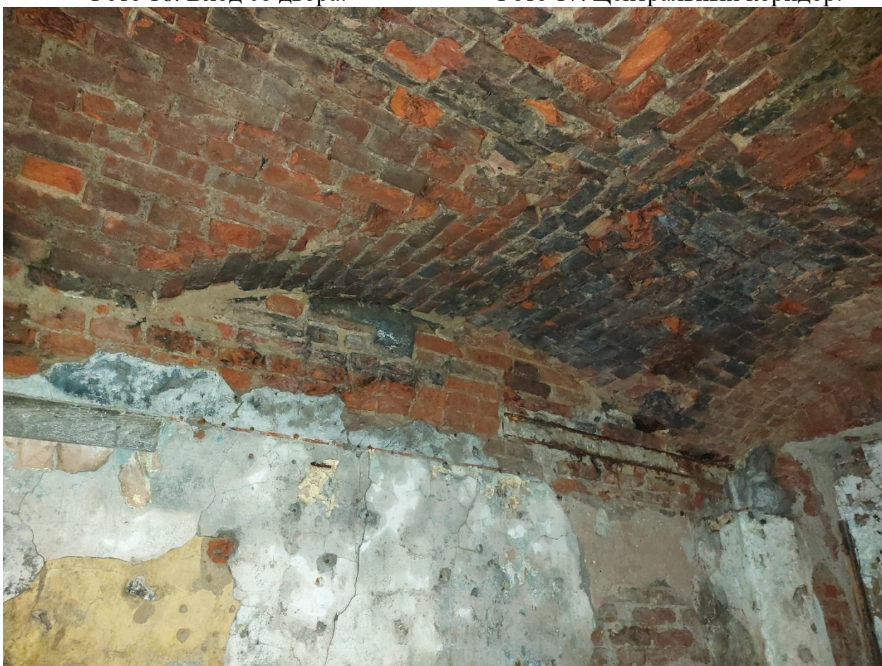
Фото 18. Фрагмент перекрытия, заложенные проемы.
