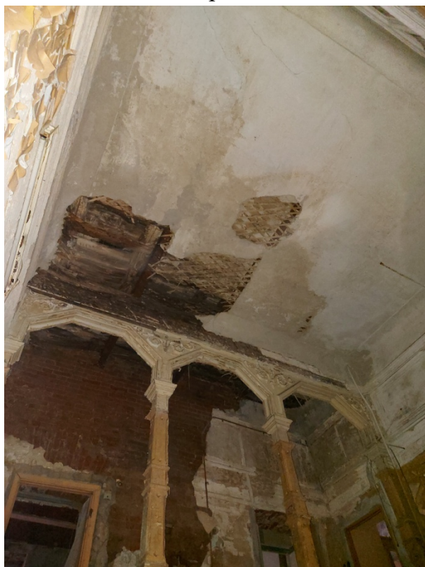
Фото 37. Перекрытие парадной лестницы.
