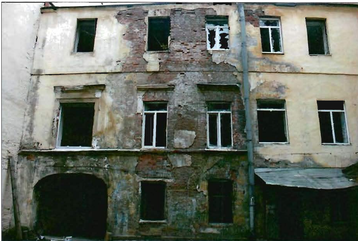
2. Дворовый фасад. Общий вид.
