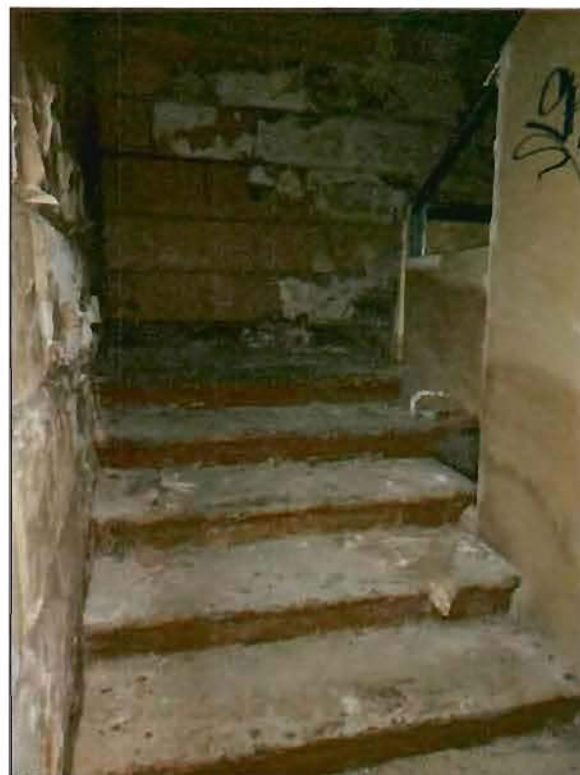
5. Интерьер. Фрагмент. Лестница.
