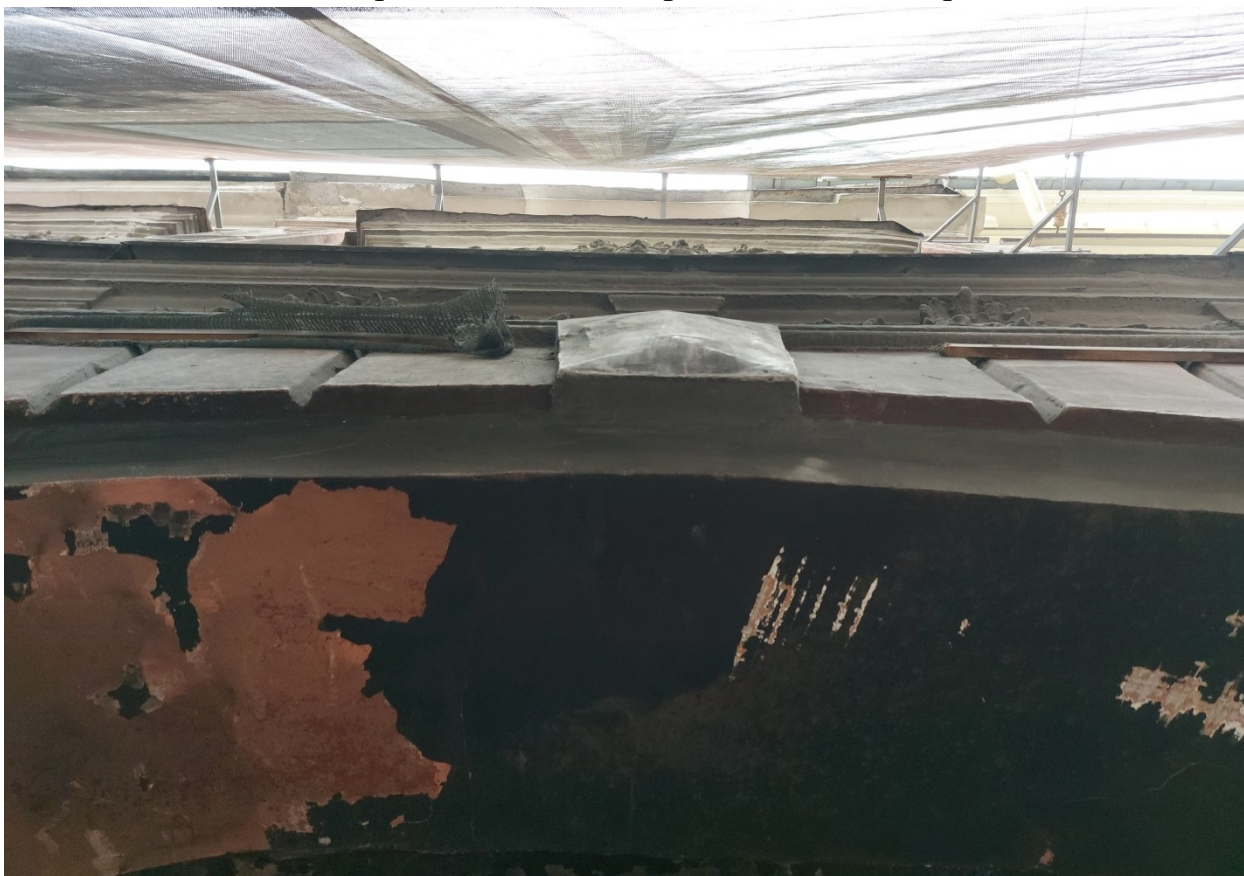
Фото 7. Оформление проездной арки.
