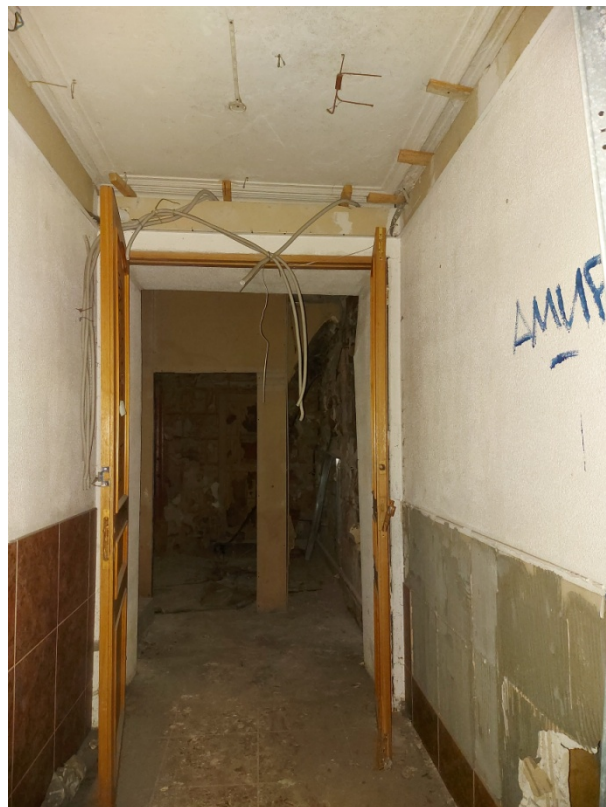
Фото 32. Коридор западного входа.
