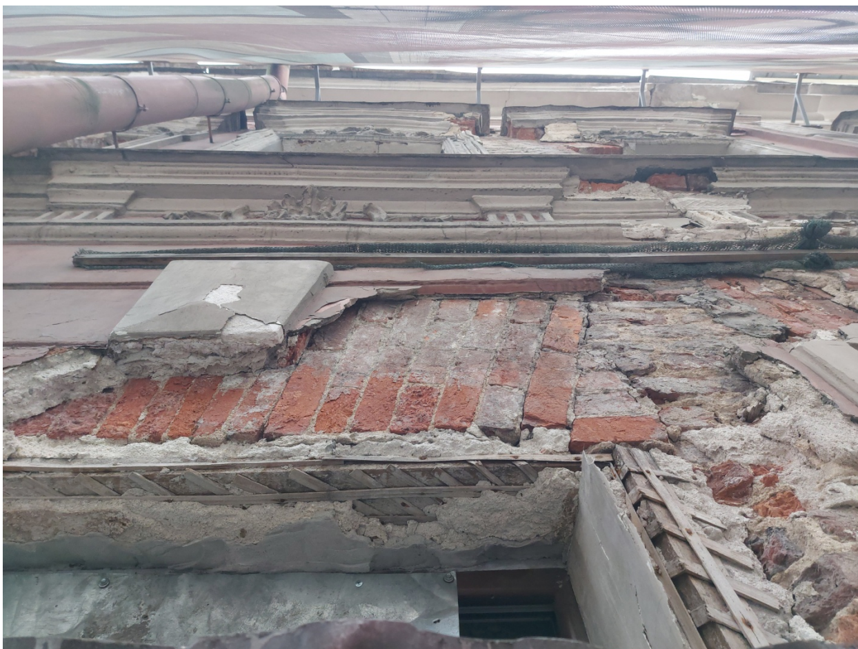
Фото 6. Фрагмент лицевого фасада, оконный проем.
