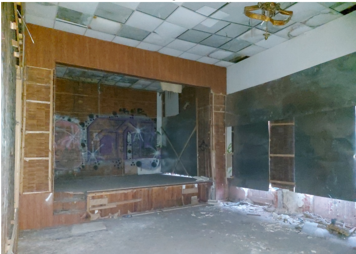
Фото 43. Западная часть помещения 14.
