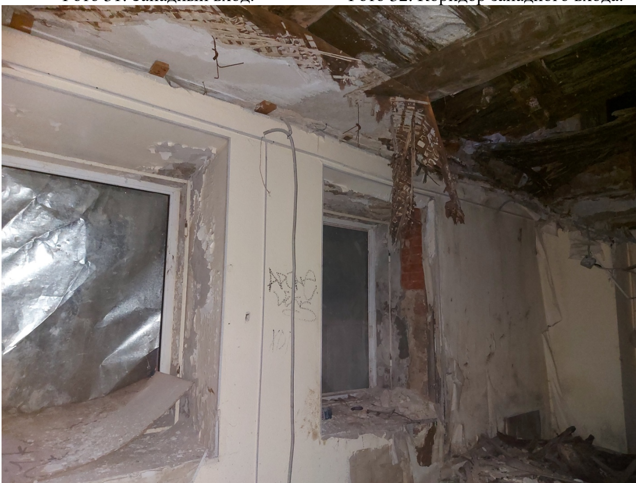
Фото 33. Проемы лицевого фасада.
