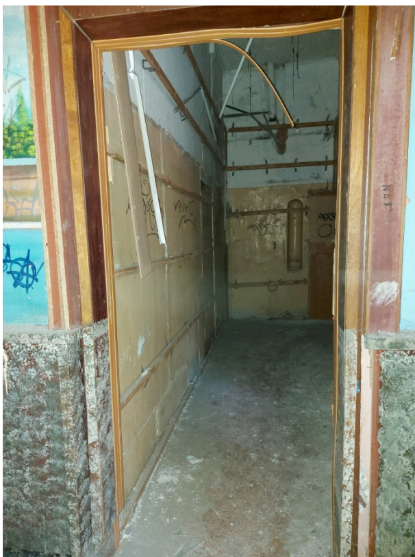
Фото 55. Вид на юго-восточную часть.
