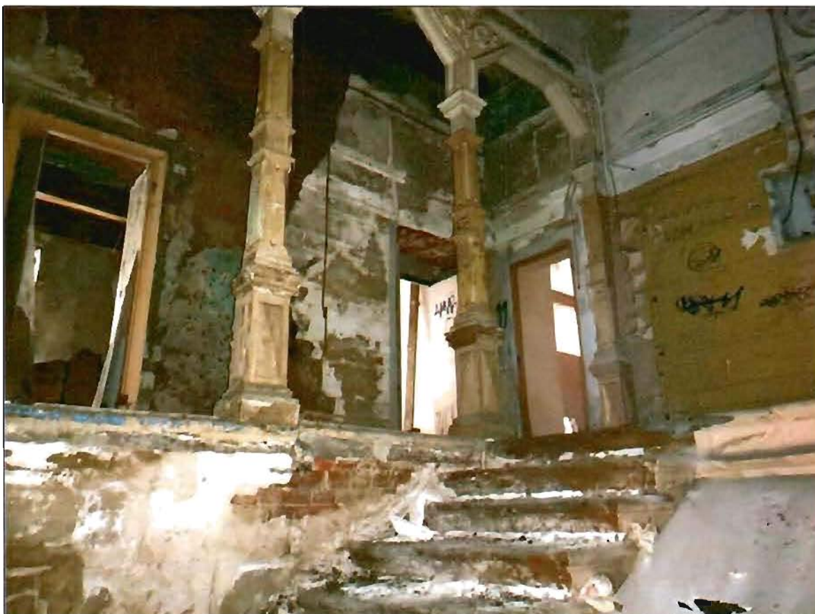
3. Интерьер. Фрагмент. Лестница с арками галереи.
