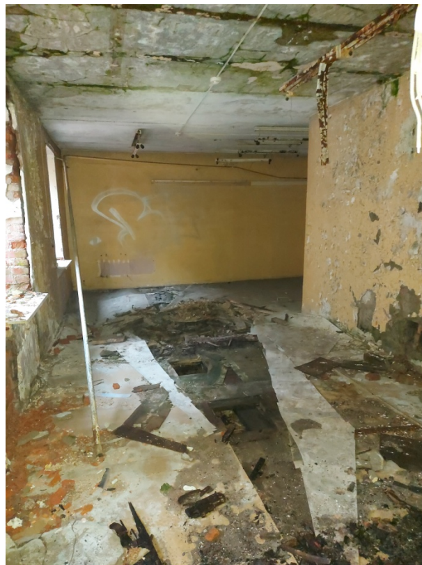
Фото 60. Западное помещение третьего этажа.
