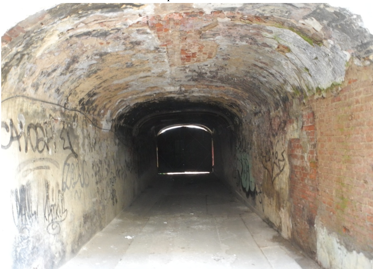
Фото 9. Проездная арка, вид со двора.
