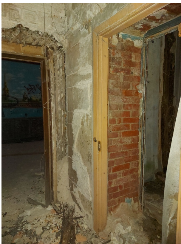
Фото 50. Проемы в центральной части.
