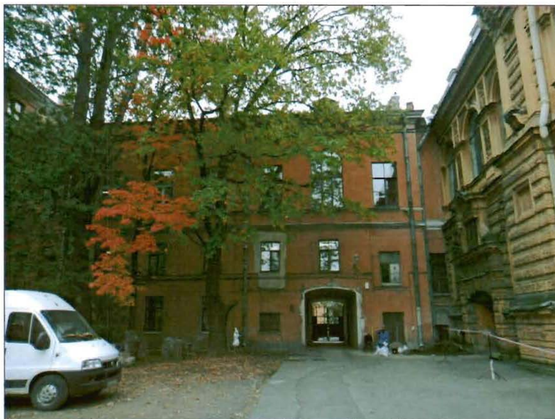
31. Восточный дворовый фасад. Общий вид.
