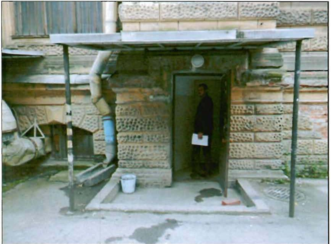
9. Северный дворовый фасад. Фрагмент.
