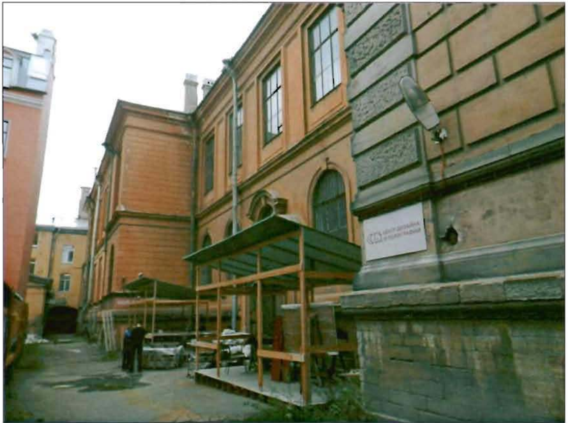
6. Южный дворовый фасад. Общий вид.
