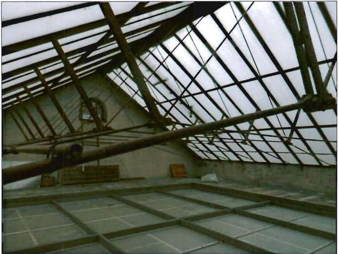
36. Металлические фермы над световым фонарем парадной лестницы.
