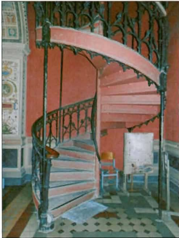
18. Помещение № 1-Н (285). Лестница.
