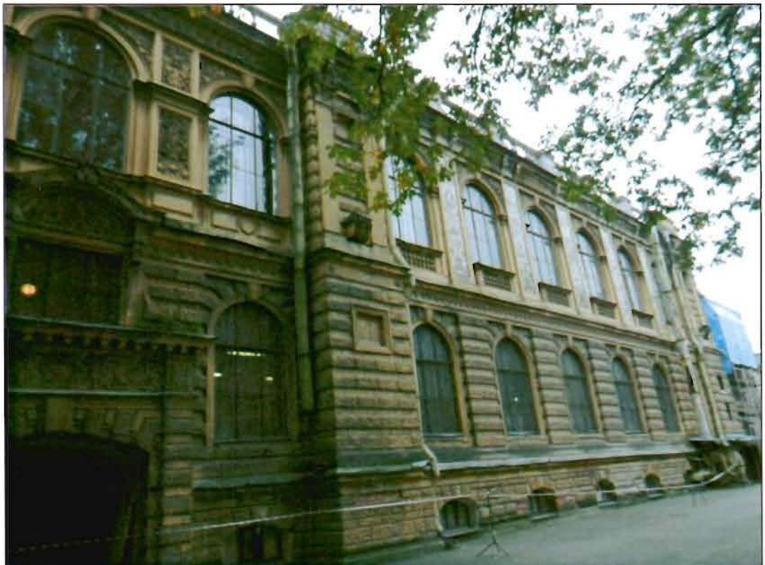
7. Северный дворовый фасад. Общий вид.
