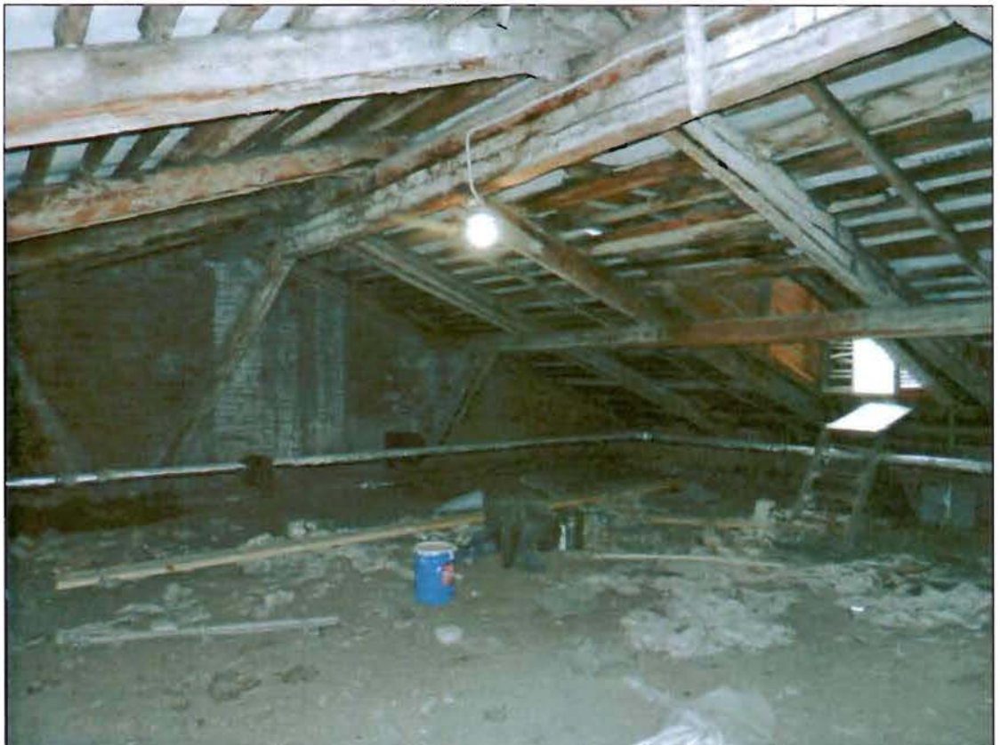
35. Стропильная система. Общий вид.
