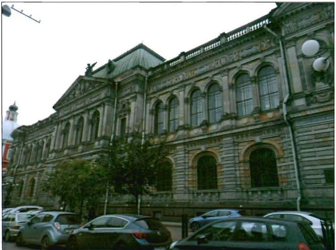
1. Общий вид с северо-востока.
