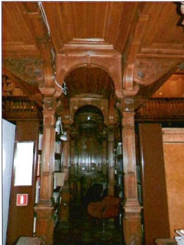
39. Помещение № 1-Н (271). Деревянные колонны.
