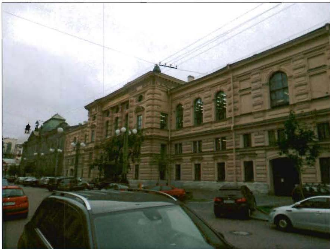
28. Лицевой фасад. Общий вид.
