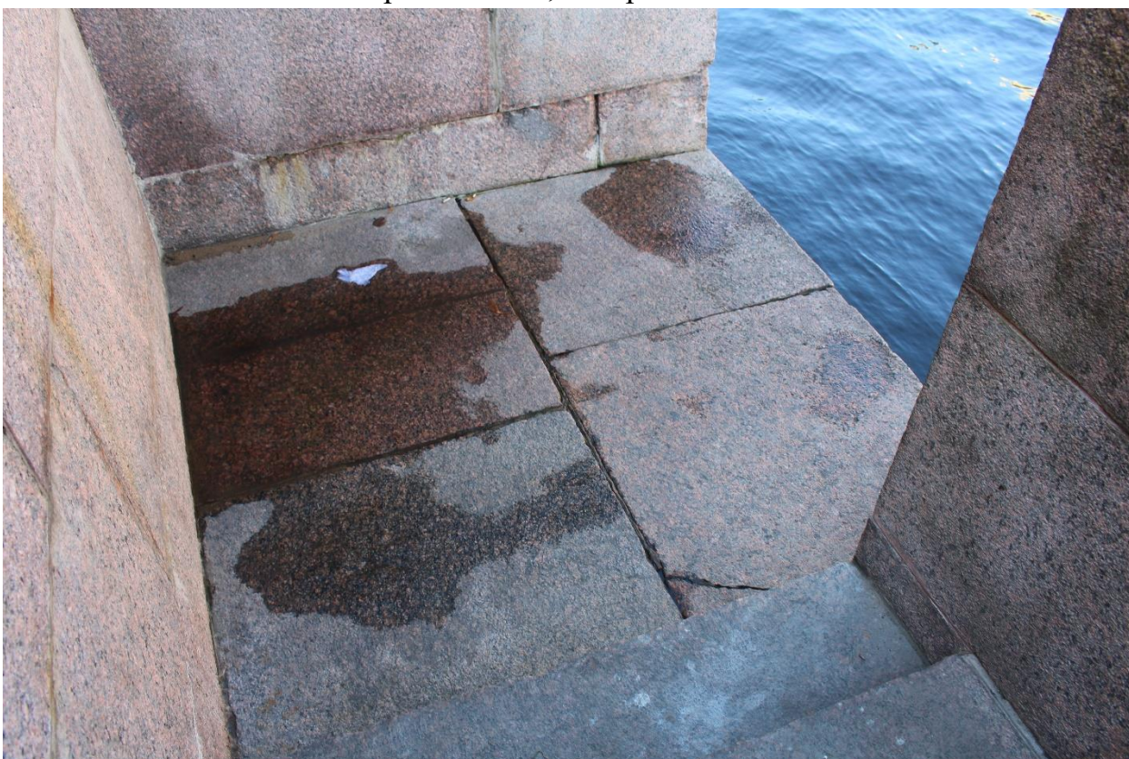
Фото 5. Вид на нижнюю площадку спуска № 15 объекта культурного наследия федерального значения «Набережные со спусками» на уч. наб. р. Мойки «Синий мост – Фонарный мост», литера Б с востока.
