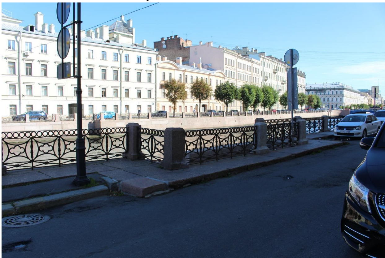
Фото 1. Вид на спуск № 15 объекта культурного наследия федерального значения «Набережные со спусками» на уч. наб. р. Мойки «Синий мост – Фонарный мост», литера Б с юго-запада.
