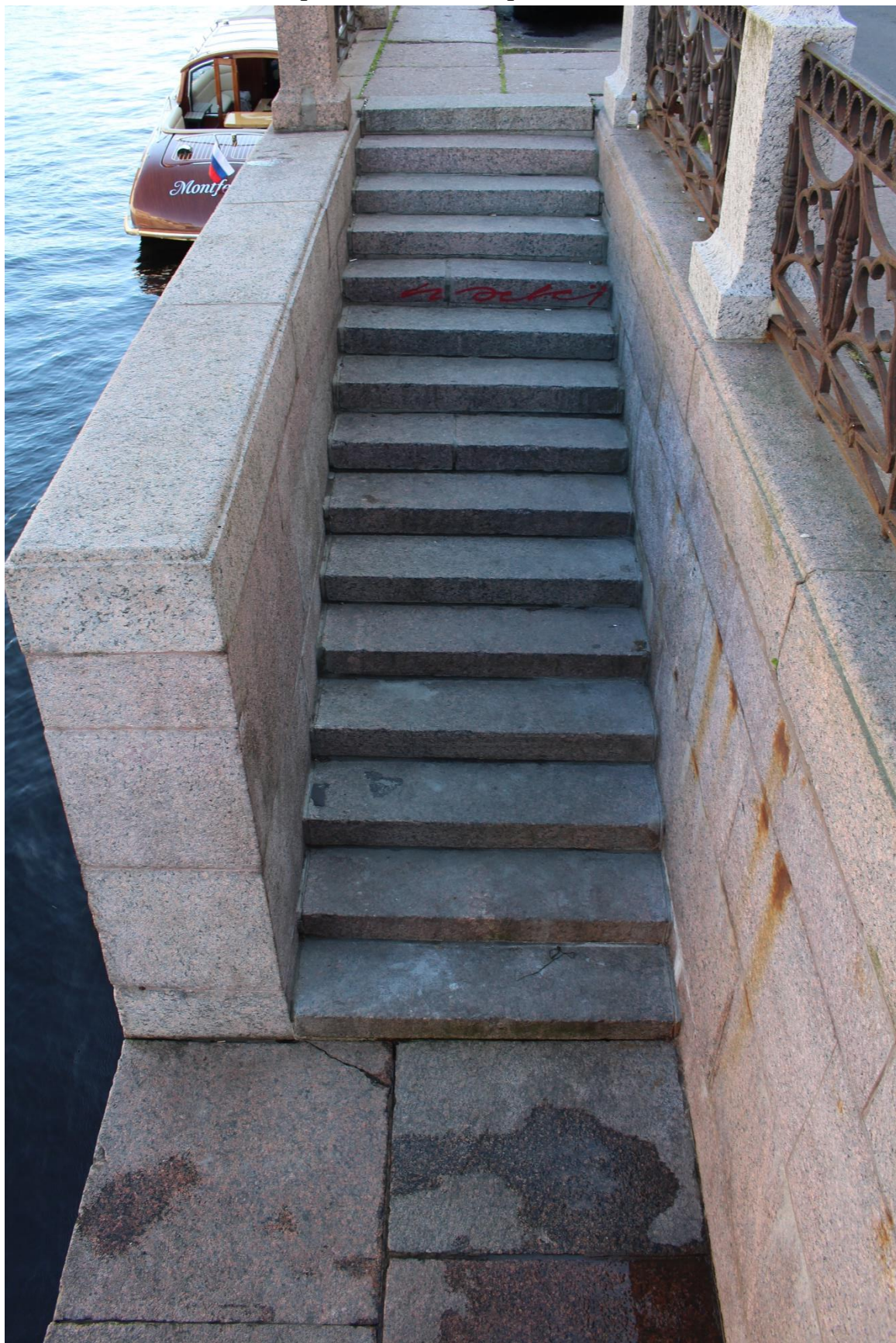
Фото 3. Вид на нижнюю площадку спуска № 15 объекта культурного наследия федерального значения «Набережные со спусками» на уч. наб. р. Мойки «Синий мост – Фонарный мост», литера Б с запада.
